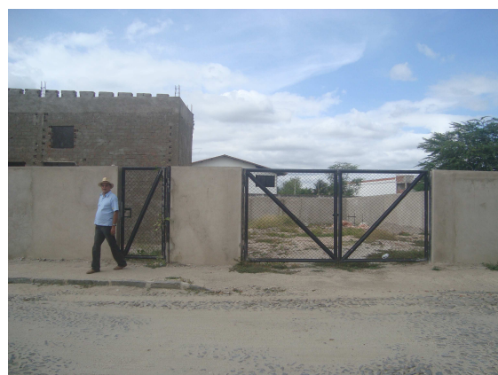
Figura 03 – EE-01 vista da Rua Benjamin Barroso_2 – Portões
