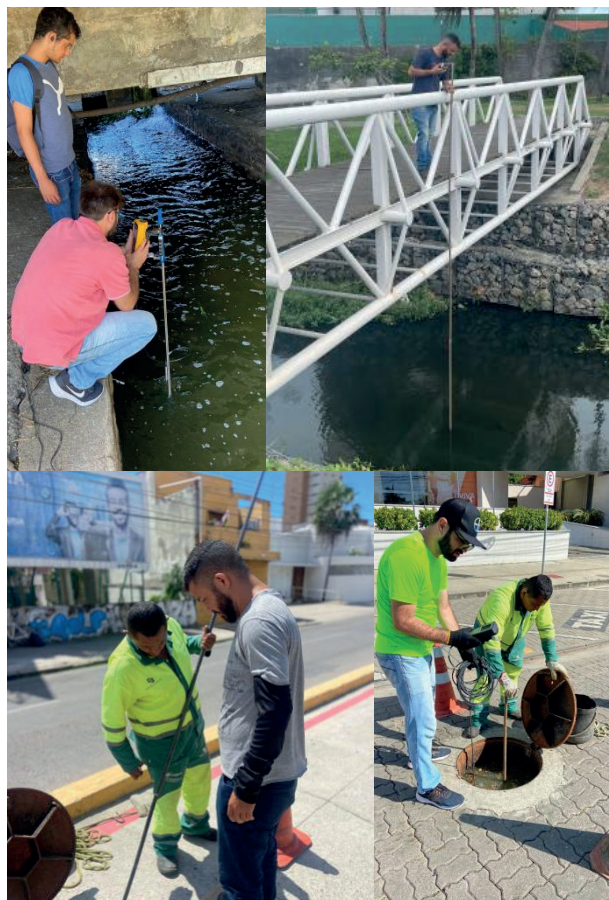
Fig. 2 - Medições de campo nas galerias de drenagem e no Interceptor Leste (IL) de Fortaleza/CE realizadas pelas equipes da UFC e CAGECE
