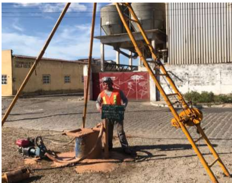
Instalação do furo SP-01
