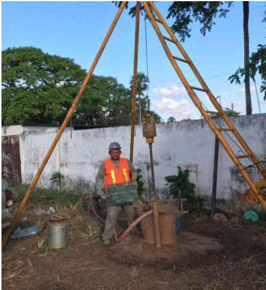
Instalação do furo SP-02
