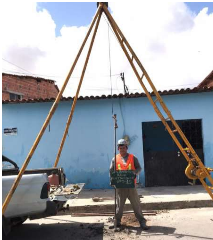
Instalação do furo SP-15
