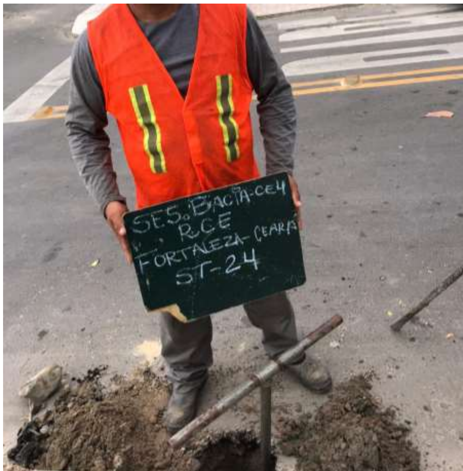
Instalação do furo ST-24
