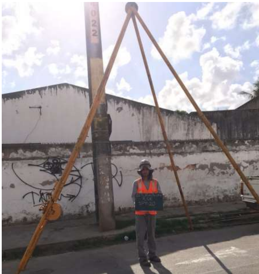
Instalação do furo SP-20
