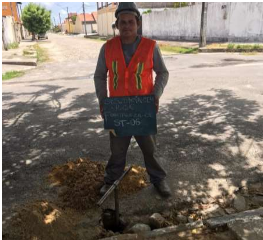
Instalação do furo ST-03
