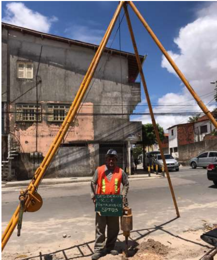
Instalação do furo SP-03
