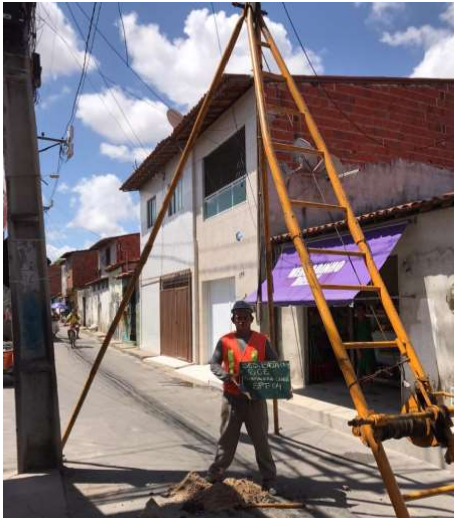
Instalação do furo SP-04
