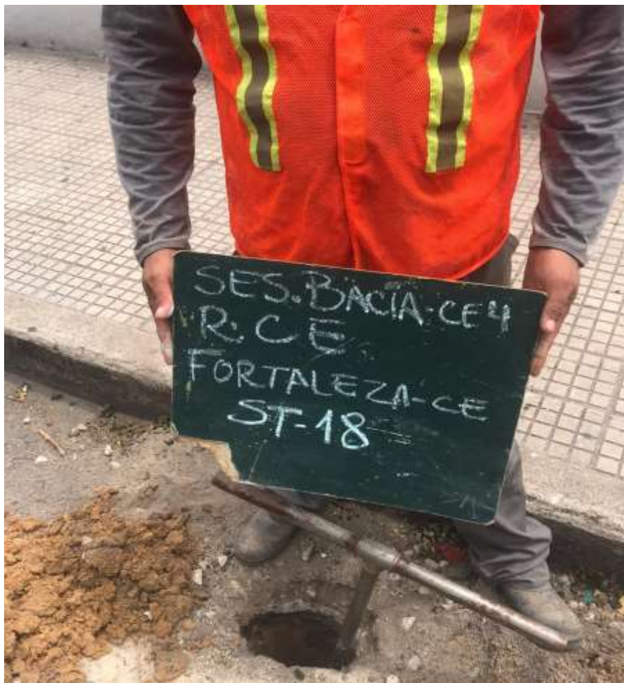
Instalação do furo ST-18
