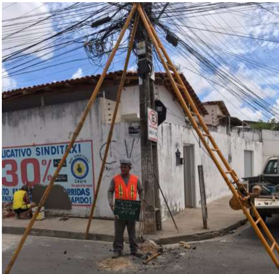
Instalação do furo SP-27
