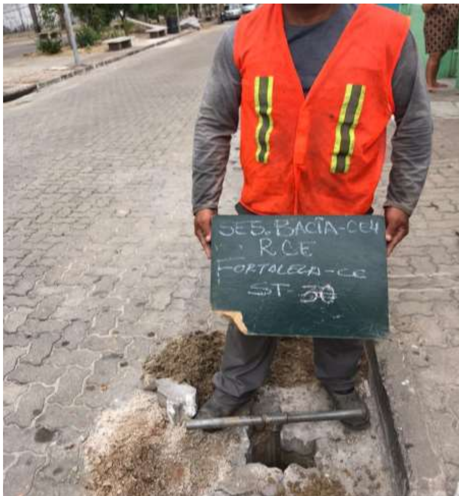
Instalação do furo ST-30
