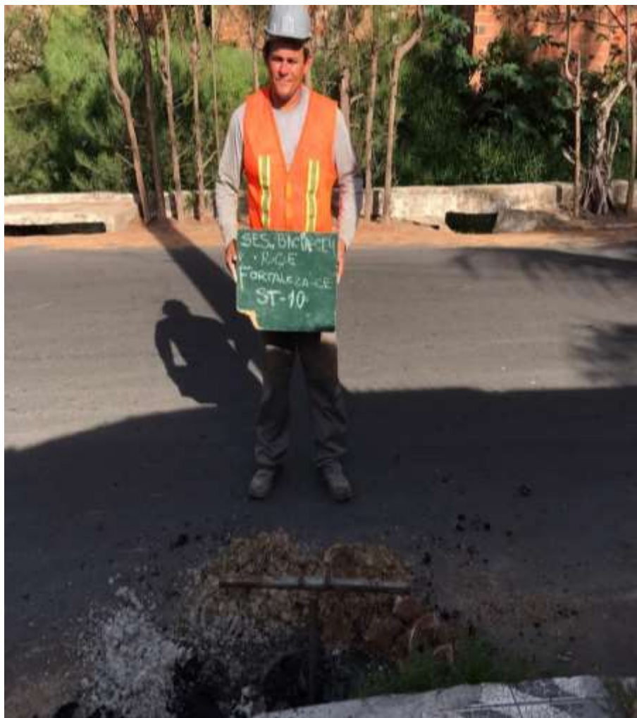
Instalação do furo ST-10
