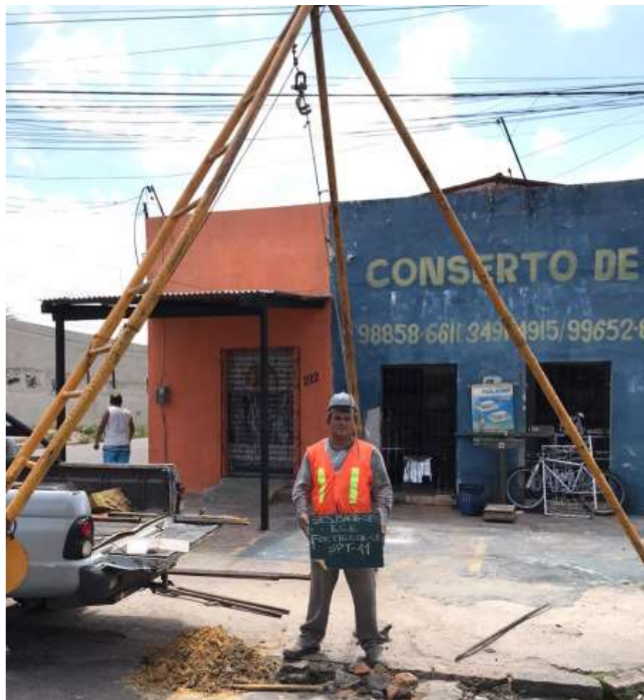
Instalação do furo SP-11
