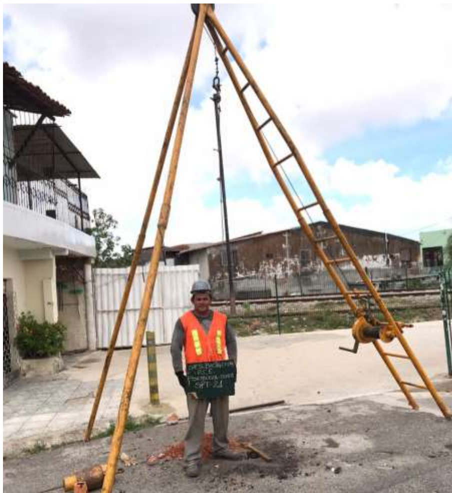
Instalação do furo SP-21
