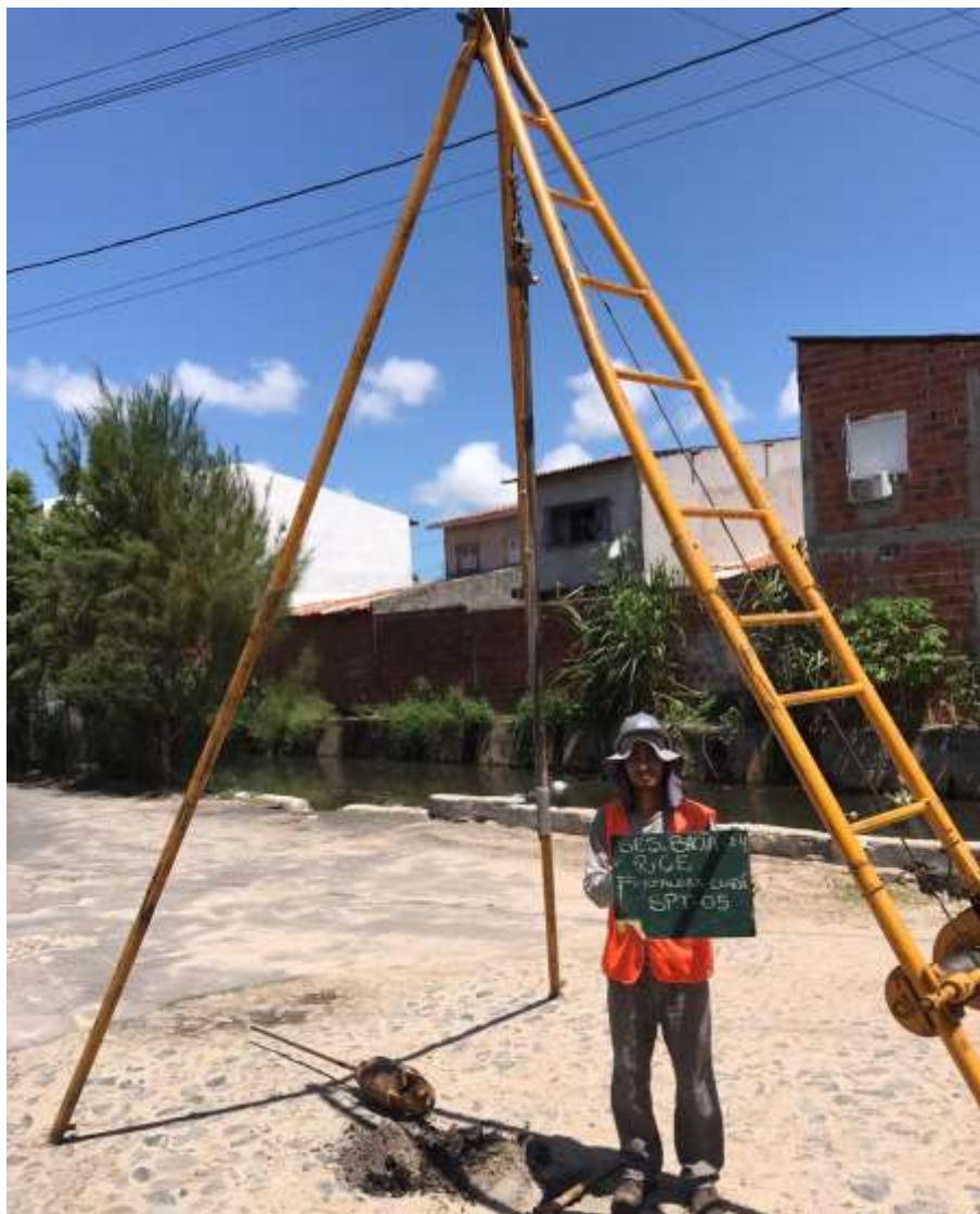
Instalação do furo SP-05
