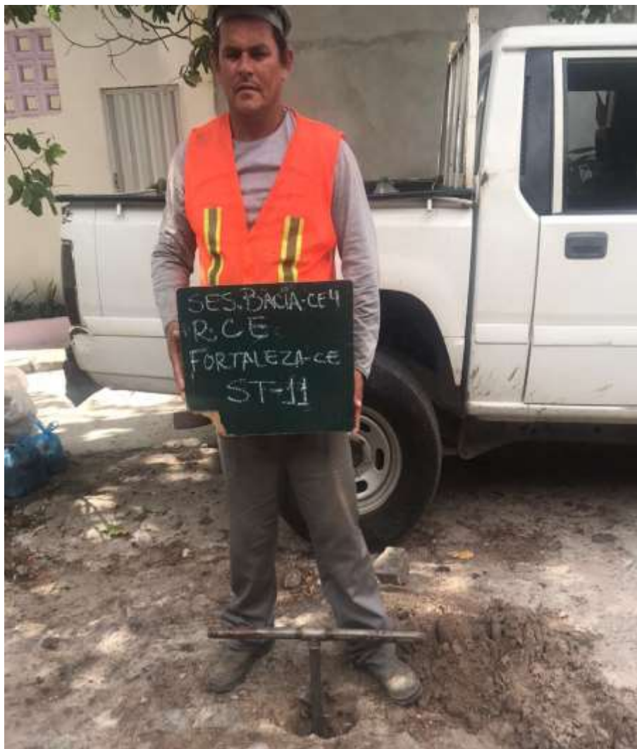
Instalação do furo ST-11
