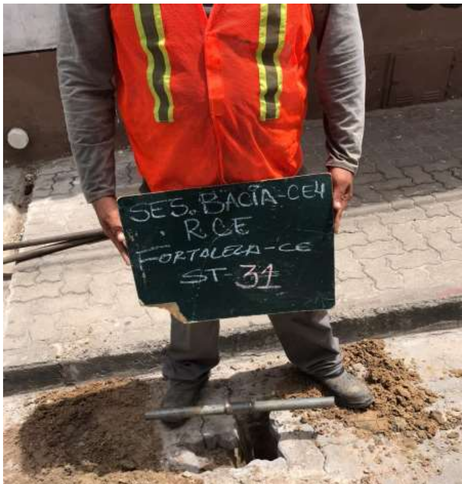
Instalação do furo ST-31
