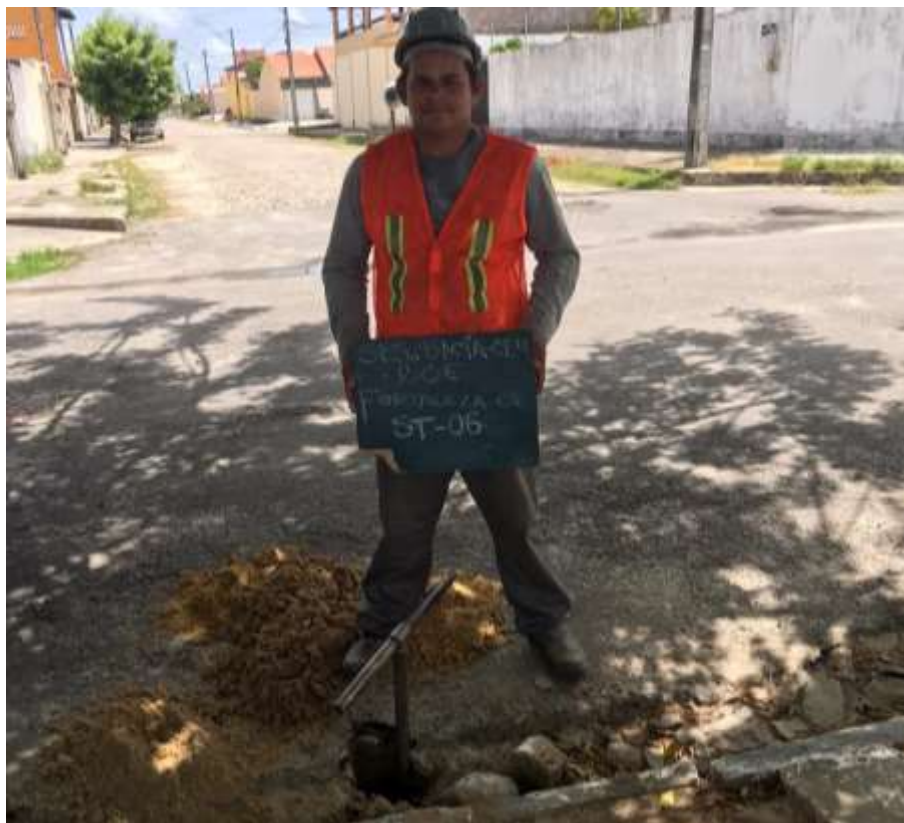
Instalação do furo ST-06
