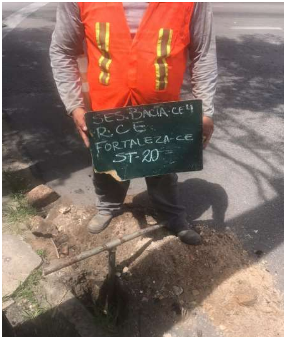
Instalação do furo ST-20
