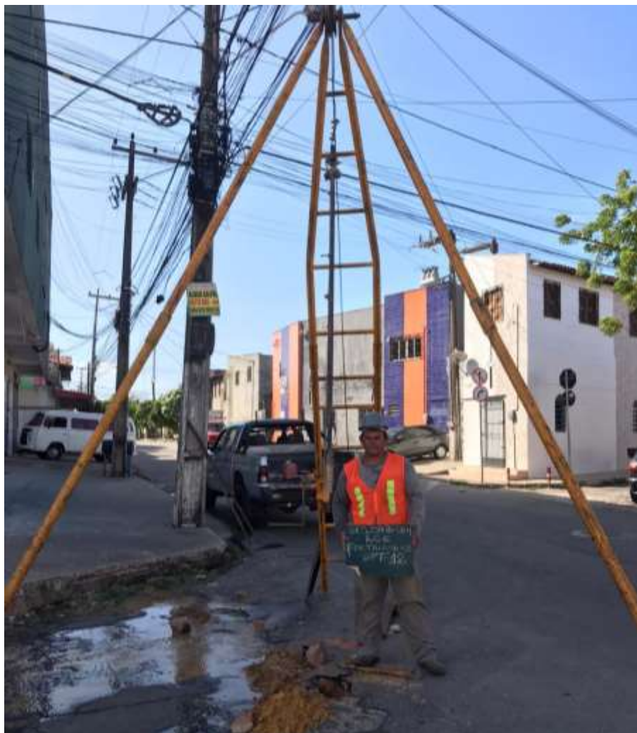
Instalação do furo SP-12
