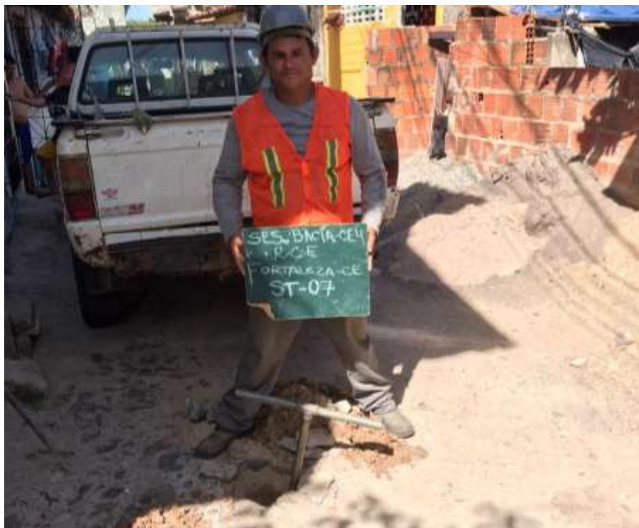
Instalação do furo ST-07
