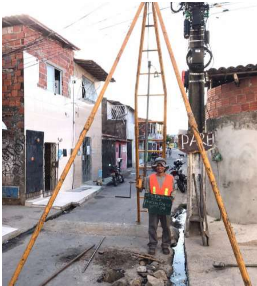
Instalação do furo SP-07
