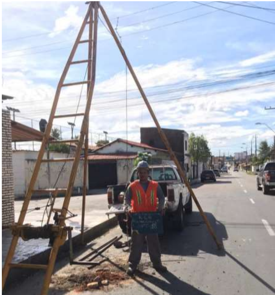
Instalação do furo SP-18
