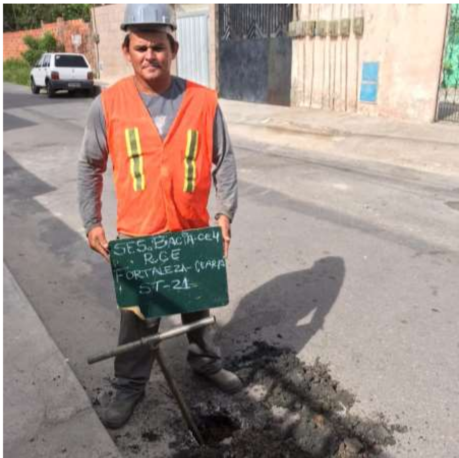
Instalação do furo ST-21
