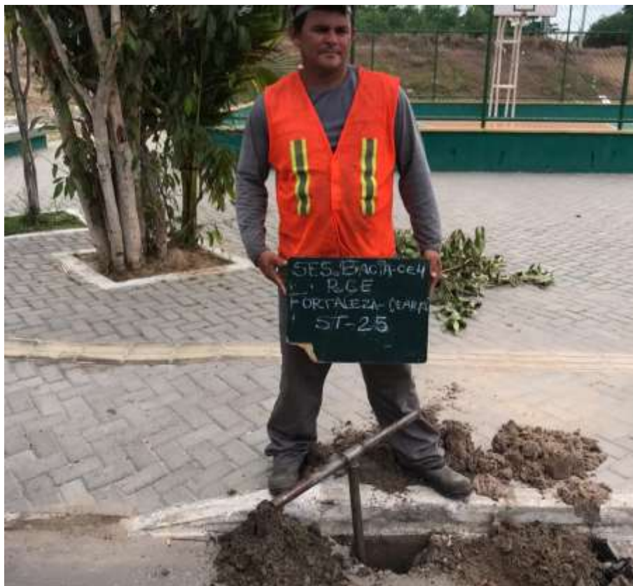
Instalação do furo ST-25
