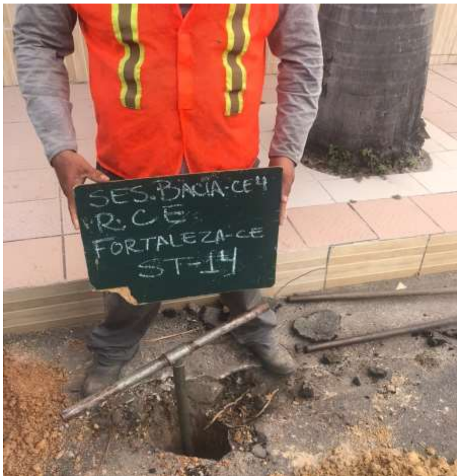
Instalação do furo ST-14
