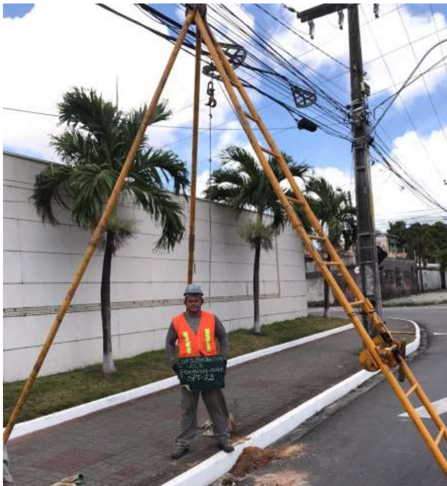
Instalação do furo SP-23
