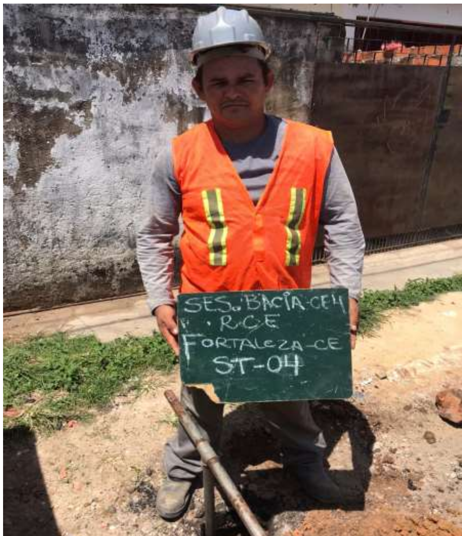
Instalação do furo ST-04
