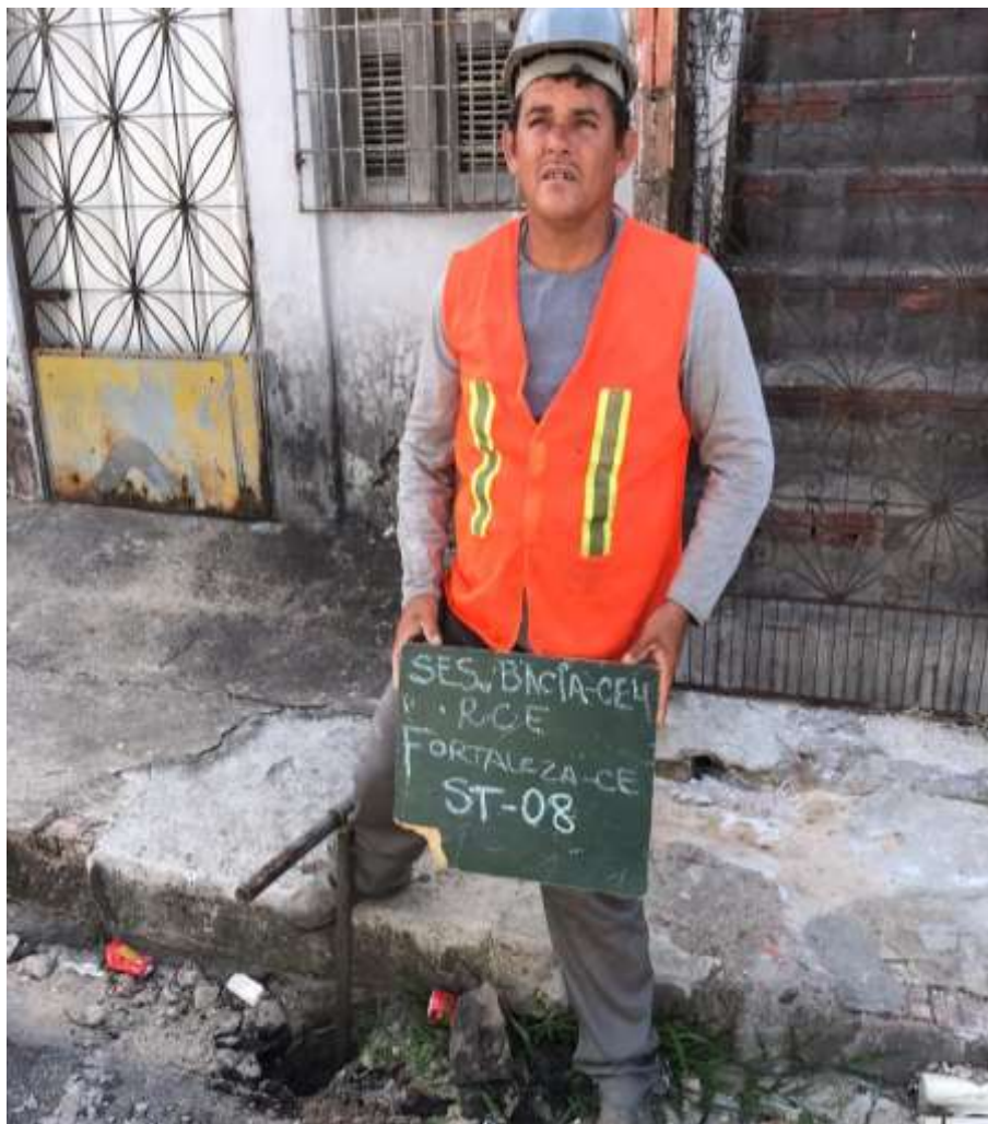
Instalação do furo ST-08
