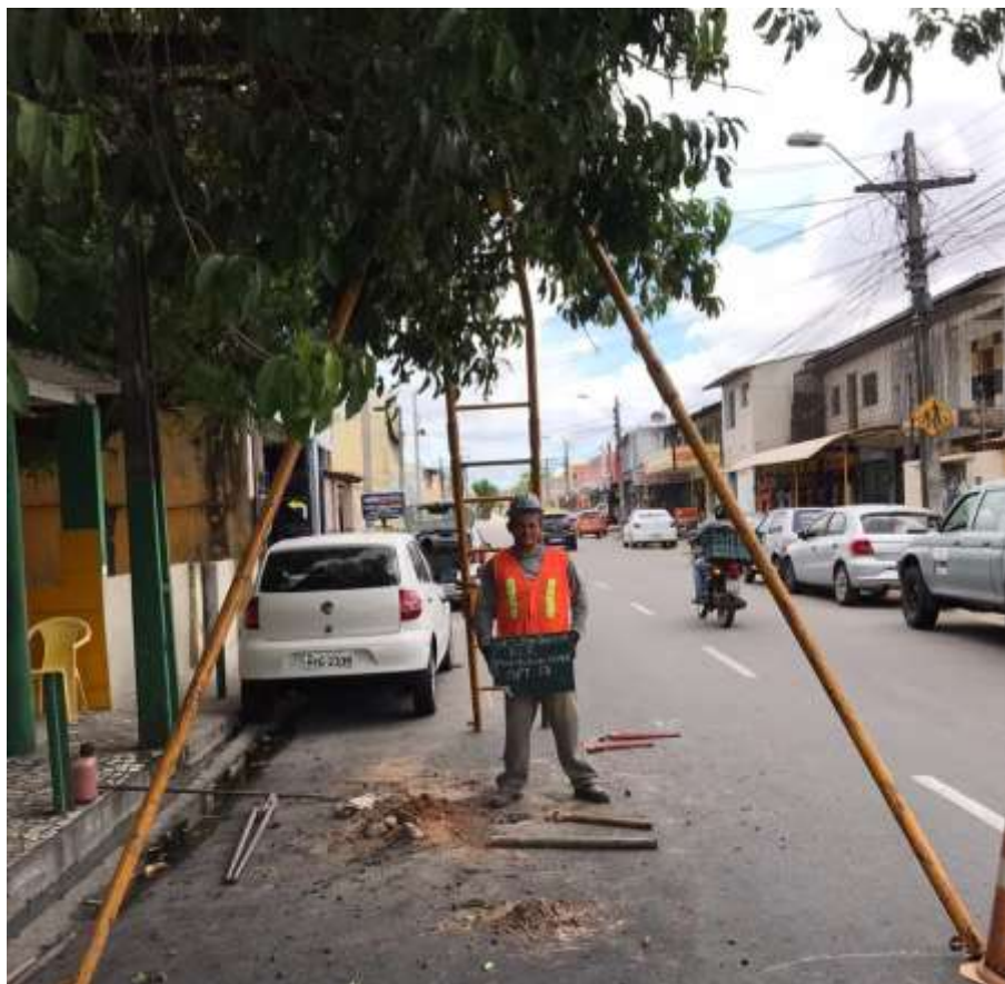
Instalação do furo SP-17
