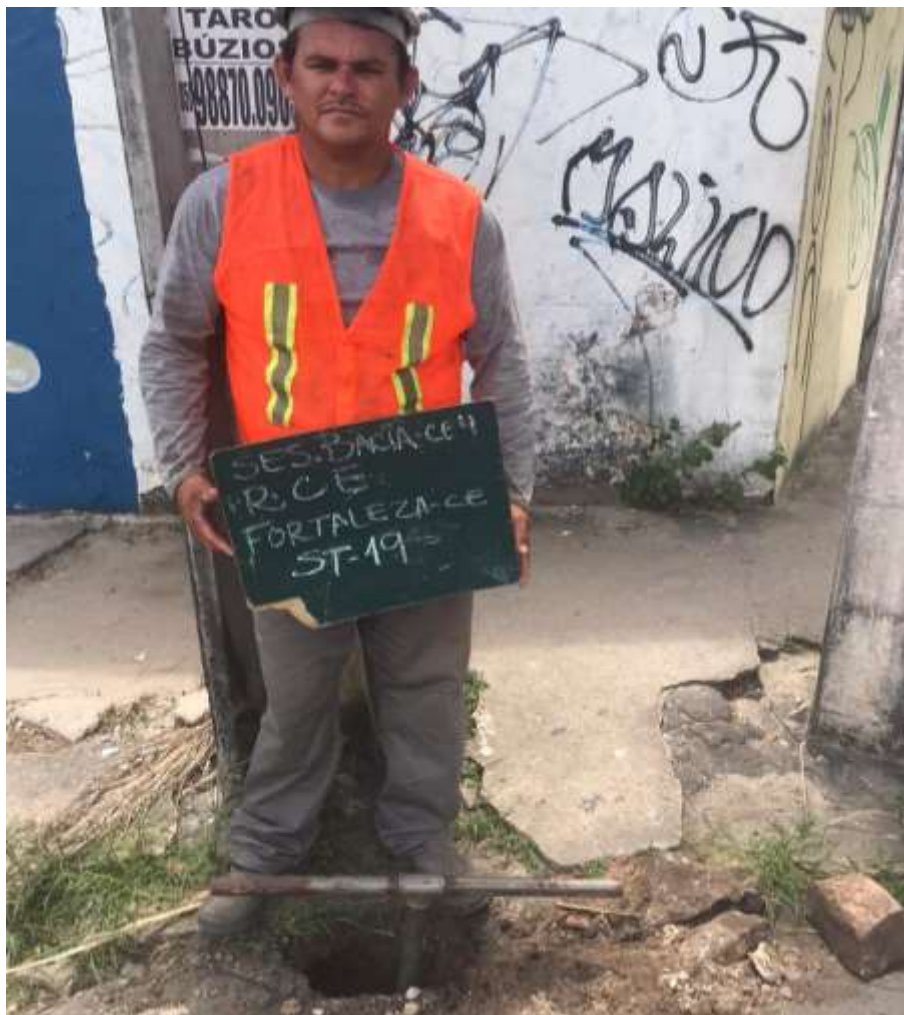
Instalação do furo ST-19
