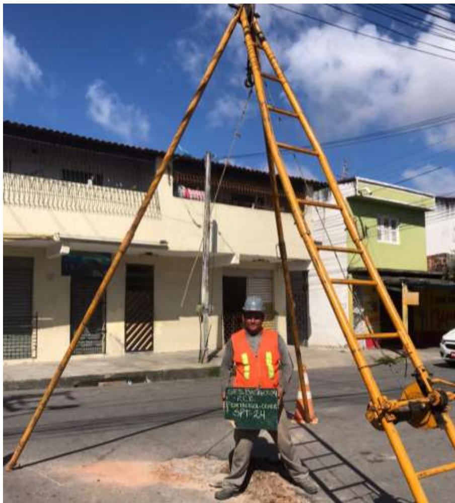
Instalação do furo SP-24
