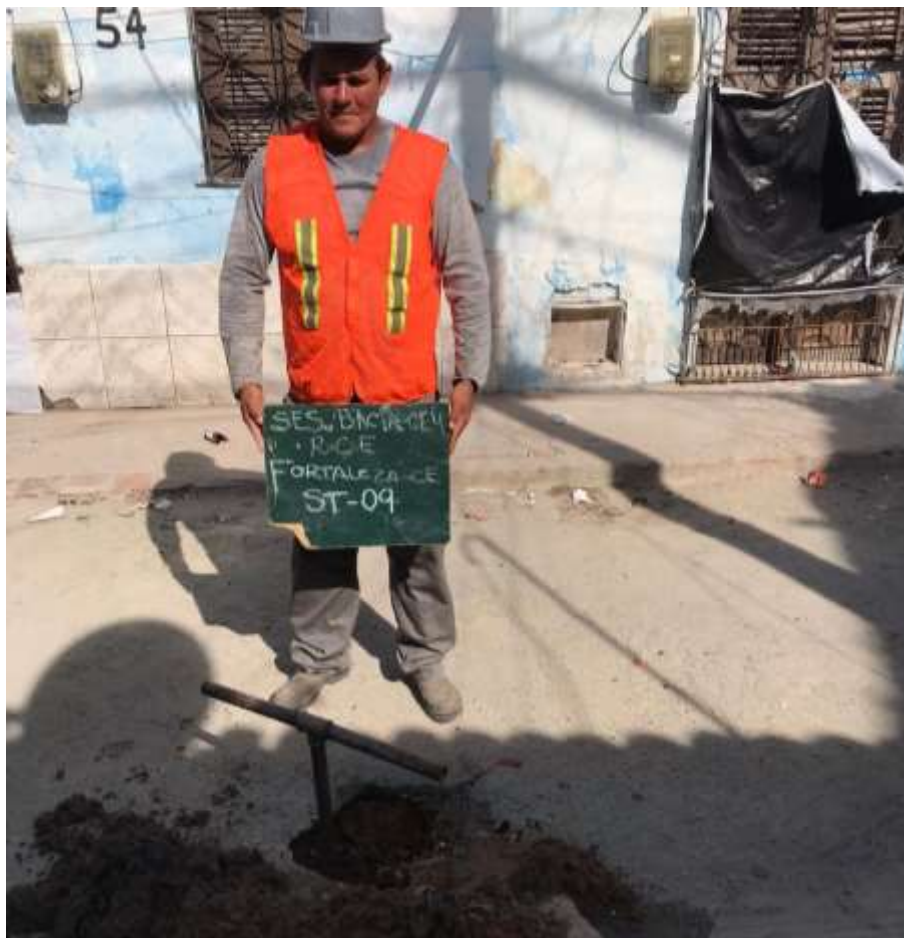
Instalação do furo ST-09
