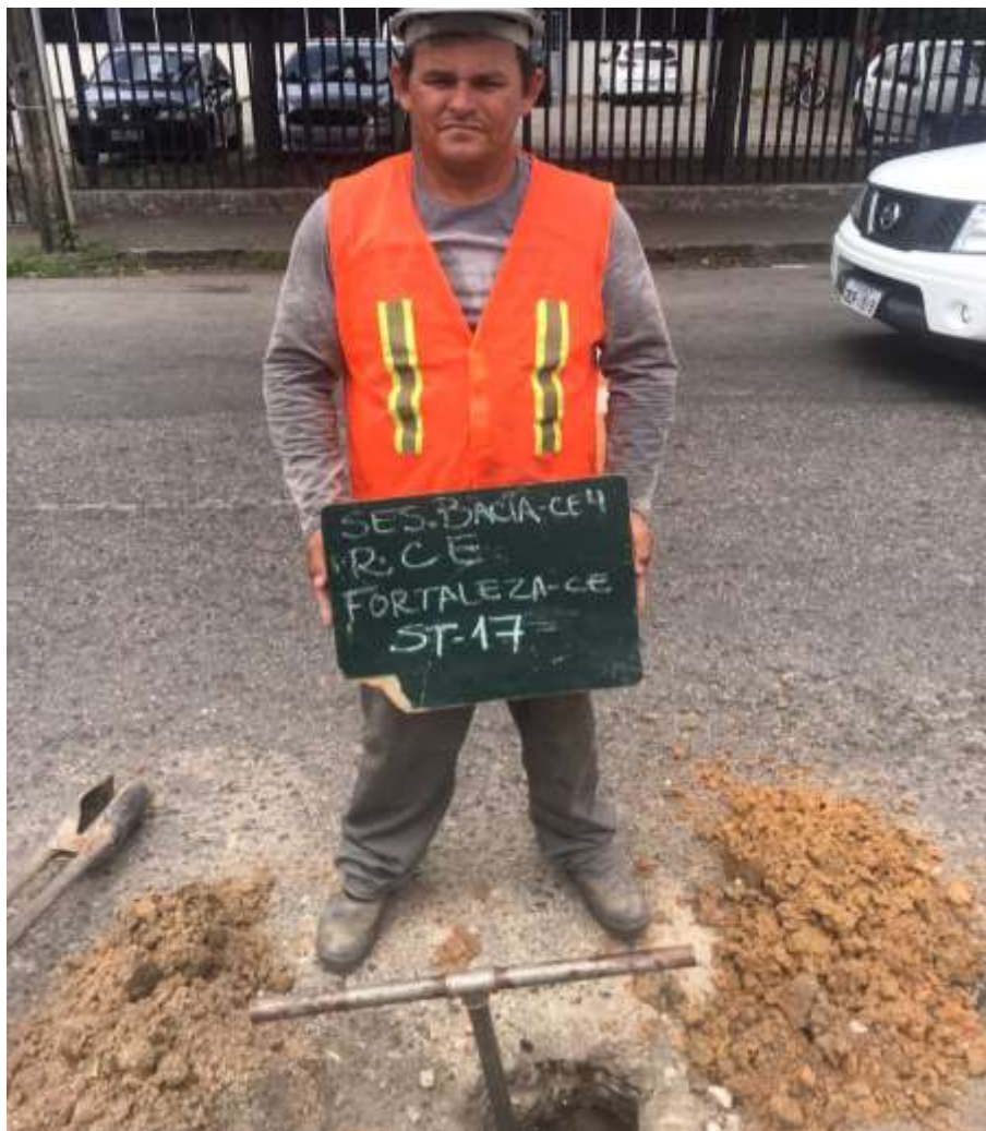
Instalação do furo ST-17
