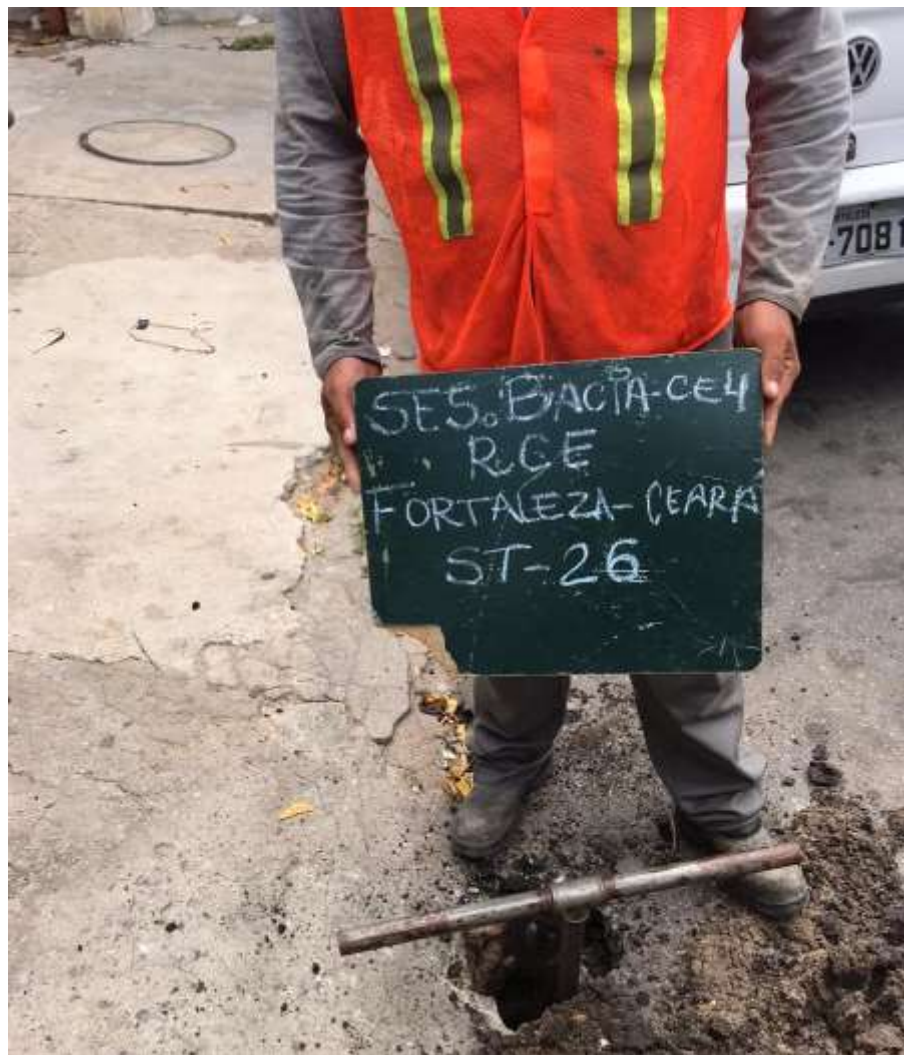
Instalação do furo ST-26
