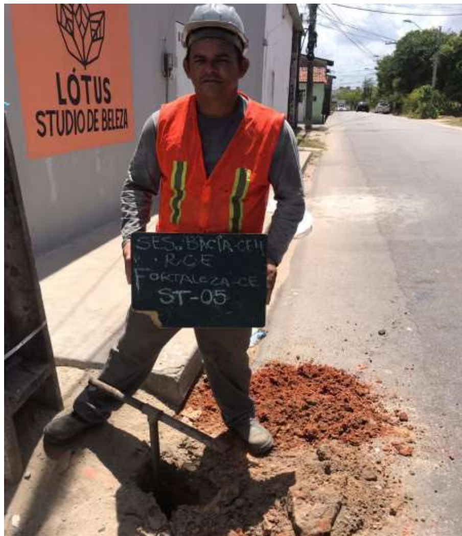
Instalação do furo ST-05
