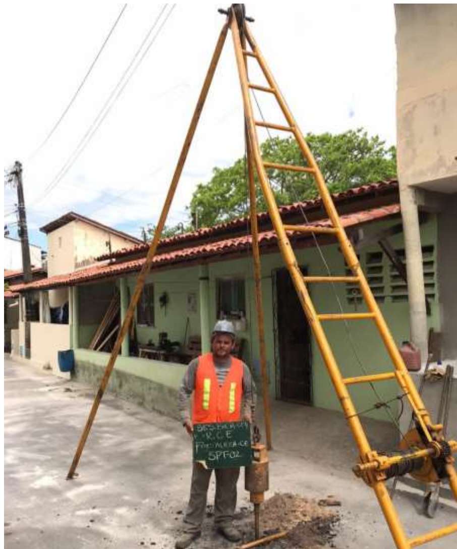
Instalação do furo SP-02
