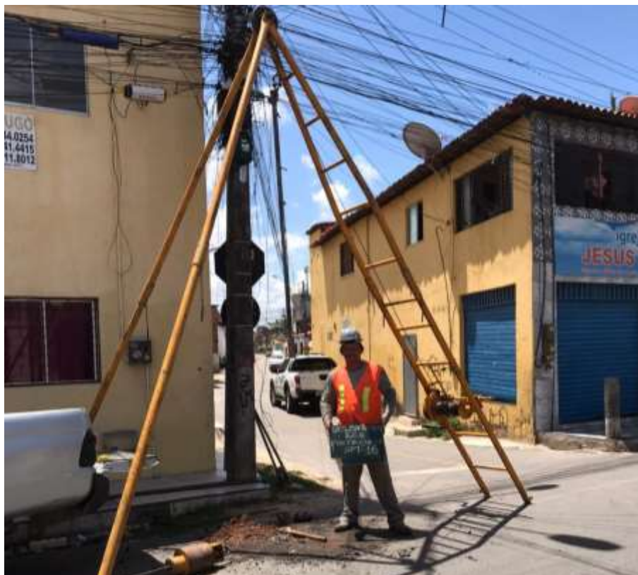
Instalação do furo SP-16
