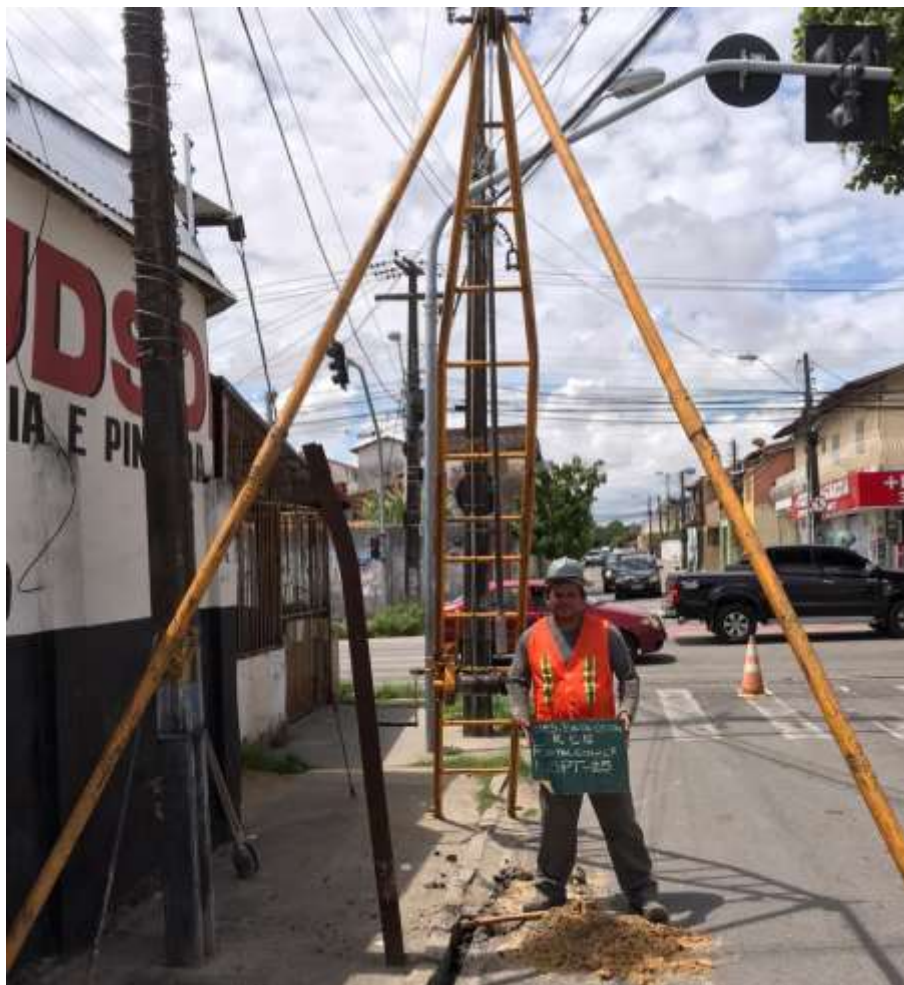
Instalação do furo SP-25
