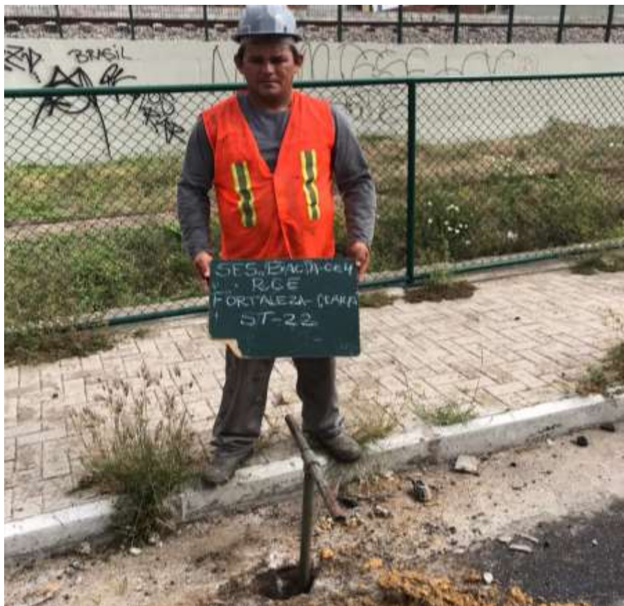
Instalação do furo ST-22
