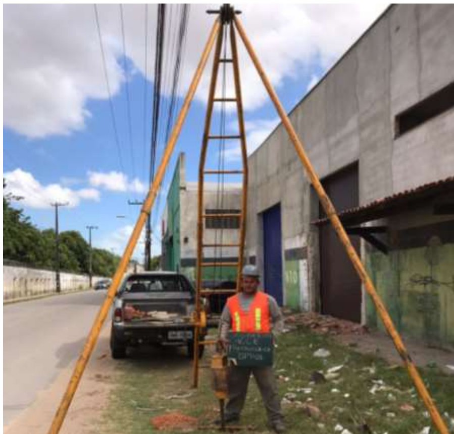
Instalação do furo SP-01
