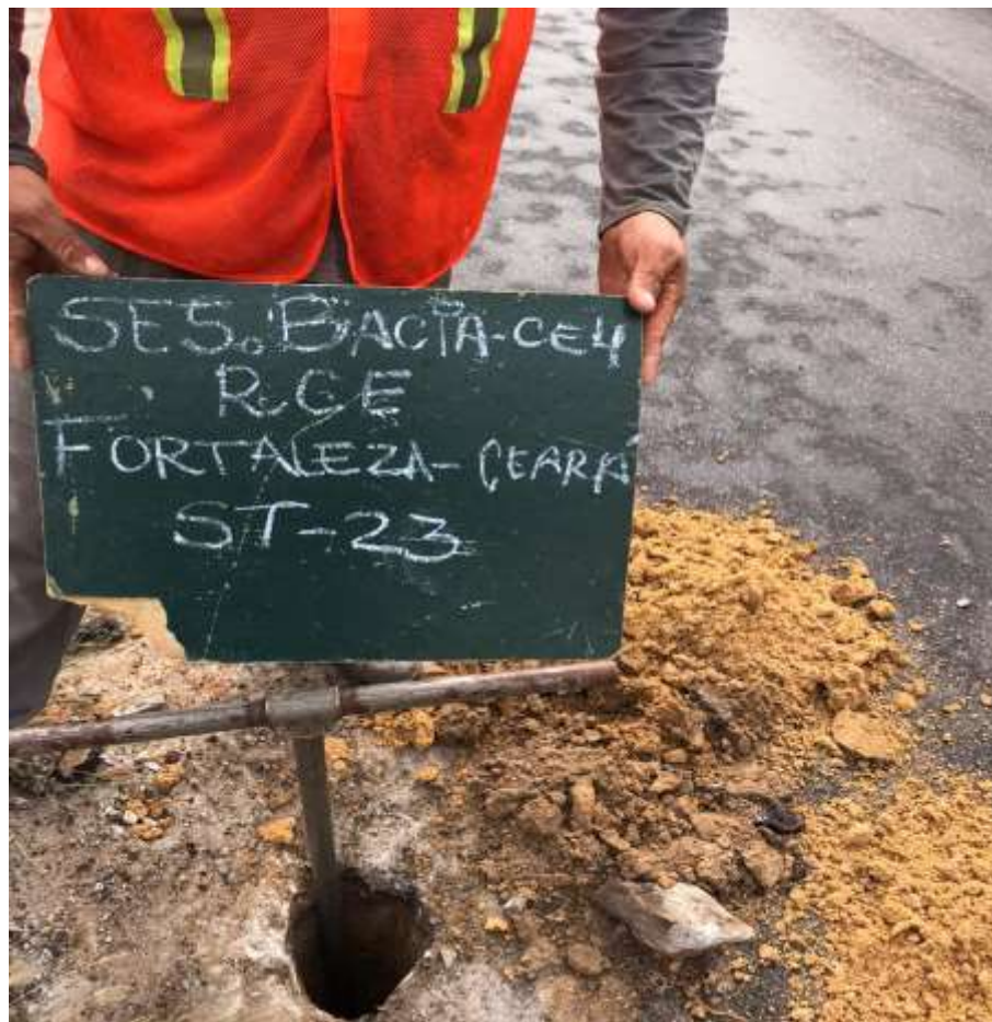
Instalação do furo ST-23
