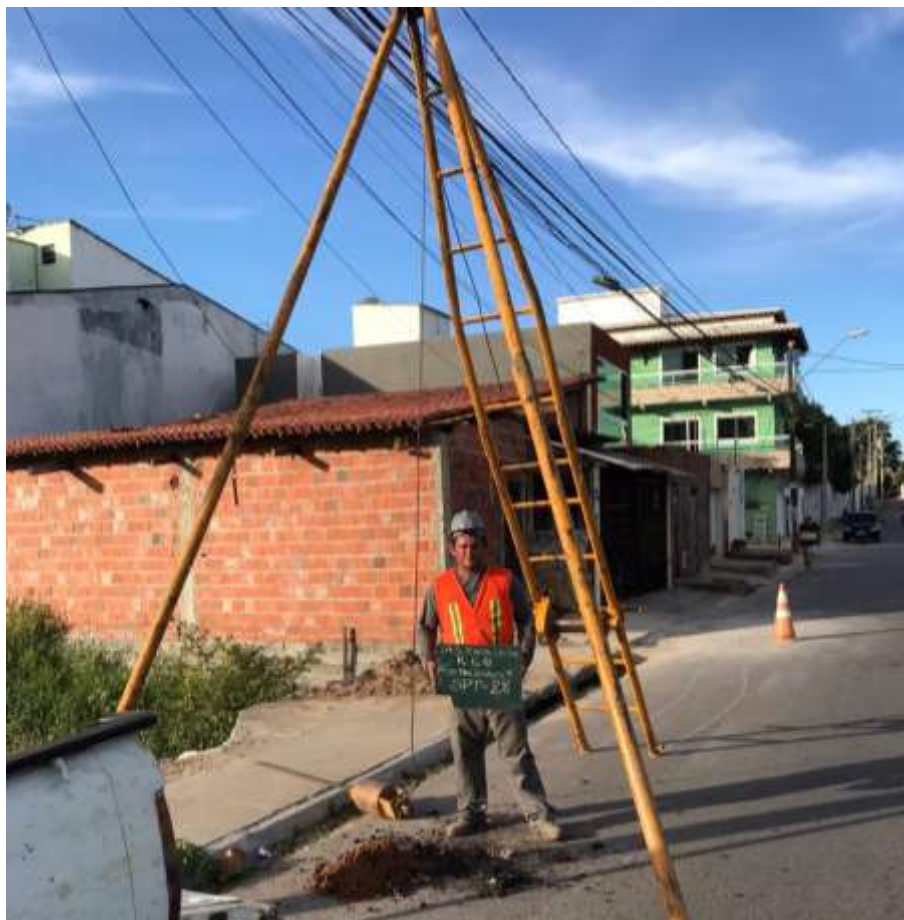
Instalação do furo SP-28
