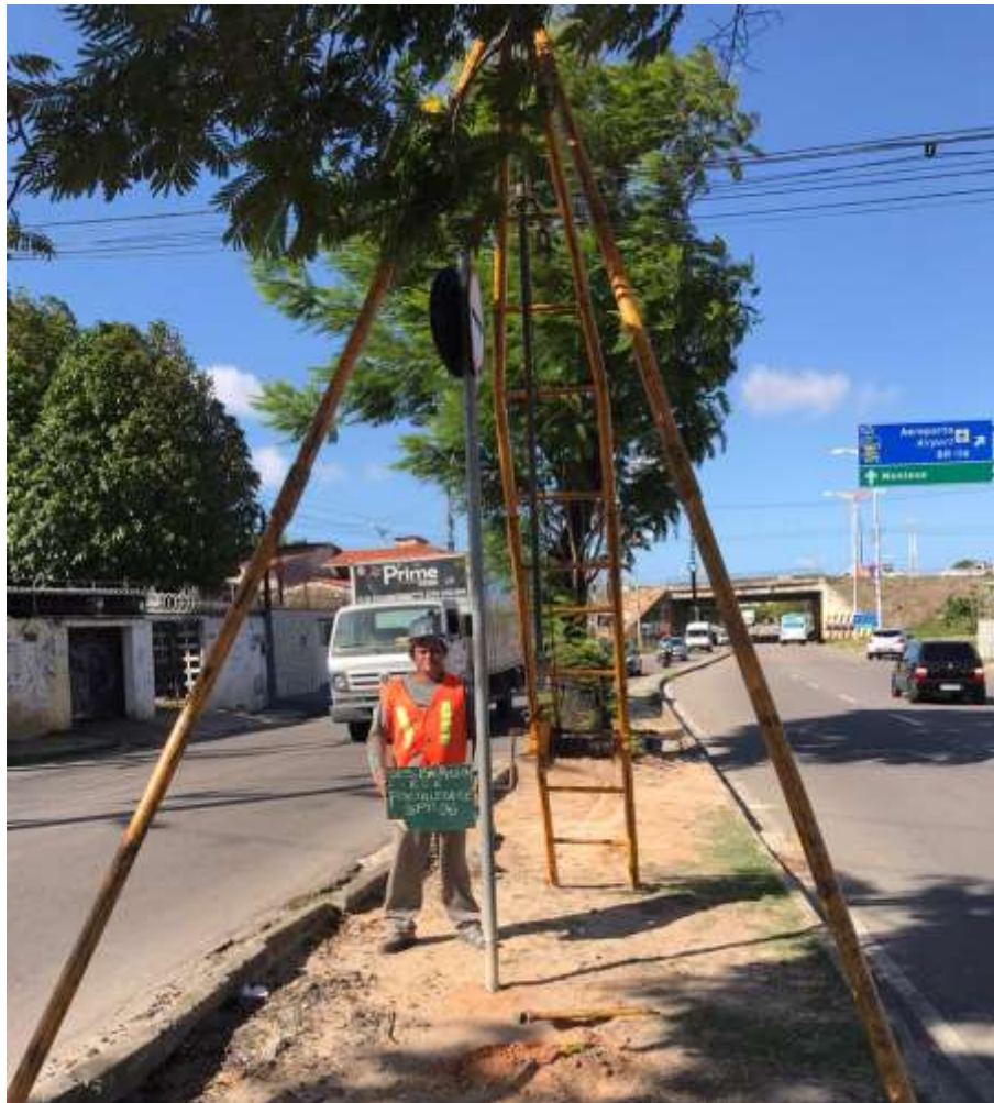
Instalação do furo SP-06
