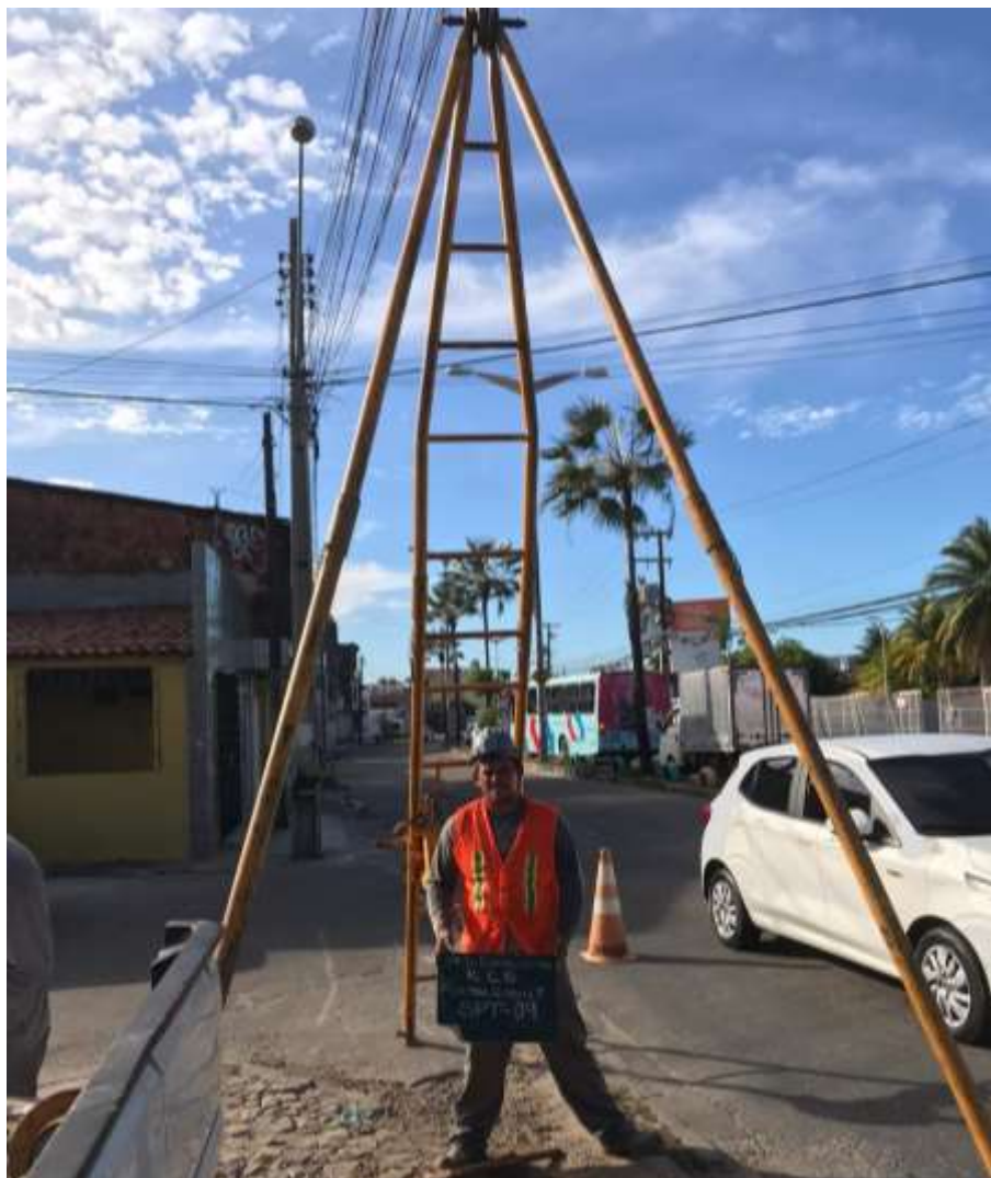
Instalação do furo SP-09
