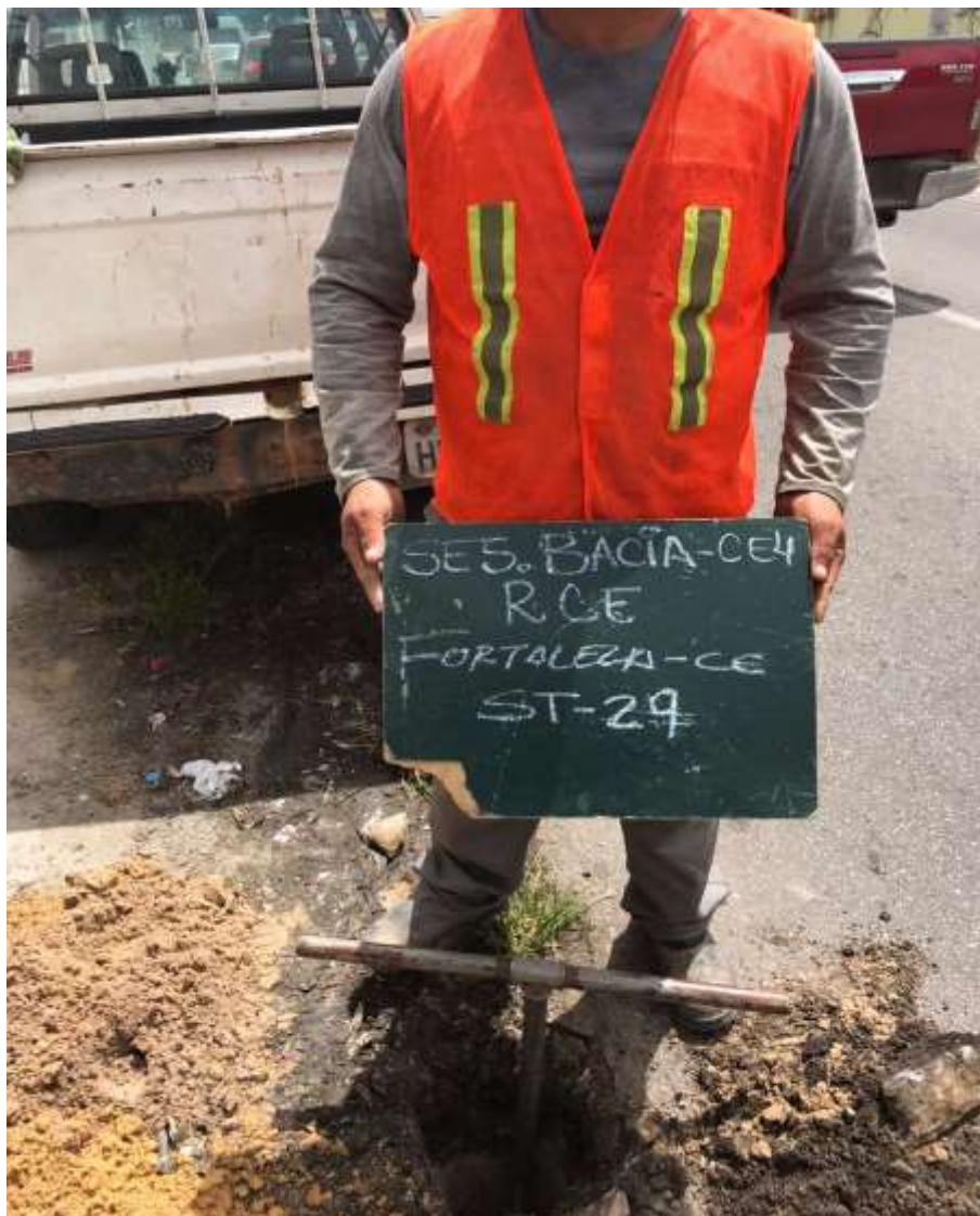
Instalação do furo ST-29
