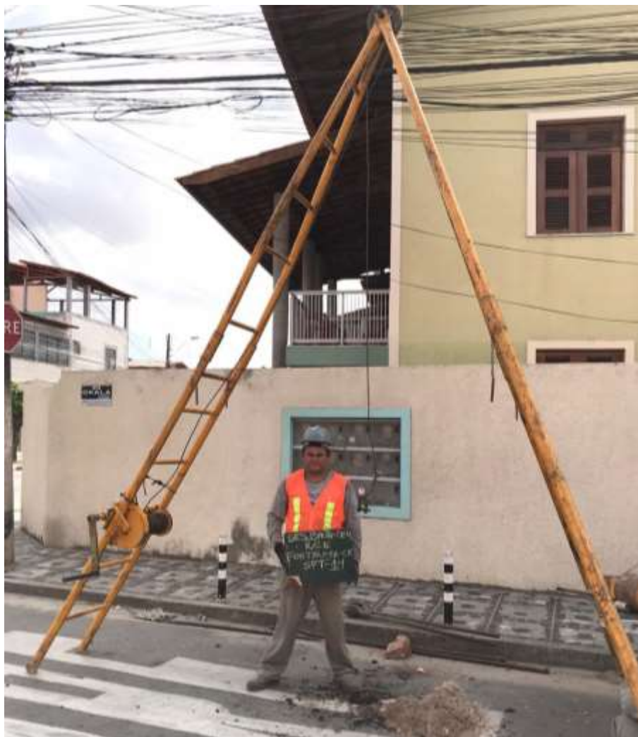
Instalação do furo SP-14
