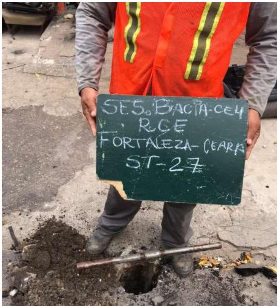
Instalação do furo ST-27
