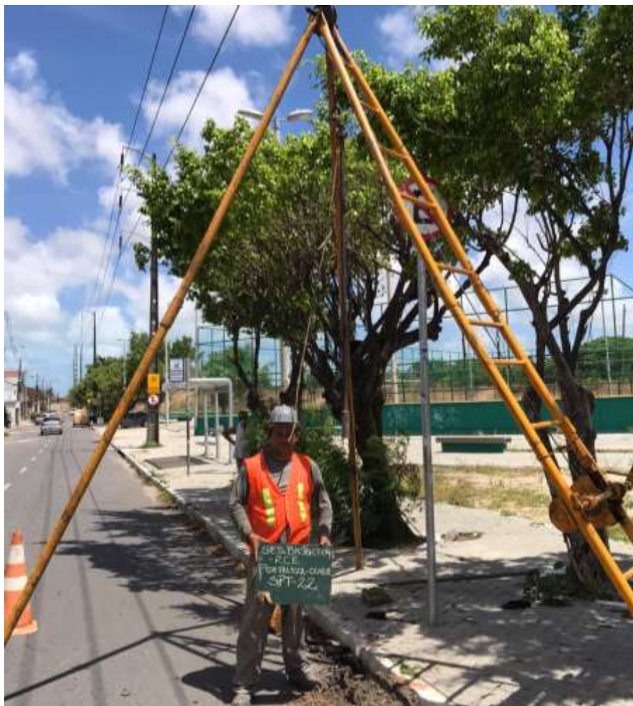
Instalação do furo SP-22
