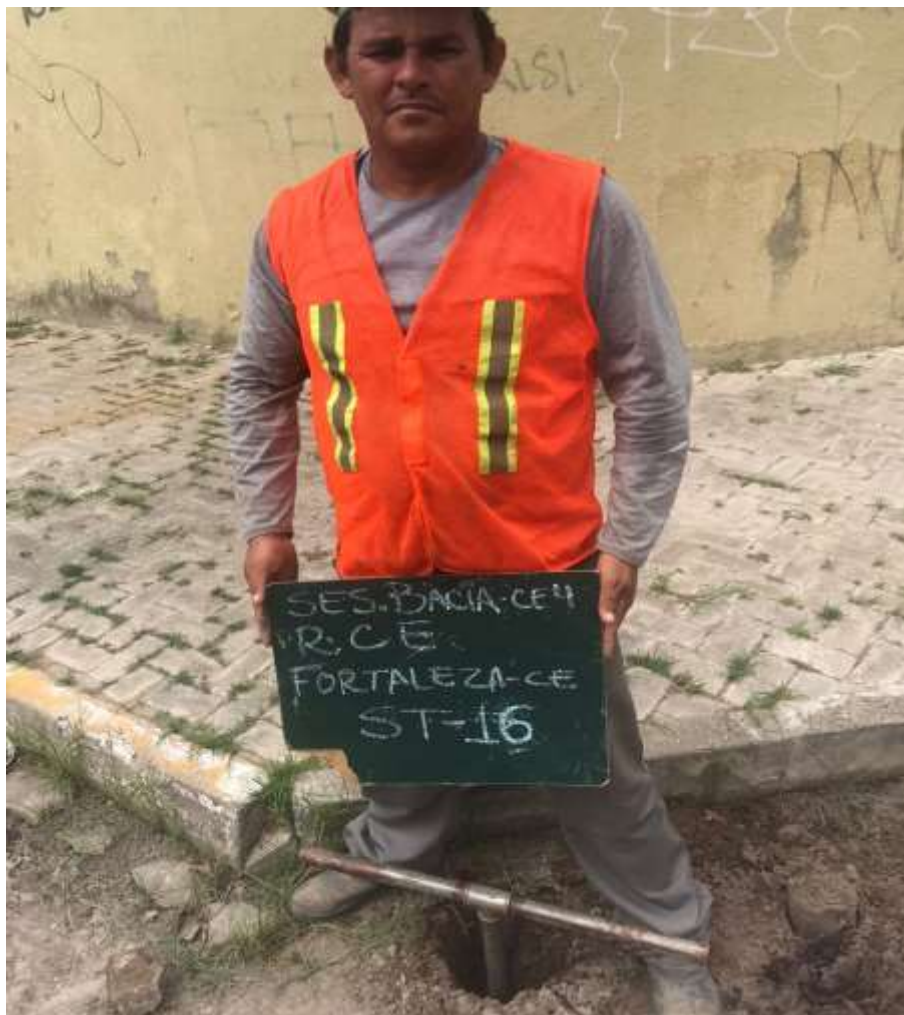
Instalação do furo ST-16
