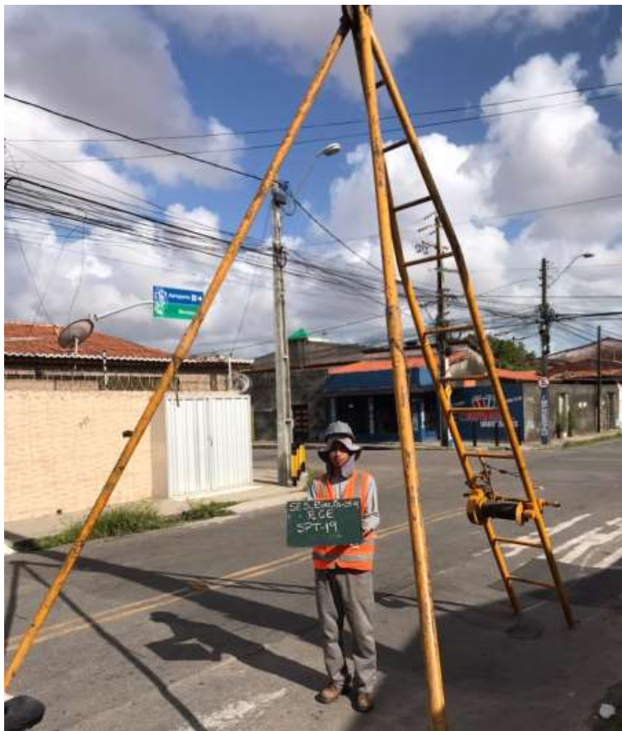
Instalação do furo SP-19
