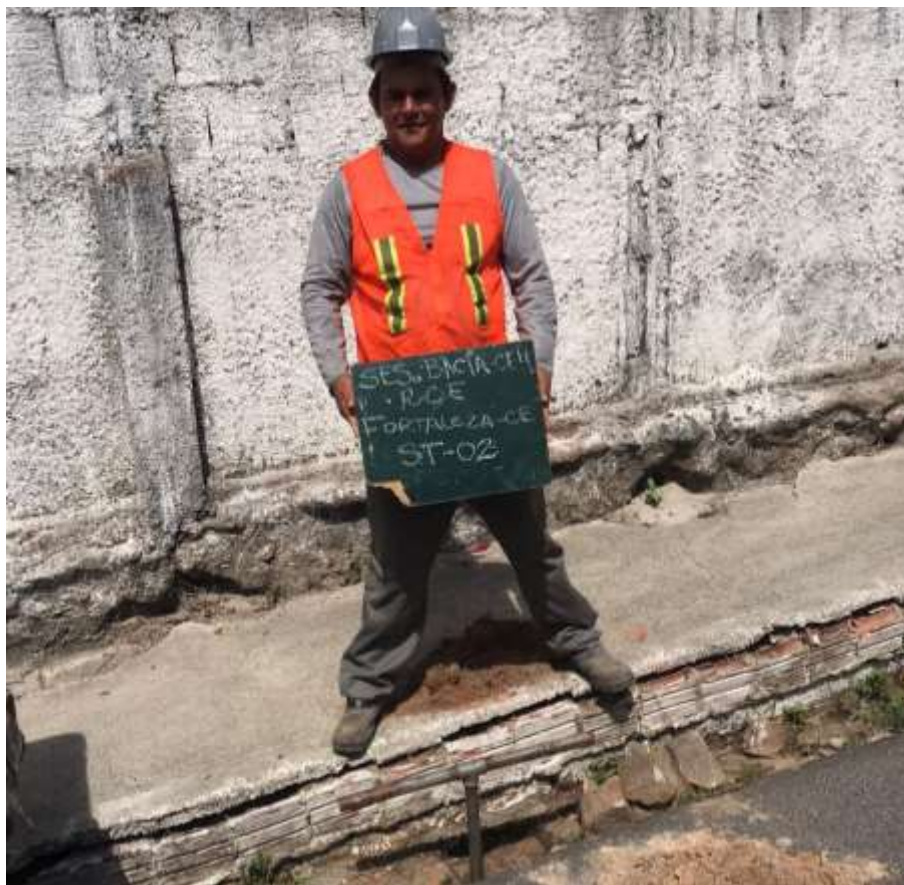
Instalação do furo ST-02
