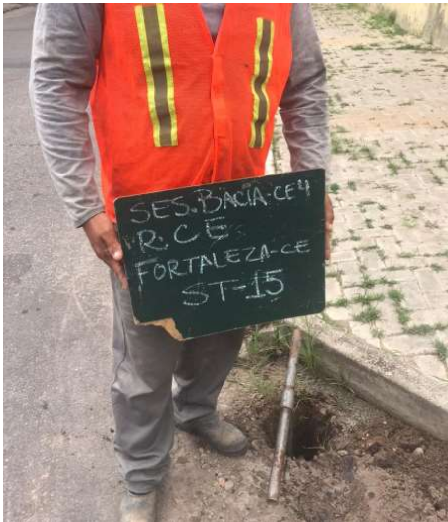
Instalação do furo ST-15
