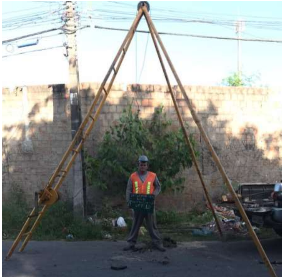
Instalação do furo SP-13
