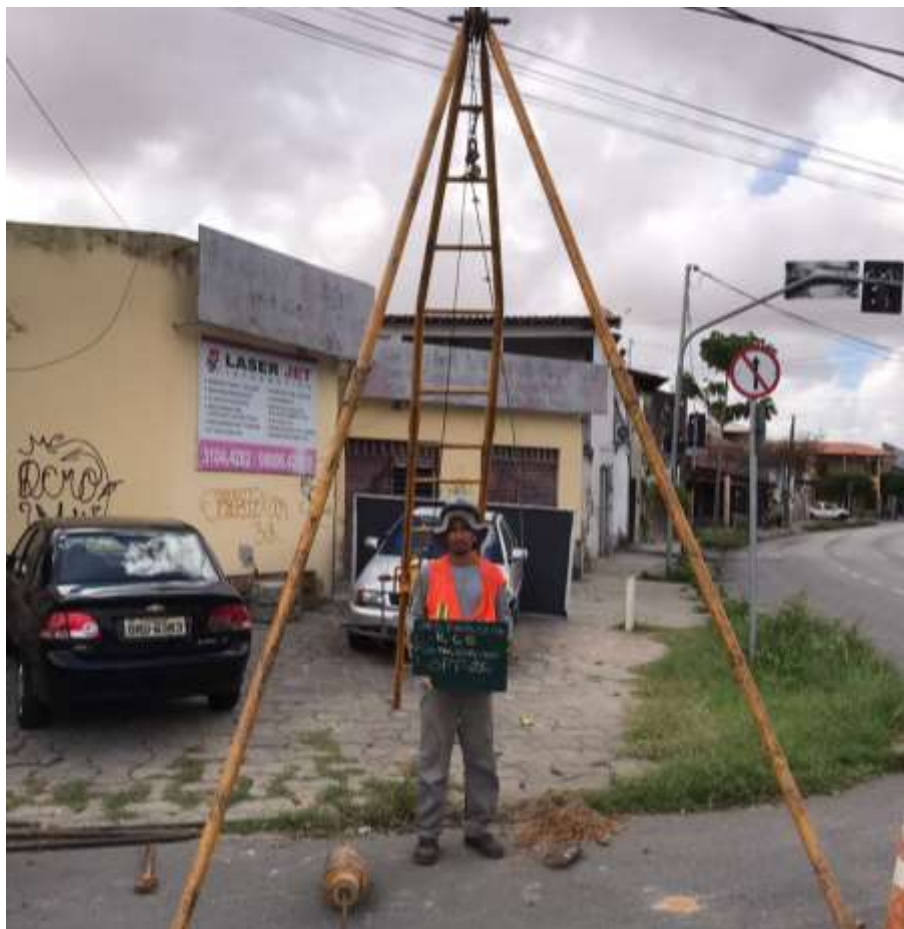
Instalação do furo SP-26
