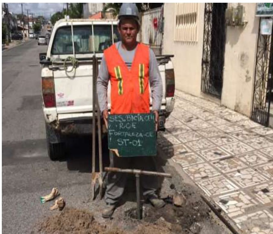
Instalação do furo ST-01
