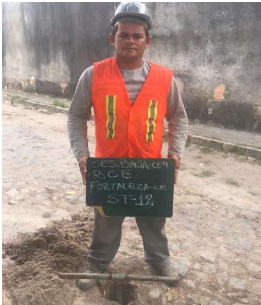
Instalação do furo ST-12
