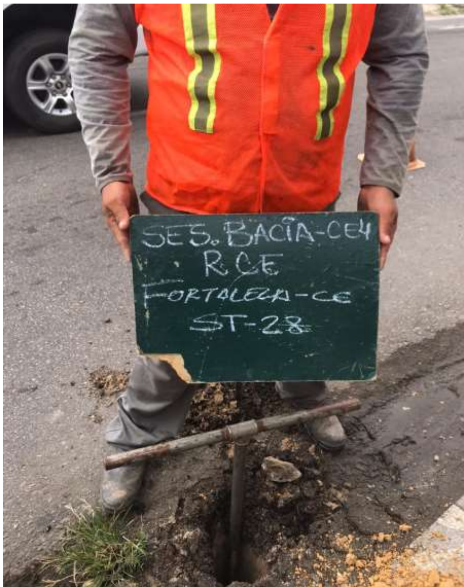
Instalação do furo ST-28
