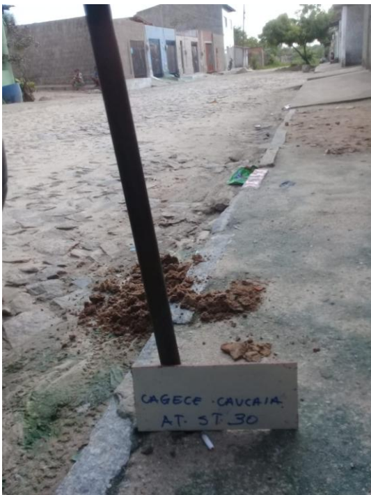
FOTO 03: Detalhe da identificação do furo ST-30 da Sub adutora - AT.
