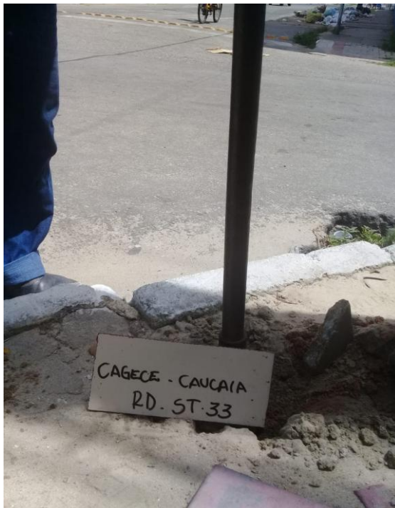
FOTO 17: Detalhe da realização do furo ST-33 do Centro.
