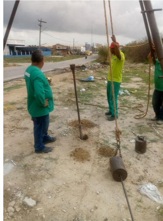
FOTO 02: Detalhe da identificação do furo SP-02 da Travessia.
