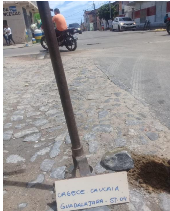
FOTO 10: Detalhe do local onde foi realizado o furo ST-04 do bairro Guadalajara.
