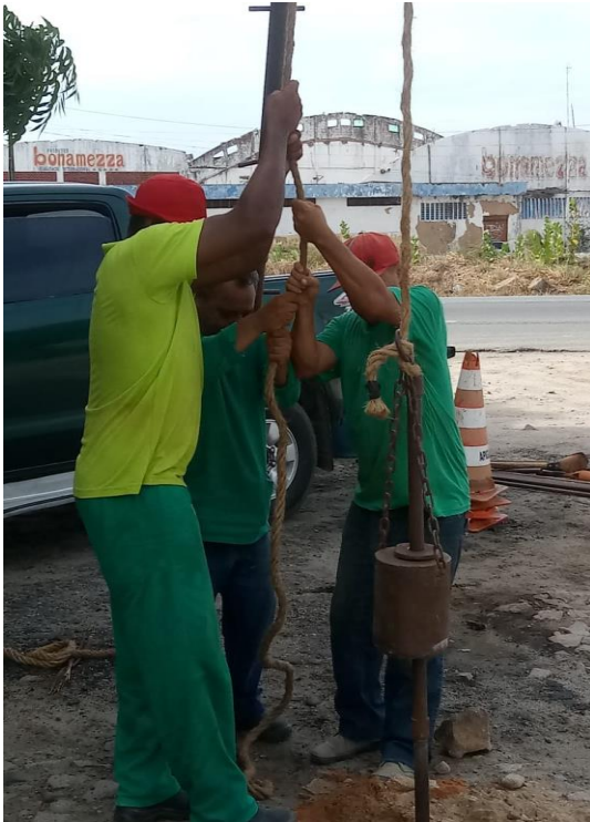
FOTO 25: Detalhe da identificação do furo SP-02 da Travessia.
