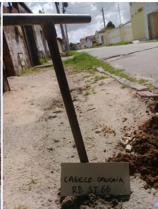
FOTO 20: Detalhe do local onde foi realizado o furo SP-66 do Centro.
