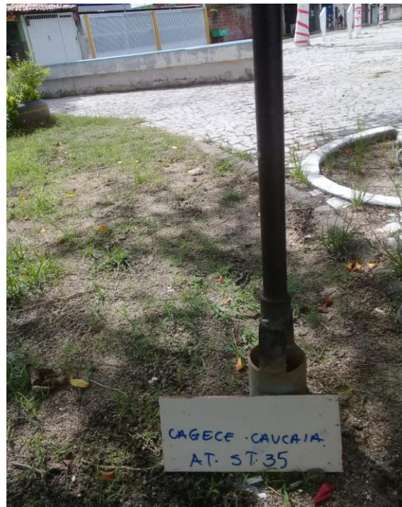
FOTO 04: Detalhe da identificação do furo ST-35 da Sub adutora - AT.
