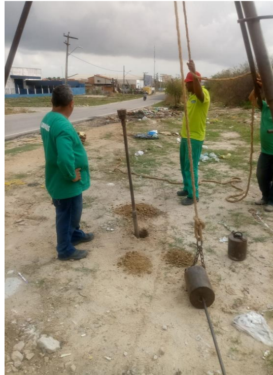
FOTO 26: Detalhe da identificação do furo SP-02 da Travessia.
