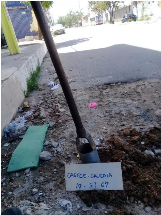
FOTO 01: Detalhe da identificação do furo ST-07 da Sub adutora - AT.
