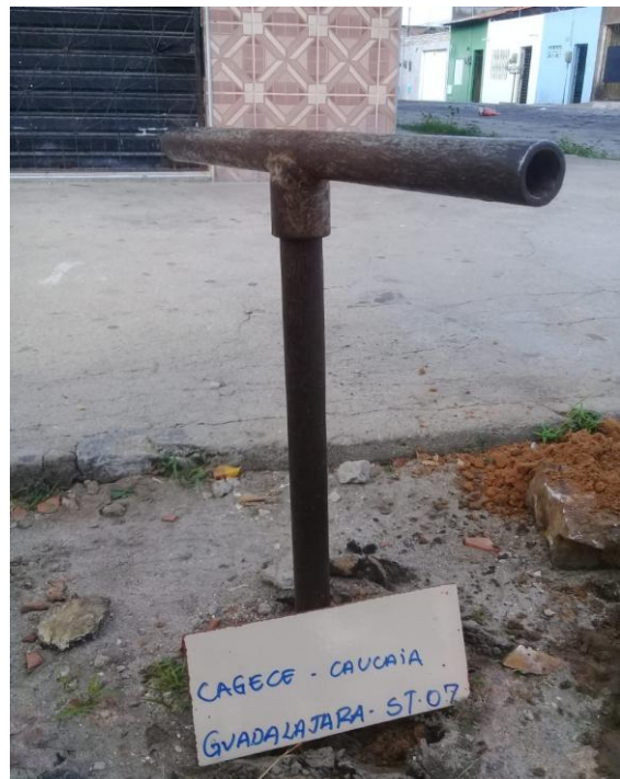
FOTO 12: Detalhe da realização do furo ST-07 do bairro Guadalajara.
