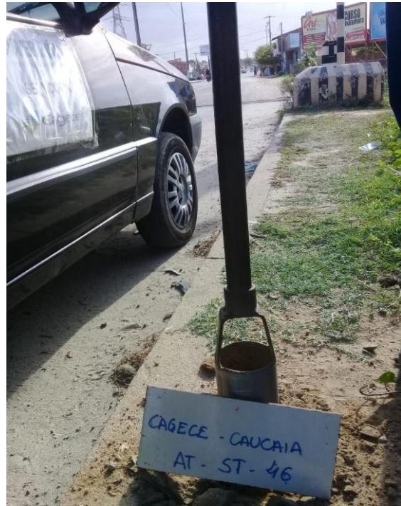
FOTO 06: Detalhe da identificação do furo ST-46 da Sub adutora - AT.
