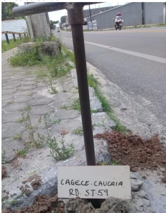
FOTO 19: Detalhe do local onde foi realizado o furo ST-59 do Centro.
