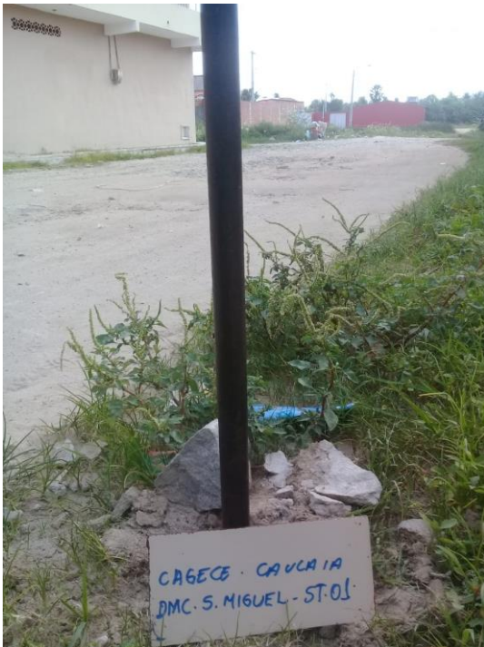
FOTO 07: Detalhe da realização do furo ST-01 do bairro São Miguel.
