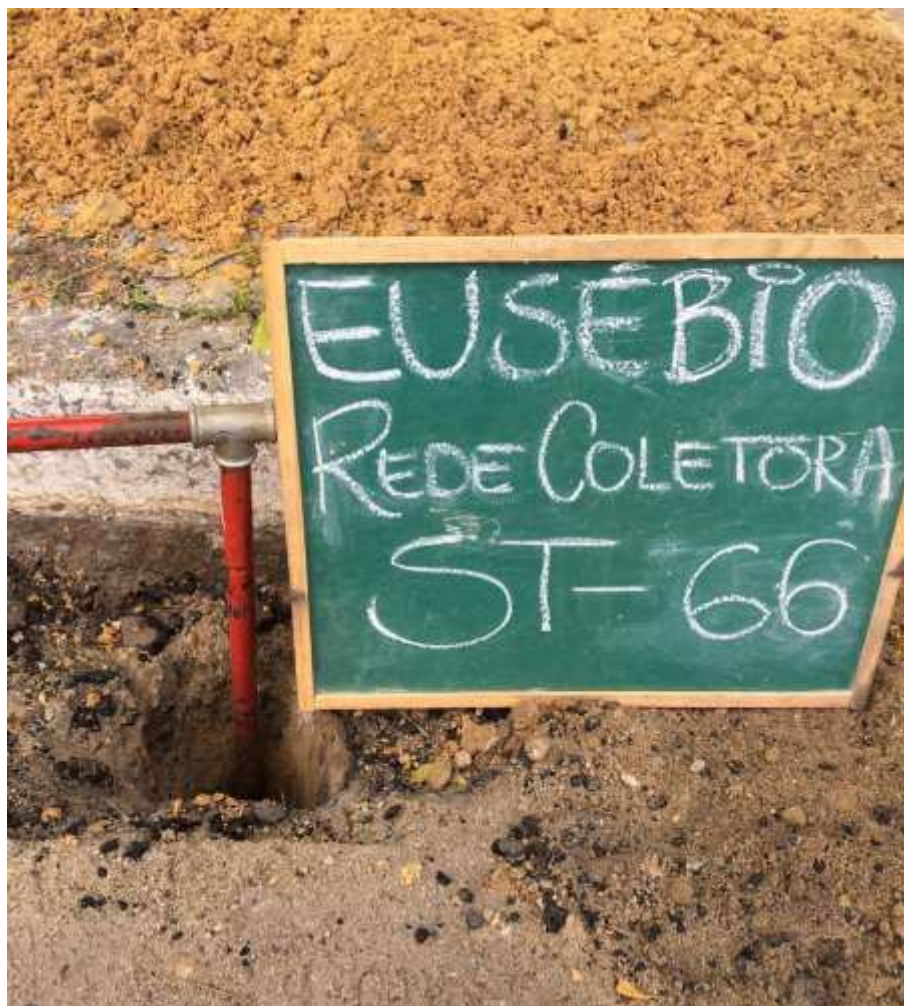
Instalação do furo ST-66
