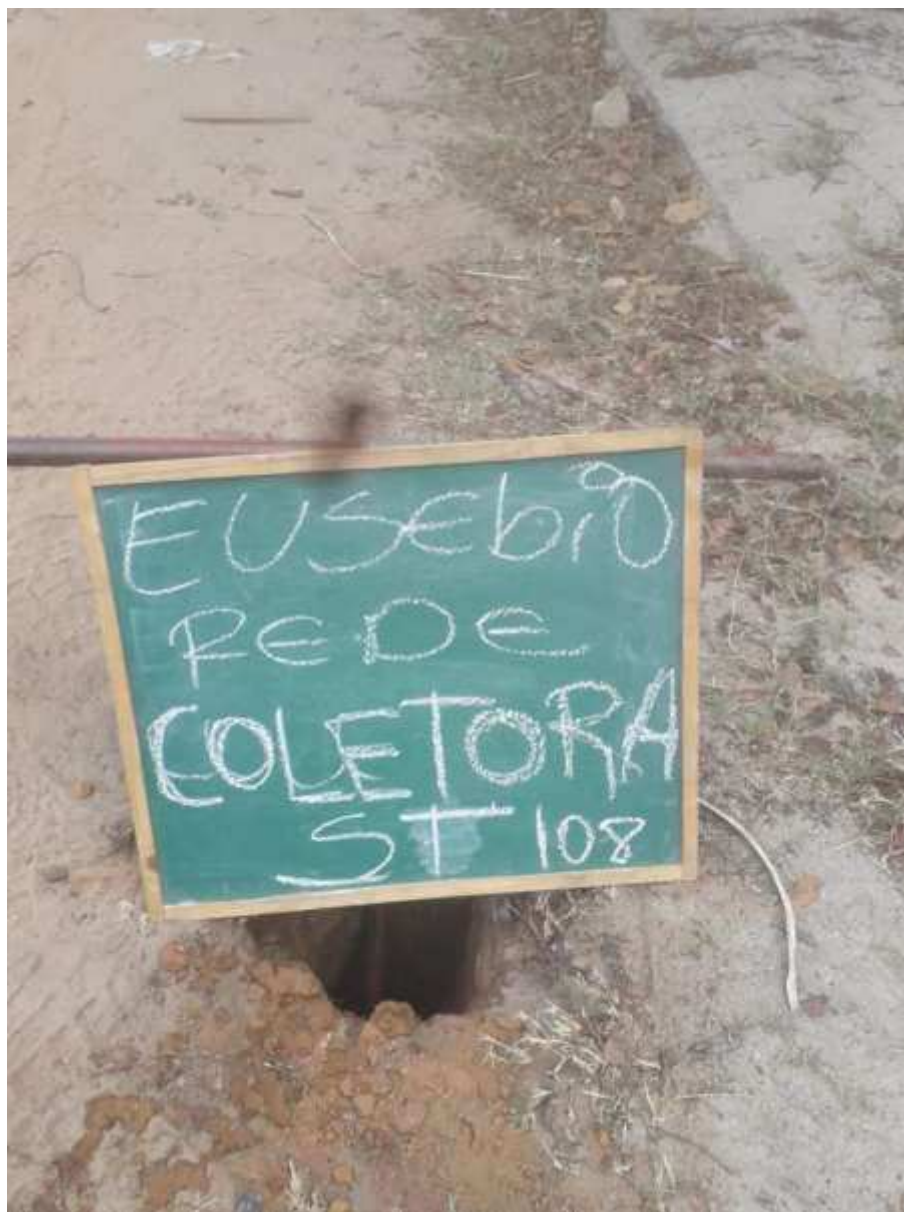
Instalação do furo ST-108
