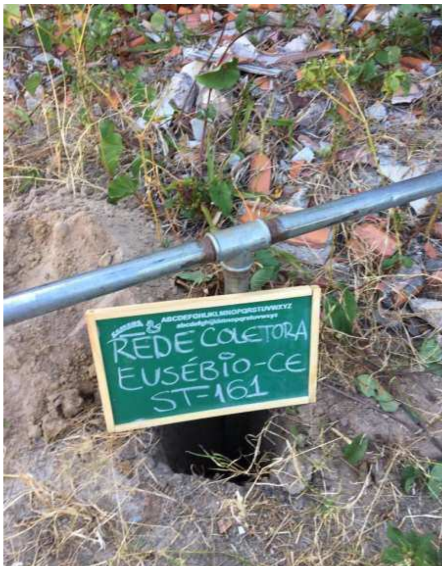
Instalação do furo ST-161
