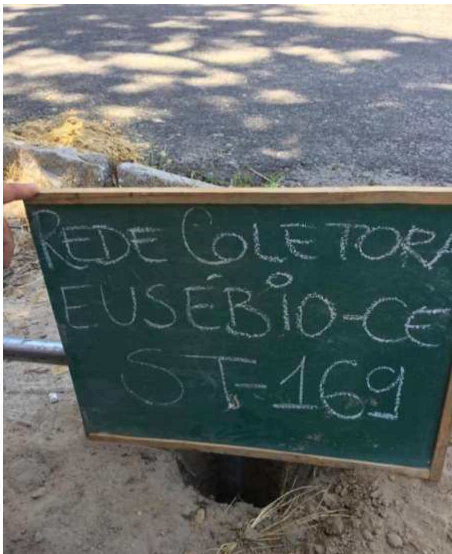
Instalação do furo ST-169
