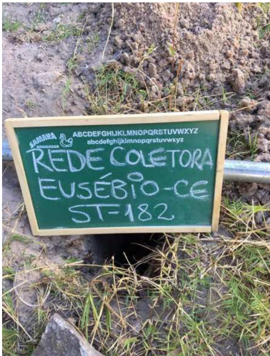
Instalação do furo ST-182
