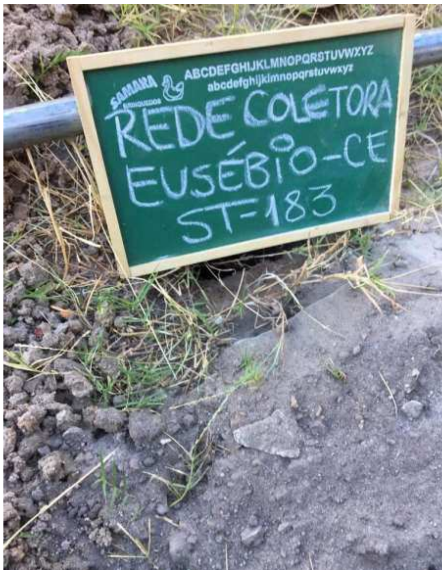
Instalação do furo ST-183
