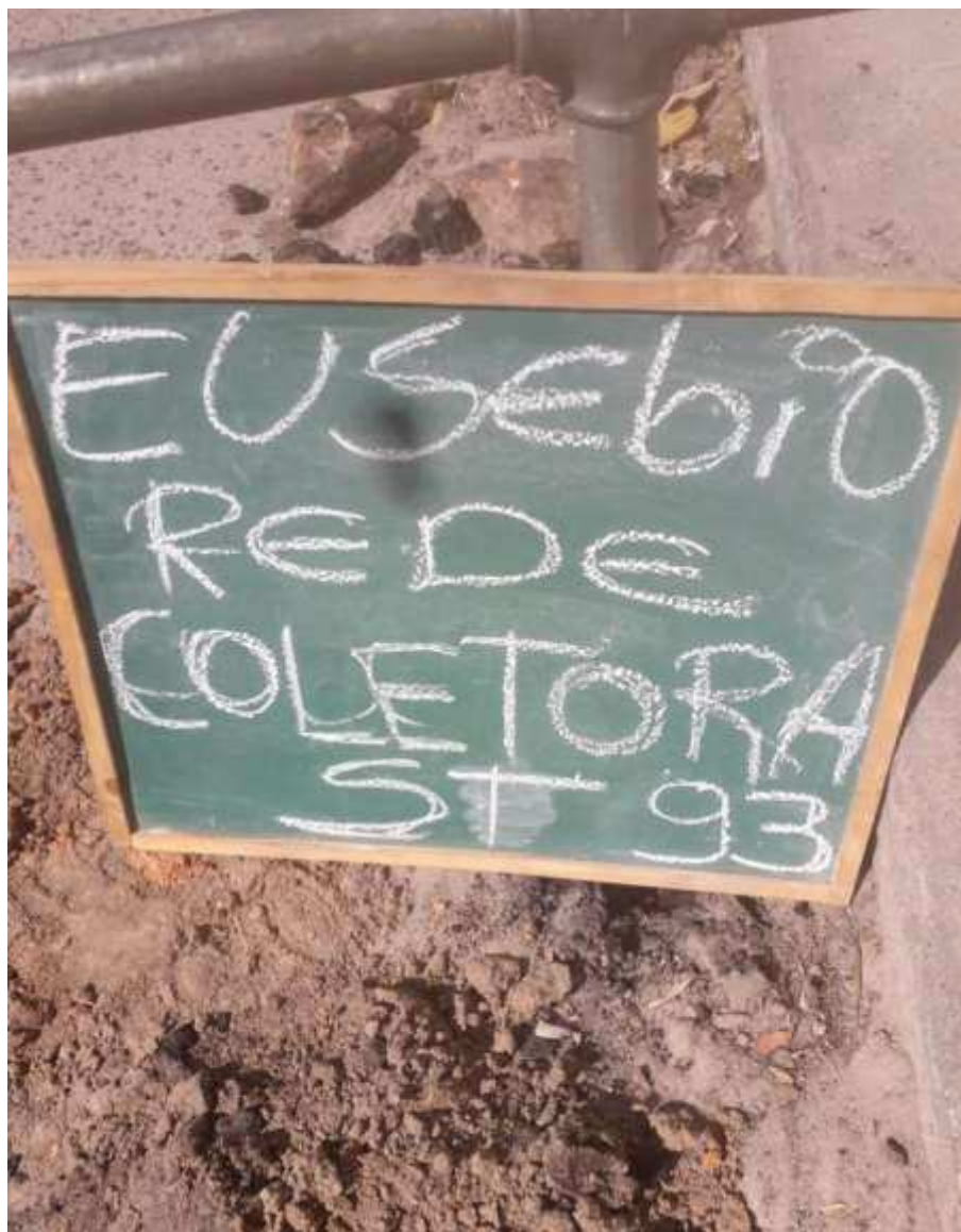
Instalação do furo ST-93
