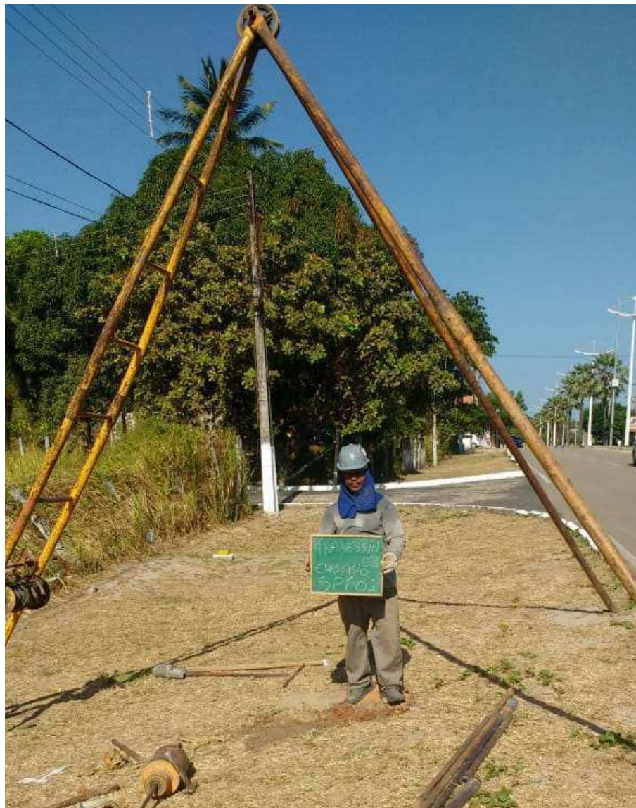
Instalação do furo SP-01
