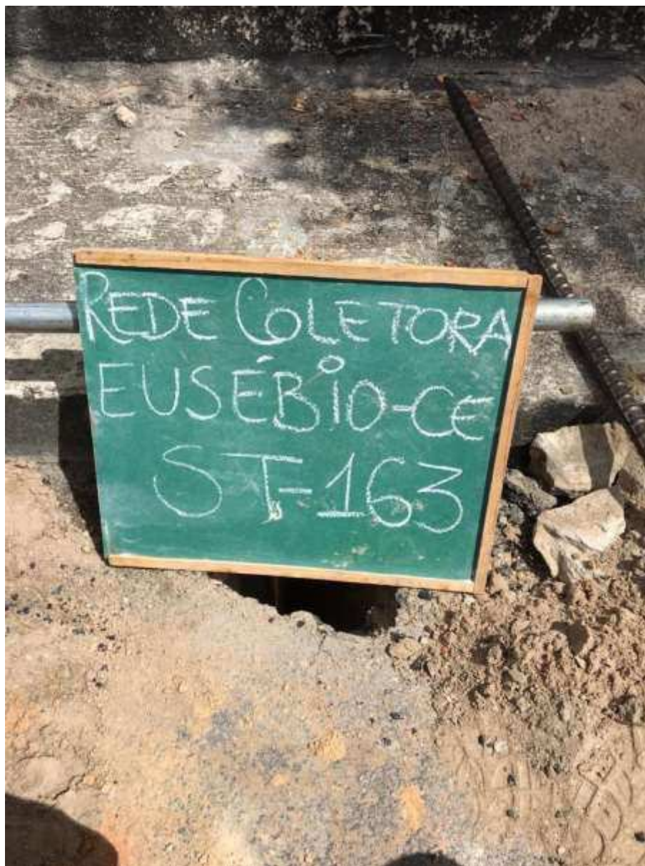
Instalação do furo ST-163
