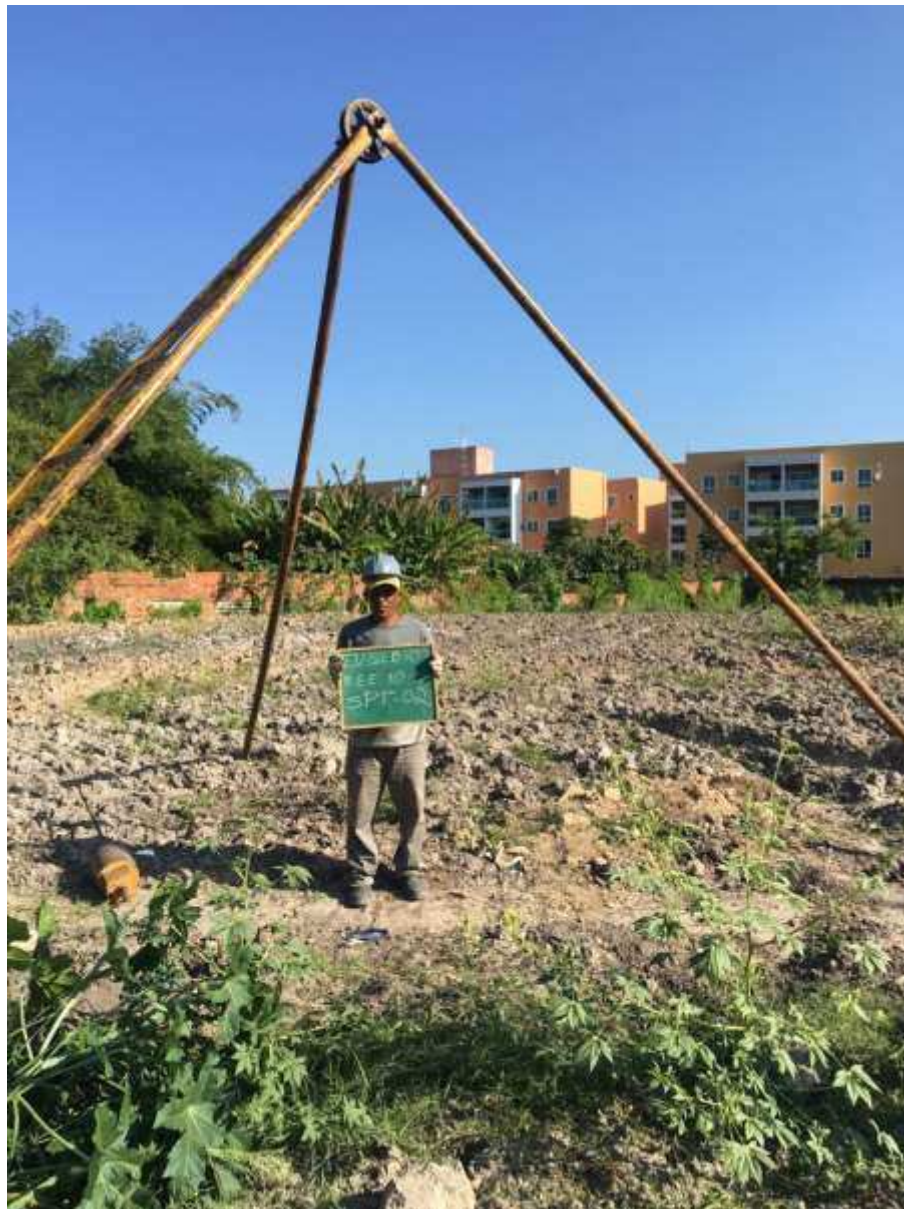
Instalação do furo SP-02
