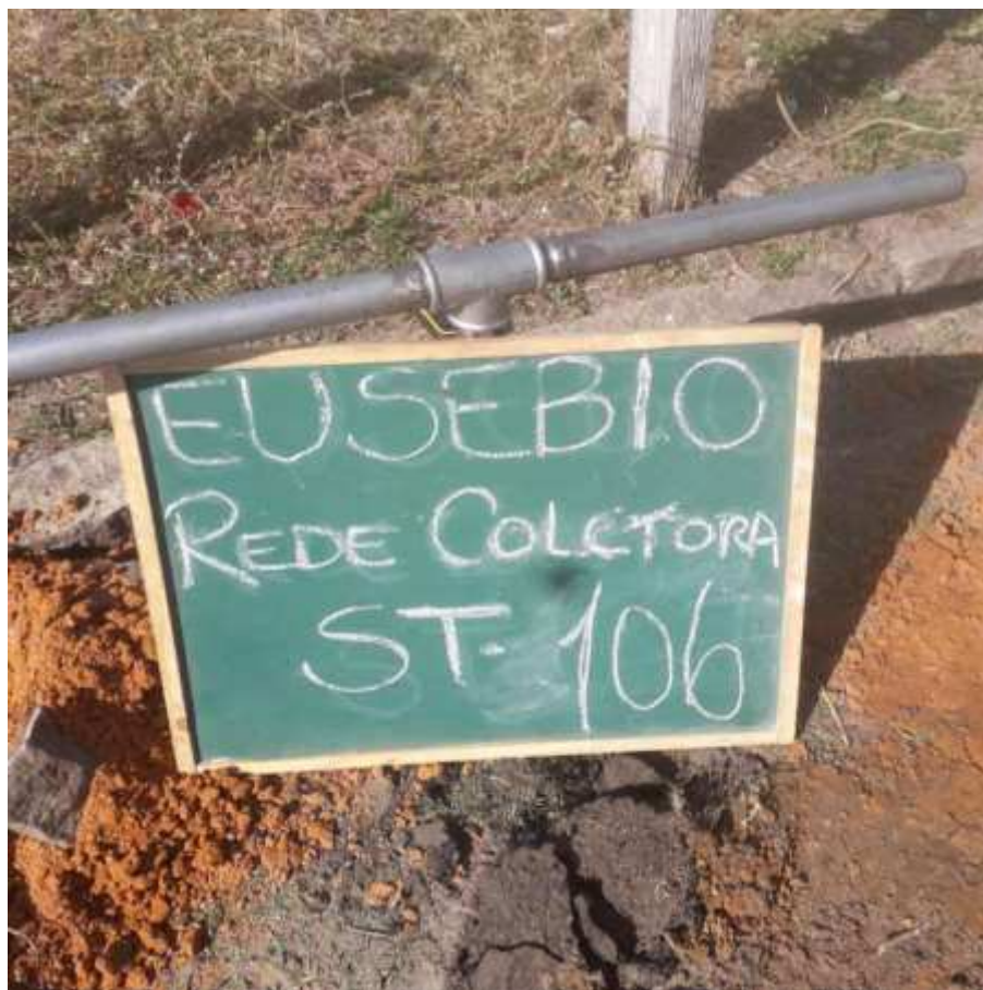
Instalação do furo ST-106
