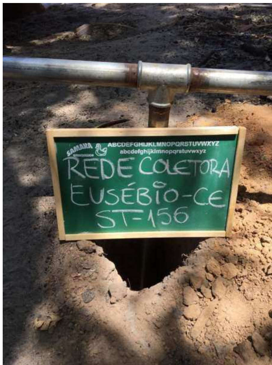
Instalação do furo ST-156
