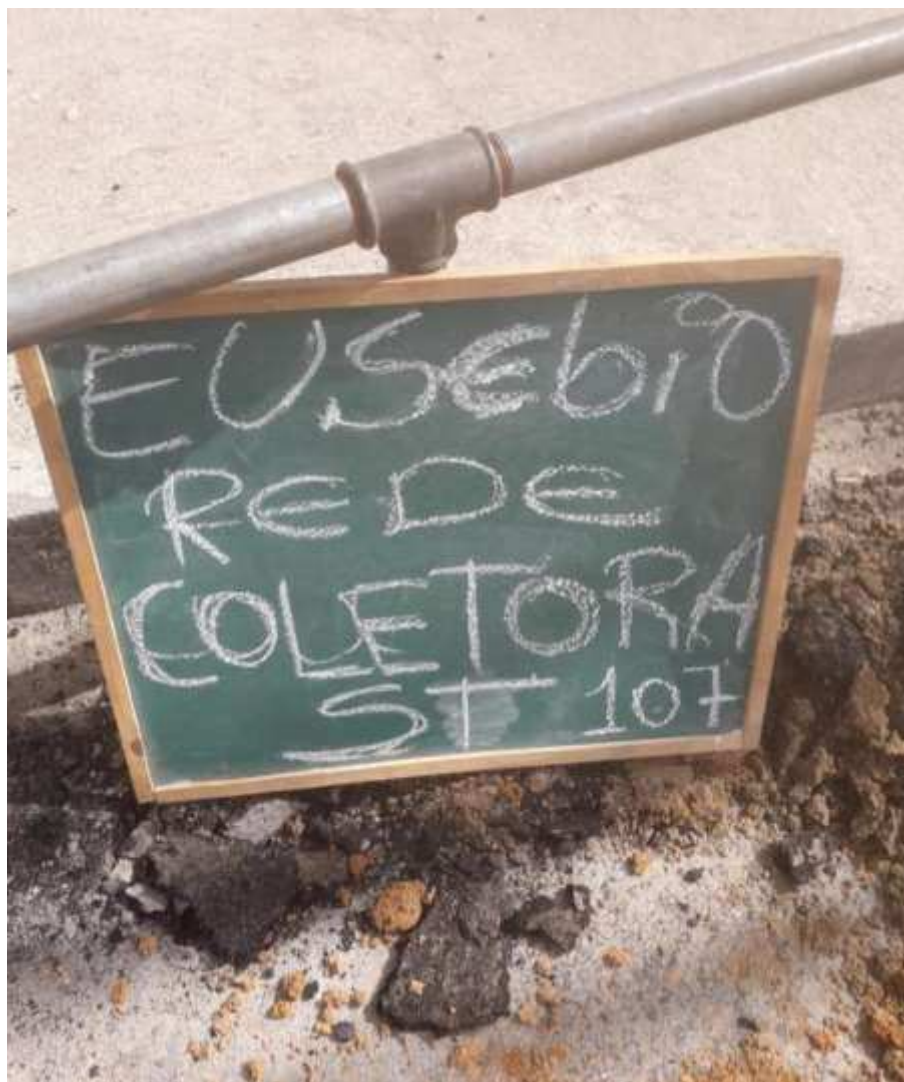
Instalação do furo ST-107
