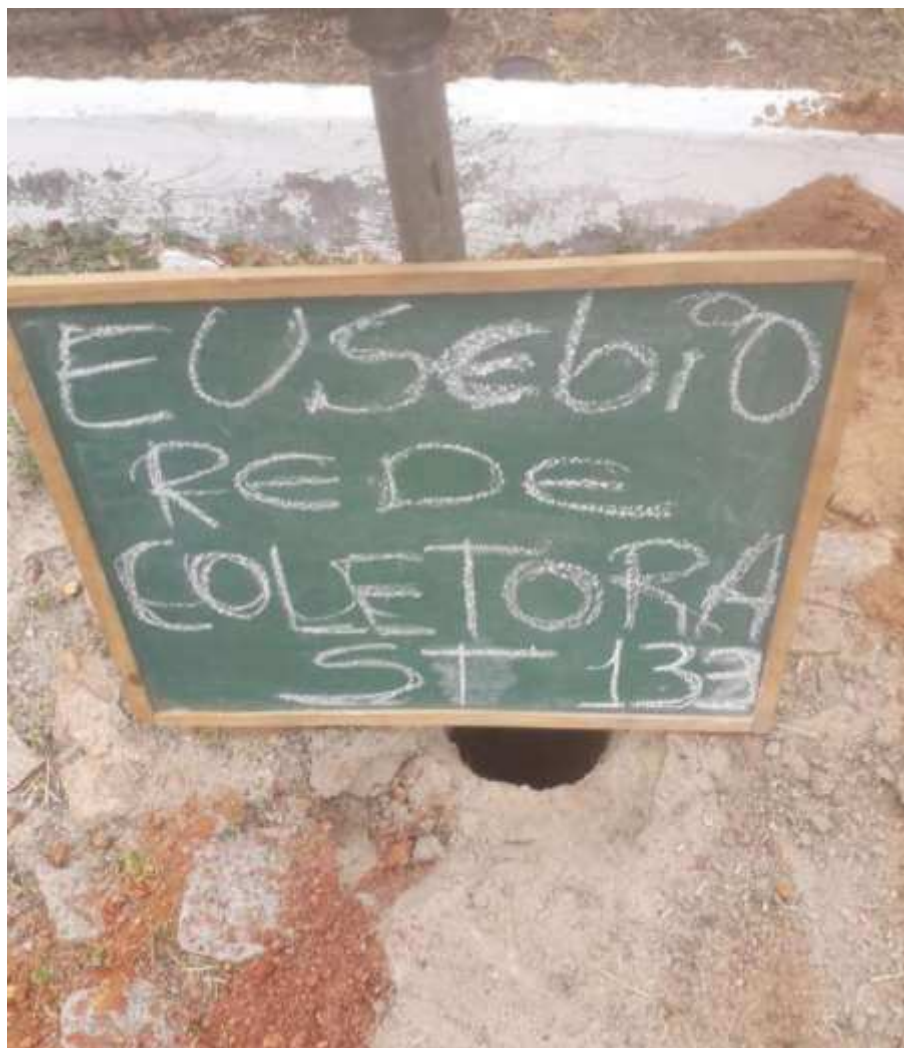
Instalação do furo ST-133
