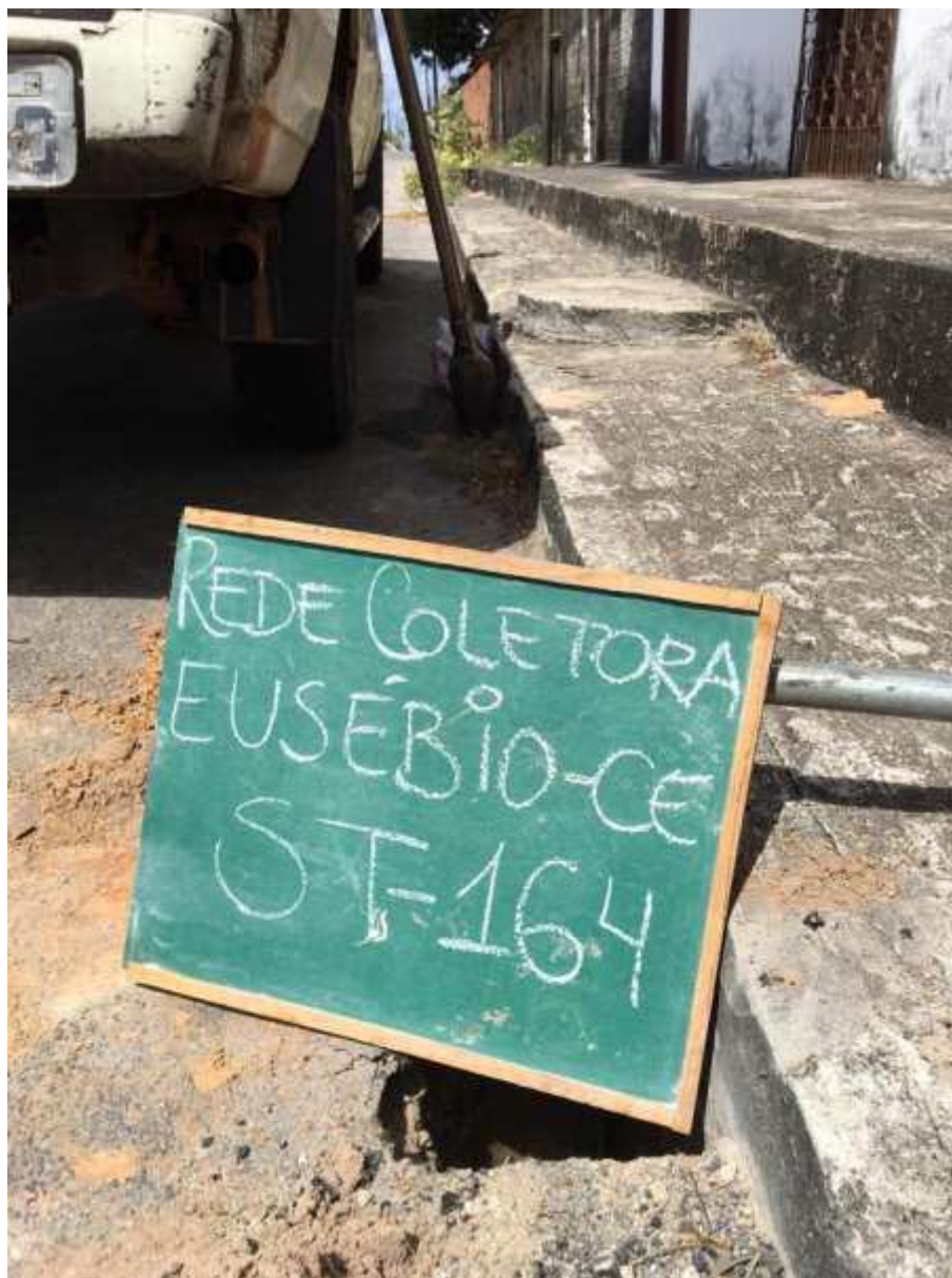
Instalação do furo ST-164
