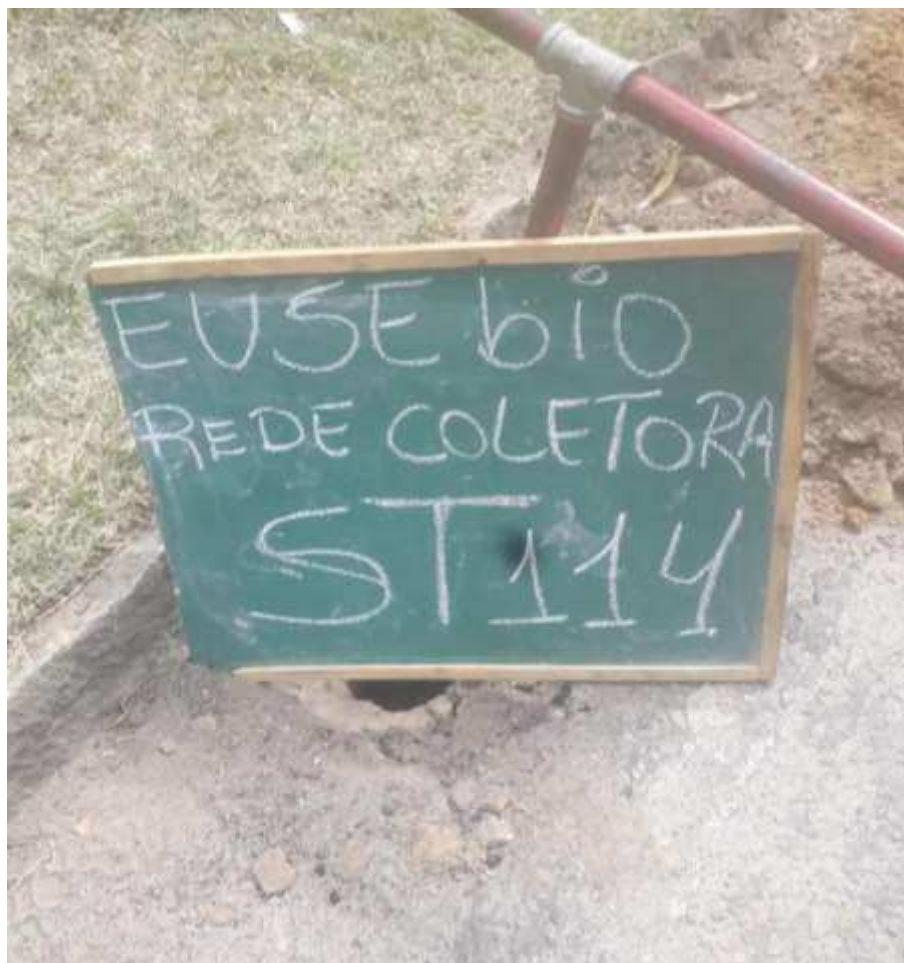
Instalação do furo ST-114
