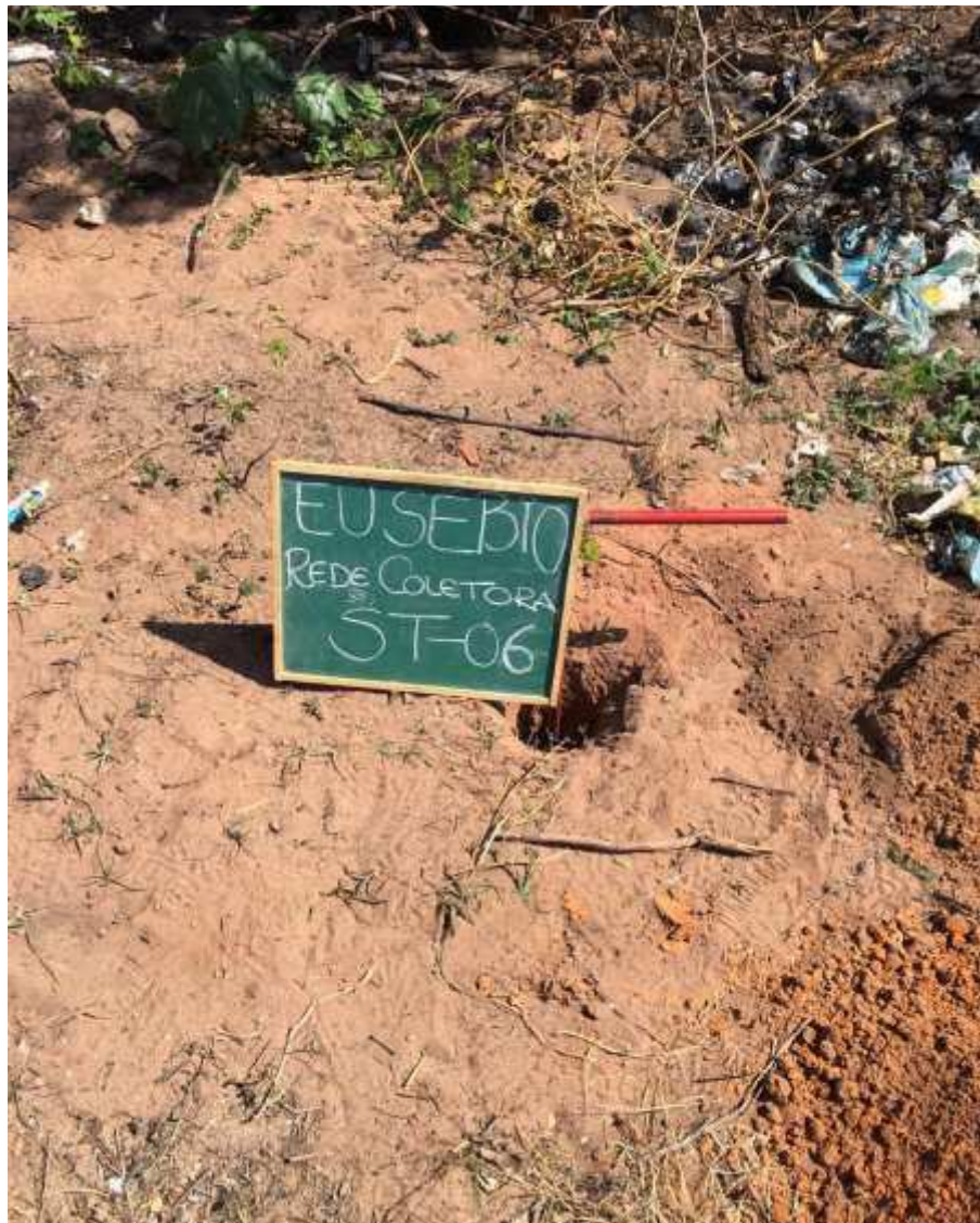
Instalação do furo ST-06
