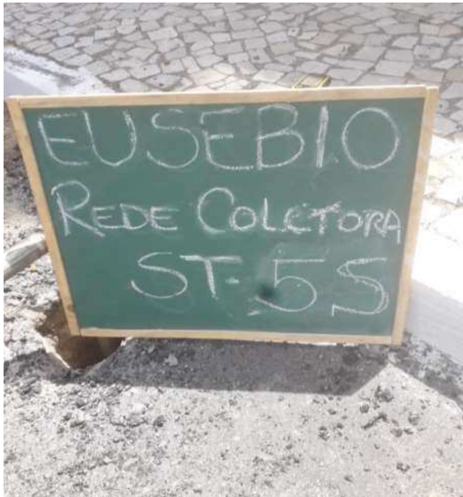
Instalação do furo ST-55
