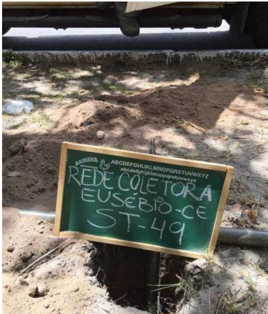
Instalação do furo ST-49
