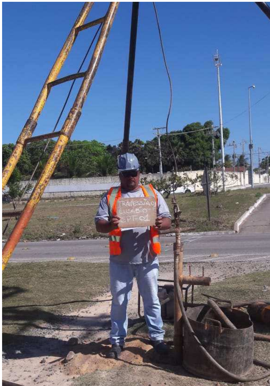
Instalação do furo SP-01
