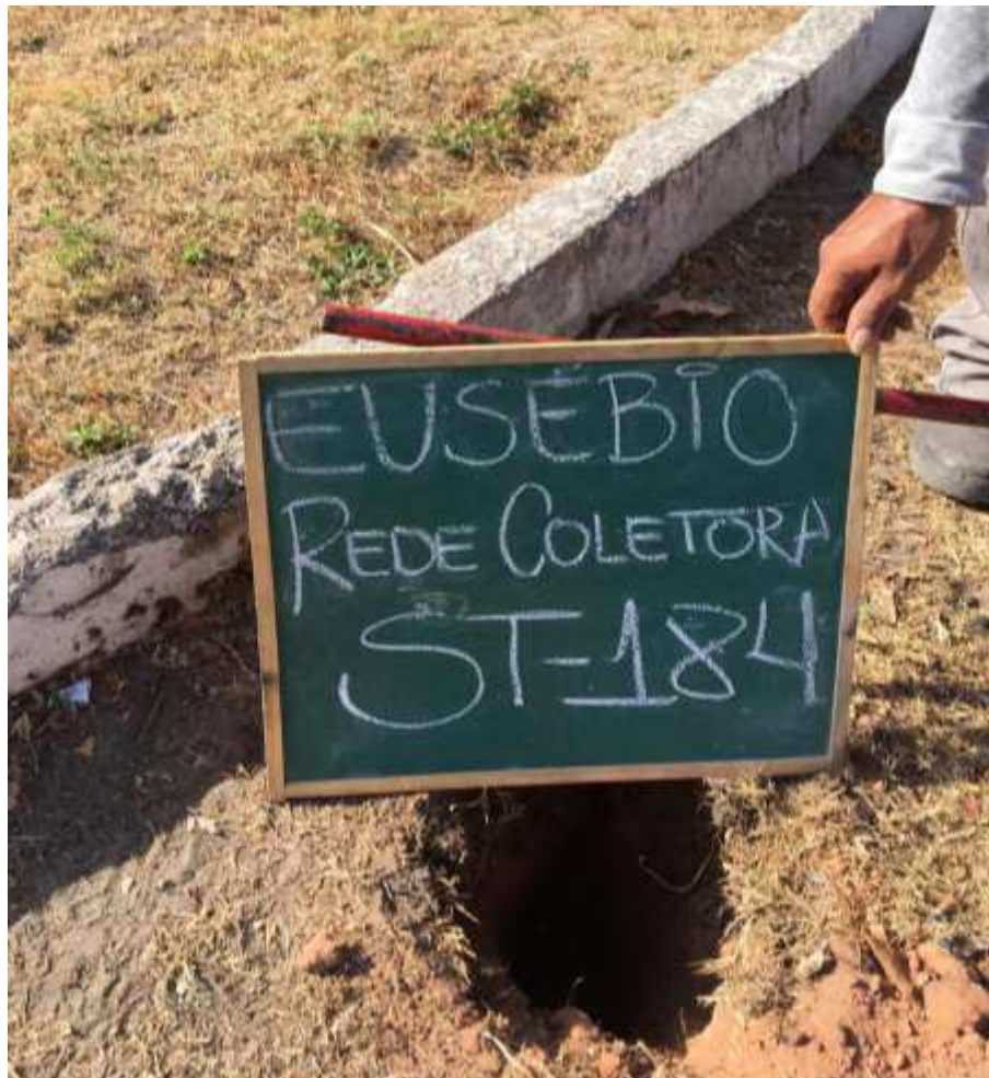
Instalação do furo ST-184
