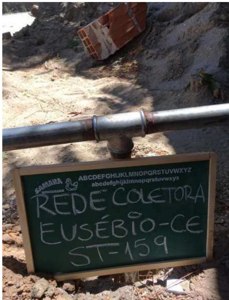
Instalação do furo ST-159
