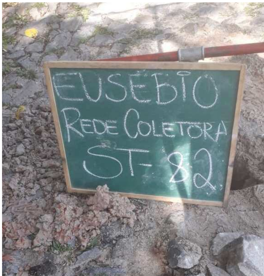
Instalação do furo ST-82
