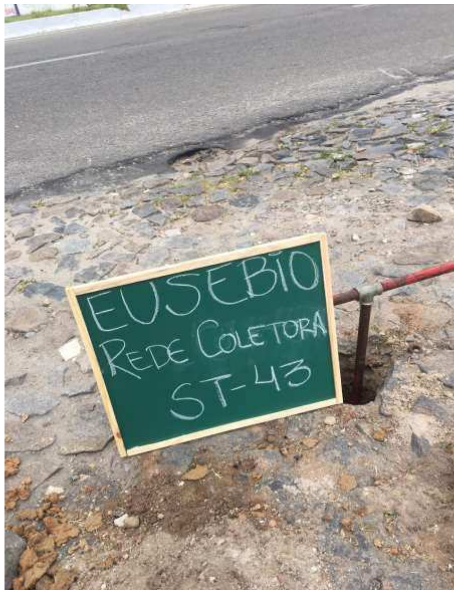
Instalação do furo ST-43
