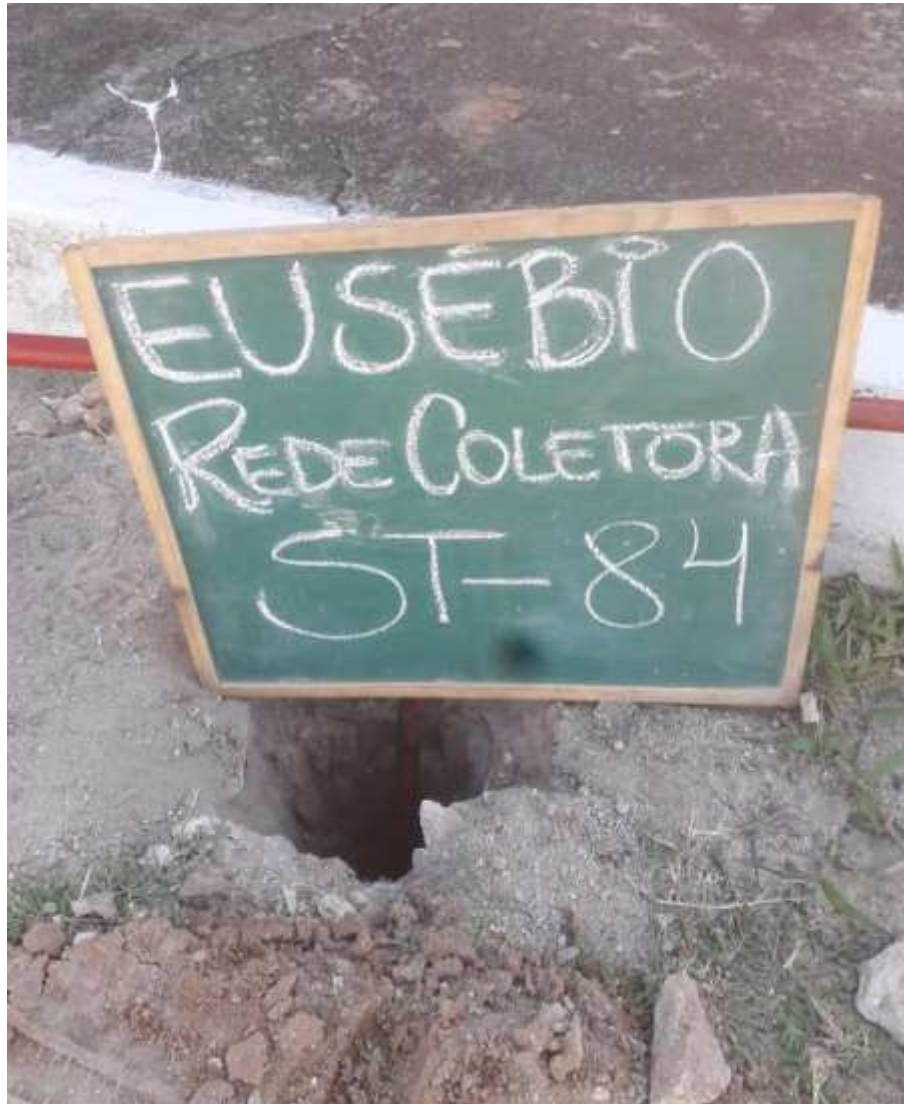
Instalação do furo ST-84
