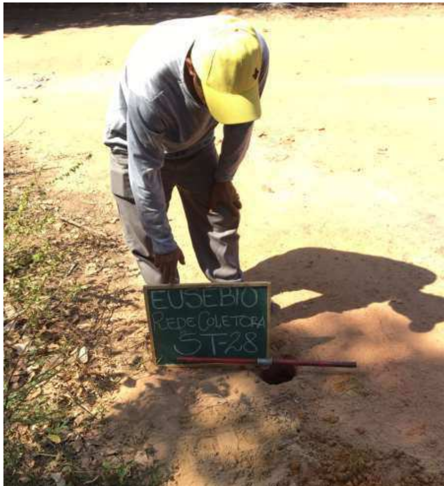
Instalação do furo ST-28
