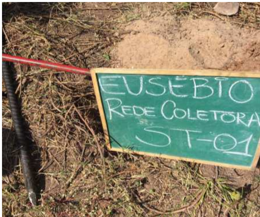
Instalação do furo ST-01
