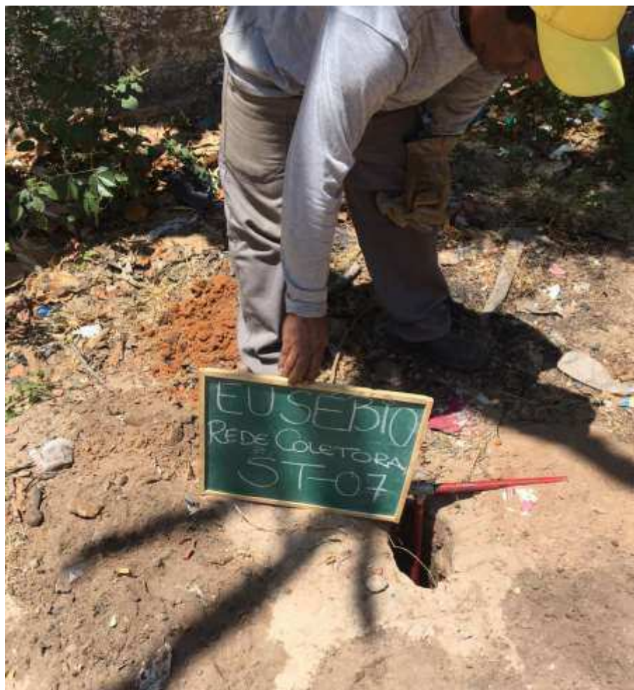
Instalação do furo ST-07
