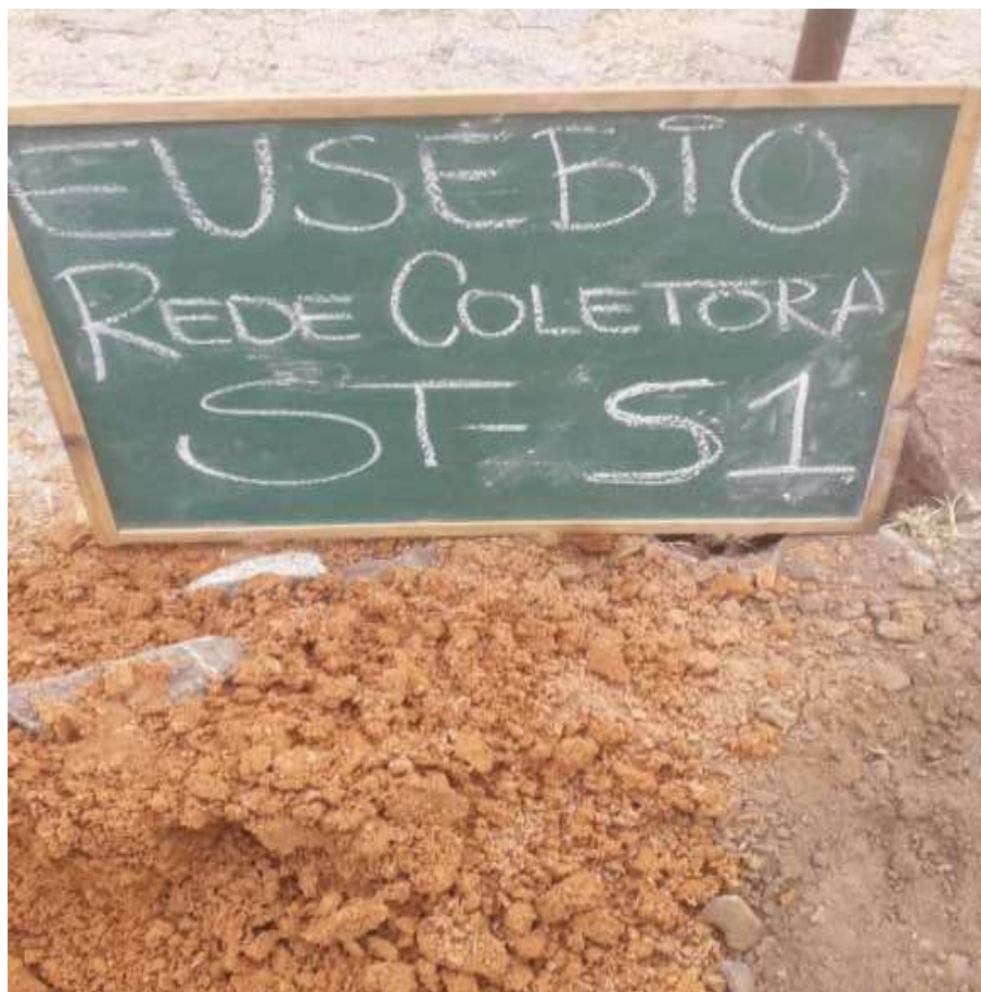
Instalação do furo ST-51
