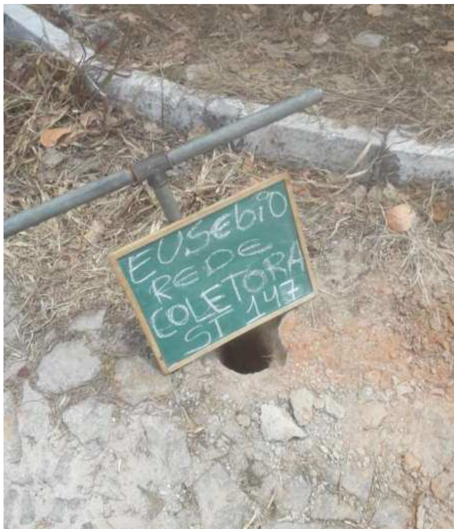
Instalação do furo ST-147
