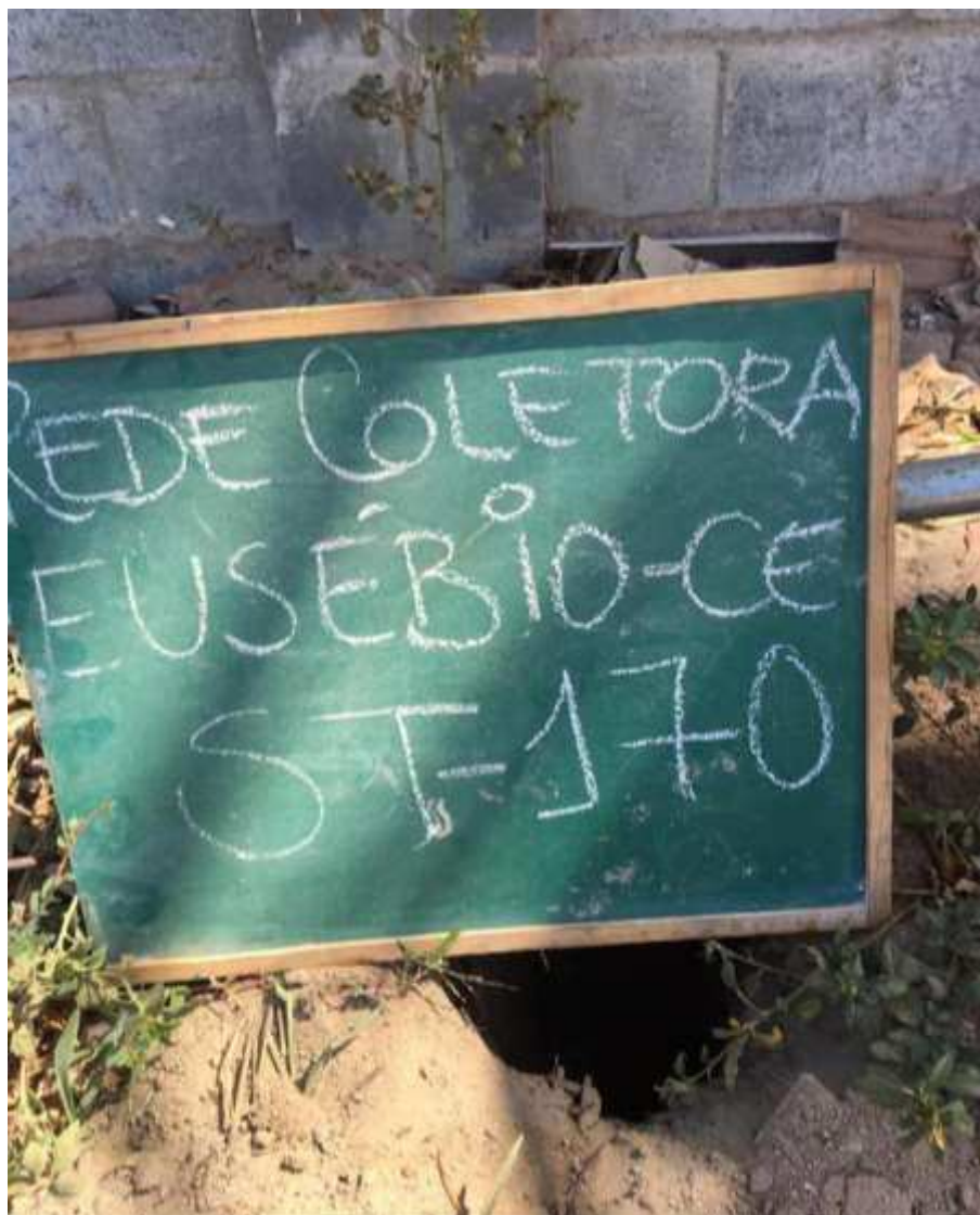
Instalação do furo ST-170
