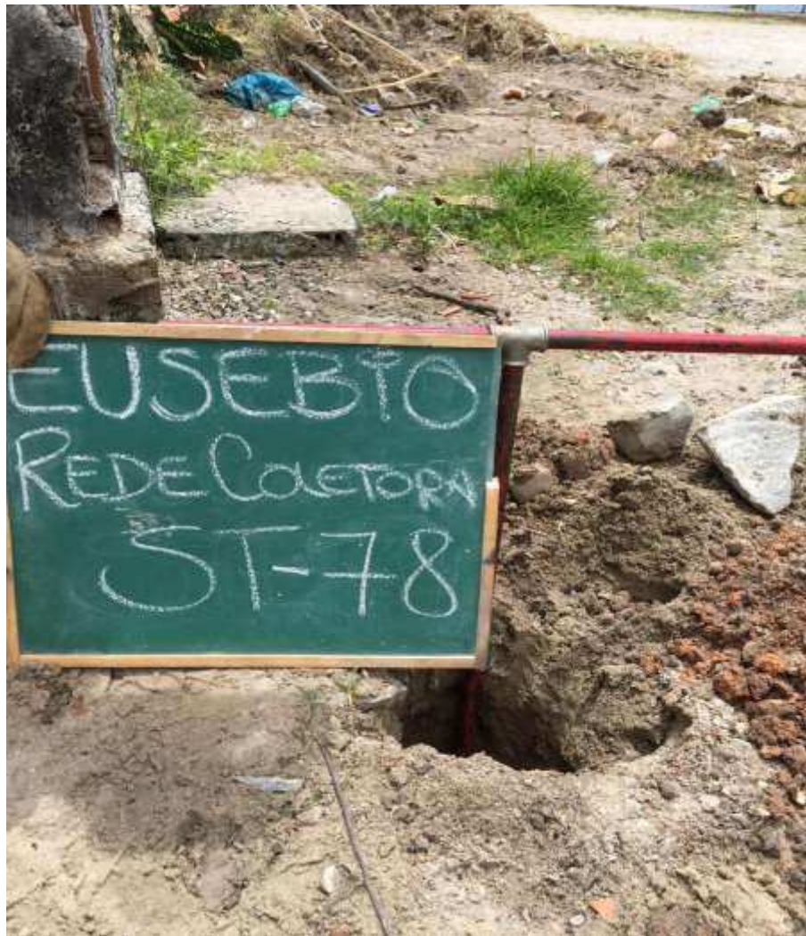
Instalação do furo ST-78
