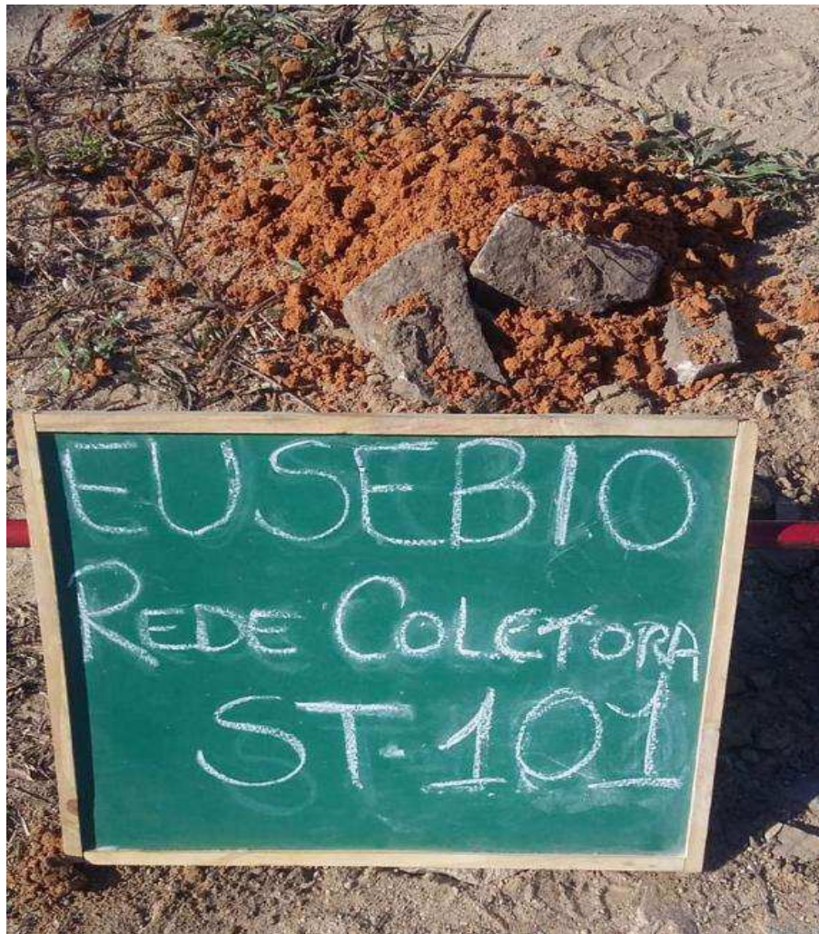
Instalação do furo ST-101
