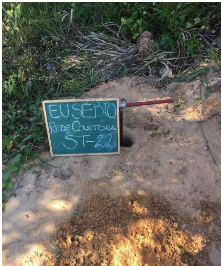
Instalação do furo ST-22
