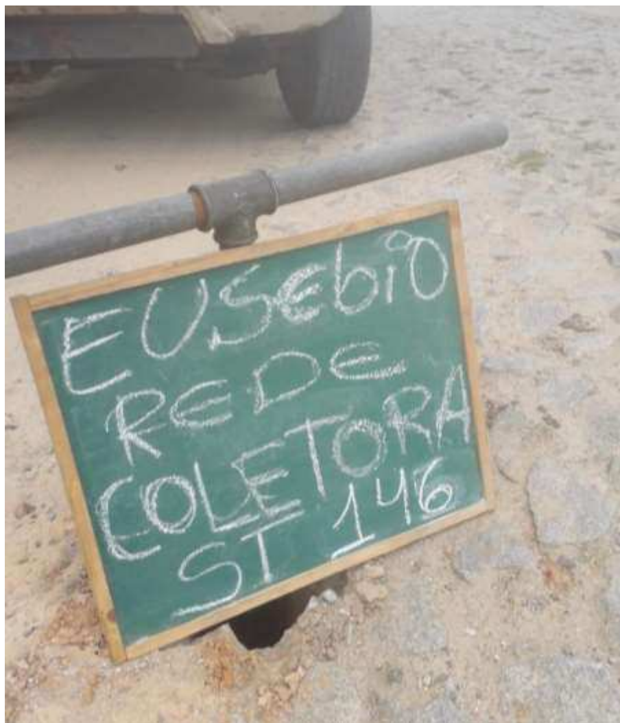
Instalação do furo ST-146
