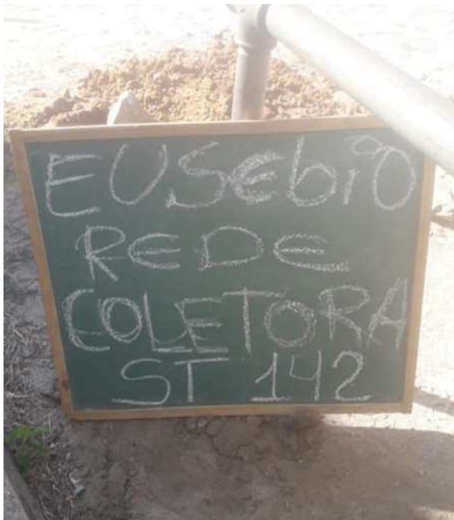
Instalação do furo ST-142
