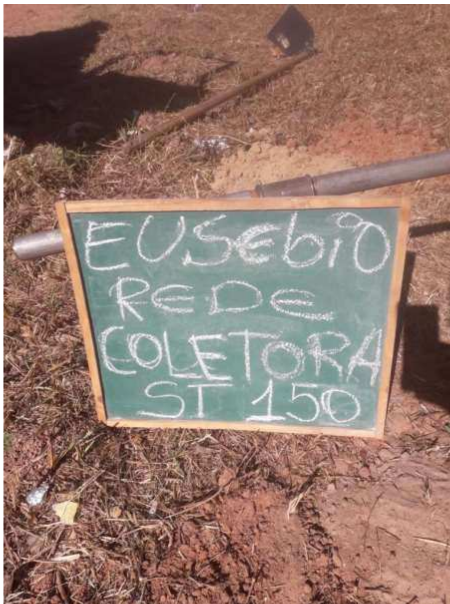
Instalação do furo ST-150
