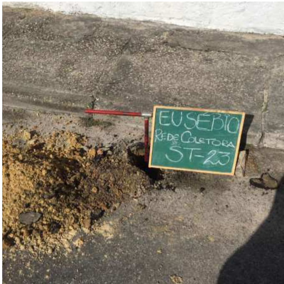
Instalação do furo ST-23
