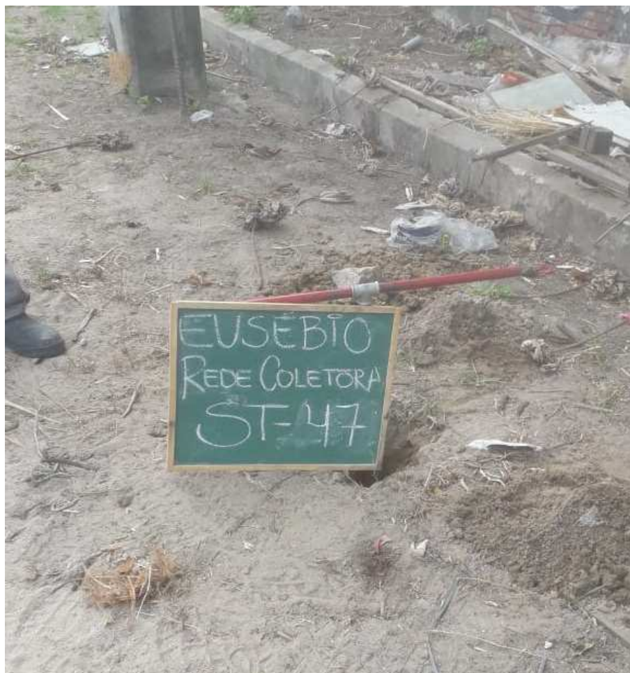
Instalação do furo ST-47
