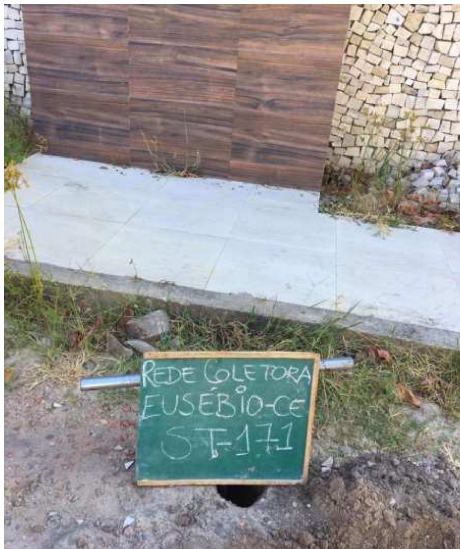
Instalação do furo ST-171
