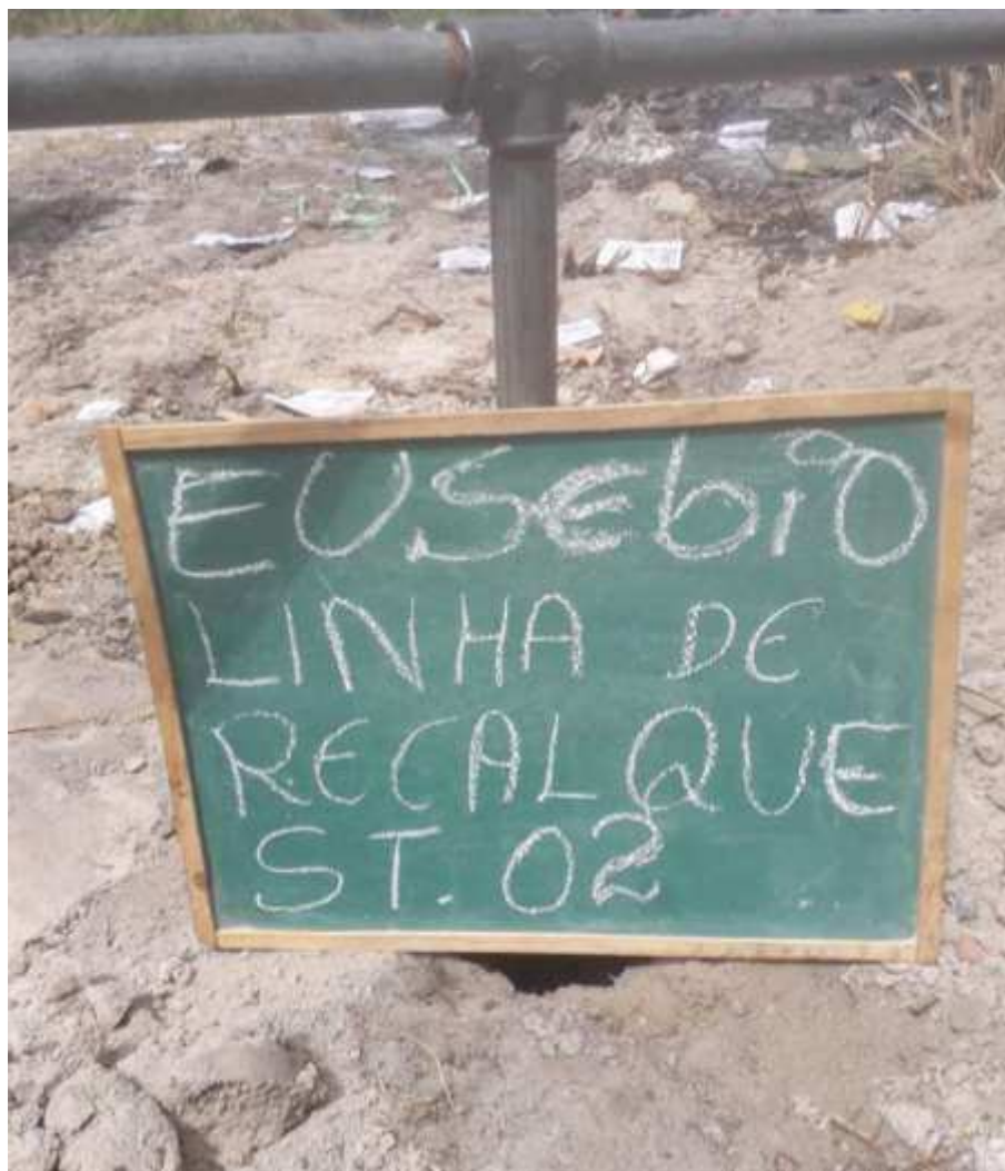
Instalação do furo ST-02
