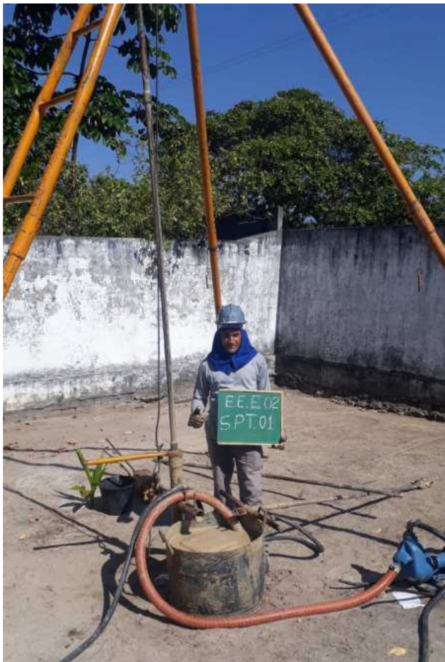
Instalação do furo SP-01
