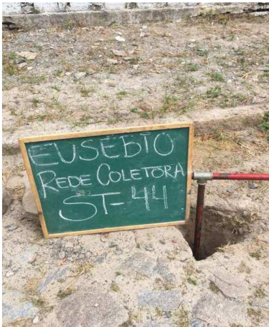
Instalação do furo ST-44
