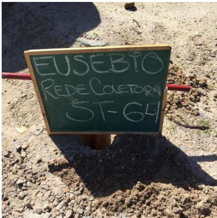
Instalação do furo ST-64
