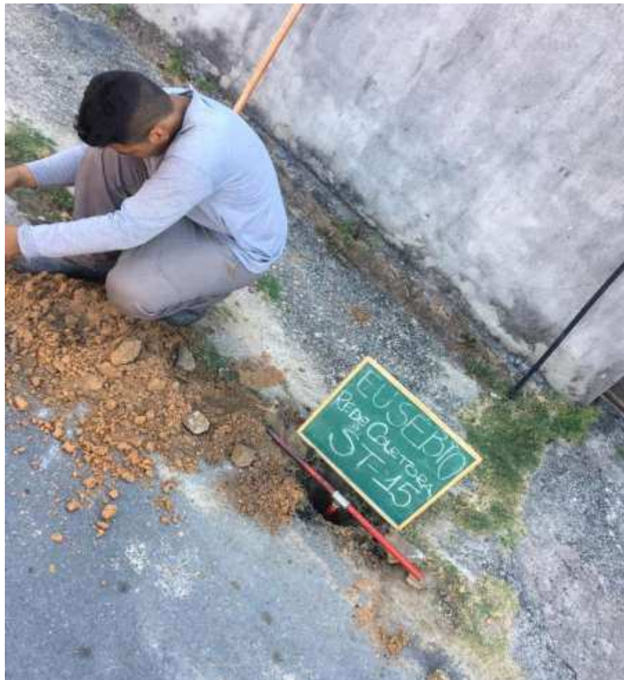
Instalação do furo ST-15
