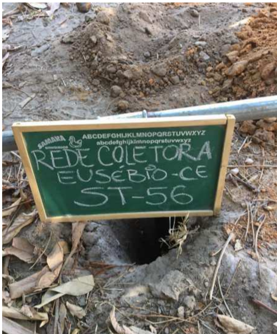
Instalação do furo ST-56
