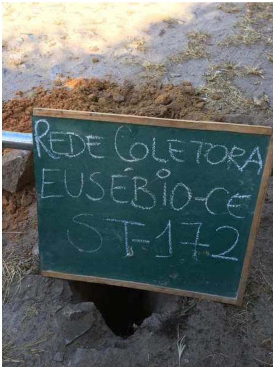
Instalação do furo ST-172
