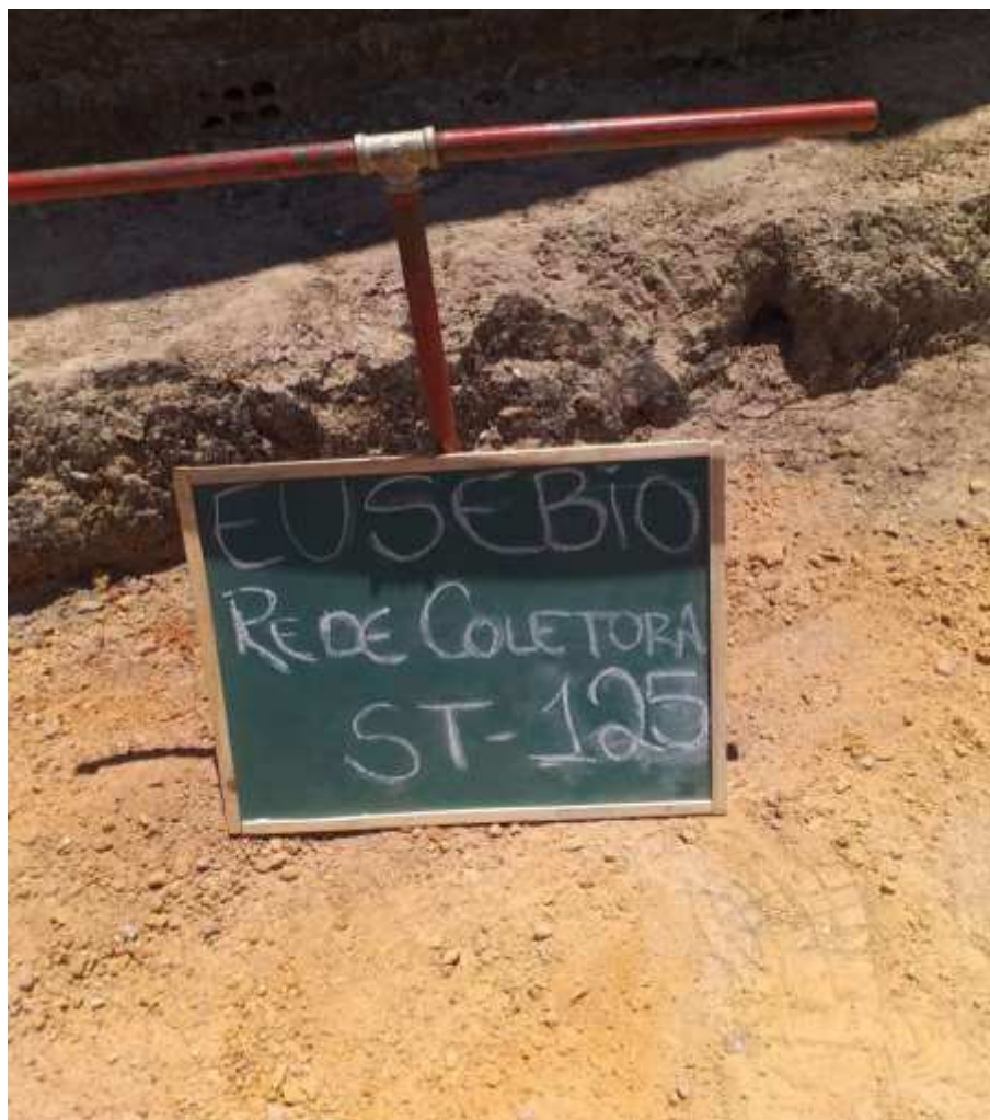
Instalação do furo ST-125
