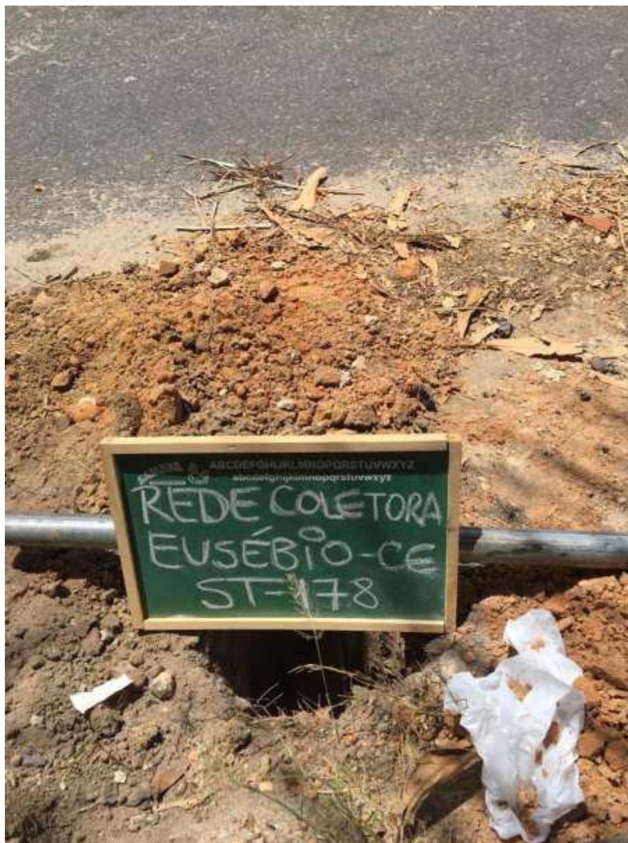
Instalação do furo ST-178
