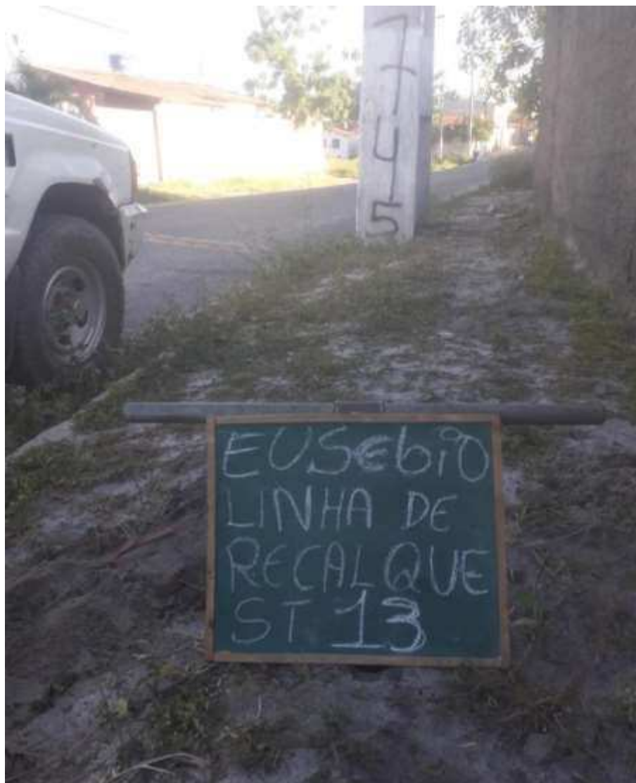
Instalação do furo ST-13
