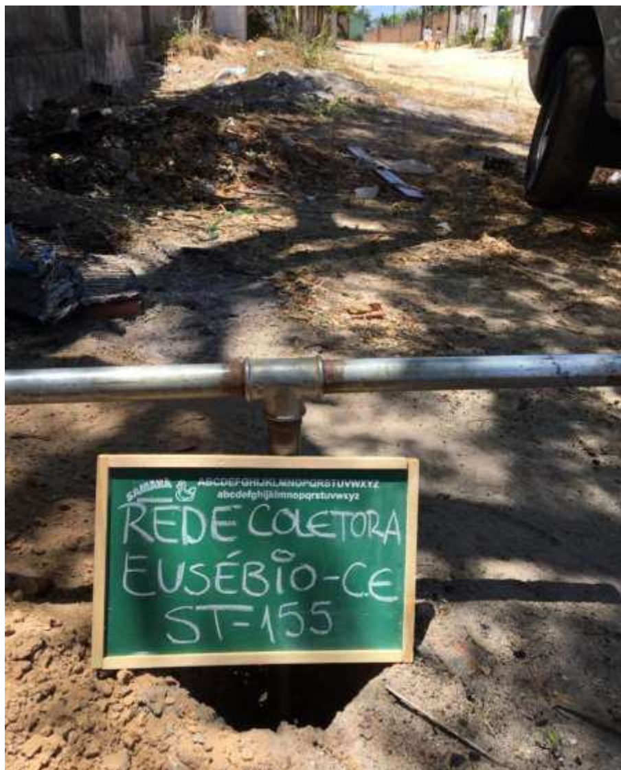
Instalação do furo ST-155
