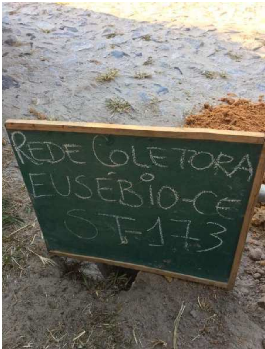
Instalação do furo ST-173
