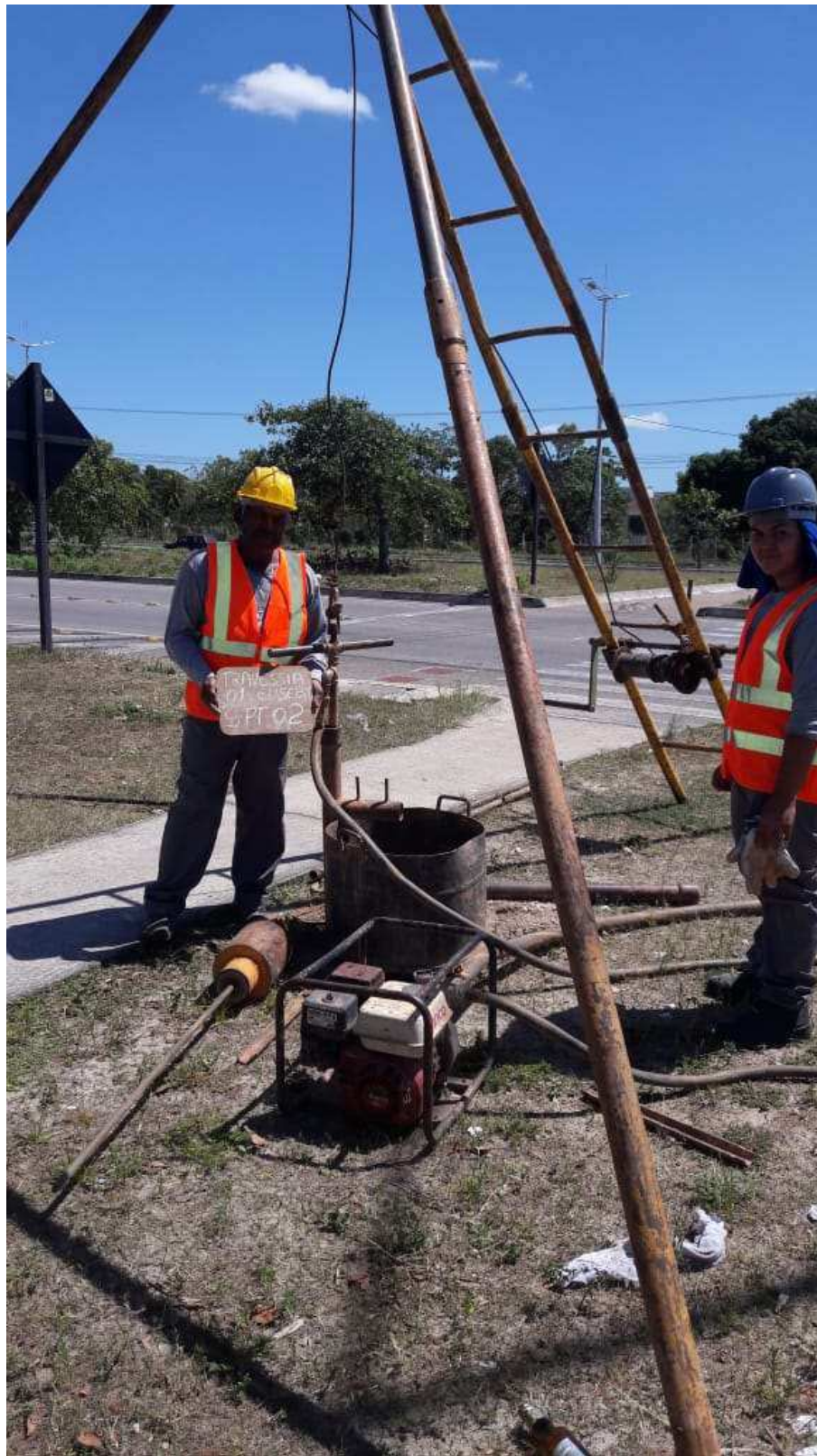
Instalação do furo SP-02
