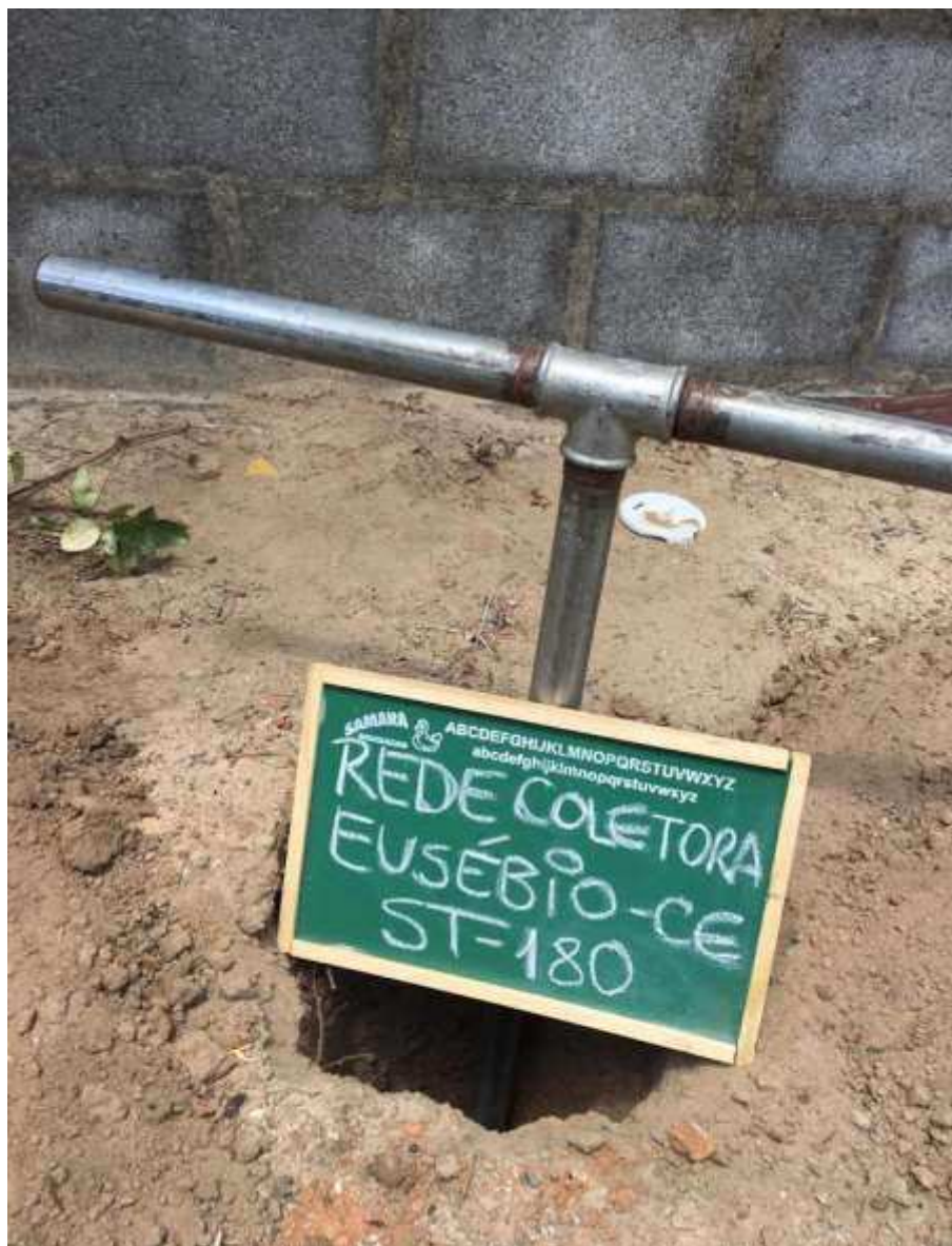
Instalação do furo ST-180
