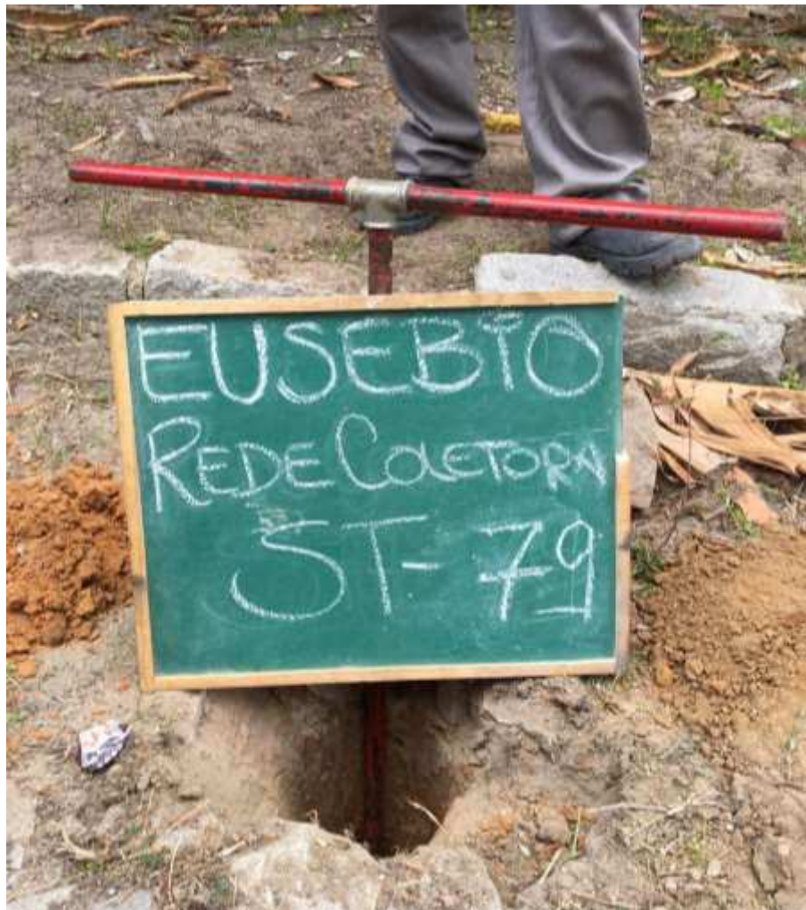
Instalação do furo ST-79
