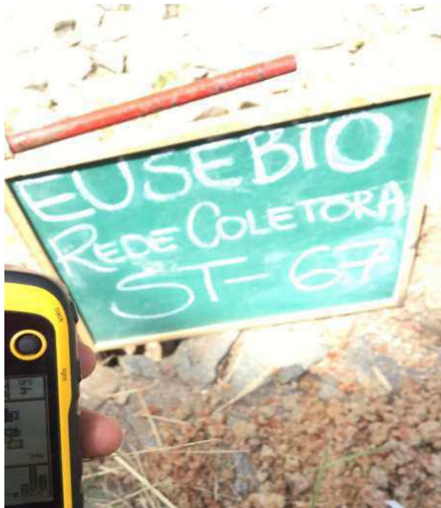
Instalação do furo ST-67
