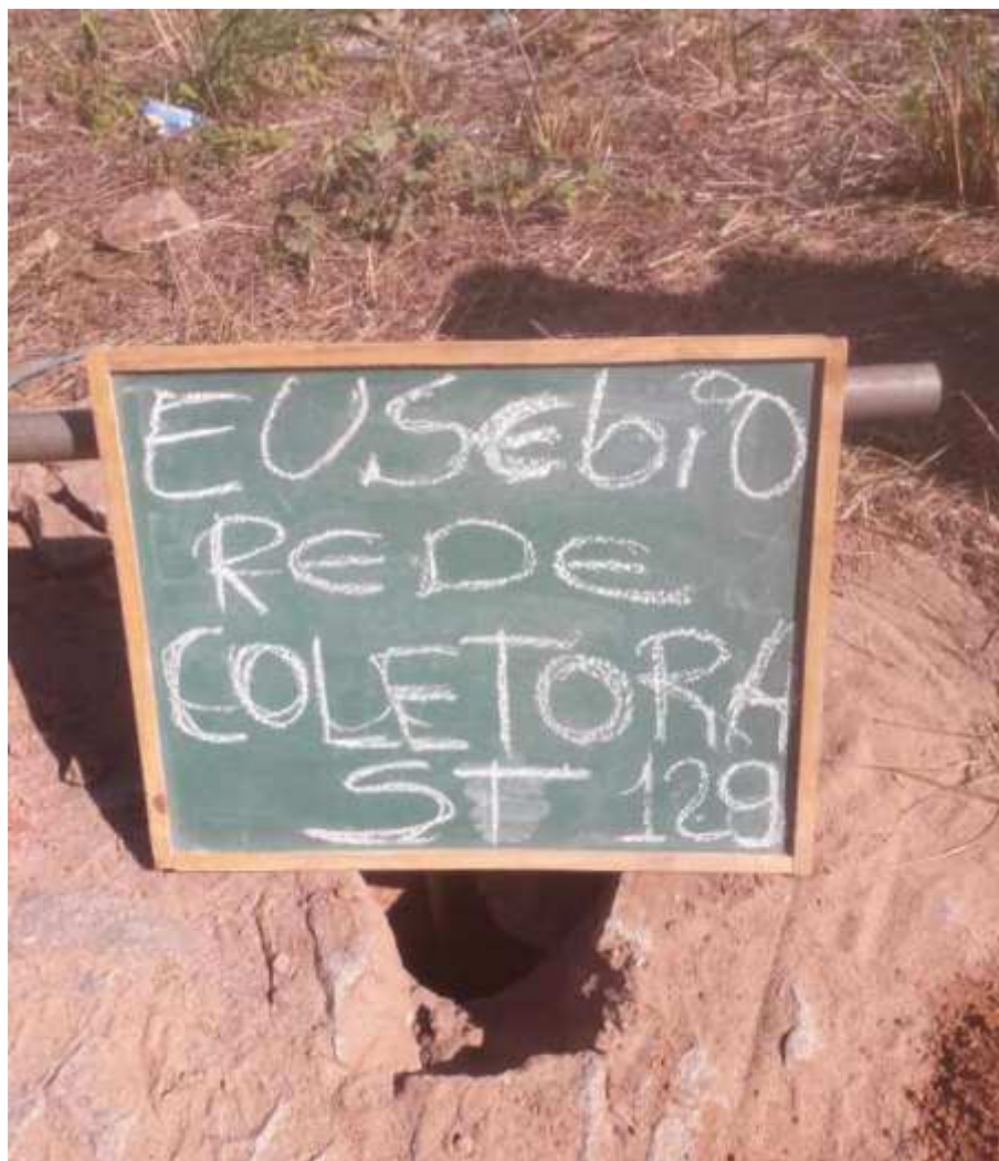
Instalação do furo ST-129
