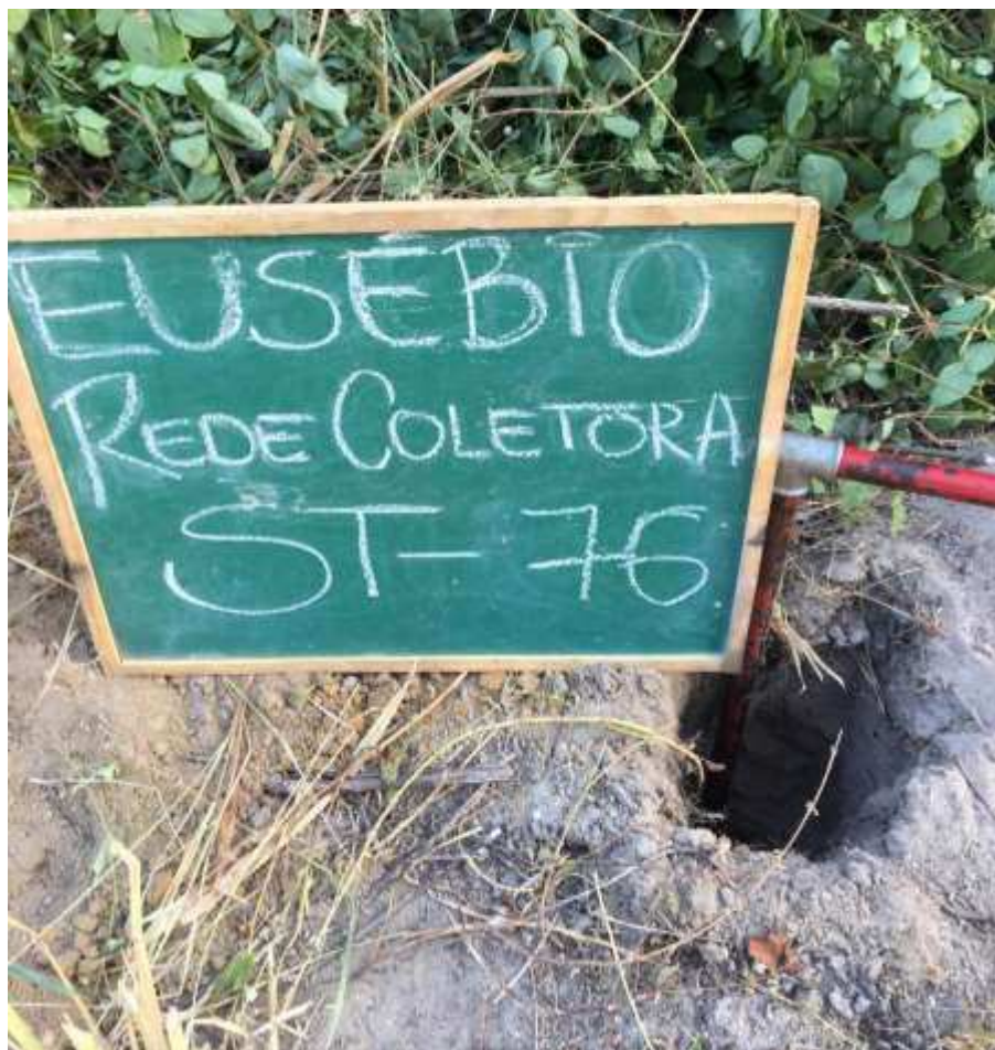
Instalação do furo ST-76
