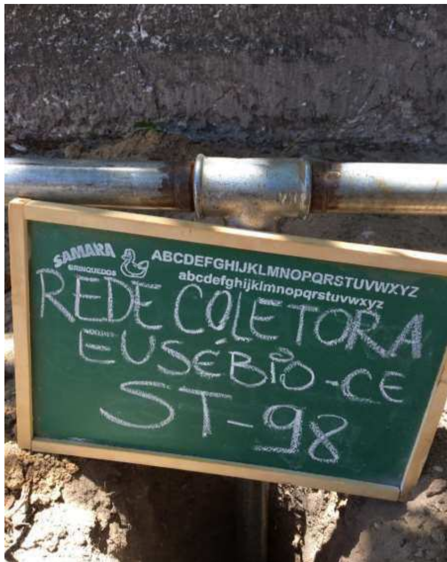
Instalação do furo ST-98
