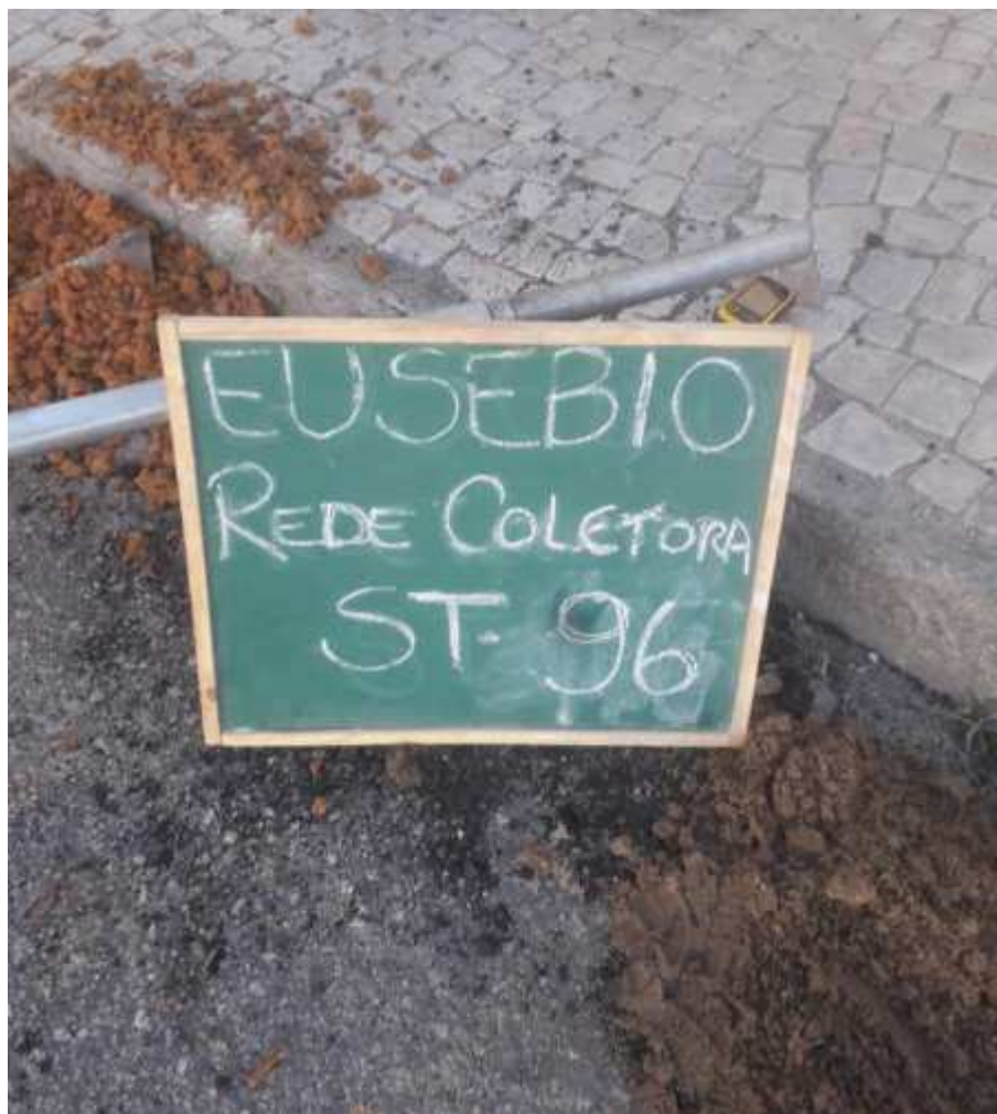
Instalação do furo ST-96
