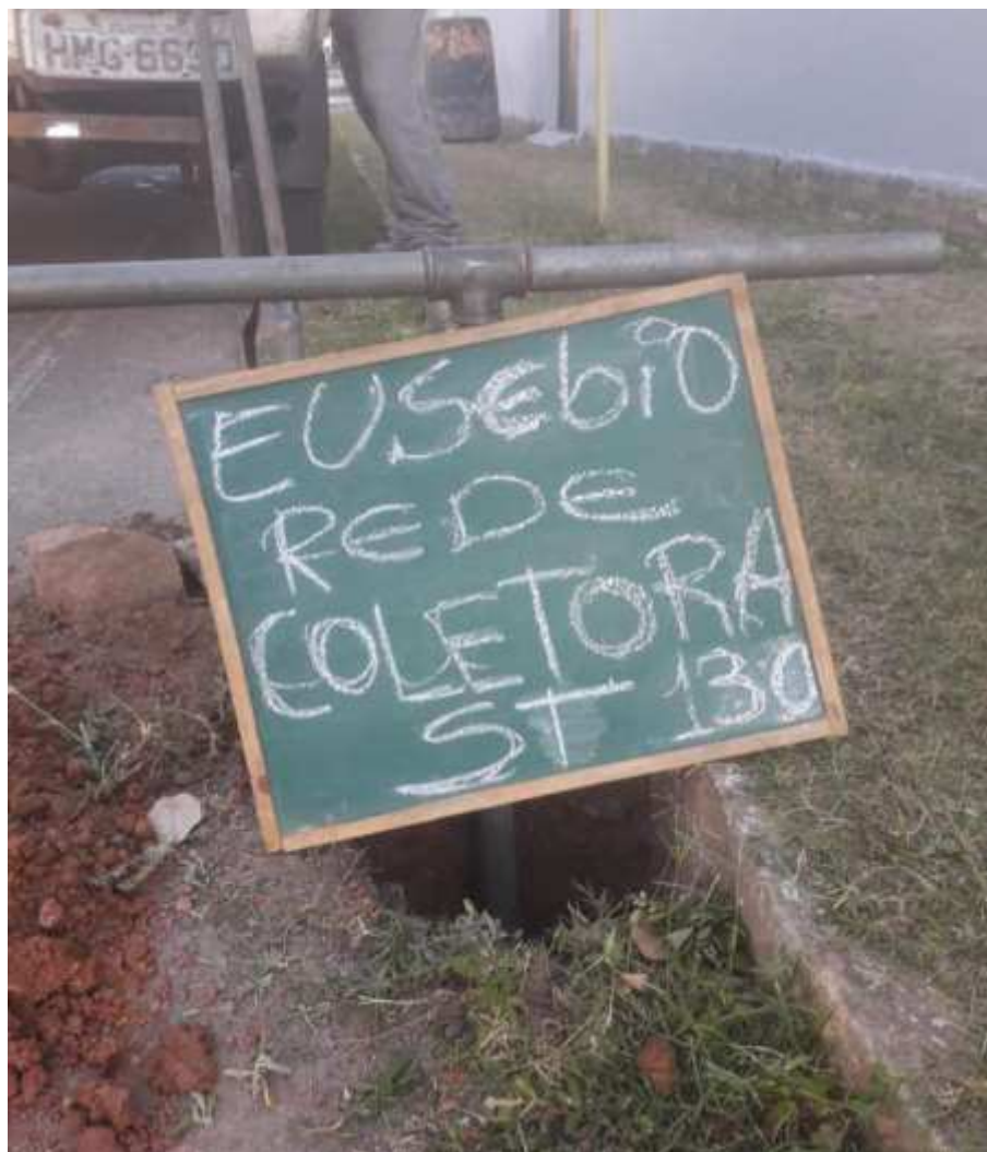
Instalação do furo ST-130
