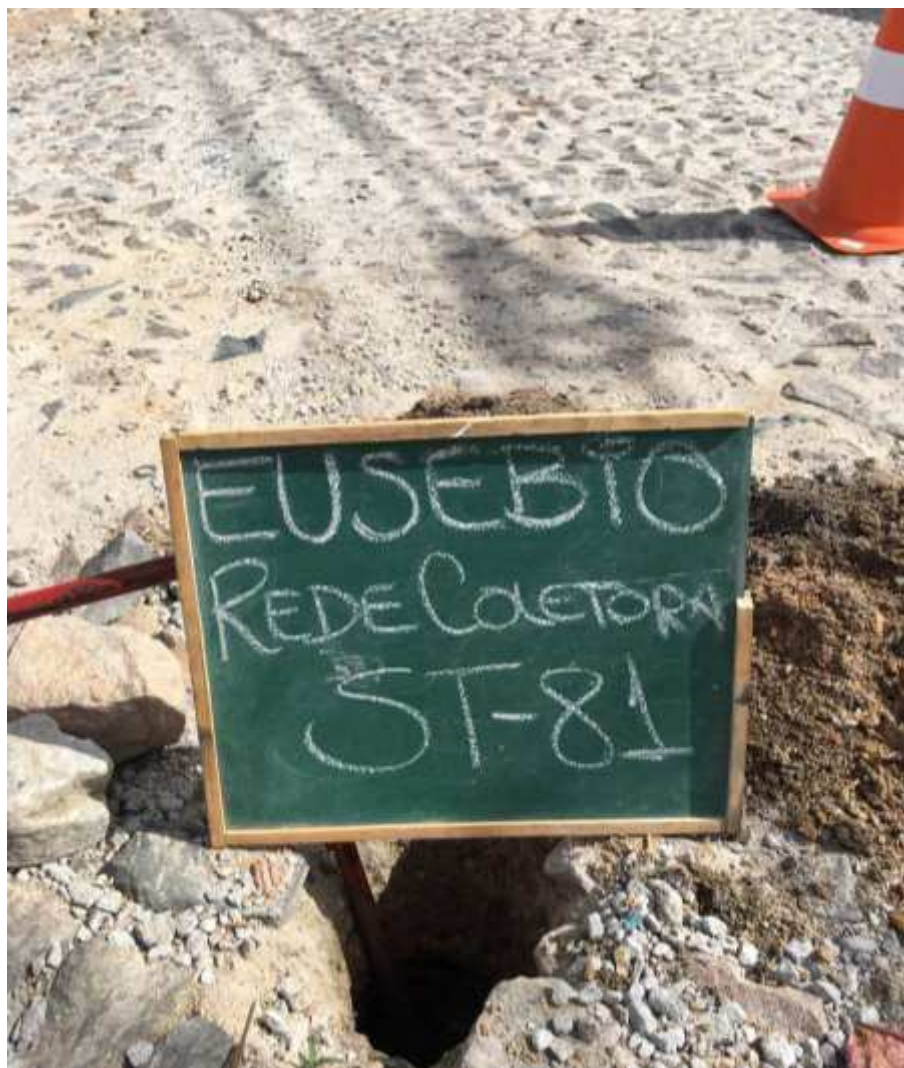
Instalação do furo ST-81
