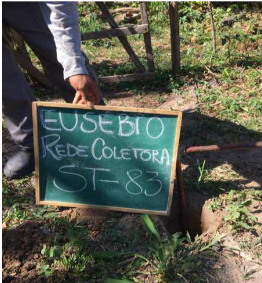
Instalação do furo ST-83
