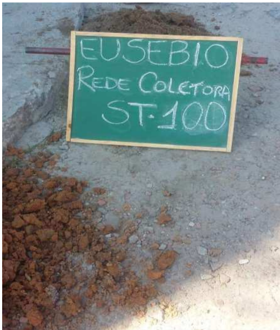
Instalação do furo ST-100
