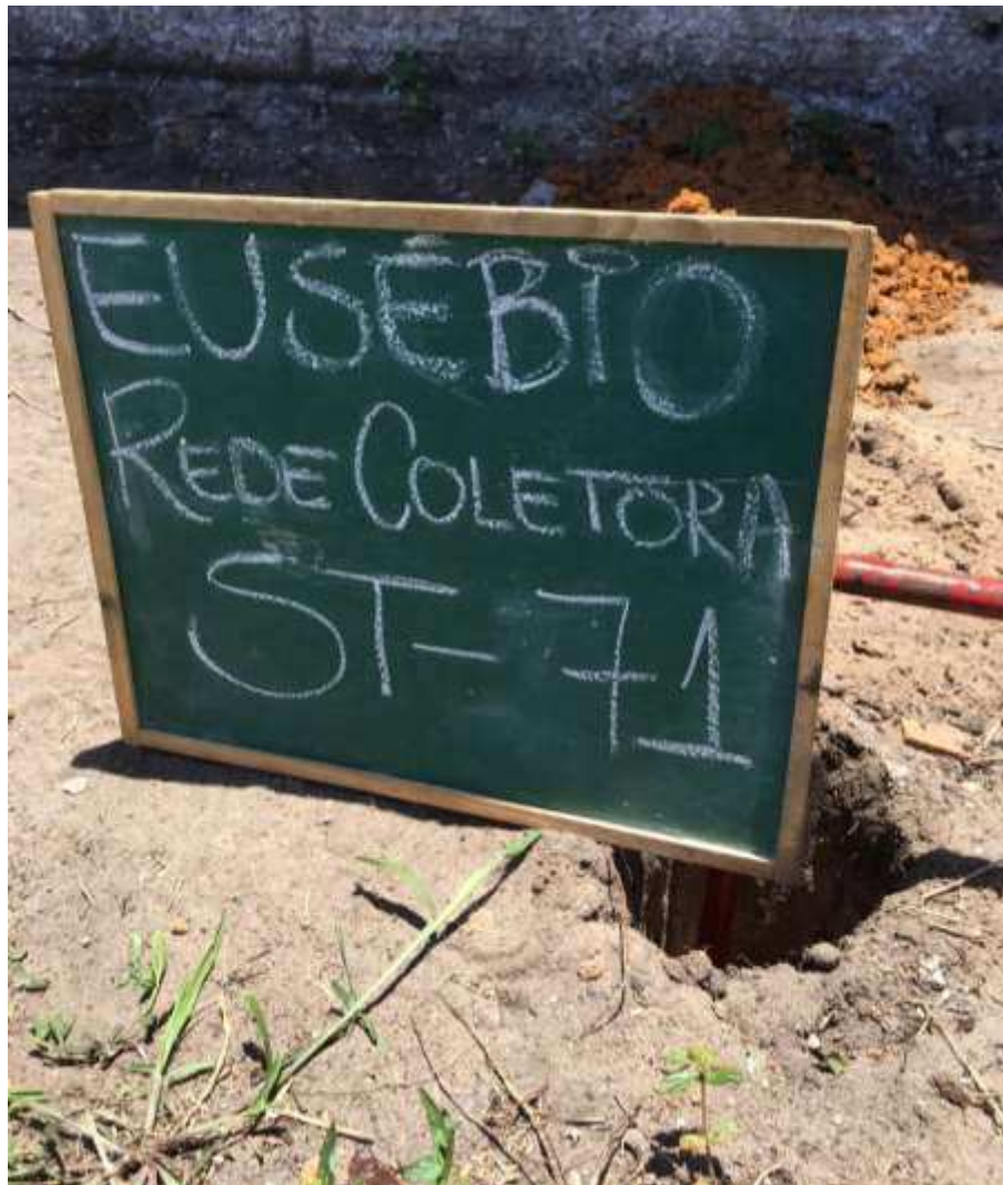
Instalação do furo ST-71
