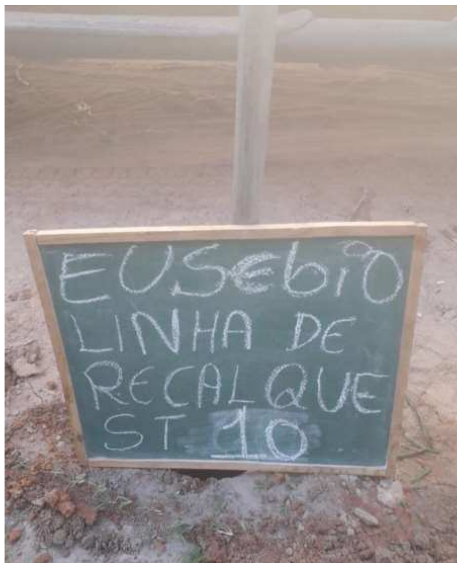
Instalação do furo ST-10
