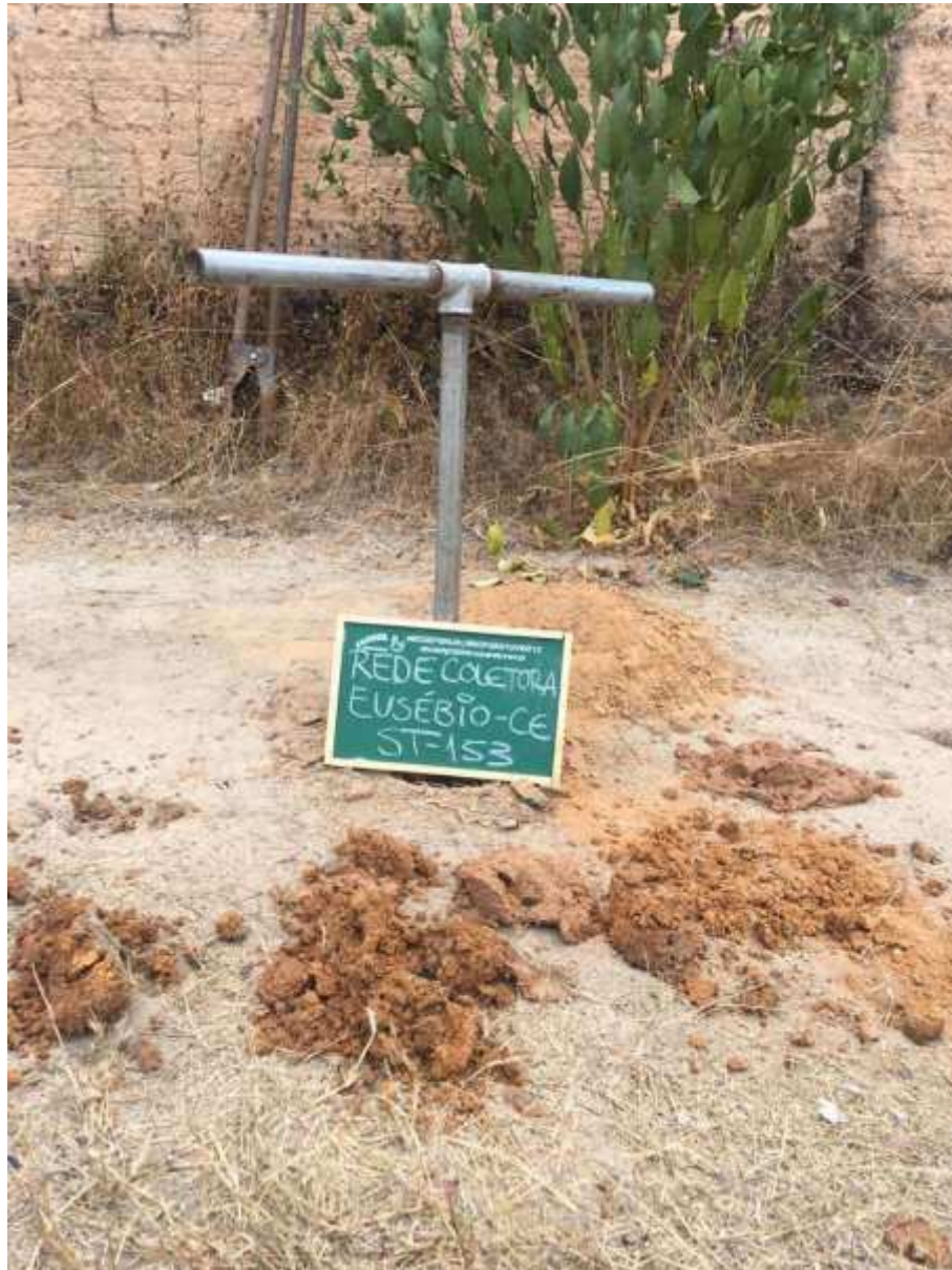
Instalação do furo ST-153
