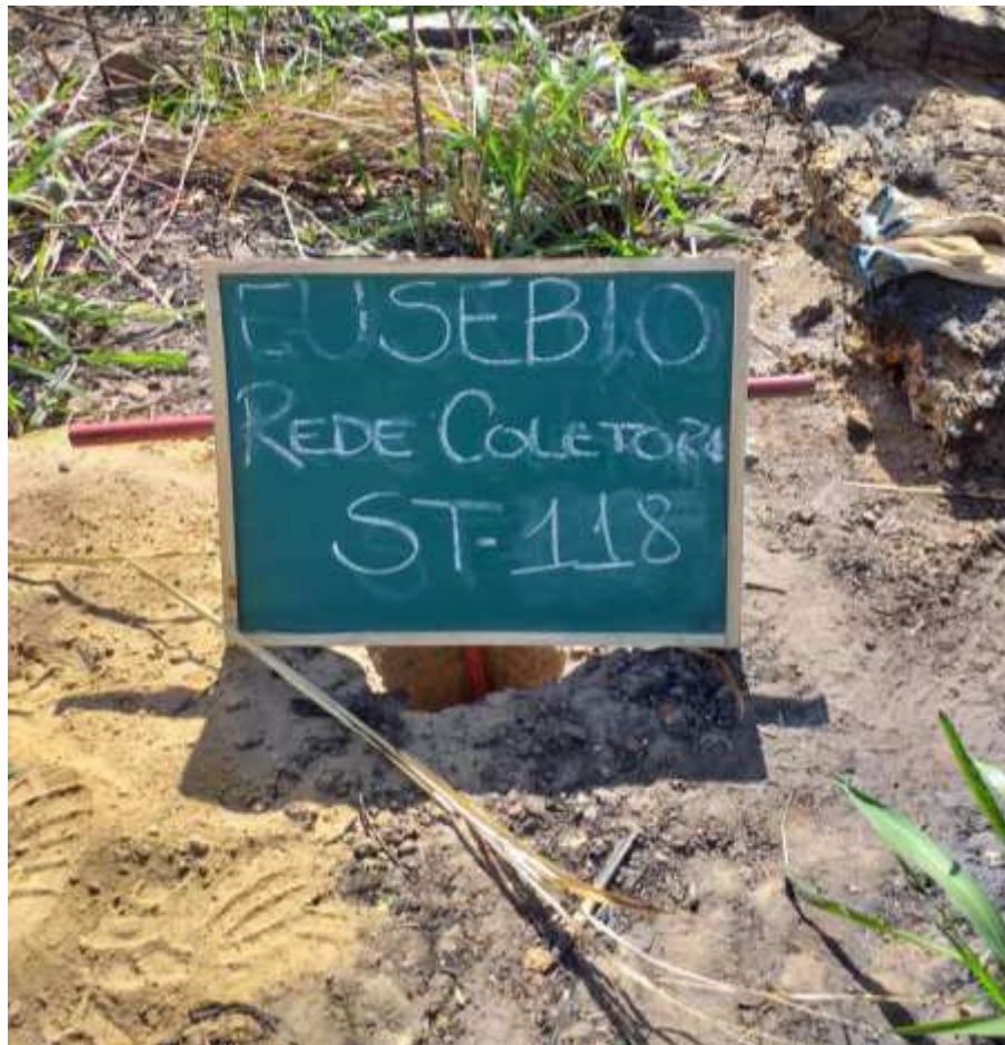
Instalação do furo ST-118
