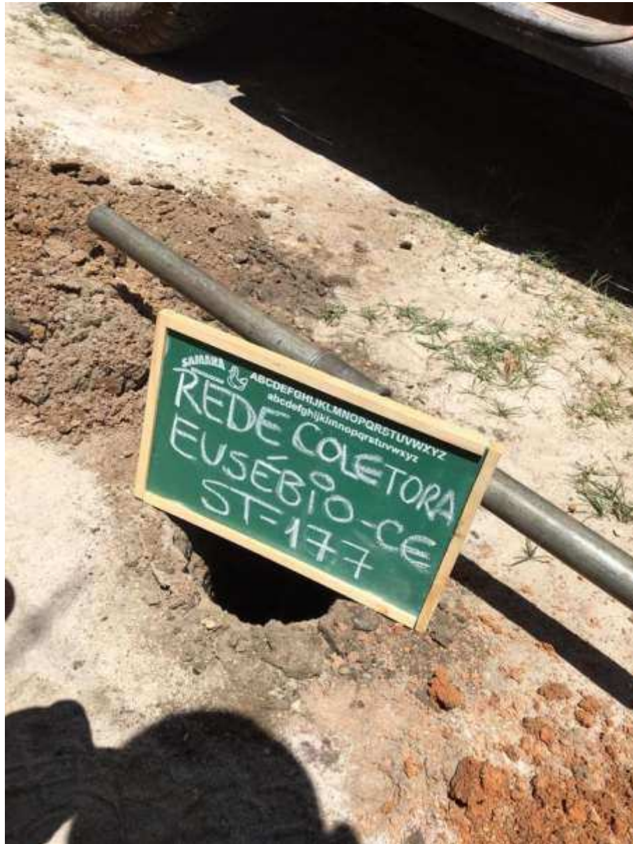
Instalação do furo ST-177
