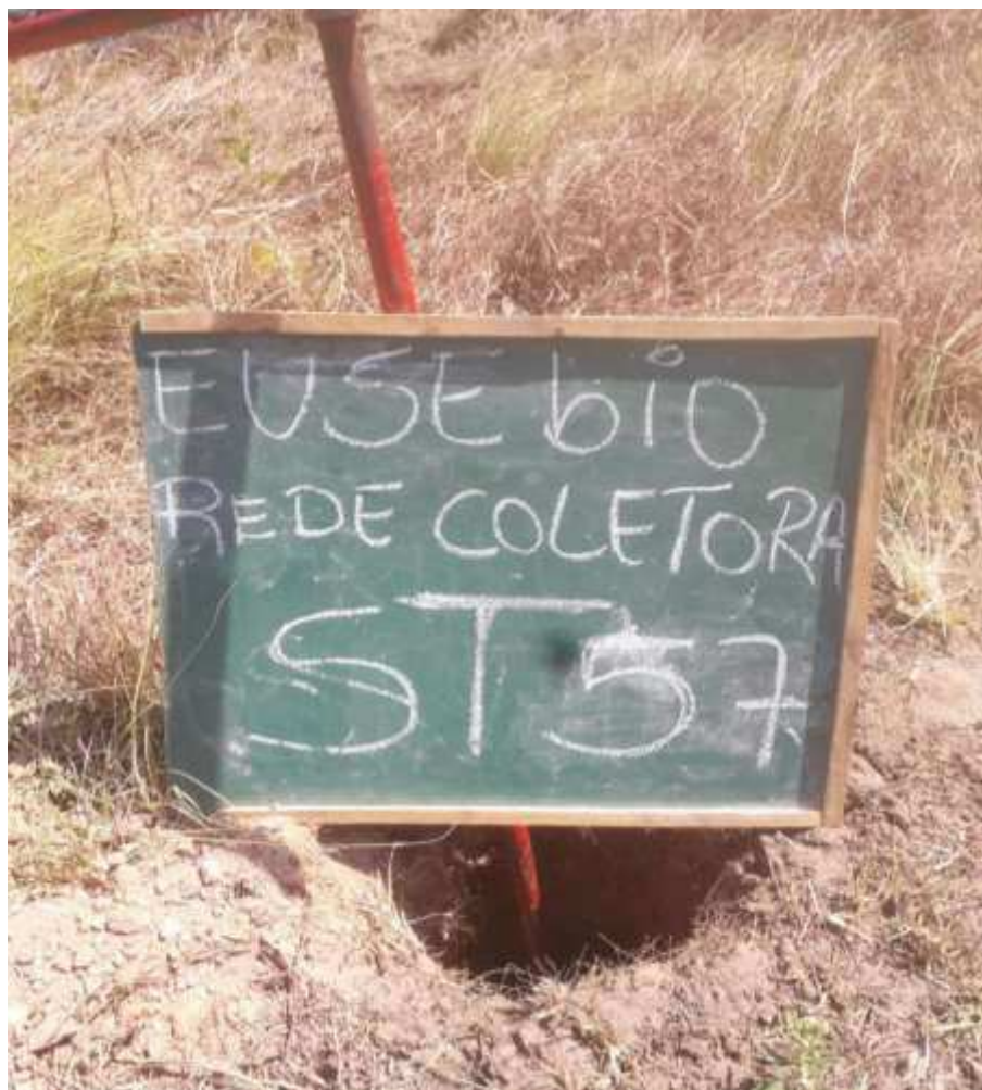
Instalação do furo ST-57
