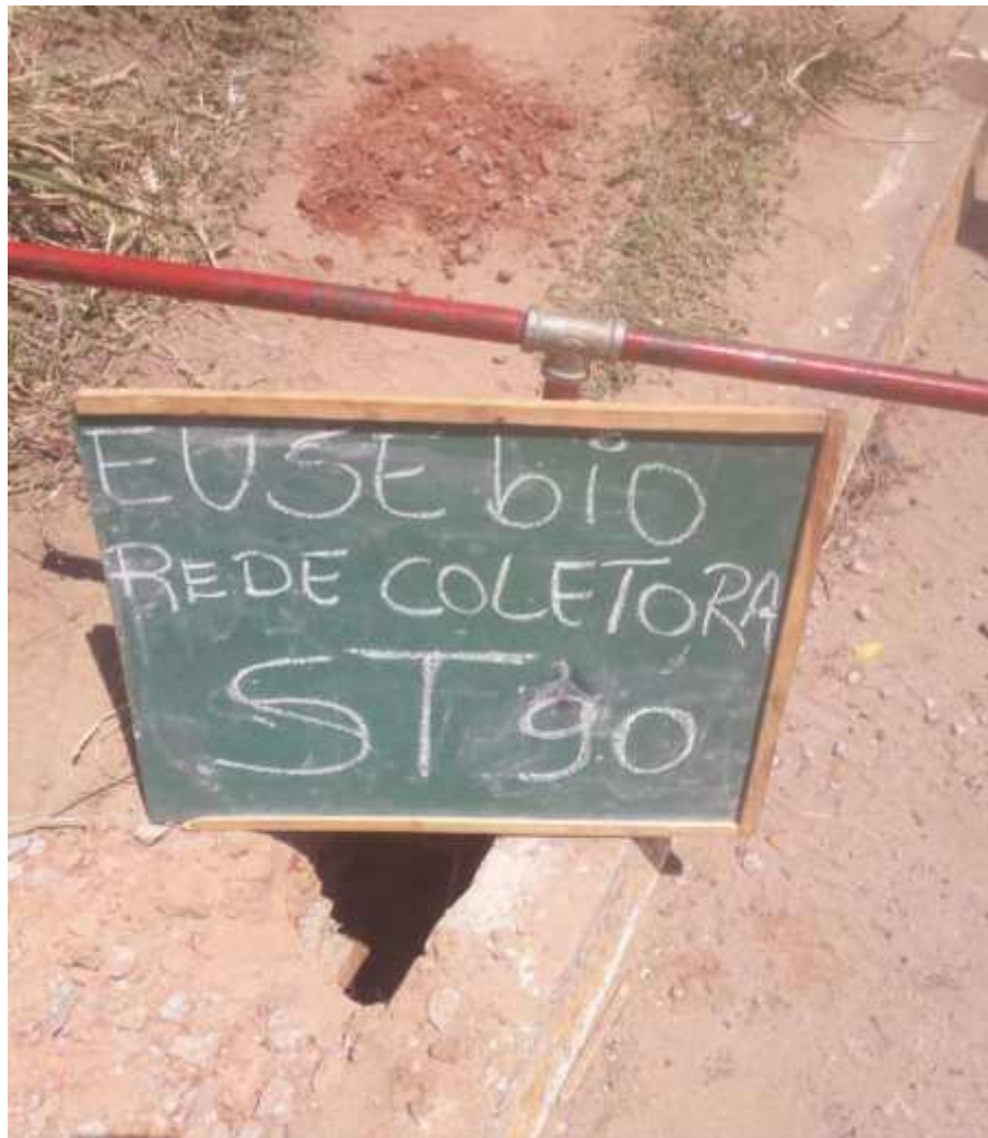
Instalação do furo ST-90
