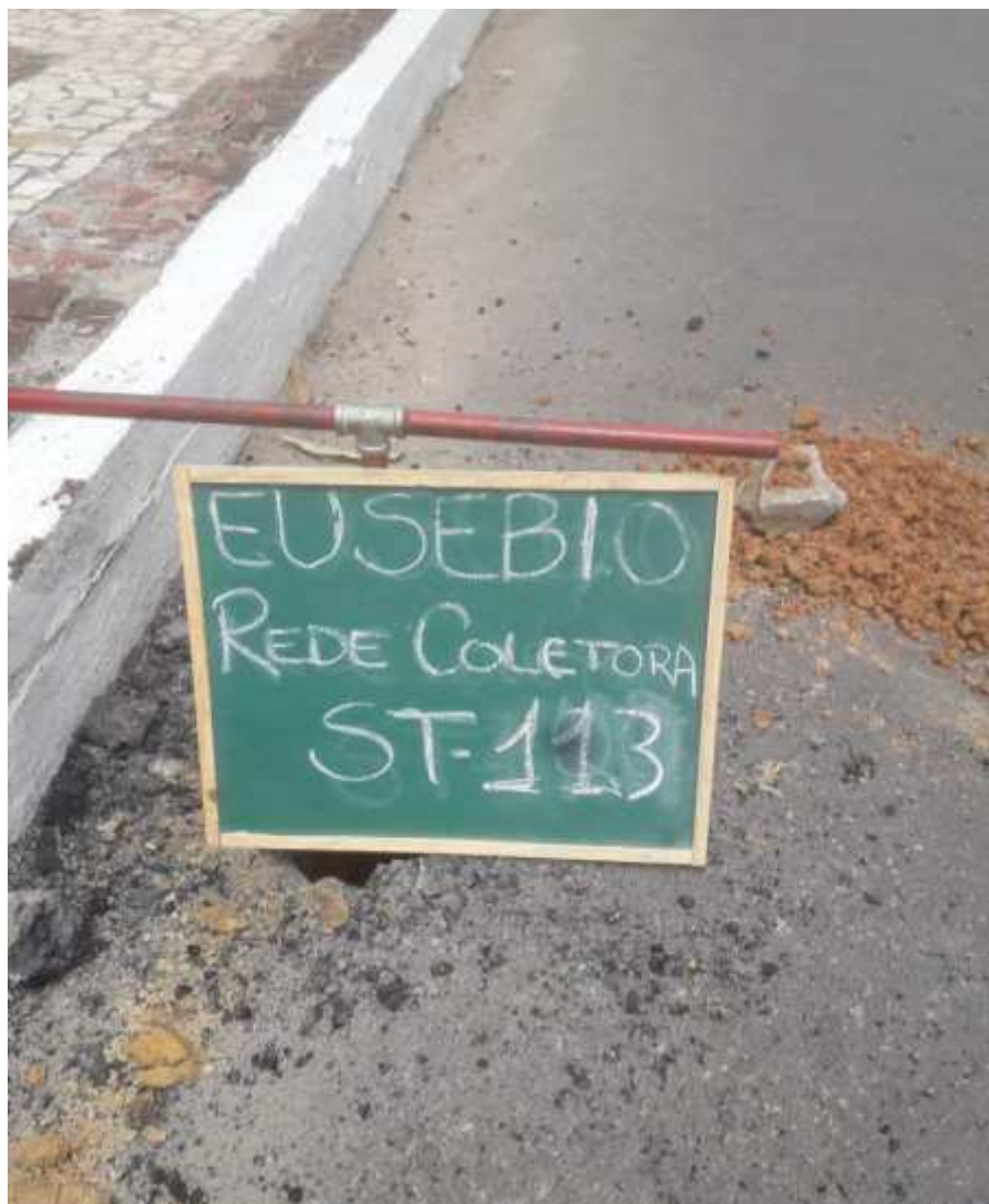
Instalação do furo ST-113
