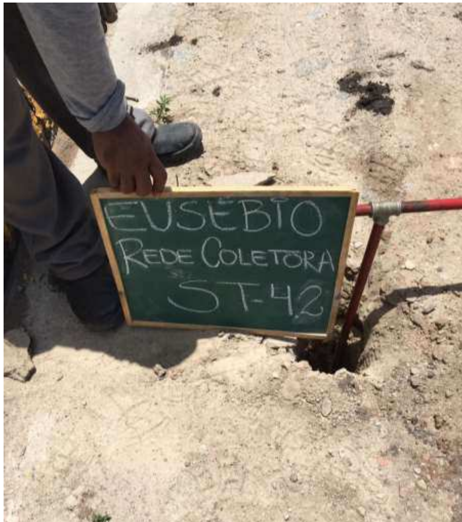
Instalação do furo ST-42
