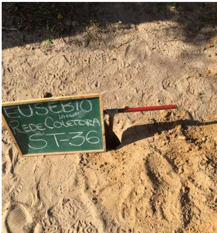
Instalação do furo ST-36
