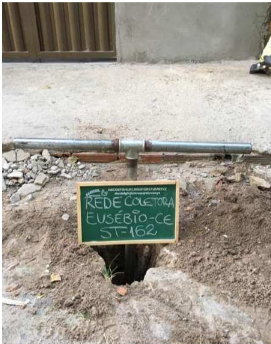
Instalação do furo ST-162
