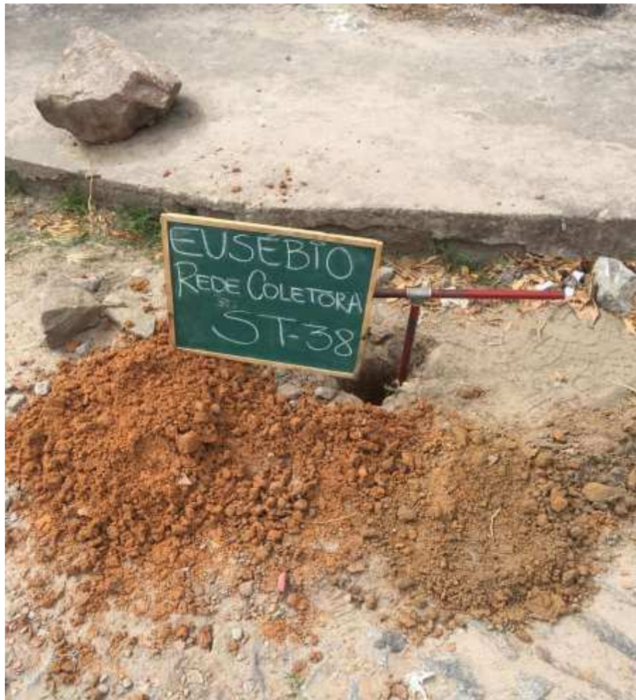
Instalação do furo ST-38
