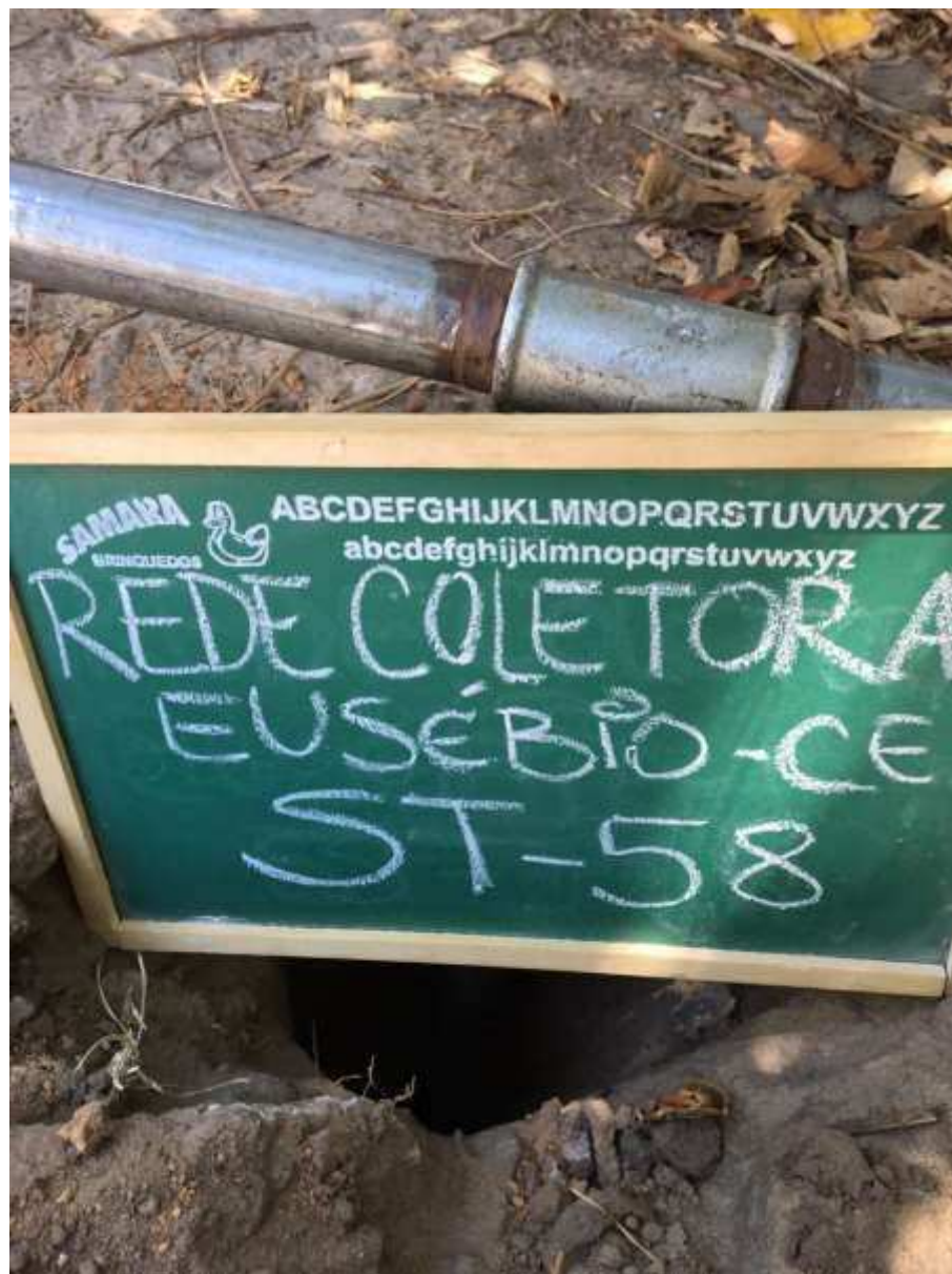
Instalação do furo ST-58
