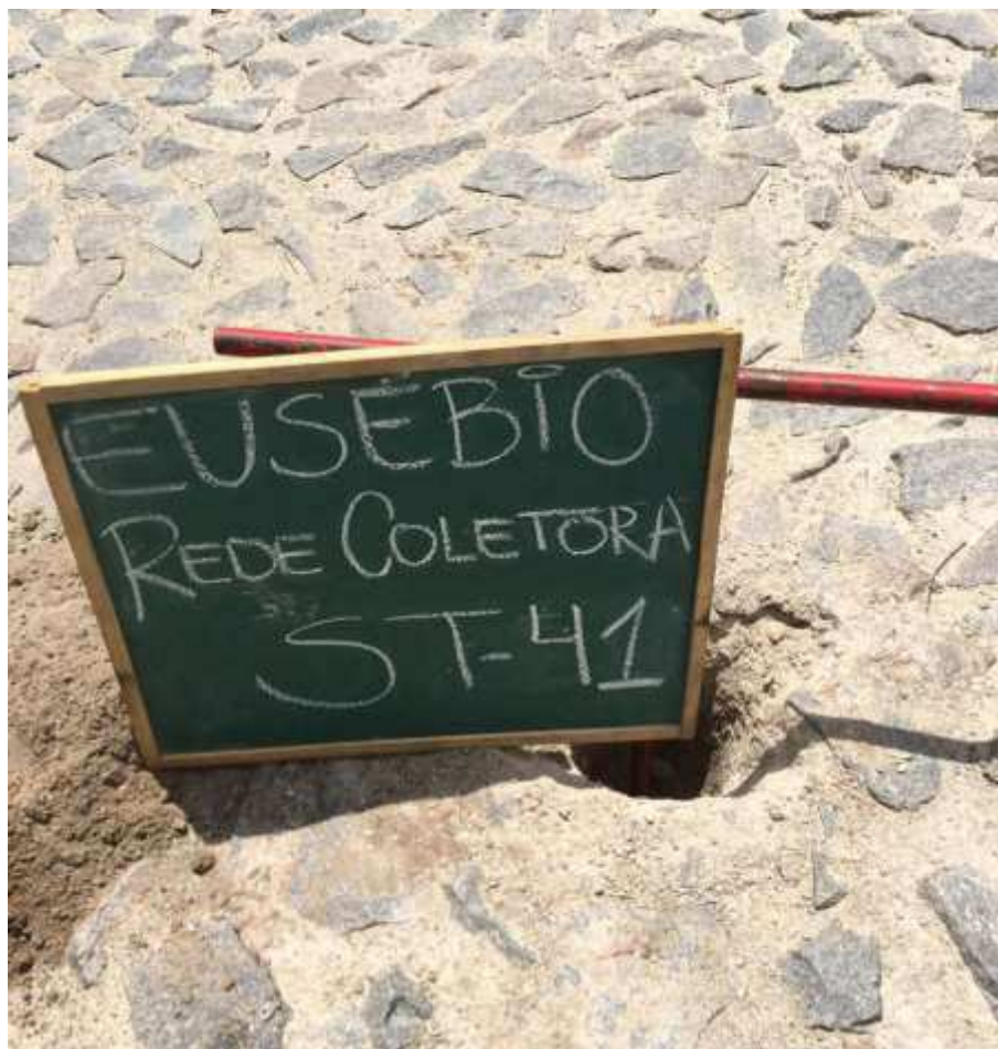
Instalação do furo ST-41
