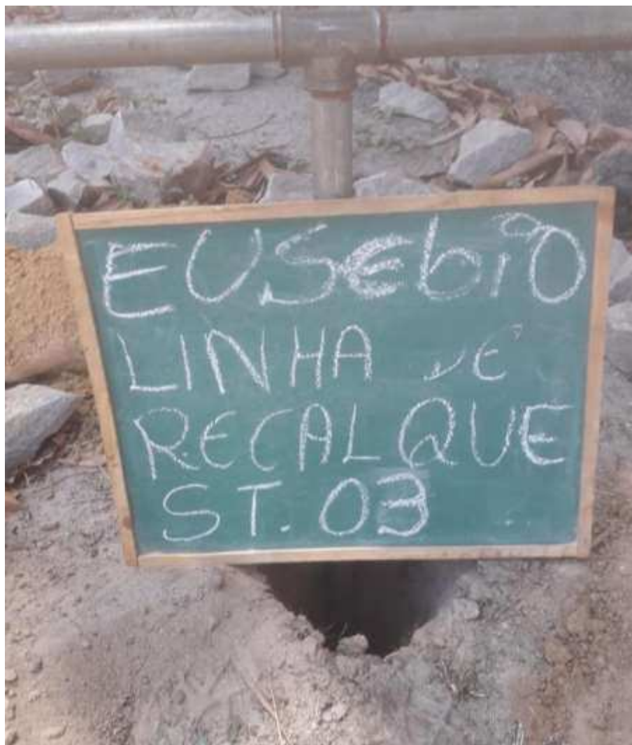
Instalação do furo ST-03
