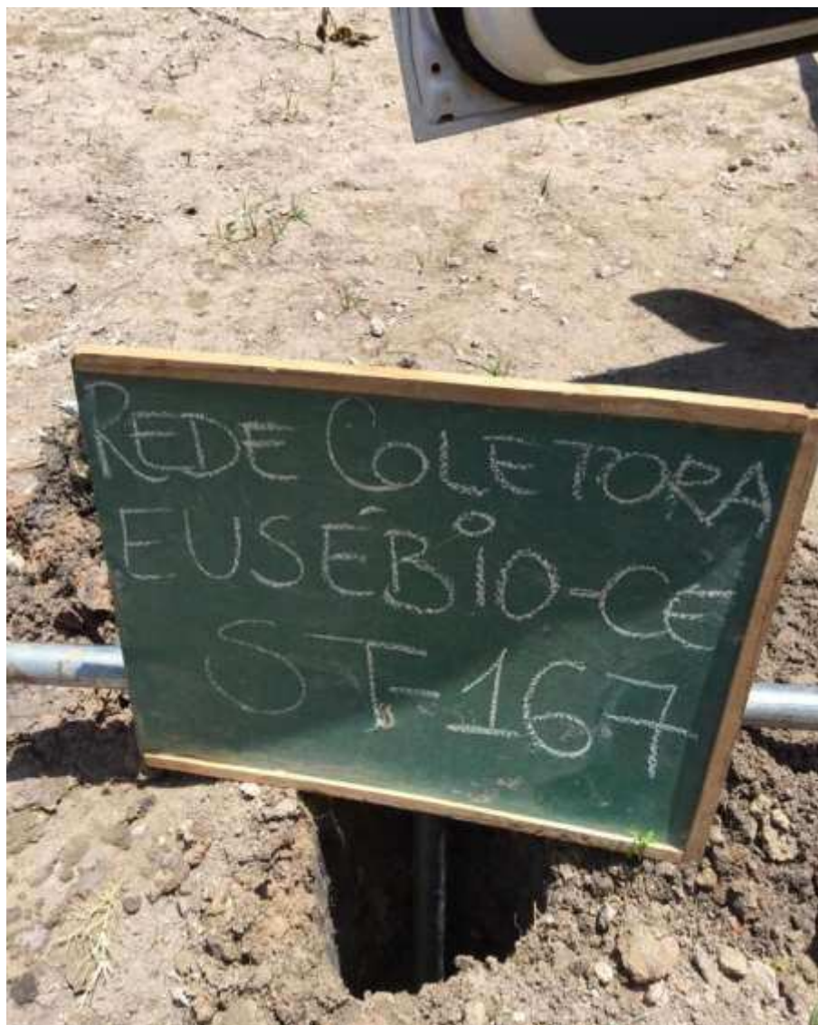
Instalação do furo ST-167
