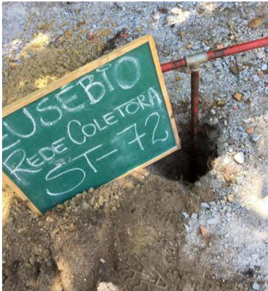
Instalação do furo ST-72
