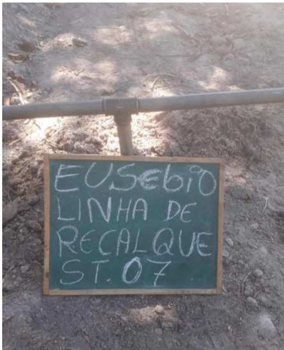
Instalação do furo ST-07
