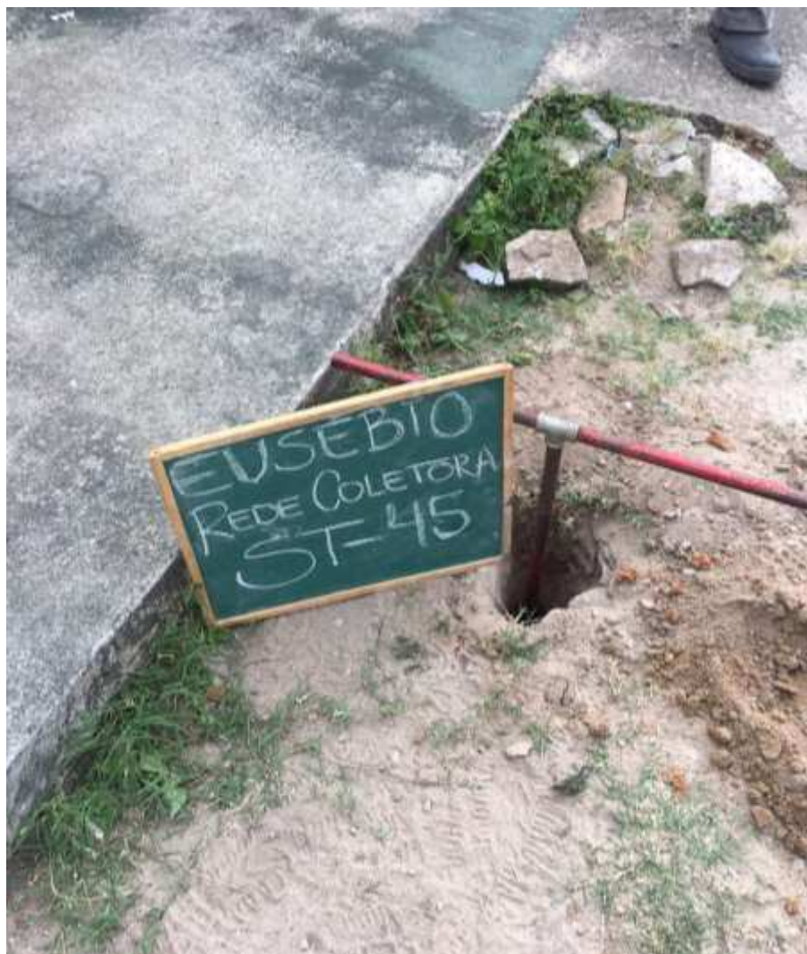
Instalação do furo ST-45
