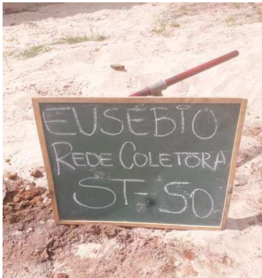
Instalação do furo ST-50
