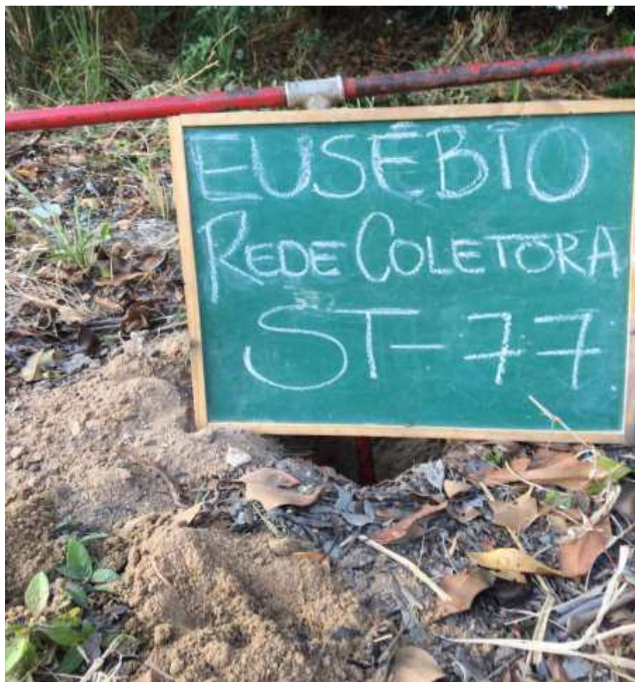
Instalação do furo ST-77
