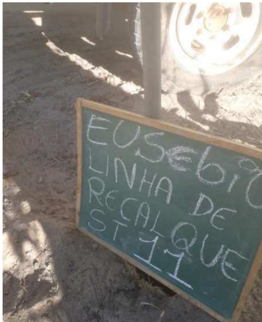
Instalação do furo ST-11
