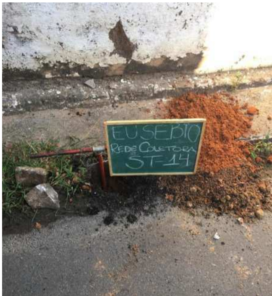
Instalação do furo ST-14
