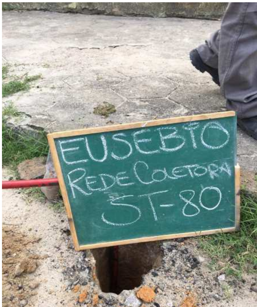
Instalação do furo ST-80
