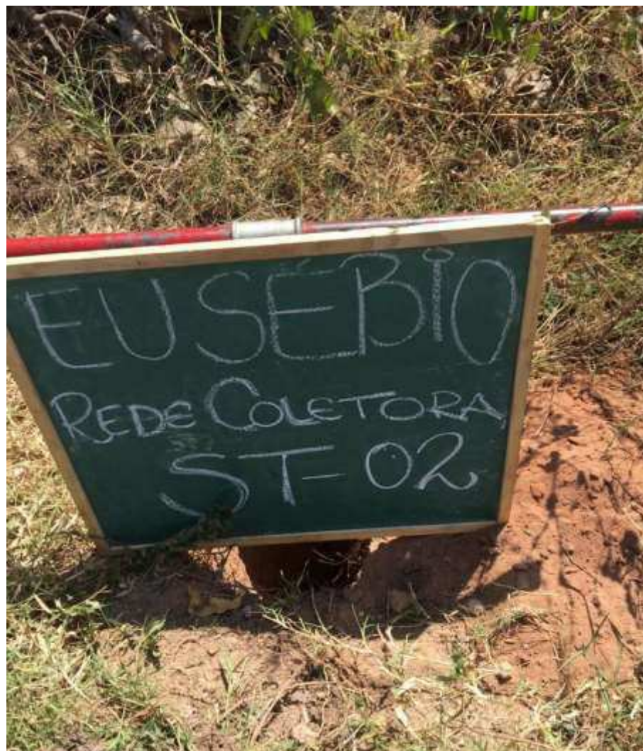
Instalação do furo ST-02
