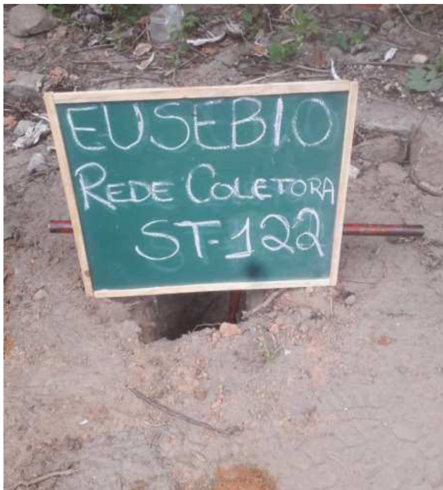
Instalação do furo ST-122
