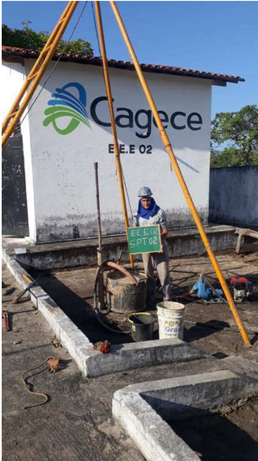
Instalação do furo SP-02
