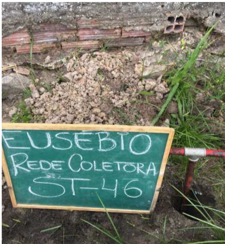
Instalação do furo ST-46
