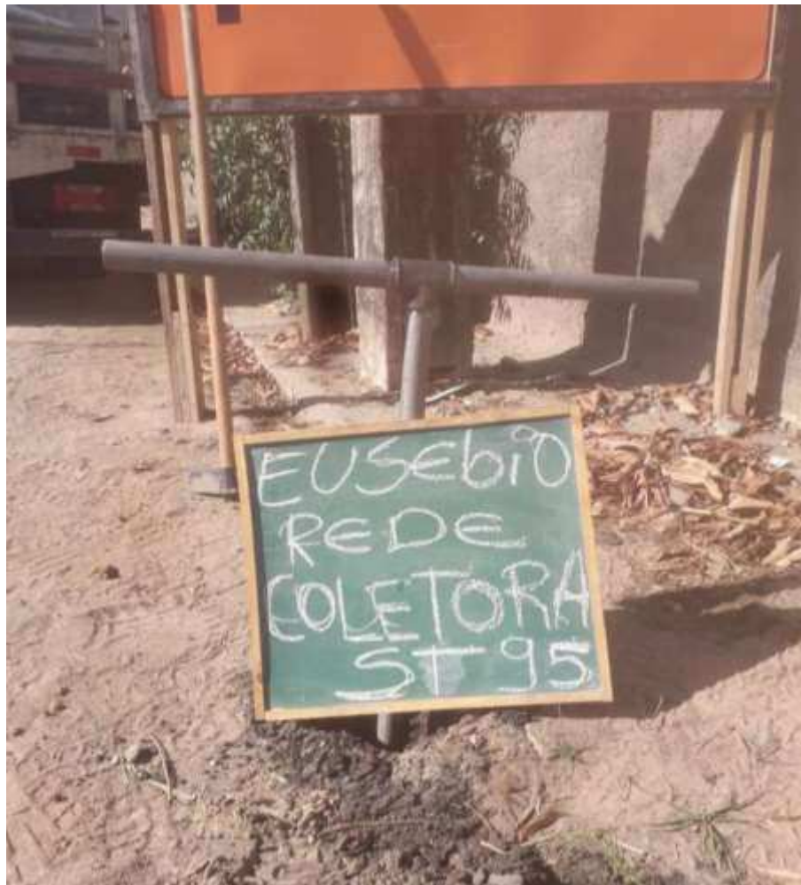
Instalação do furo ST-95
