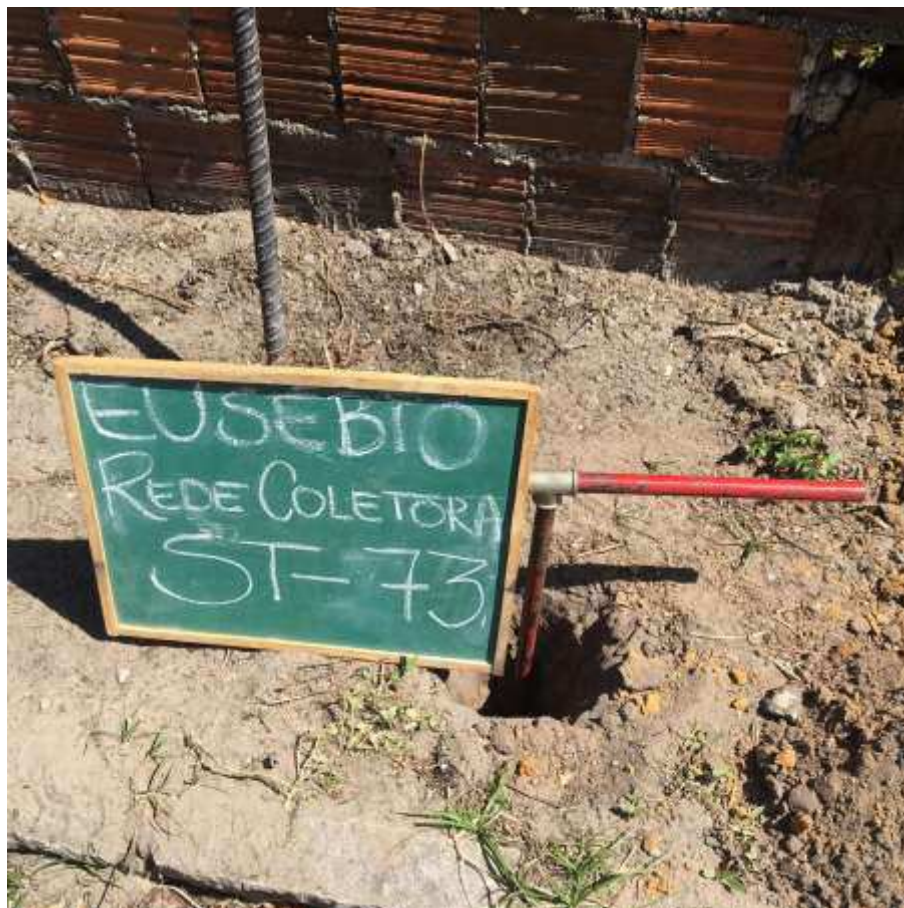
Instalação do furo ST-73
