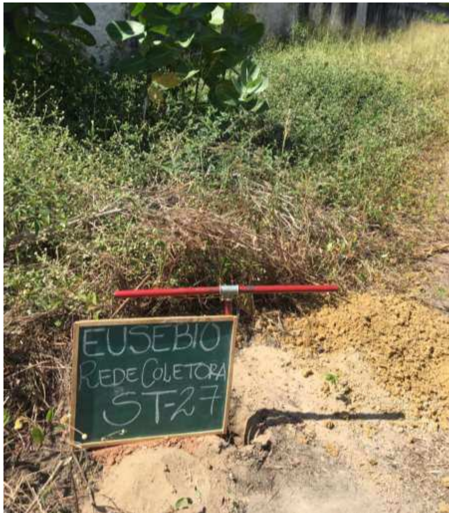
Instalação do furo ST-27
