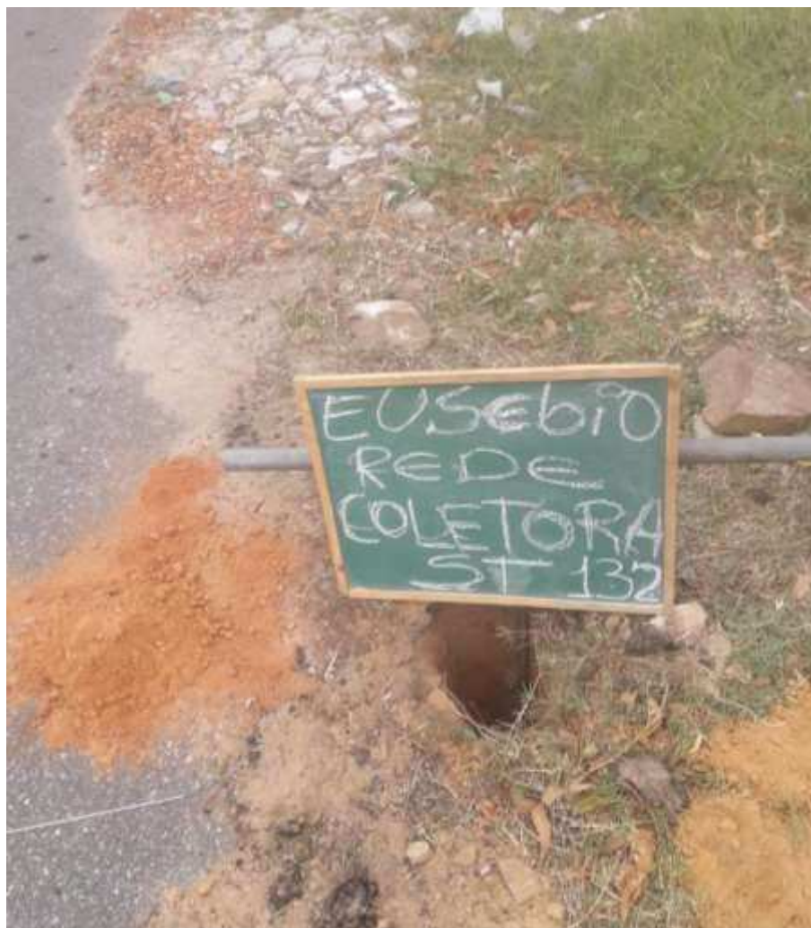
Instalação do furo ST-132
