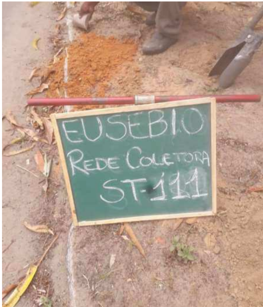
Instalação do furo ST-111
