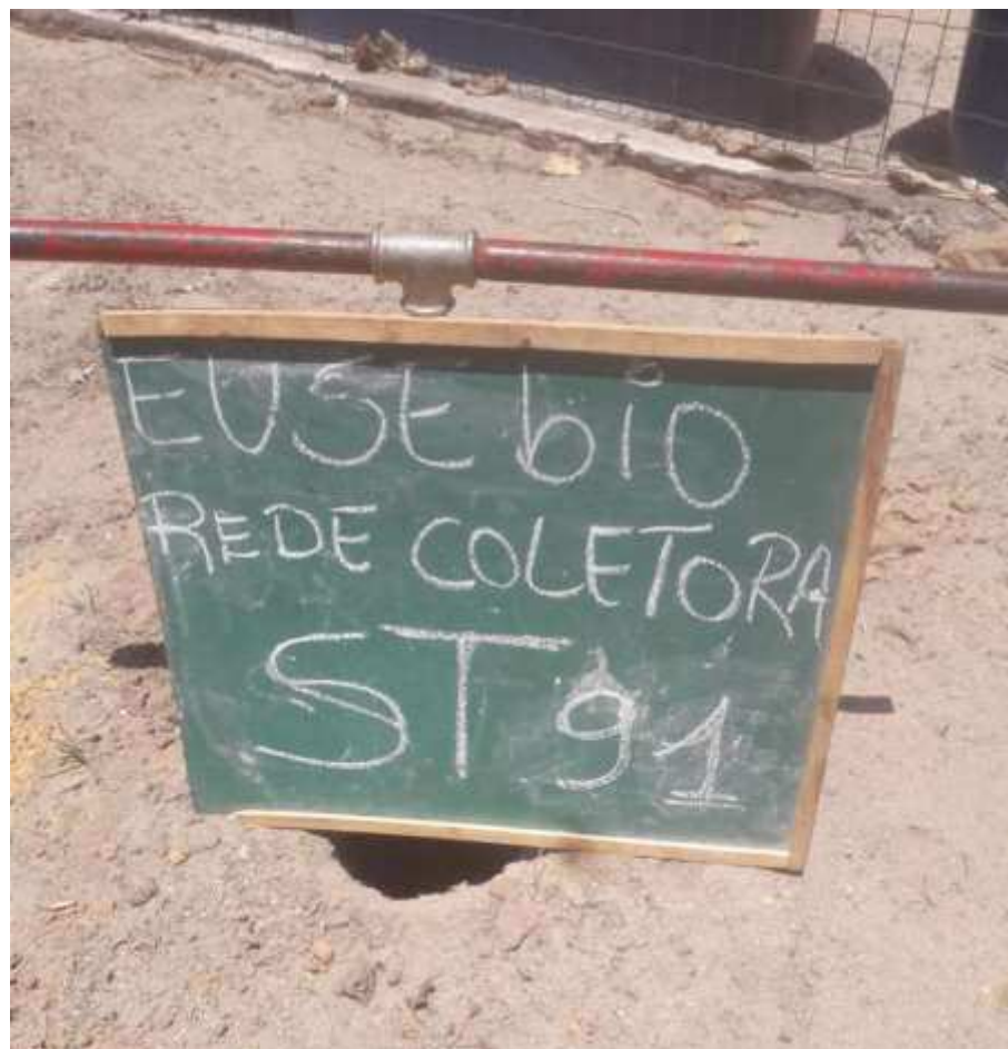
Instalação do furo ST-91
