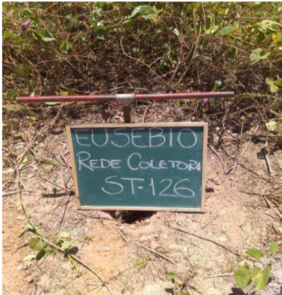
Instalação do furo ST-126
