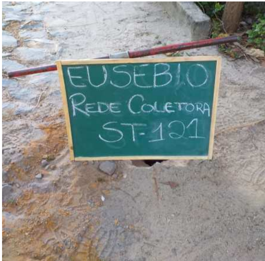
Instalação do furo ST-121
