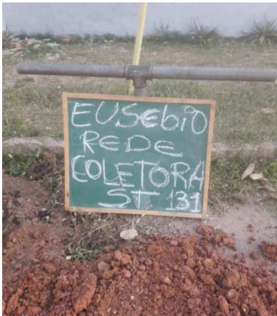
Instalação do furo ST-131
