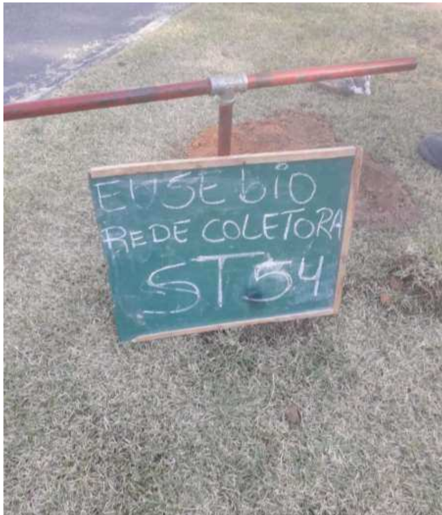
Instalação do furo ST-54
