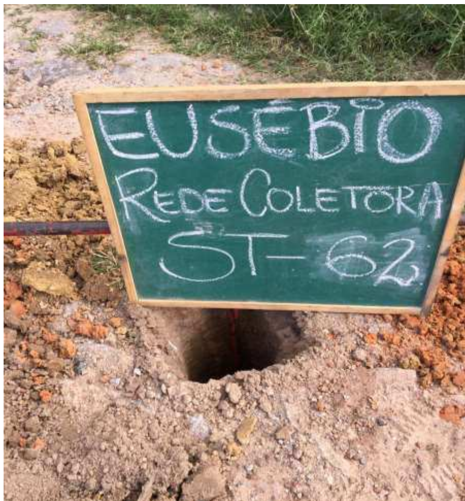
Instalação do furo ST-62
