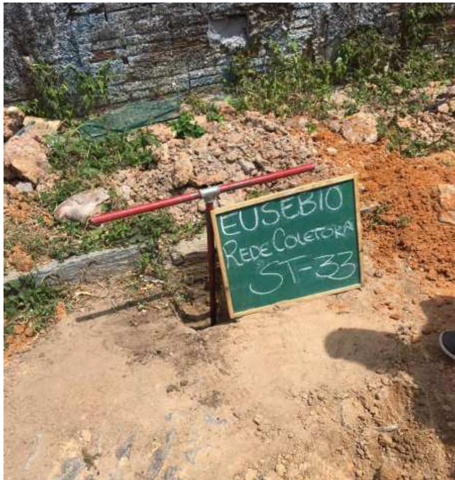
Instalação do furo ST-33
