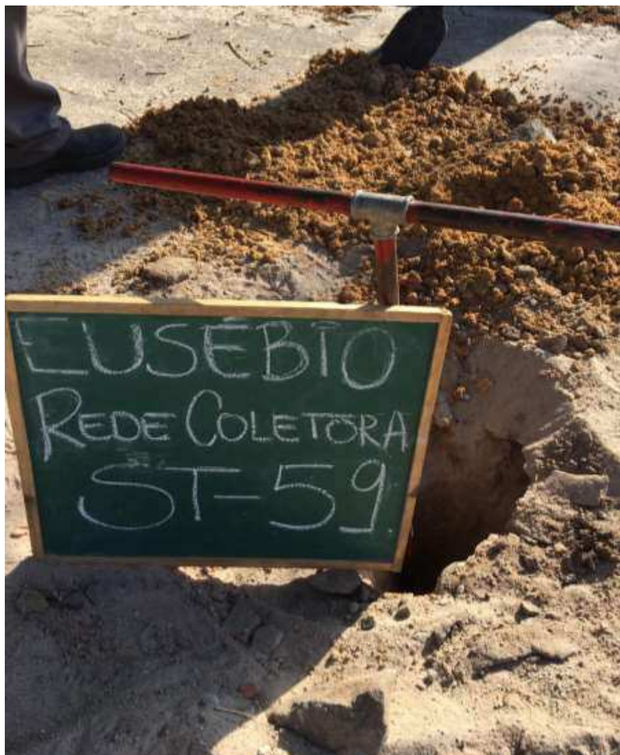
Instalação do furo ST-59
