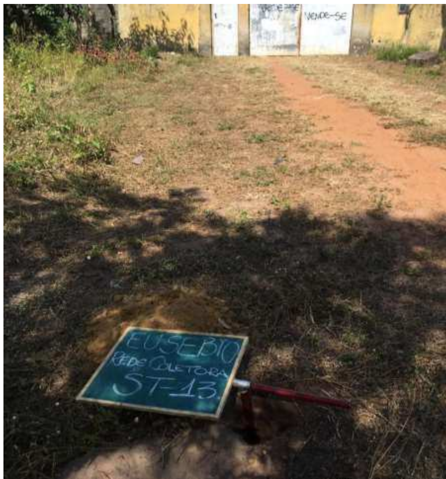
Instalação do furo ST-13
