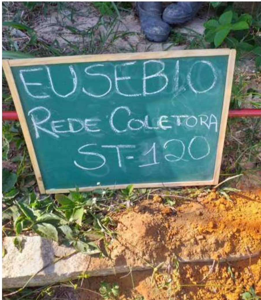
Instalação do furo ST-120
