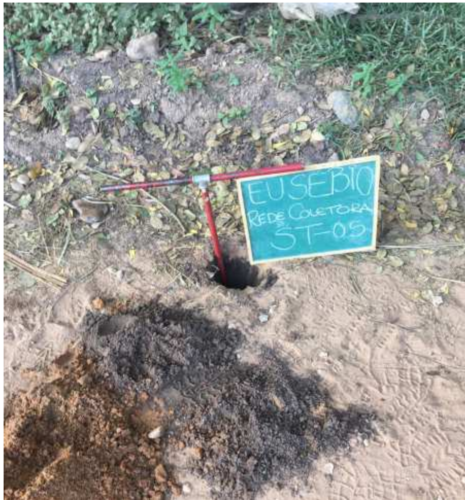
Instalação do furo ST-05
