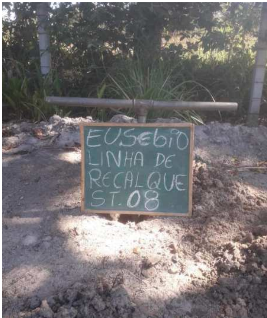
Instalação do furo ST-08
