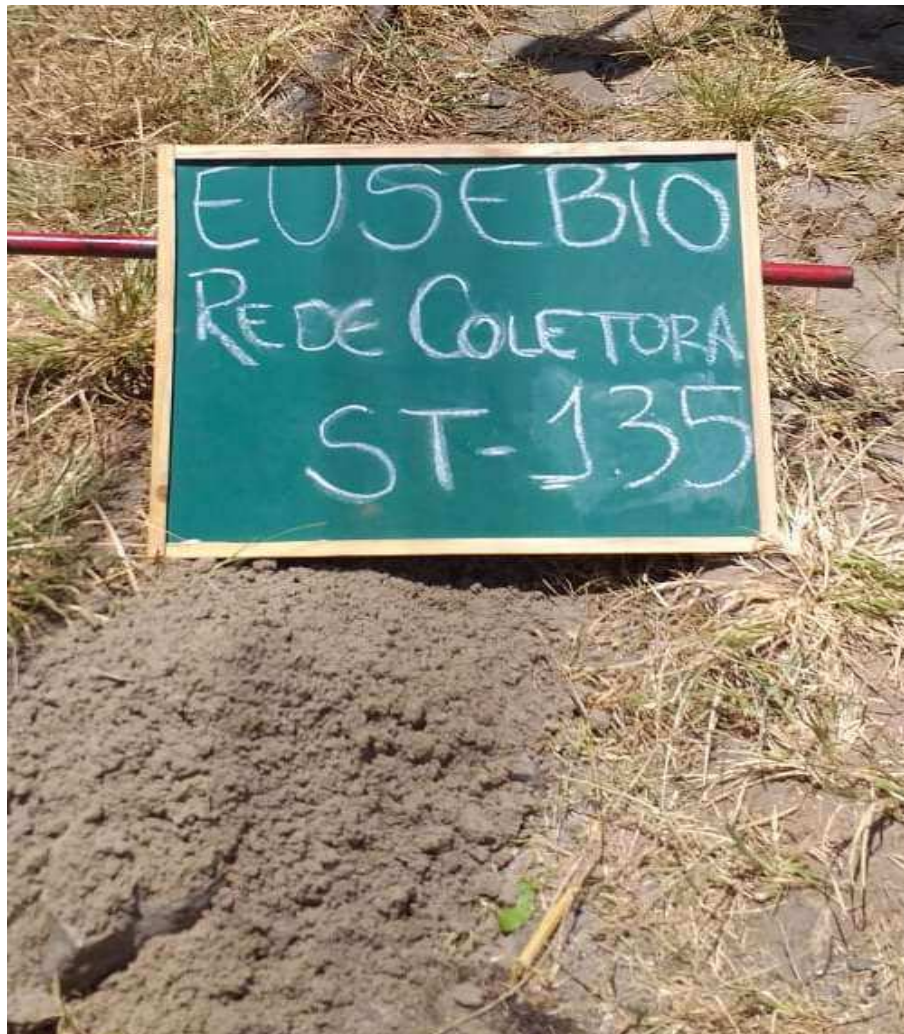
Instalação do furo ST-135
