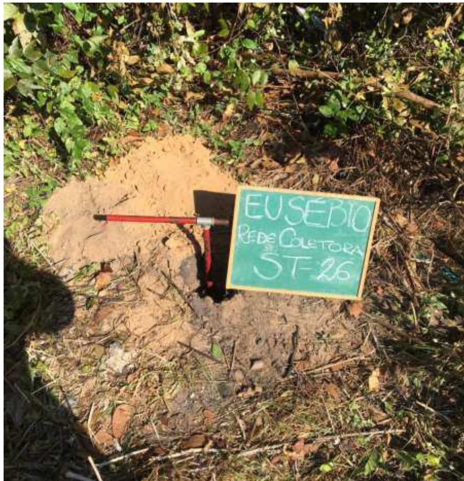
Instalação do furo ST-26
