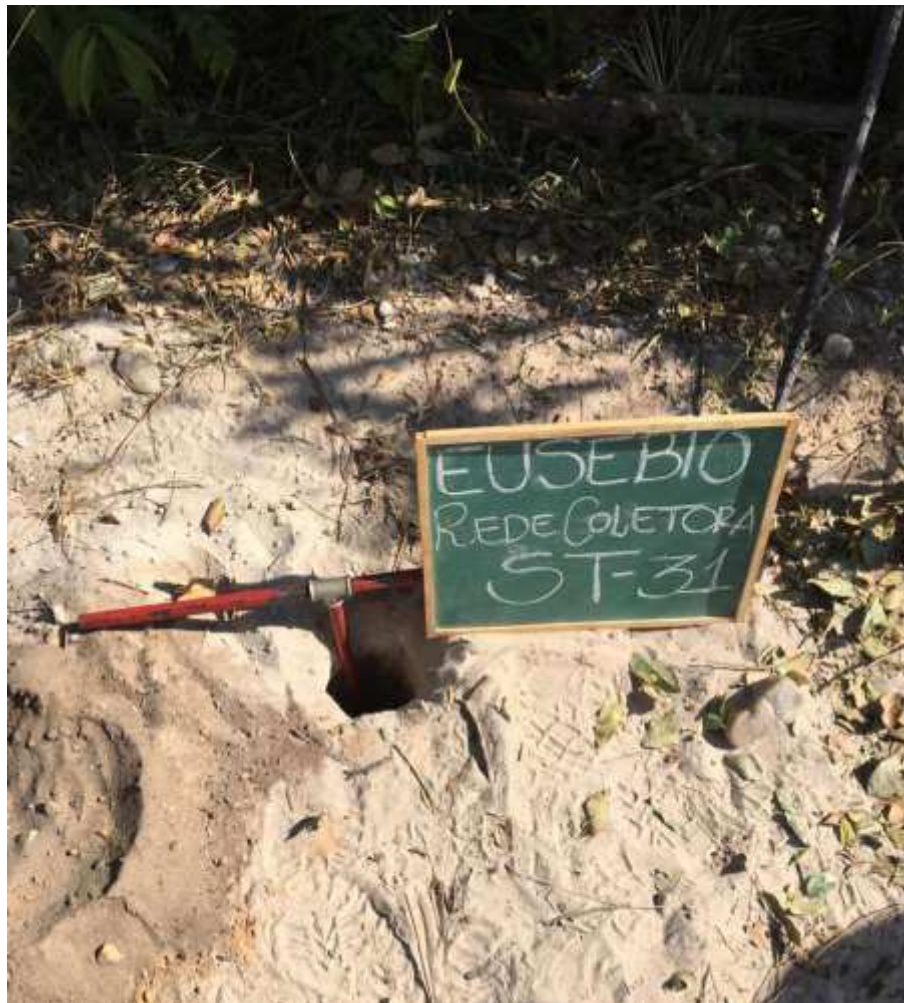
Instalação do furo ST-31
