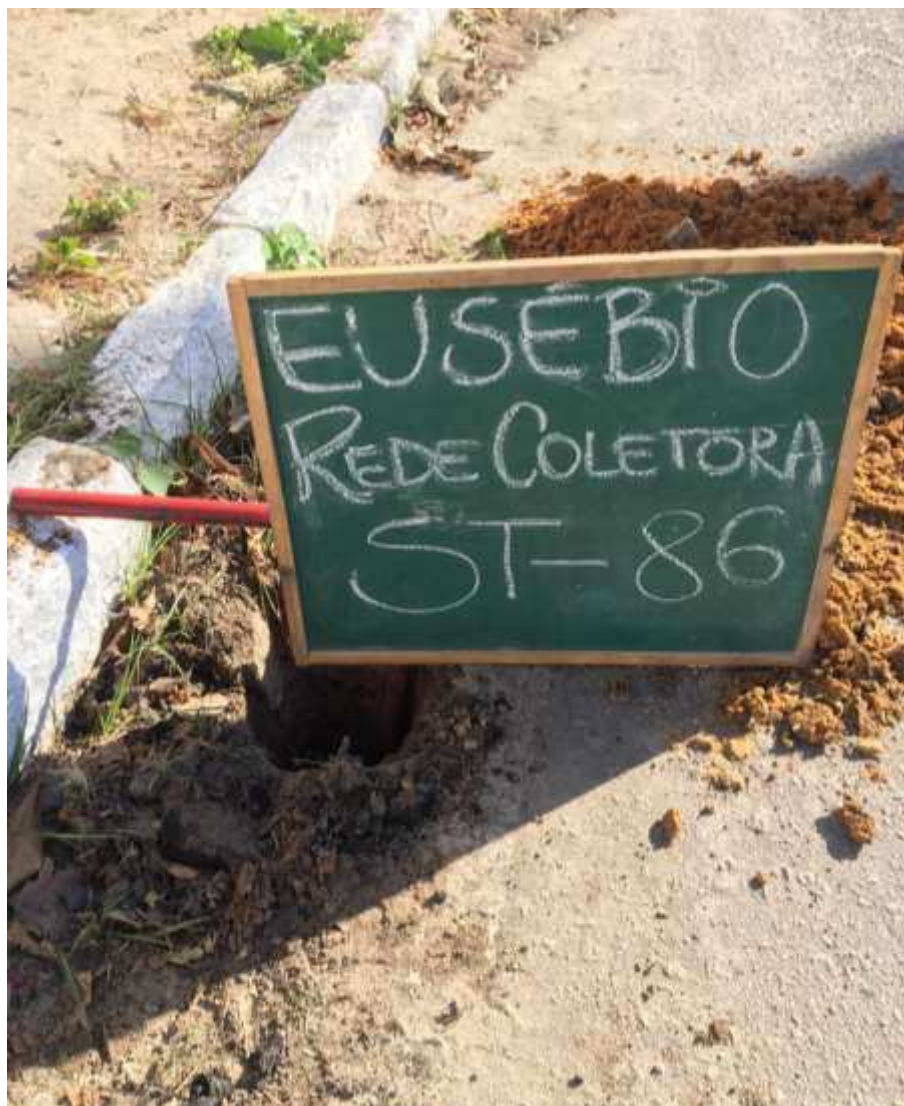
Instalação do furo ST-86
