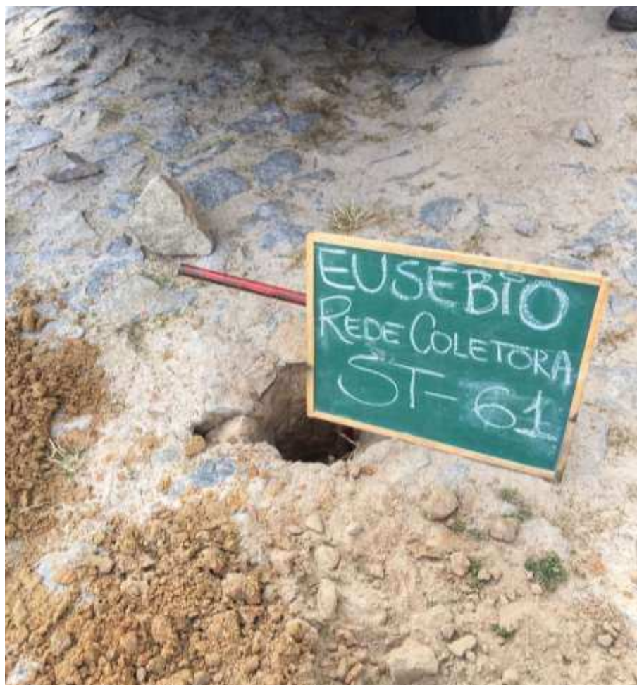
Instalação do furo ST-61
