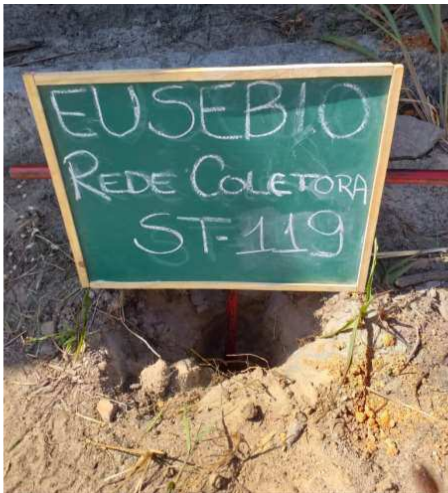
Instalação do furo ST-119
