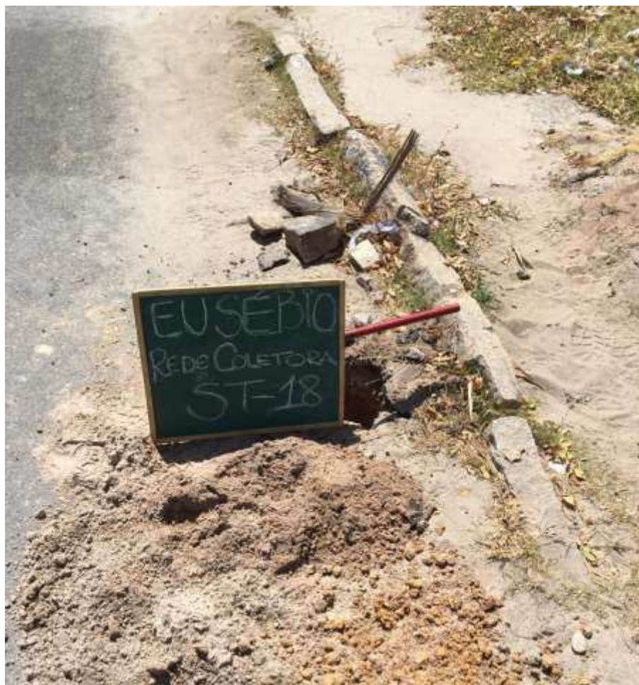
Instalação do furo ST-18
