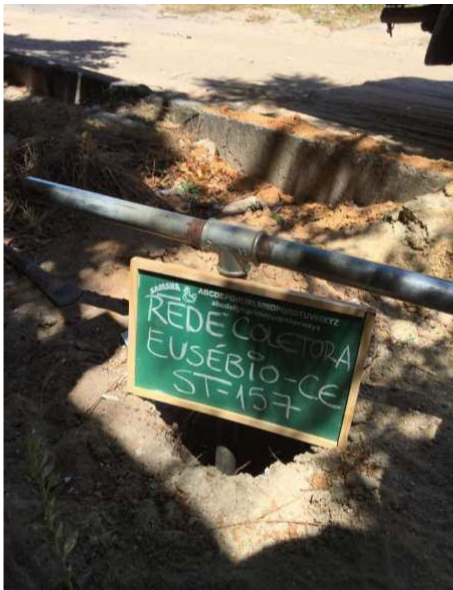
Instalação do furo ST-157
