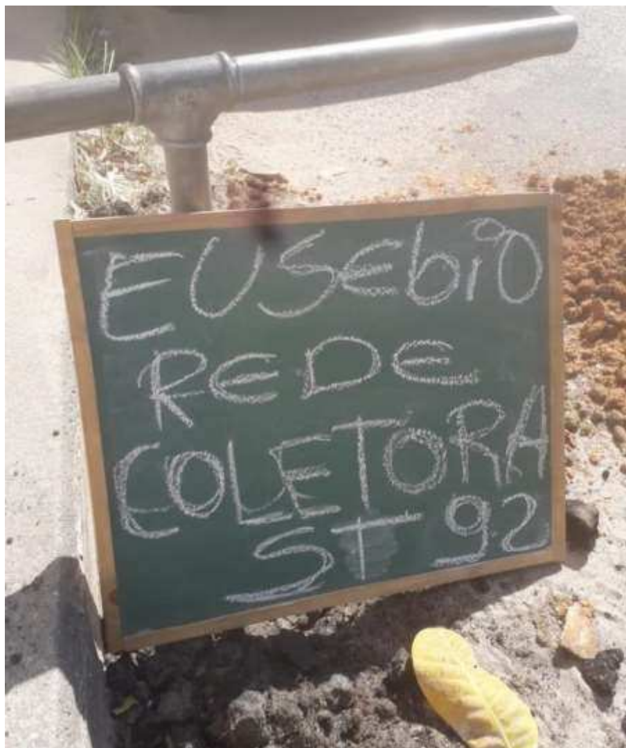
Instalação do furo ST-92
