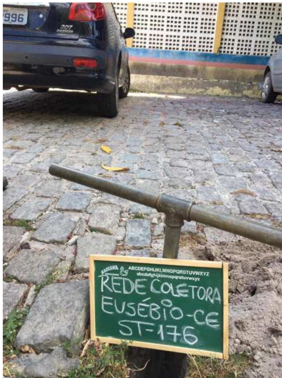
Instalação do furo ST-176
