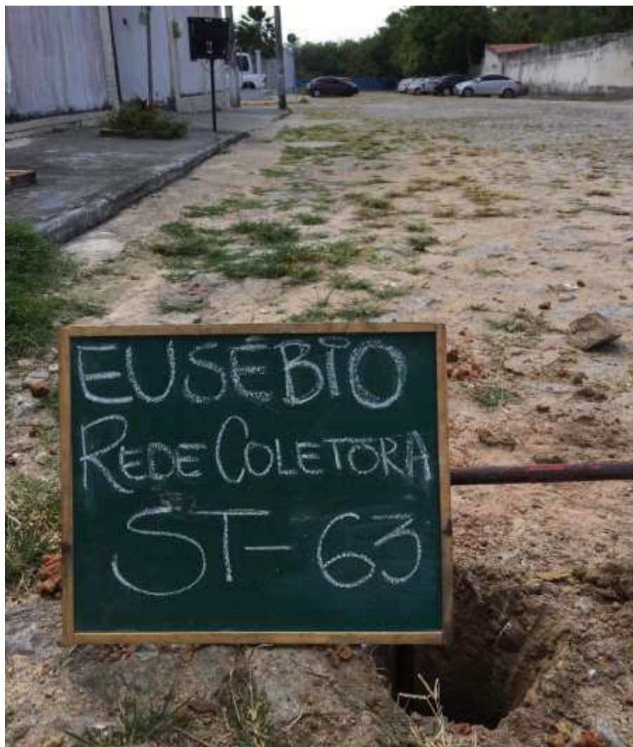
Instalação do furo ST-63
