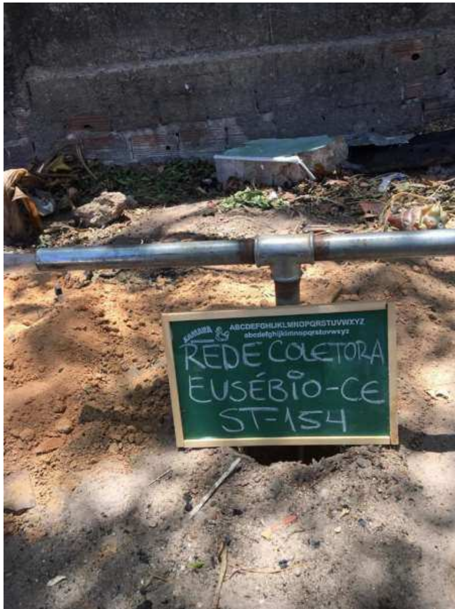
Instalação do furo ST-154
