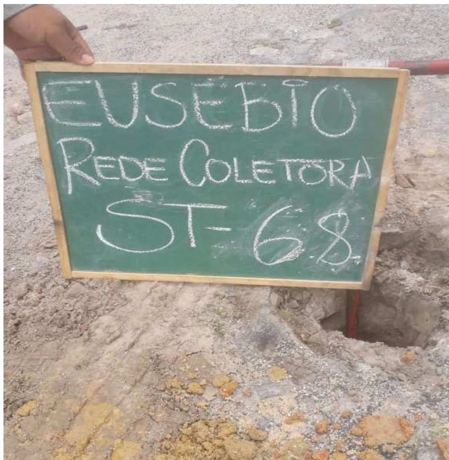
Instalação do furo ST-68
