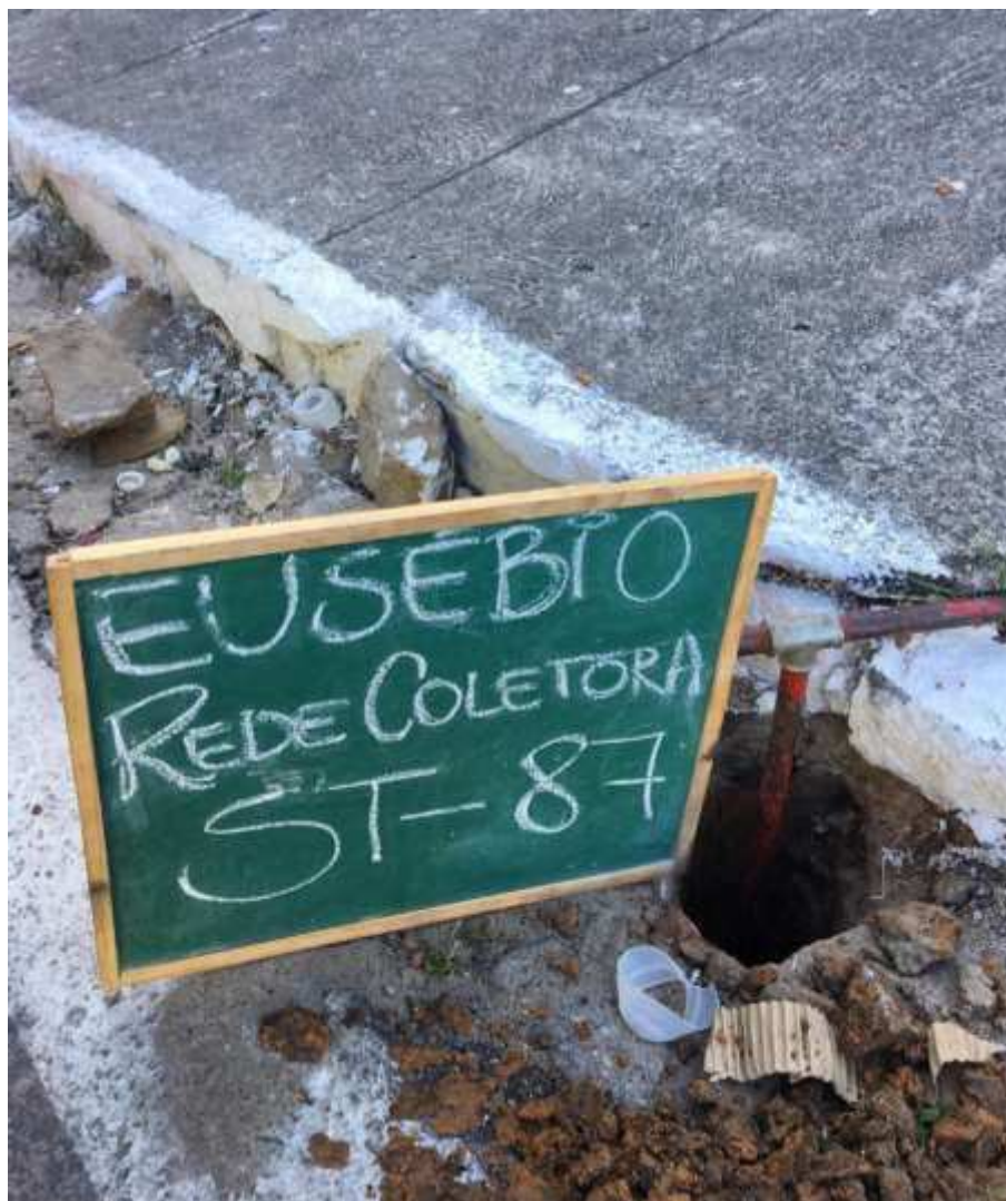
Instalação do furo ST-87
