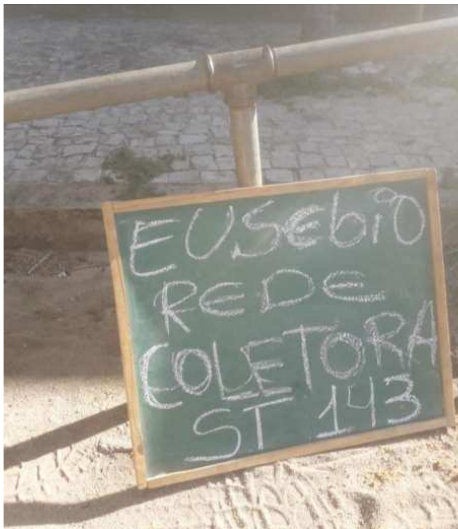
Instalação do furo ST-143
