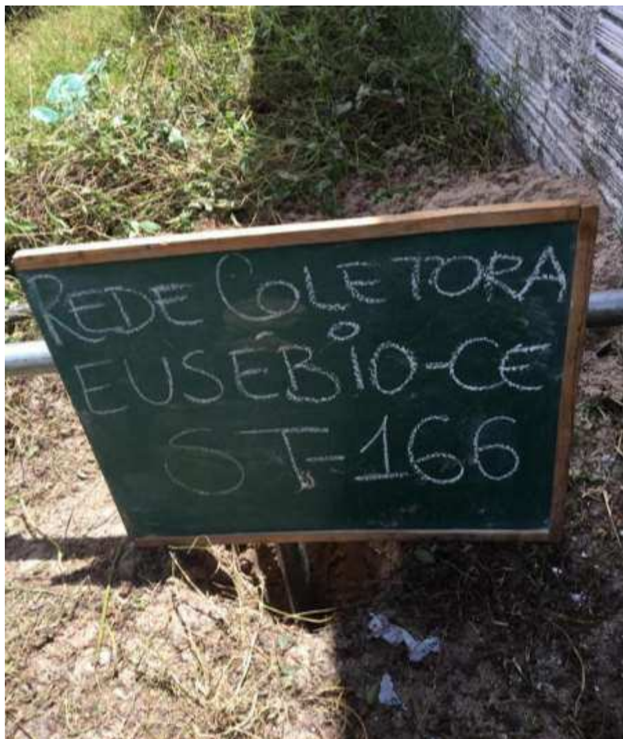
Instalação do furo ST-166
