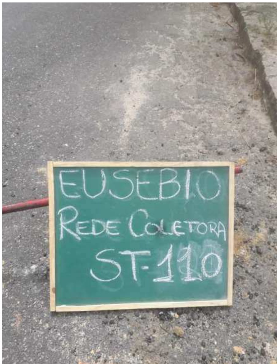
Instalação do furo ST-110
