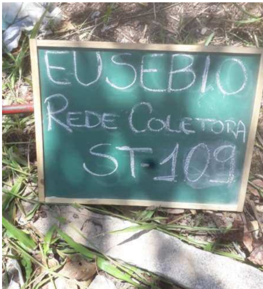
Instalação do furo ST-109
