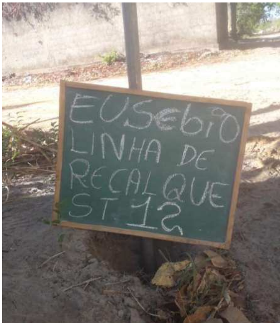
Instalação do furo ST-12
