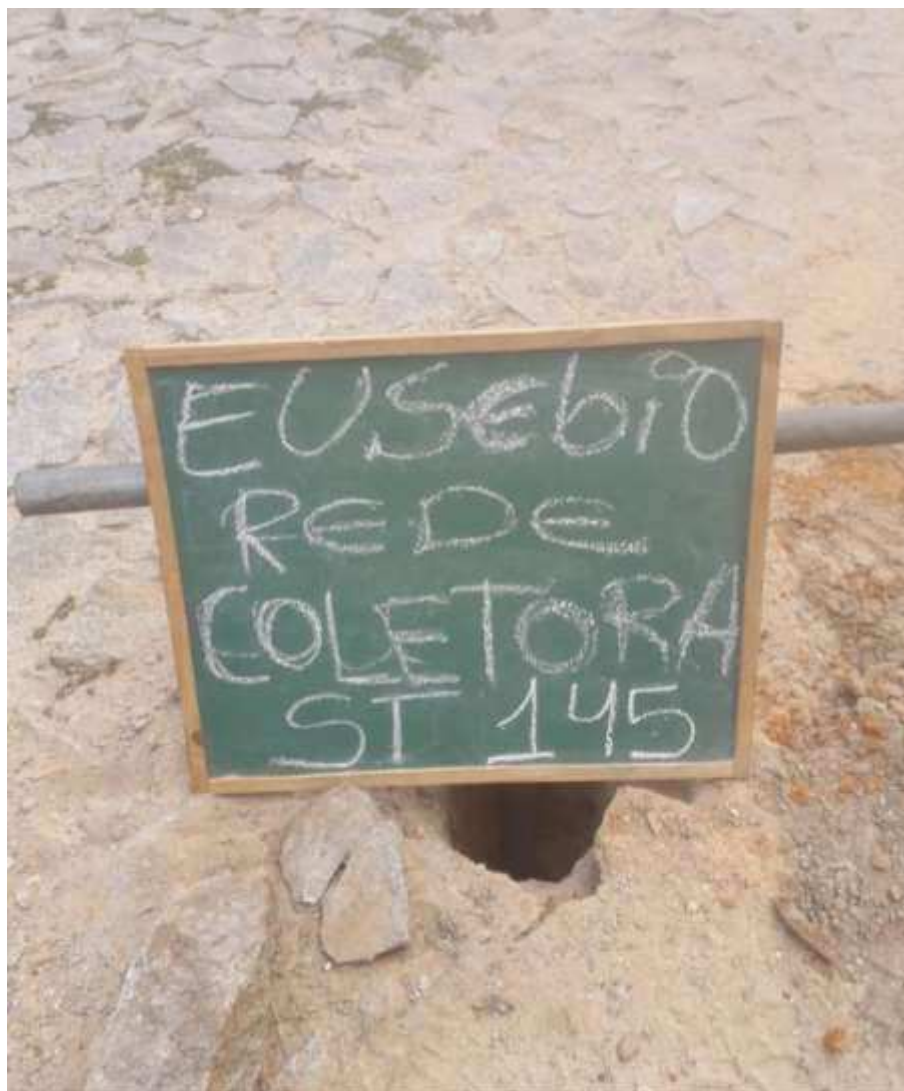
Instalação do furo ST-145
