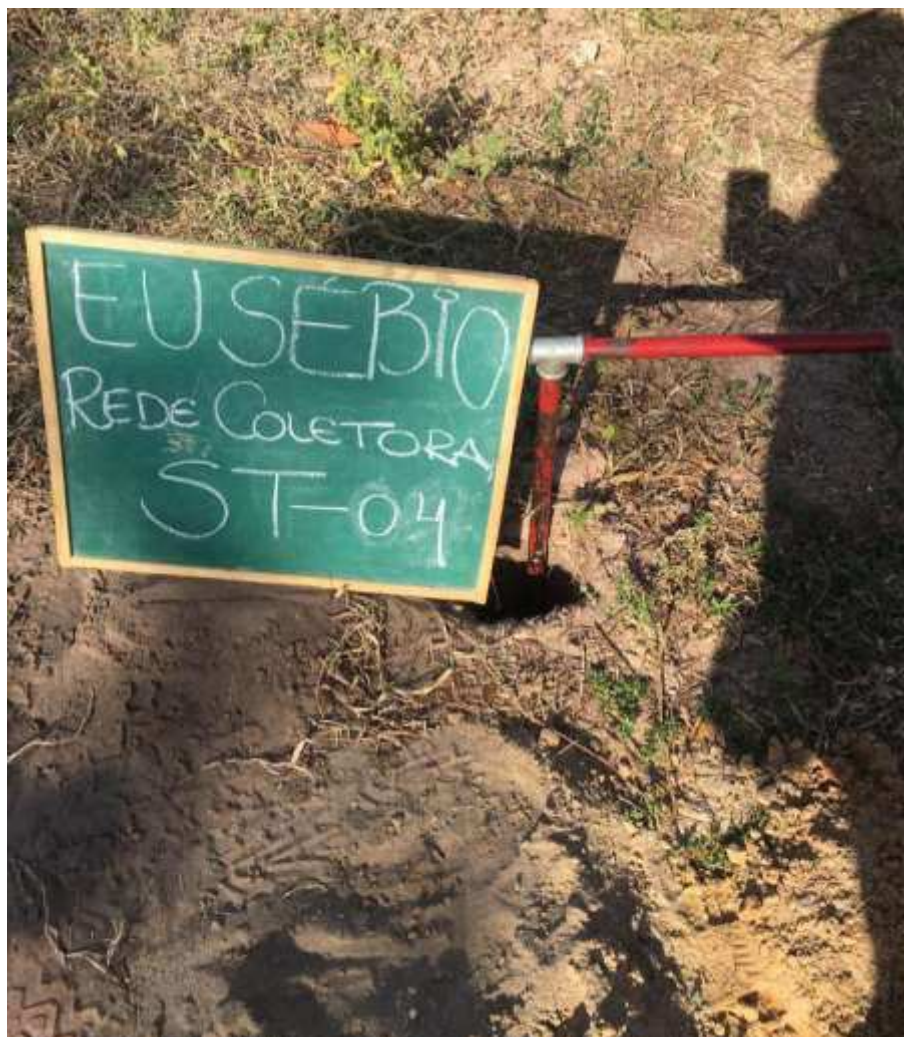
Instalação do furo ST-04
