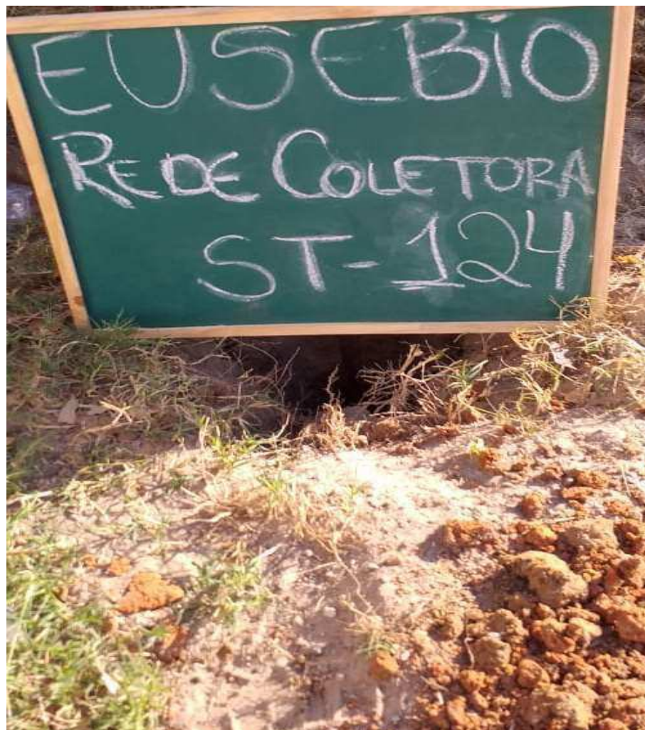
Instalação do furo ST-124
