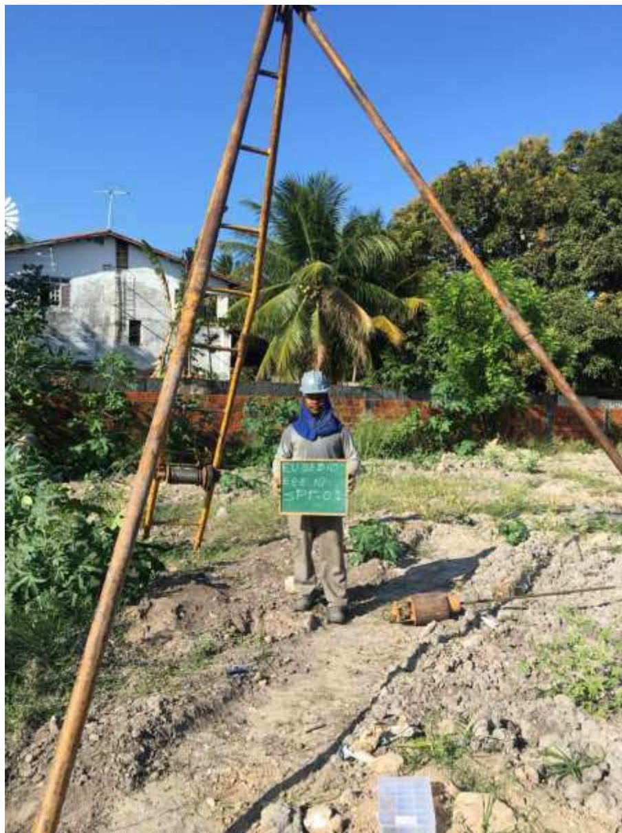
Instalação do furo SP-01
