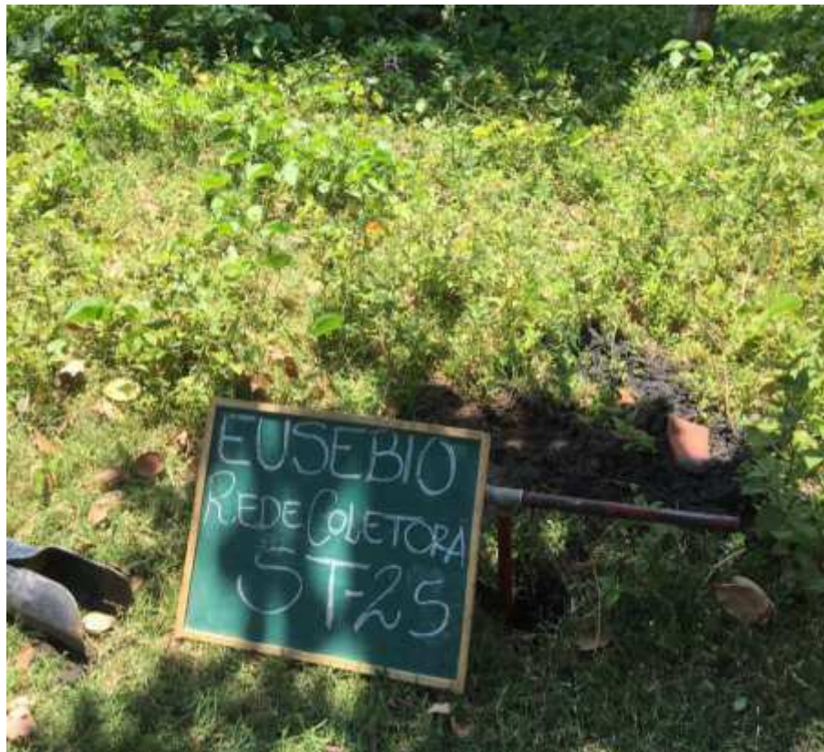
Instalação do furo ST-25
