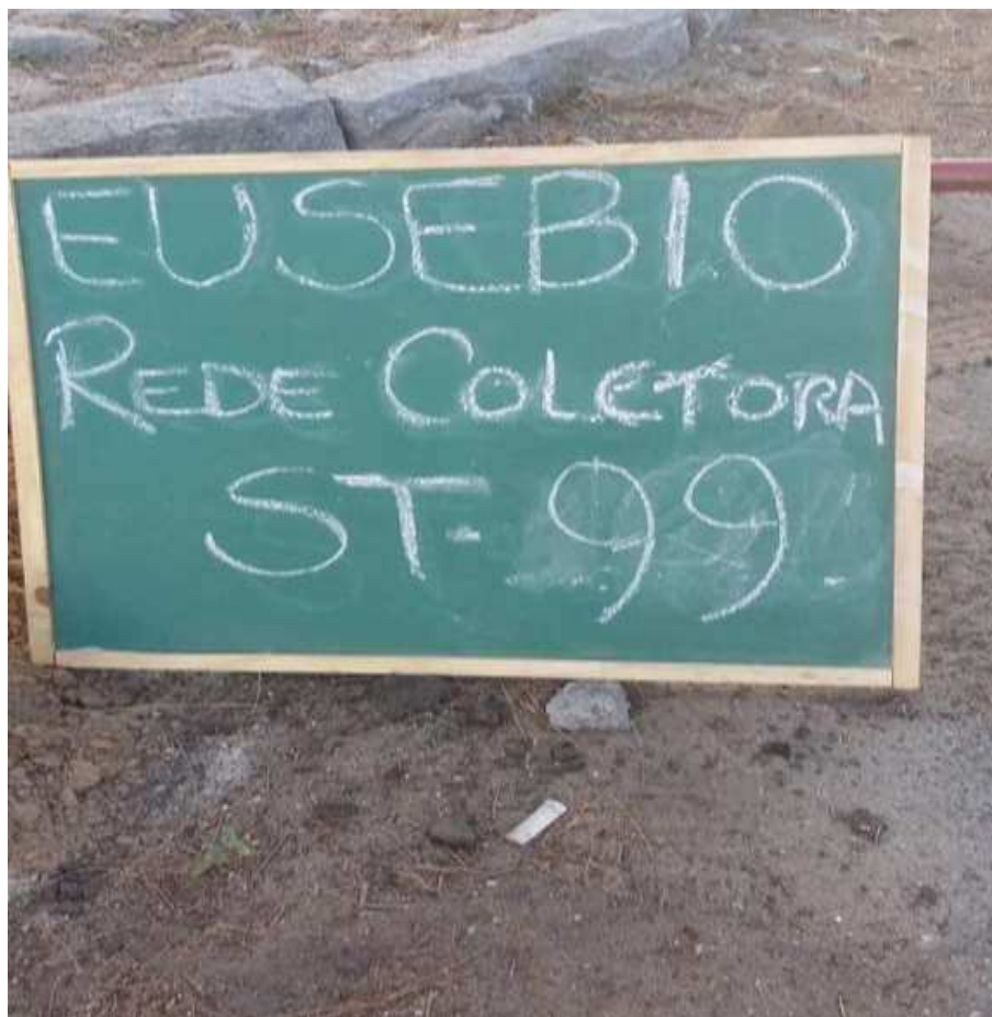
Instalação do furo ST-99
