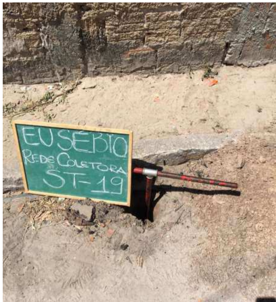
Instalação do furo ST-19
