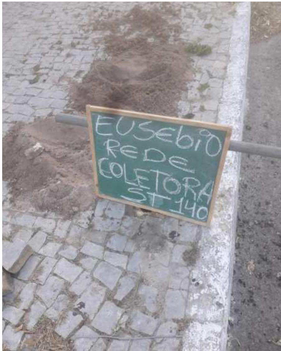
Instalação do furo ST-140
