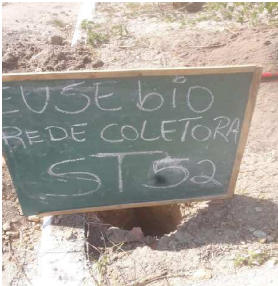
Instalação do furo ST-52
