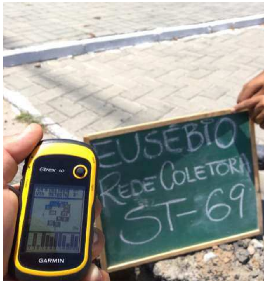
Instalação do furo ST-69
