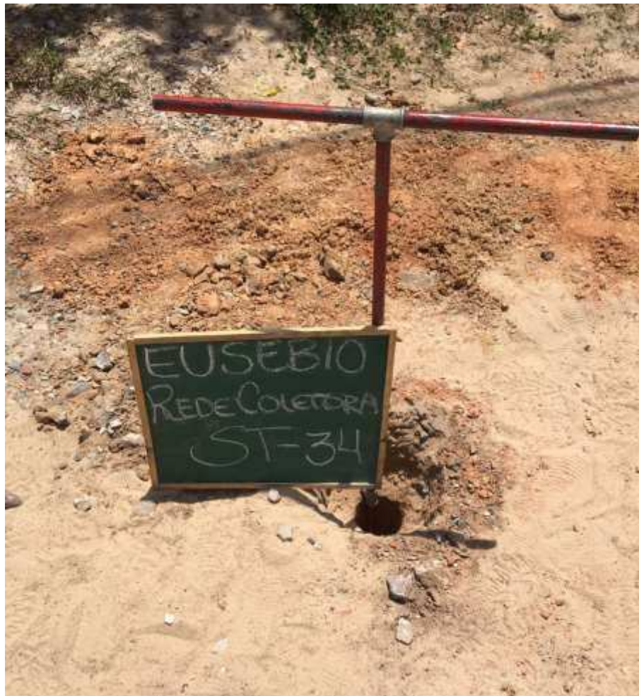
Instalação do furo ST-34
