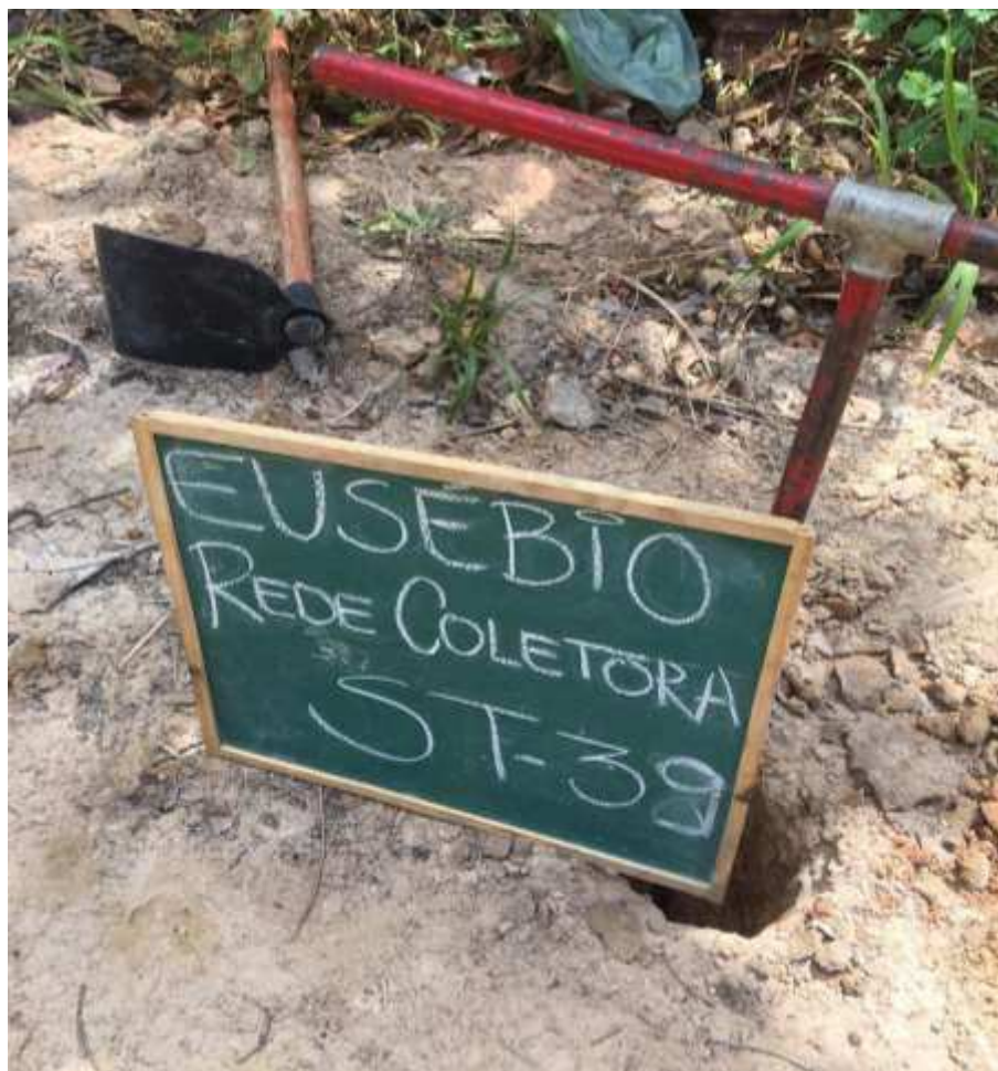
Instalação do furo ST-39
