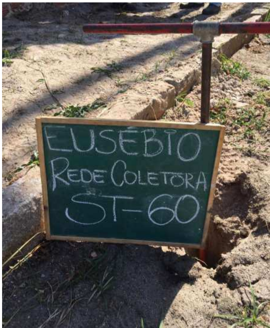
Instalação do furo ST-60
