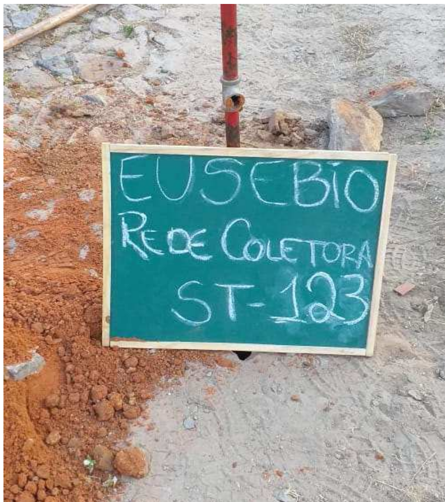
Instalação do furo ST-123
