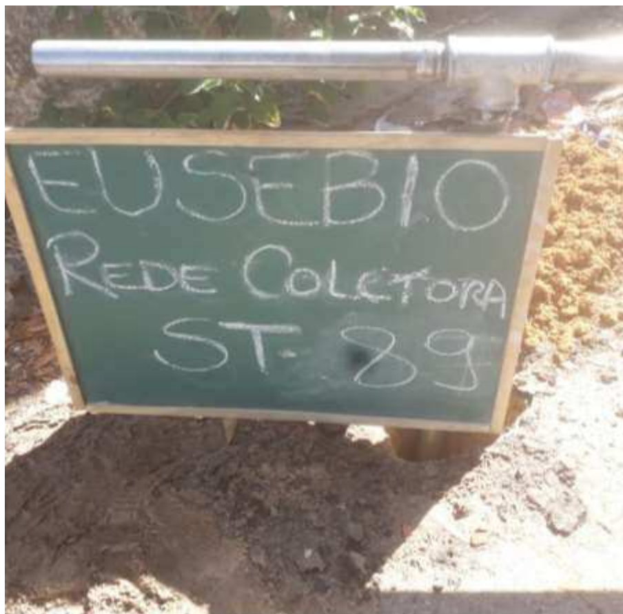
Instalação do furo ST-89
