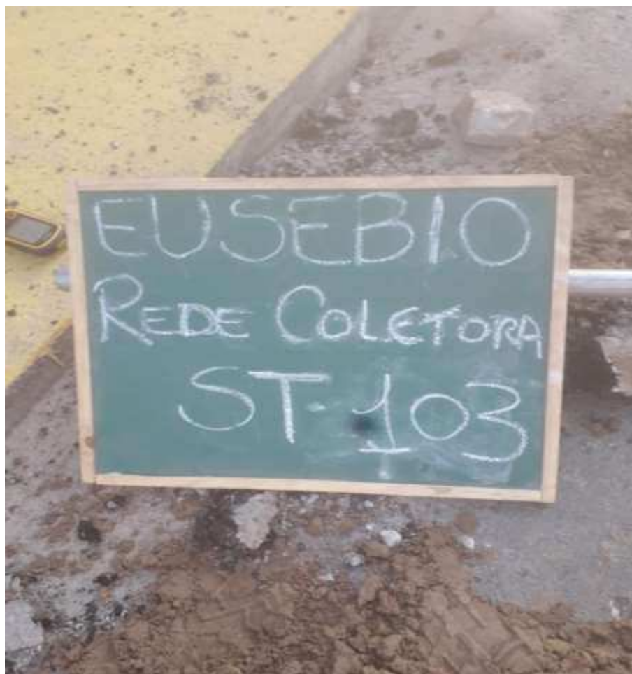
Instalação do furo ST-103
