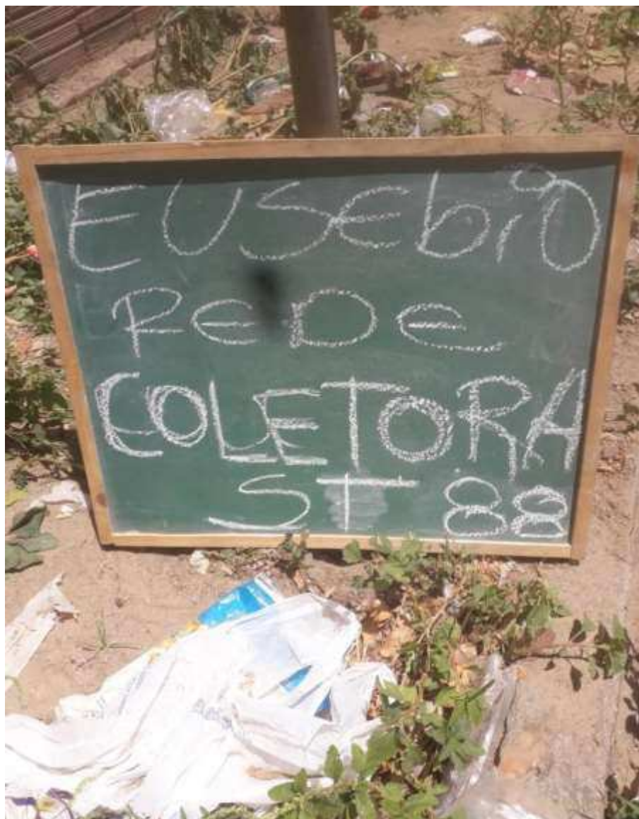
Instalação do furo ST-88
