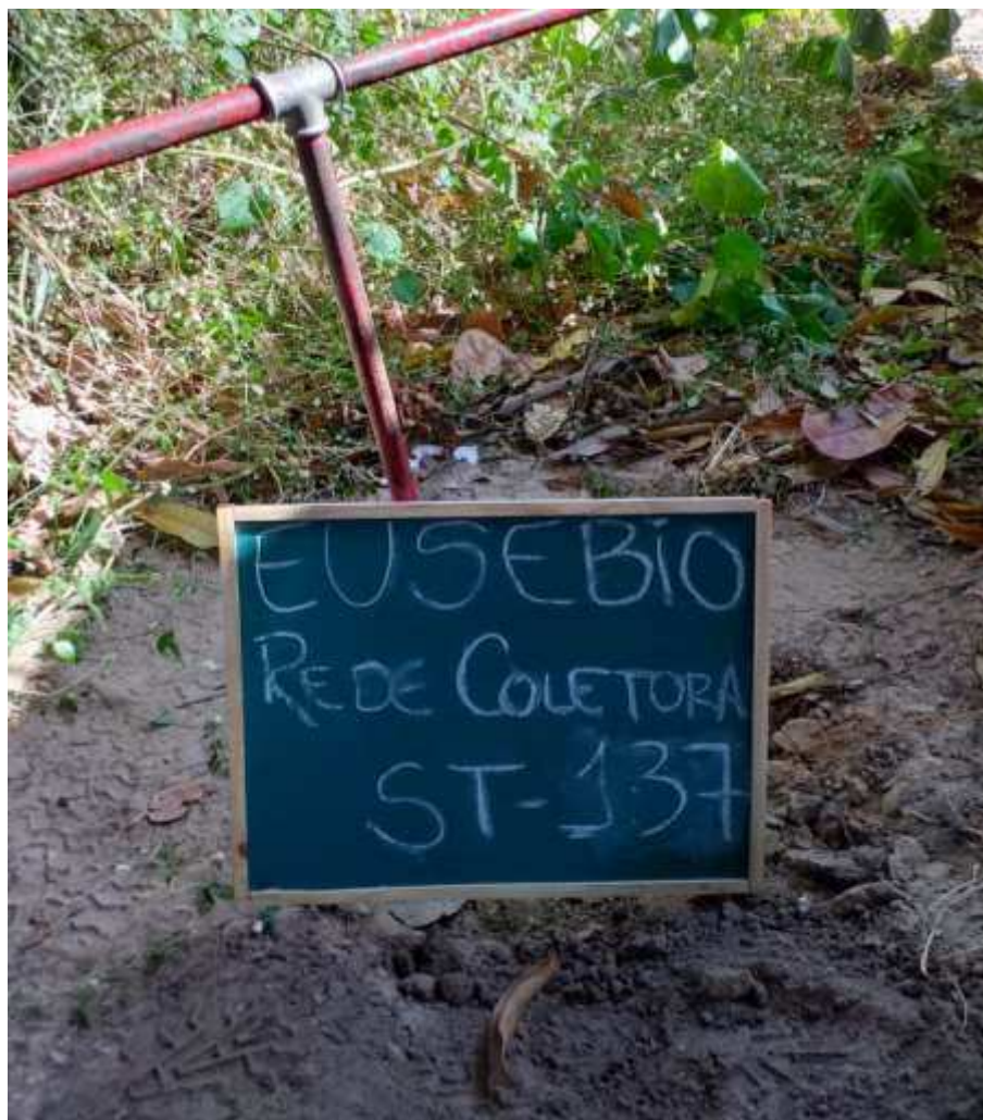
Instalação do furo ST-137
