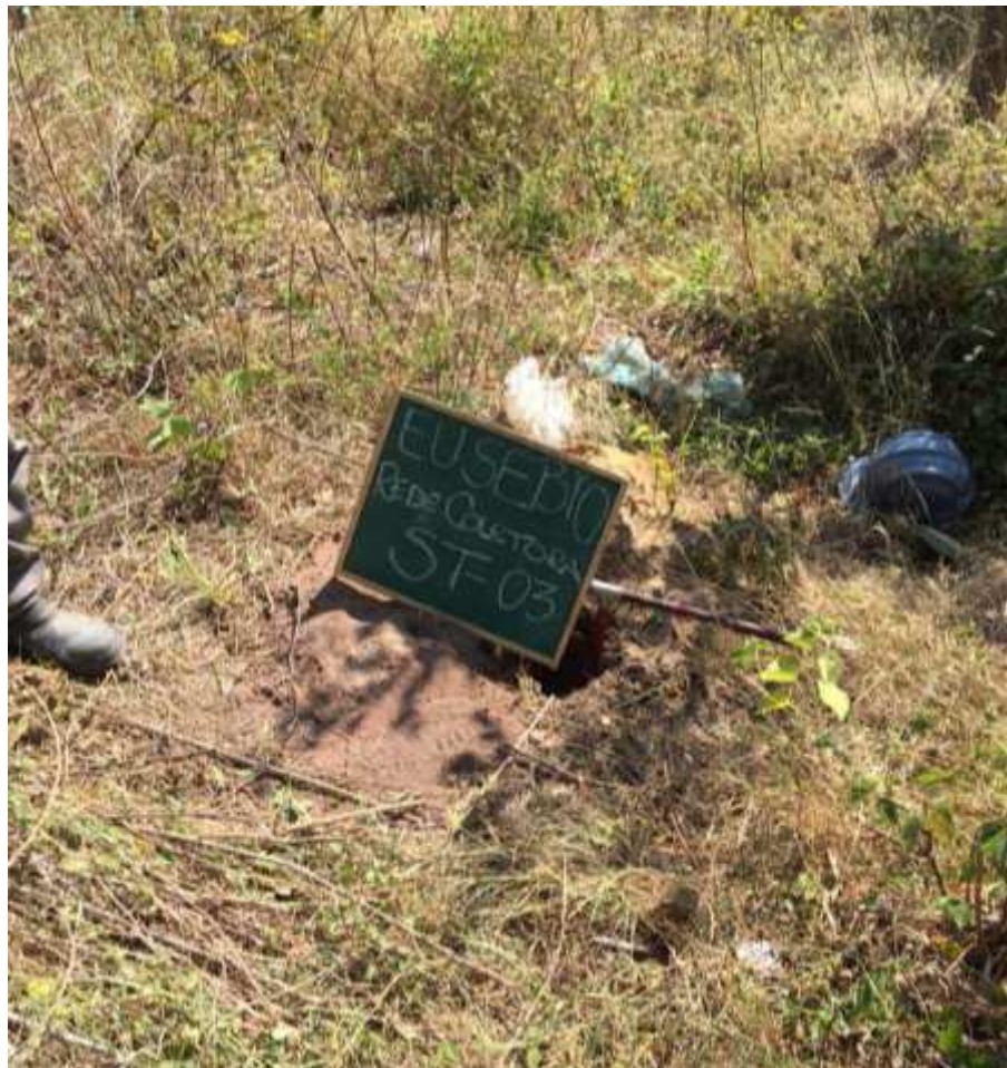
Instalação do furo ST-03
