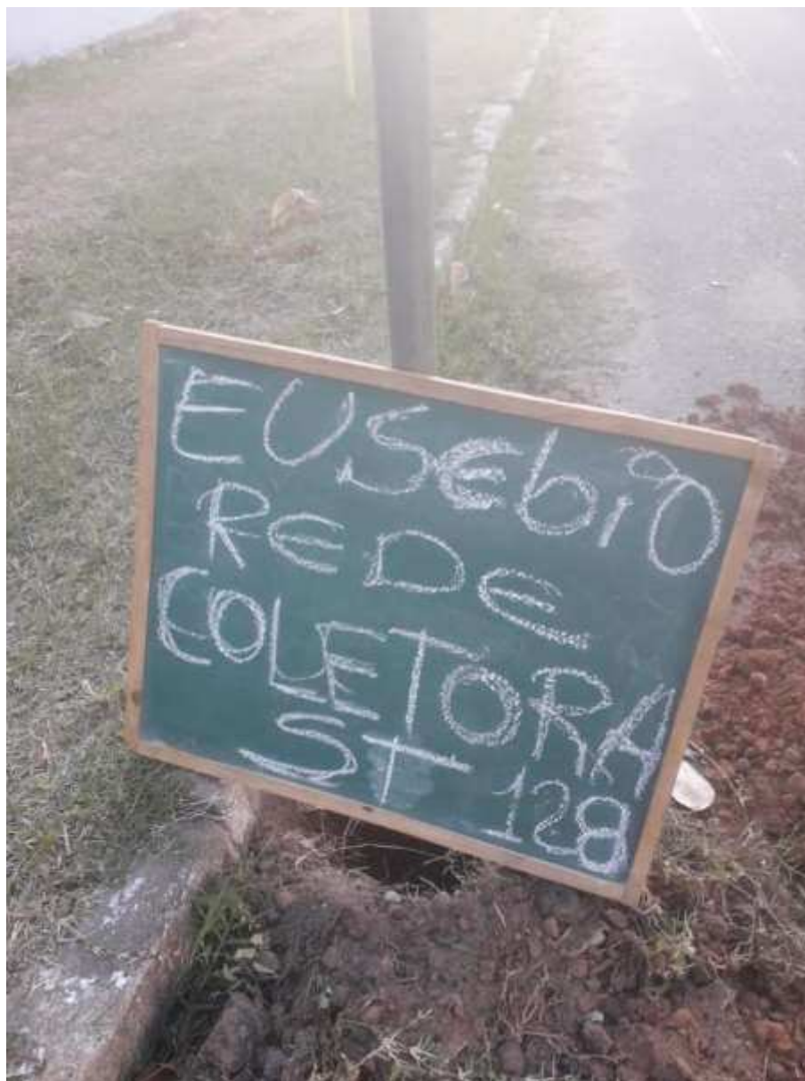
Instalação do furo ST-128
