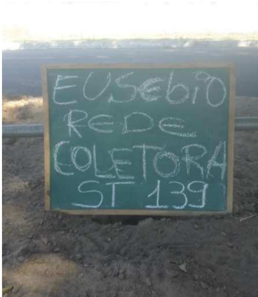
Instalação do furo ST-139
