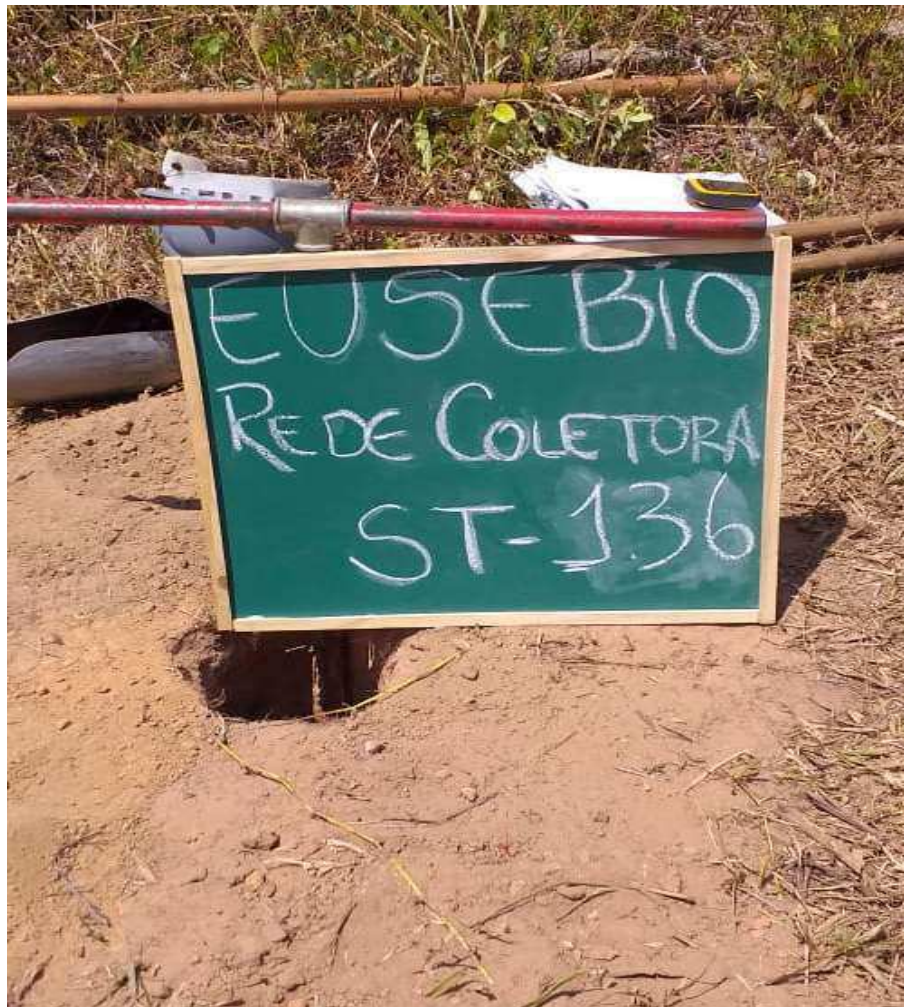
Instalação do furo ST-136
