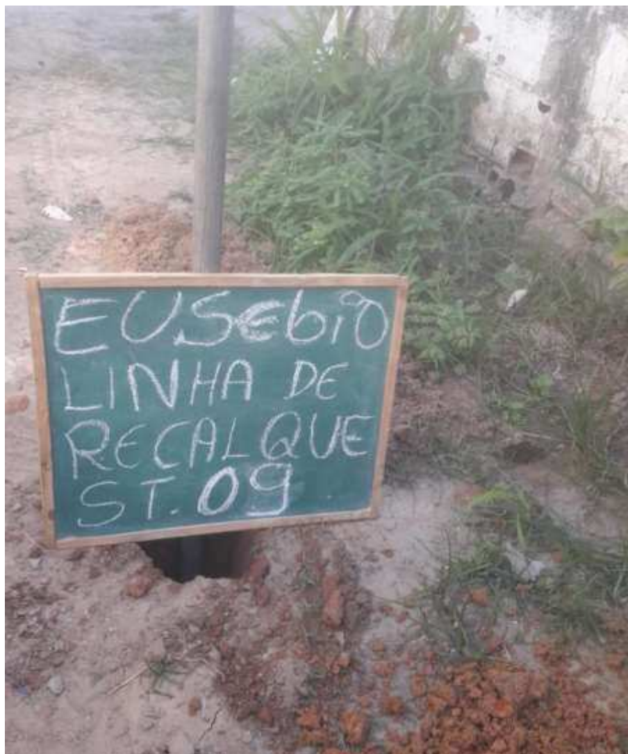
Instalação do furo ST-09
