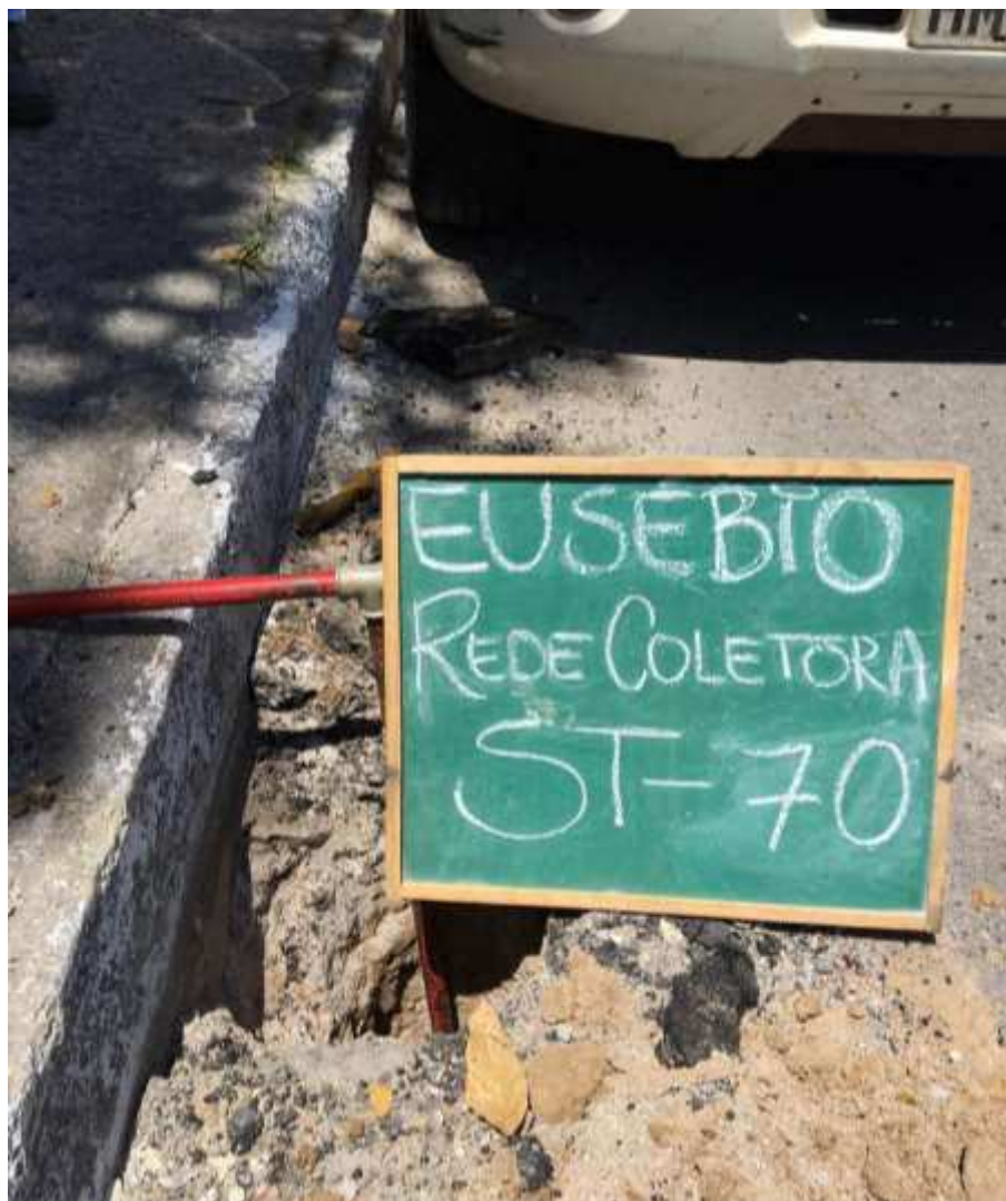
Instalação do furo ST-70
