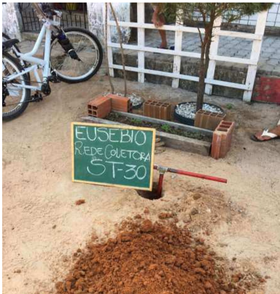
Instalação do furo ST-30
