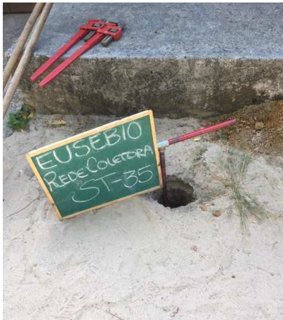
Instalação do furo ST-35
