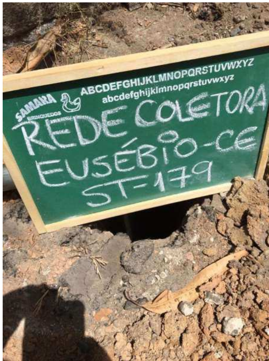
Instalação do furo ST-179
