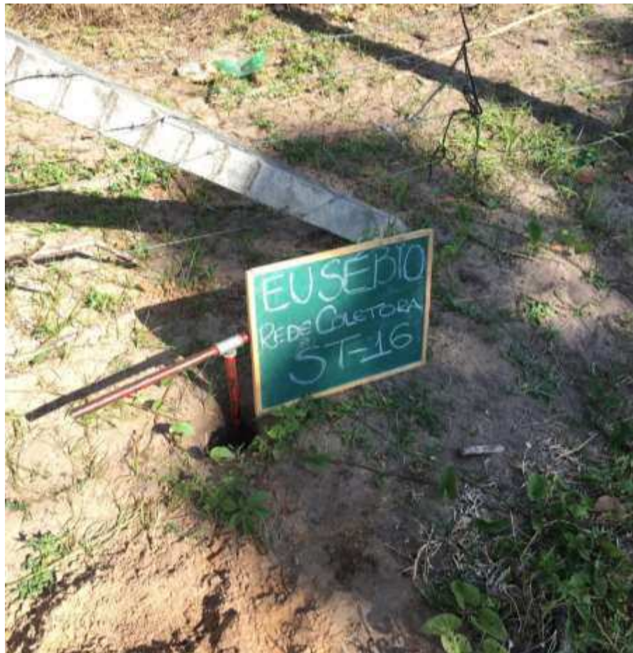
Instalação do furo ST-16
