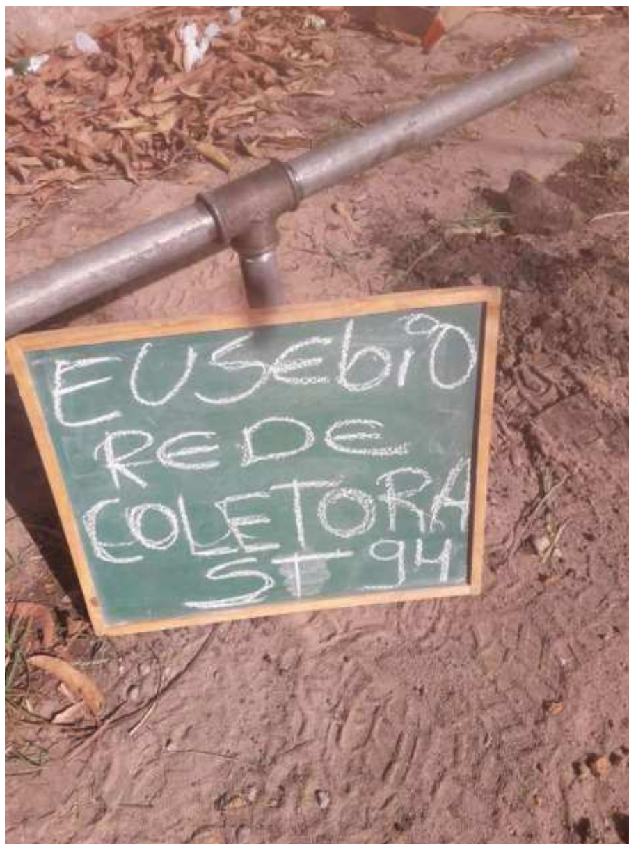
Instalação do furo ST-94
