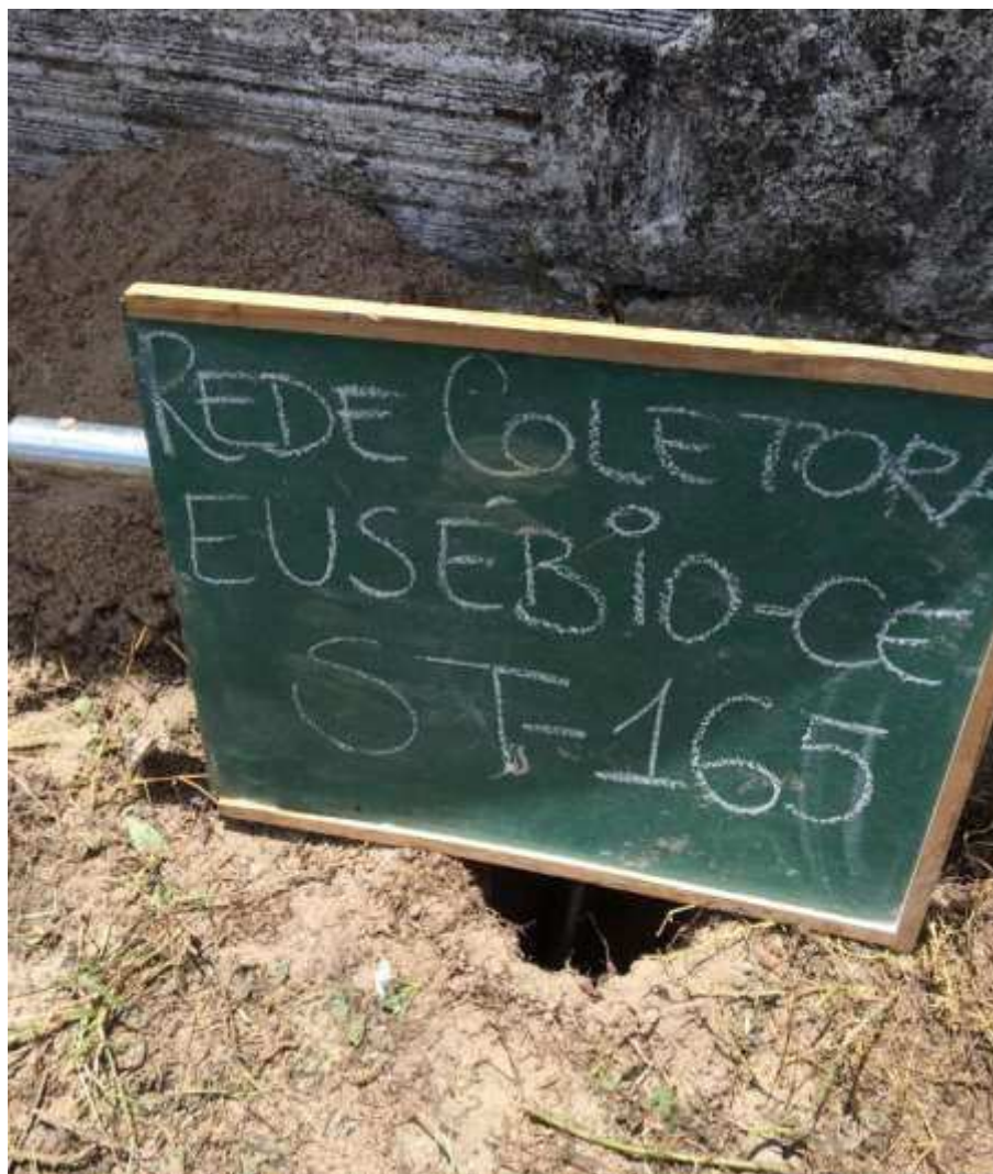
Instalação do furo ST-165
