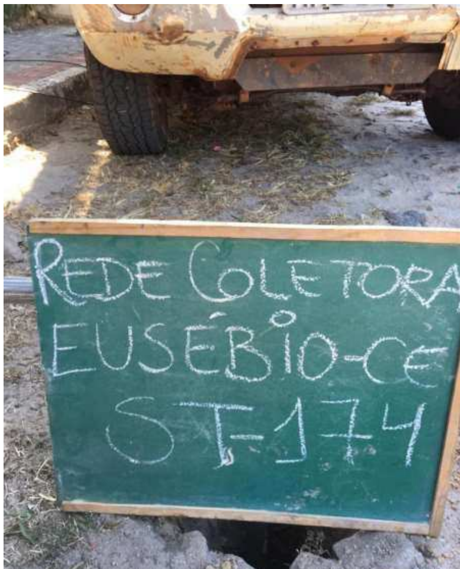
Instalação do furo ST-174
