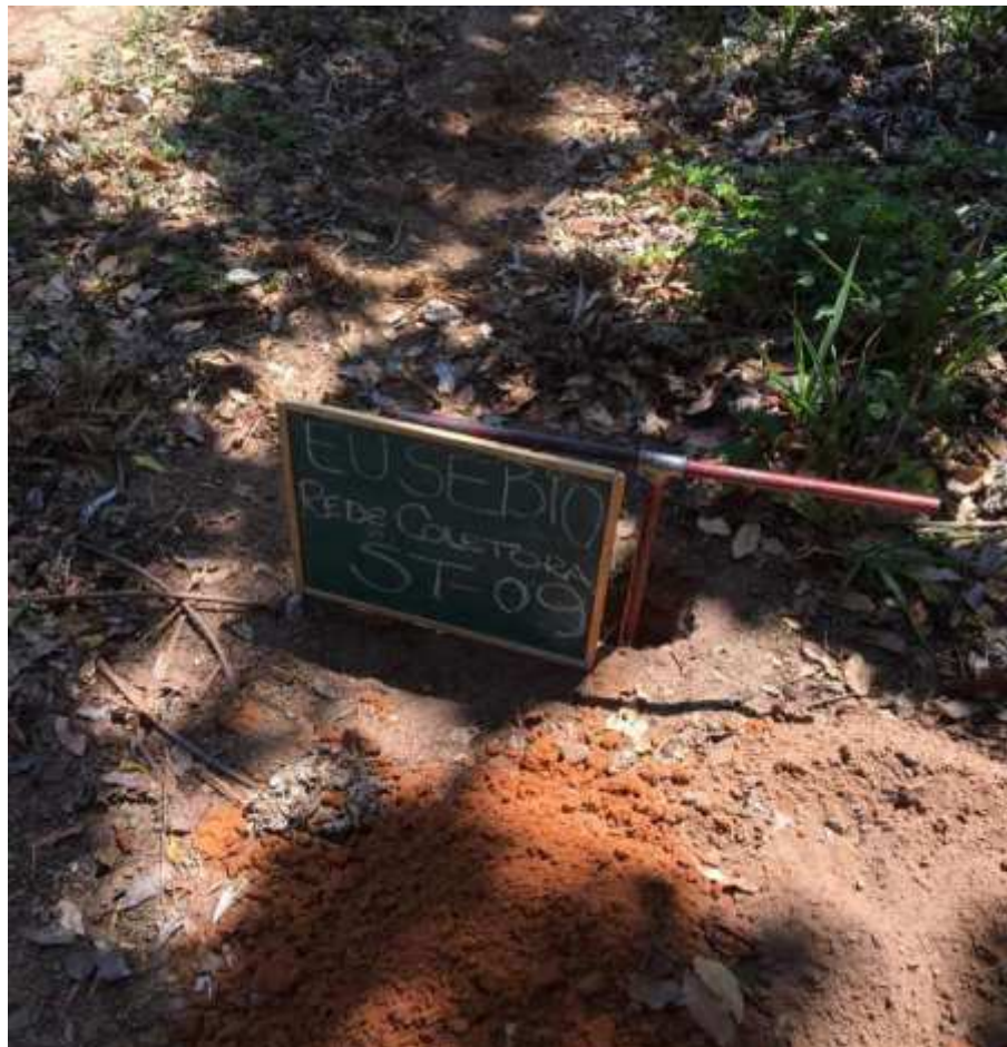
Instalação do furo ST-09
