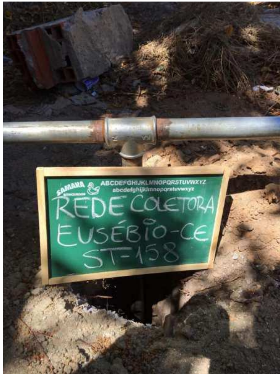
Instalação do furo ST-158
