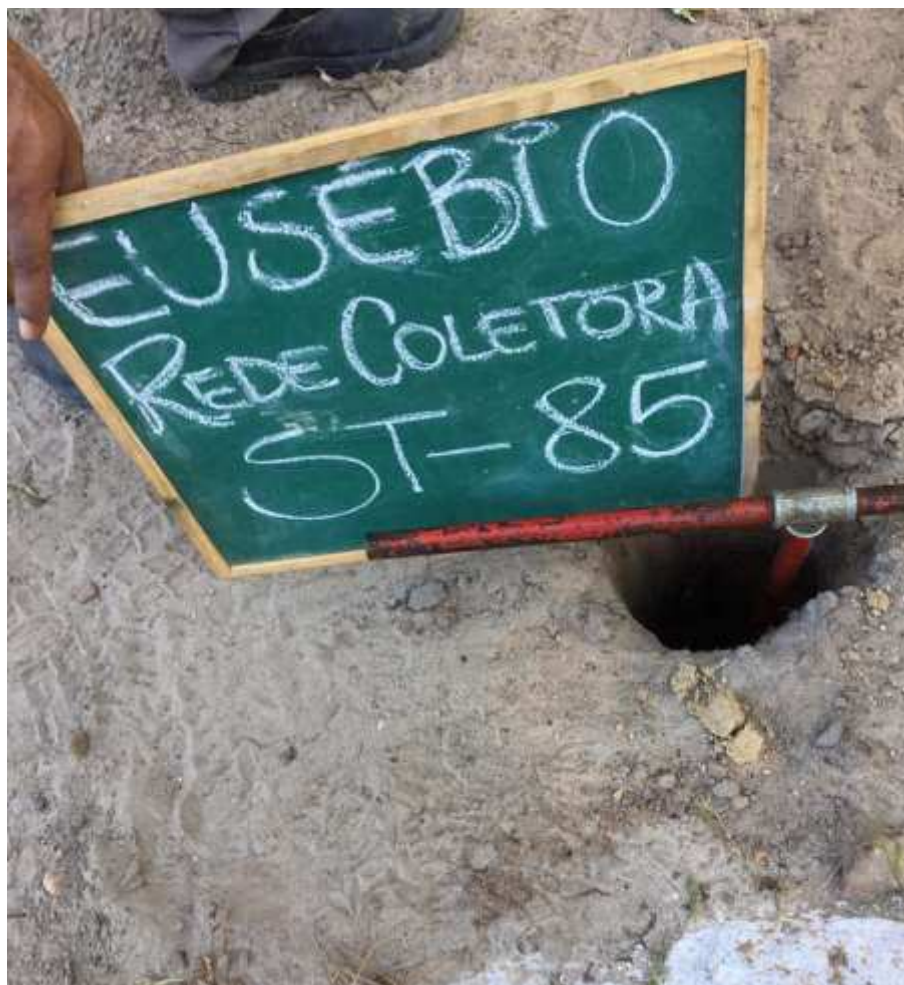
Instalação do furo ST-85
