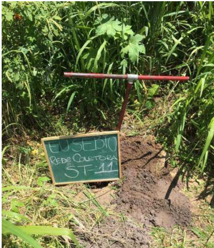
Instalação do furo ST-11
