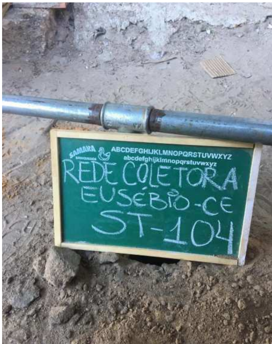
Instalação do furo ST-104
