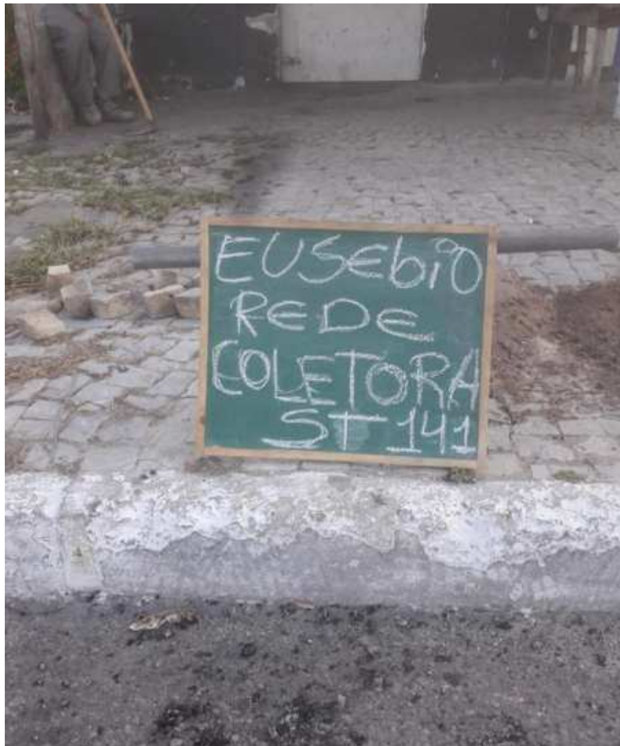
Instalação do furo ST-141
