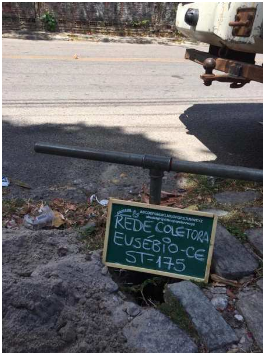
Instalação do furo ST-175
