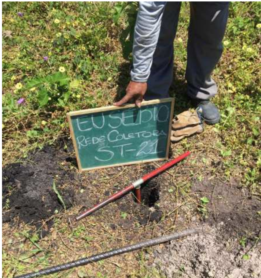
Instalação do furo ST-21
