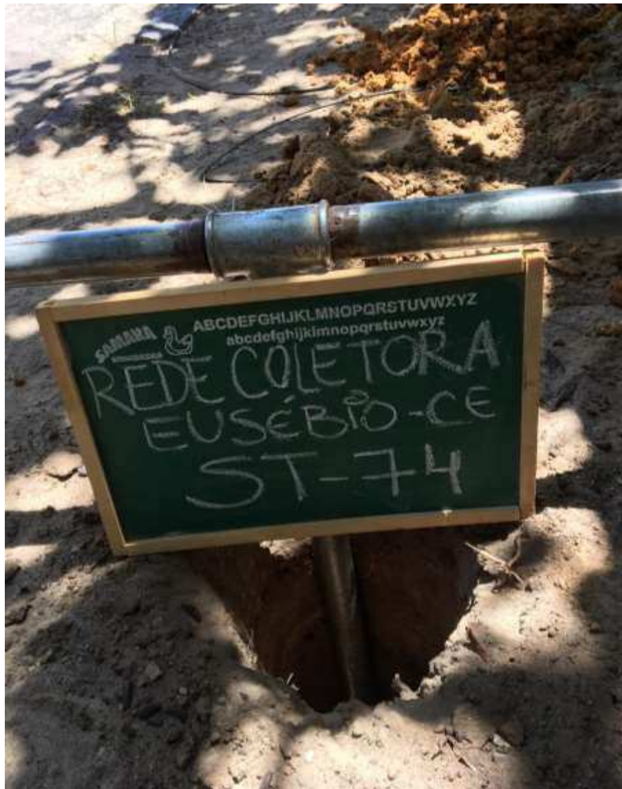
Instalação do furo ST-74
