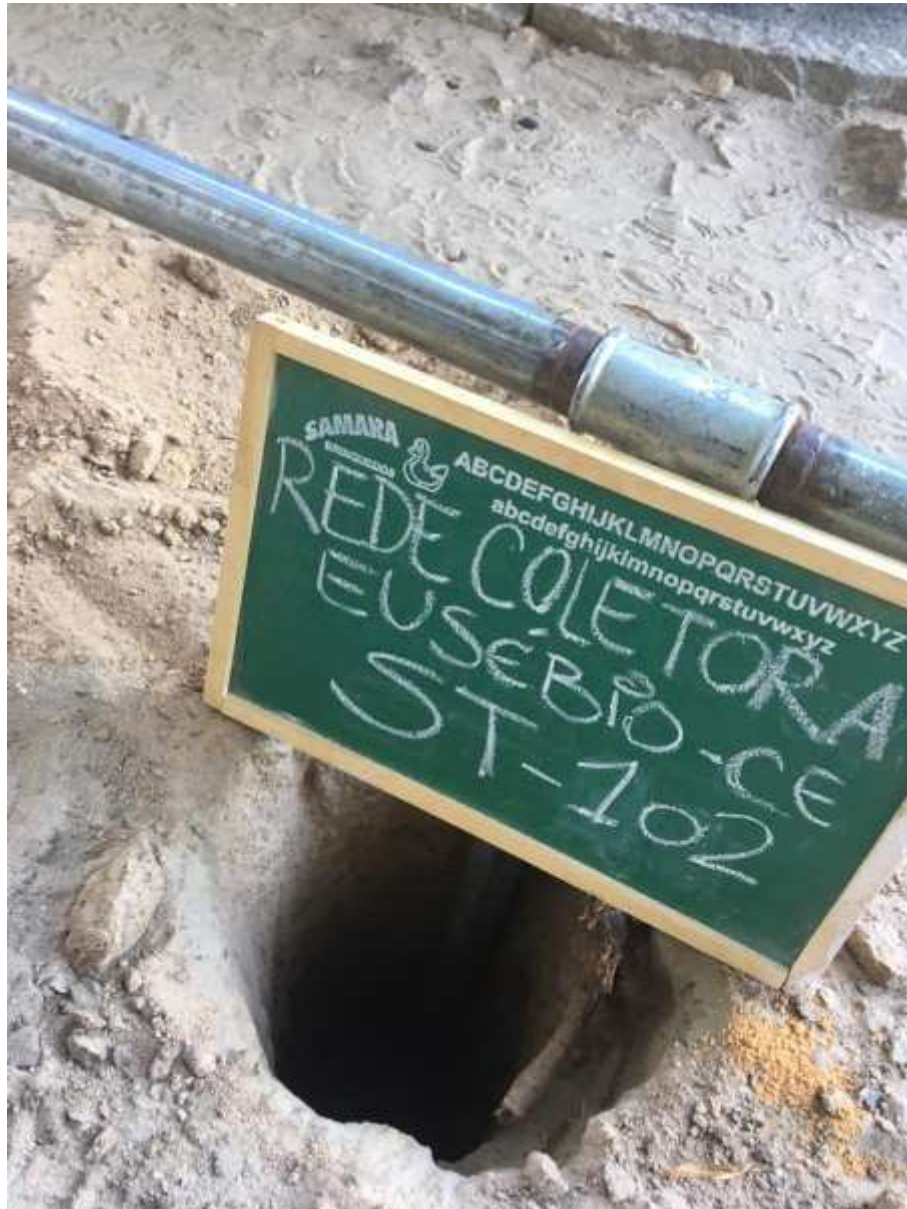
Instalação do furo ST-102
