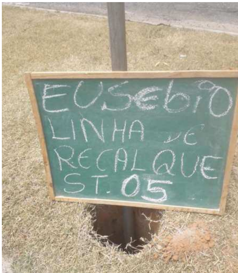
Instalação do furo ST-05
