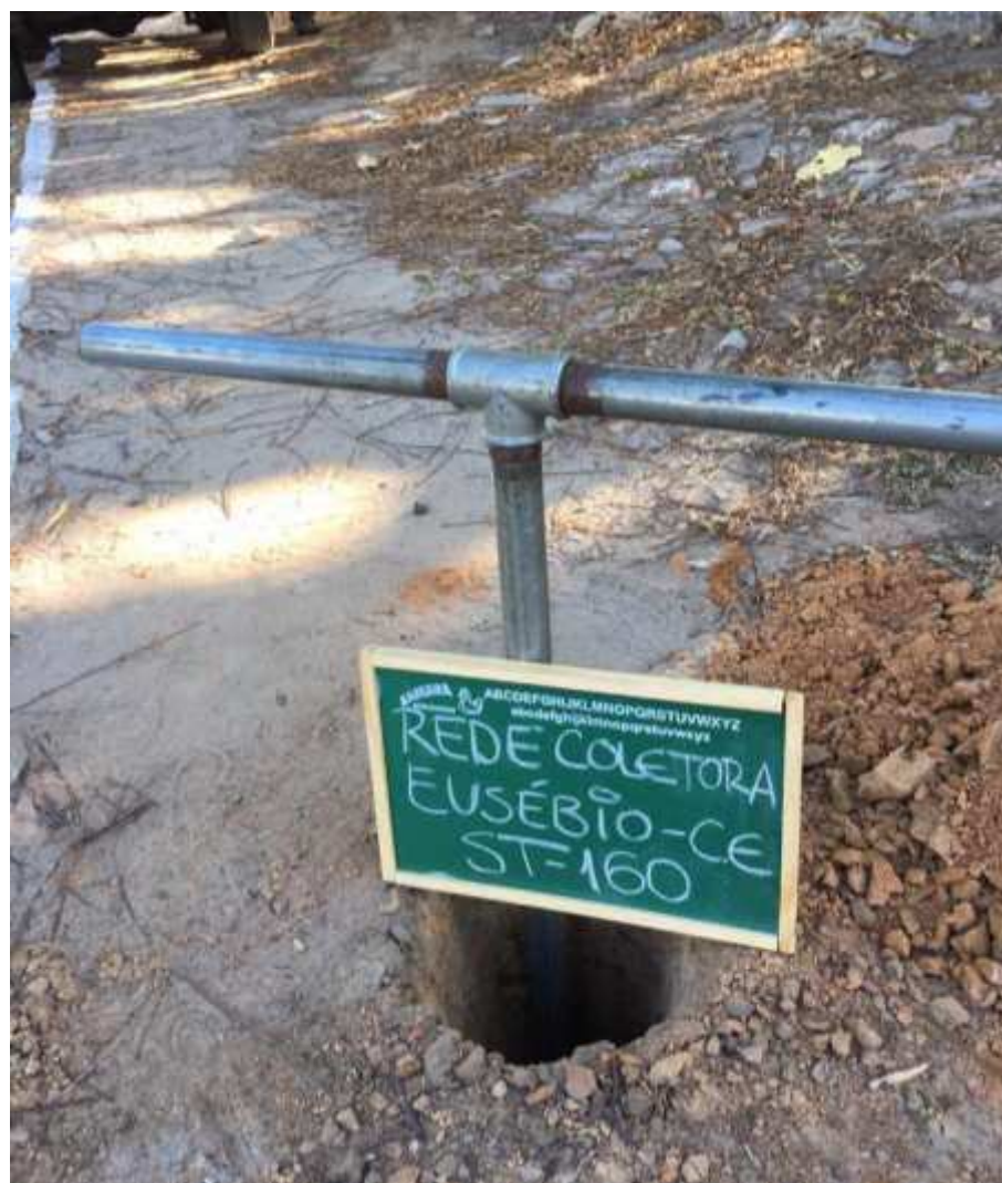
Instalação do furo ST-160
