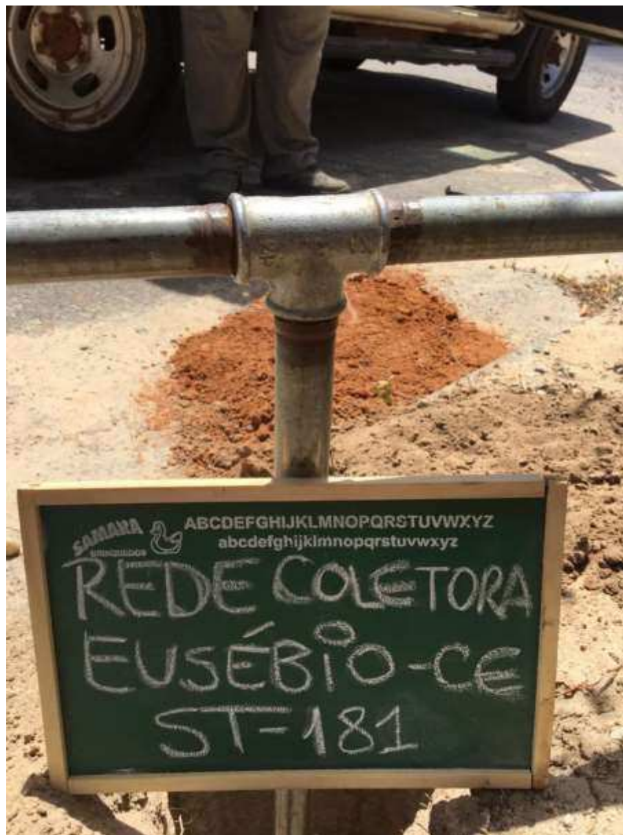
Instalação do furo ST-181
