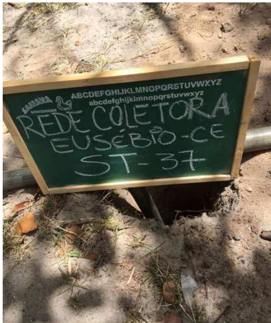
Instalação do furo ST-37
