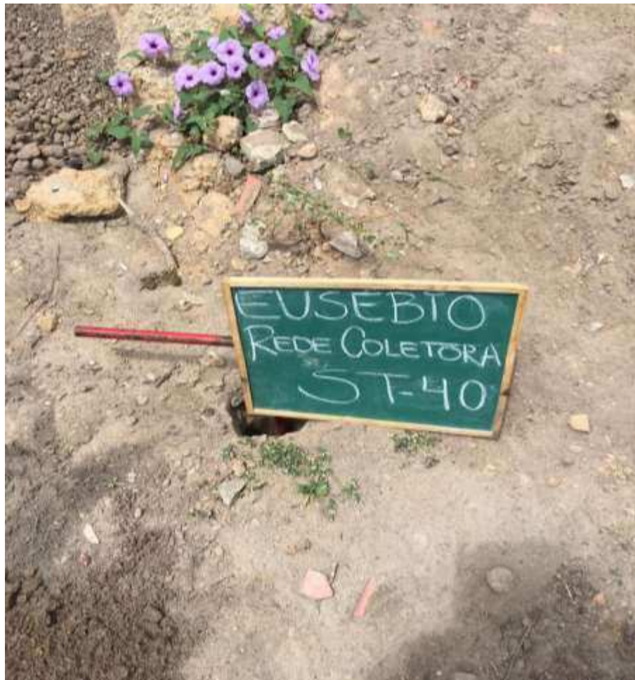
Instalação do furo ST-40
