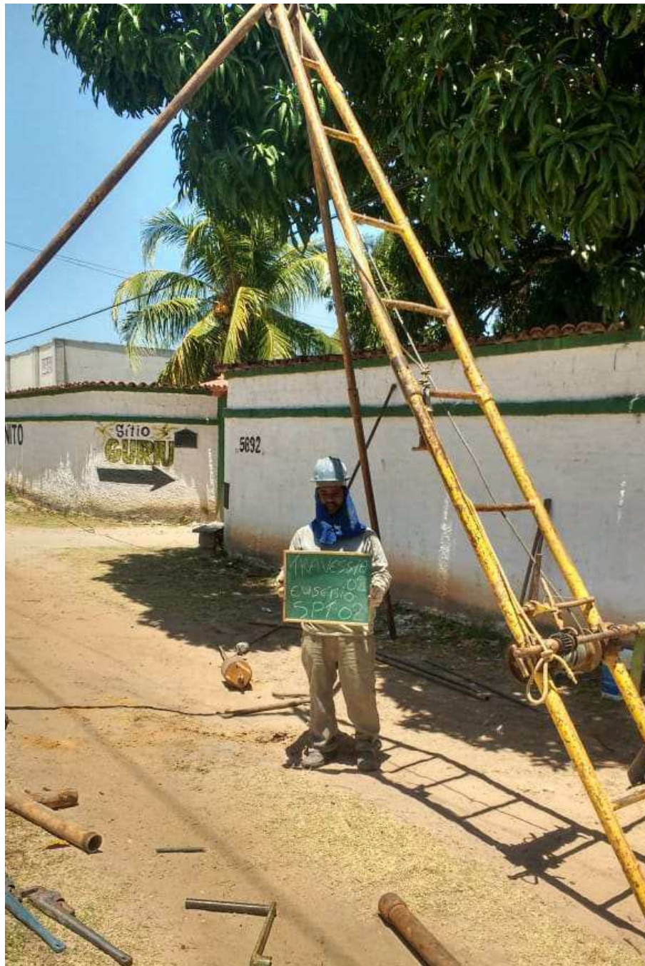
Instalação do furo SP-02
