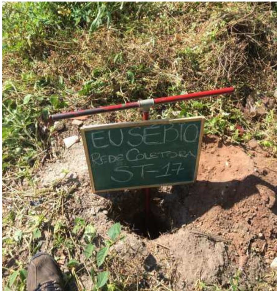
Instalação do furo ST-17
