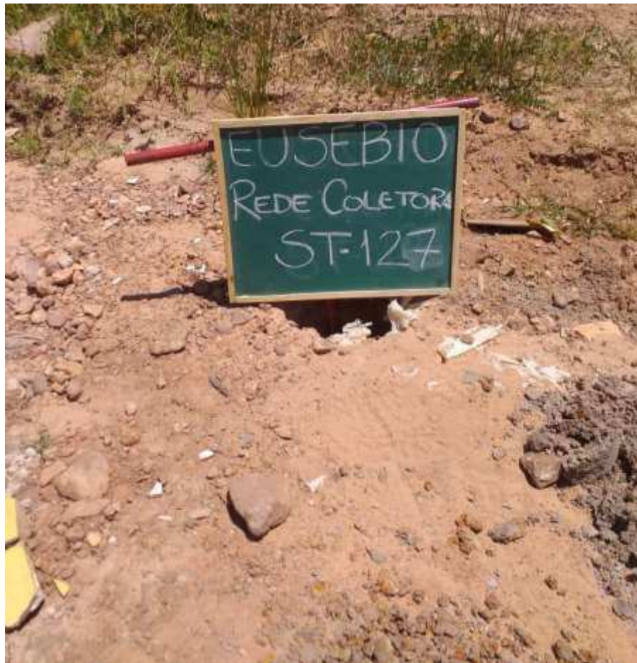
Instalação do furo ST-127
