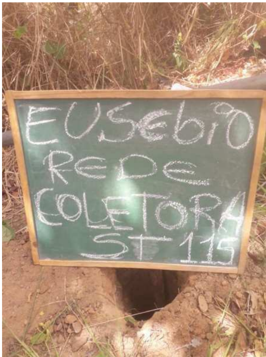
Instalação do furo ST-115
