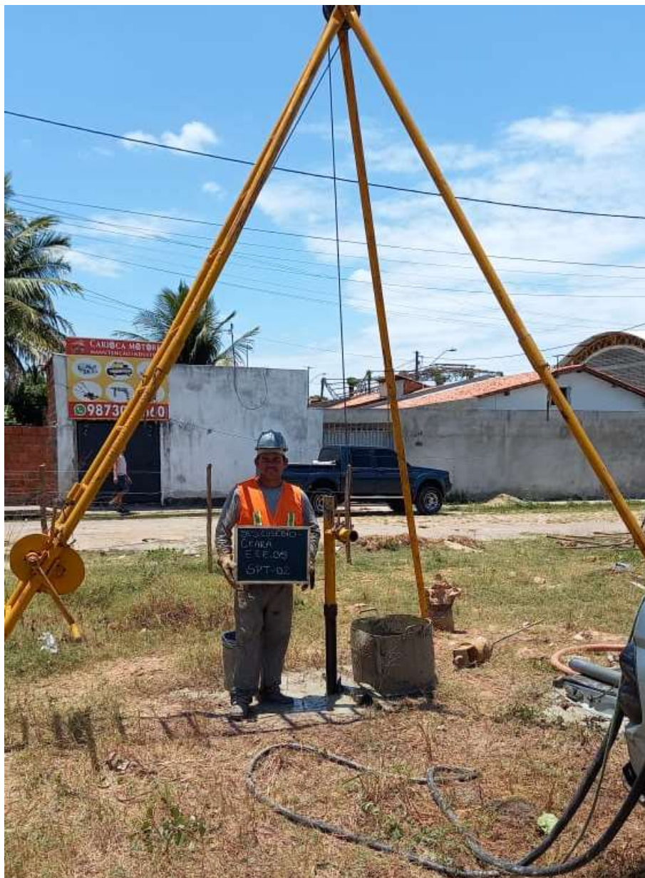
Instalação do furo SP-02
