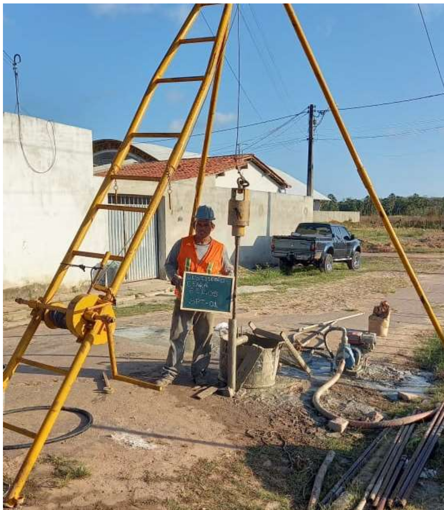
Instalação do furo SP-01
