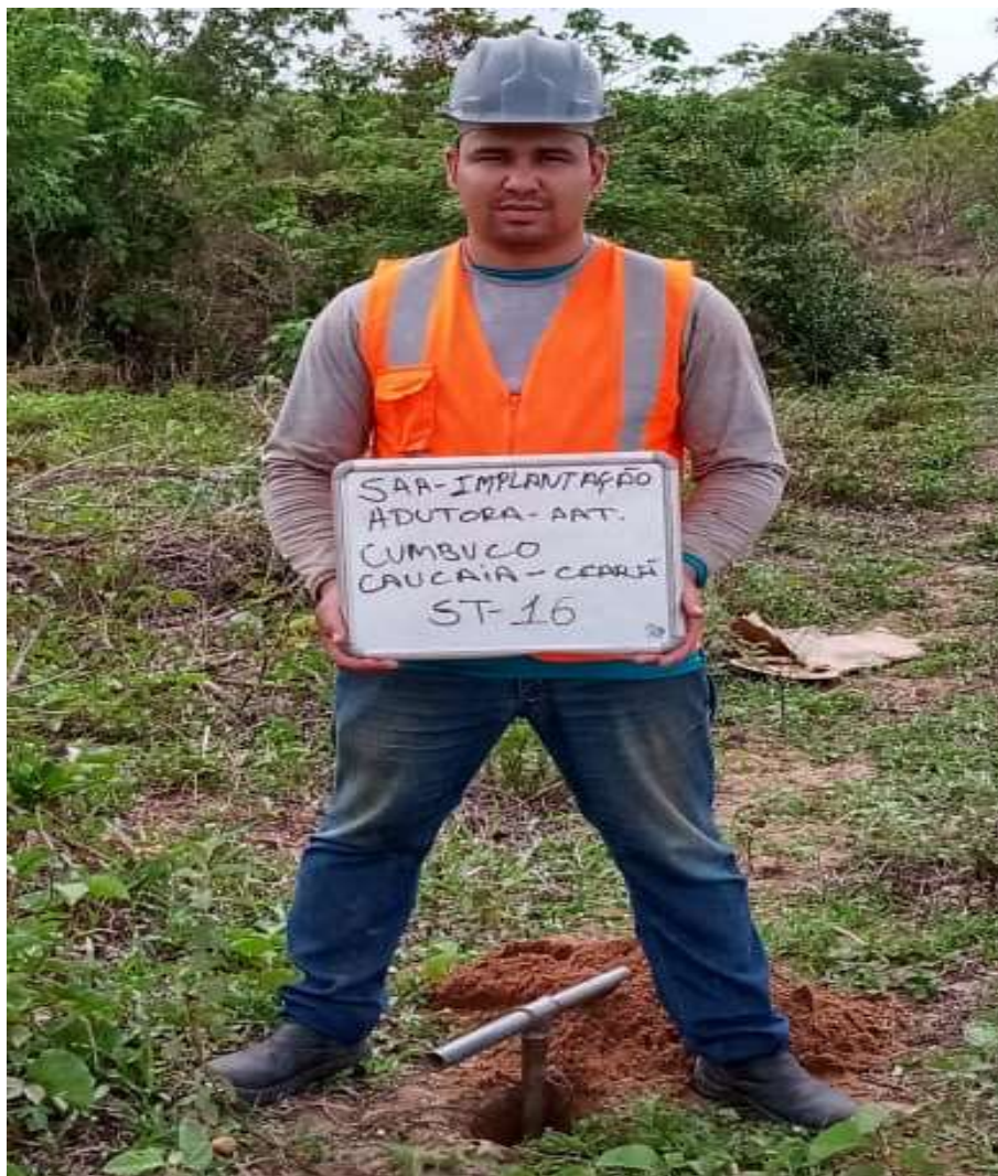
Instalação do furo ST-16
