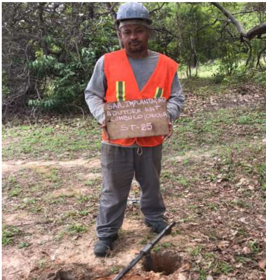
Instalação do furo ST-25
