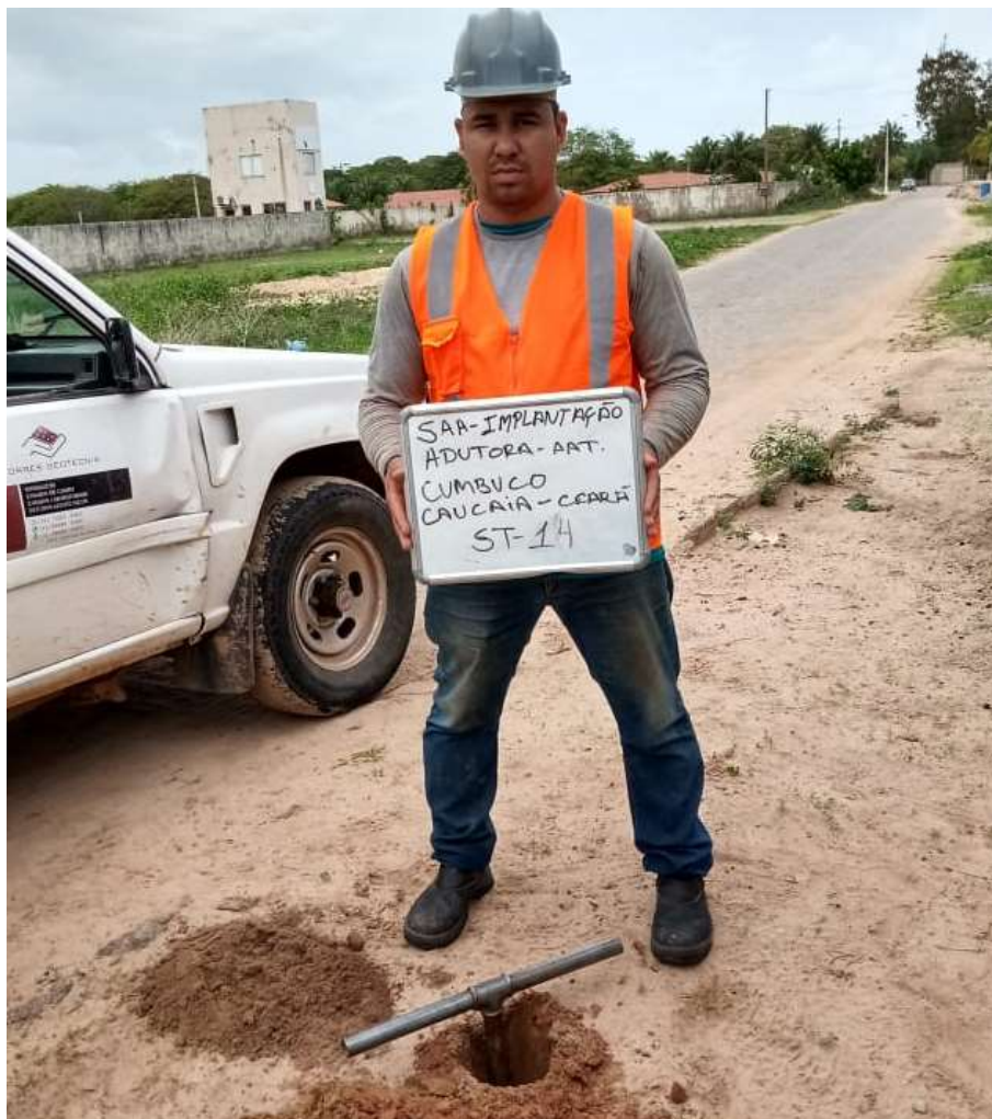
Instalação do furo ST-14
