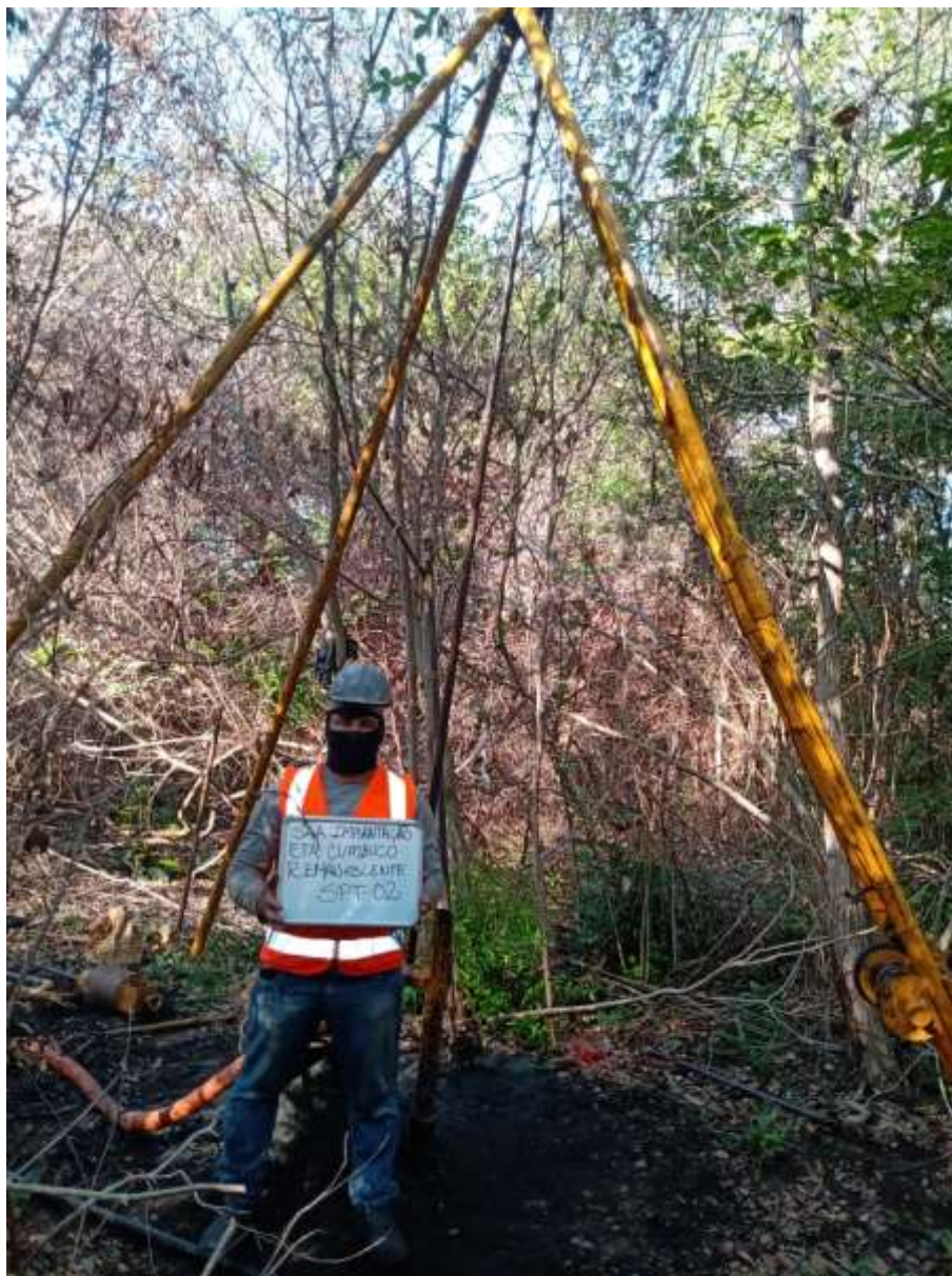
Instalação do furo SP-02
