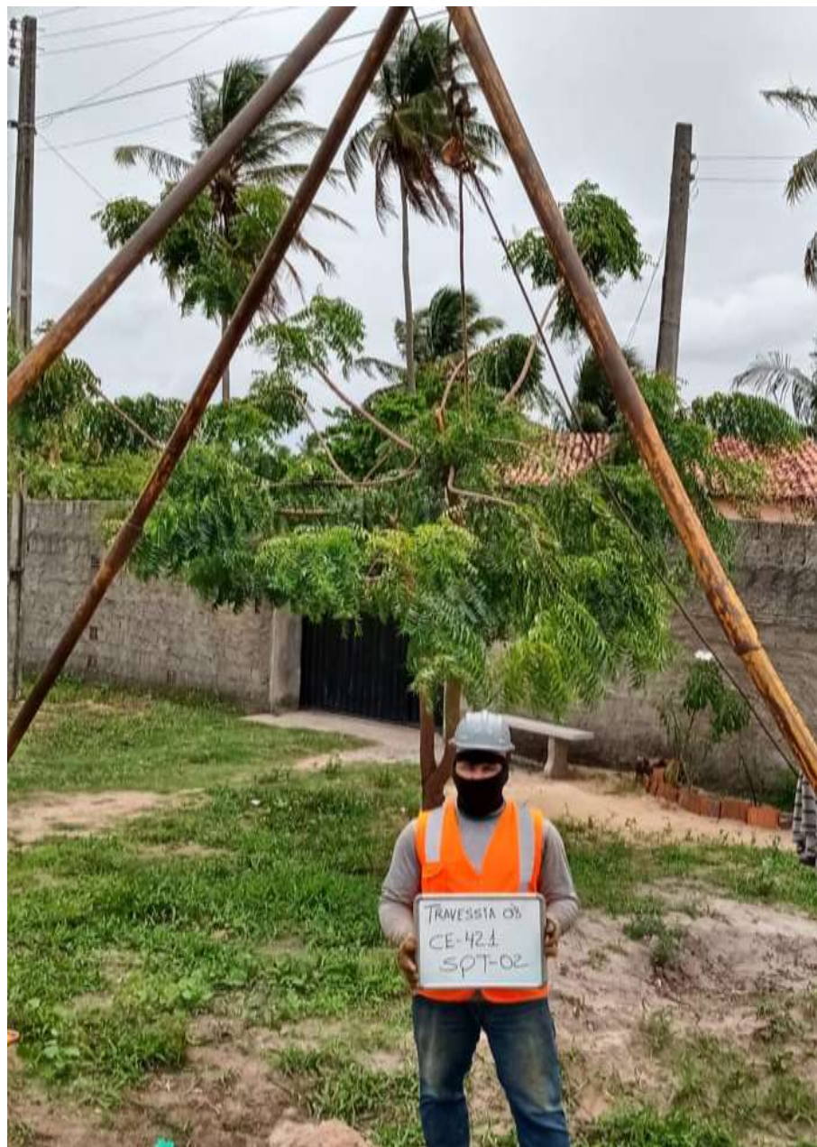
Instalação do furo SP-02
