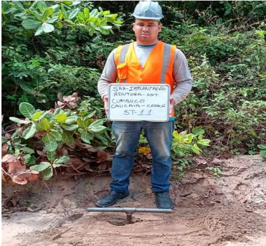
Instalação do furo ST-11
