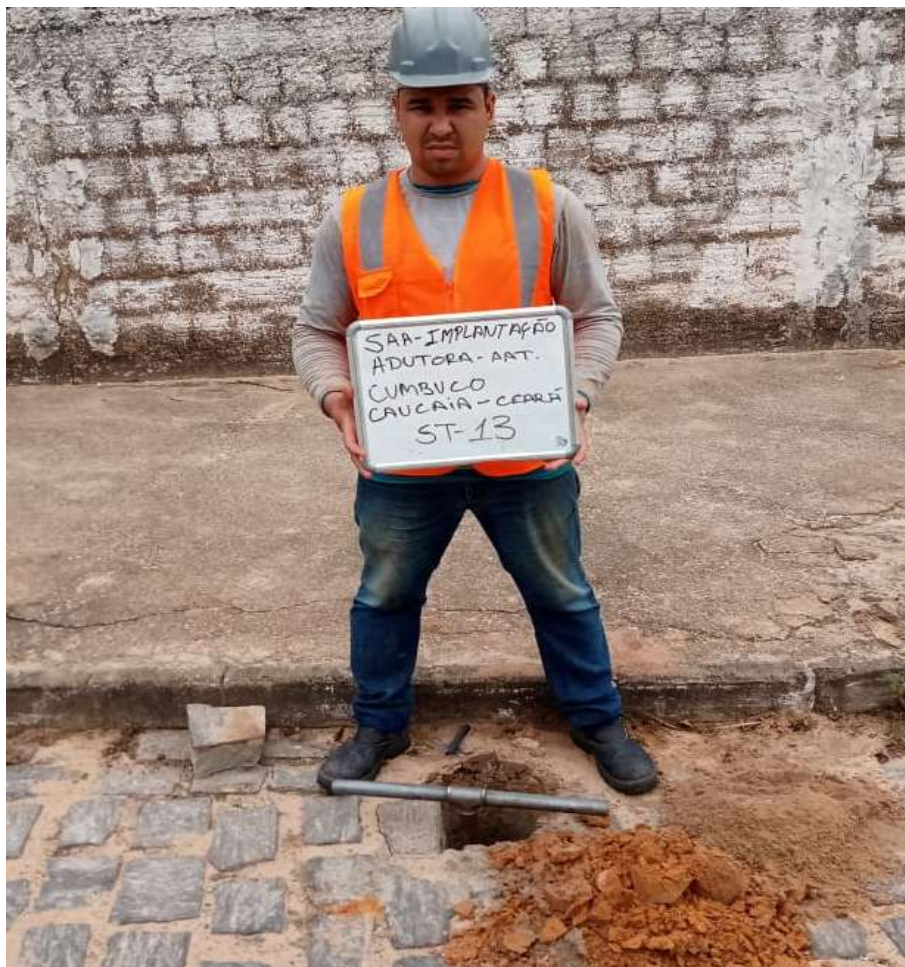
Instalação do furo ST-13
