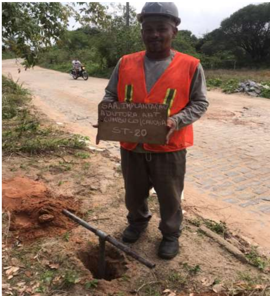
Instalação do furo ST-20
