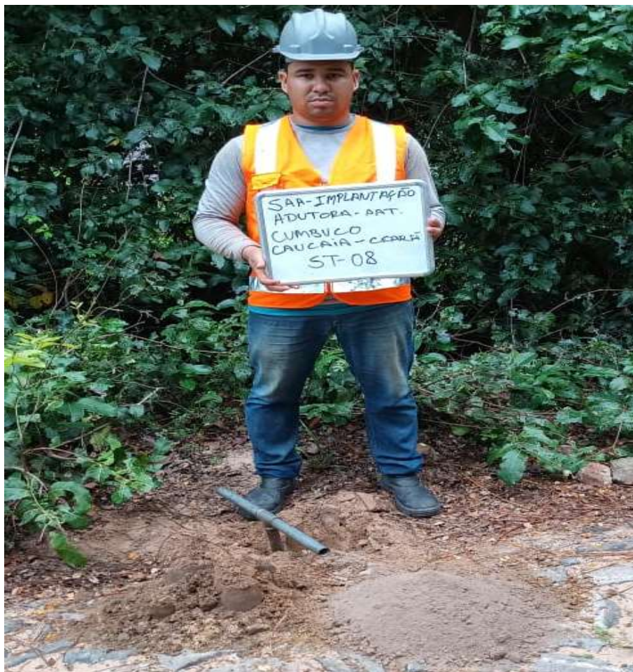
Instalação do furo ST-08
