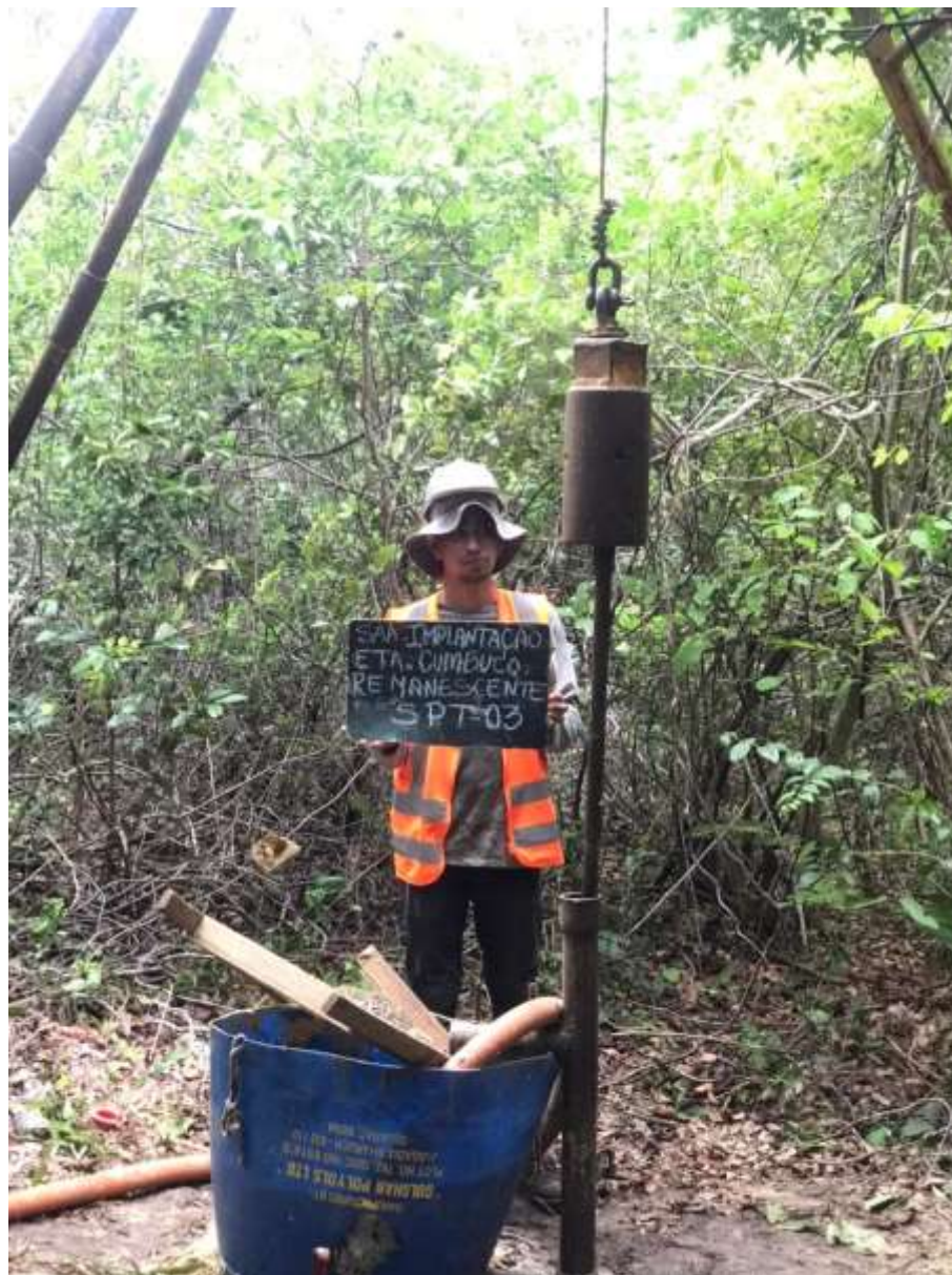
Instalação do furo SP-03
