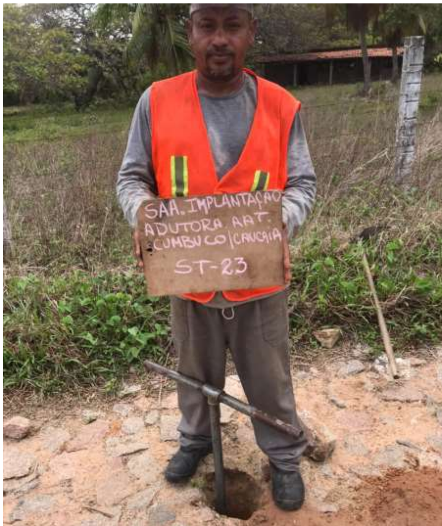
Instalação do furo ST-23
