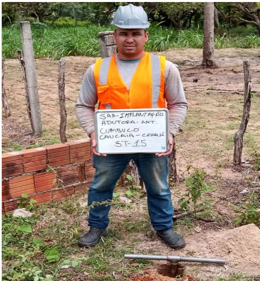
Instalação do furo ST-15
