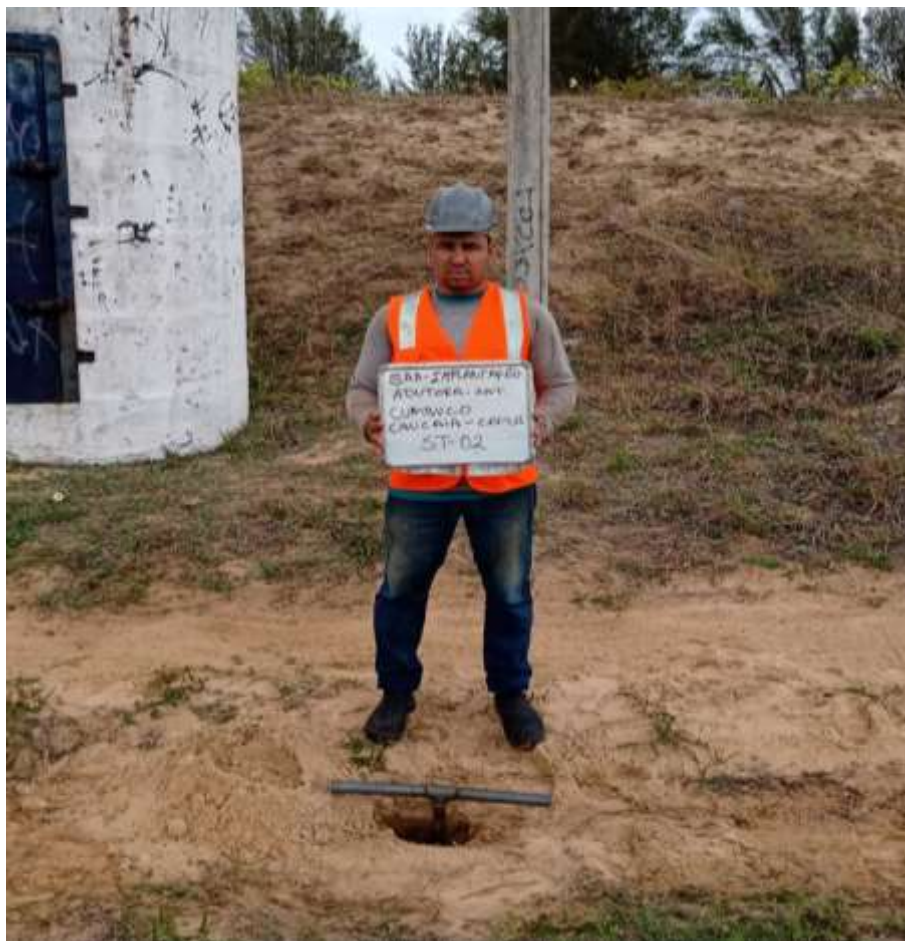
Instalação do furo ST-02
