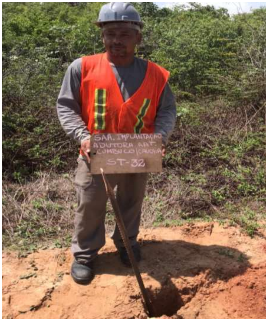
Instalação do furo ST-32
