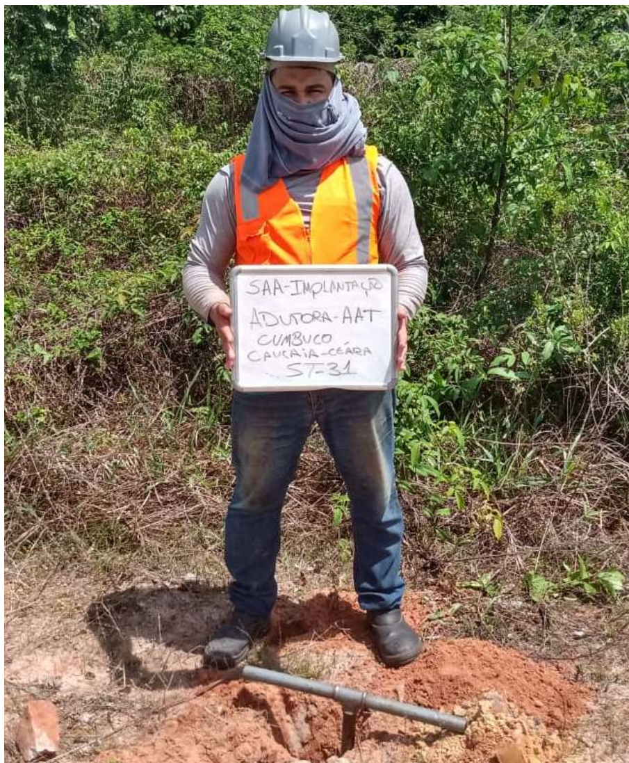
Instalação do furo ST-31
