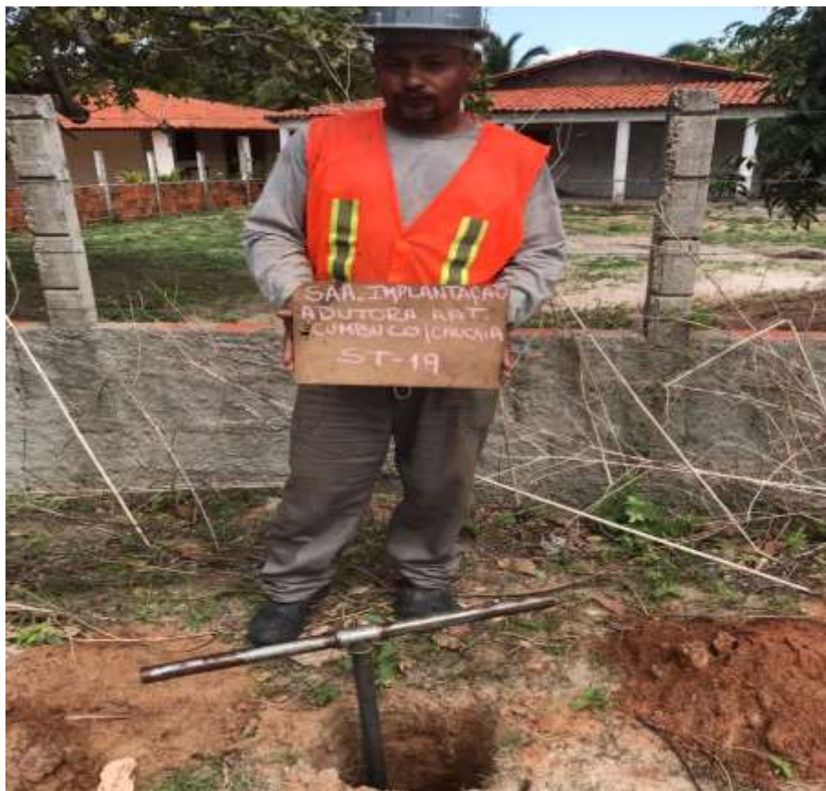
Instalação do furo ST-19
