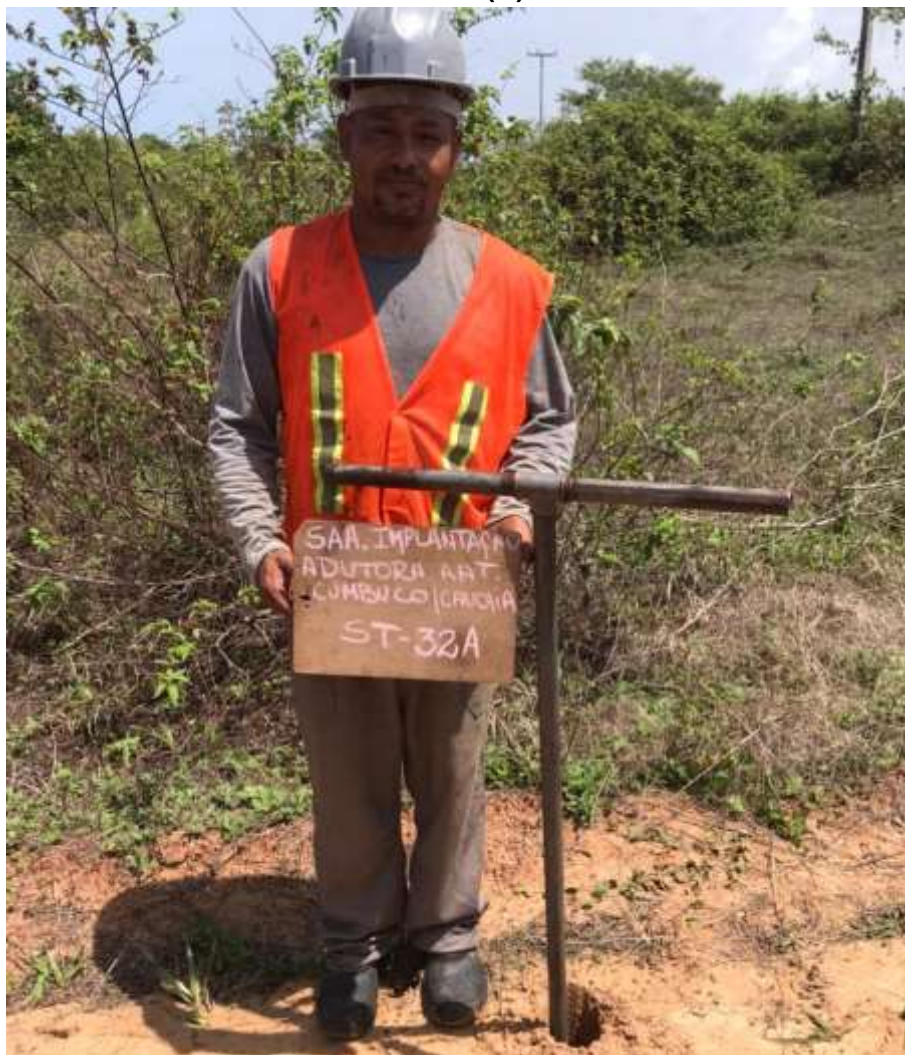
Instalação do furo ST-32 (A)
