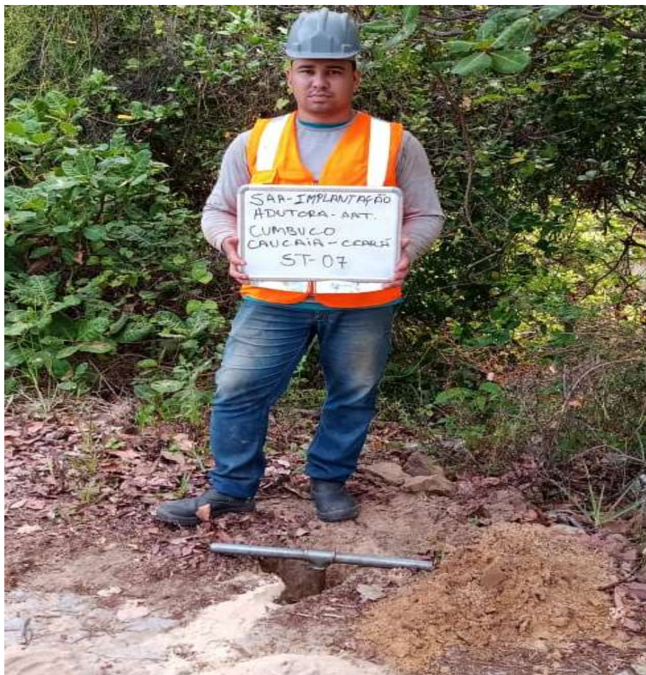
Instalação do furo ST-07
