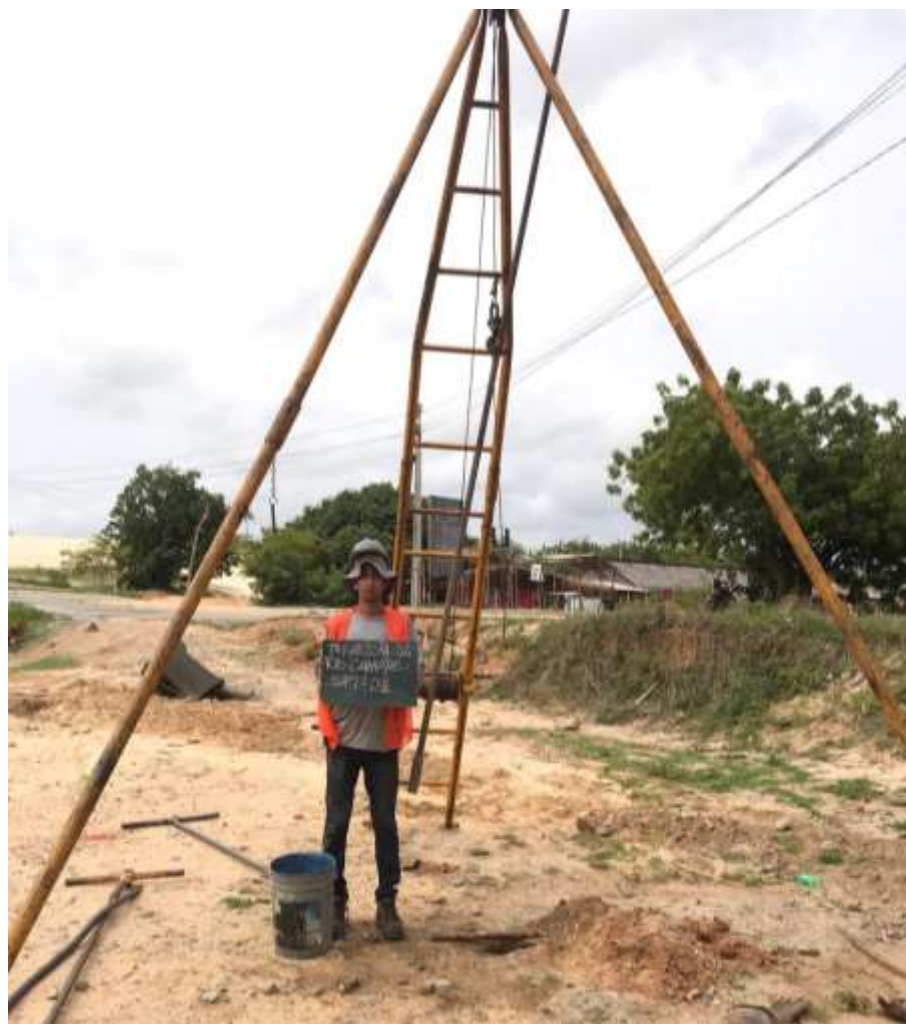
Instalação do furo SP-01
