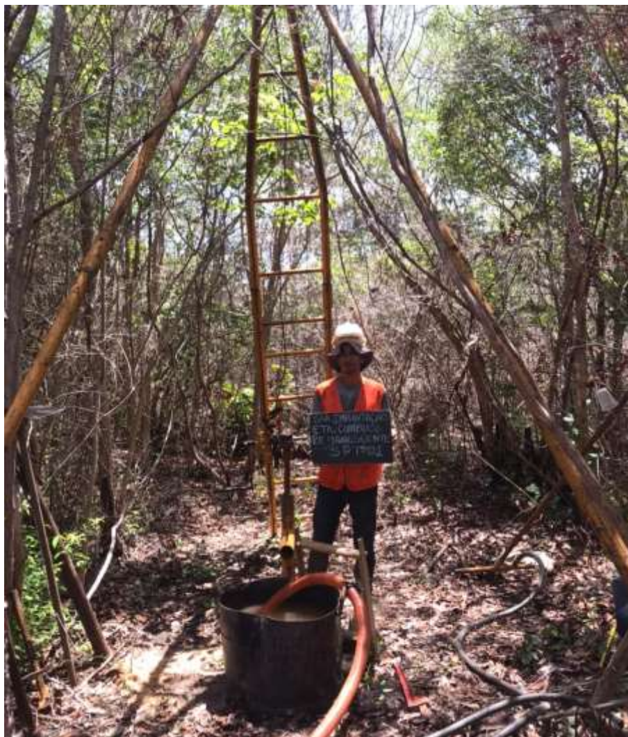
Instalação do furo SP-01
