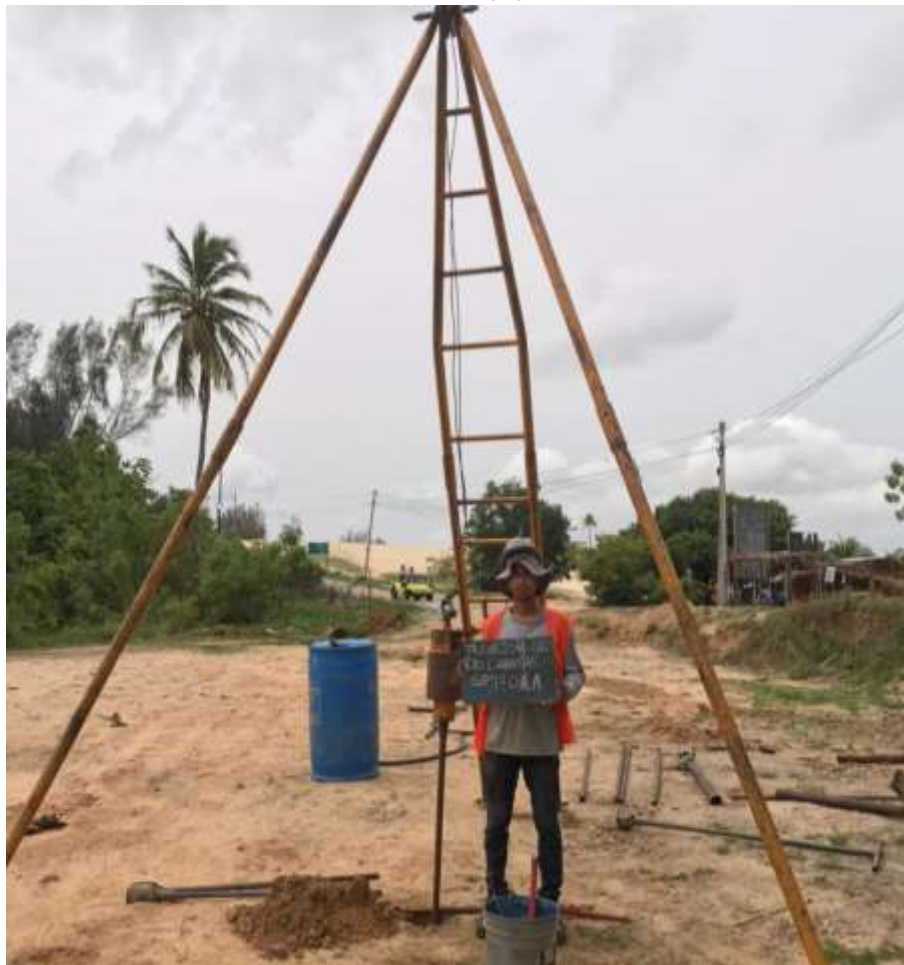
Instalação do furo SP-01 A
