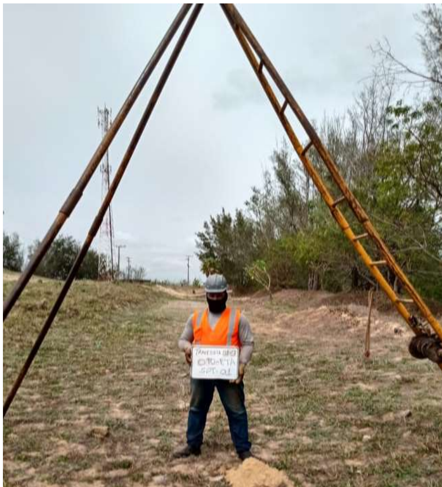
Instalação do furo SP-01
