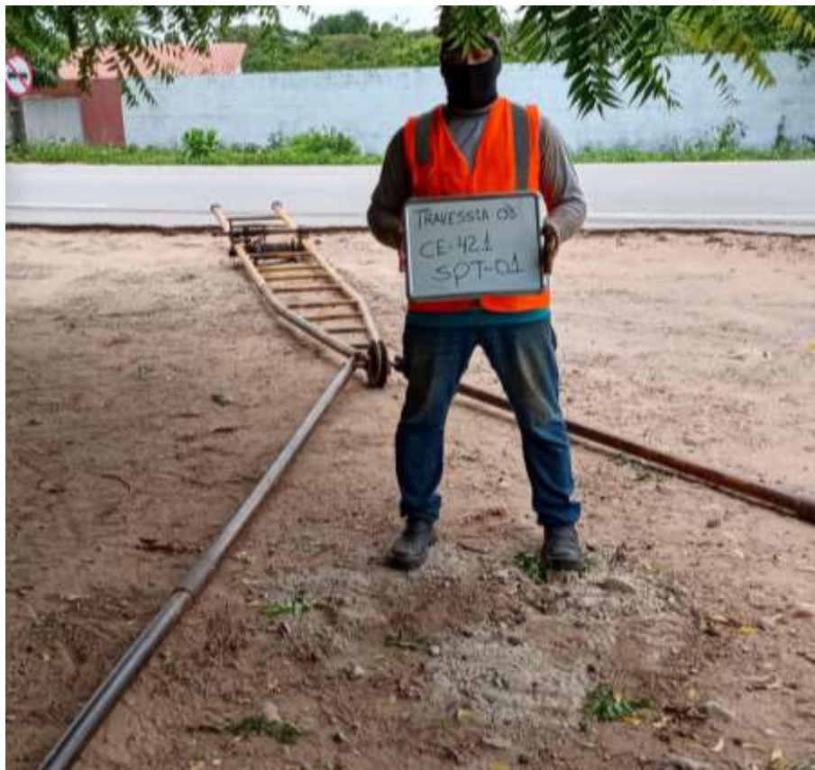
Instalação do furo SP-01
