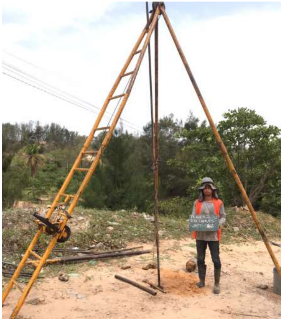
Instalação do furo SP-02
