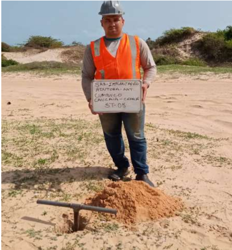
Instalação do furo ST-05
