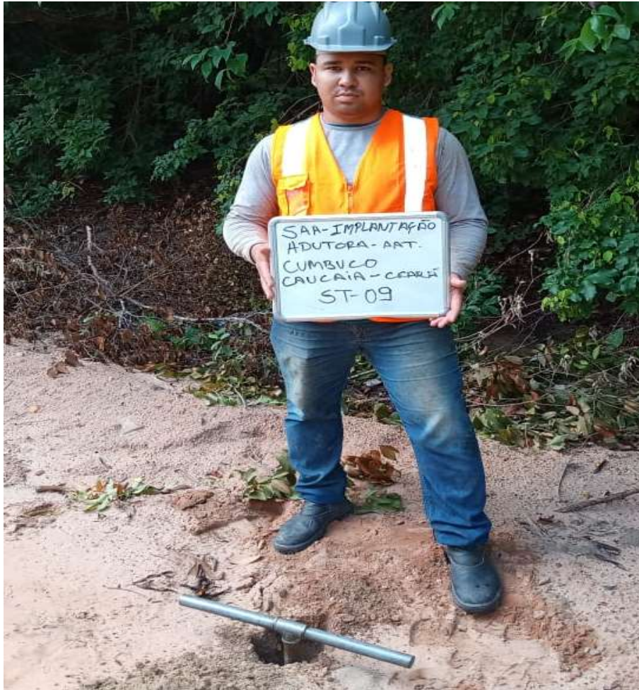
Instalação do furo ST-09
