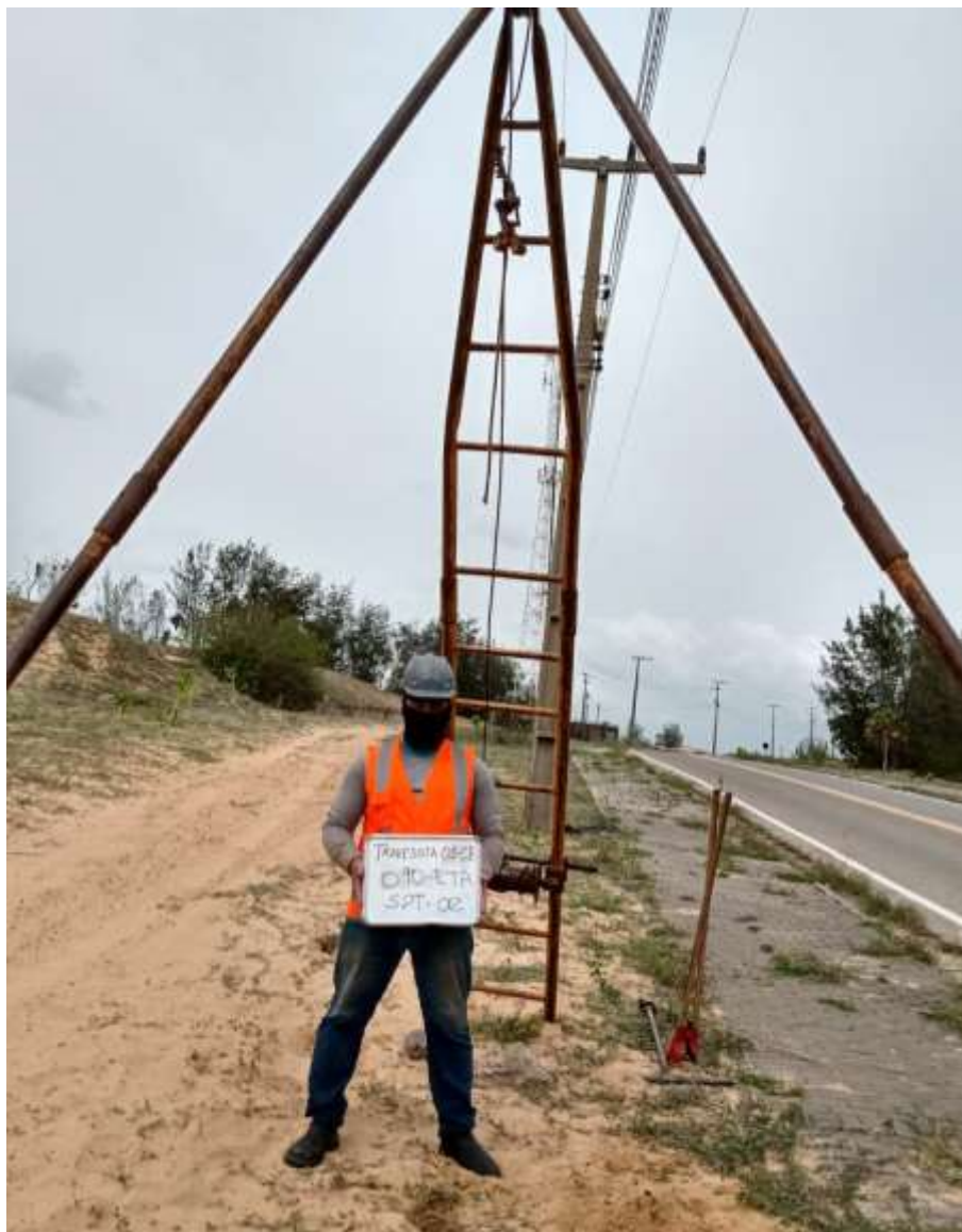
Instalação do furo SP-02
