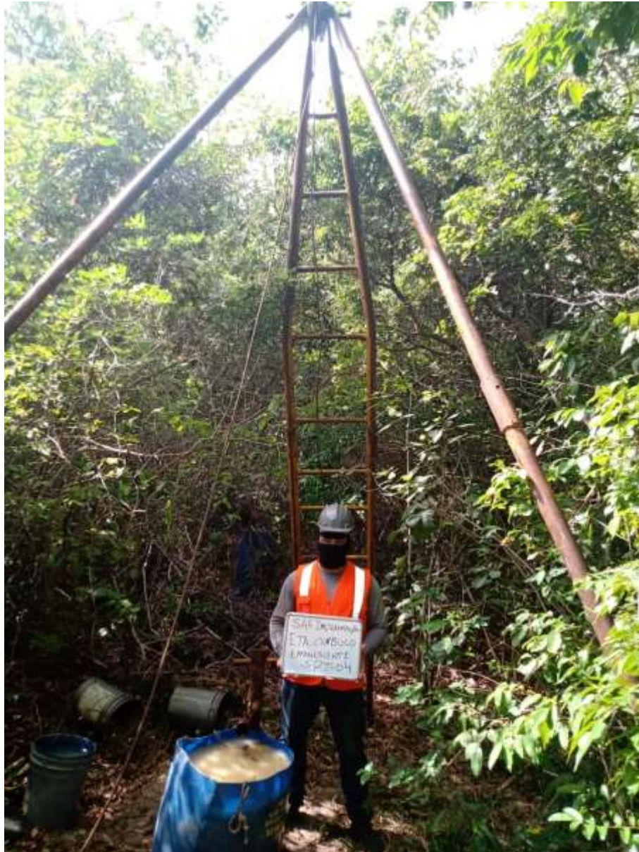
Instalação do furo SP-04
