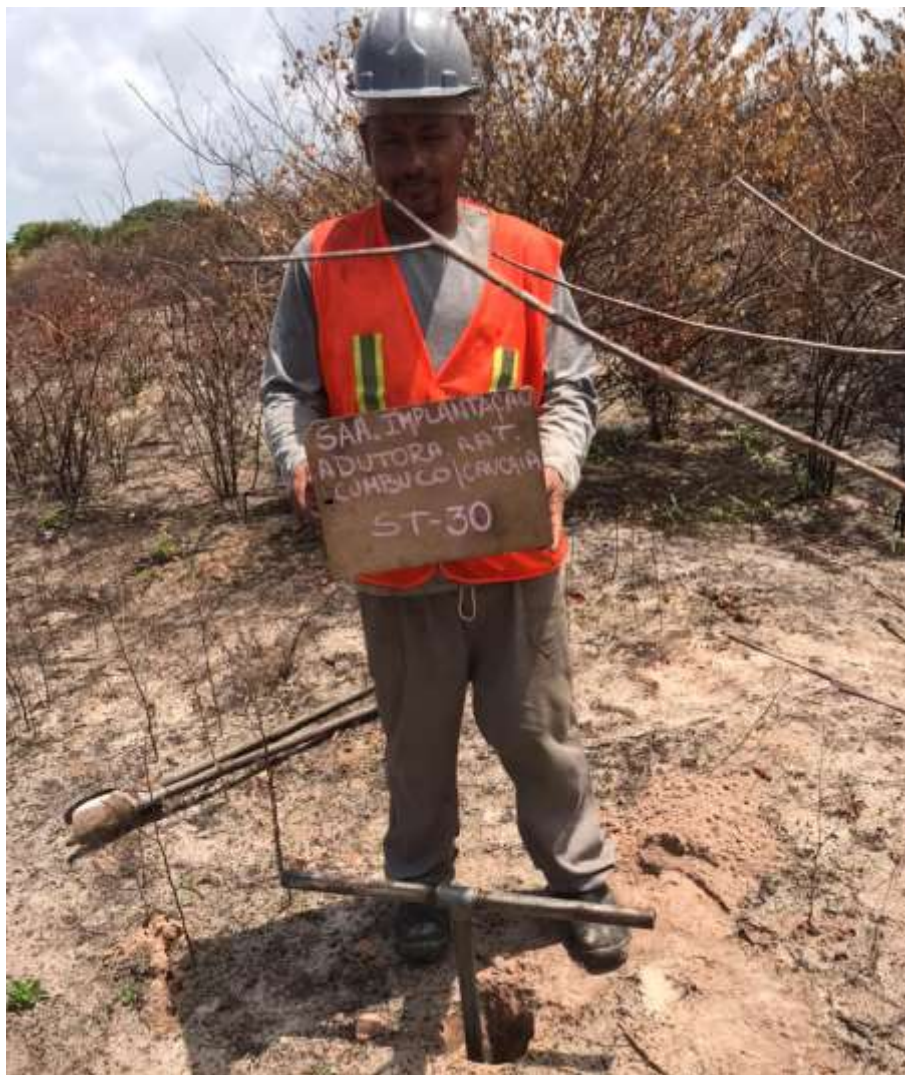
Instalação do furo ST-30
