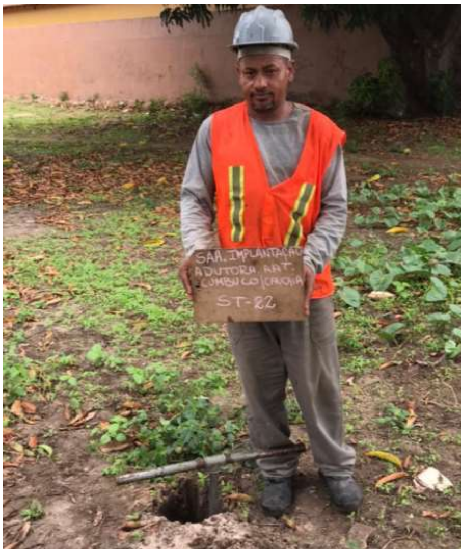
Instalação do furo ST-22
