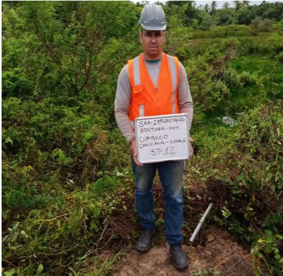
Instalação do furo ST-12
