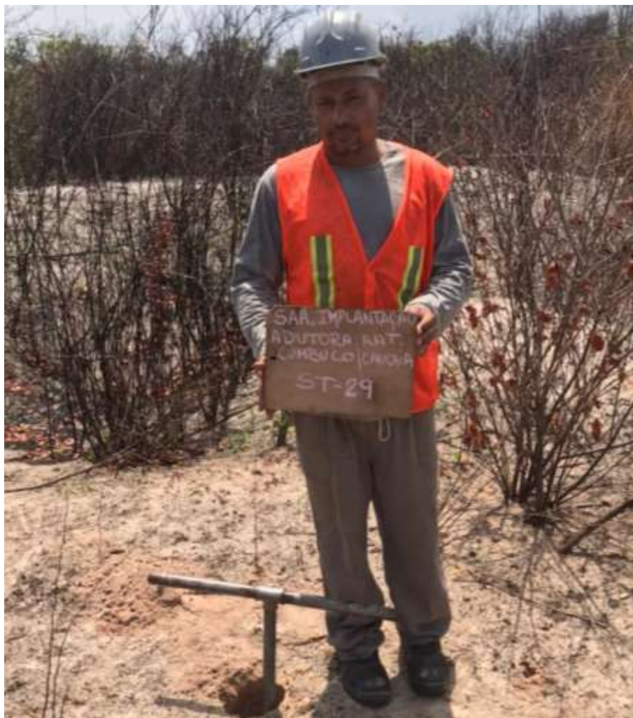
Instalação do furo ST-29
