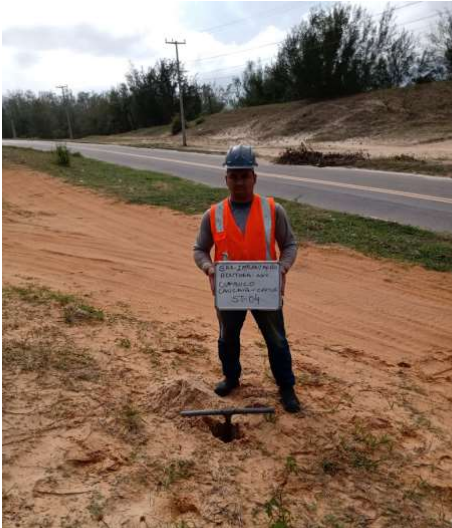
Instalação do furo ST-04
