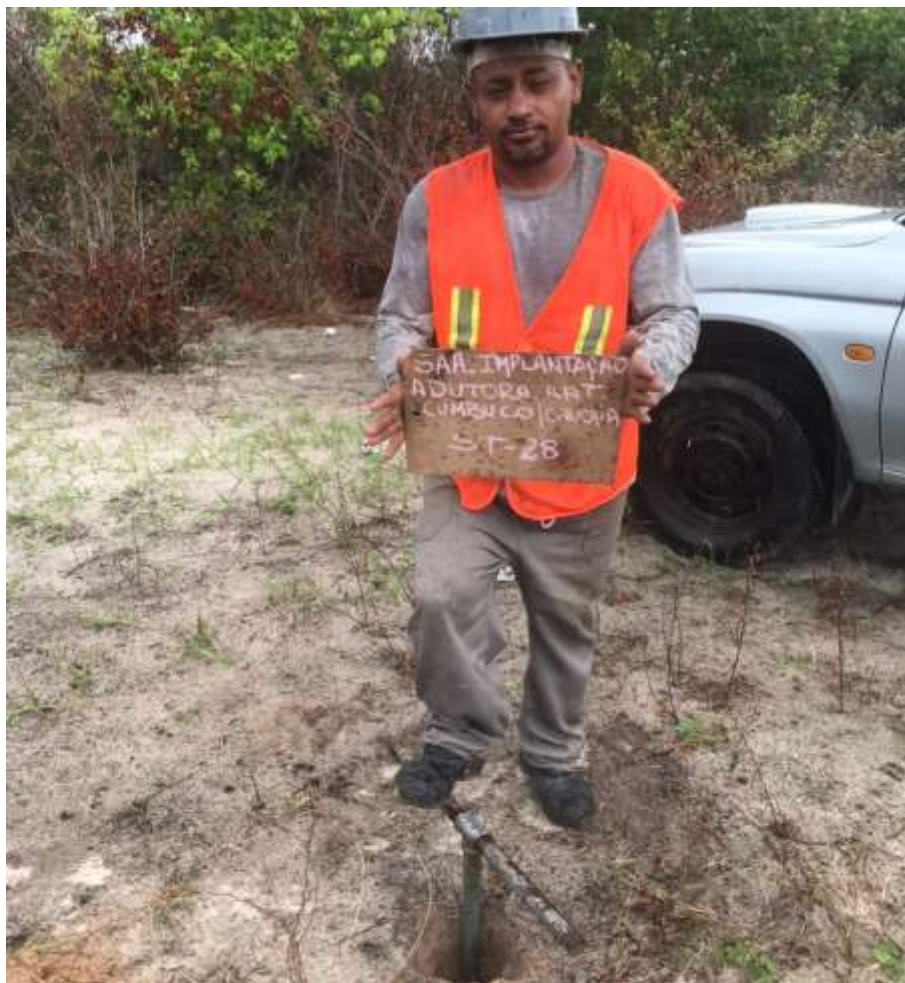
Instalação do furo ST-28
