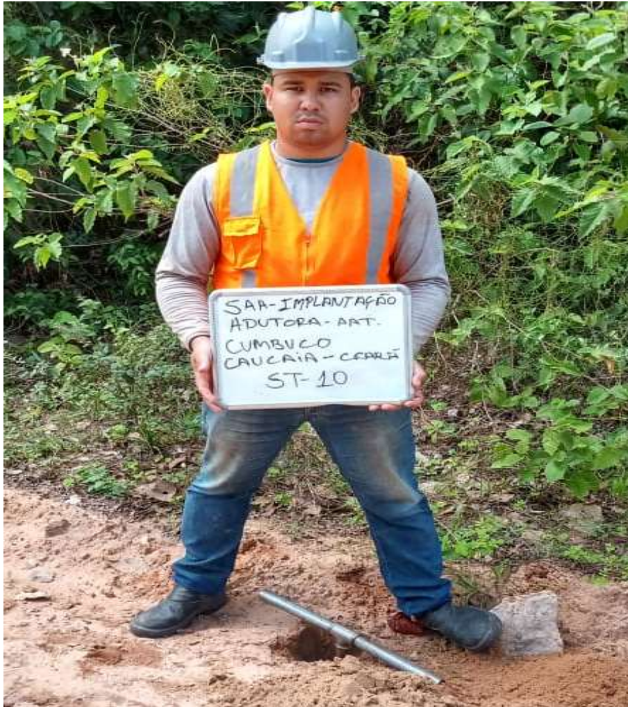
Instalação do furo ST-10
