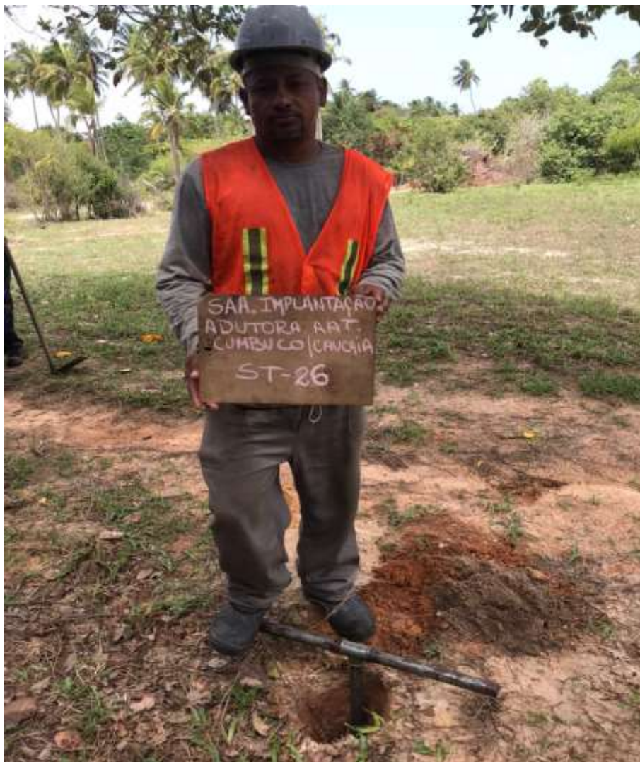
Instalação do furo ST-26
