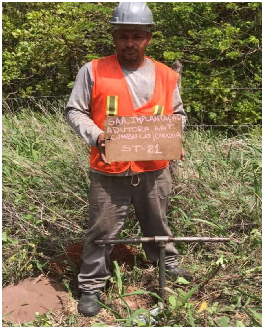
Instalação do furo ST-21
