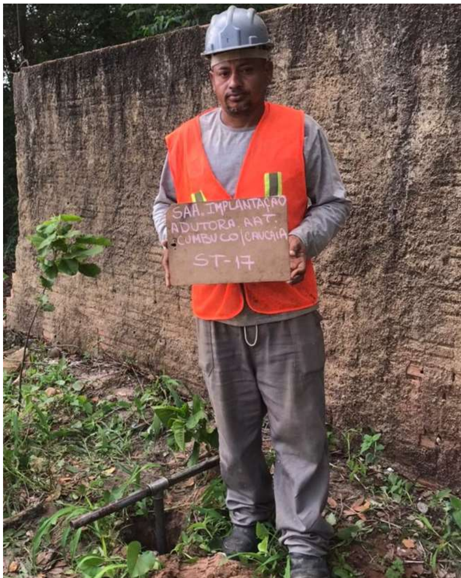
Instalação do furo ST-17
