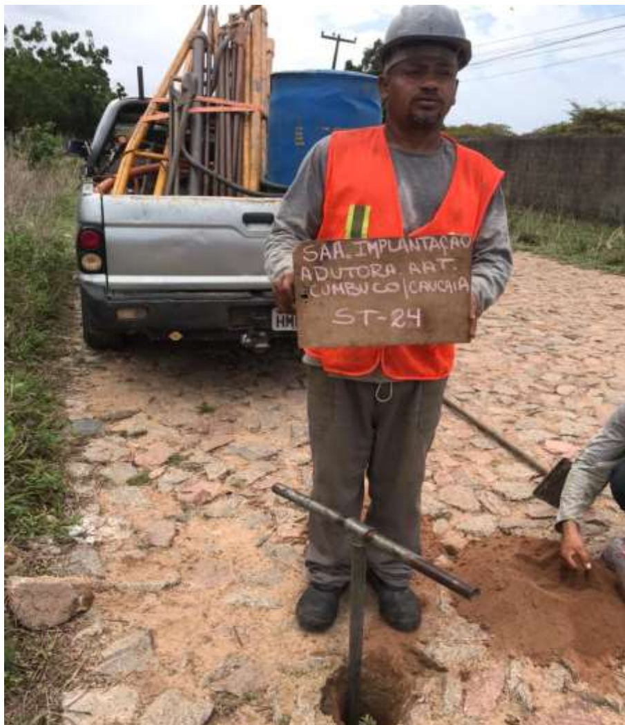
Instalação do furo ST-24
