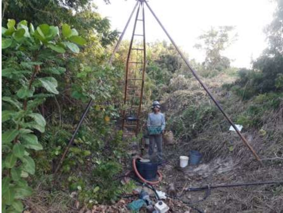
Instalação do furo SPT-01 A
