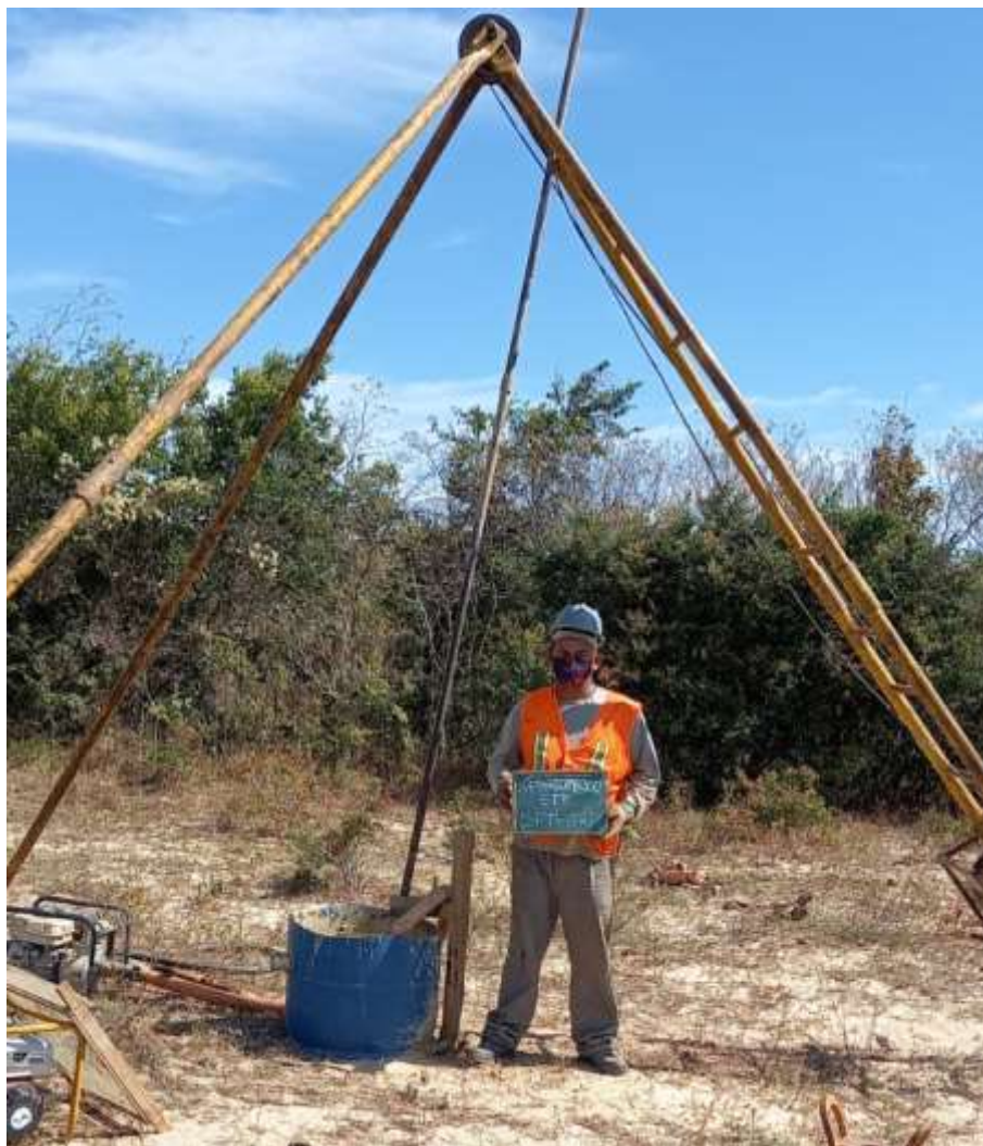
Instalação do furo SPT-02
