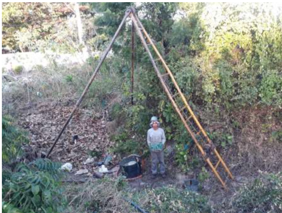
Instalação do furo SPT-01
