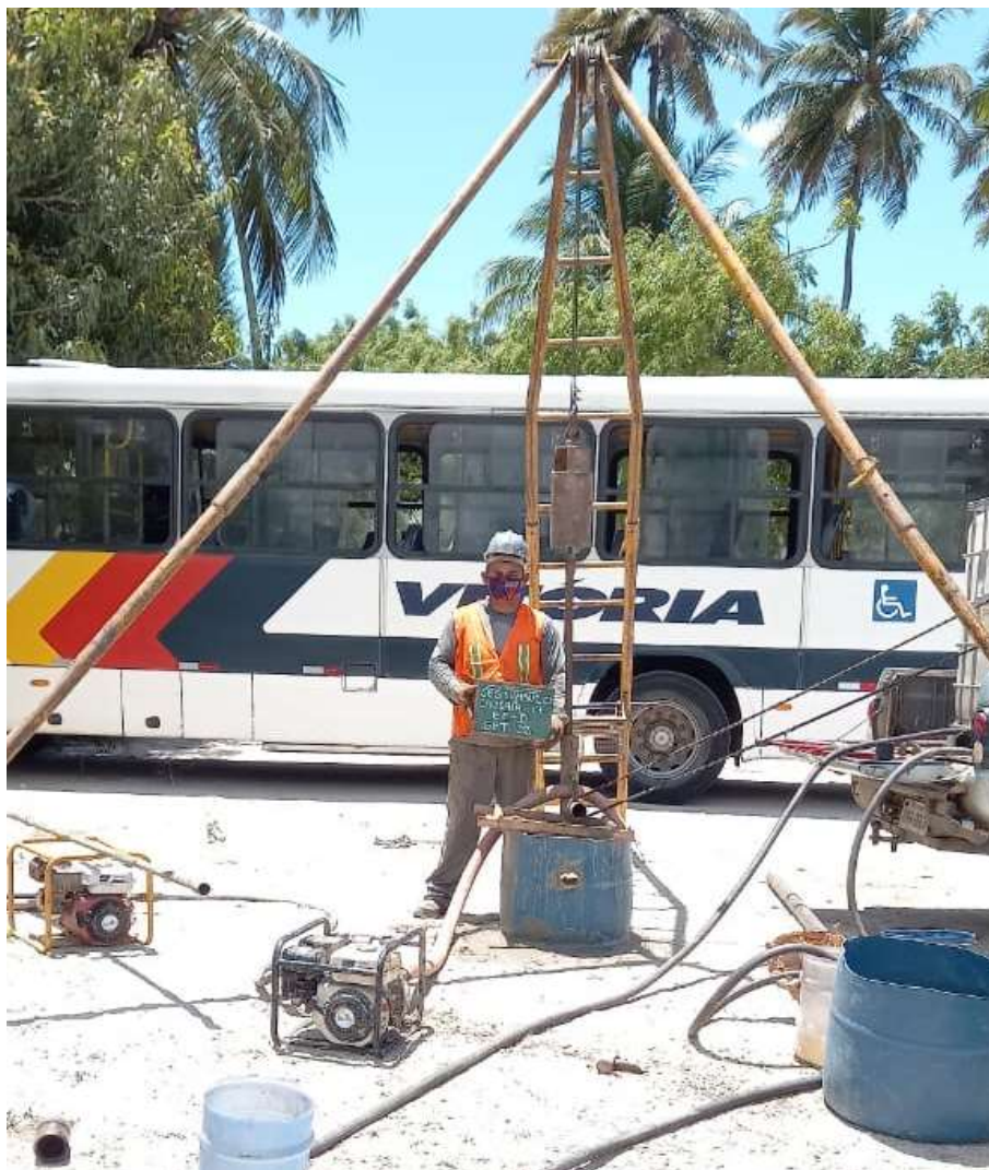
Instalação do furo SPT-02
