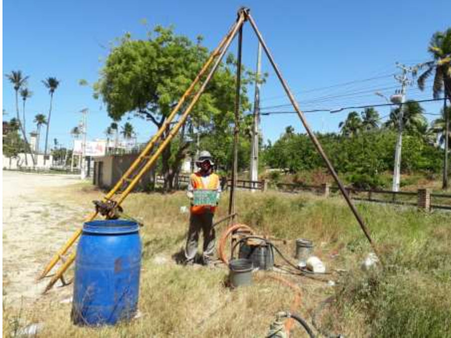
Instalação do furo SPT-01
