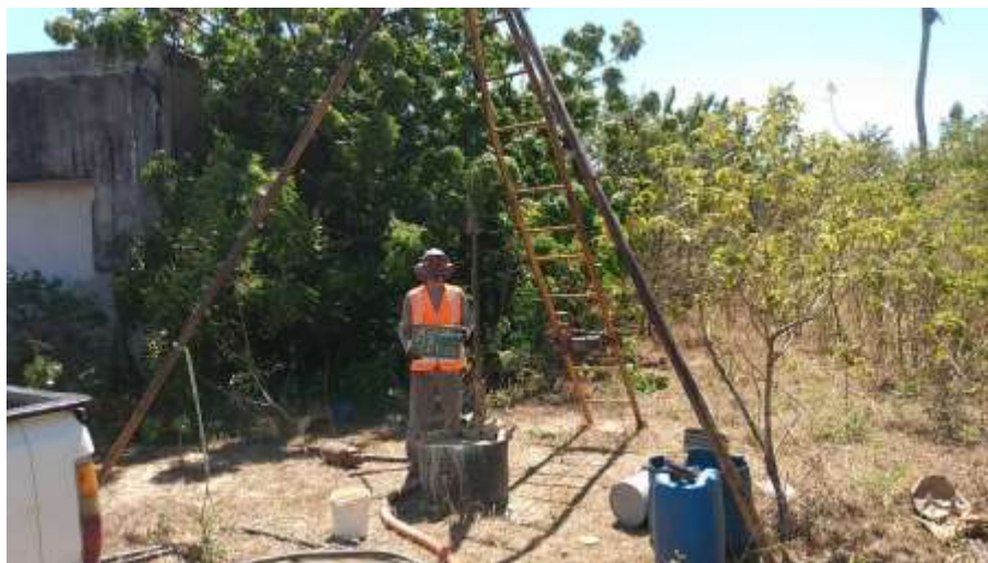
Instalação do furo SPT-01
