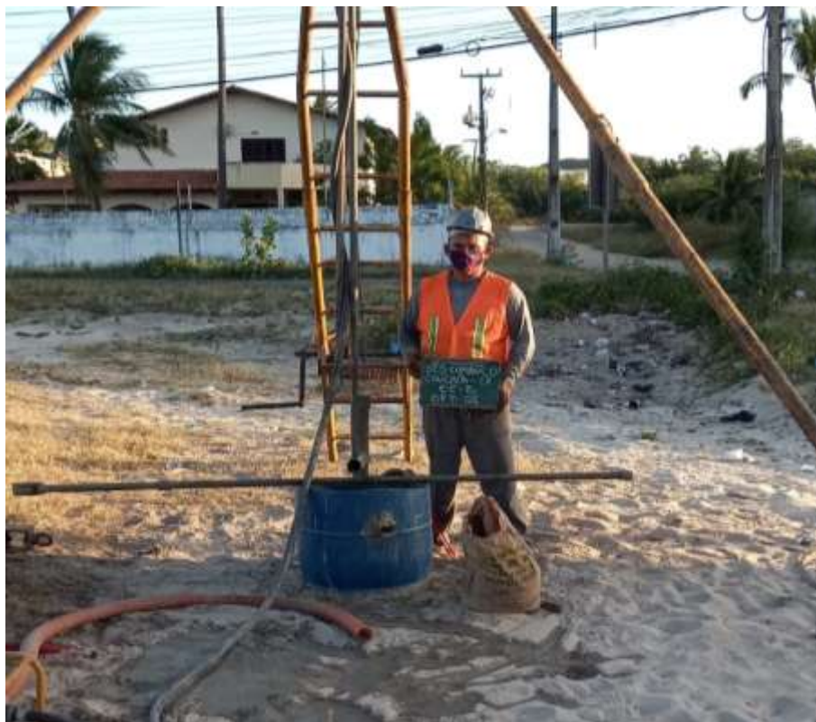
Instalação do furo SPT-01
