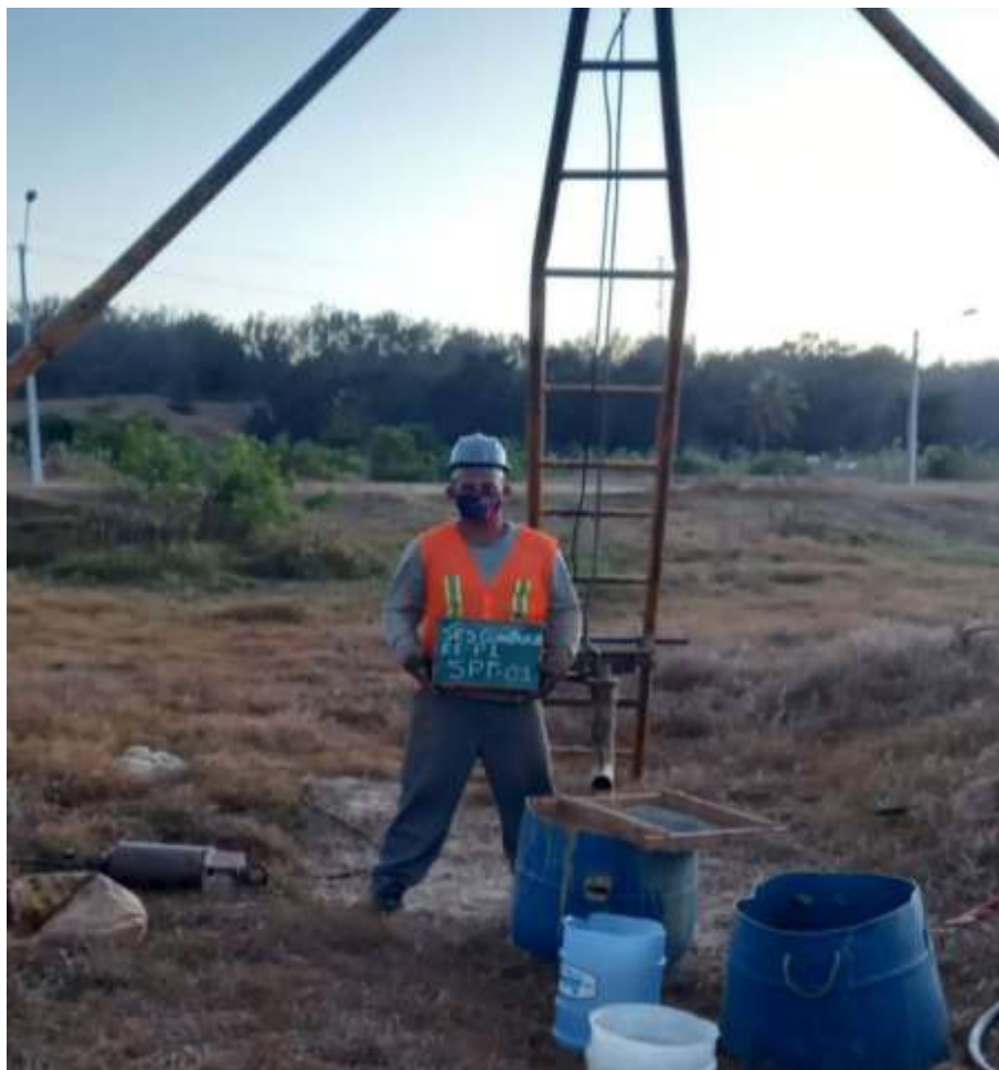
Instalação do furo SPT-01
