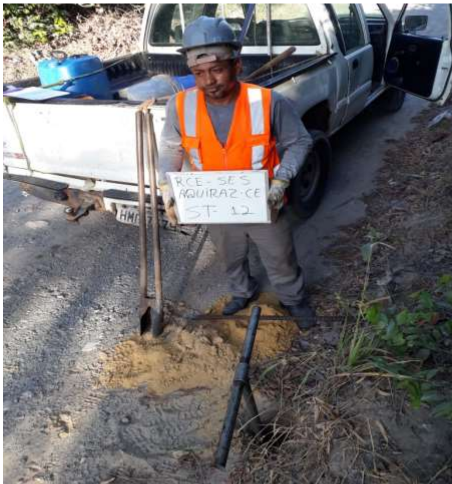
Instalação do furo ST-12
