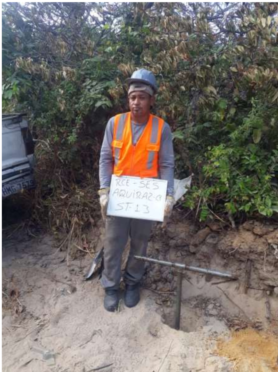
Instalação do furo ST-13
