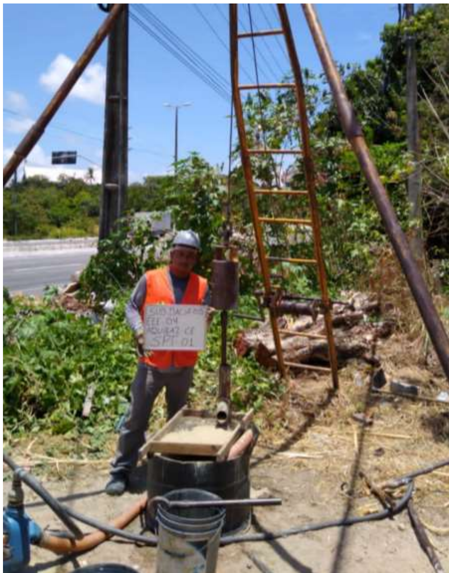
Instalação do furo SPT-EEE04
