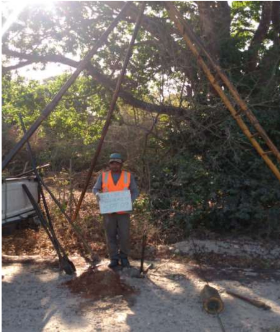
Instalação do furo SPT-09
