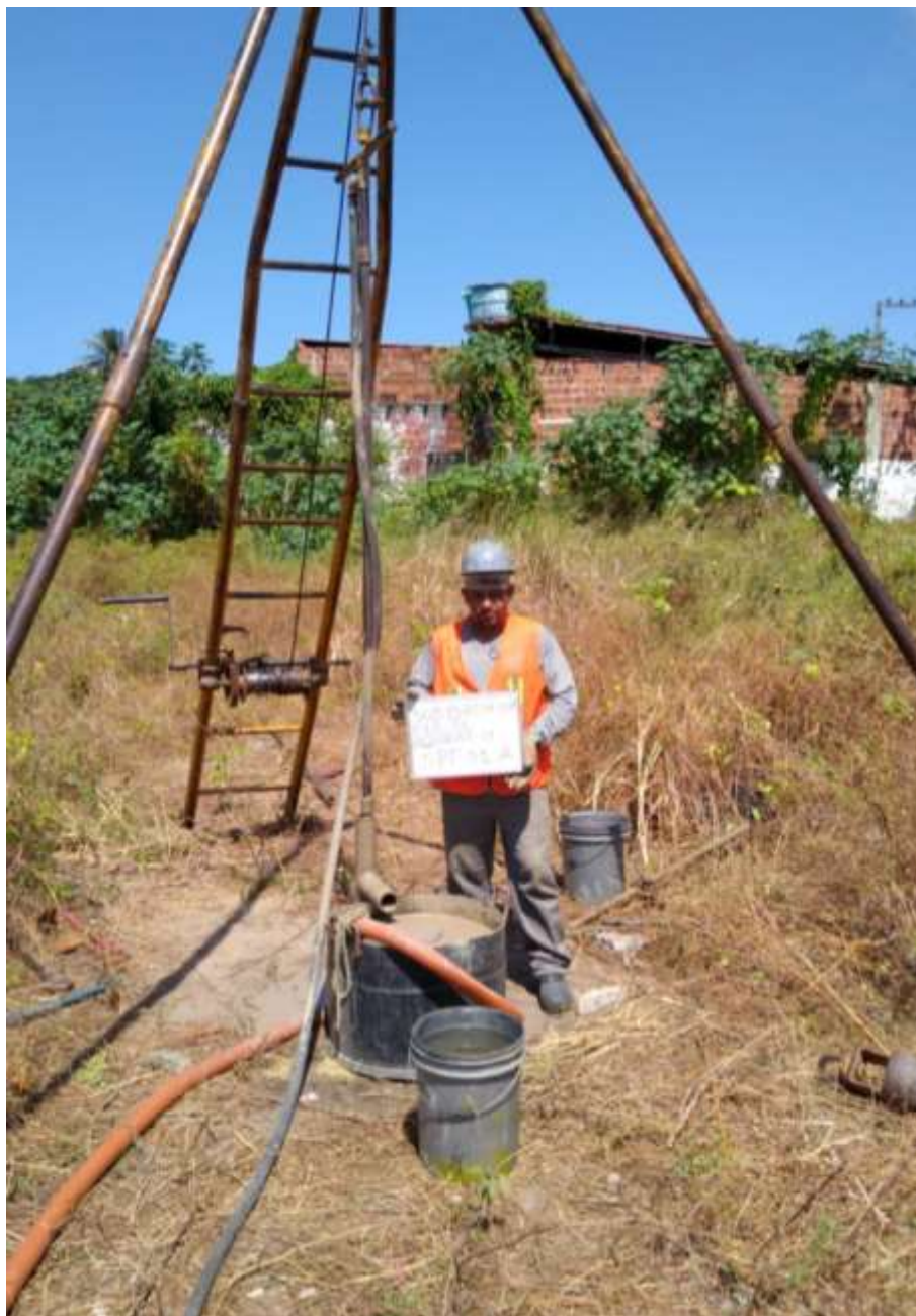
Instalação do furo SPT-EEE06 A
