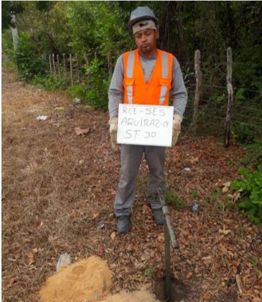
Instalação do furo ST-30
