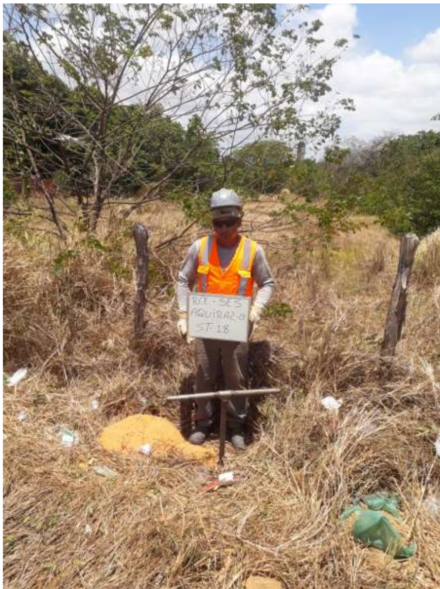
Instalação do furo ST-18
