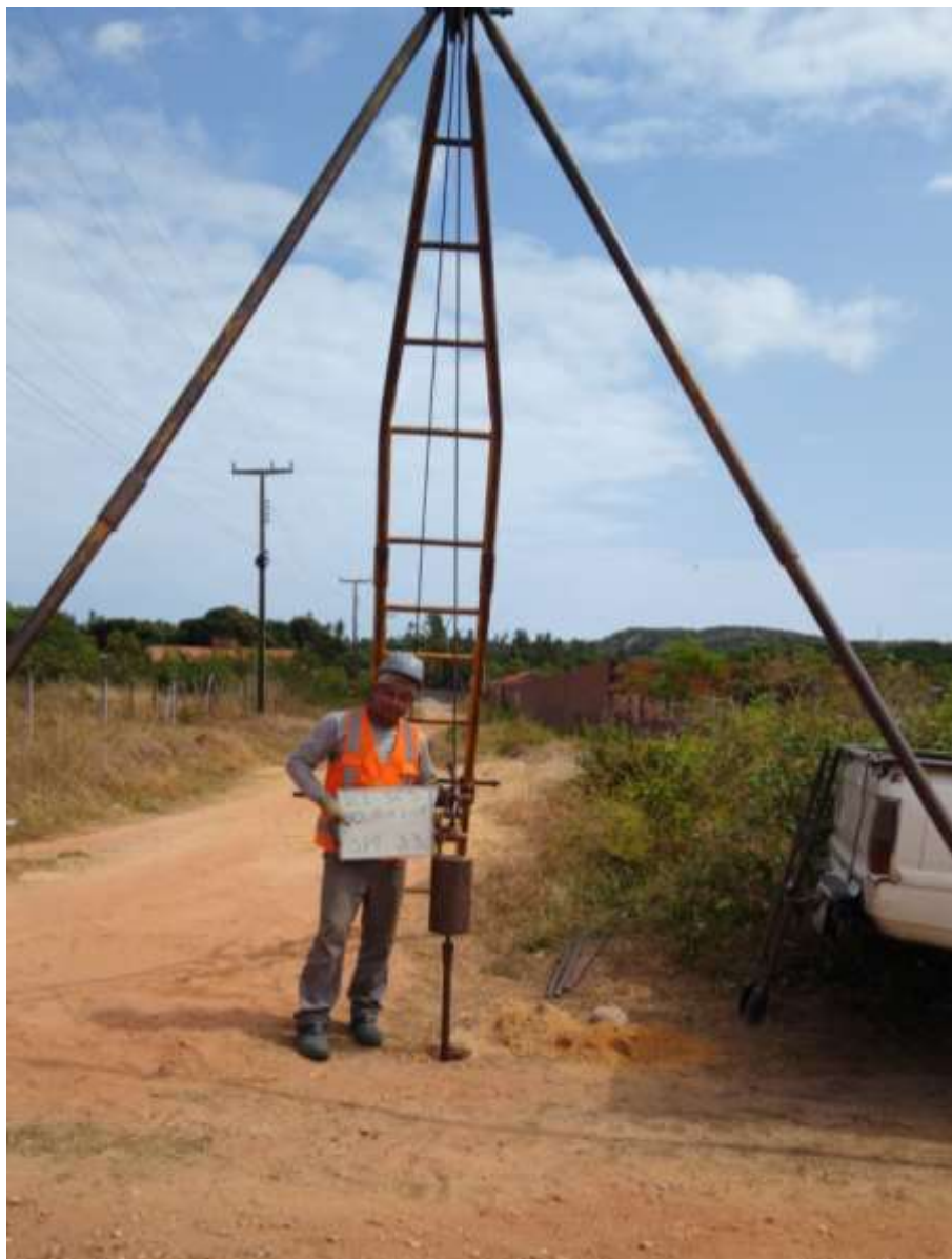
Instalação do furo SPT-33
