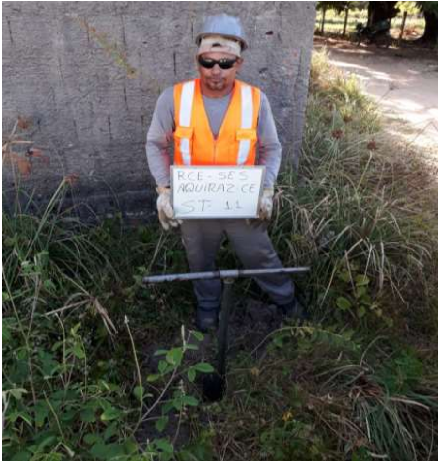
Instalação do furo ST-11
