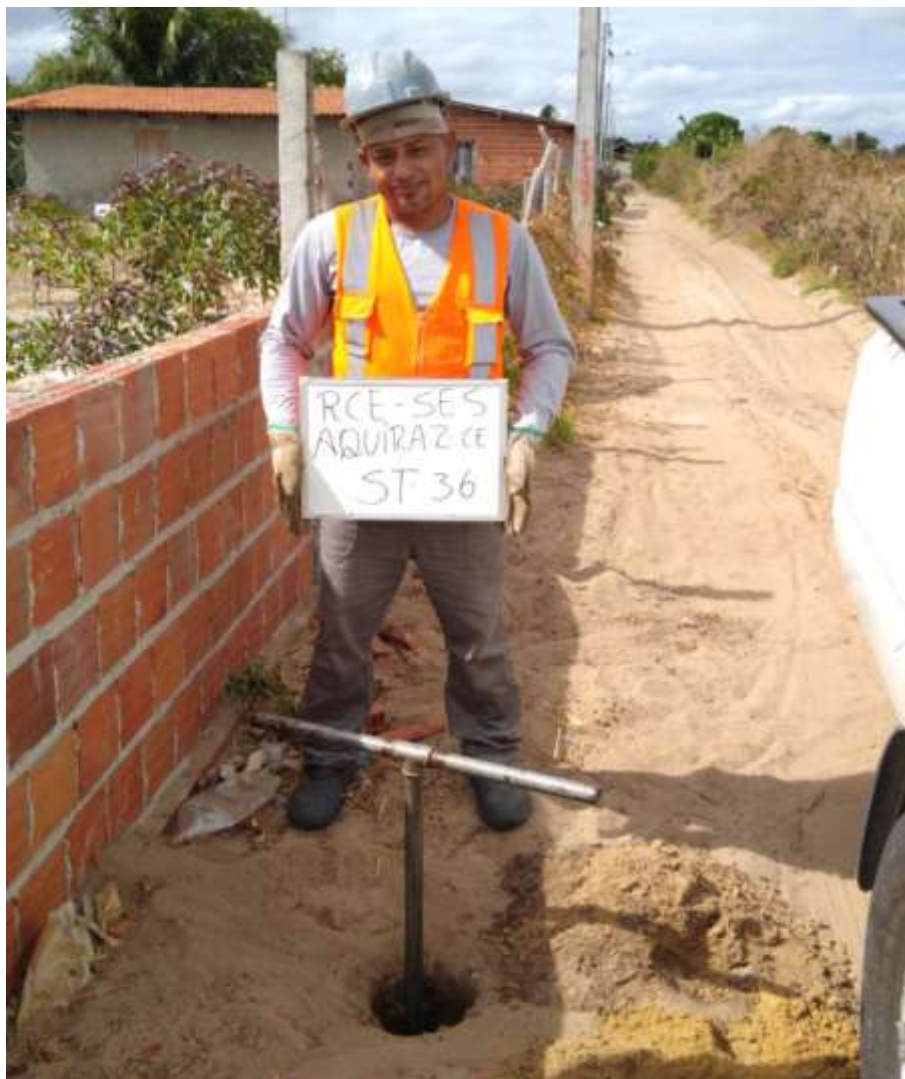
Instalação do furo ST-36
