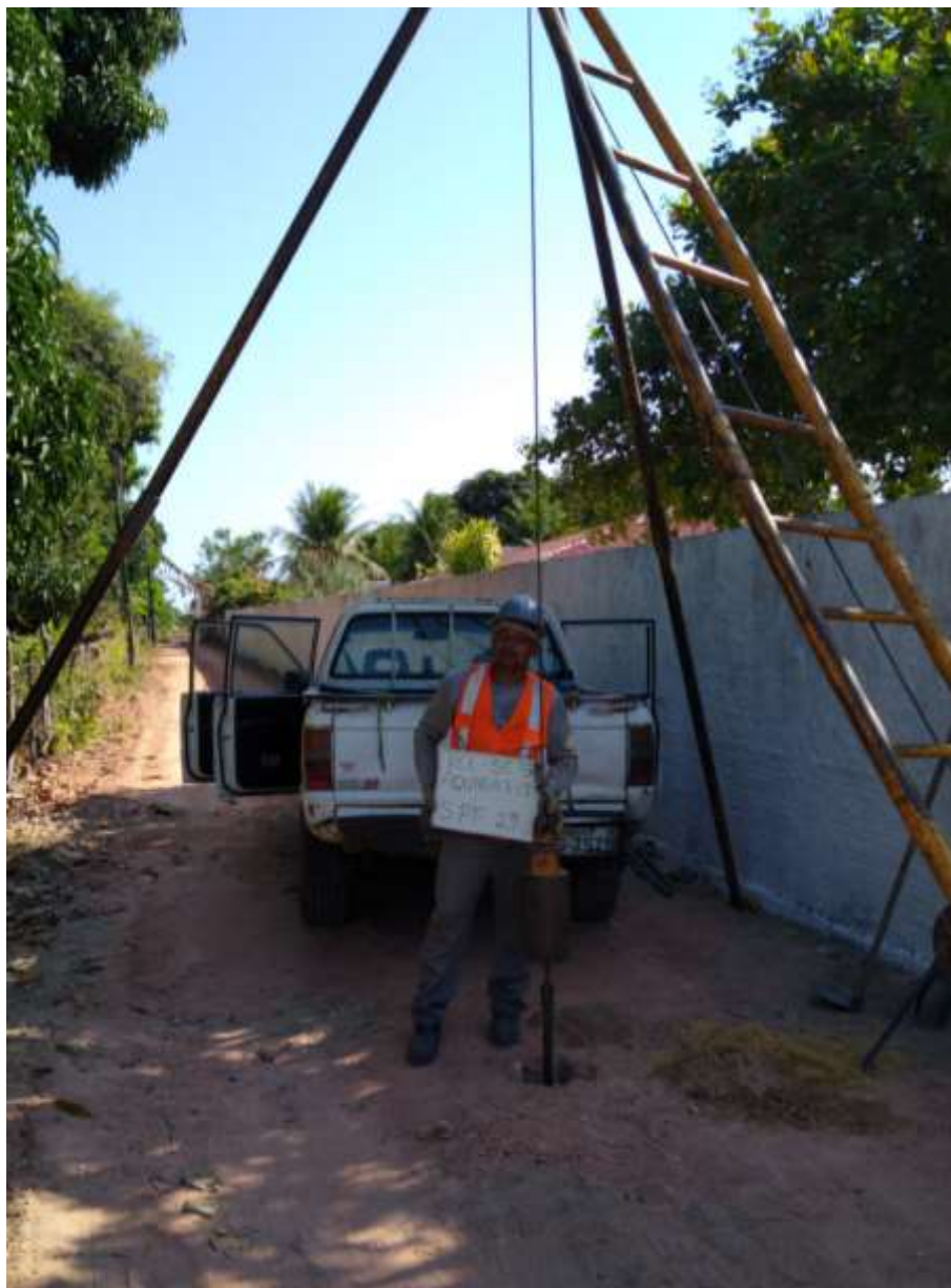
Instalação do furo SPT-29
