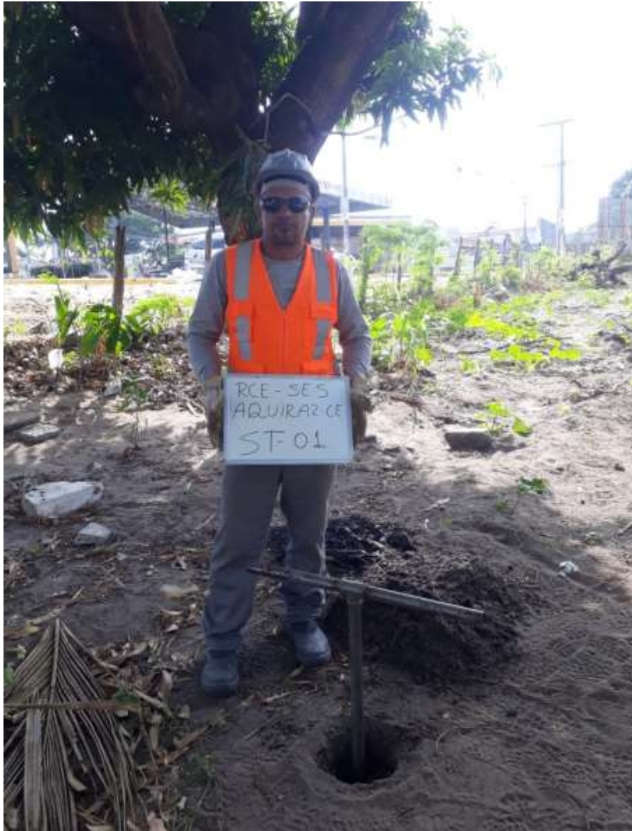
Instalação do furo ST-01
