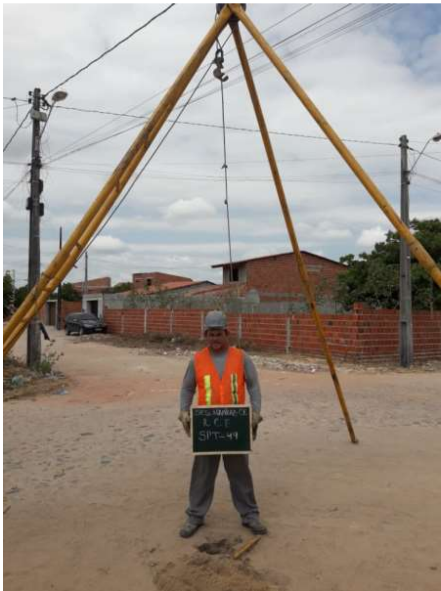
Instalação do furo SPT-49
