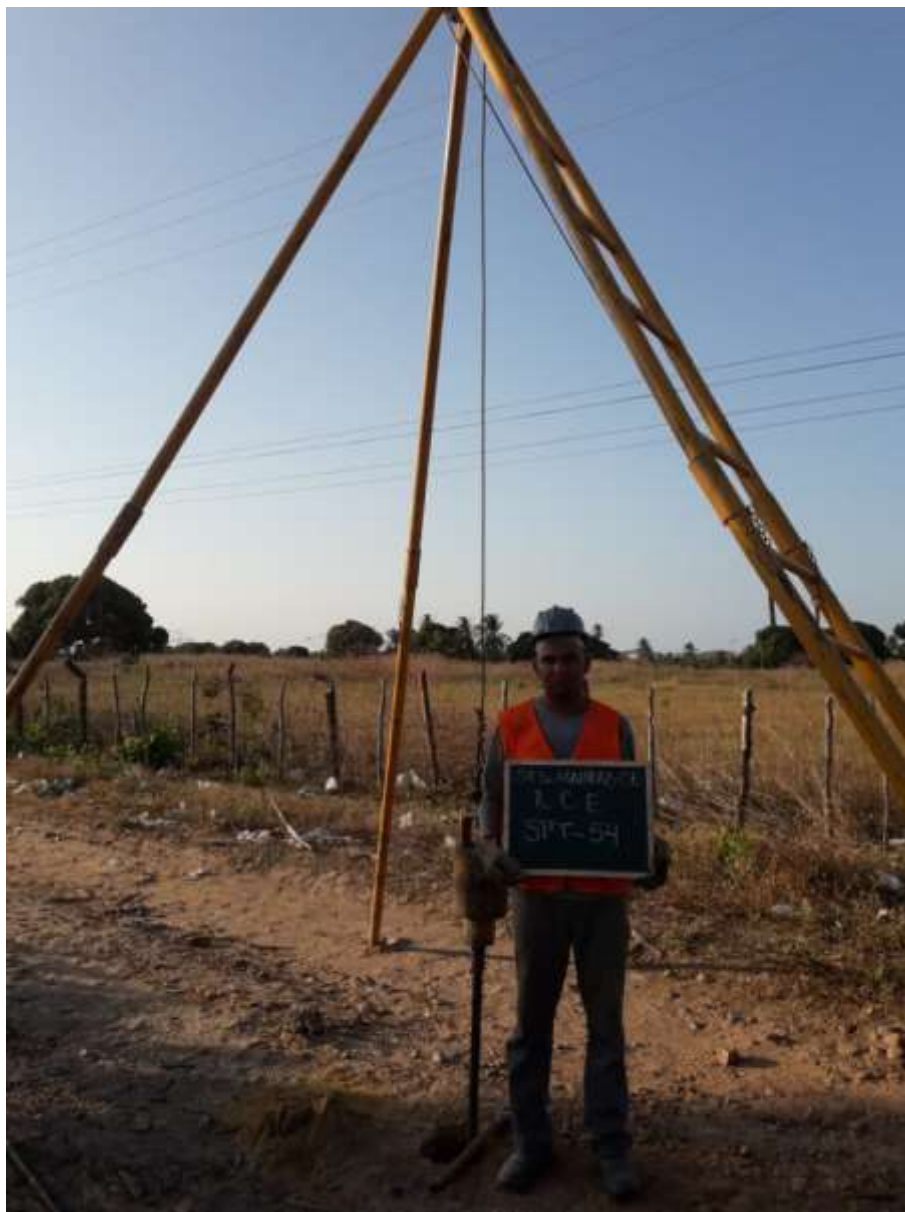
Instalação do furo SPT-54
