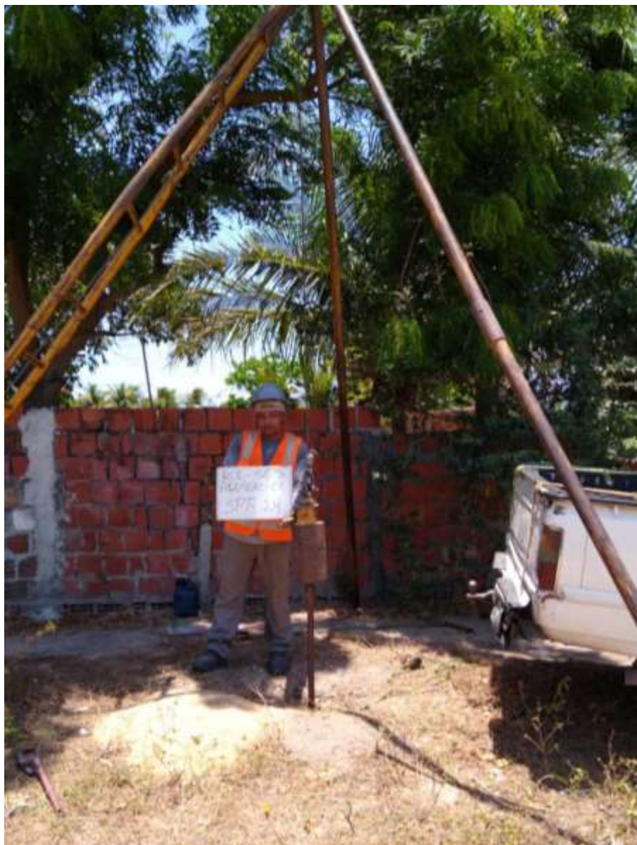
Instalação do furo SPT-24
