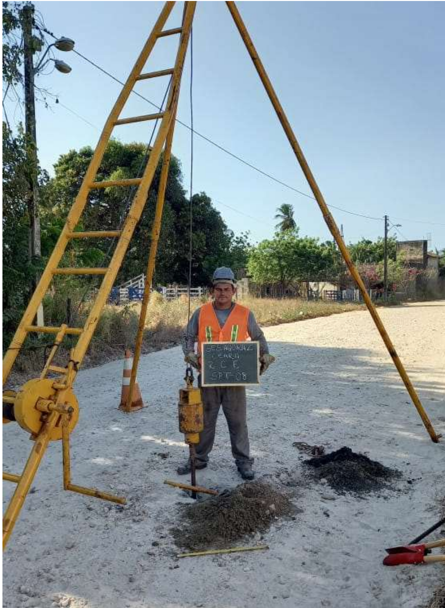
Instalação do furo SPT-08
