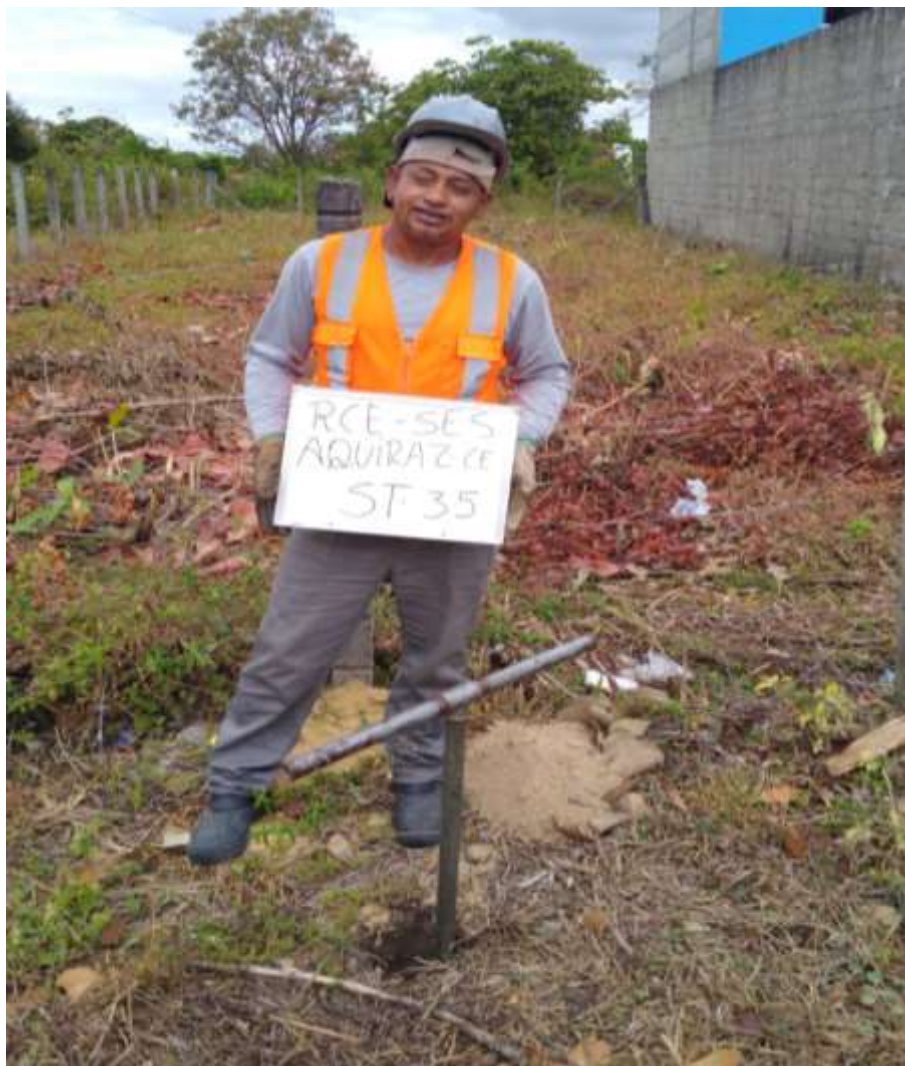
Instalação do furo ST-35
