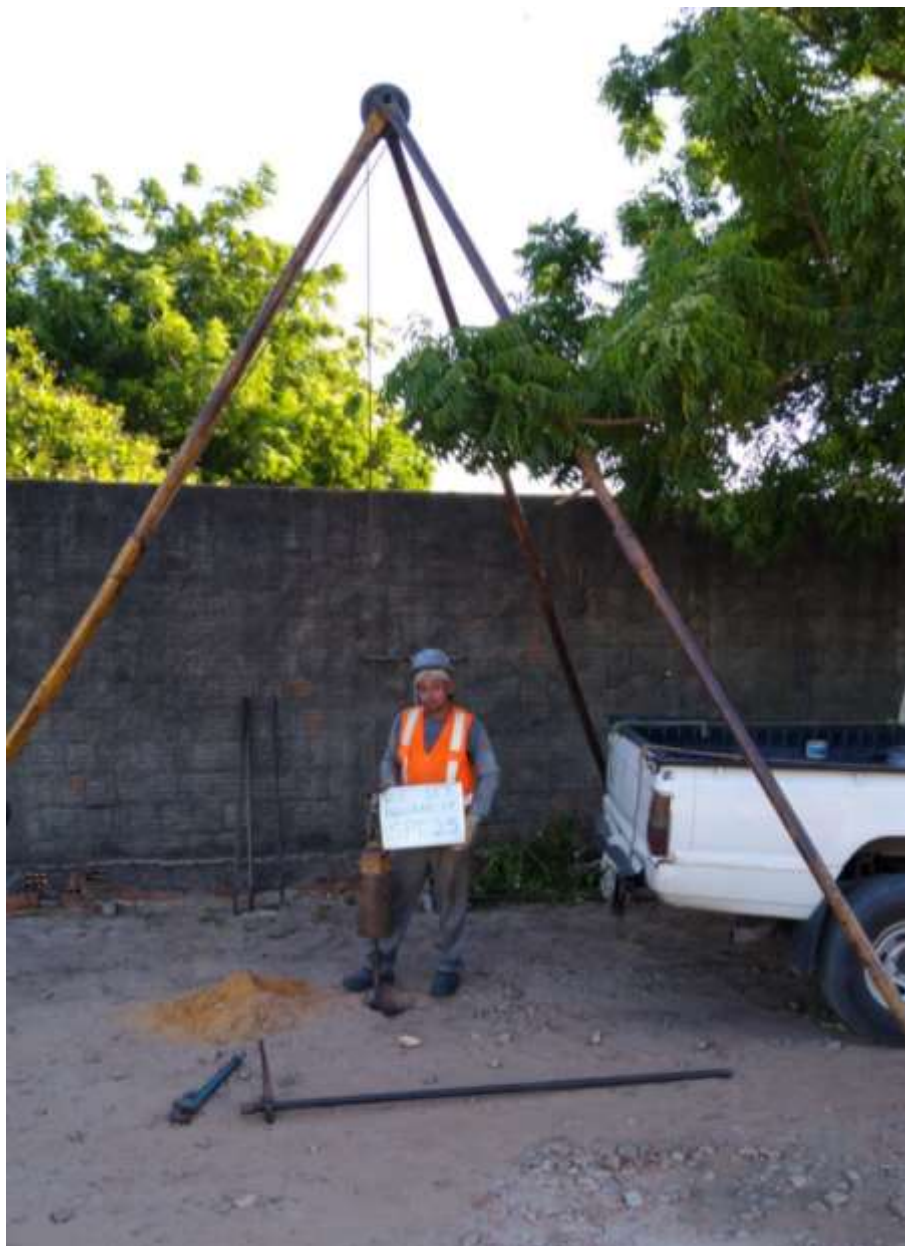
Instalação do furo SPT-25
