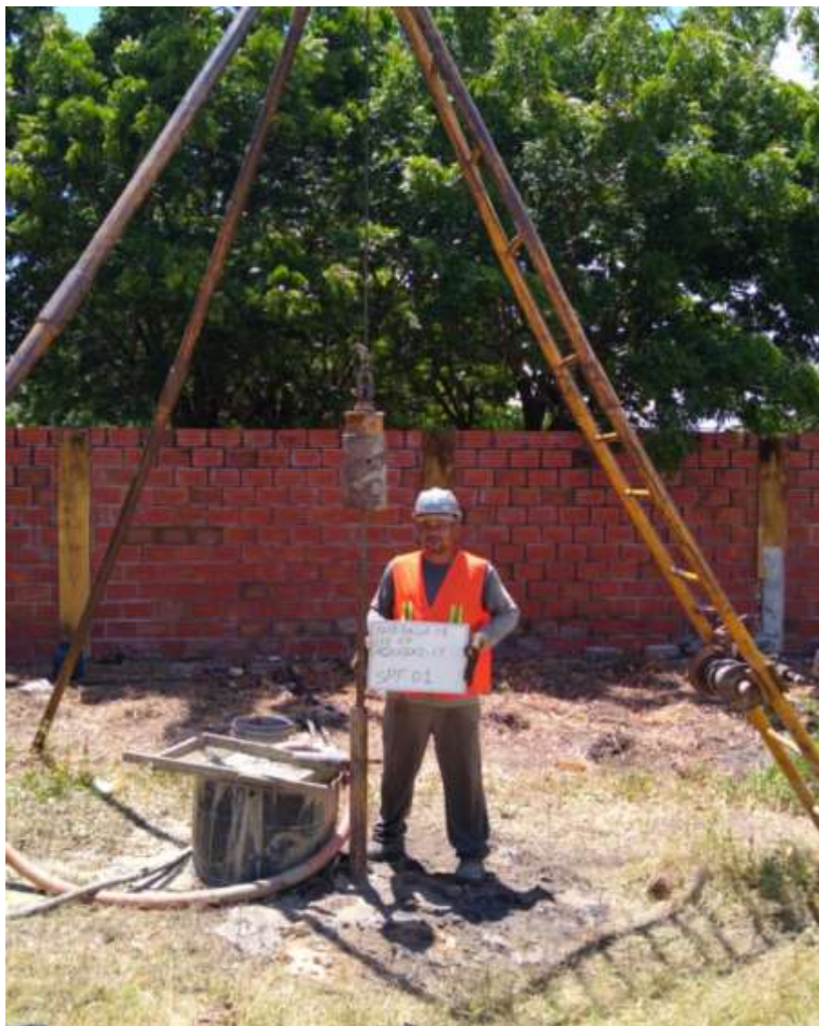
Instalação do furo SPT-EEE07
