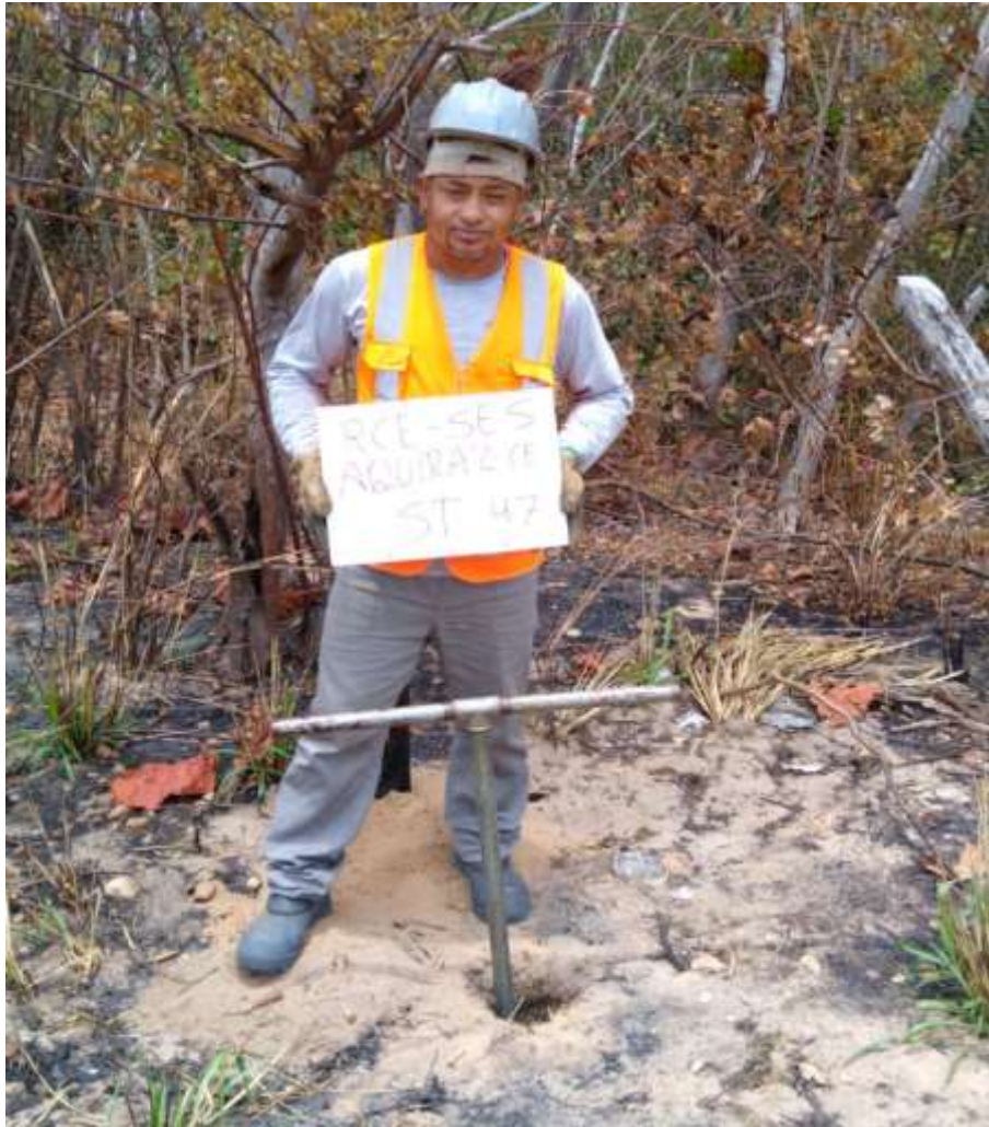
Instalação do furo ST-47
