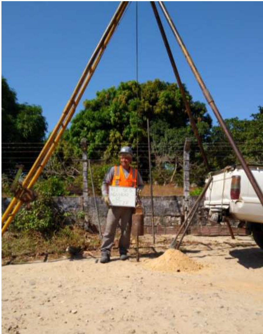
Instalação do furo SPT-17
