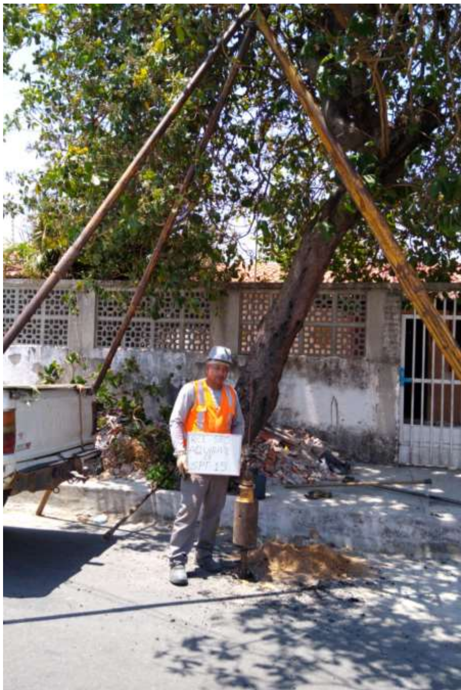
Instalação do furo SPT-15
