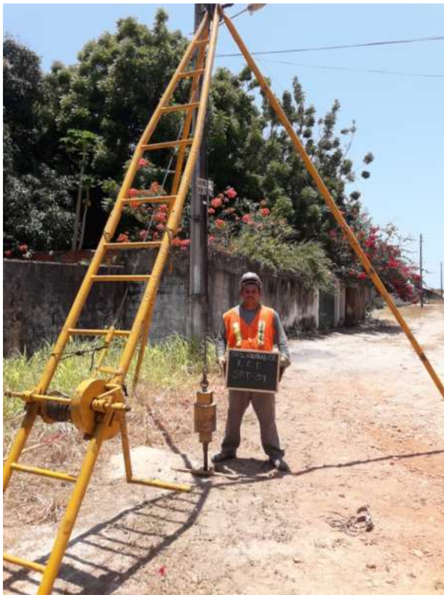
Instalação do furo SPT-39
