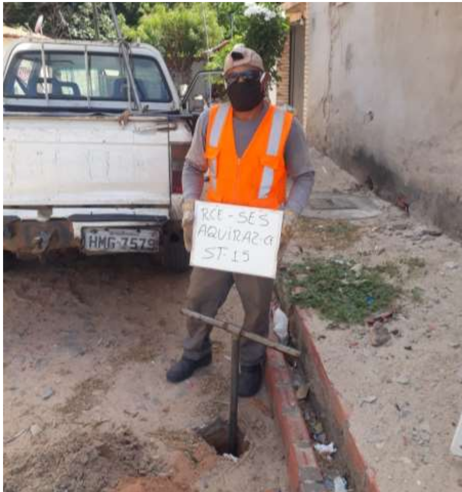
Instalação do furo ST-15
