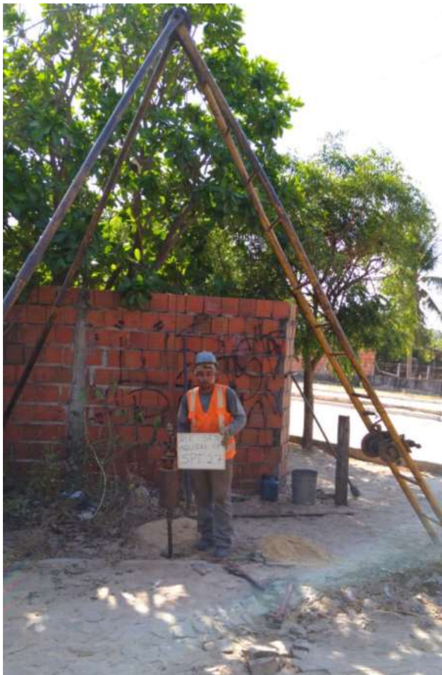
Instalação do furo SPT-27
