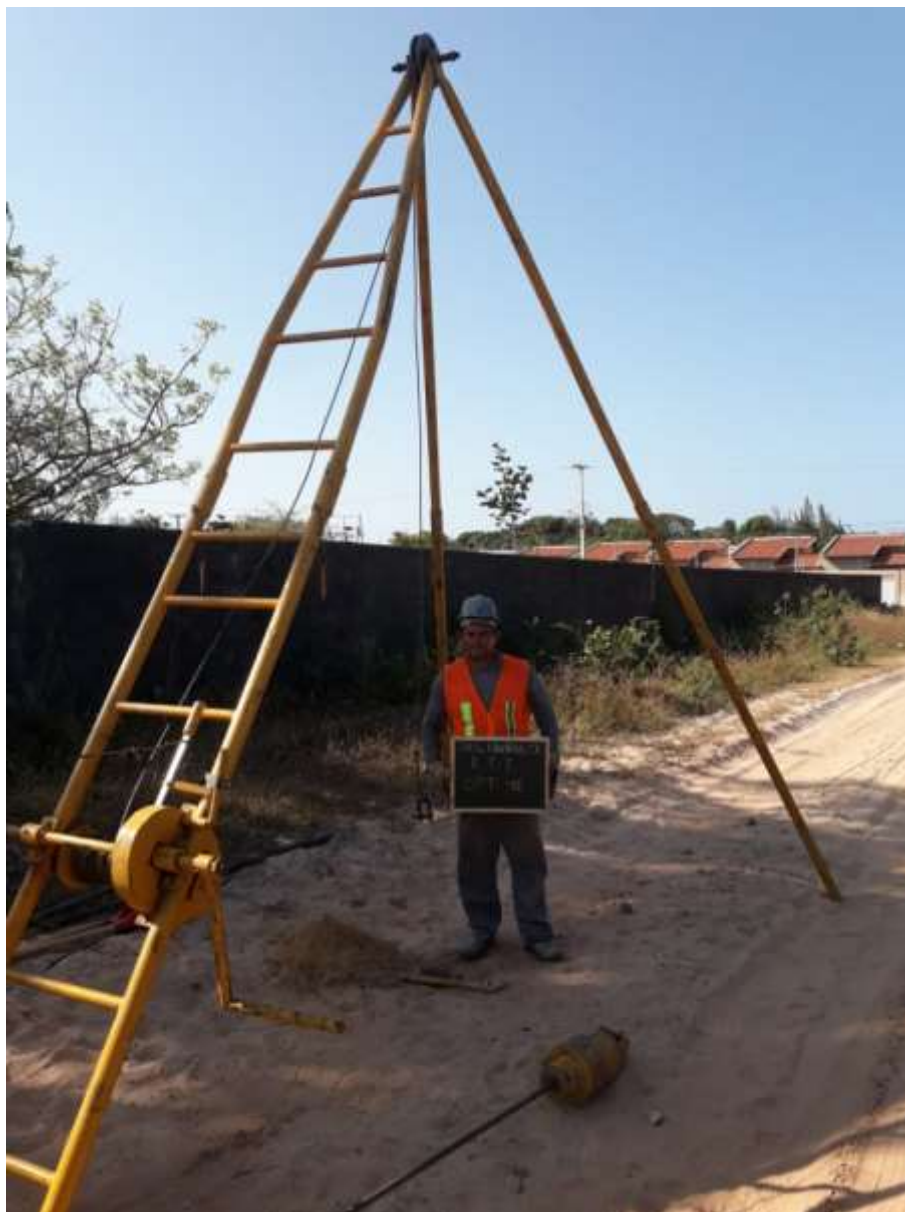
Instalação do furo SPT-41
