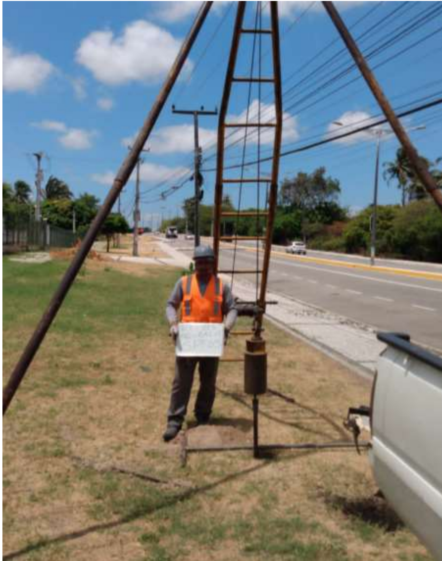
Instalação do furo SPT-05
