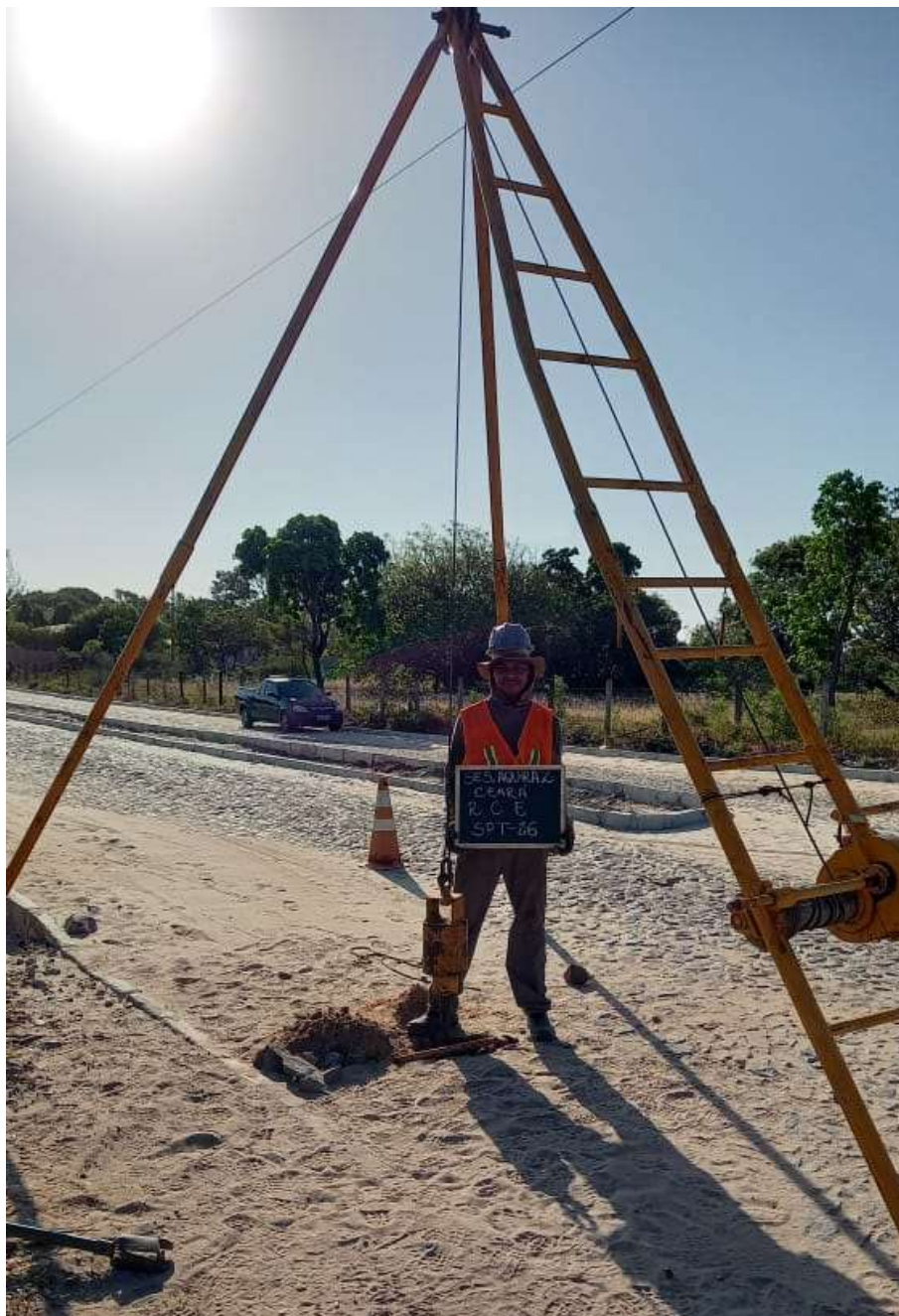
Instalação do furo SPT-26
