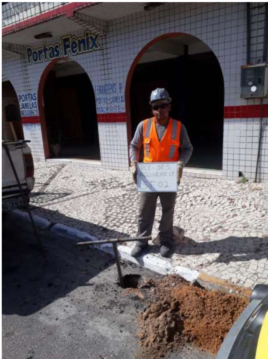
Instalação do furo ST-02
