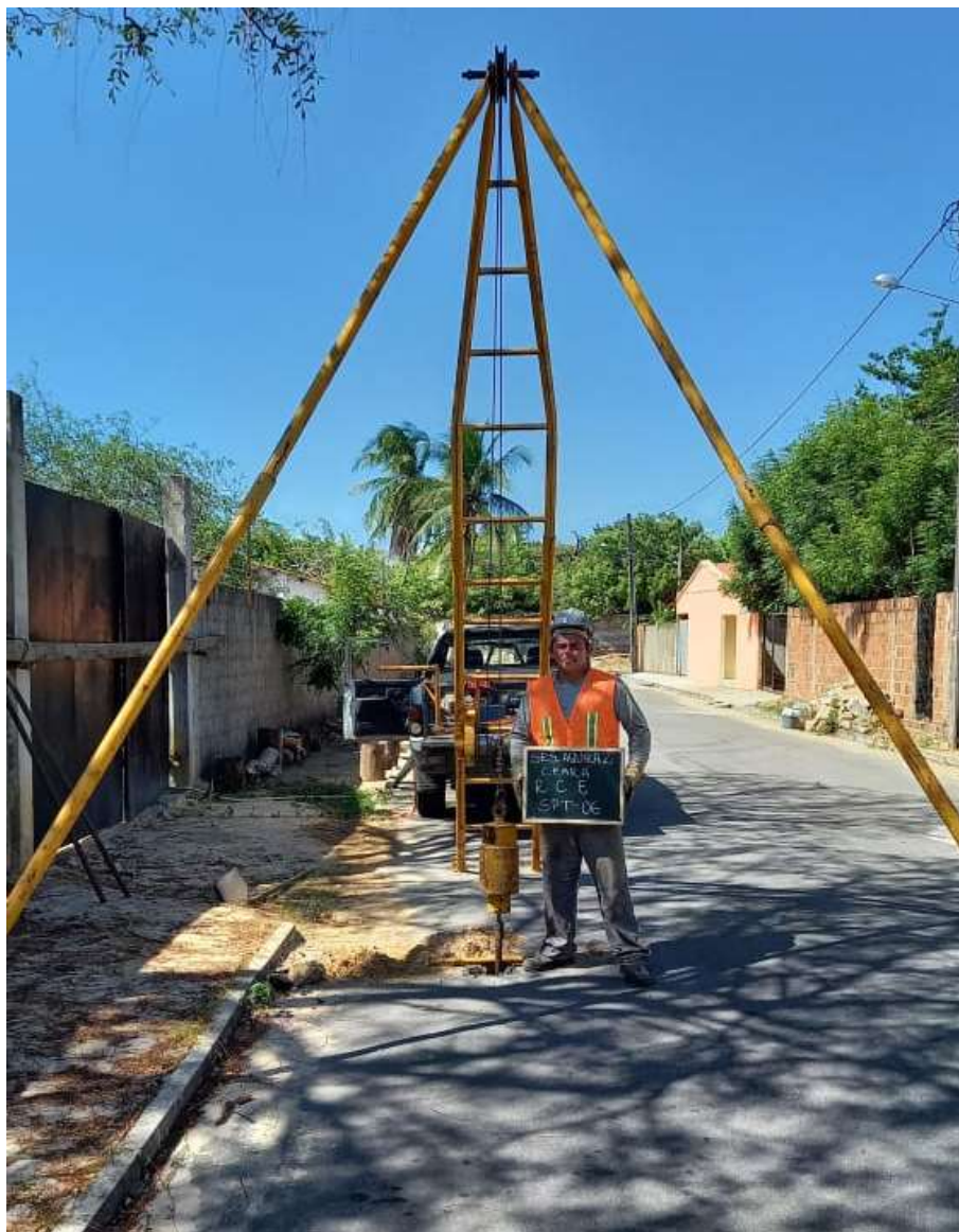
Instalação do furo SPT-06
