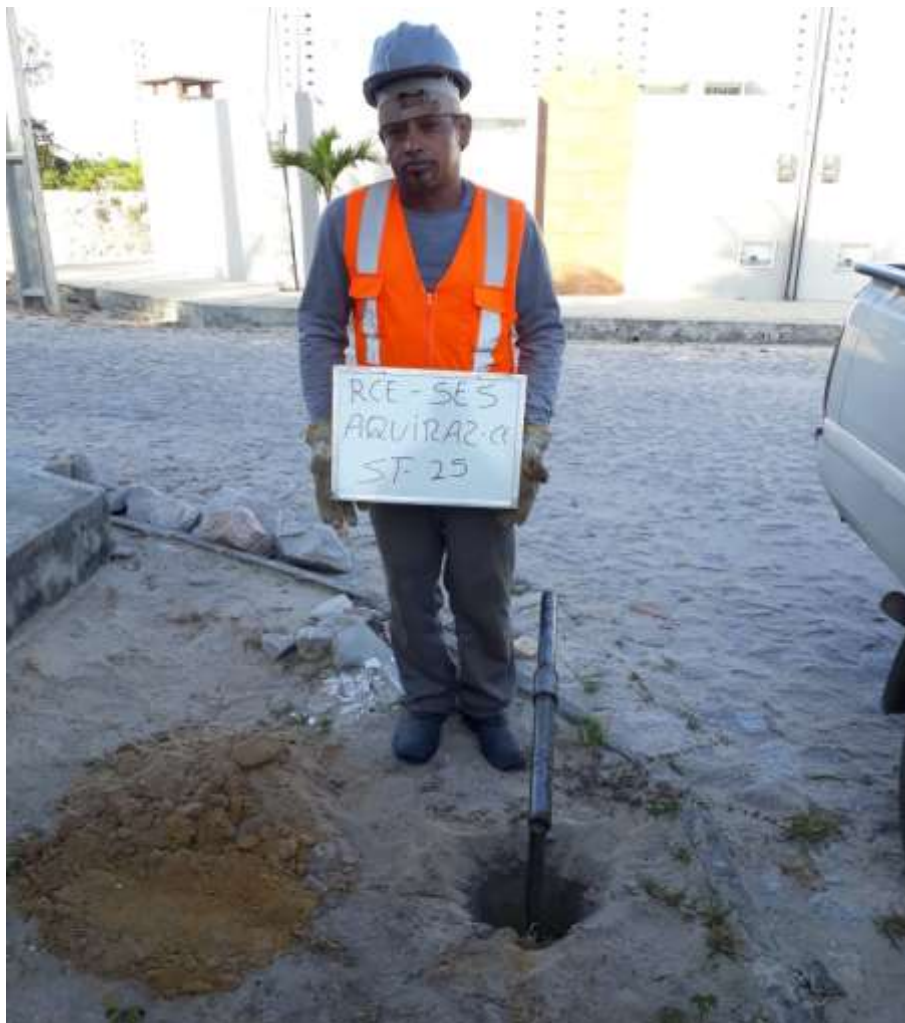
Instalação do furo ST-25
