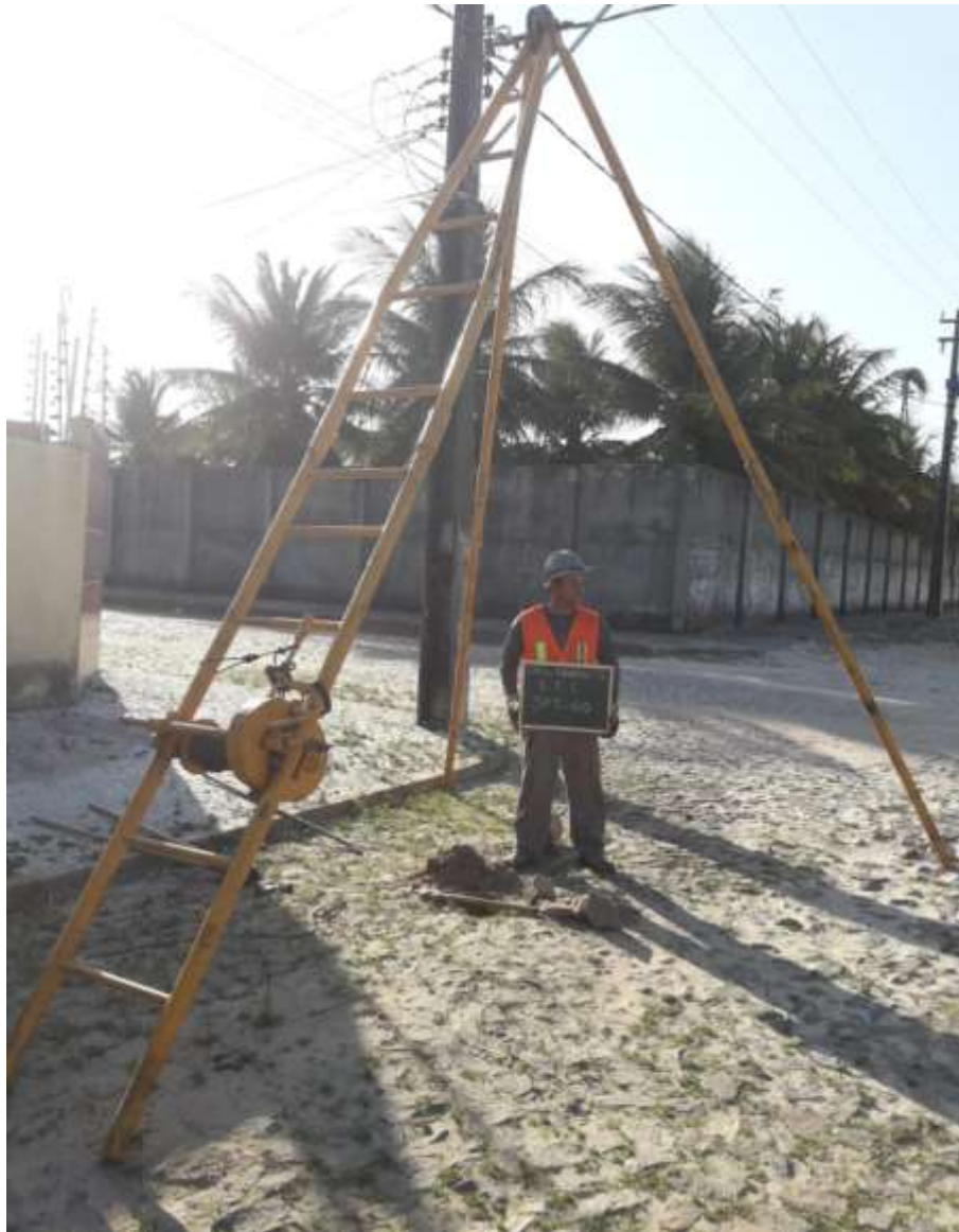
Instalação do furo SPT-50
