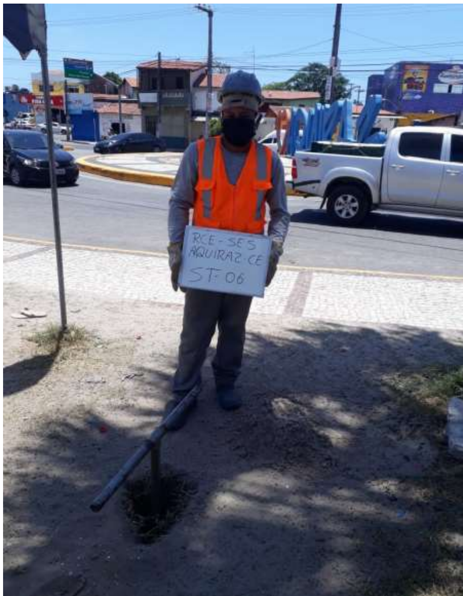
Instalação do furo ST-06
