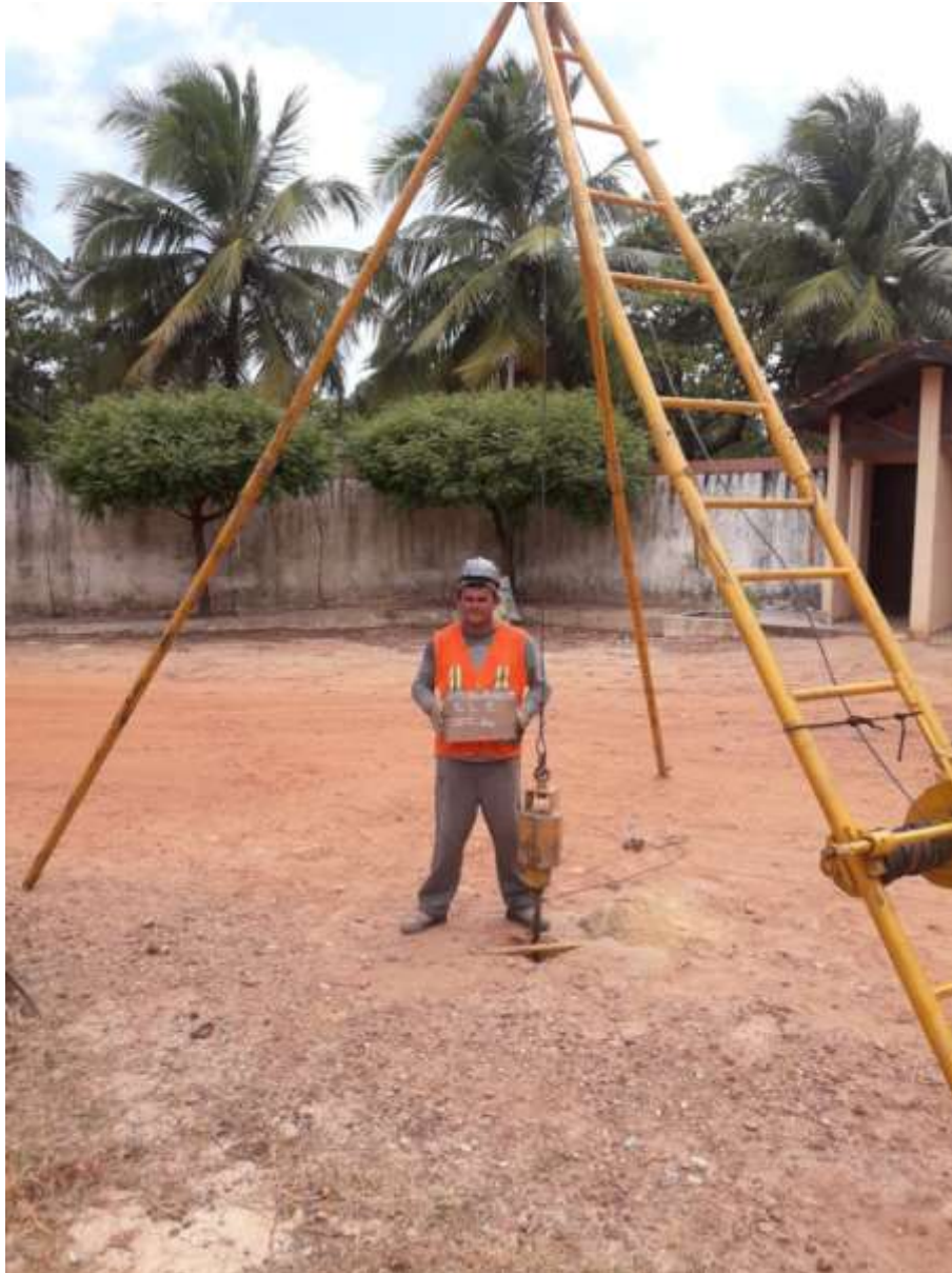
Instalação do furo SPT-34
