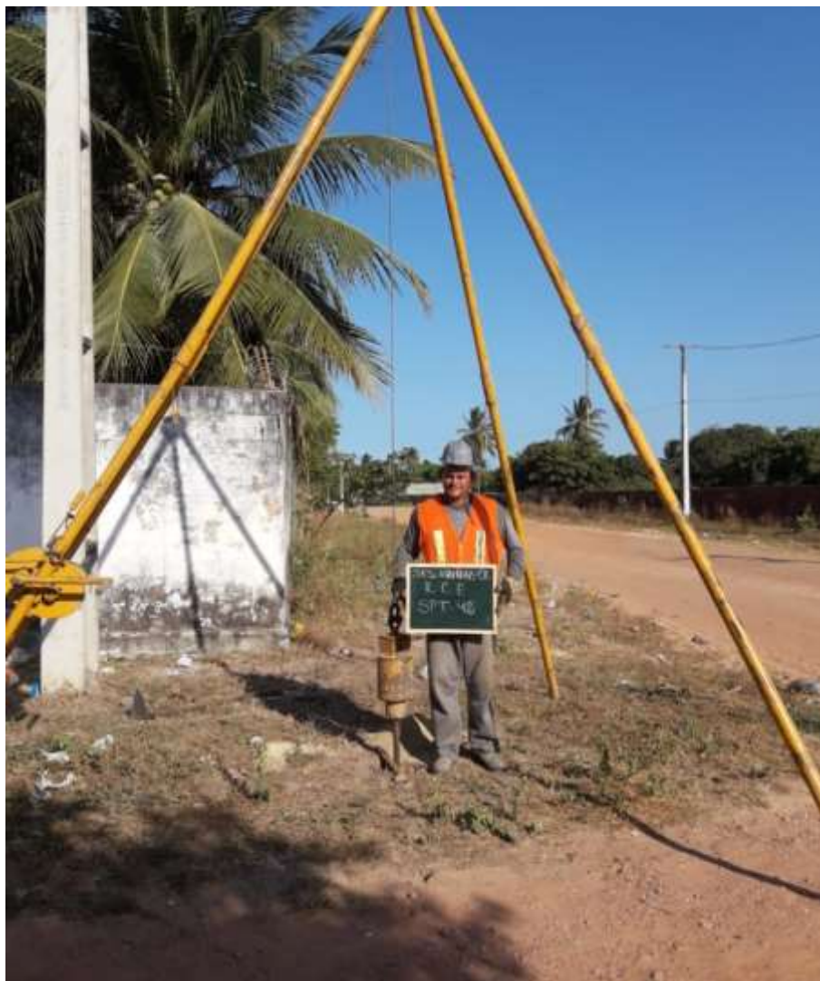
Instalação do furo SPT-42
