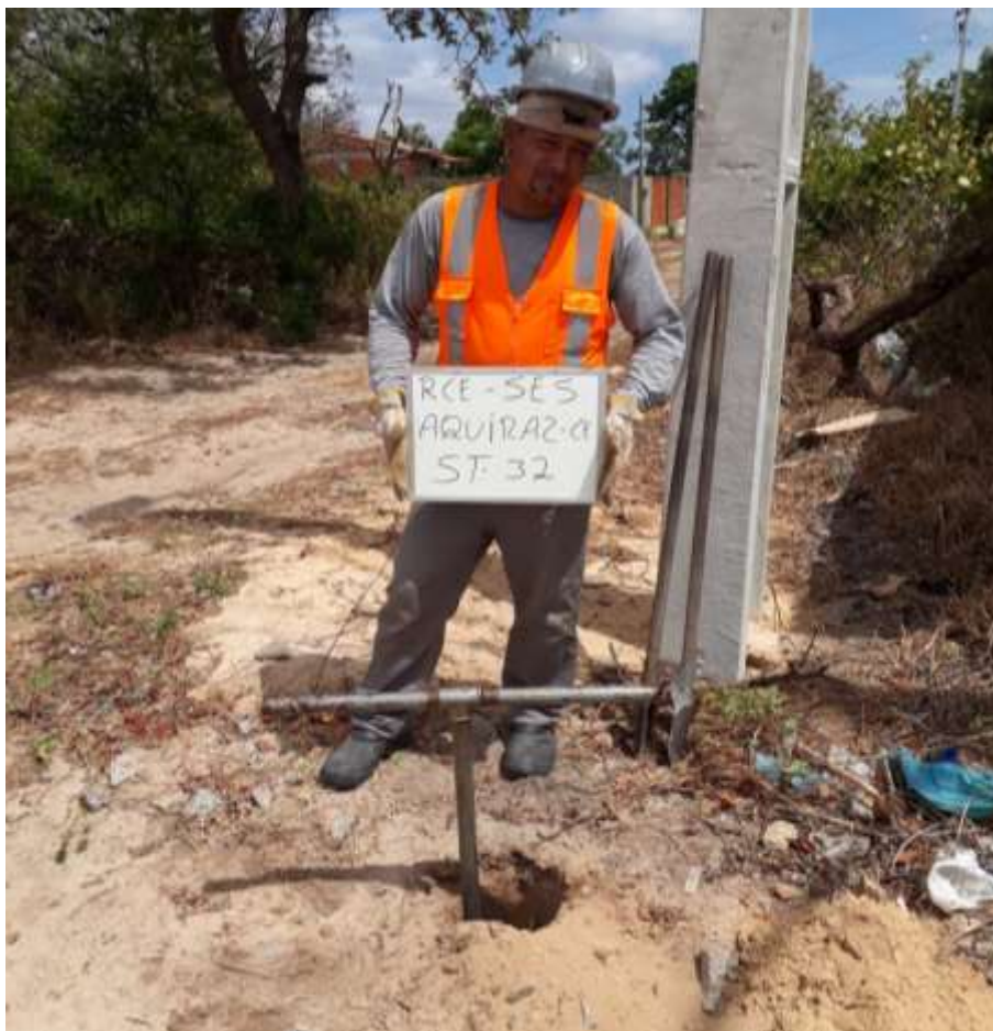
Instalação do furo ST-32
