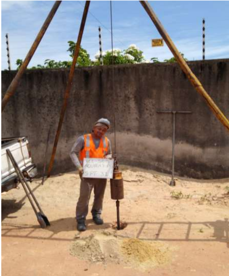
Instalação do furo SPT-31
