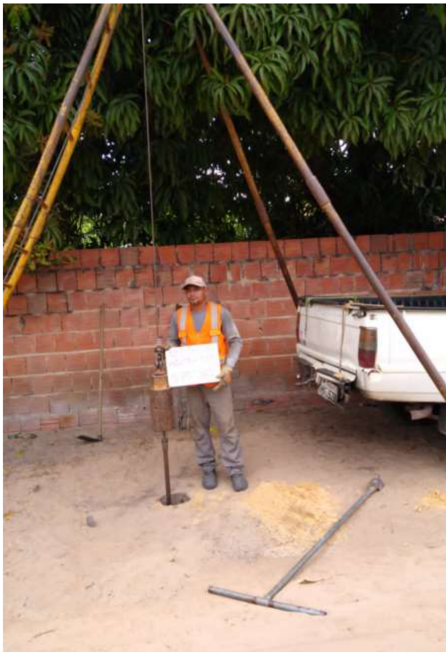
Instalação do furo SPT-30
