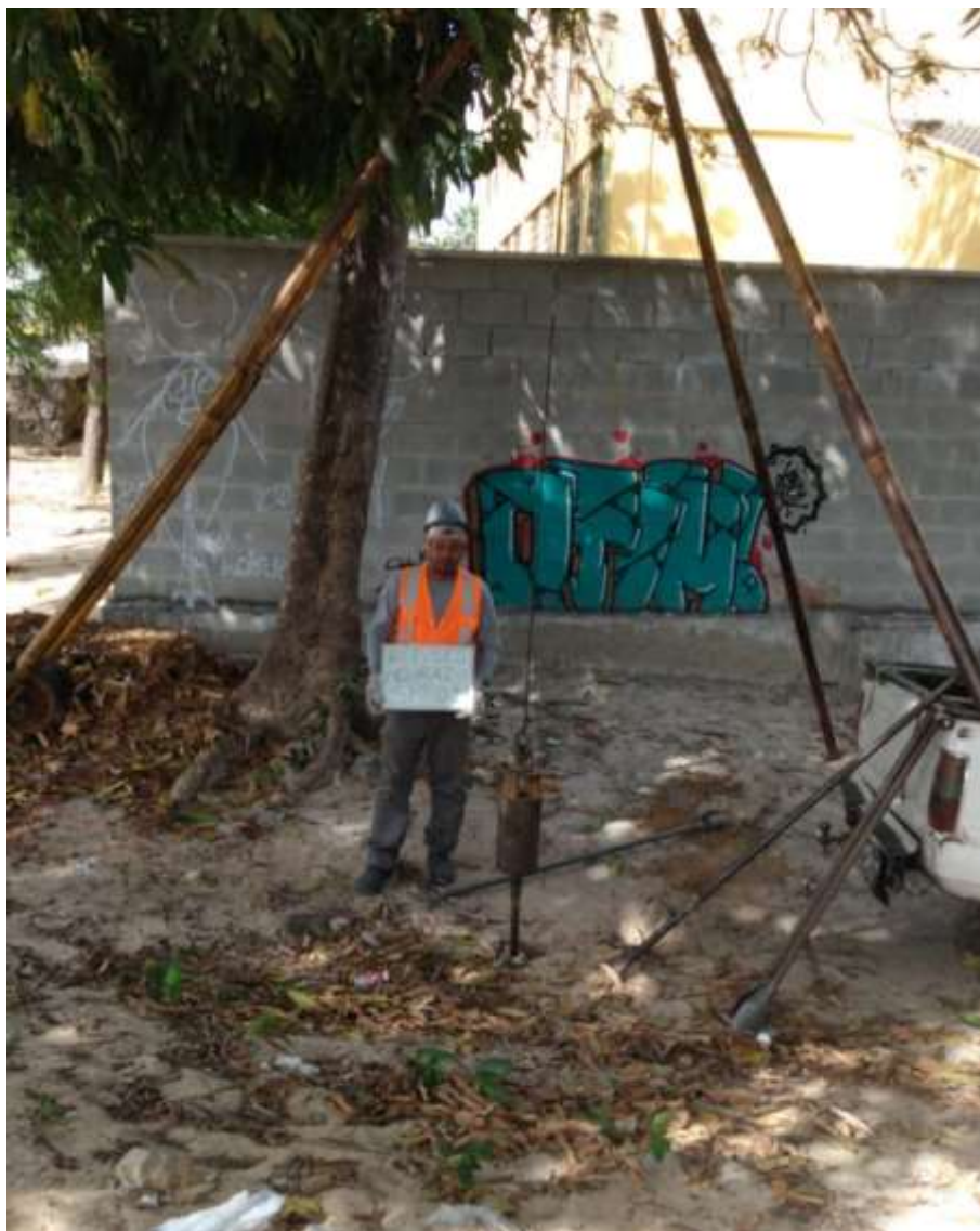
Instalação do furo SPT-01
