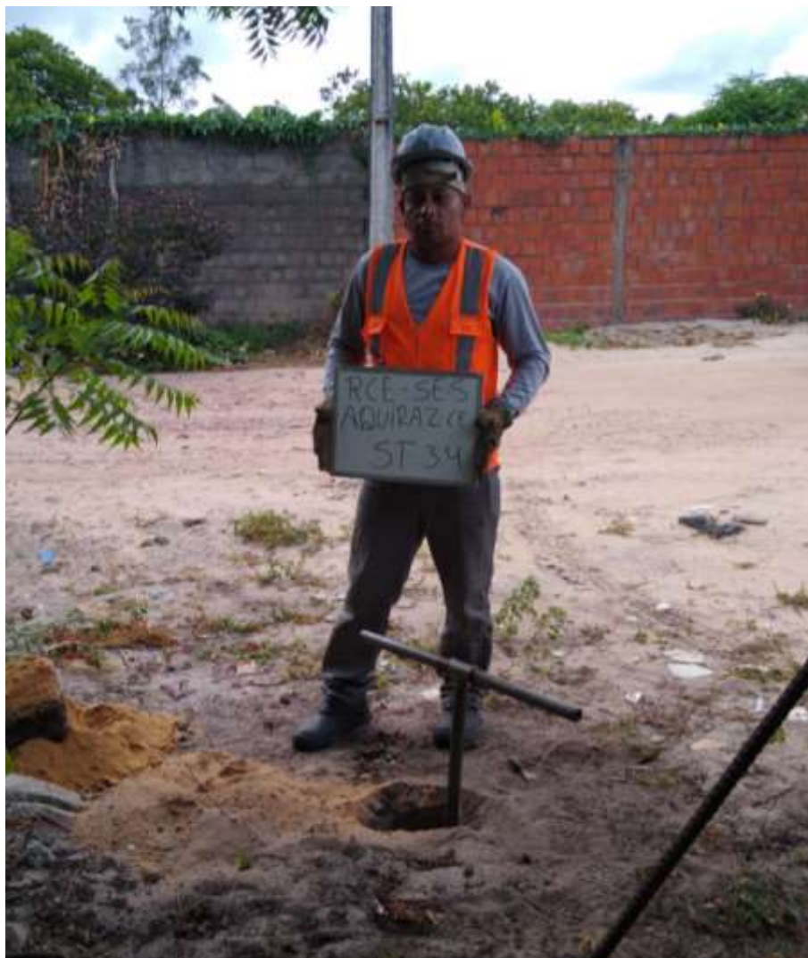
Instalação do furo ST-34
