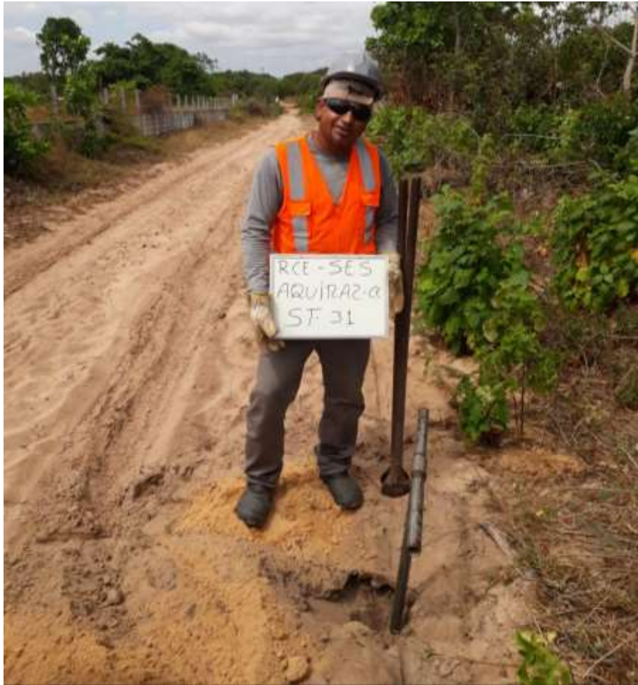
Instalação do furo ST-31
