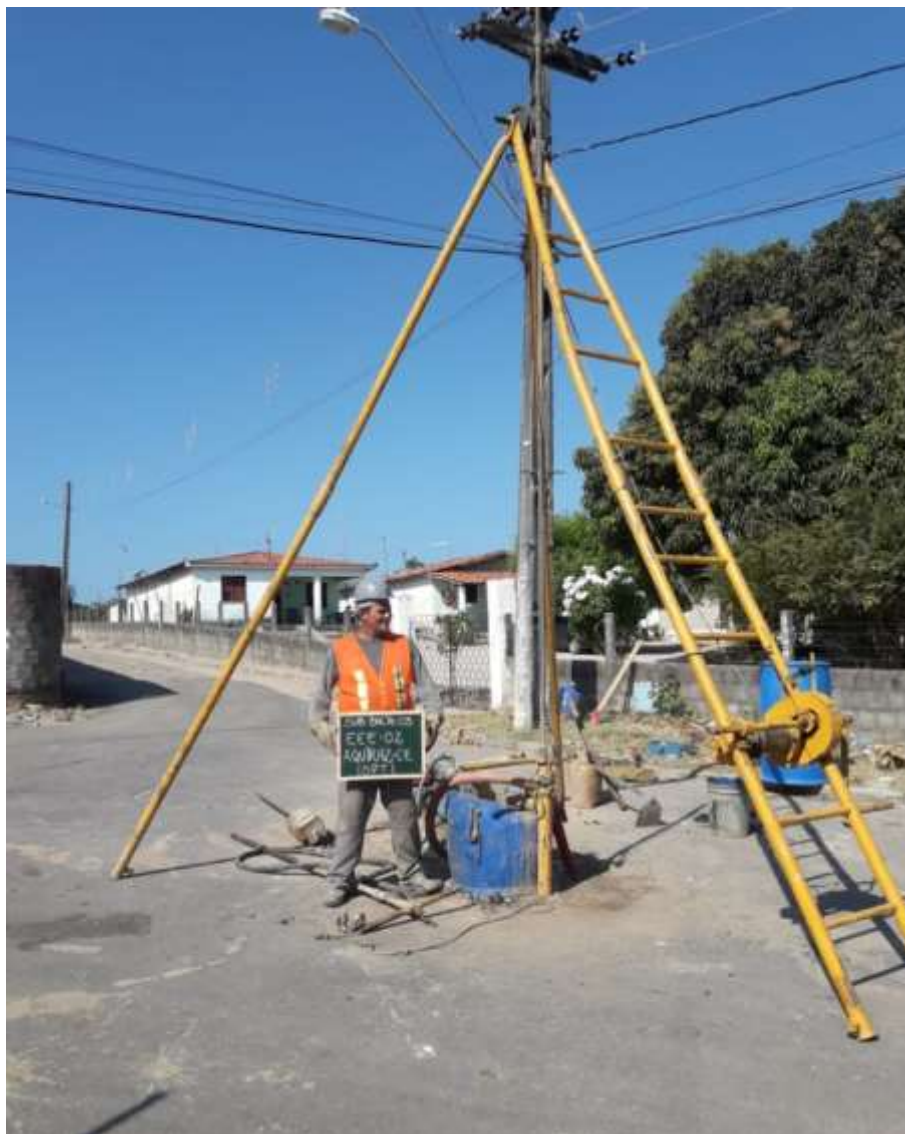
Instalação do furo SPT-EEE02
