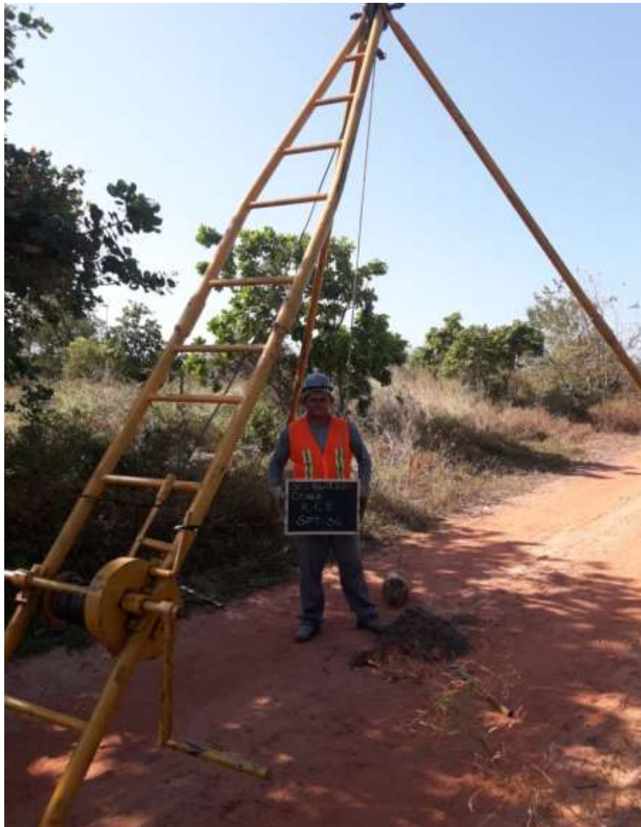
Instalação do furo SPT-36
