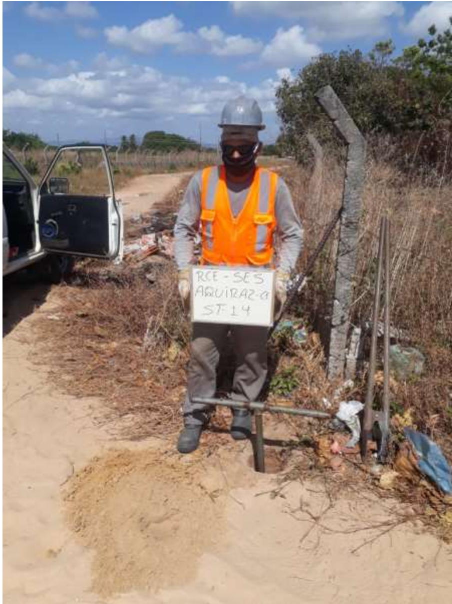
Instalação do furo ST-14
