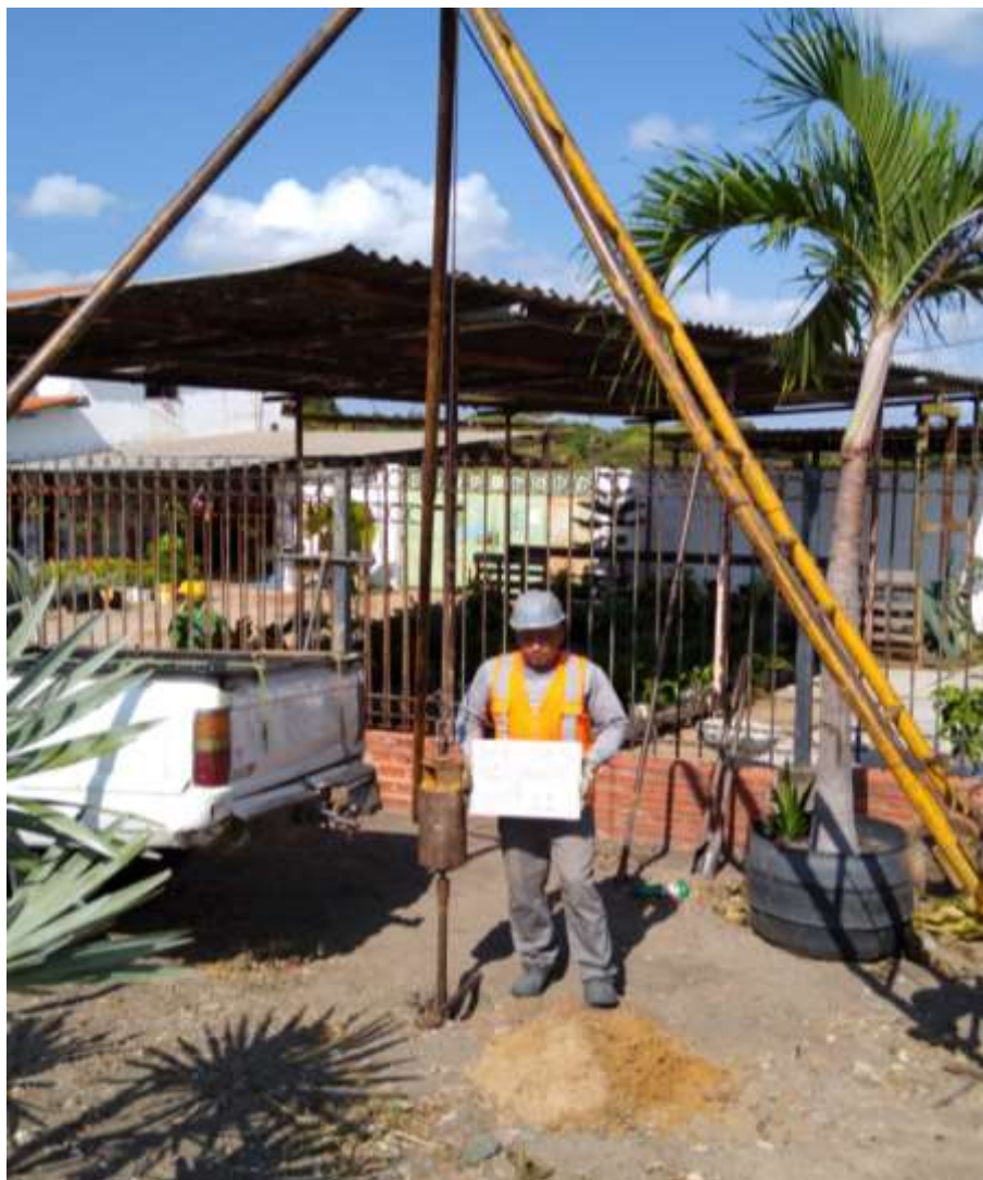
Instalação do furo SPT-11
