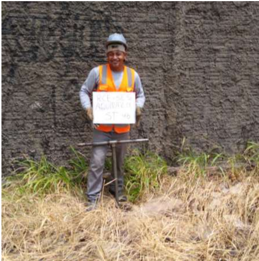
Instalação do furo ST-46
