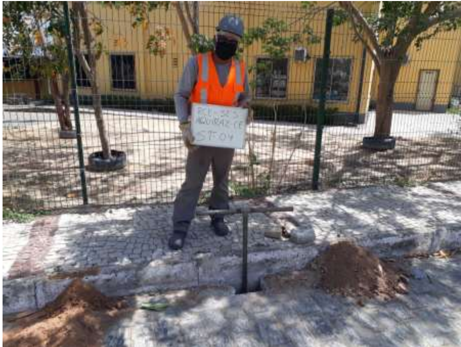
Instalação do furo ST-04
