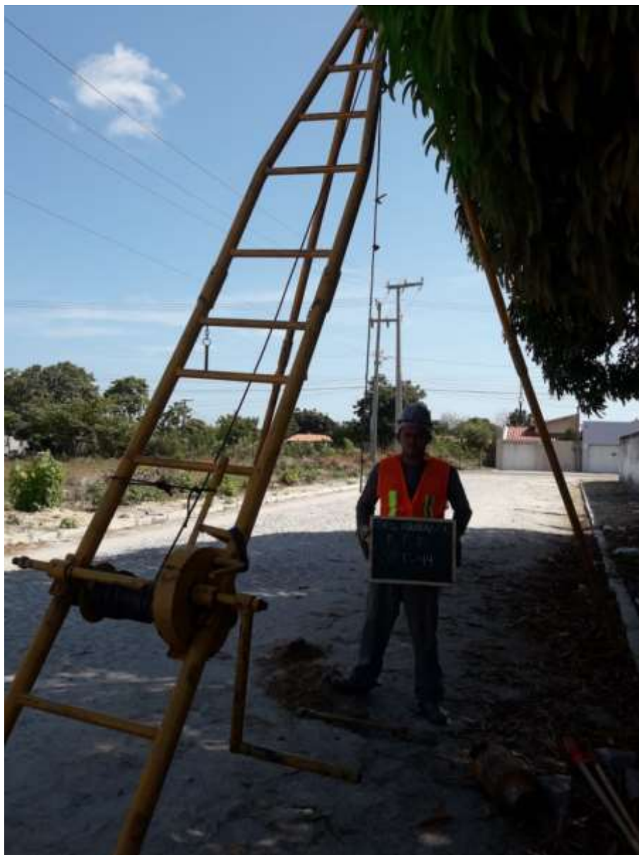
Instalação do furo SPT-44
