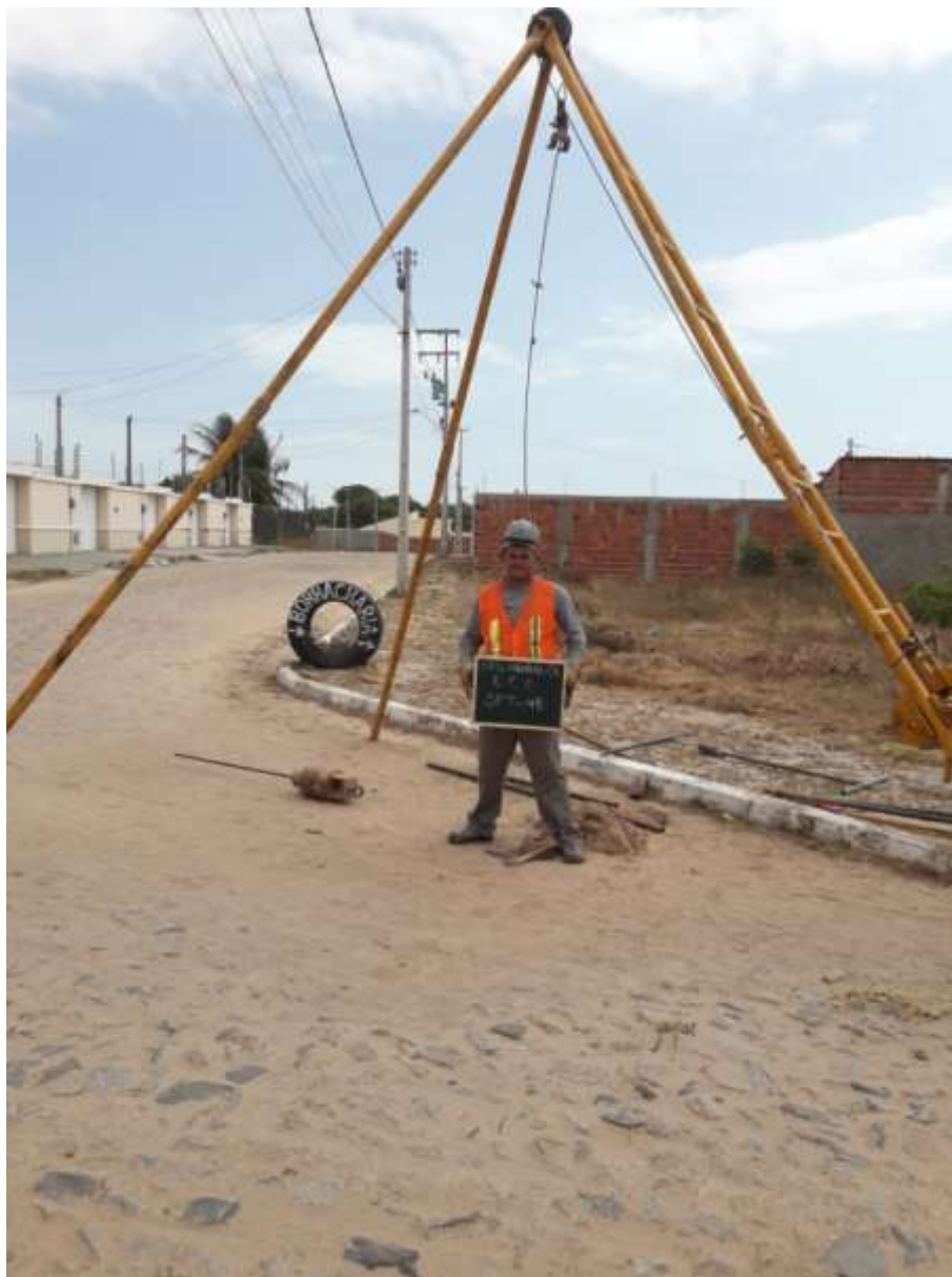
Instalação do furo SPT-48
