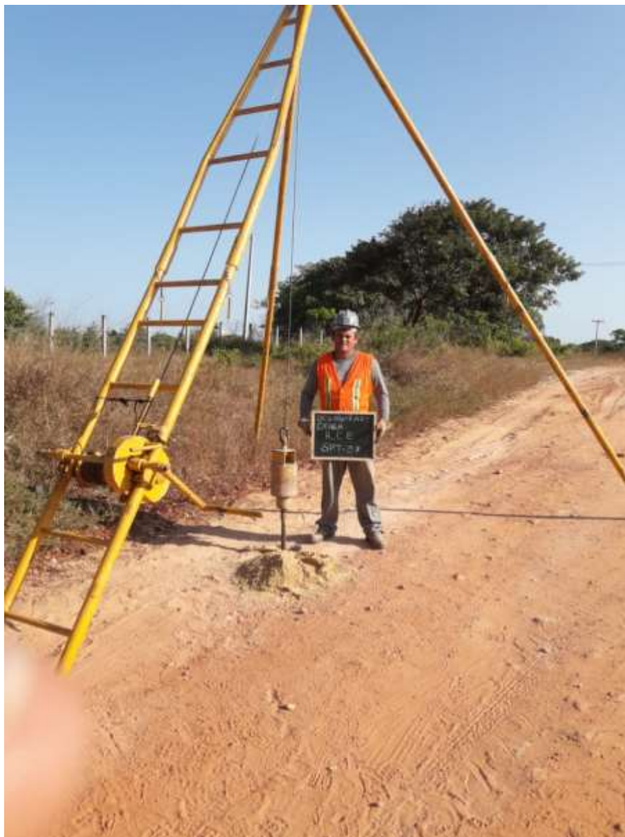
Instalação do furo SPT-37
