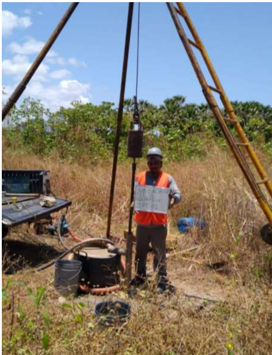
Instalação do furo SPT-EEE06
