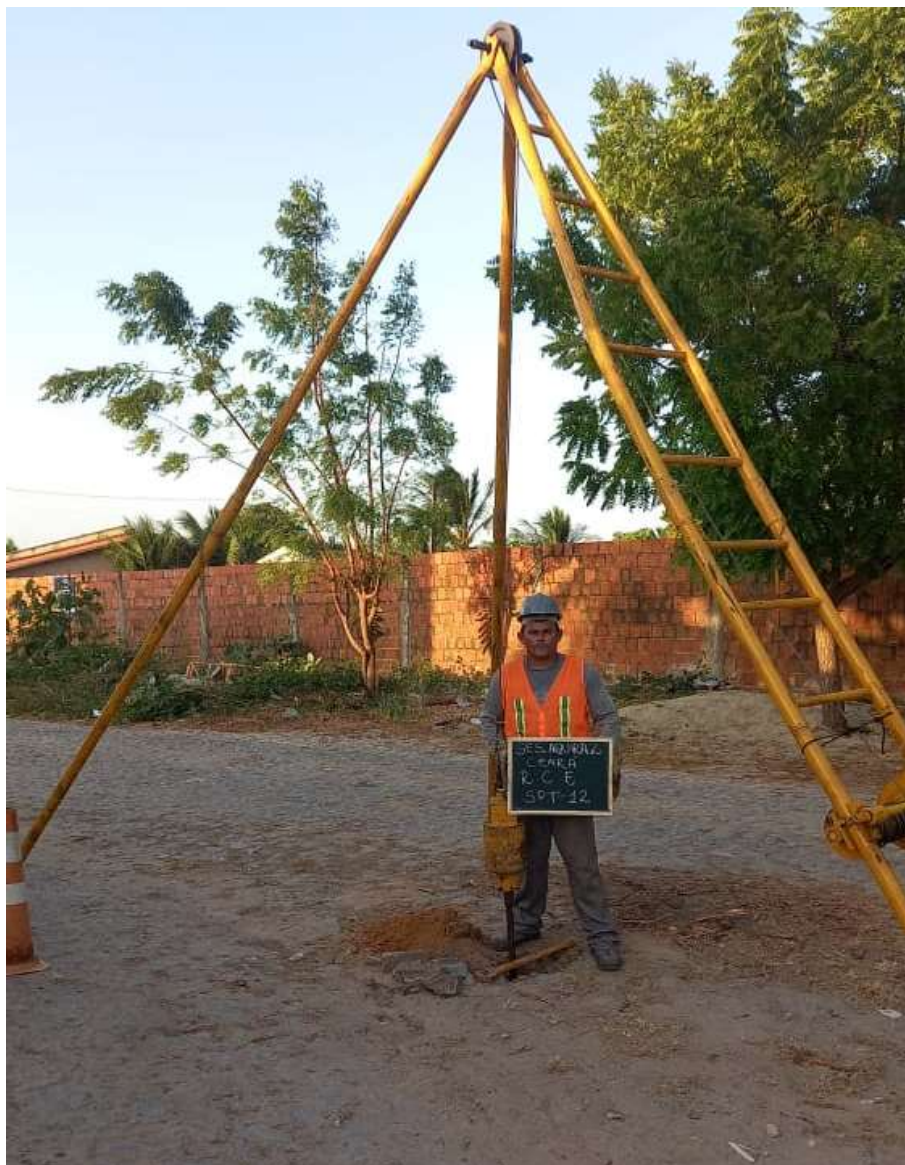
Instalação do furo SPT-12
