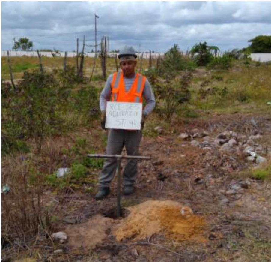
Instalação do furo ST-41
