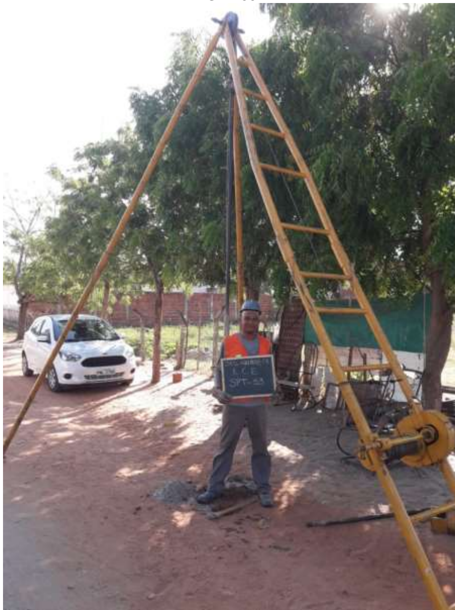
Instalação do furo SPT-53
