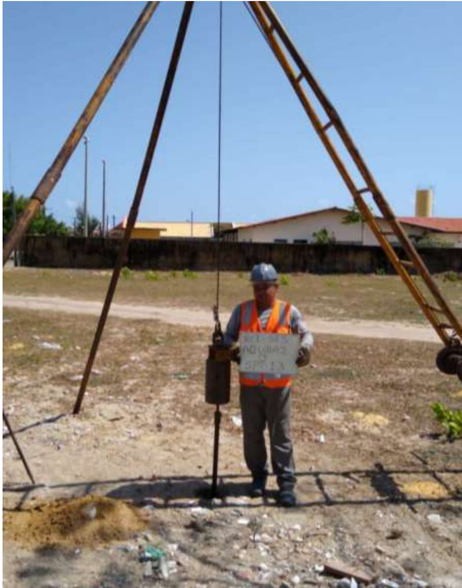
Instalação do furo SPT-13
