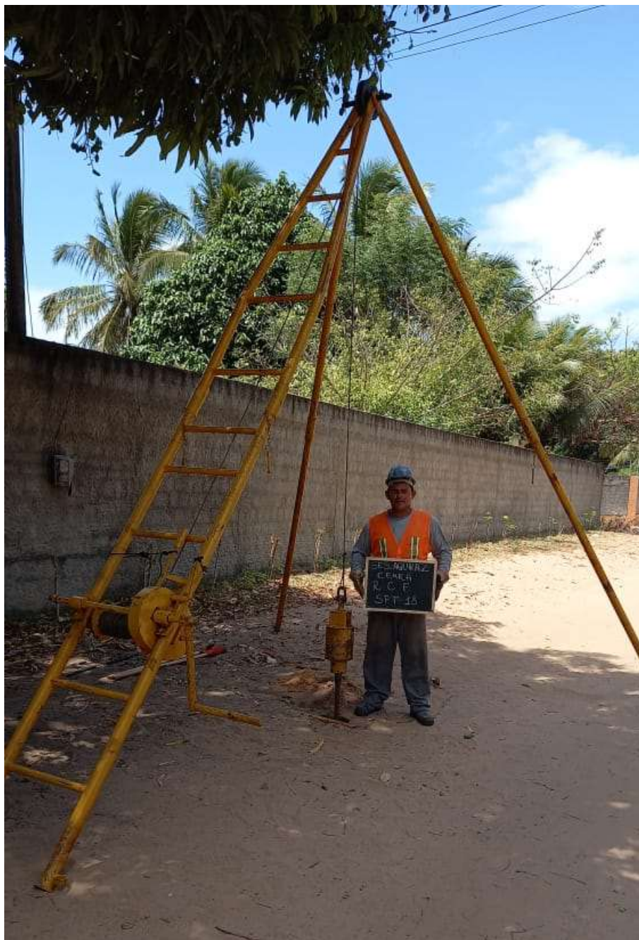
Instalação do furo SPT-18
