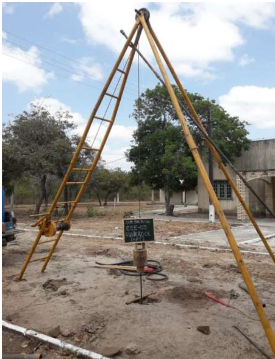
Instalação do furo SPT-EEE05
