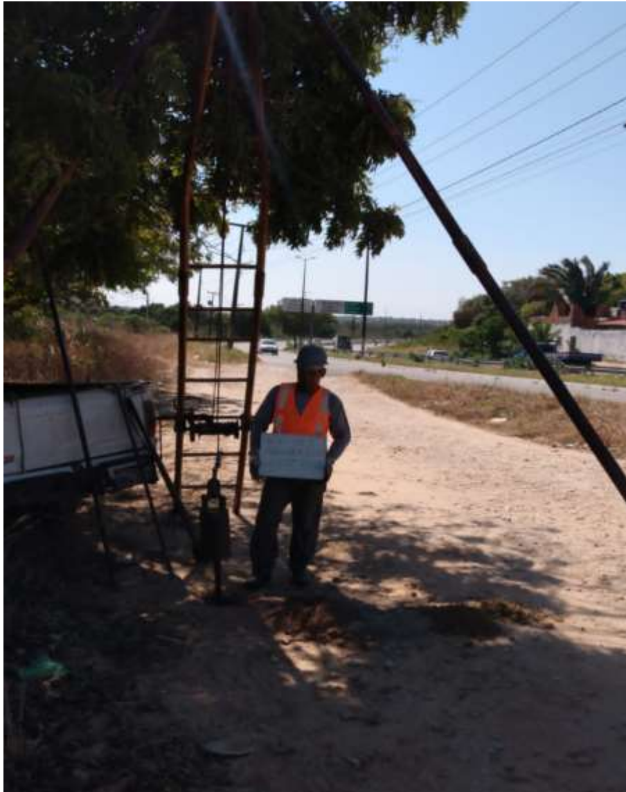
Instalação do furo SPT-07
