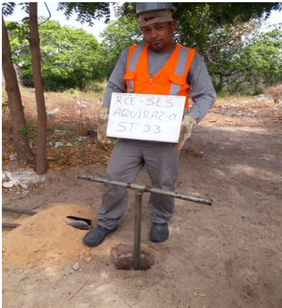
Instalação do furo ST-33
