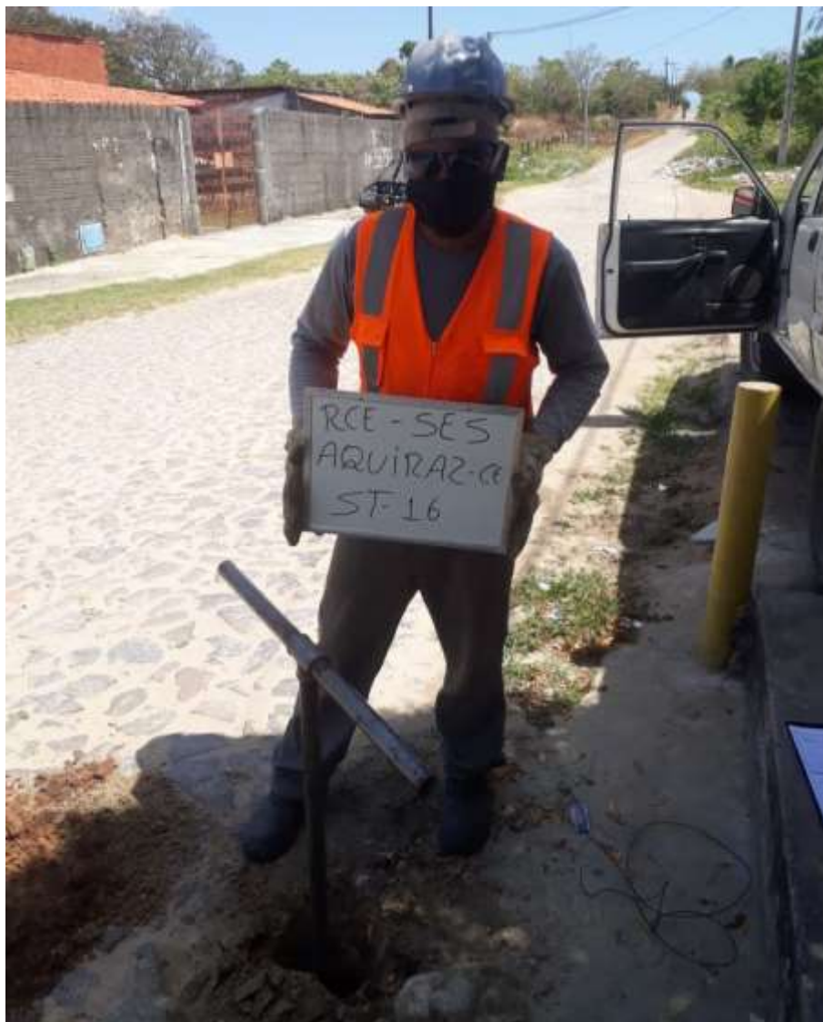
Instalação do furo ST-16
