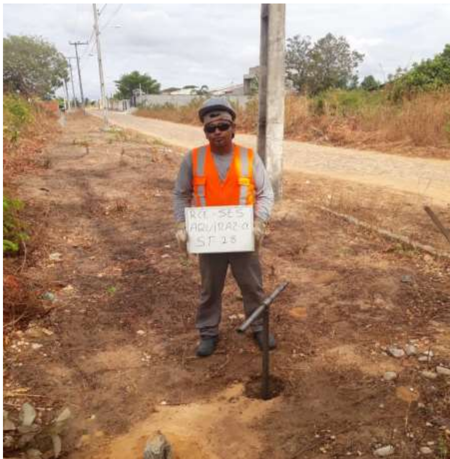
Instalação do furo ST-28
