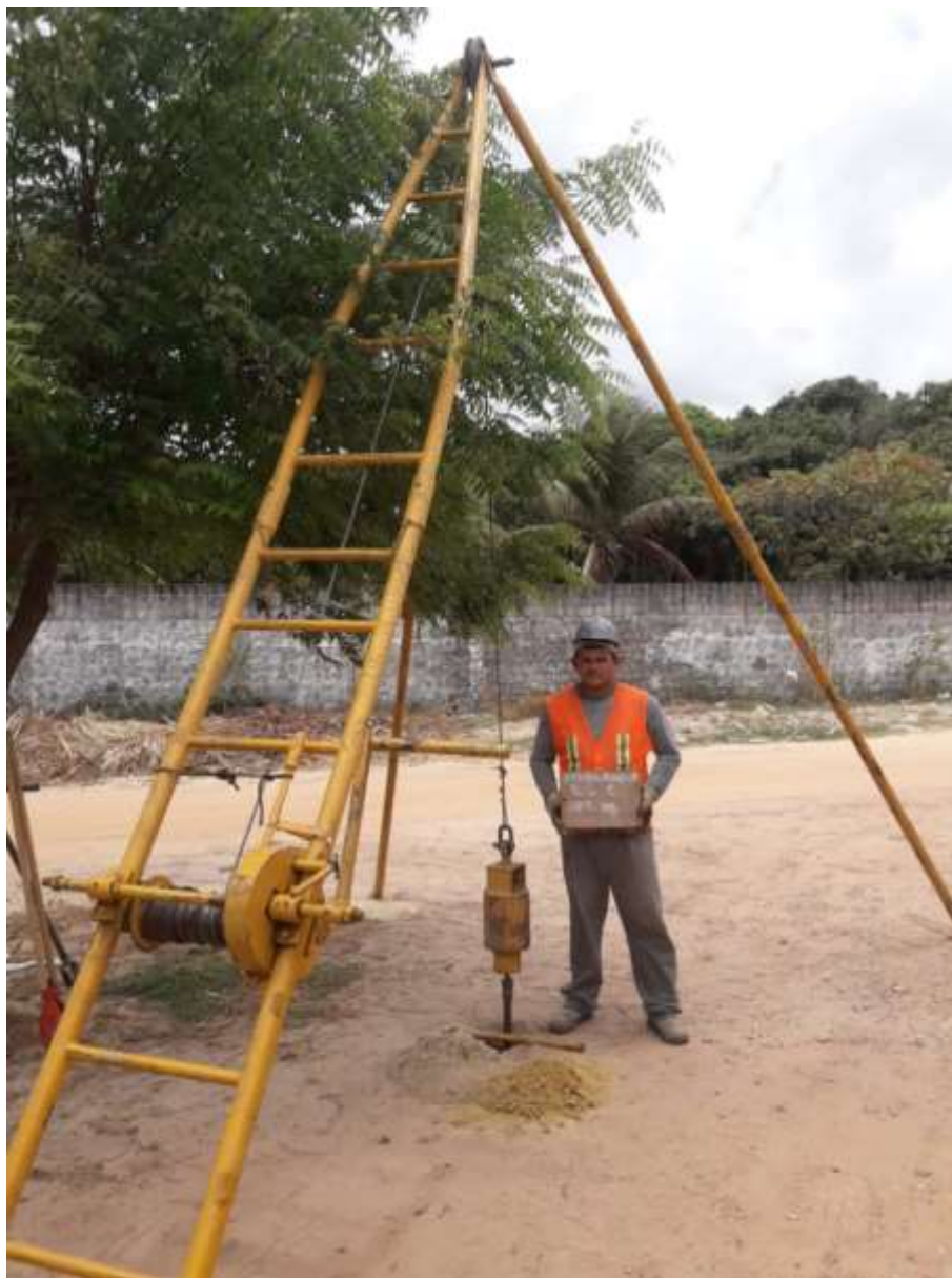
Instalação do furo SPT-55
