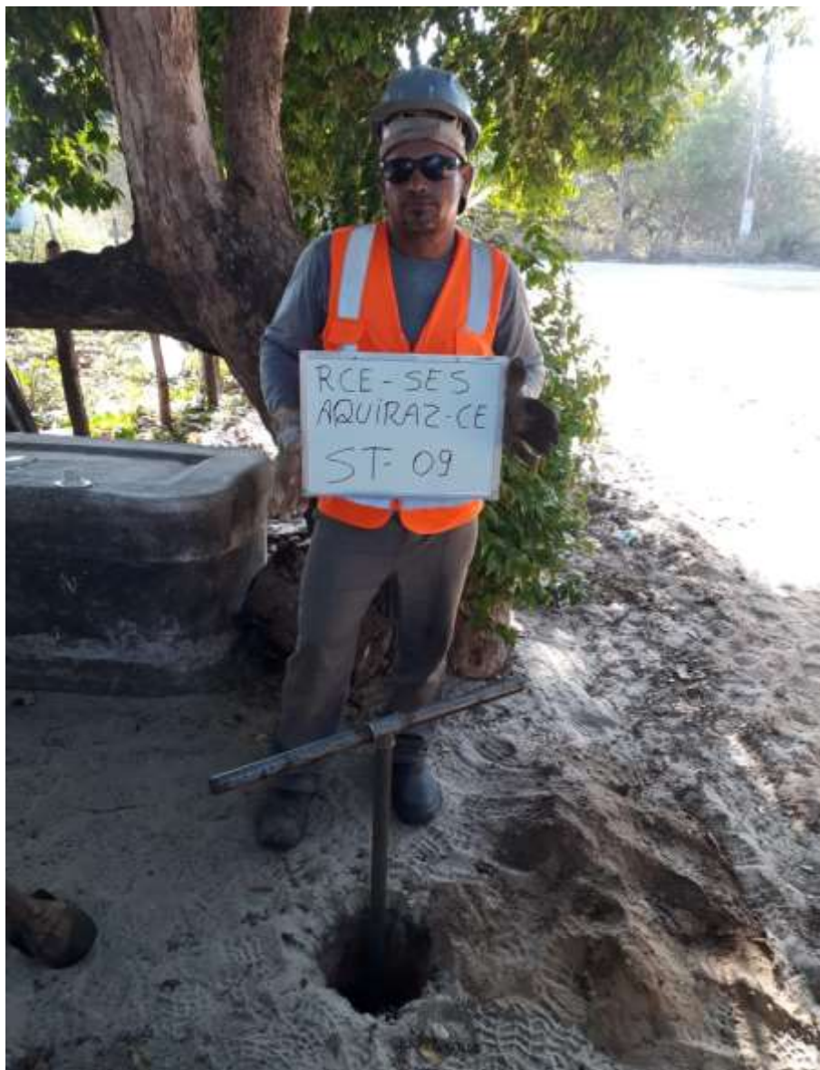
Instalação do furo ST-09
