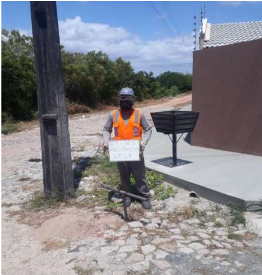
Instalação do furo ST-17
