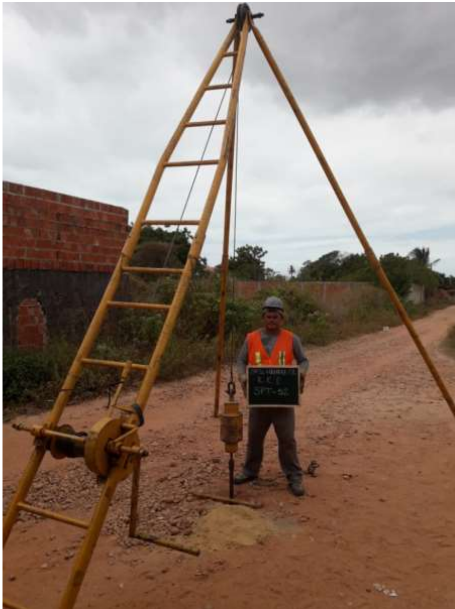
Instalação do furo SPT-52
