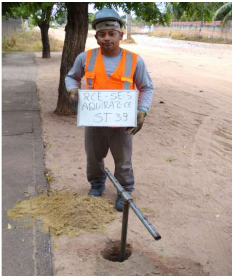
Instalação do furo ST-39
