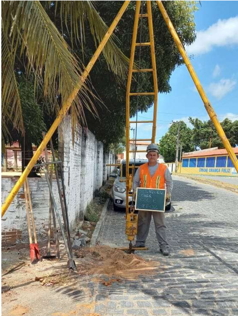
Instalação do furo SPT-02
