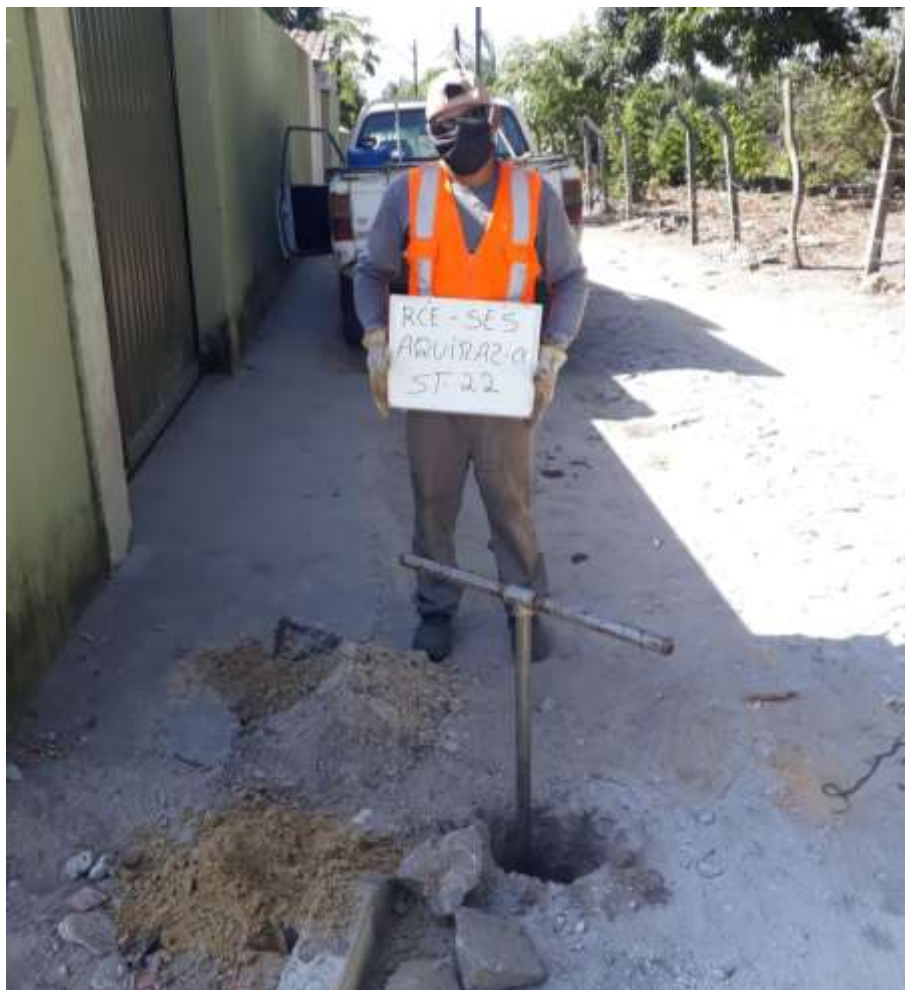
Instalação do furo ST-22
