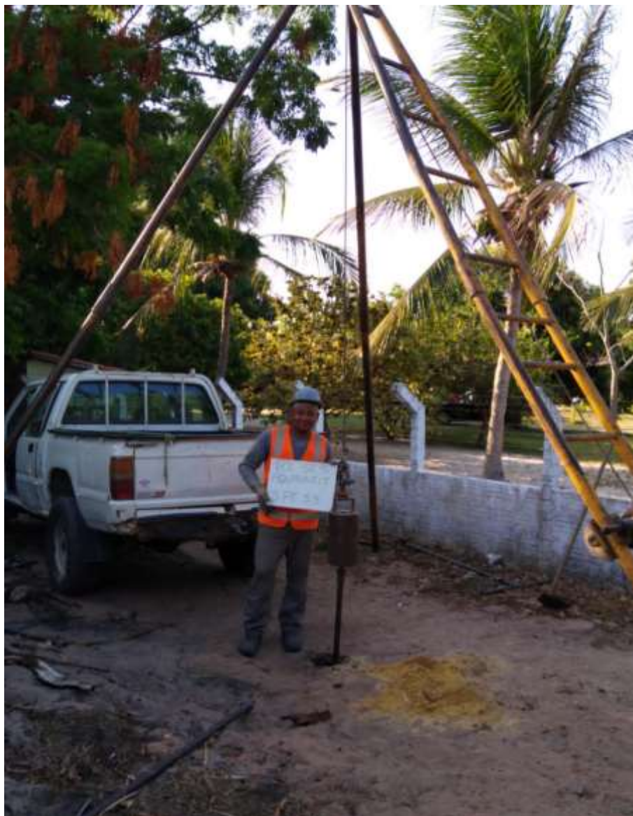
Instalação do furo SPT-35
