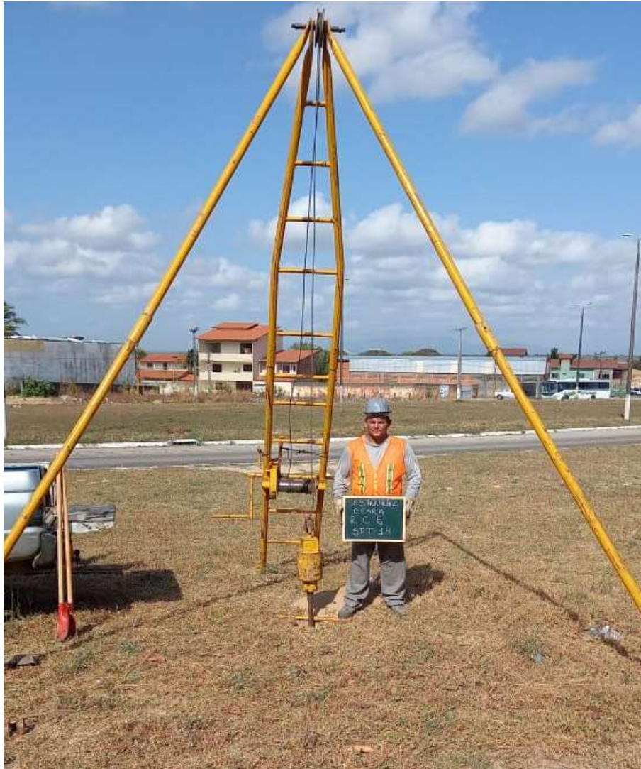
Instalação do furo SPT-14
