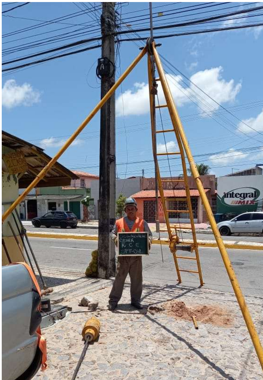
Instalação do furo SPT-04
