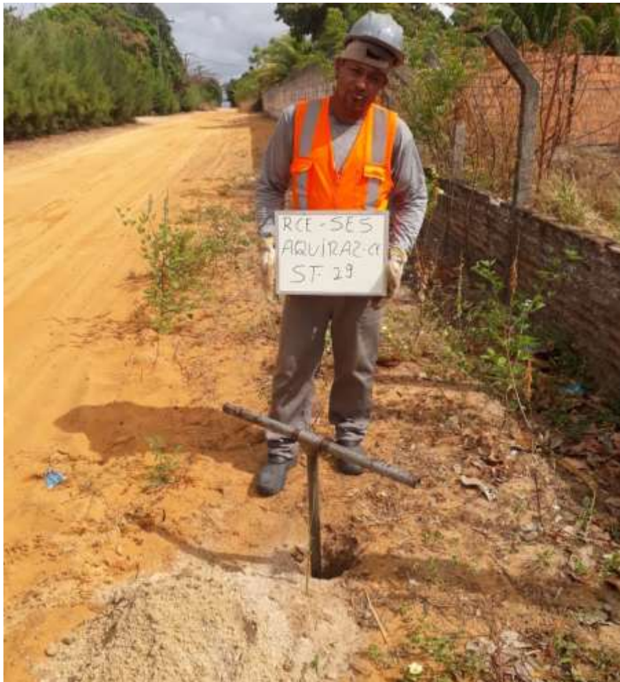
Instalação do furo ST-29
