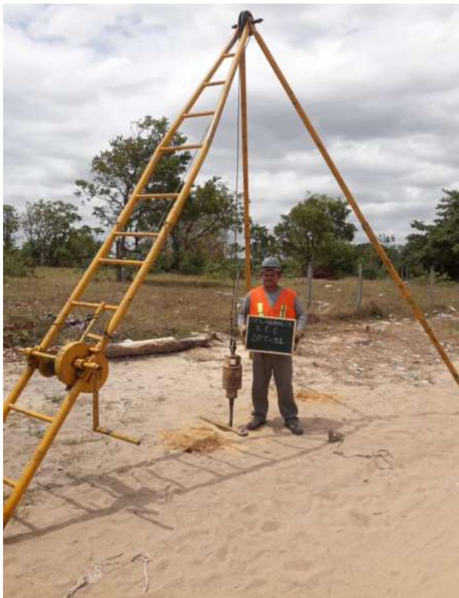
Instalação do furo SPT-51
