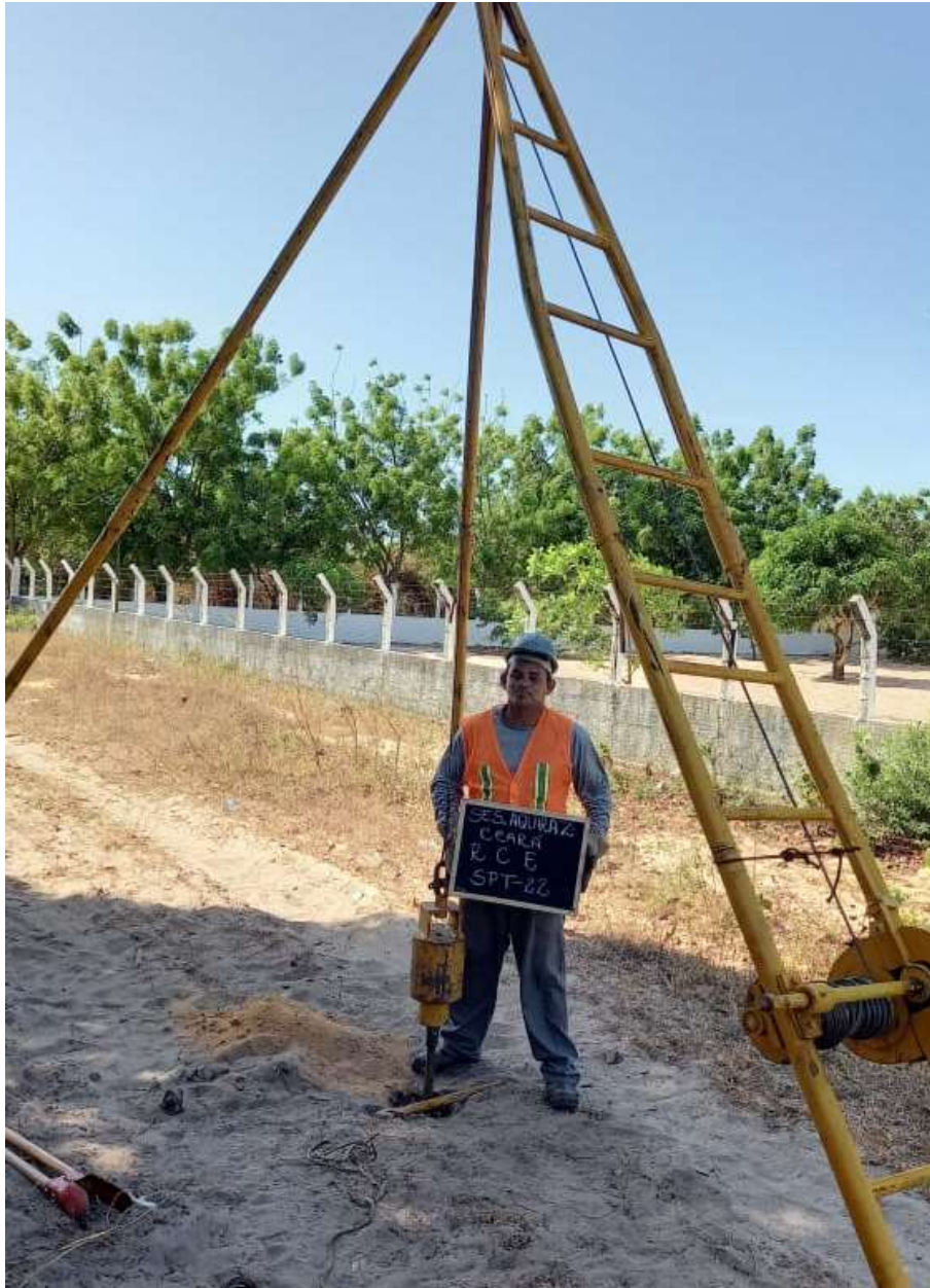
Instalação do furo SPT-22
