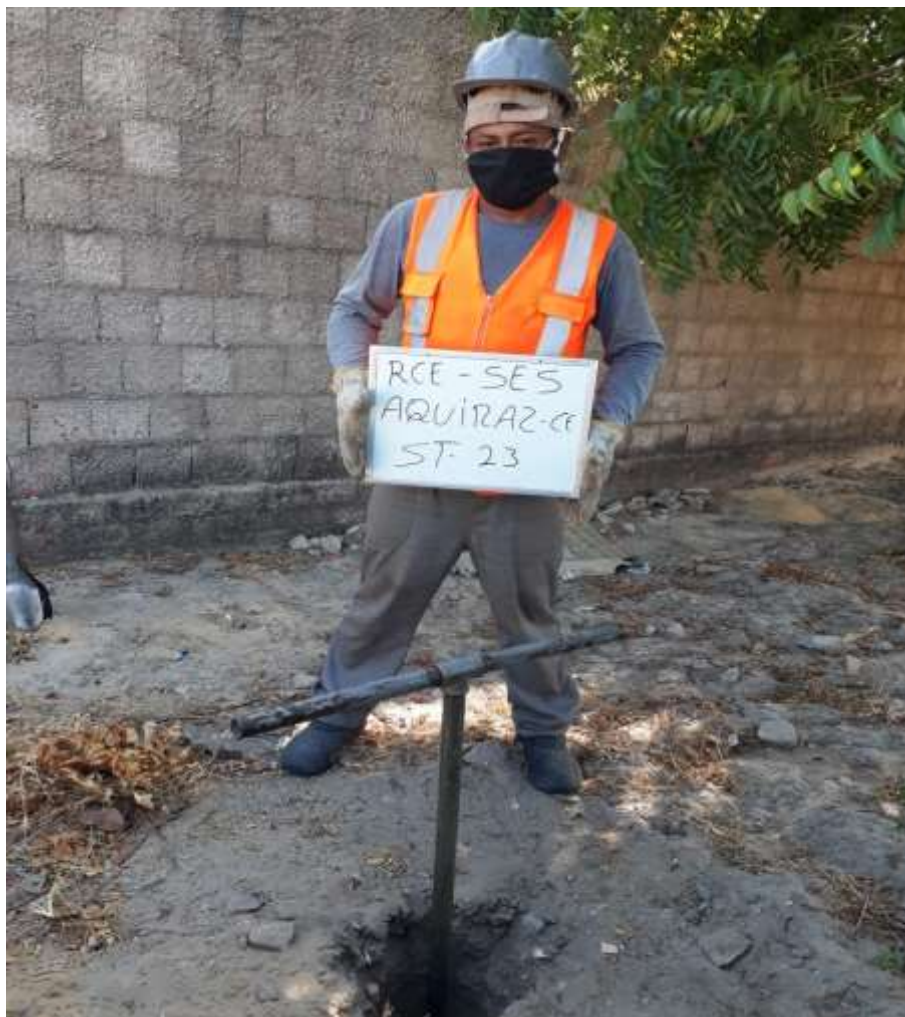
Instalação do furo ST-23
