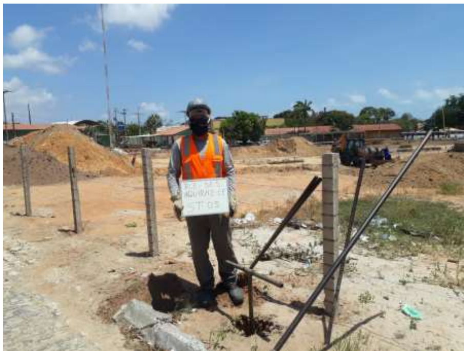
Instalação do furo ST-05
