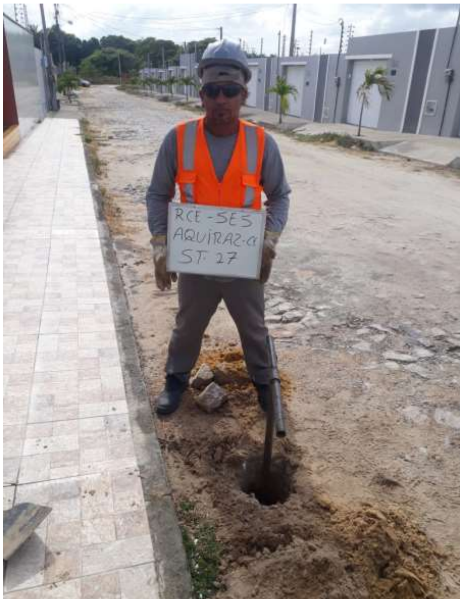
Instalação do furo ST-27
