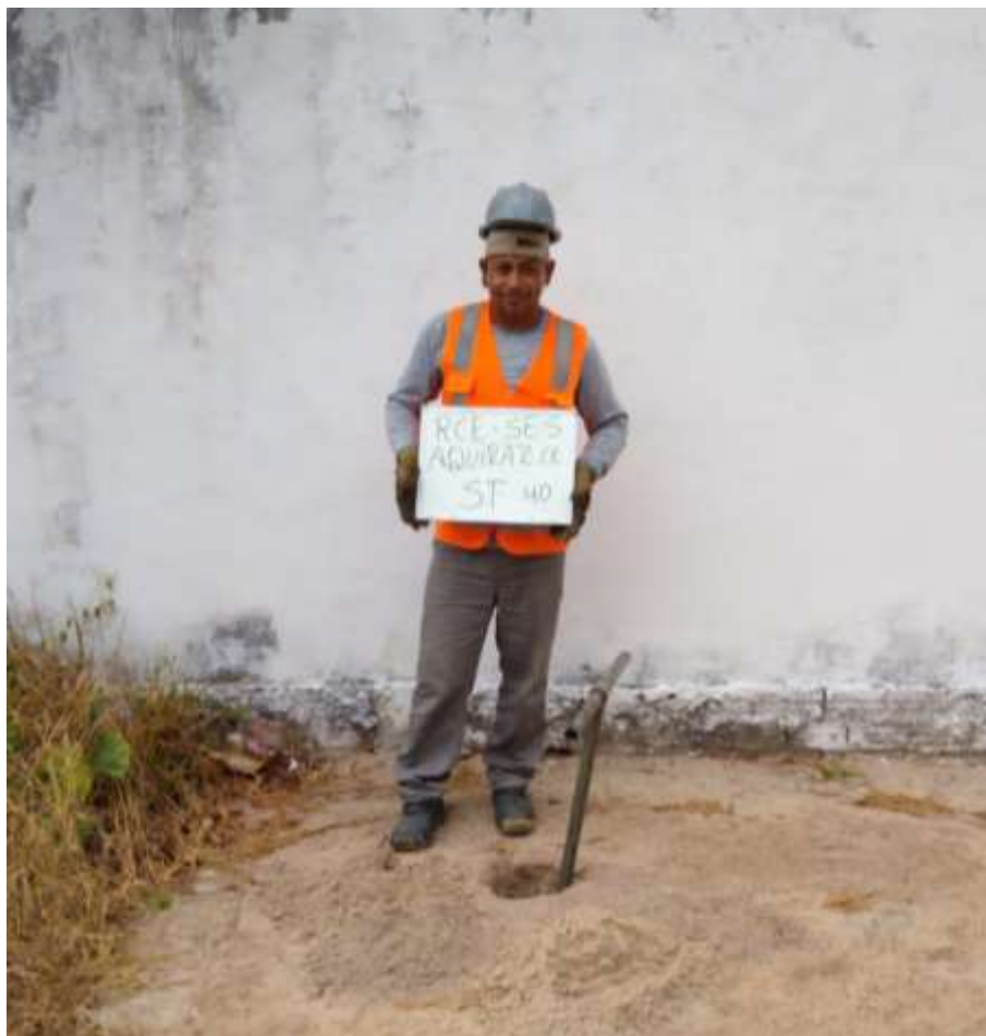
Instalação do furo ST-40
