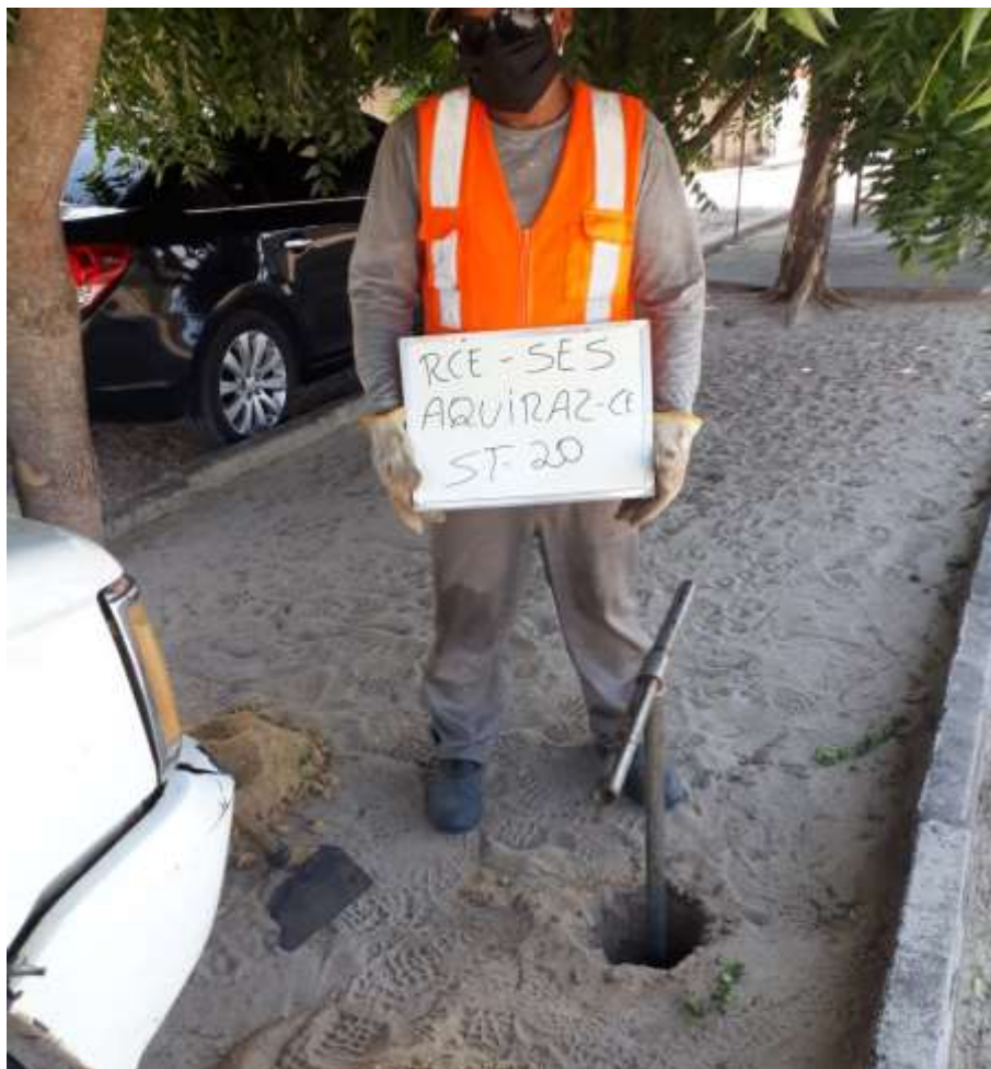
Instalação do furo ST-20
