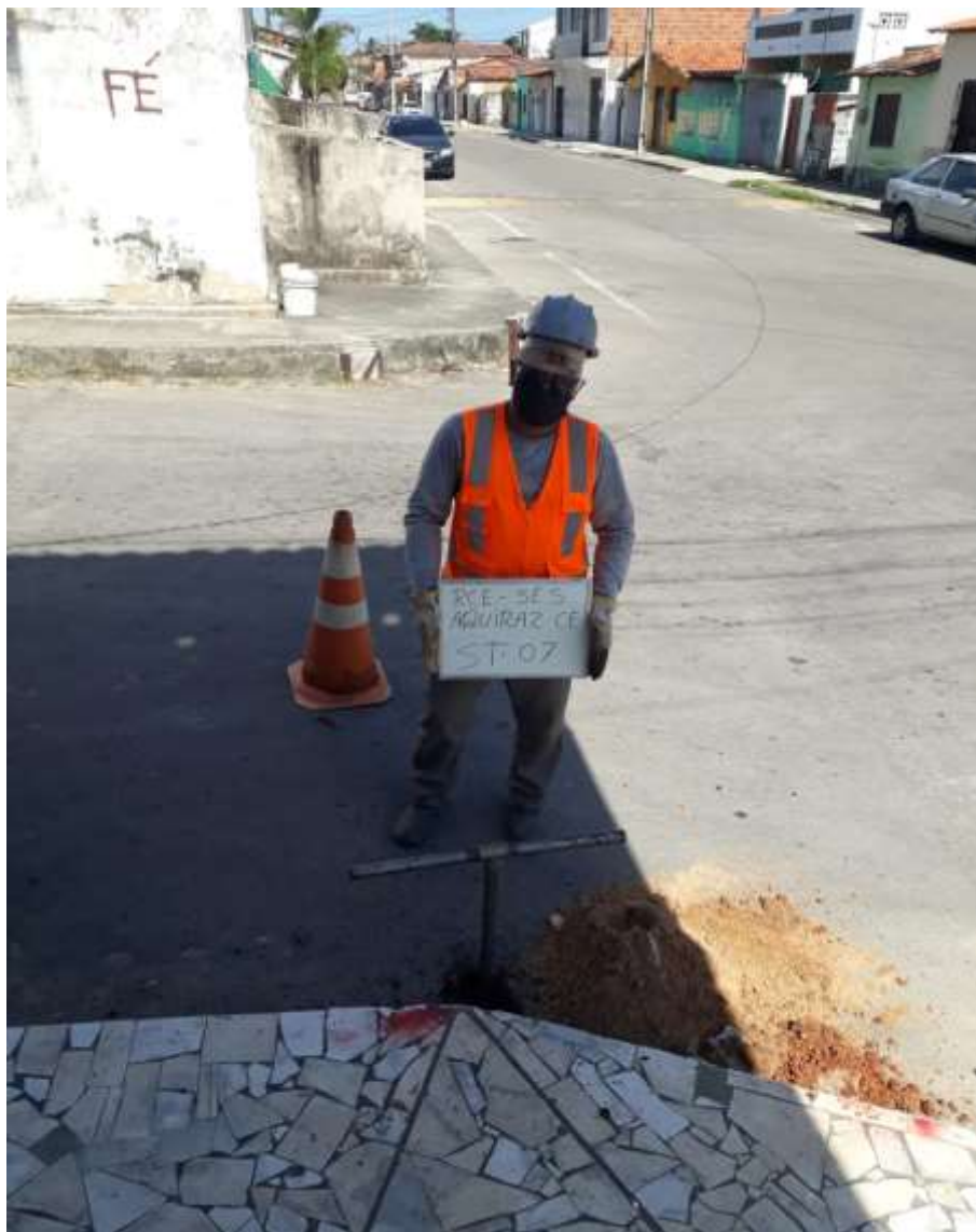
Instalação do furo ST-07
