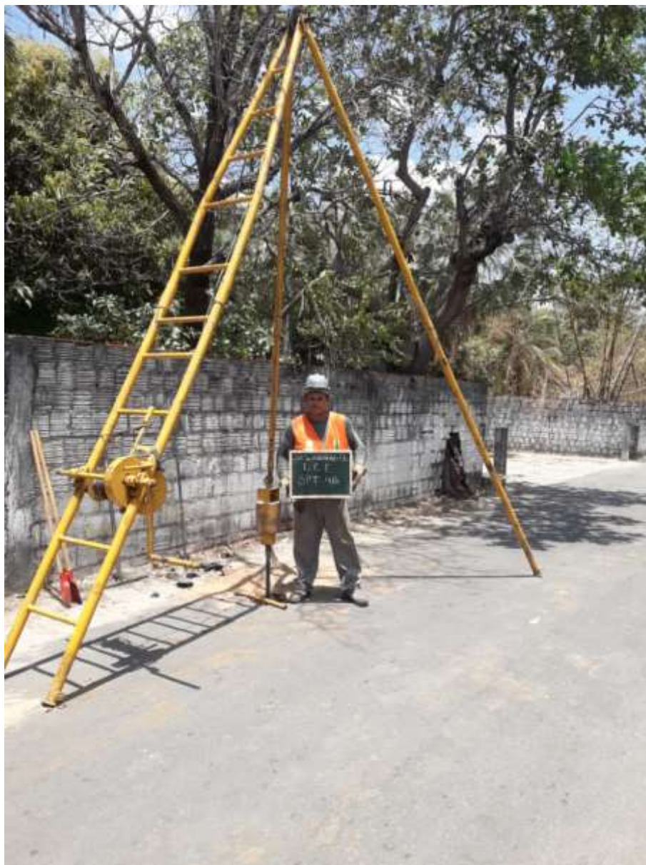
Instalação do furo SPT-46
