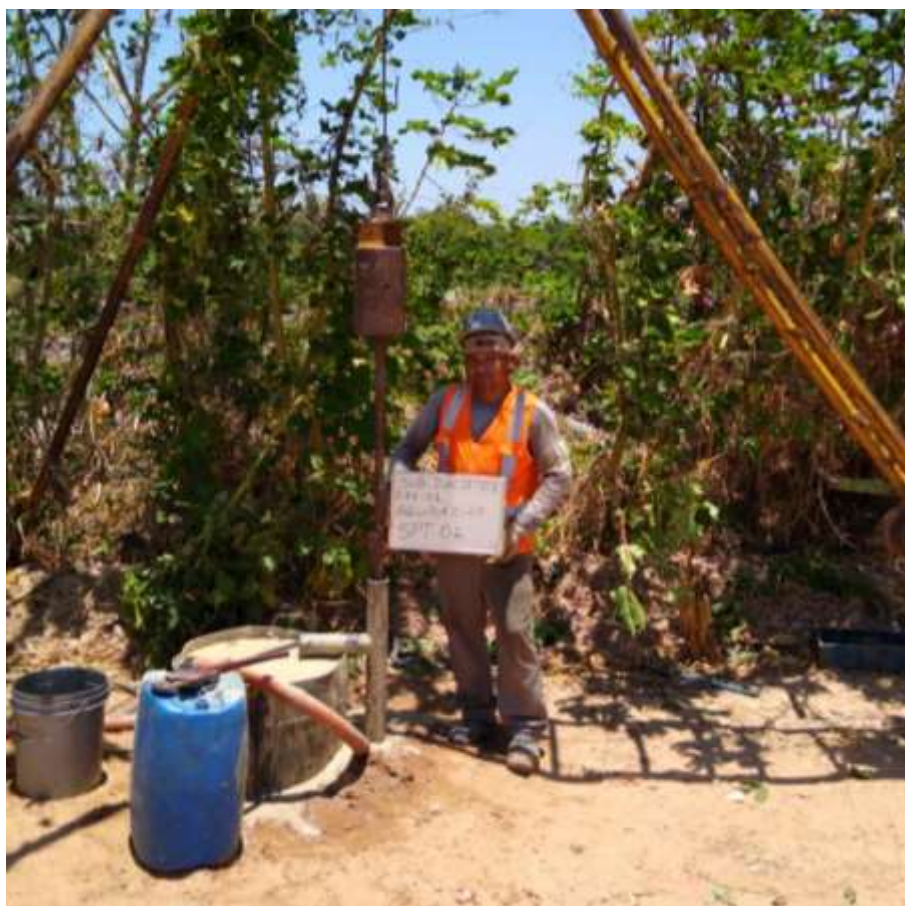
Instalação do furo SPT-EEE01
