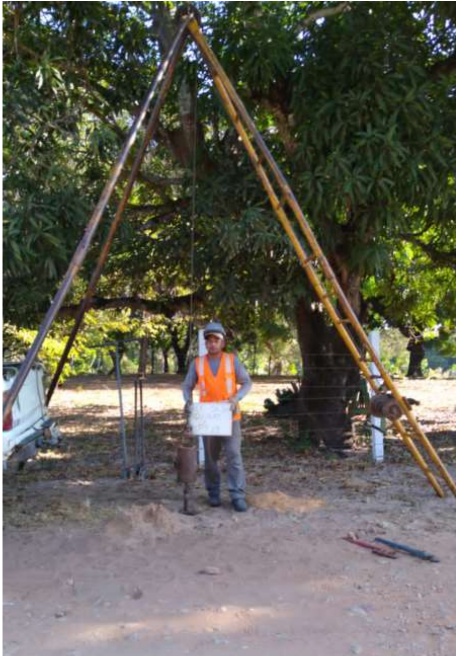
Instalação do furo SPT-19
