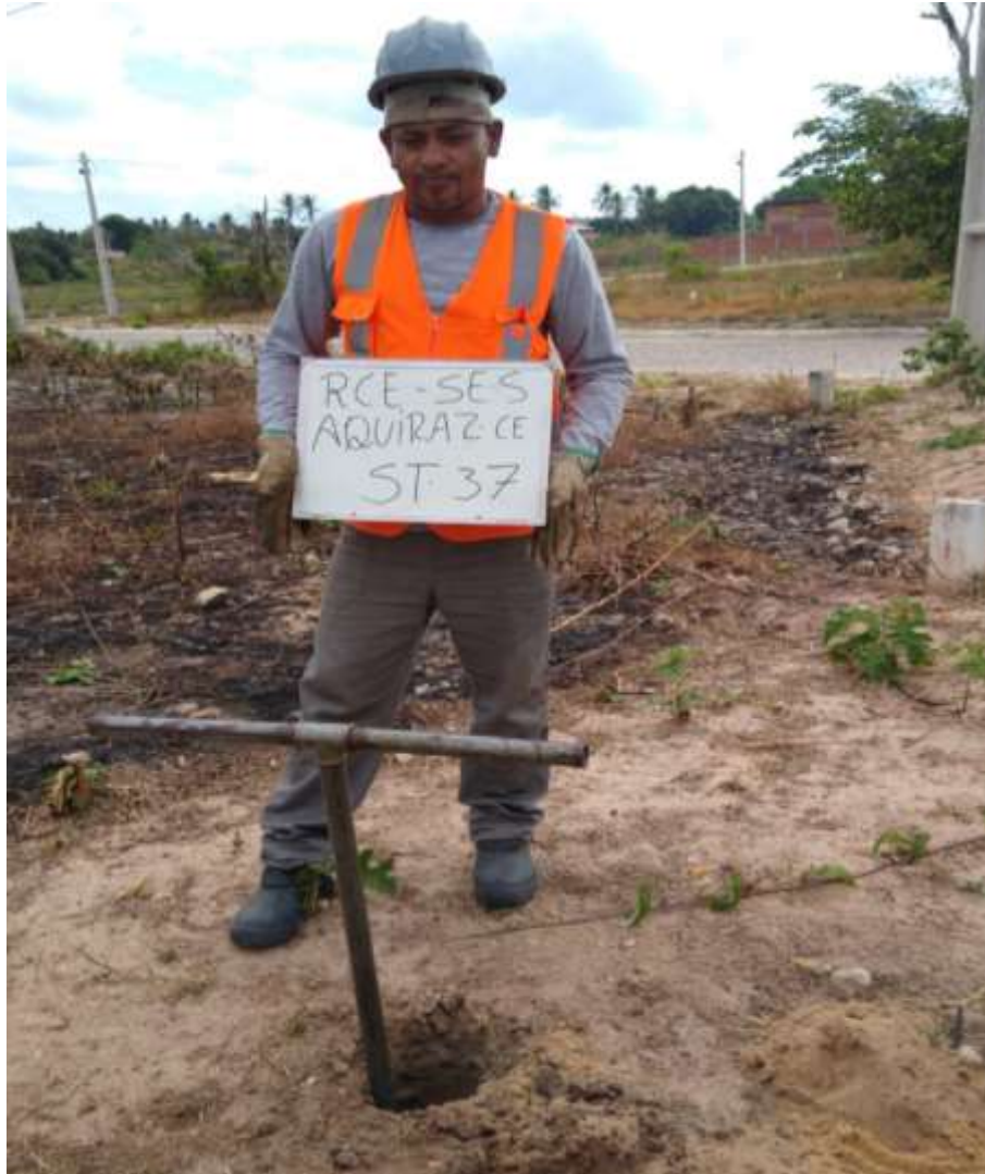
Instalação do furo ST-37
