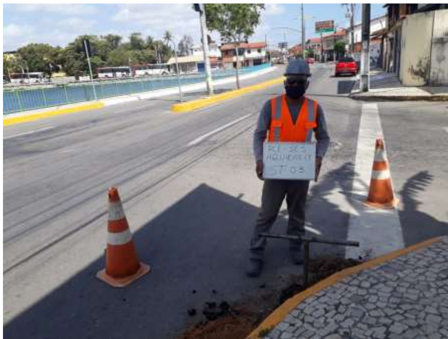
Instalação do furo ST-03
