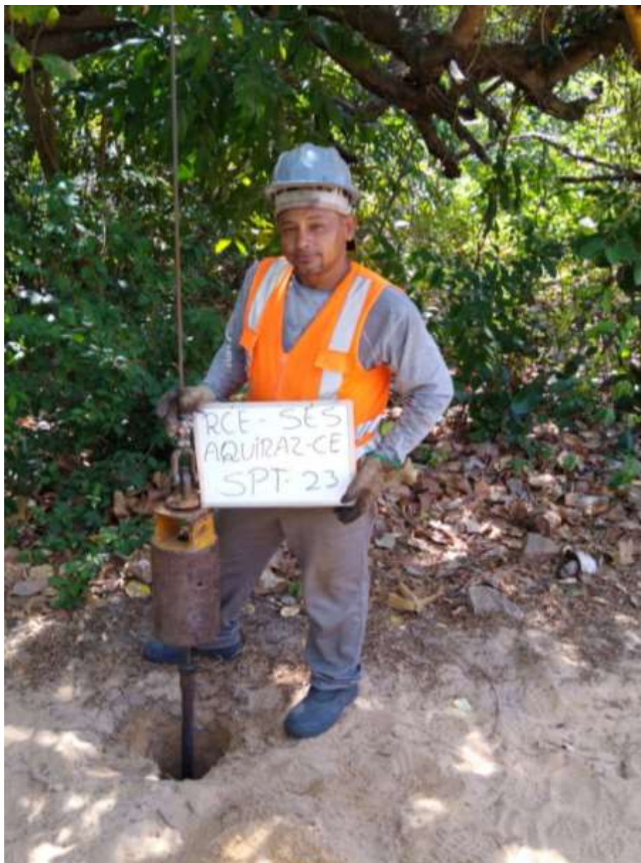
Instalação do furo SPT-23
