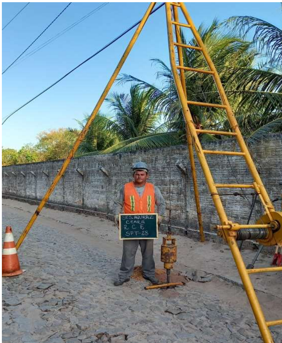
Instalação do furo SPT-28
