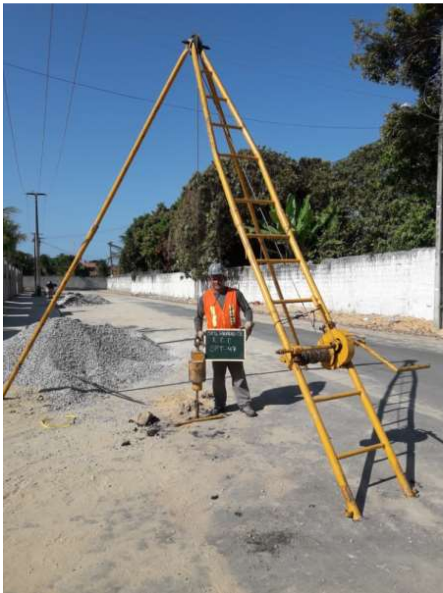
Instalação do furo SPT-47
