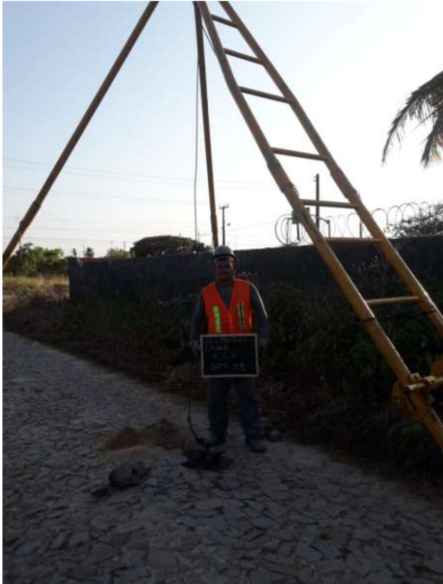
Instalação do furo SPT-38
