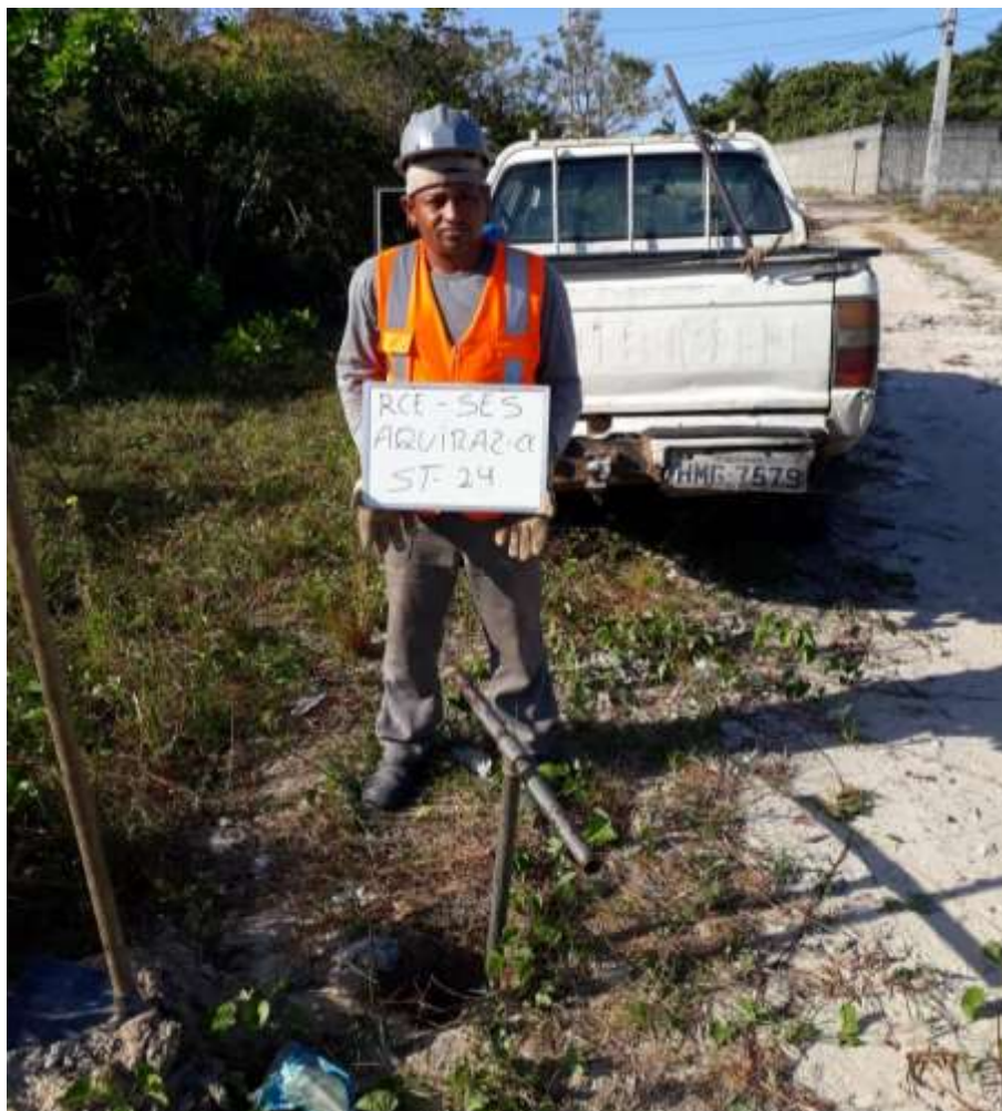
Instalação do furo ST-24
