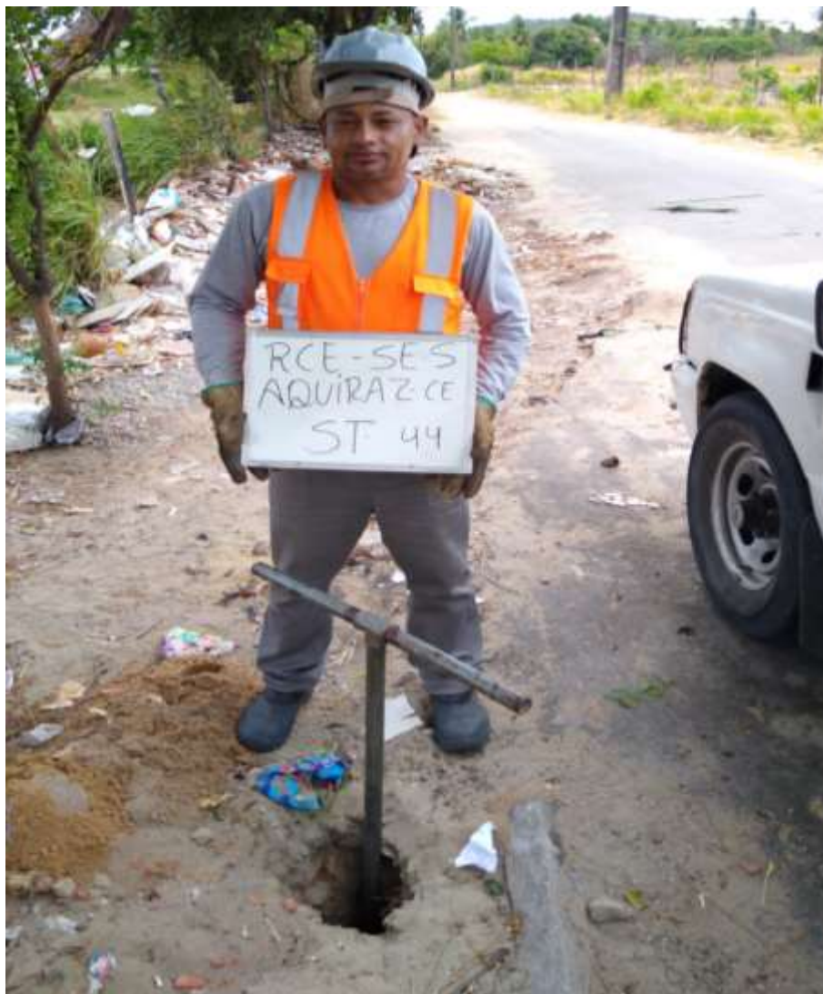
Instalação do furo ST-44
