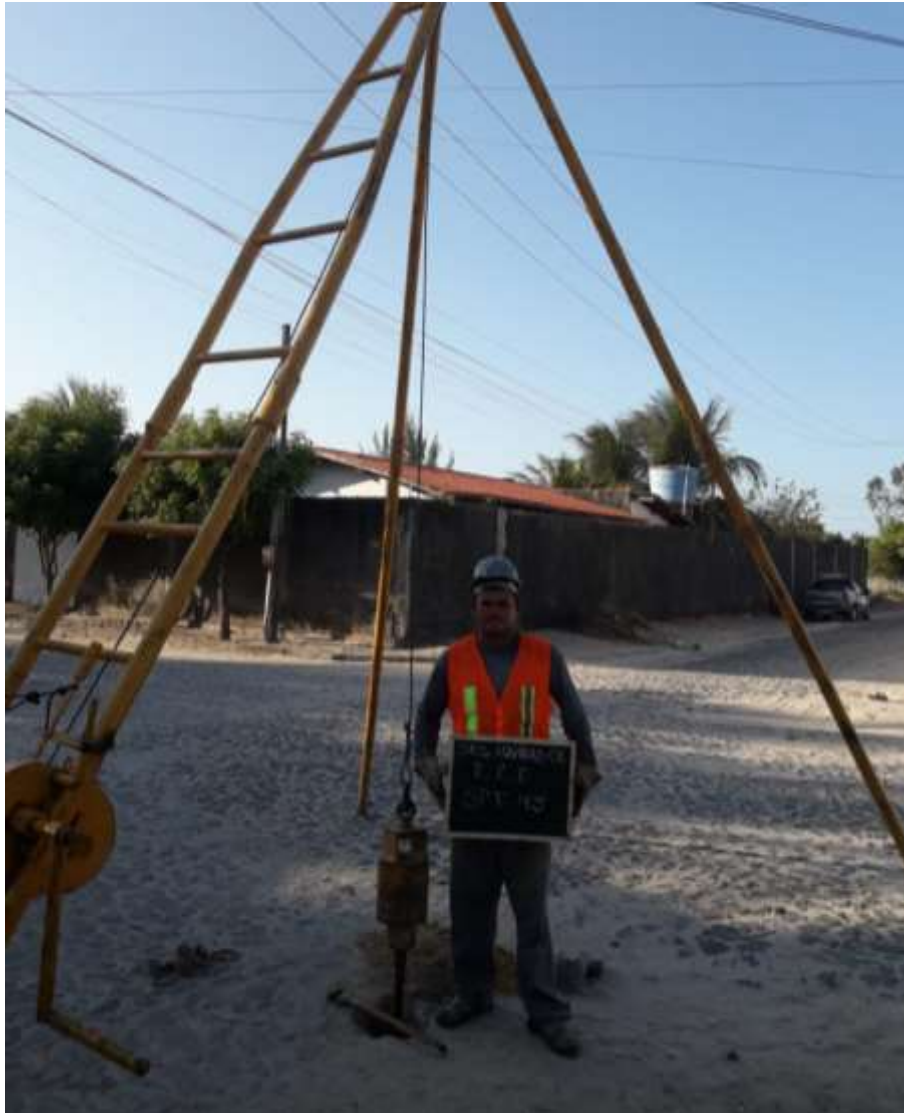
Instalação do furo SPT-43
