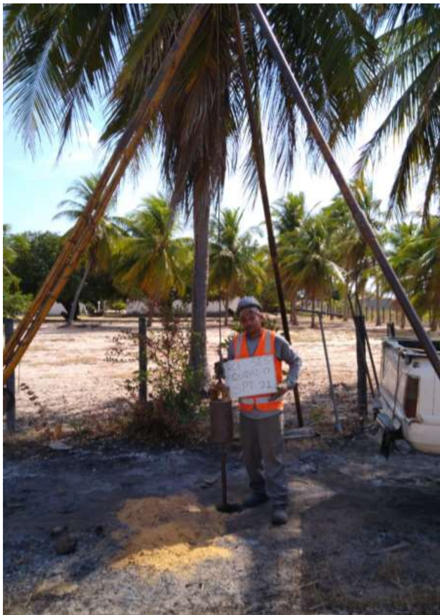
Instalação do furo SPT-21
