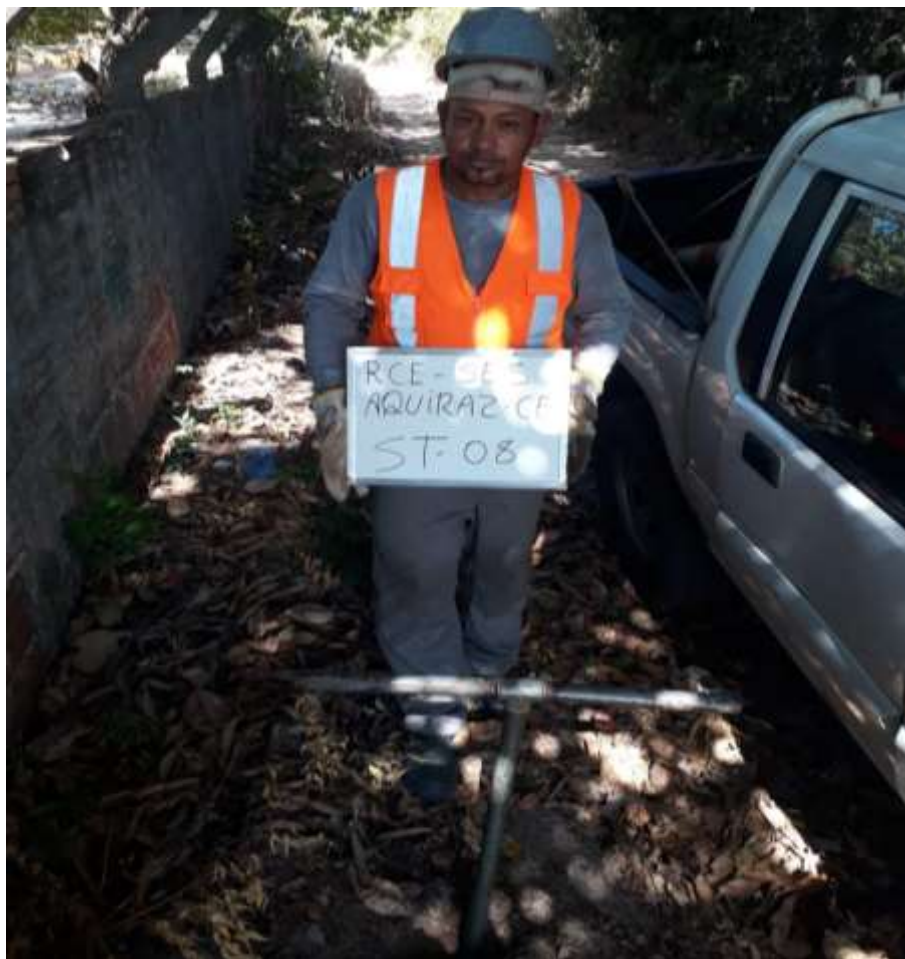
Instalação do furo ST-08
