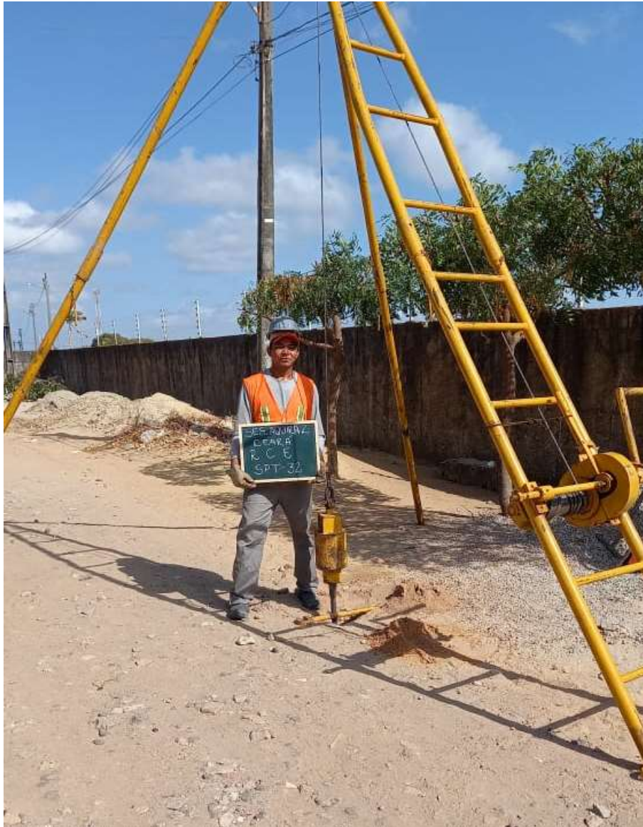
Instalação do furo SPT-32
