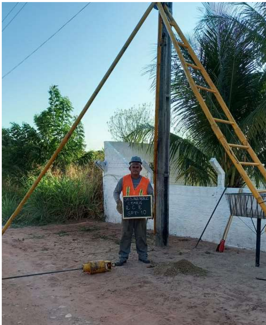
Instalação do furo SPT-10
