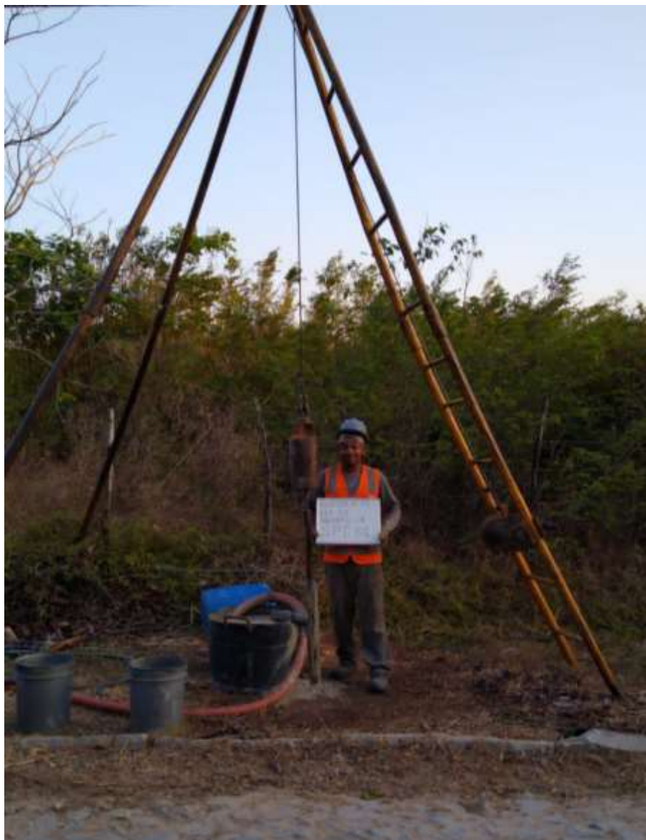
Instalação do furo SPT-EEE03
