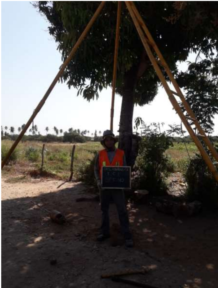
Instalação do furo SPT-40
