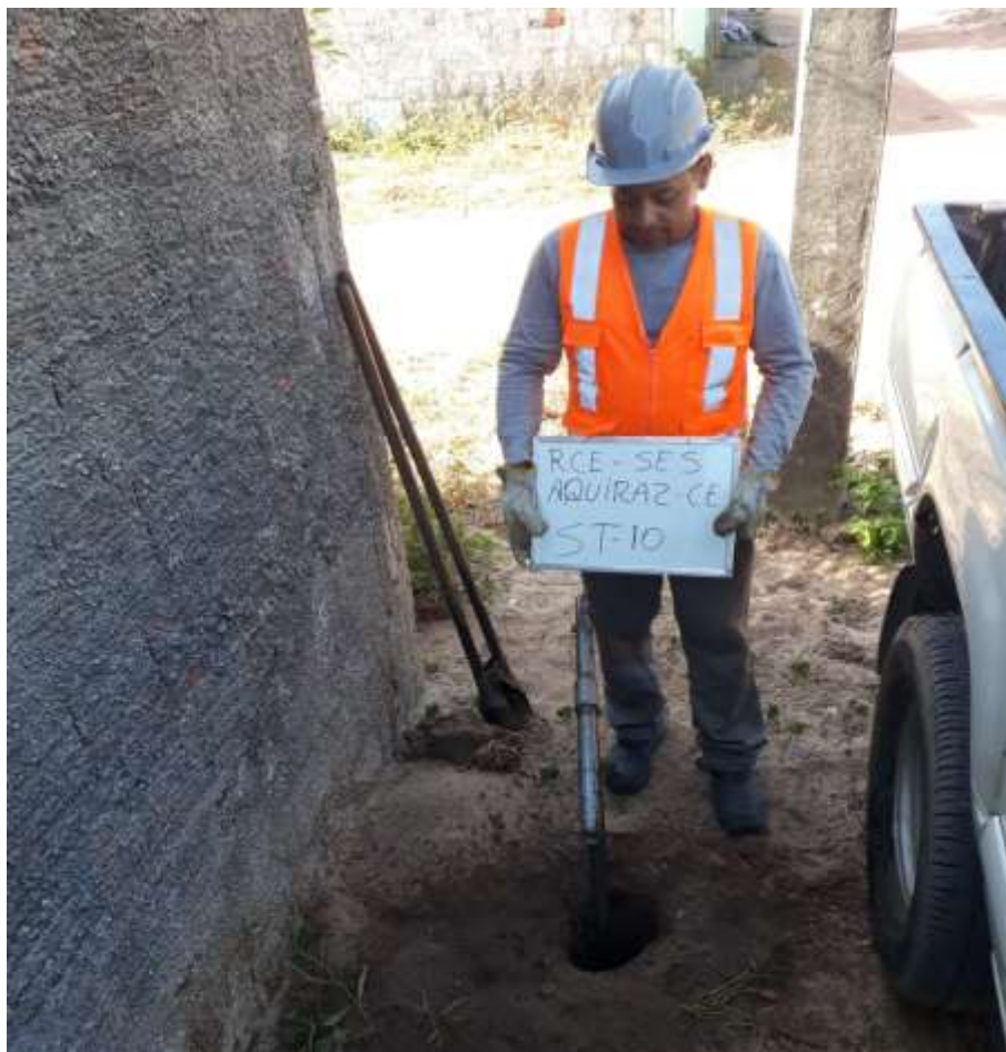
Instalação do furo ST-10
