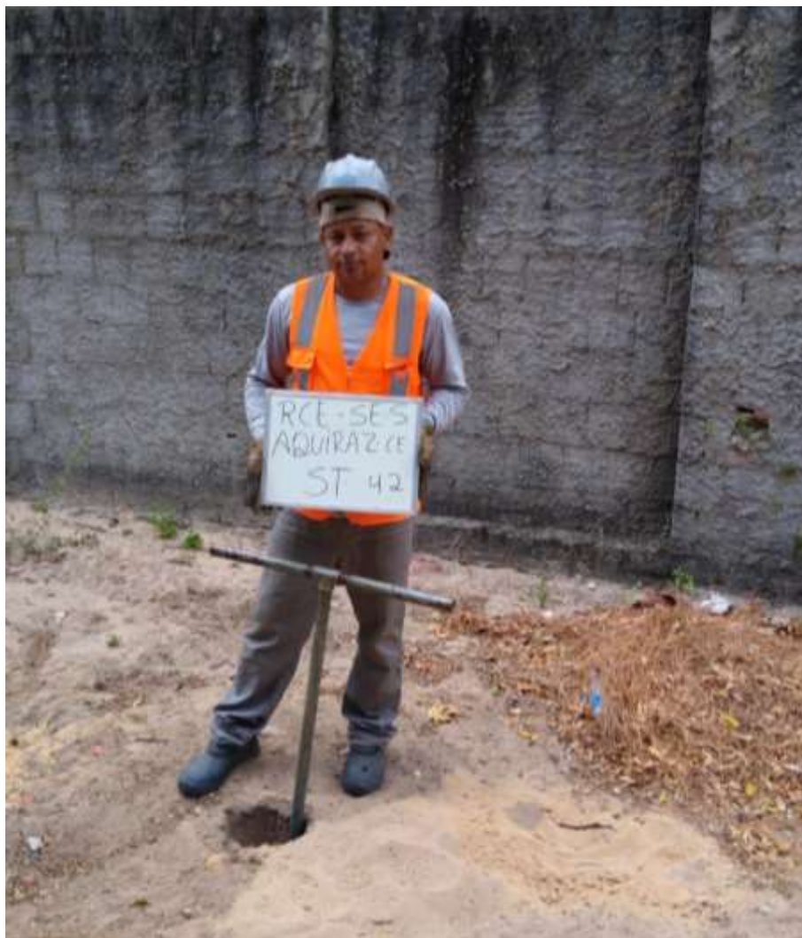
Instalação do furo ST-42
