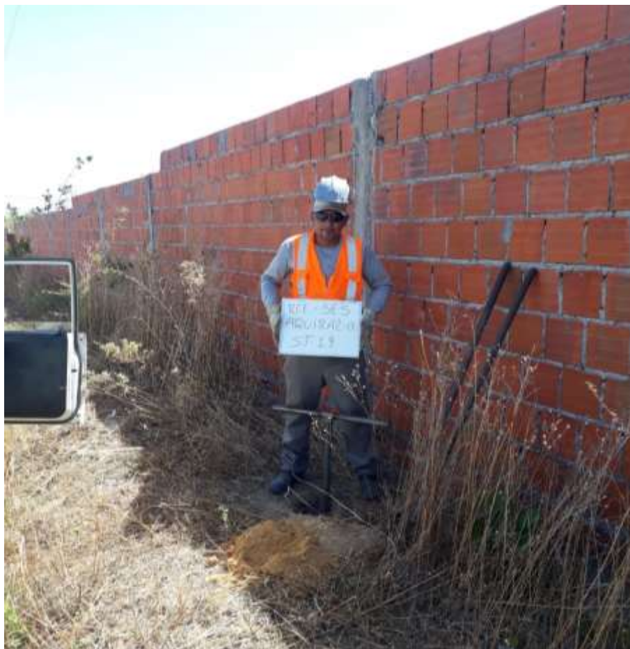
Instalação do furo ST-19
