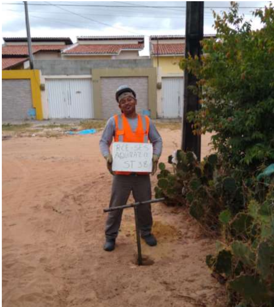
Instalação do furo ST-38
