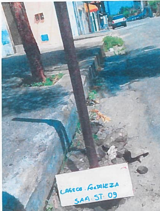
FOTO 09: Detalhe do local onde foi realizado o ST-09.
