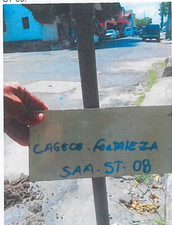
FOTO 08: Detalhe do local onde foi realizado o ST-08.
