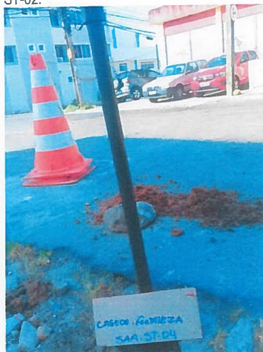
FOTO 04: Detalhe do local onde foi realizado o ST-04.
