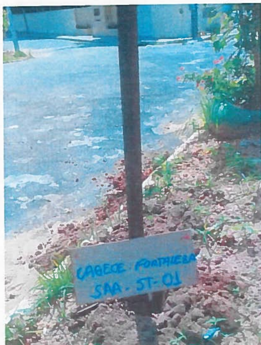
FOTO 01: Detalhe do local onde foi realizado o ST-01.
