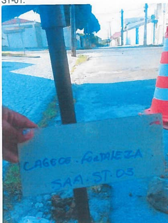
FOTO 03: Detalhe do local onde foi realizado o ST-03.
