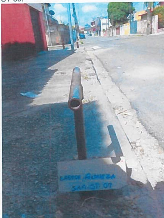
FOTO 07: Detalhe do local onde foi realizado o ST-07.
