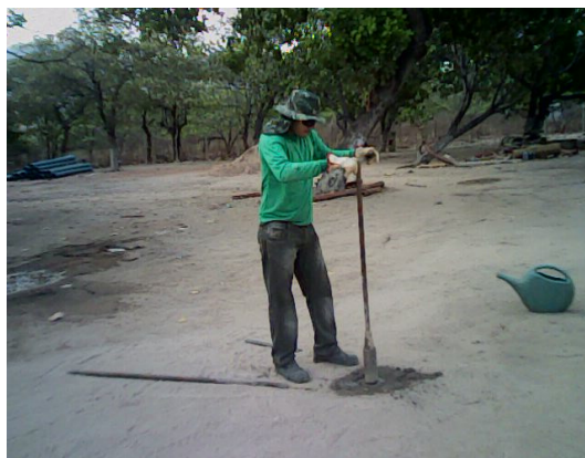
Foto 06- Início da execução da sondagem a trado ST-05.
