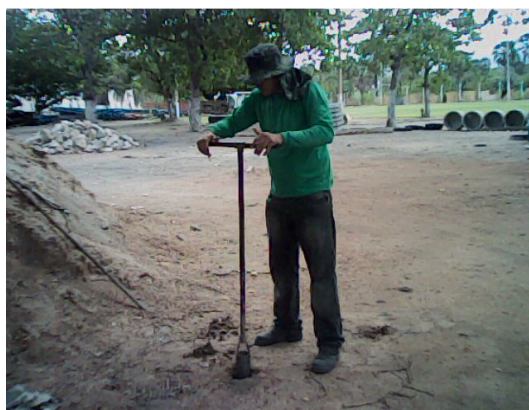
Foto 08- Início da execução do furo de sondagem a trado ST-06.
