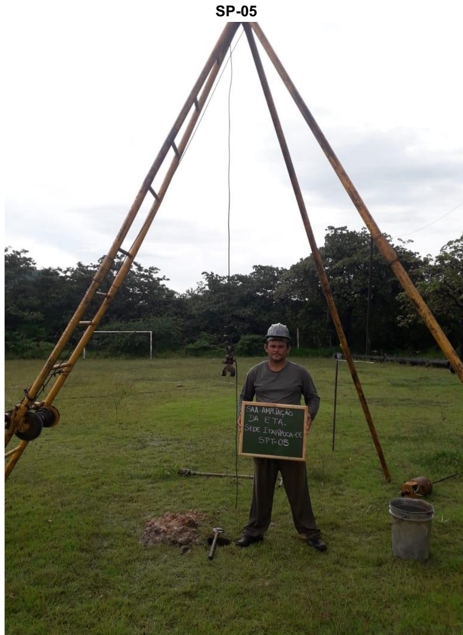
Instalação do furo SP-05
