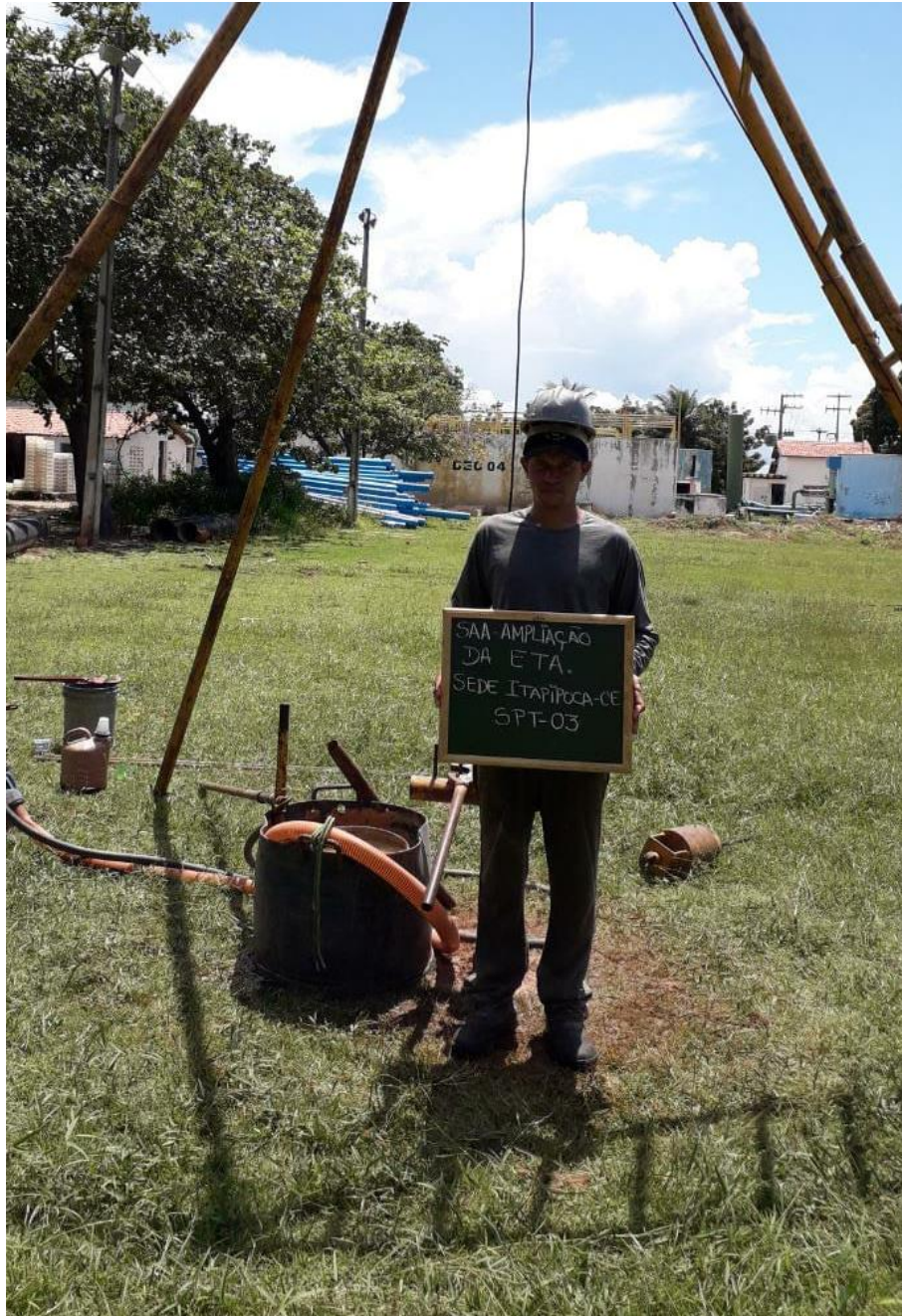
Instalação do furo SP-03
