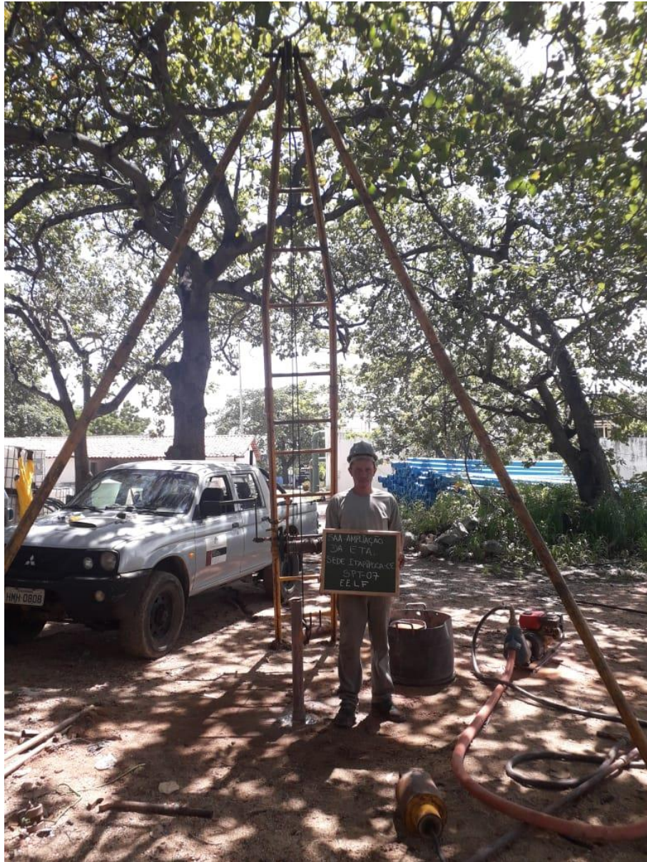
Instalação do furo SP-07
