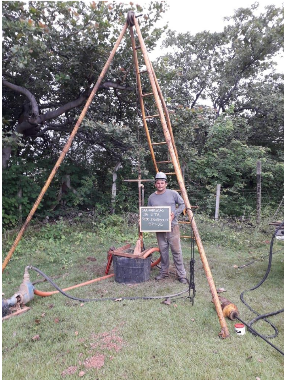
Instalação do furo SP-02
