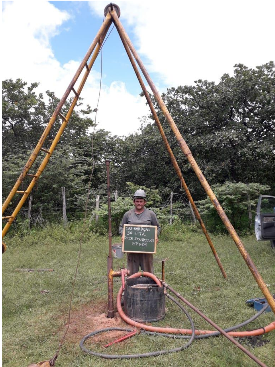
Instalação do furo SP-04
