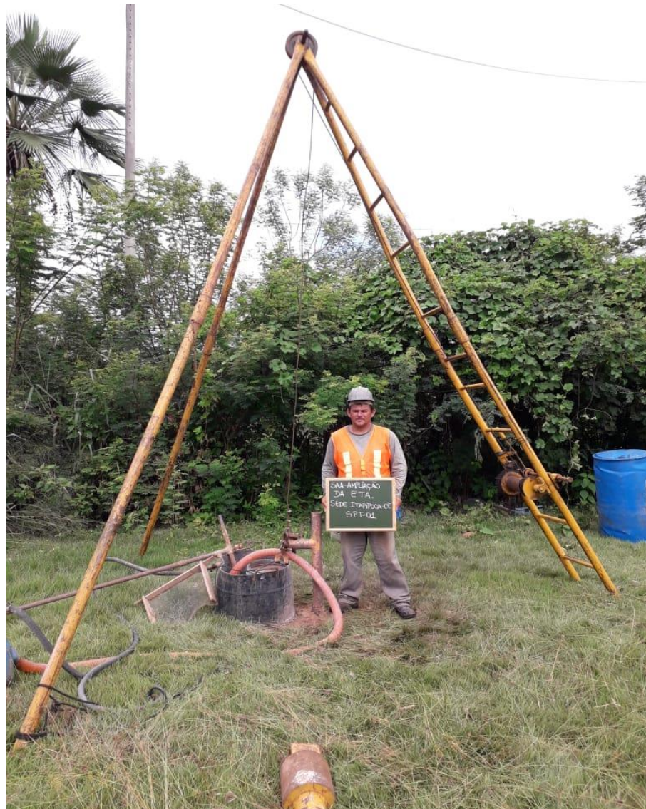
Instalação do furo SP-01
