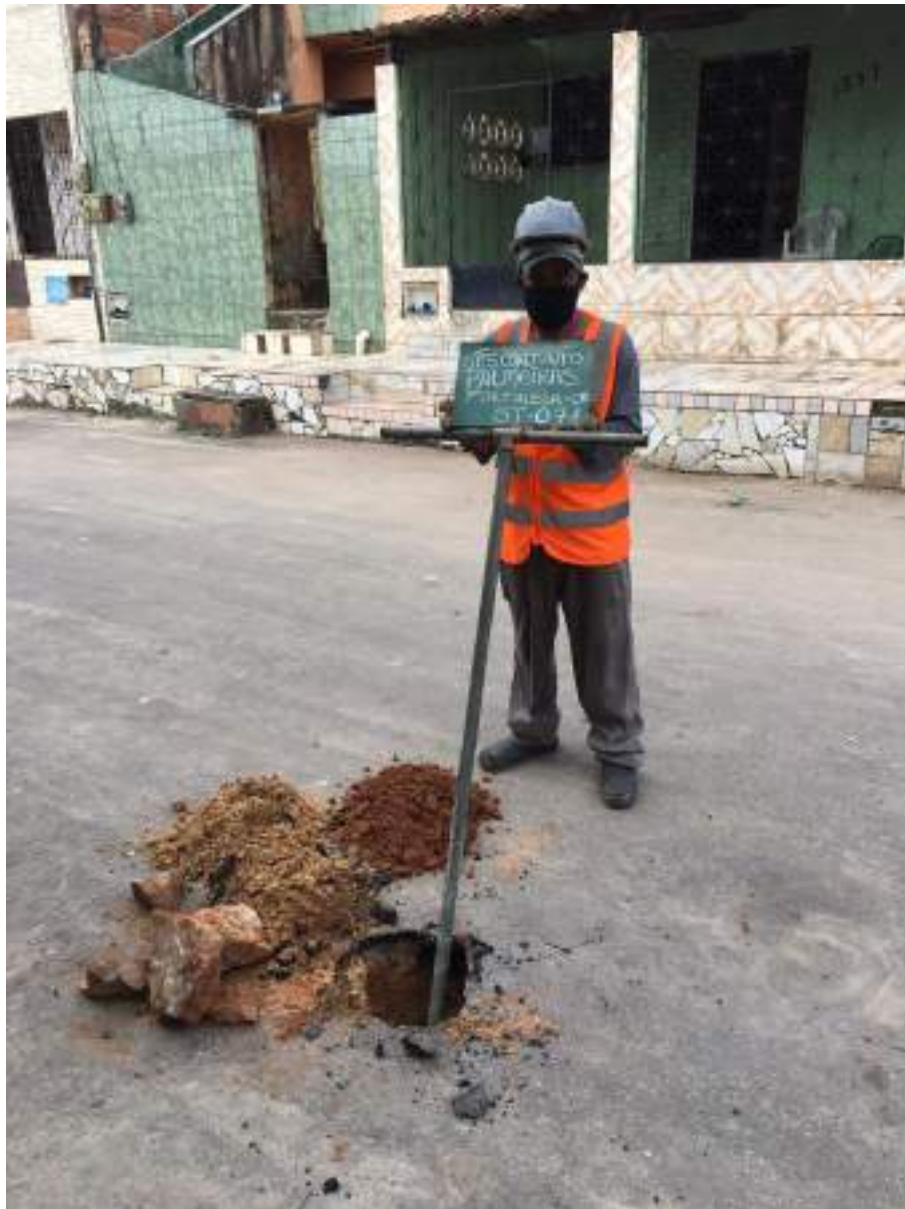
Instalação do furo ST-07 A
