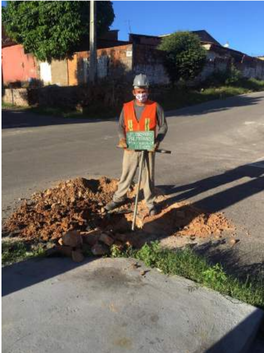
Instalação do furo ST-05
