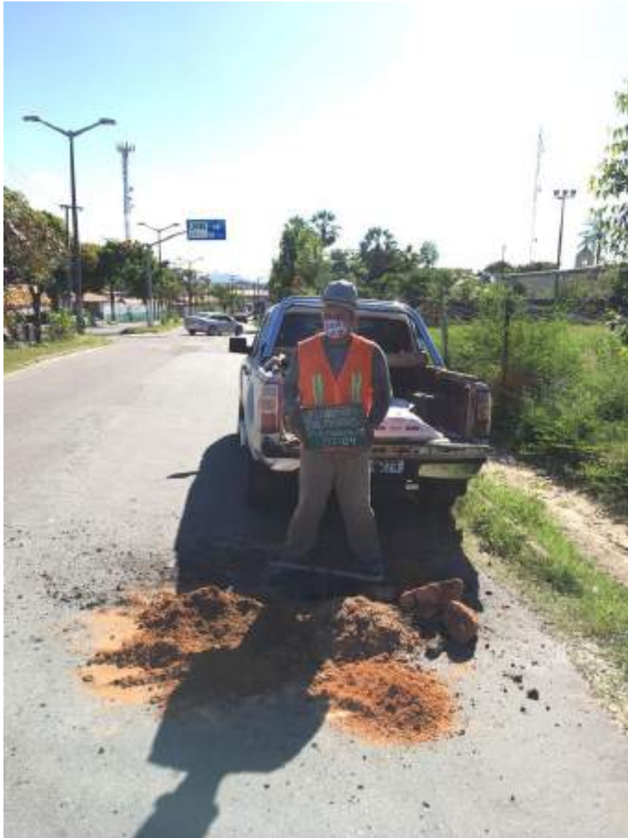
Instalação do furo ST-04
