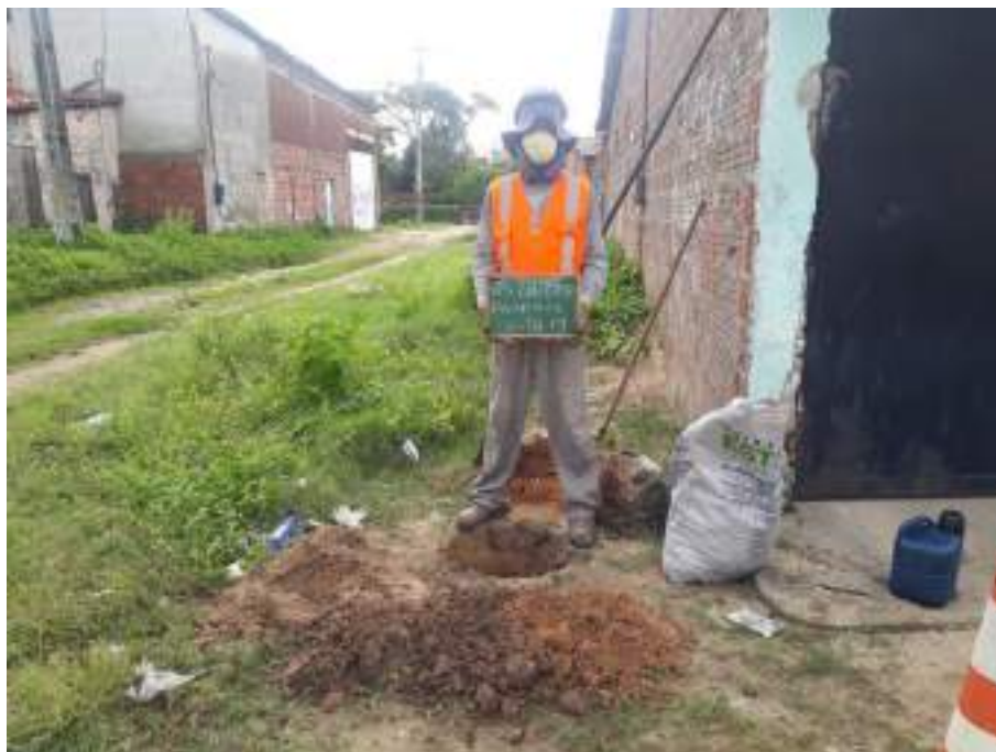
Instalação do furo ST-19
