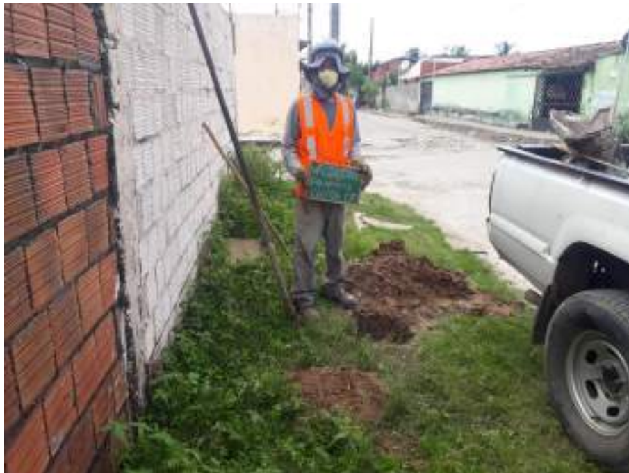
Instalação do furo ST-17
