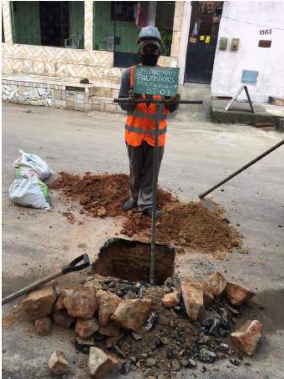
Instalação do furo ST-07
