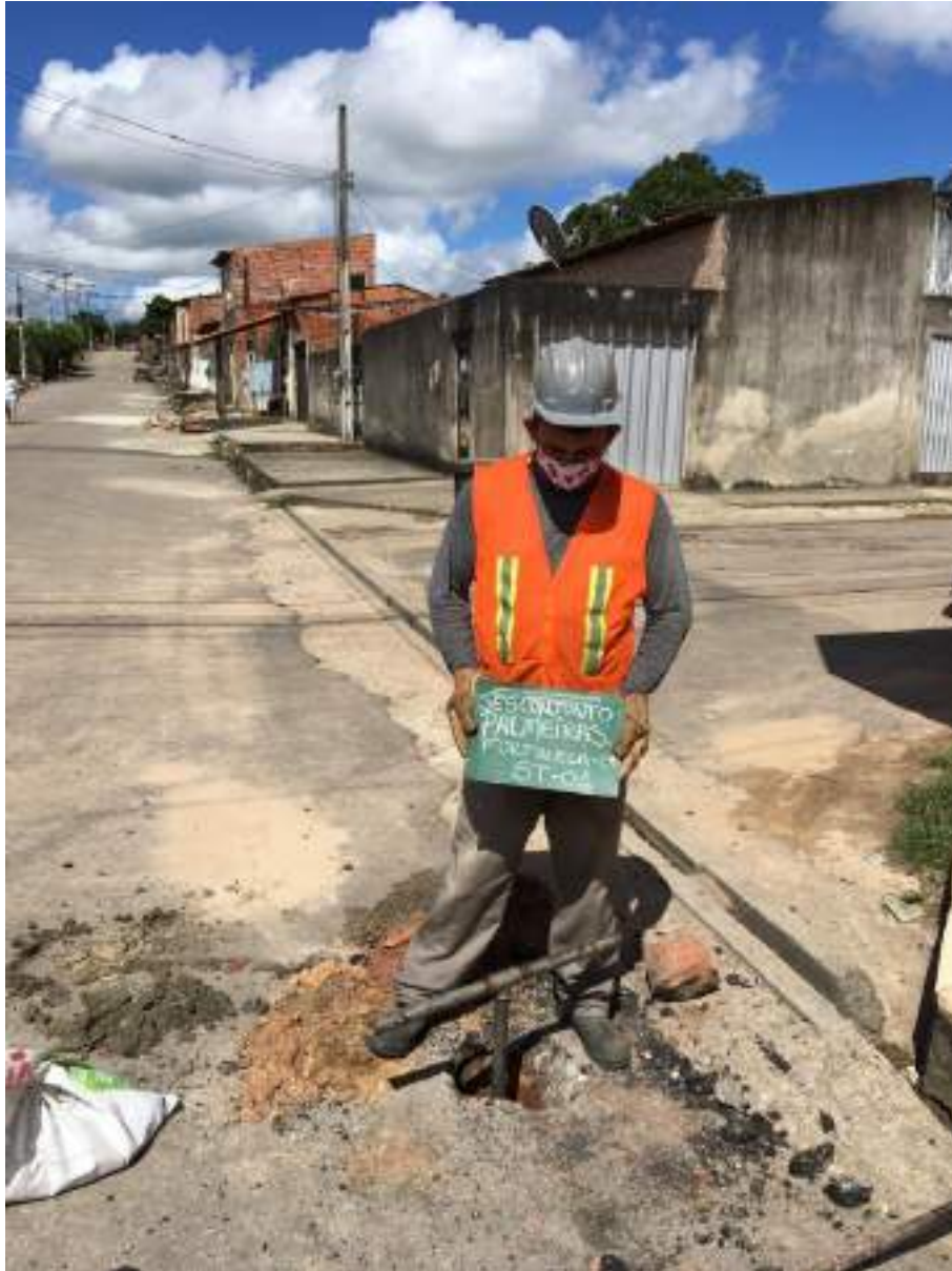
Instalação do furo ST-01
