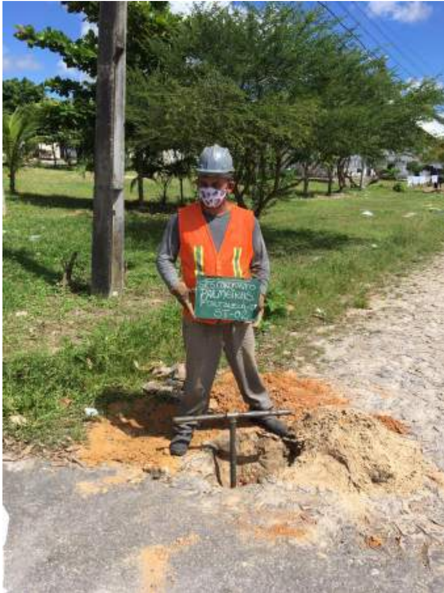
Instalação do furo ST-02
