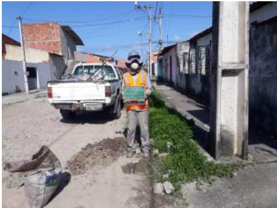
Instalação do furo ST-15
