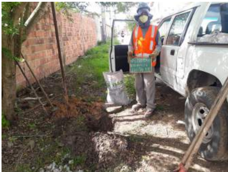
Instalação do furo ST-18
