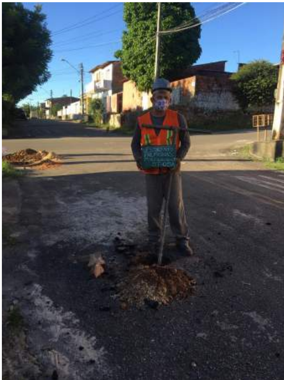
Instalação do furo ST-05 A
