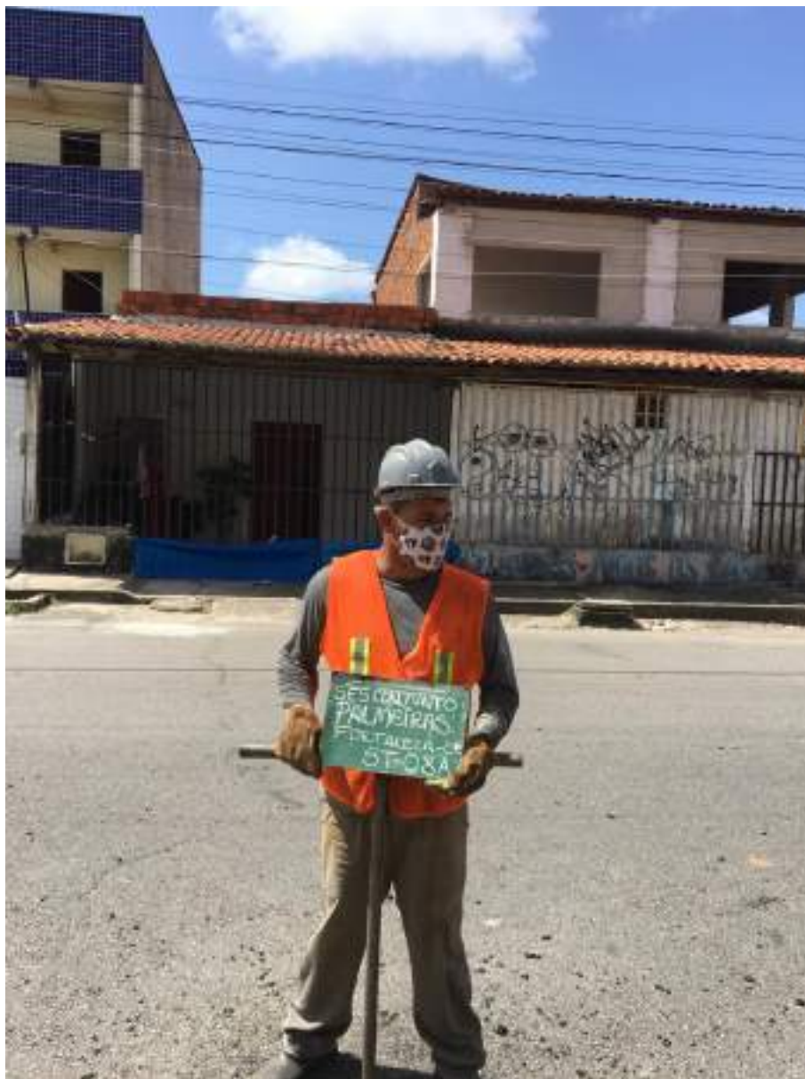
Instalação do furo ST-08 A
