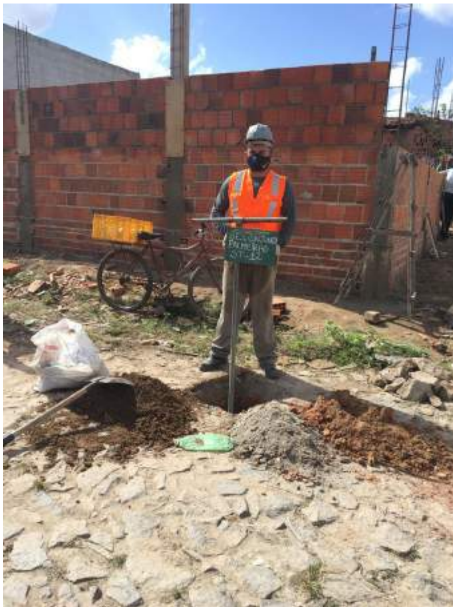
Instalação do furo ST-12
