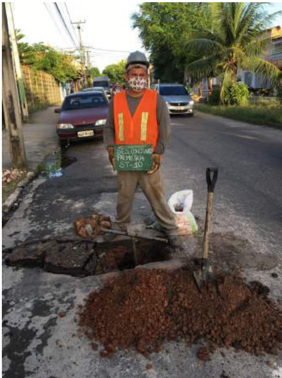
Instalação do furo ST-10
