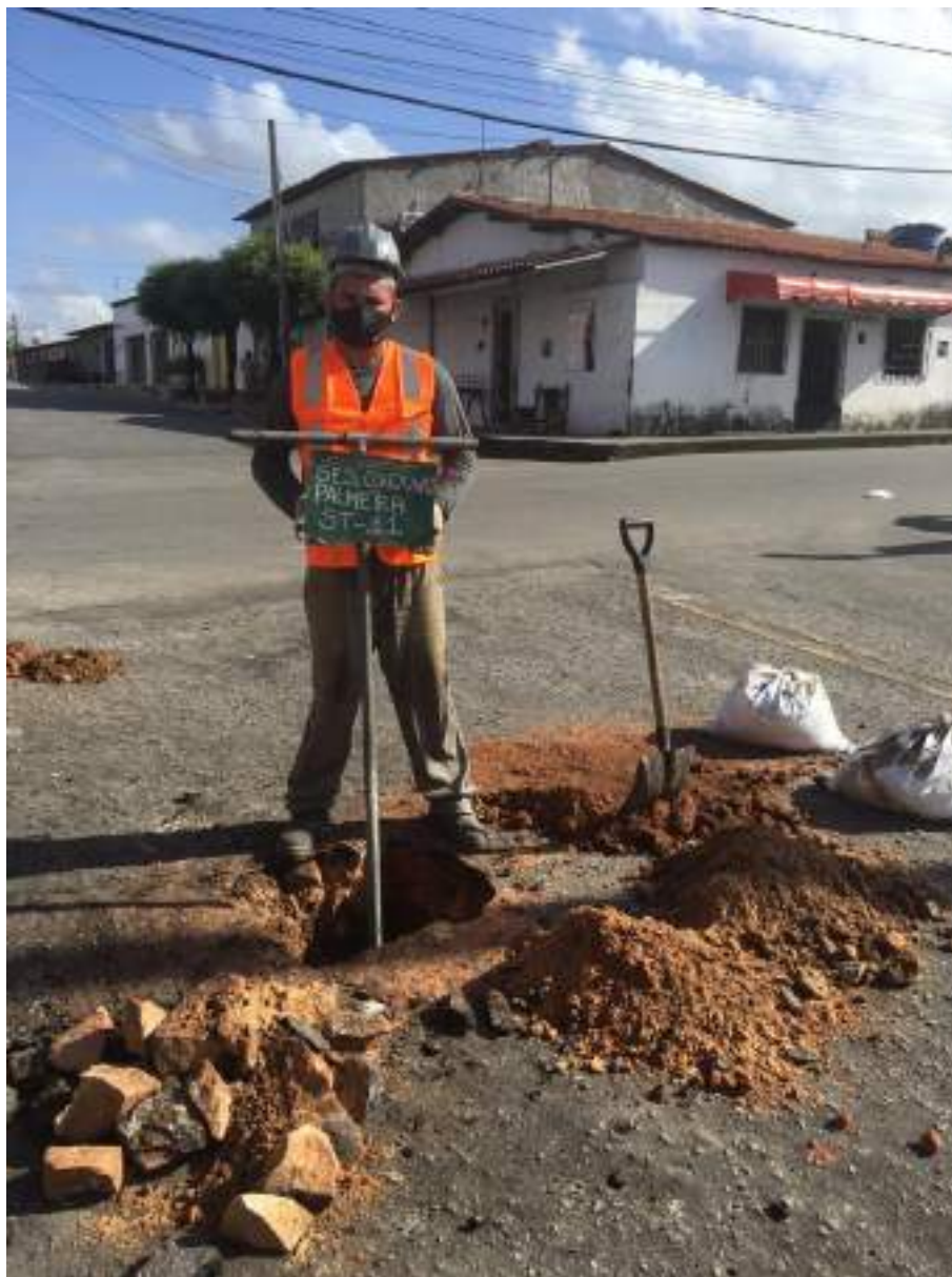
Instalação do furo ST-11
