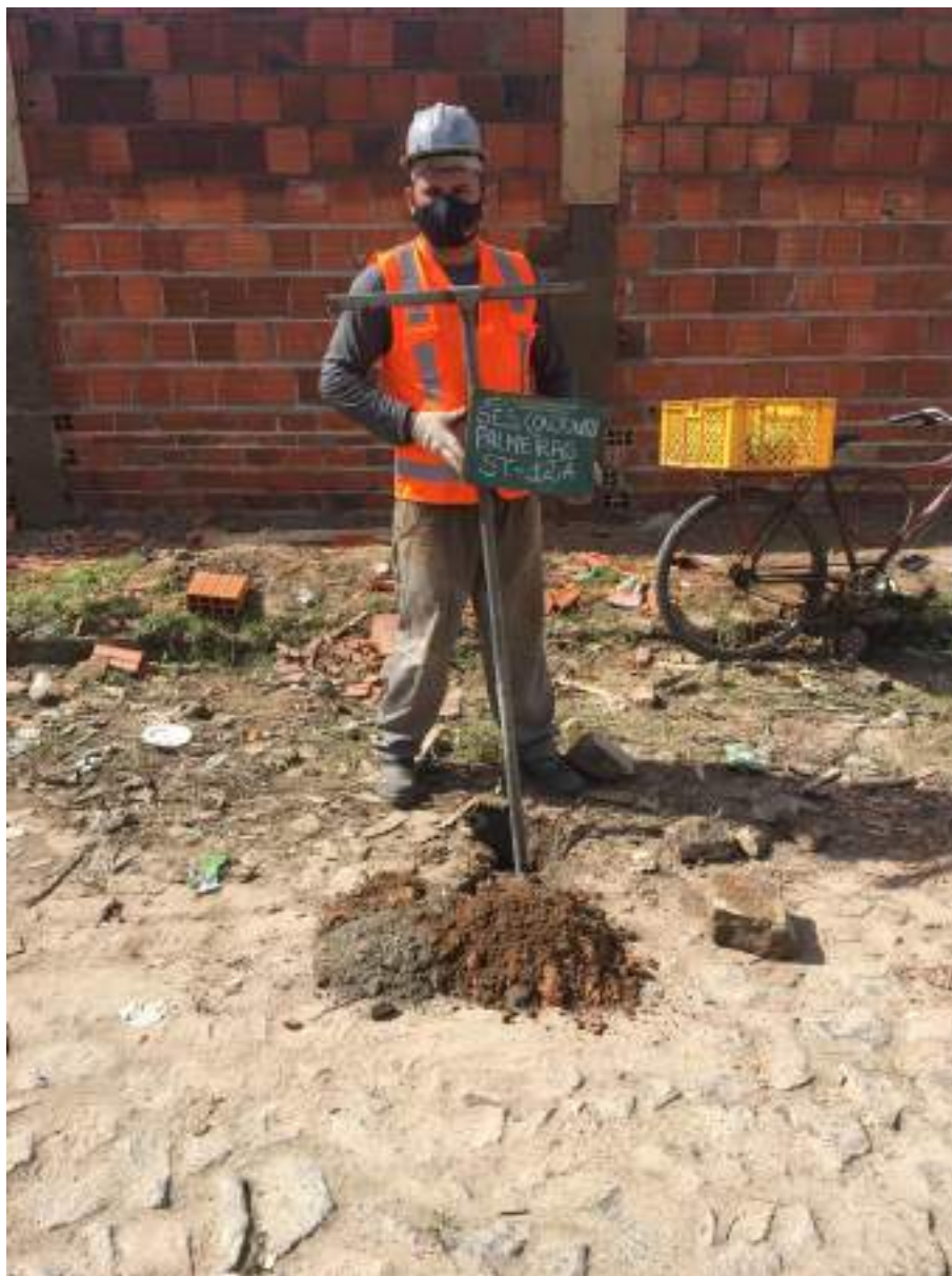
Instalação do furo ST-12 A
