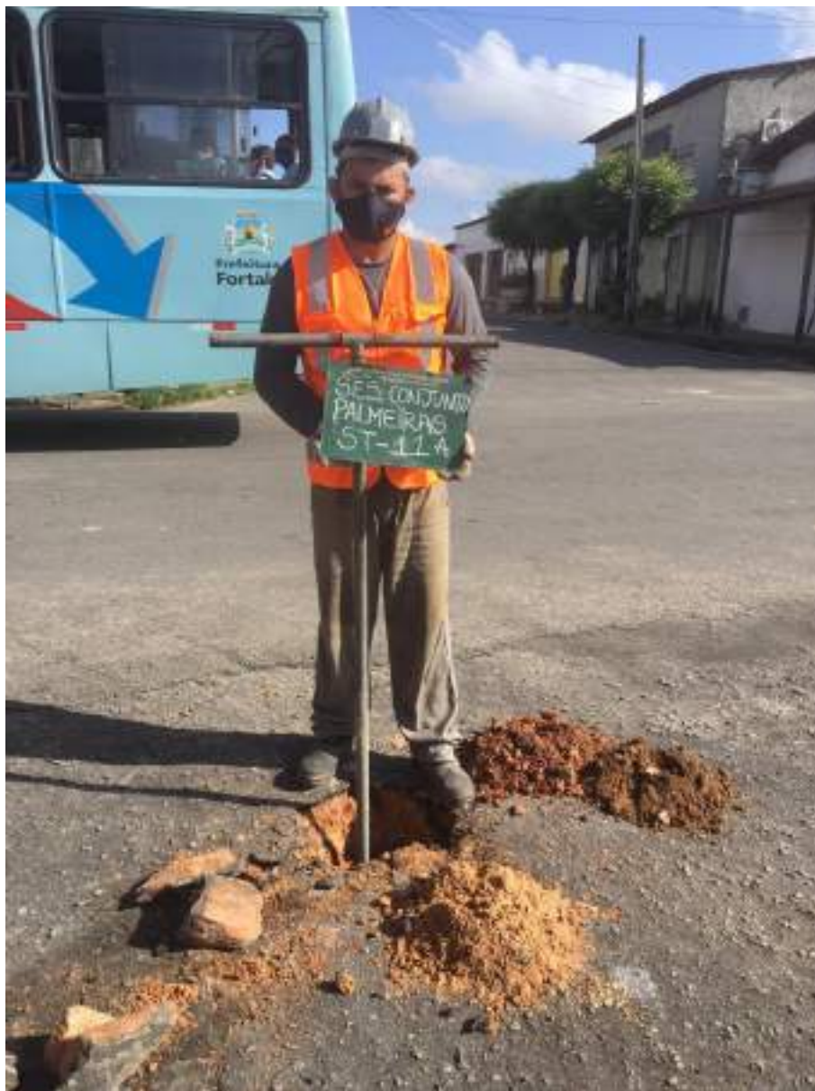
Instalação do furo ST-11 A
