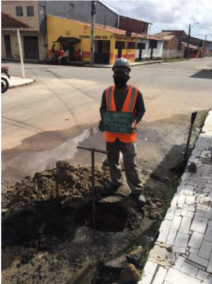
Instalação do furo ST-06
