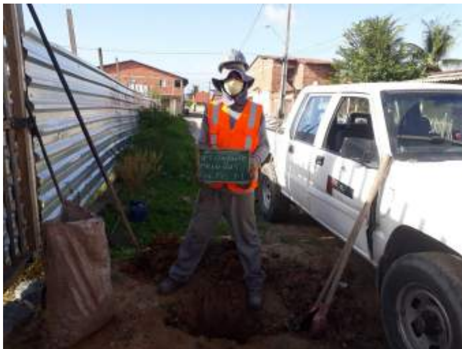
Instalação do furo ST-14
