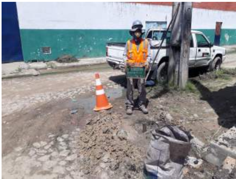
Instalação do furo ST-16
