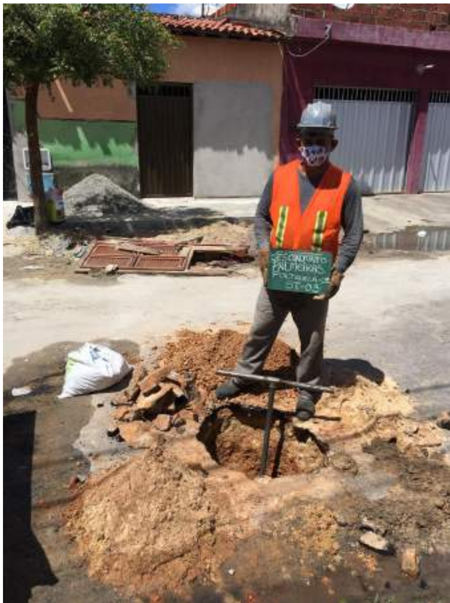
Instalação do furo ST-03
