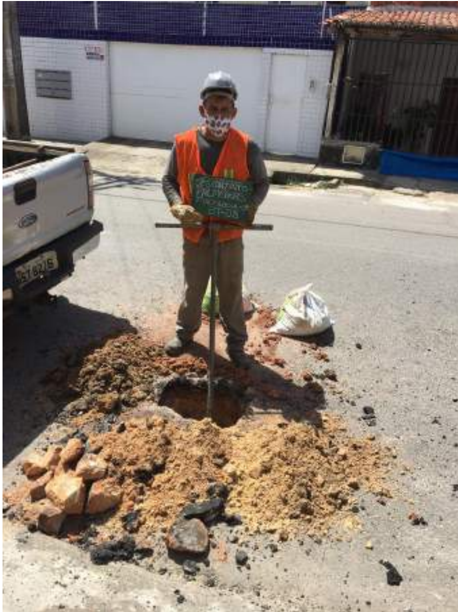
Instalação do furo ST-08
