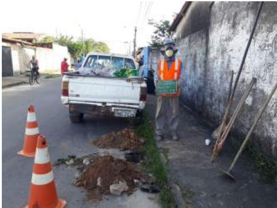
Instalação do furo ST-13
