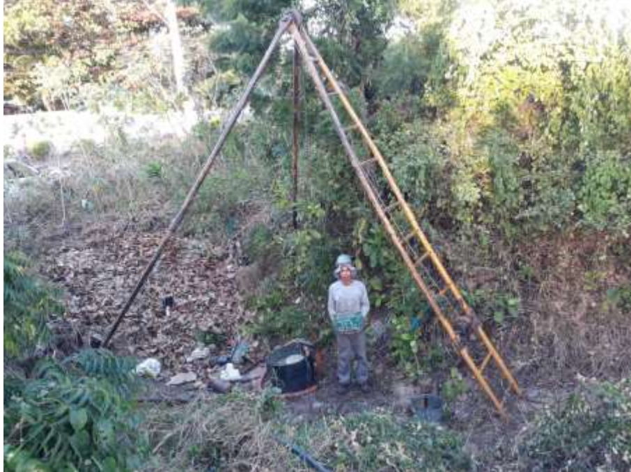
Instalação do furo SPT-01
