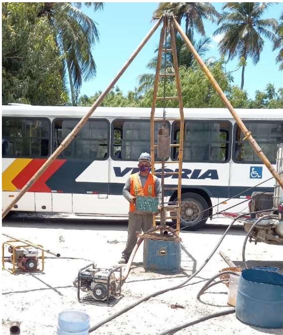
Instalação do furo SPT-02
