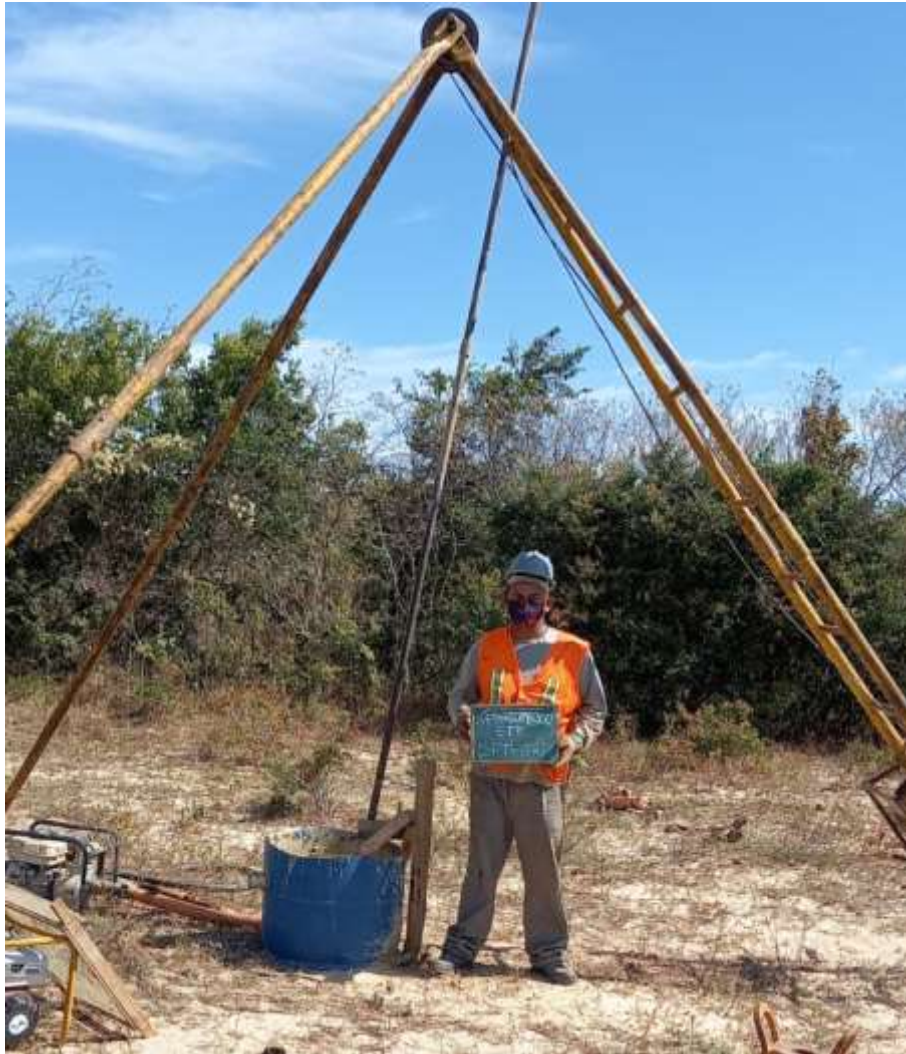
Instalação do furo SPT-02
