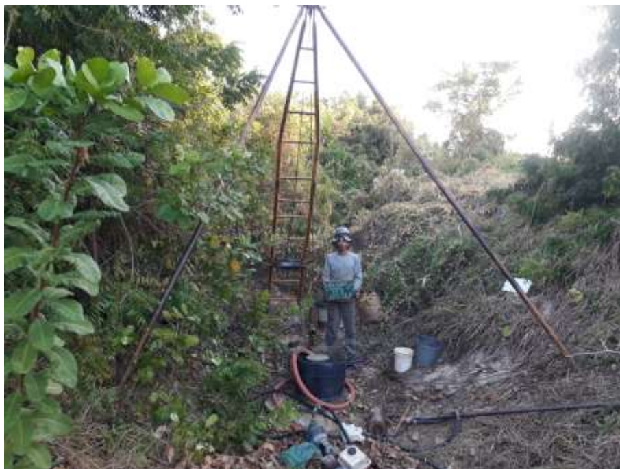
Instalação do furo SPT-01 A
