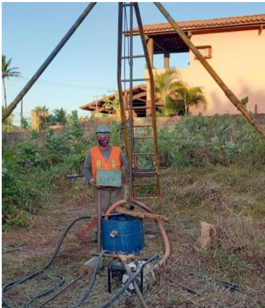
Instalação do furo SPT-02
