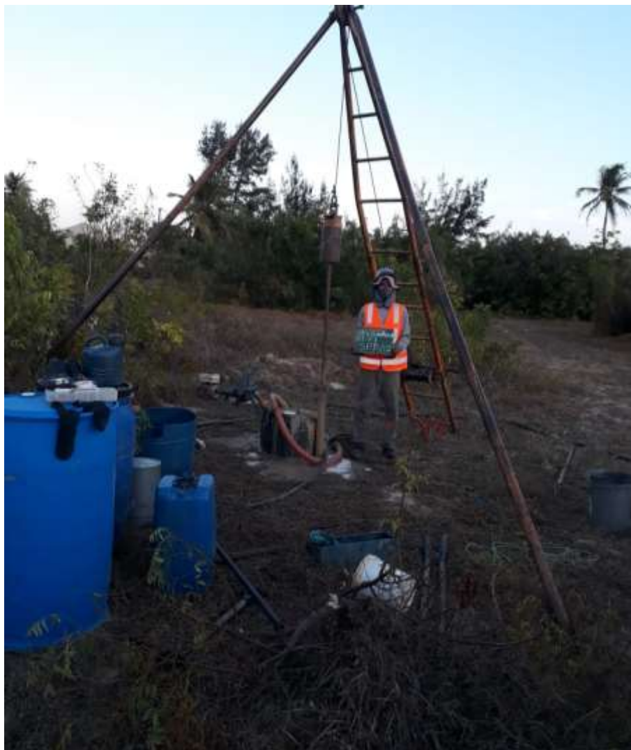
Instalação do furo SPT-02
