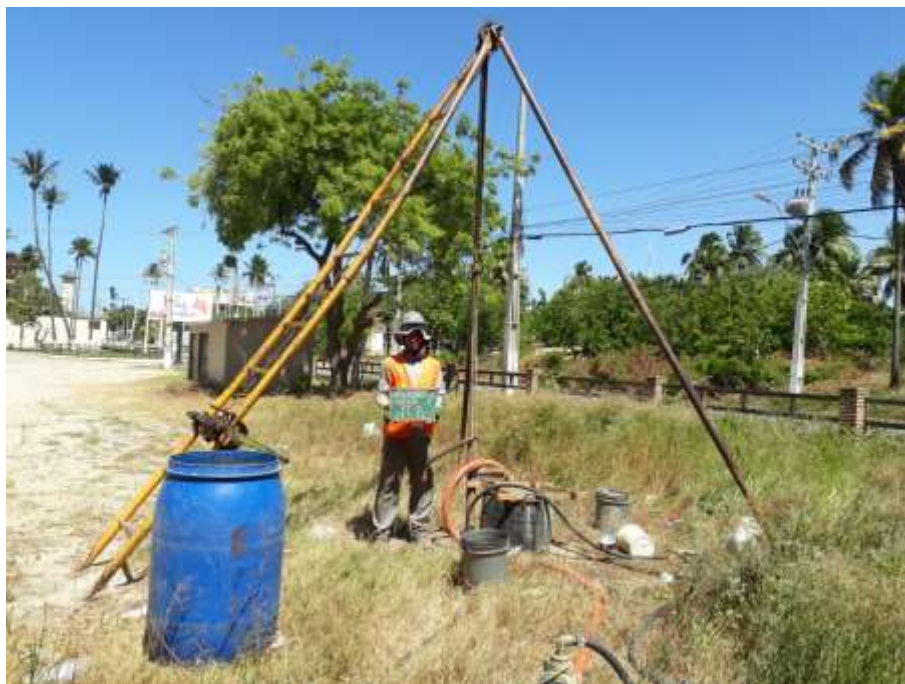
Instalação do furo SPT-01
