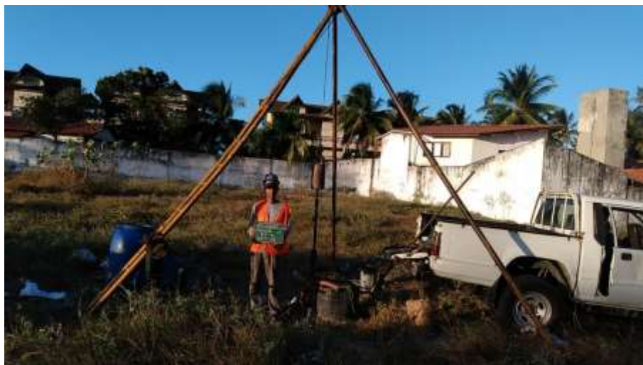
Instalação do furo SPT-02
