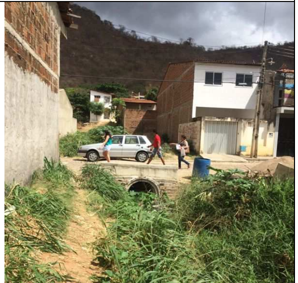
FOTO 10 - ÁREA DE INTERFERÊNCIA COM DRENAGEM
