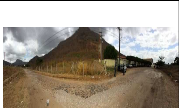
FOTO 08 - ÁREA DA EEE-05
