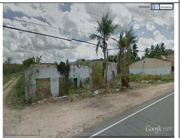
FOTO 06- ÁREA DA EEE-03
