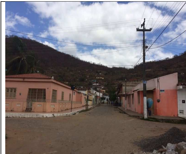
FOTO 01- RUA A SER CONTEMPLADA COM REDE COLETORA
