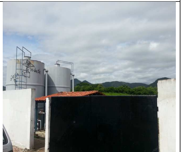
FOTO 04- ETE EXISTENTE/ÁREA DA EEE-01
