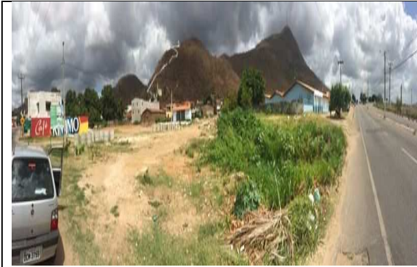
FOTO 07 - ÁREA DA EEE-04
