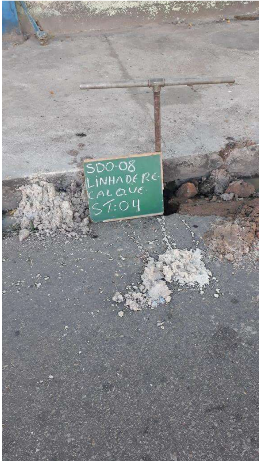
Instalação do furo ST-04
