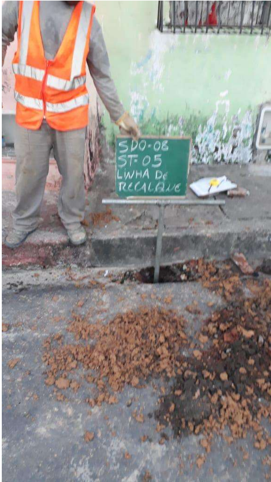
Instalação do furo ST-05
