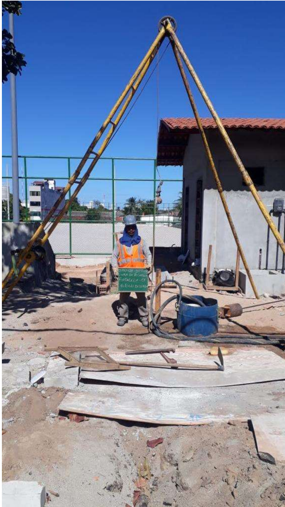
Instalação do furo SP-04
