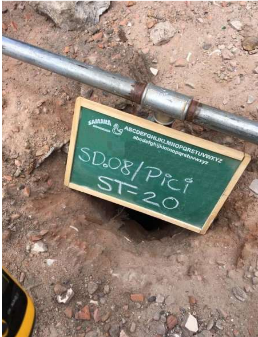
Instalação do furo ST-20
