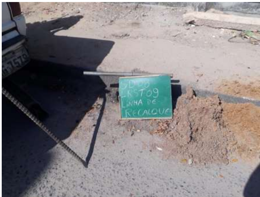
Instalação do furo ST-09
