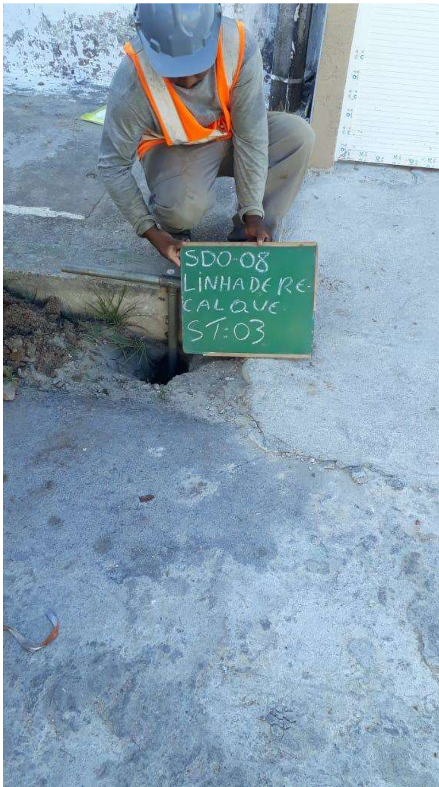
Instalação do furo ST-03
