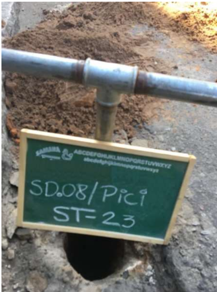
Instalação do furo ST-23
