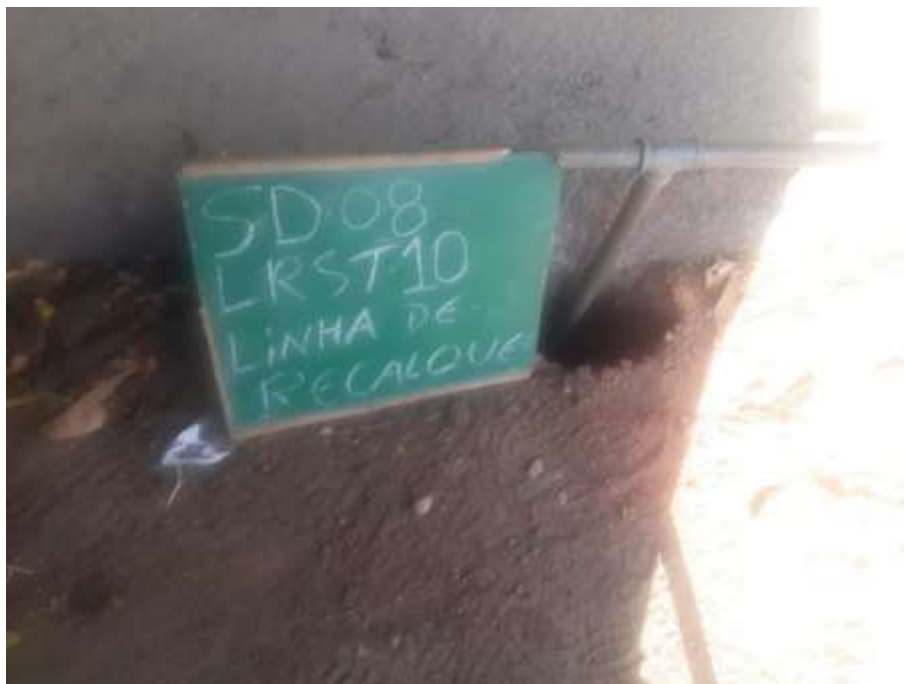
Instalação do furo ST-10
