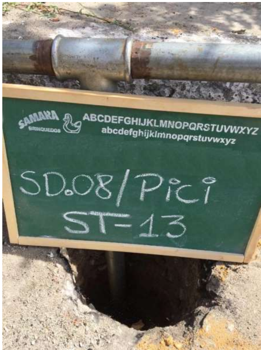
Instalação do furo ST-13
