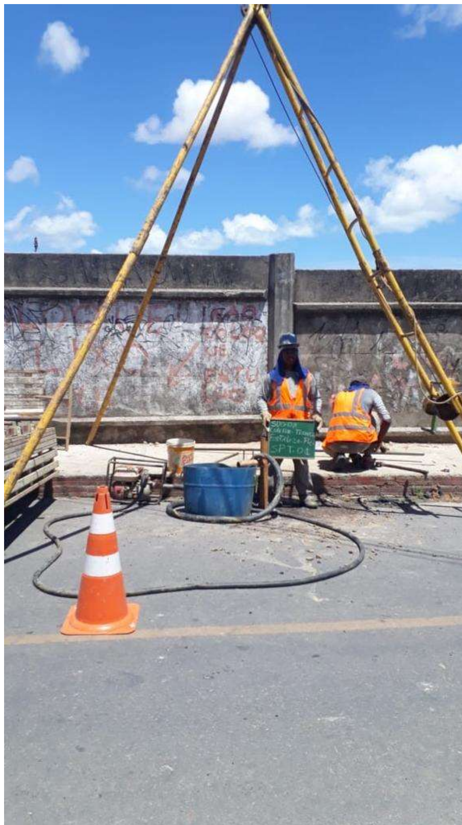
Instalação do furo SP-01
