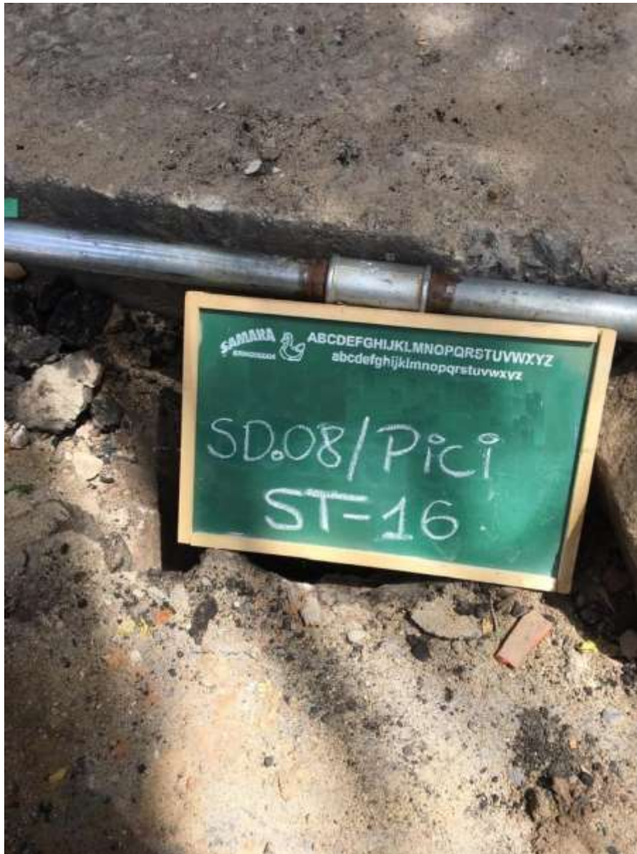
Instalação do furo ST-16
