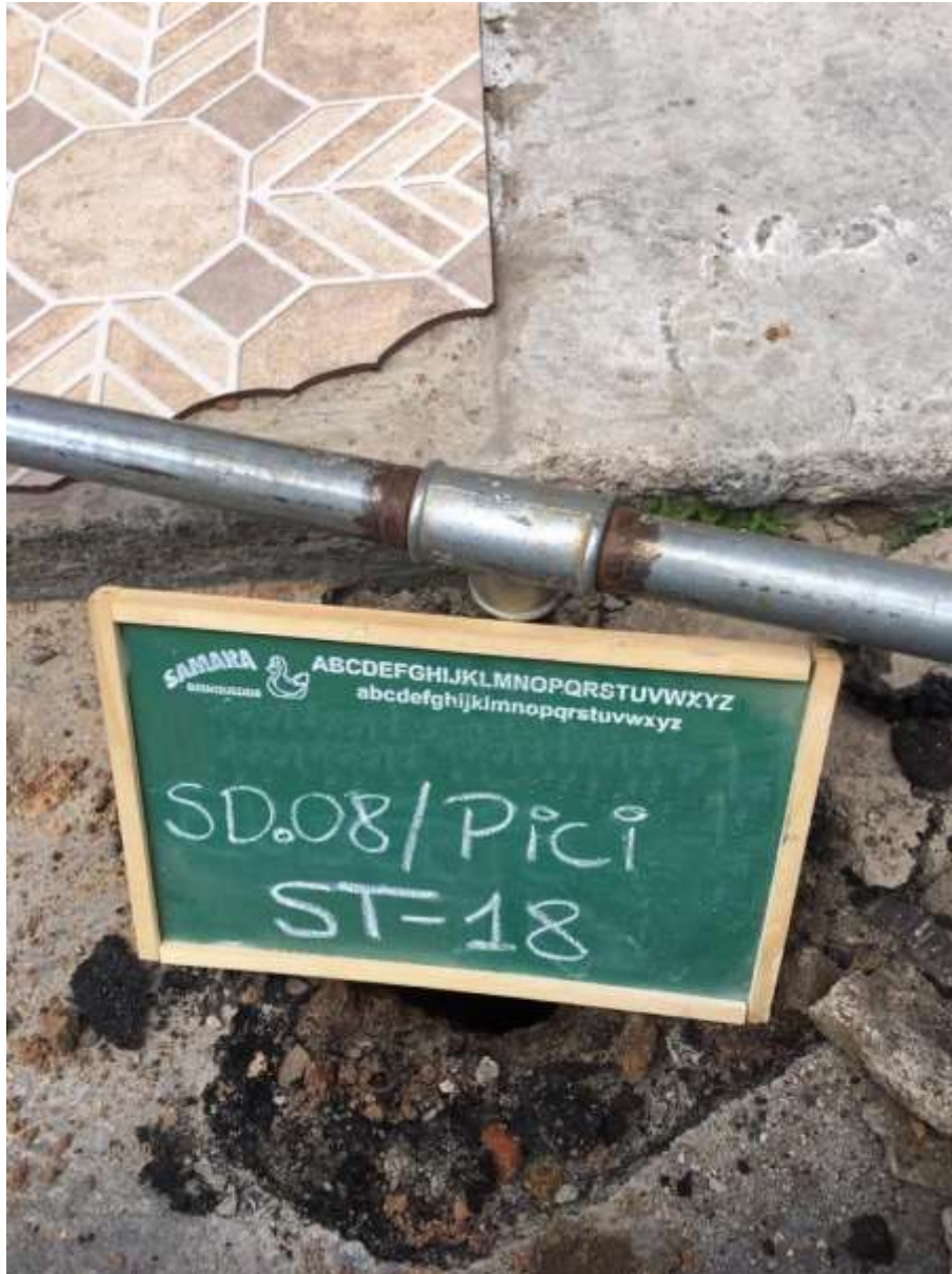
Instalação do furo ST-18
