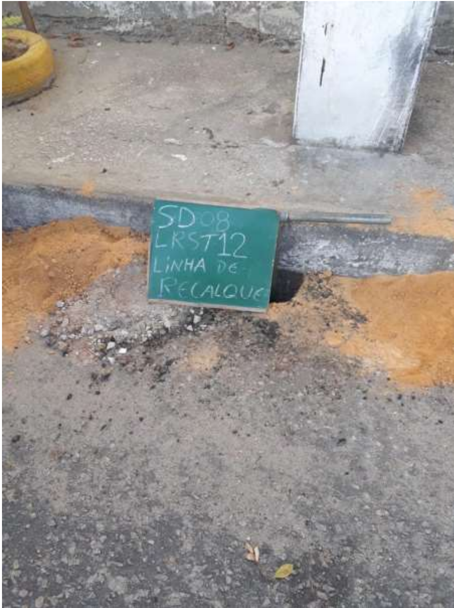
Instalação do furo ST-12
