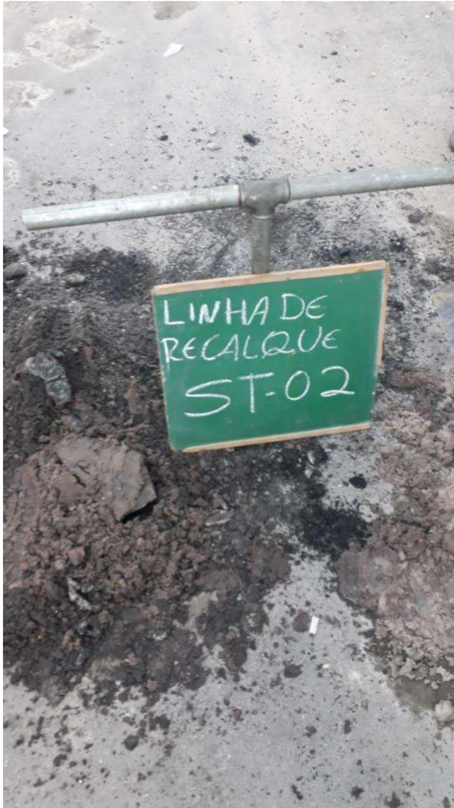
Instalação do furo ST-02
