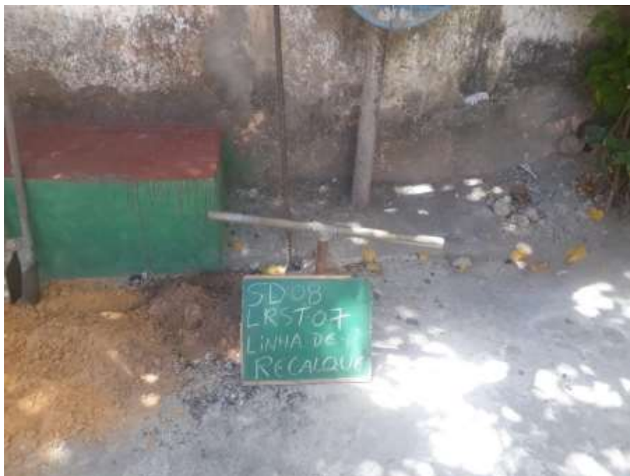
Instalação do furo ST-07
