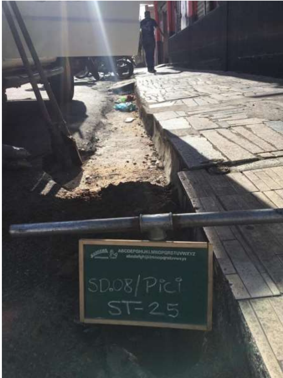
Instalação do furo ST-25
