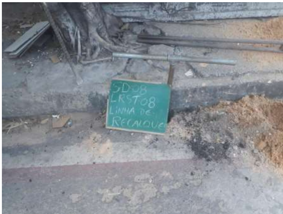
Instalação do furo ST-08
