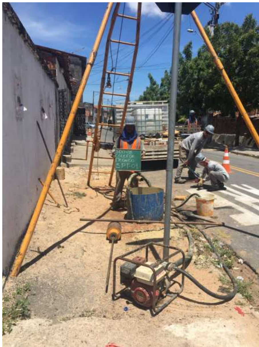
Instalação do furo SP-01
