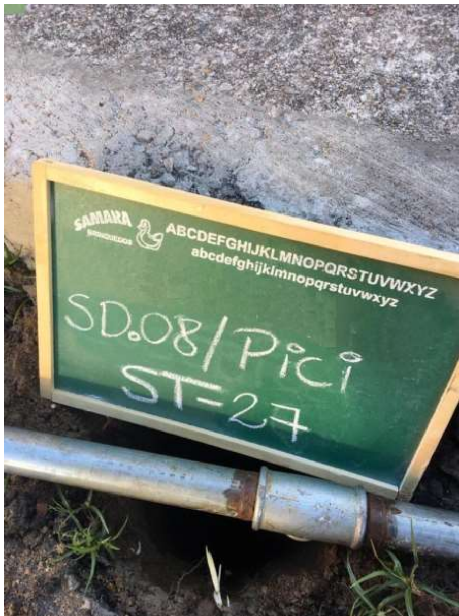
Instalação do furo ST-27
