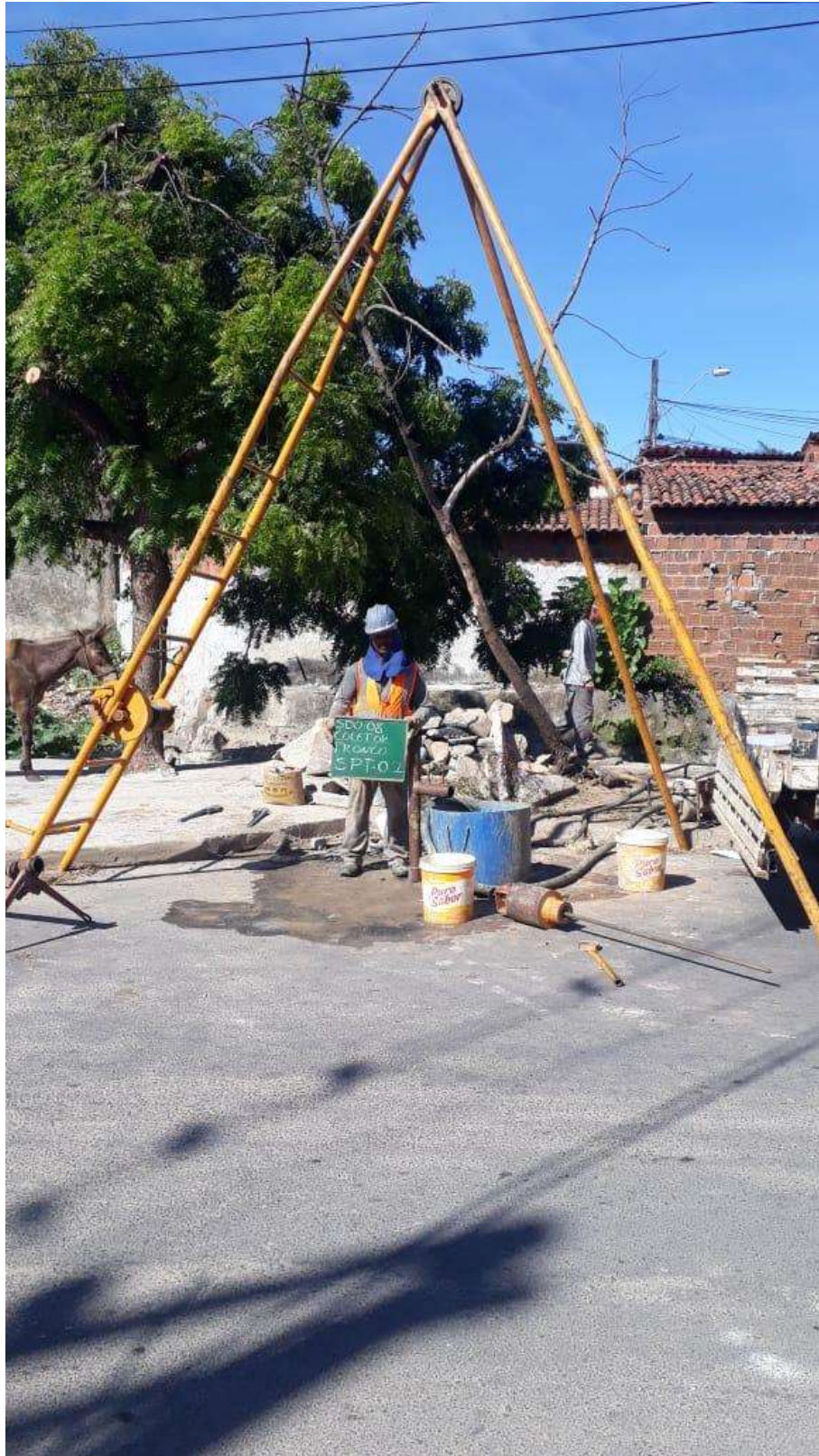
Instalação do furo SP-02
