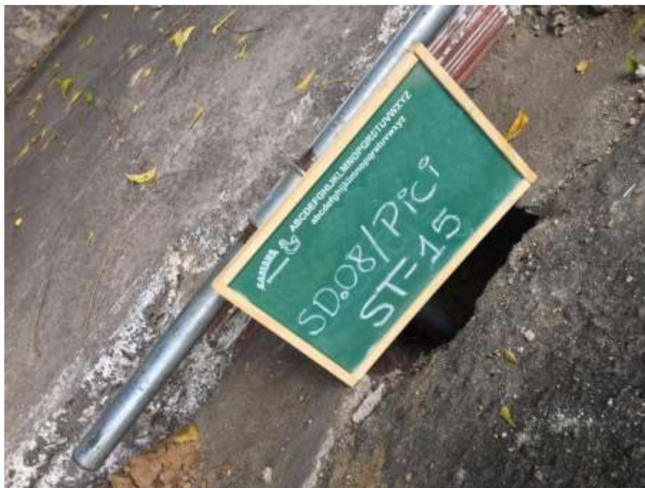
Instalação do furo ST-15
