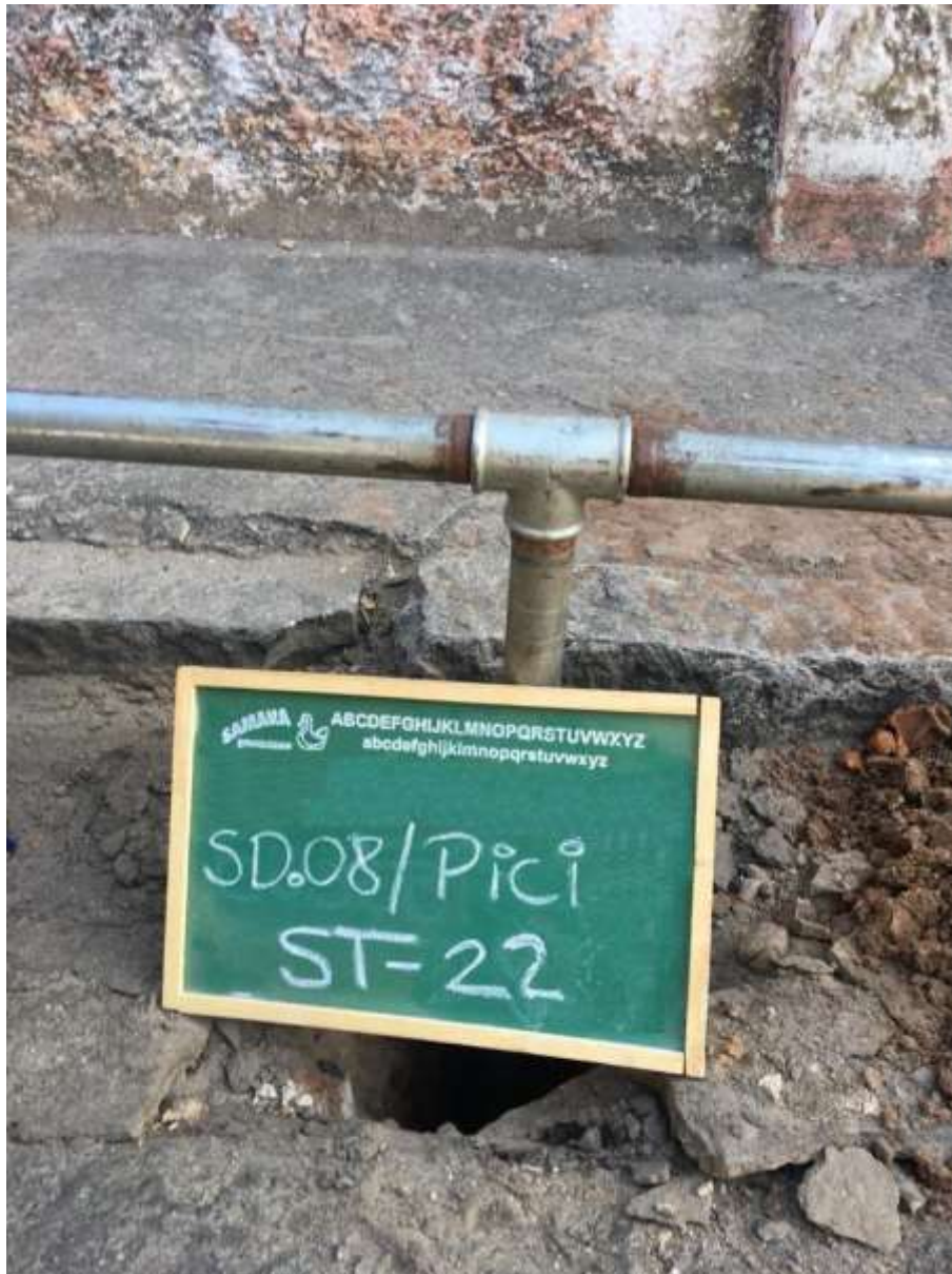
Instalação do furo ST-22
