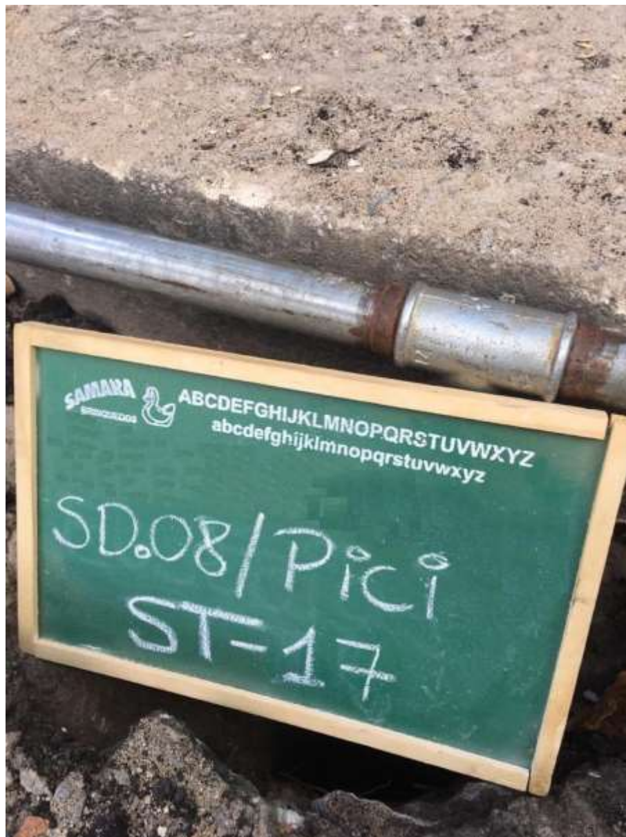
Instalação do furo ST-17
