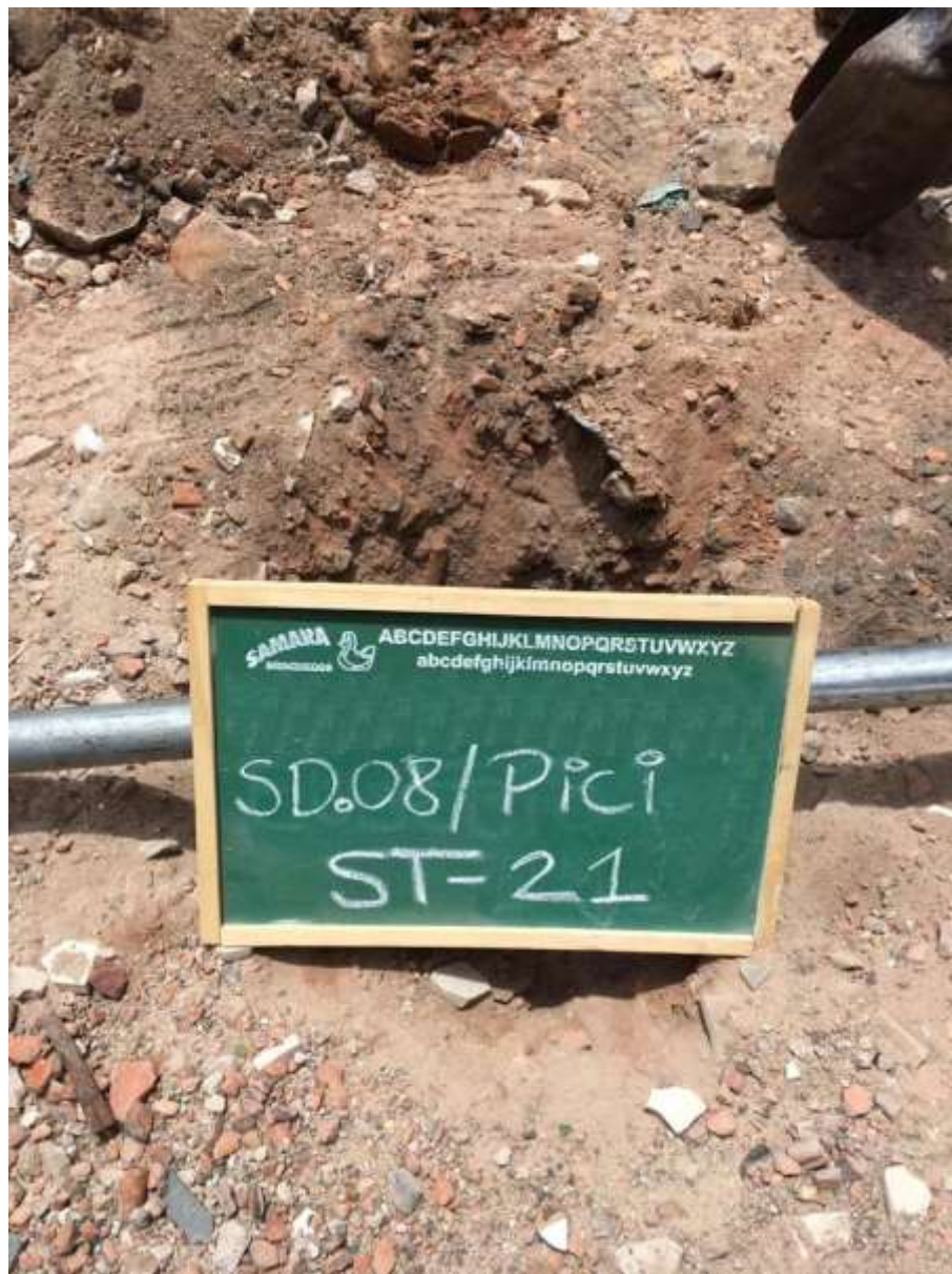
Instalação do furo ST-21
