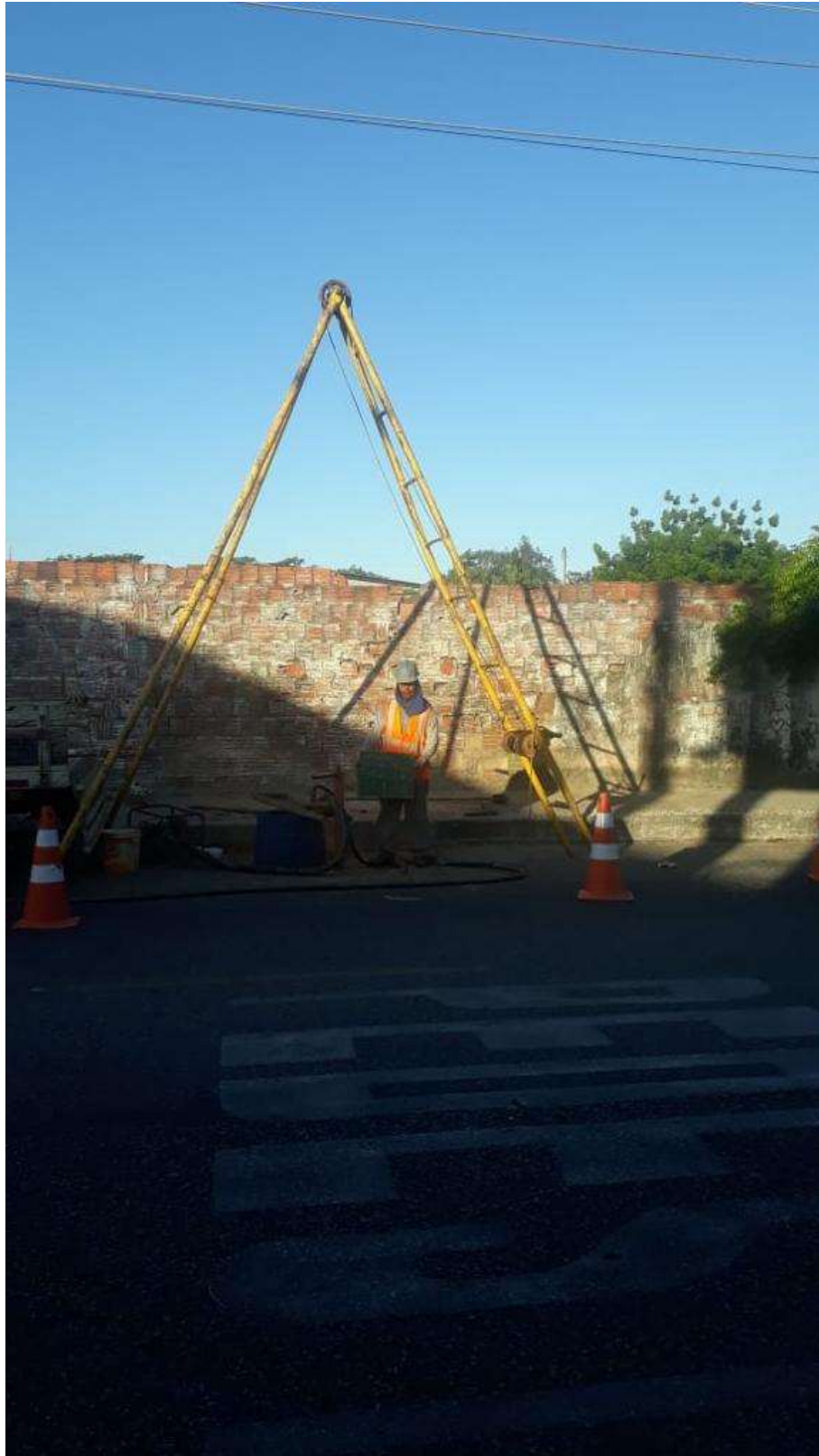
Instalação do furo SP-02
