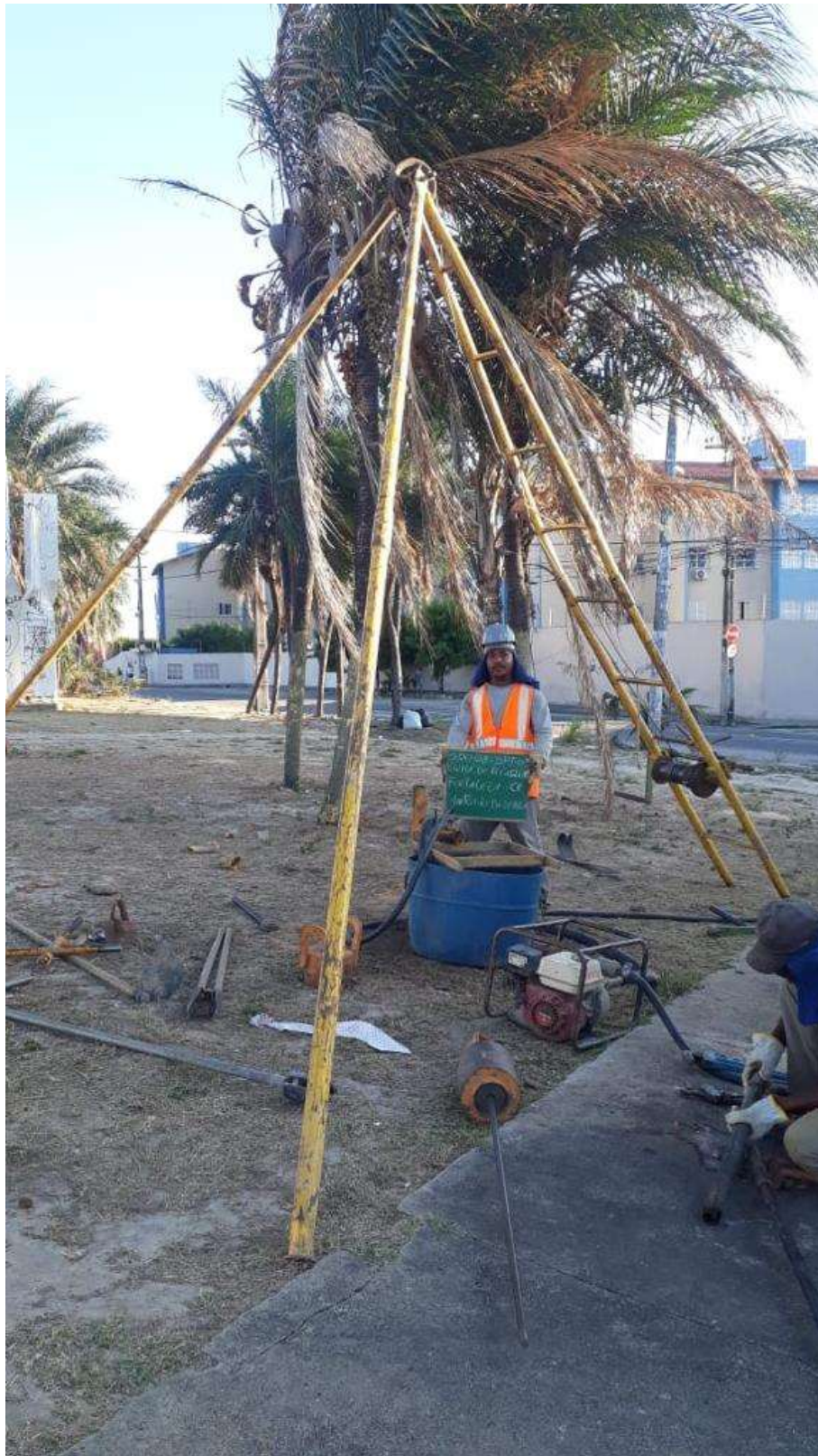
Instalação do furo SP-03
