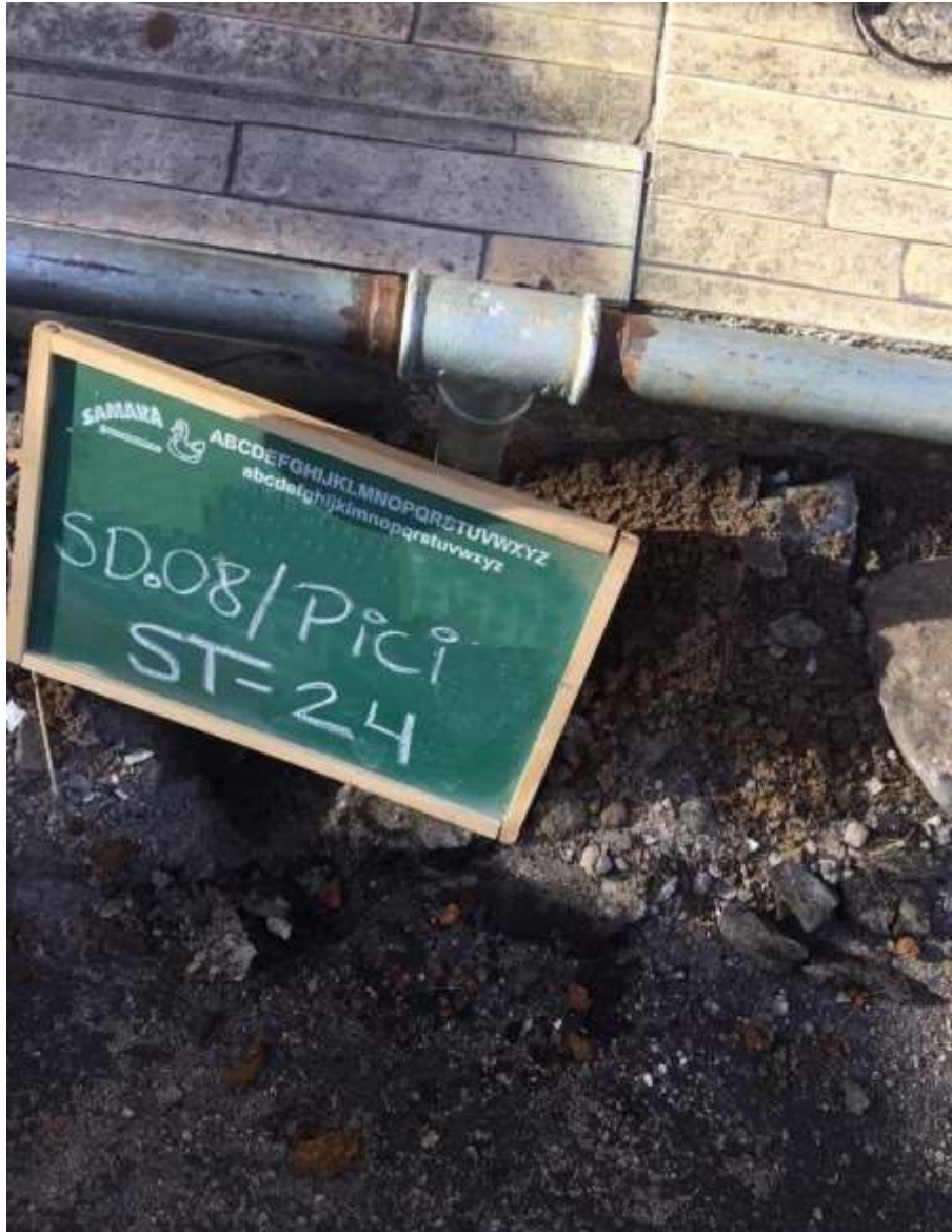
Instalação do furo ST-24
