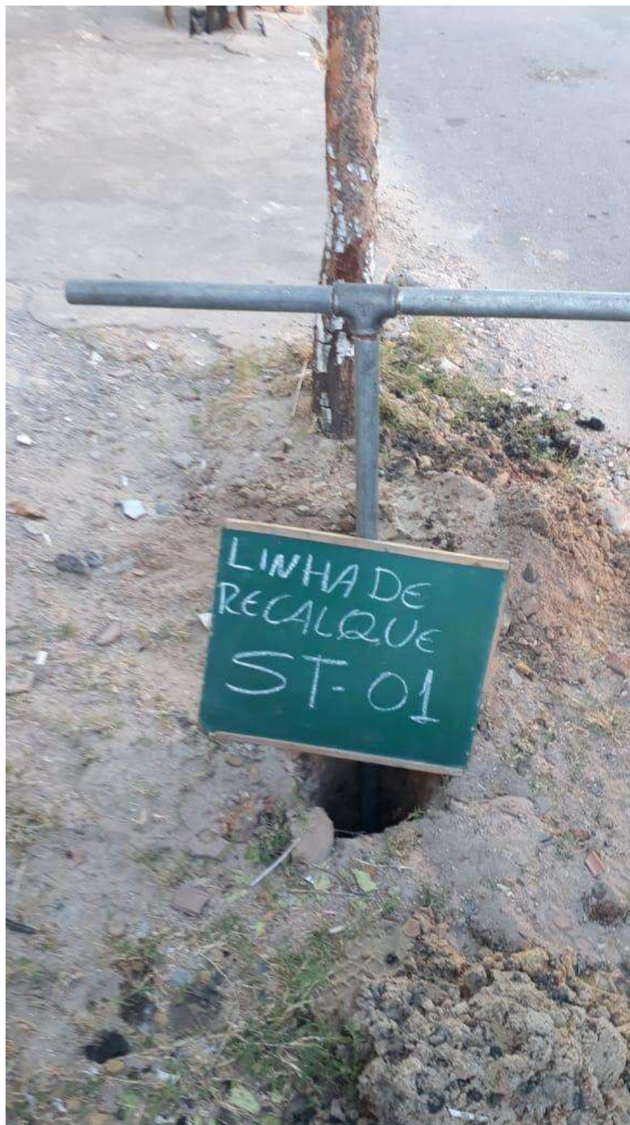
Instalação do furo ST-01
