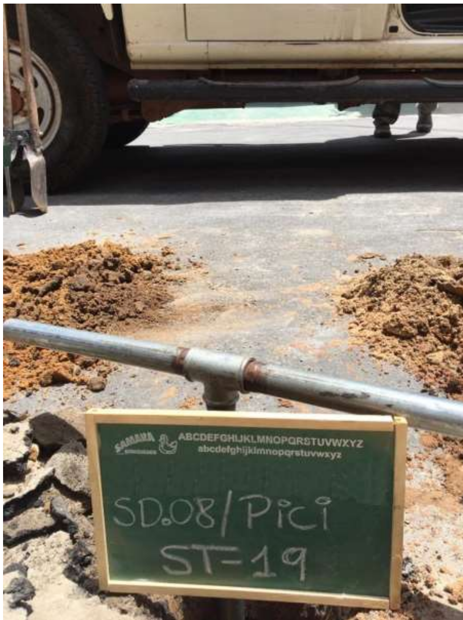
Instalação do furo ST-19
