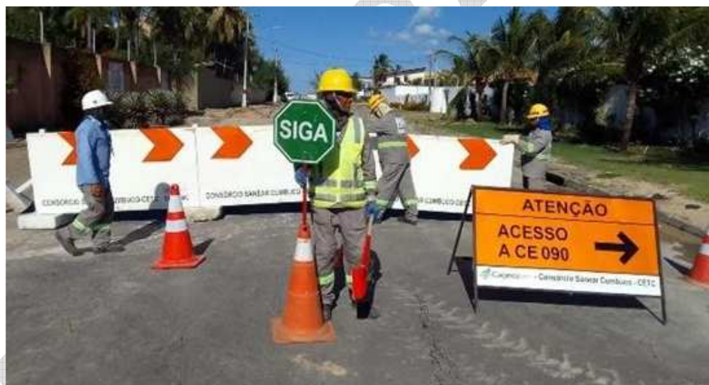
Figura 34 - Operação com uso de trabalhador “siga”
