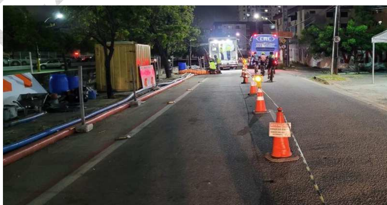
Figura 31 – Dispositivo luminoso intermitente com acendimento sequencial
