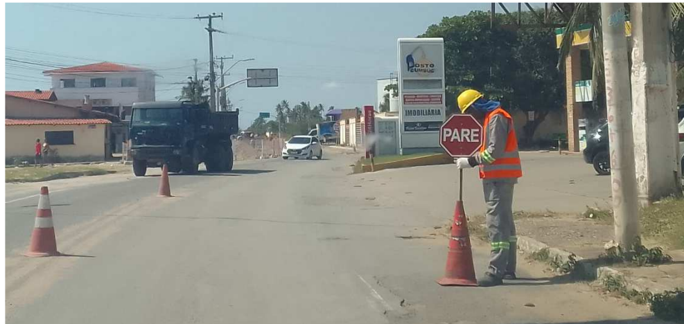
Figura 33 - Operação com uso de trabalhador “pare”
