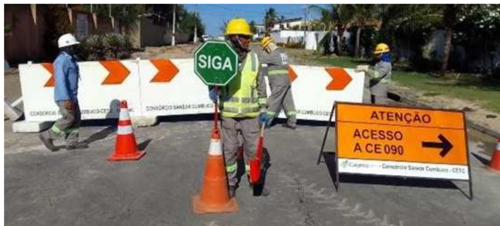
Figura 34 - Operação com uso de trabalhador “siga”
