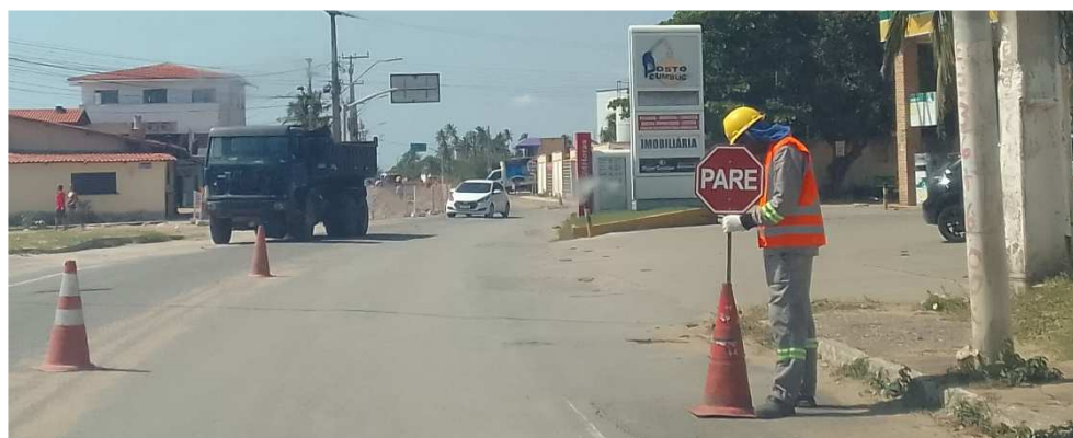
Figura 33 - Operação com uso de trabalhador “pare”
