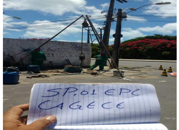
FOTO 02: Detalhe do local onde foi realizado o furo SP-01.
