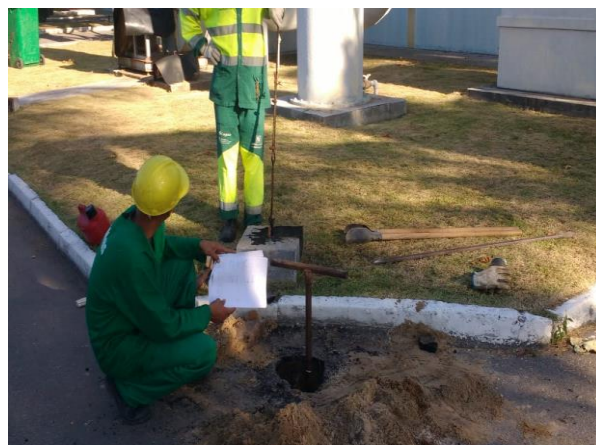
FOTO 10: Detalhe do local onde foi realizado o furo ST-11 do plano EPC.
