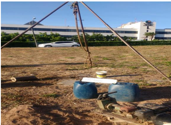
FOTO 03: Detalhe do local onde foi realizado o furo SP-02.
