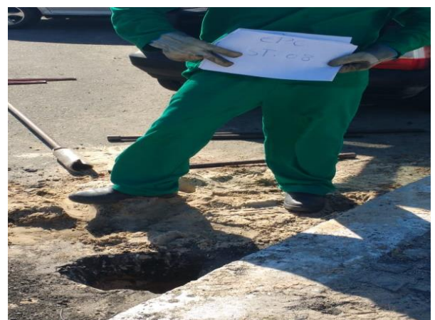
FOTO 06 Detalhe da Identificação do furo ST-08.
