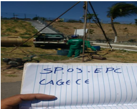
FOTO 05: Detalhe do local onde foi realizado o furo SP-03.
