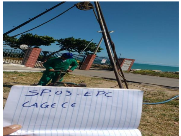
FOTO 06: Detalhe do local onde foi realizado o furo SP-03.
