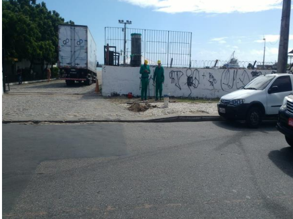
FOTO 01: Detalhe do local onde foi realizado o furo ST-04 do plano EPC.
