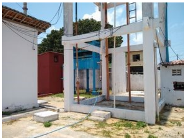
Foto 5: Estação de tratamento
