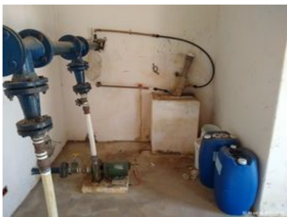
Foto 7: Estação Elevatória de Lavagem dos filtros
