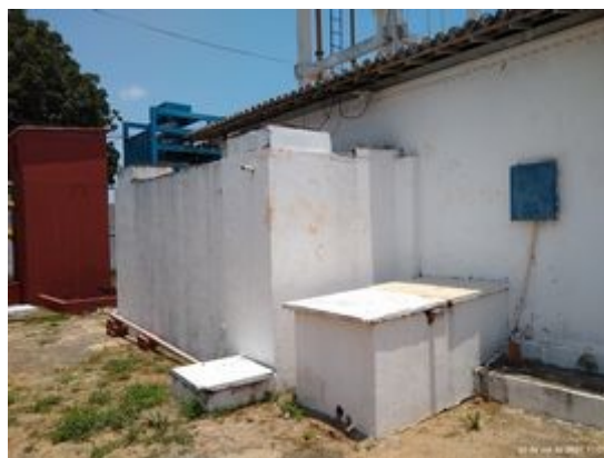
Foto 4: Casa de Bombas
