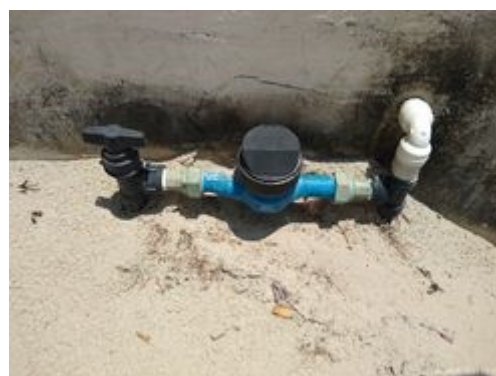
Foto 12: Ligação predial existente
