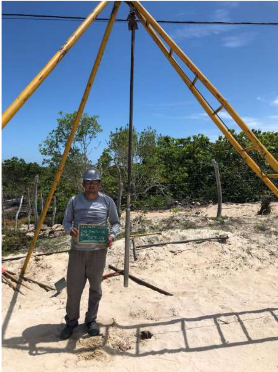
Instalação do furo SP-04
