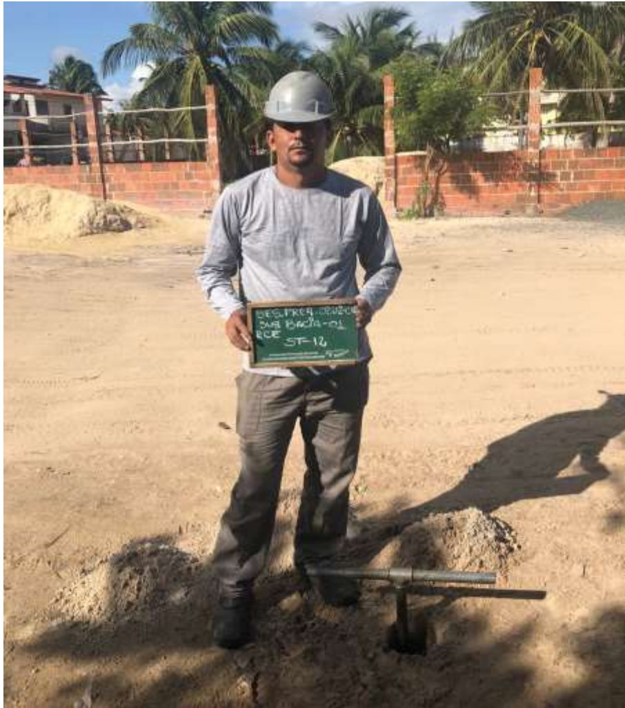
Instalação do furo ST-12
