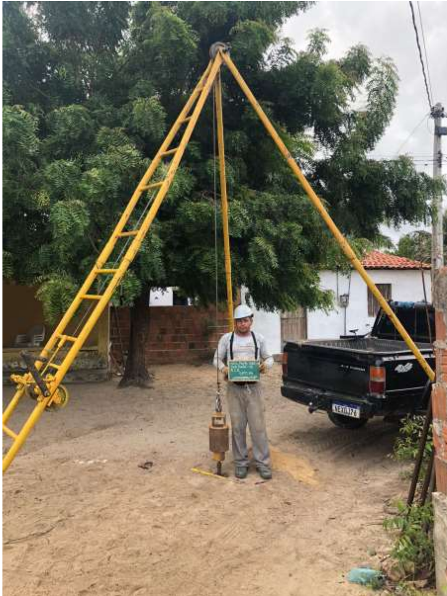
Instalação do furo SP-16
