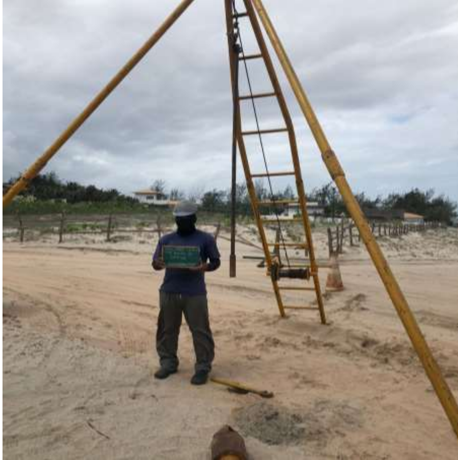
Instalação do furo SP-01
