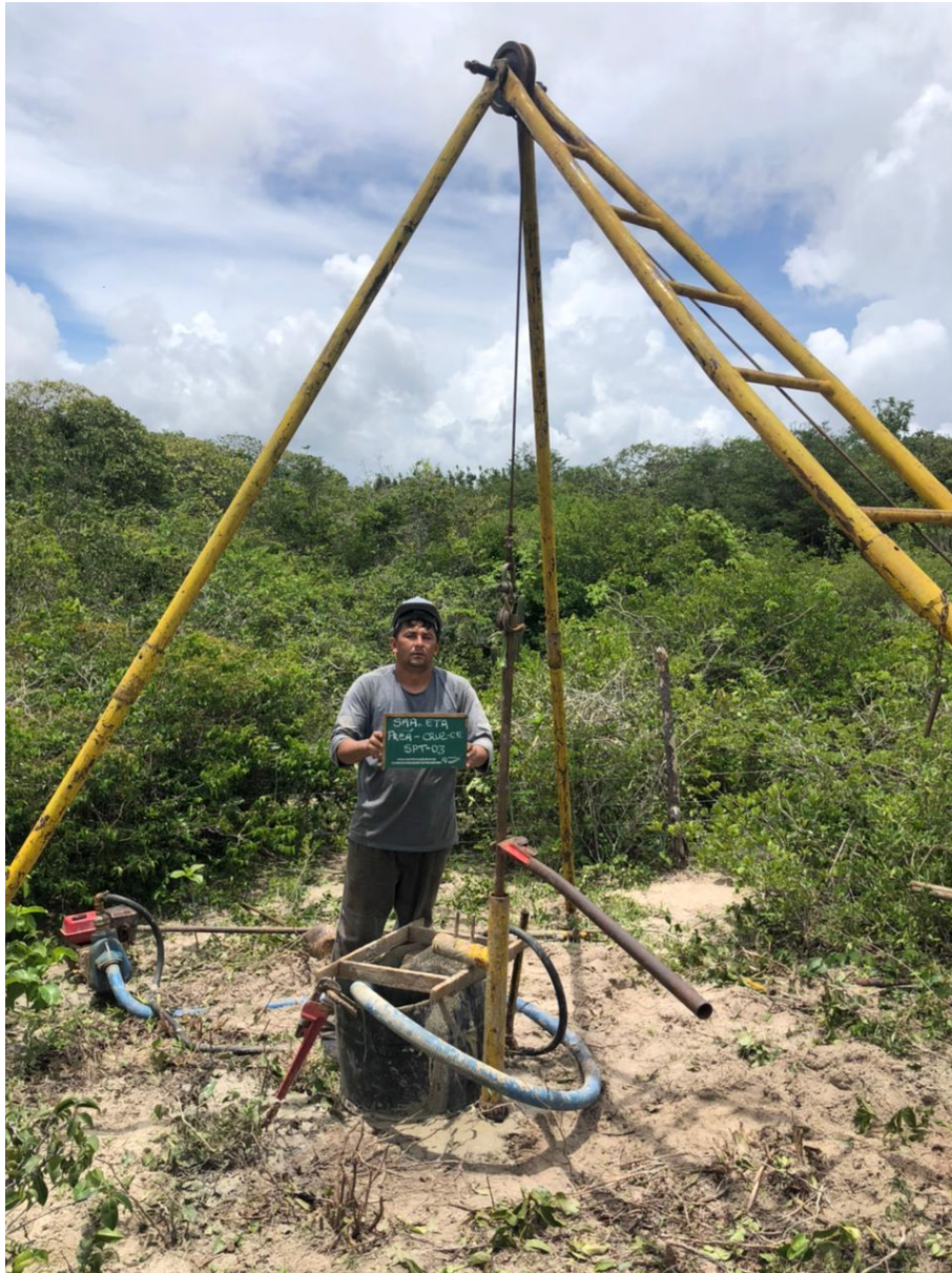
Instalação do furo SP-03
