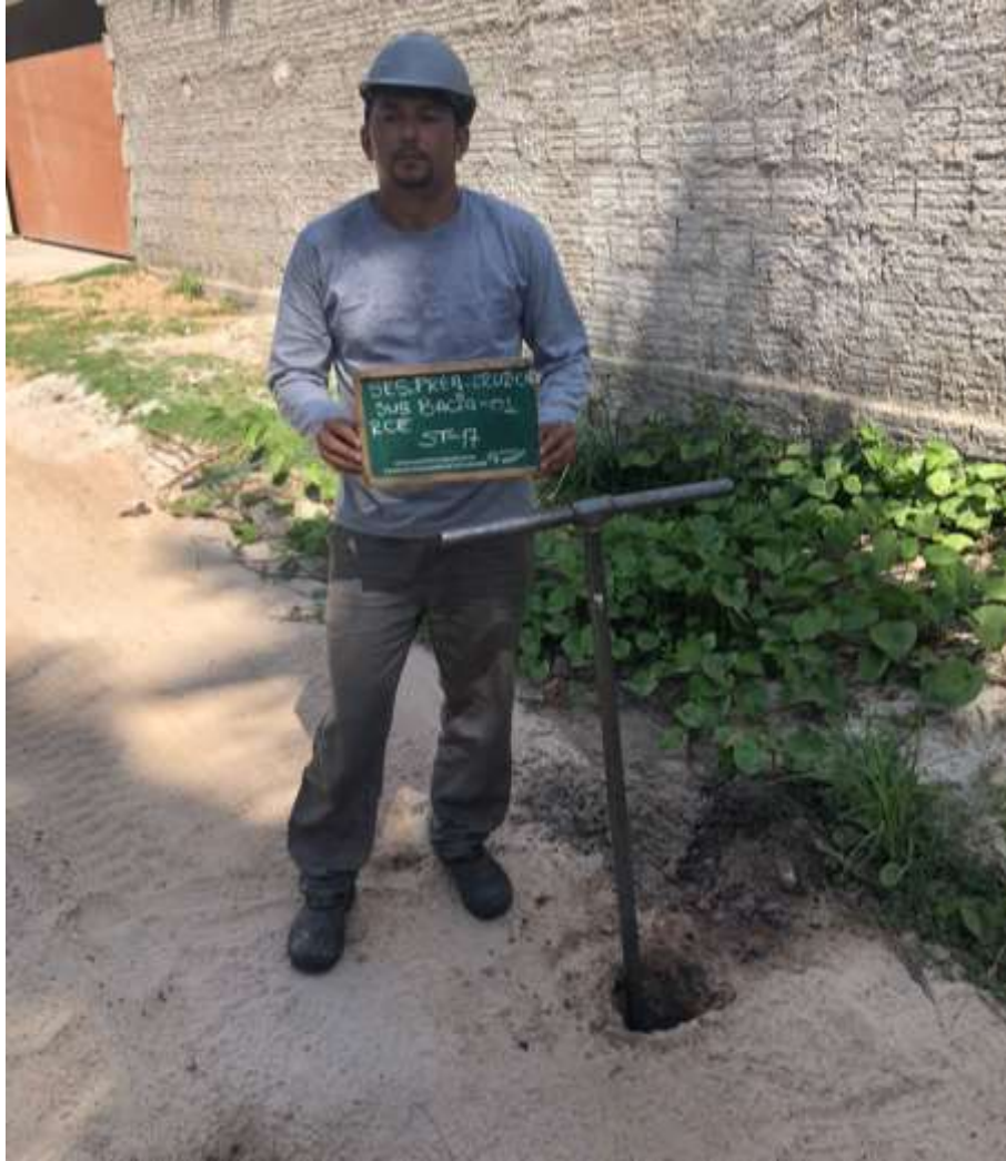
Instalação do furo ST-17
