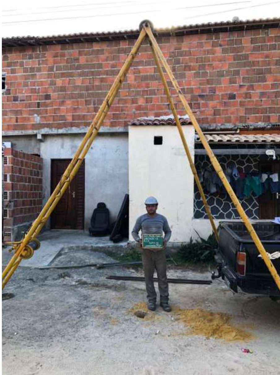
Instalação do furo SP-11
