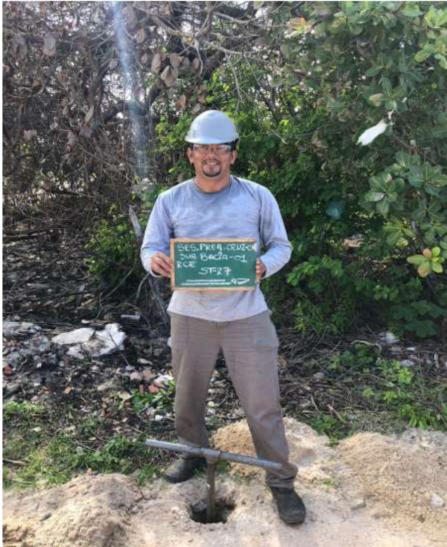
Instalação do furo ST-27
