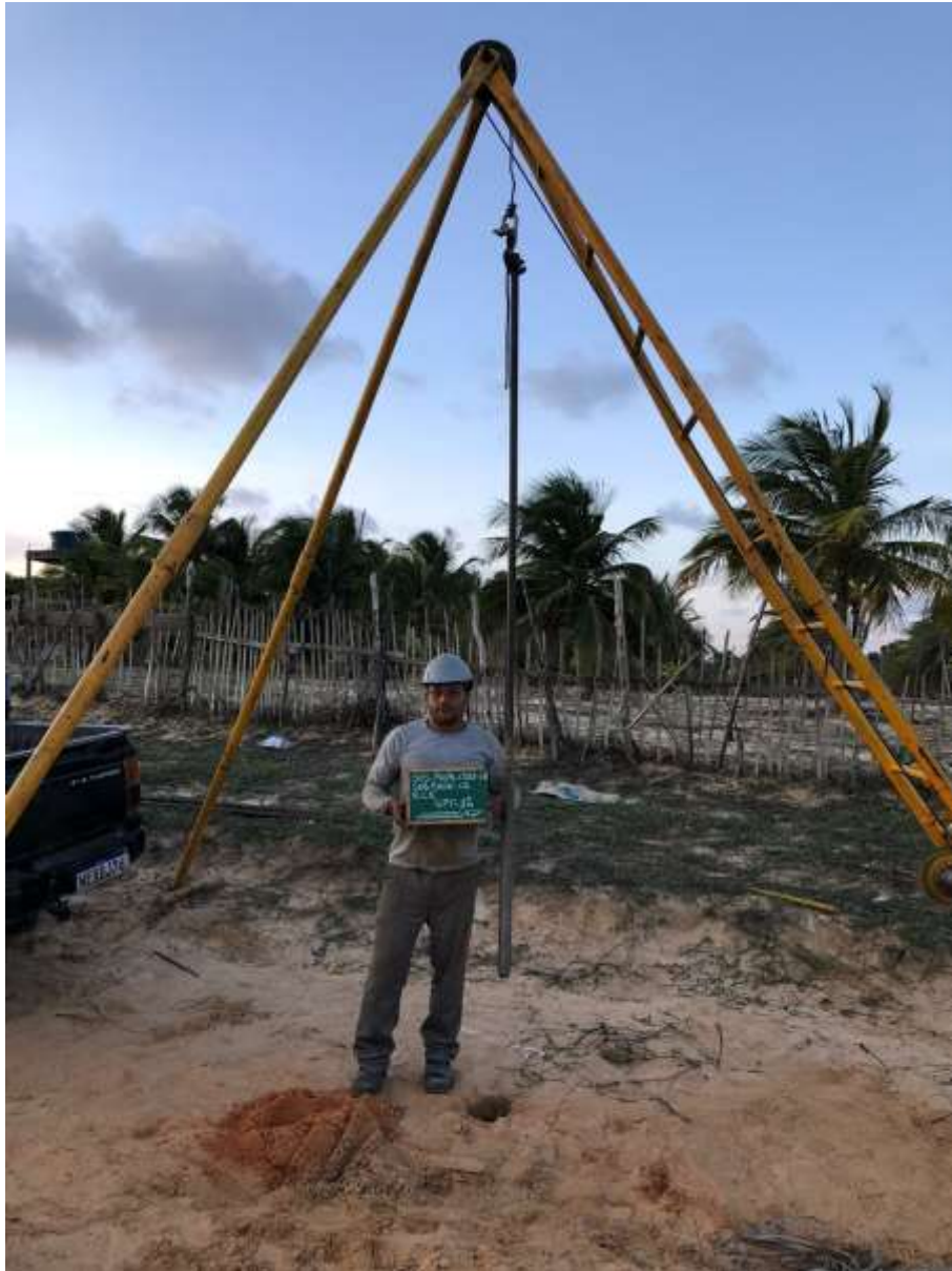
Instalação do furo SP-12
