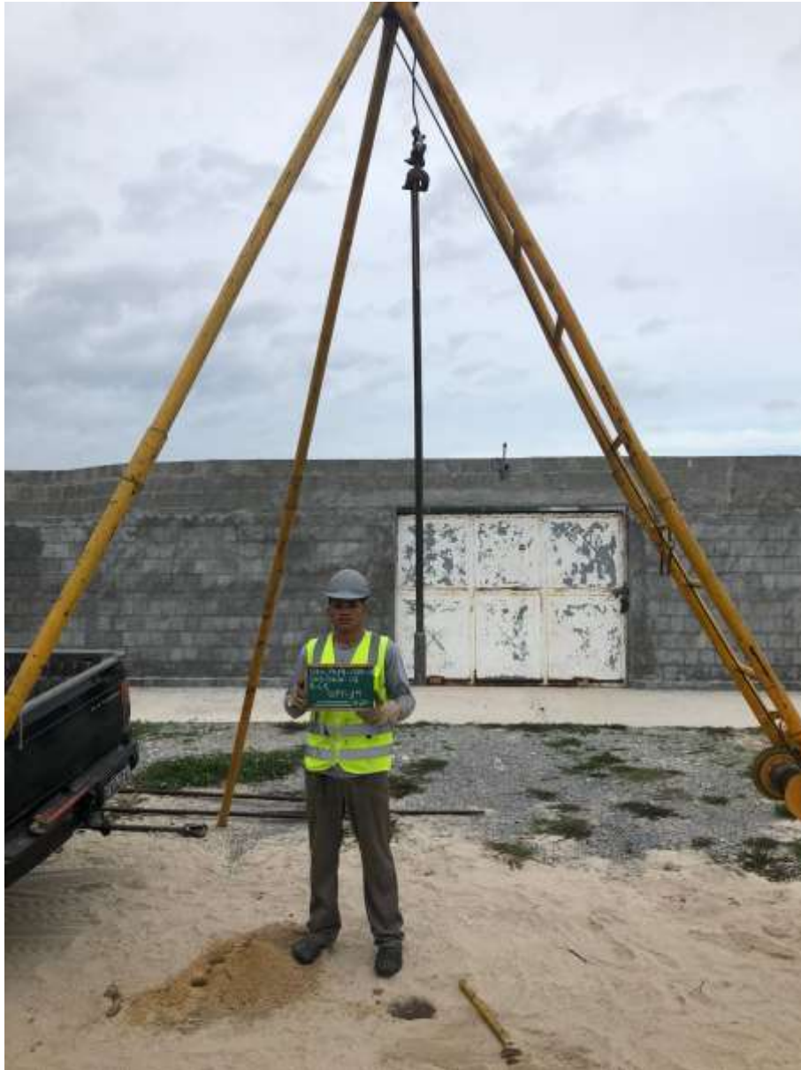
Instalação do furo SP-14
