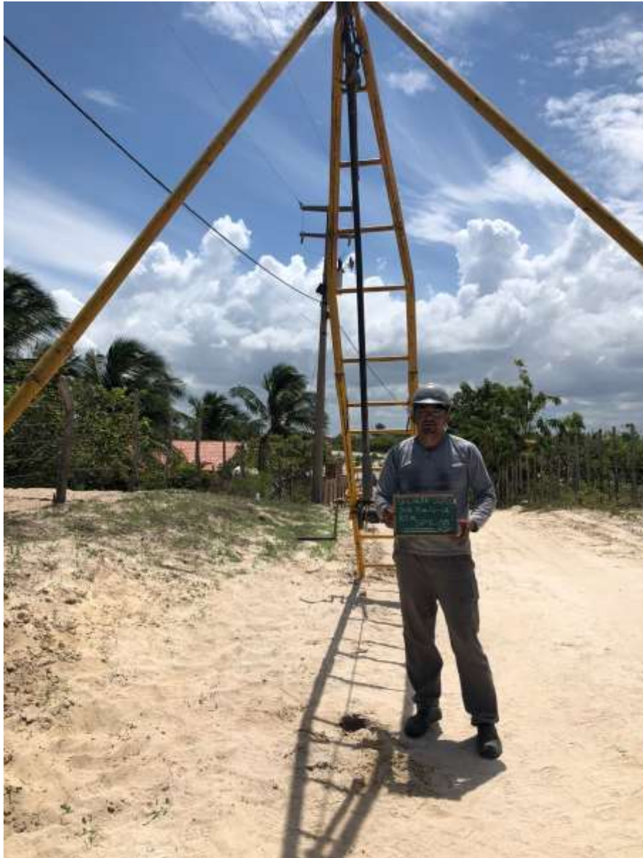
Instalação do furo SP-05
