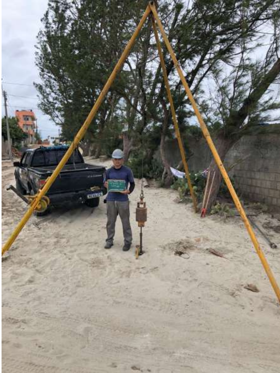
Instalação do furo SP-02
