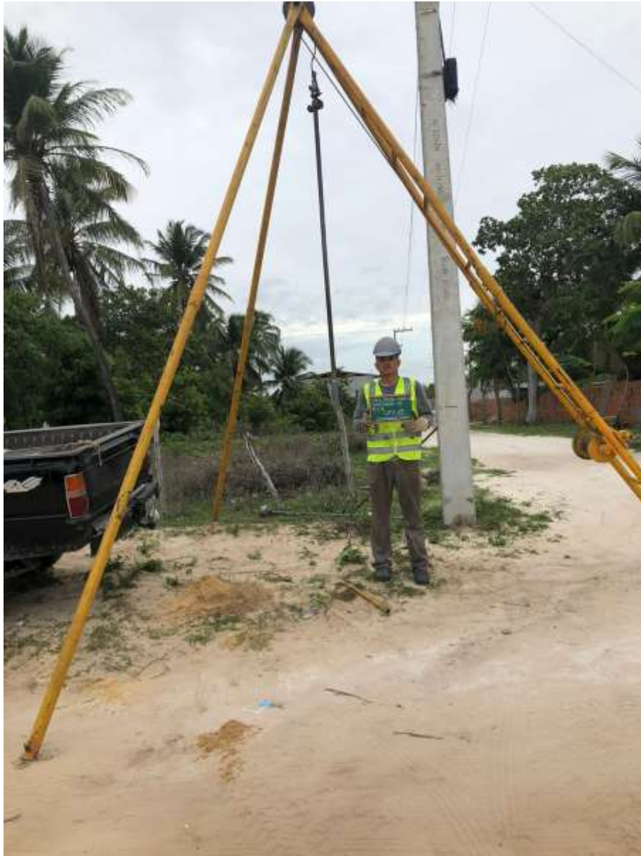
Instalação do furo SP-15
