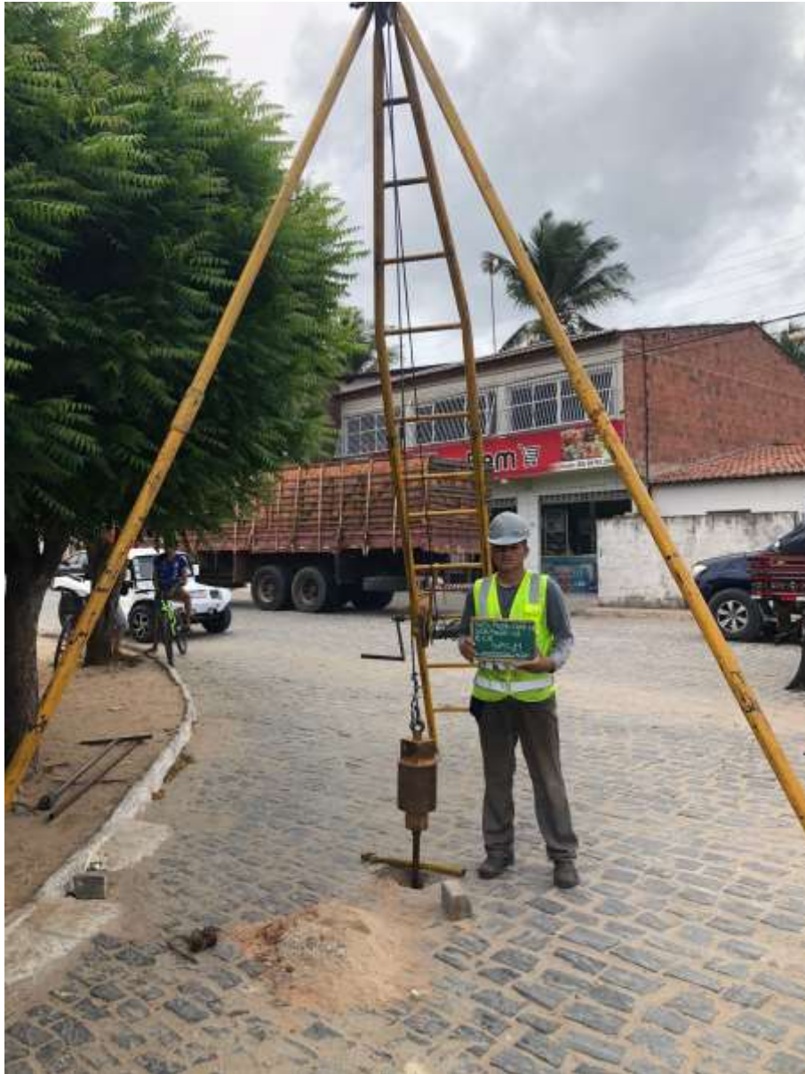
Instalação do furo SP-19
