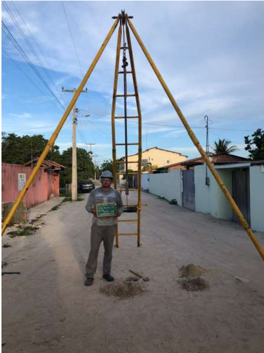
Instalação do furo SP-08
