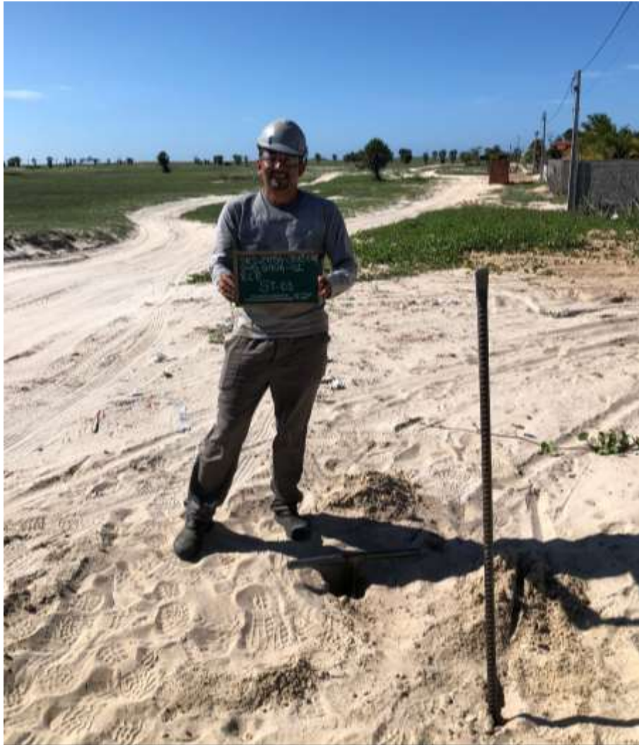
Instalação do furo ST-03
