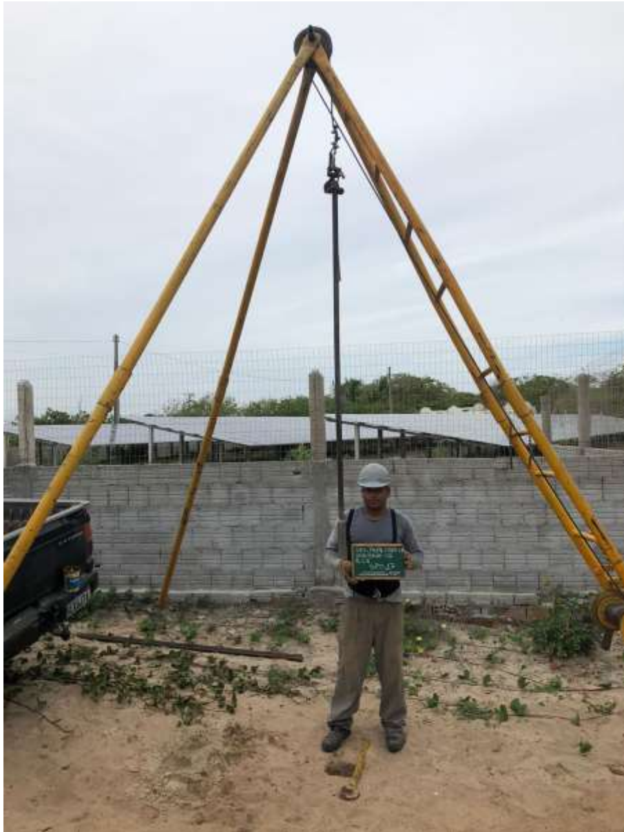
Instalação do furo SP-17
