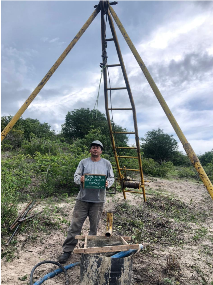
Instalação do furo SP-05
