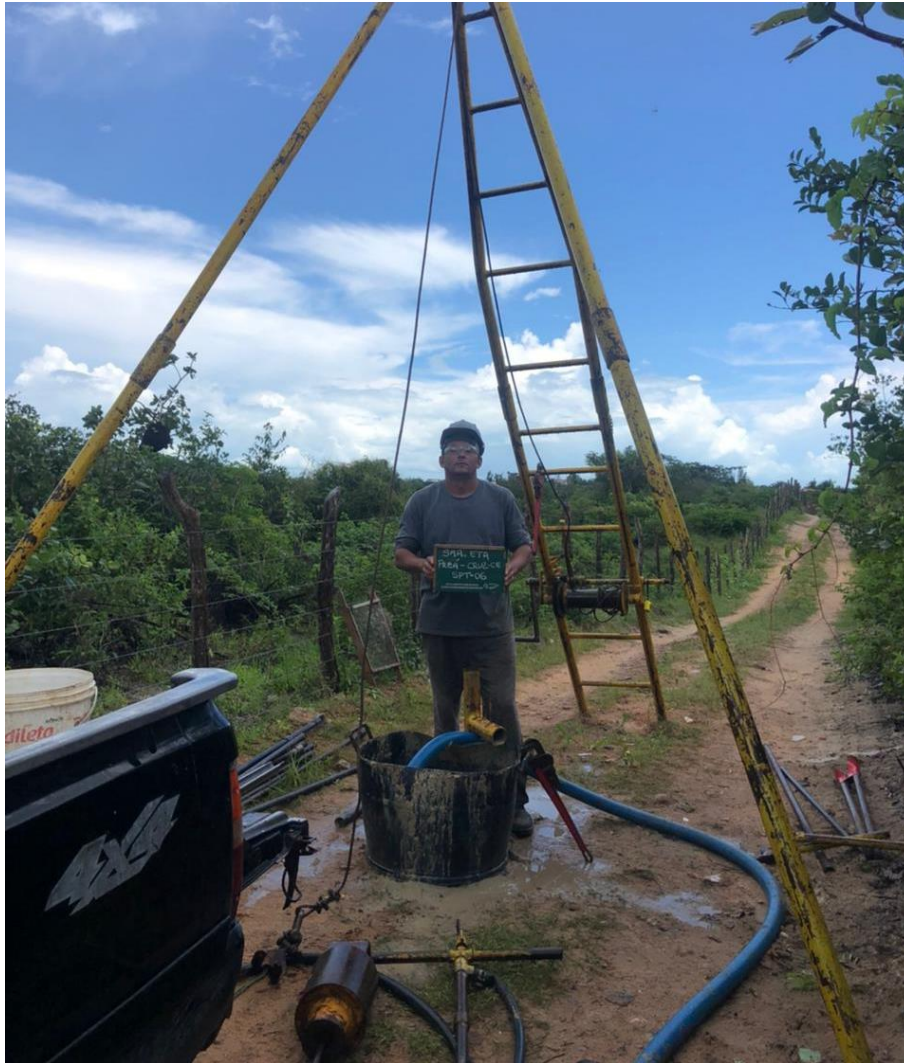
Instalação do furo SP-06
