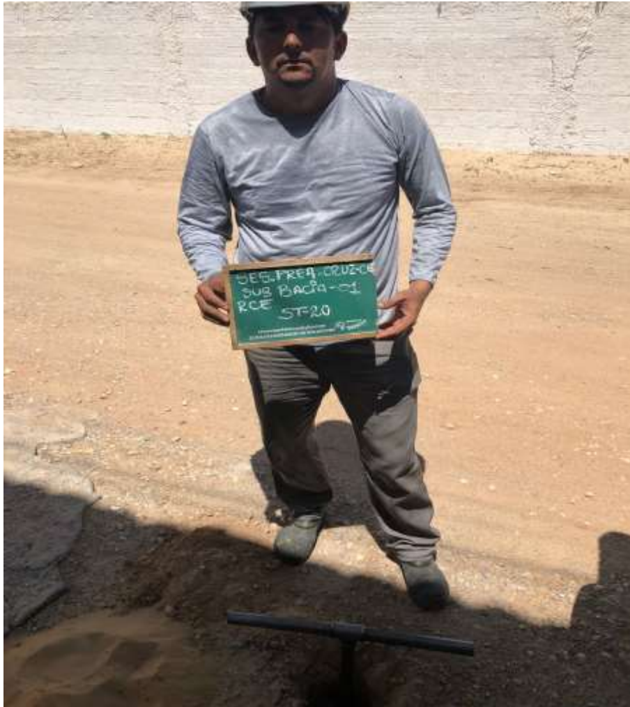
Instalação do furo ST-20
