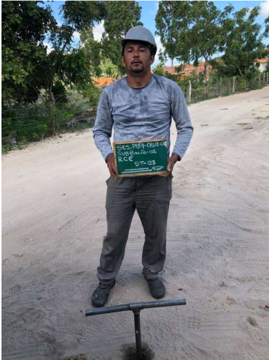
Instalação do furo ST-03
