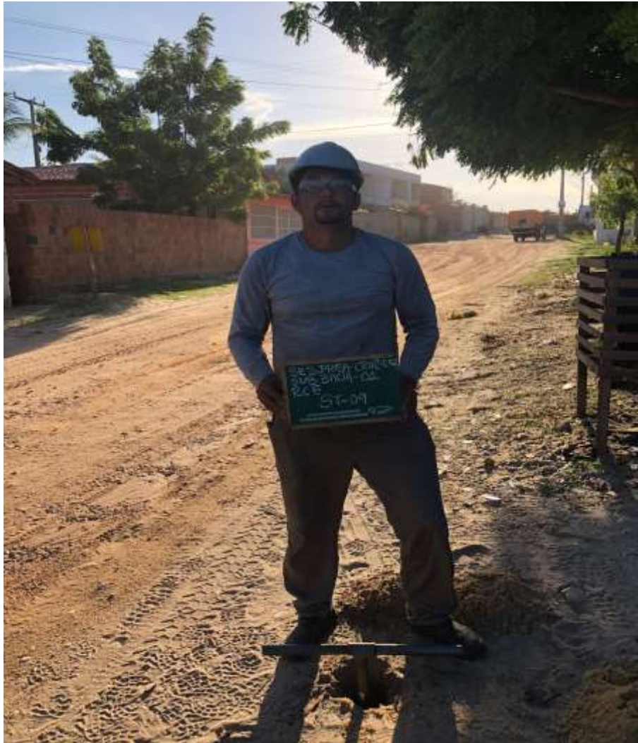
Instalação do furo ST-09
