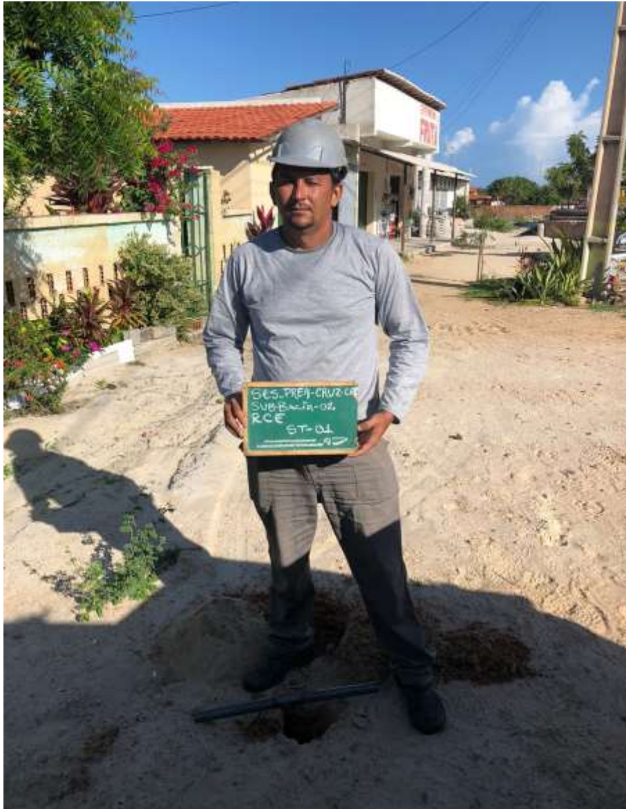
Instalação do furo ST-01
