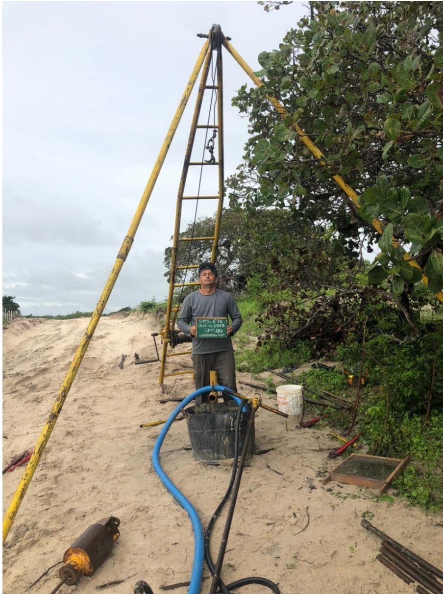
Instalação do furo SP-04
