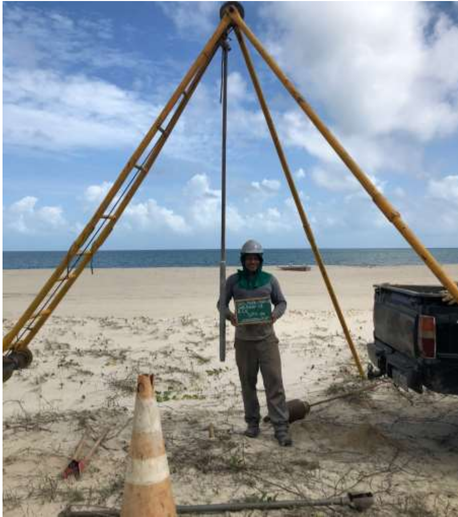
Instalação do furo SP-06
