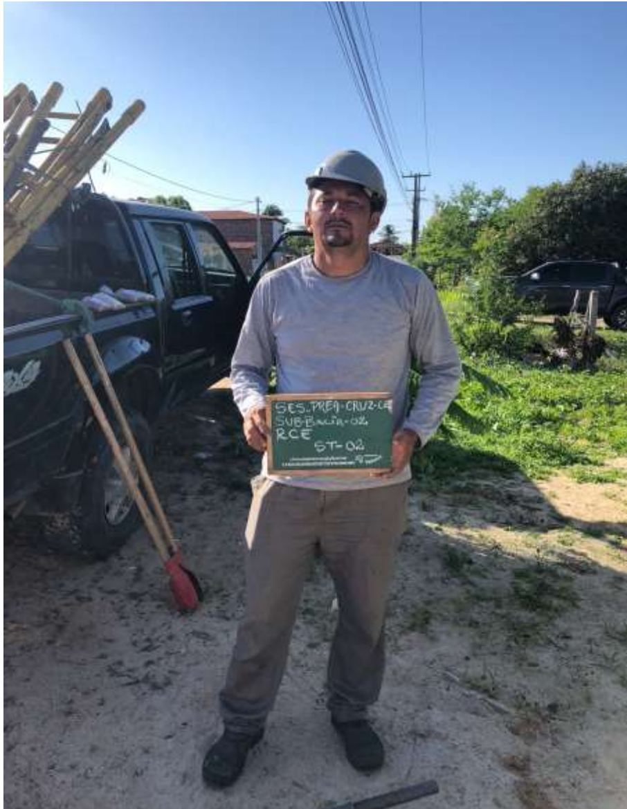
Instalação do furo ST-02
