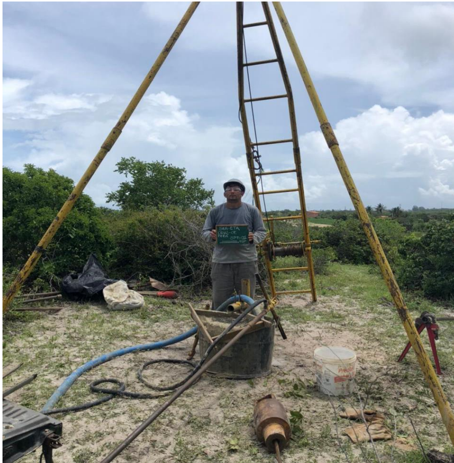
Instalação do furo SP-01
