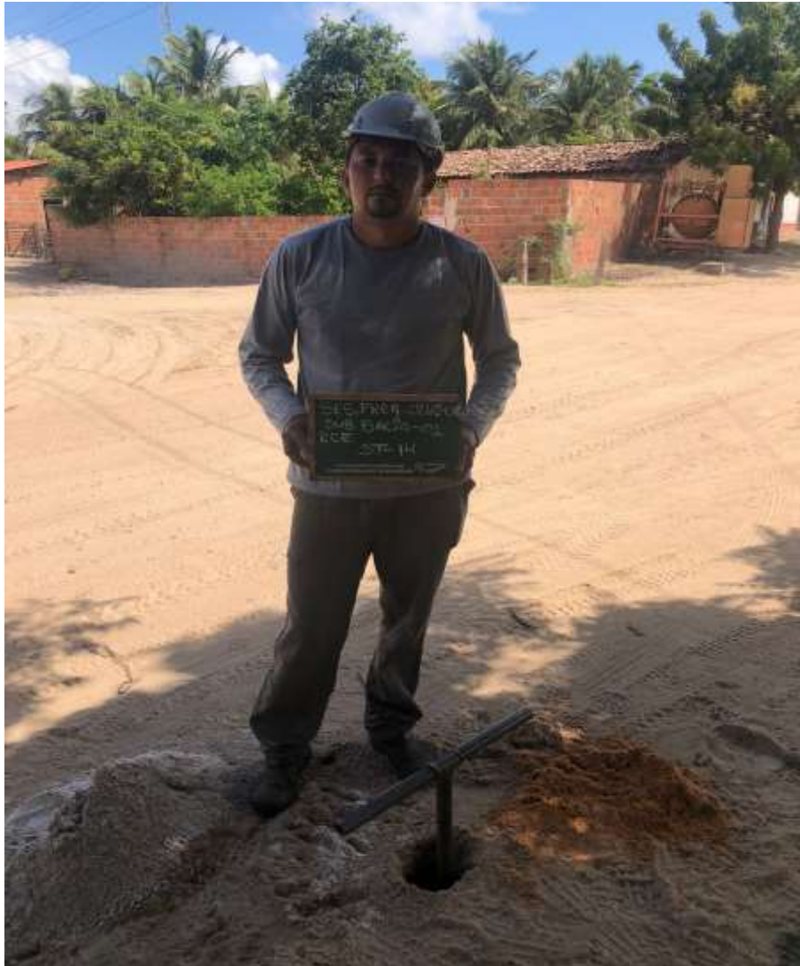
Instalação do furo ST-14
