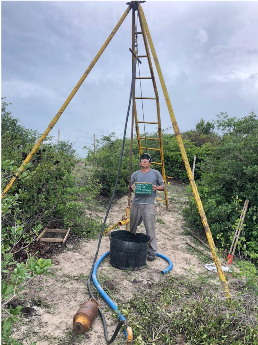
Instalação do furo SP-04
