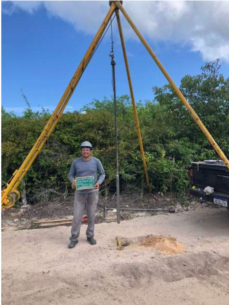
Instalação do furo SP-02
