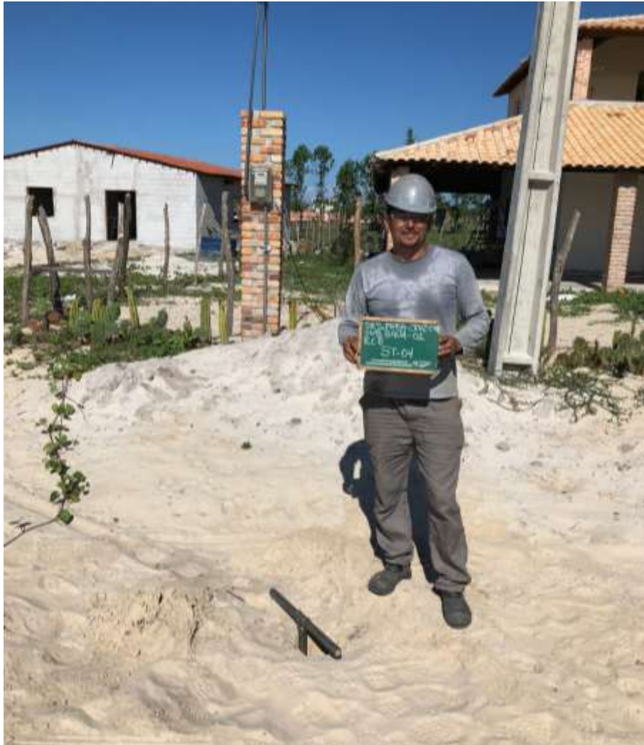
Instalação do furo ST-04
