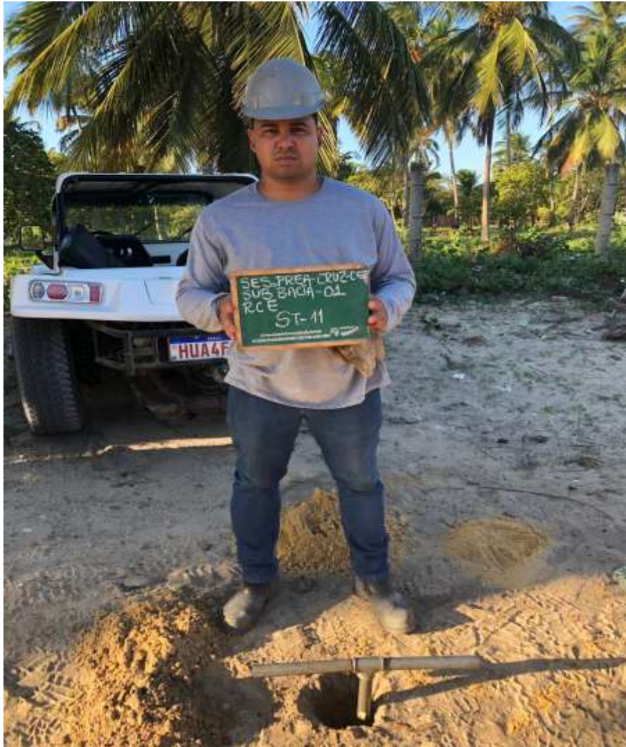
Instalação do furo ST-11
