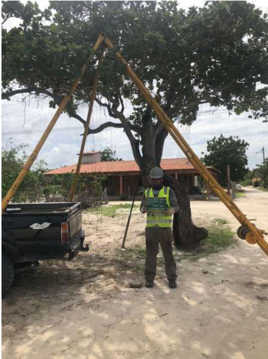
Instalação do furo SP-20
