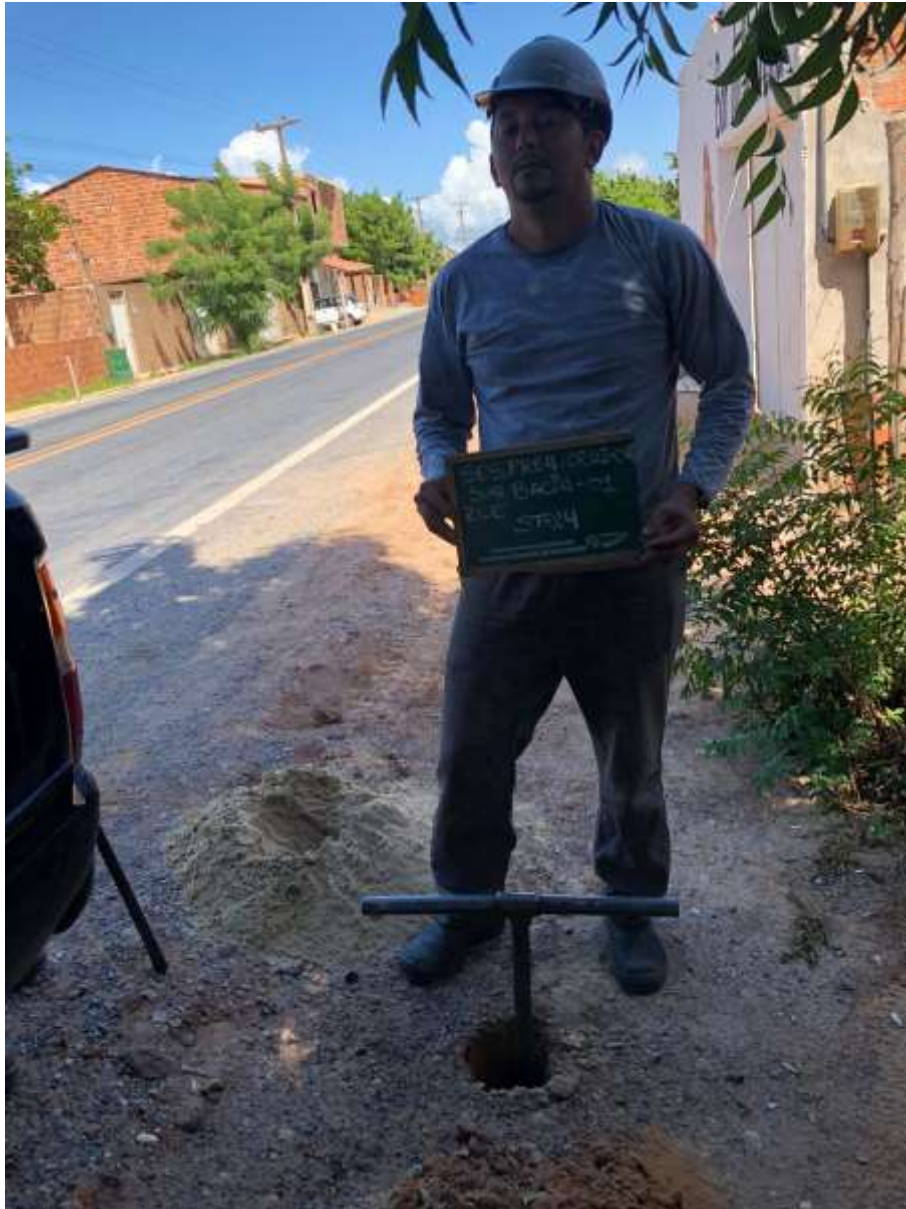
Instalação do furo ST-24
