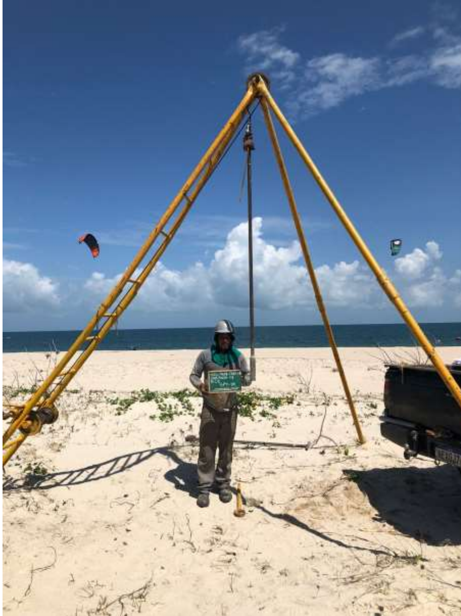
Instalação do furo SP-07
