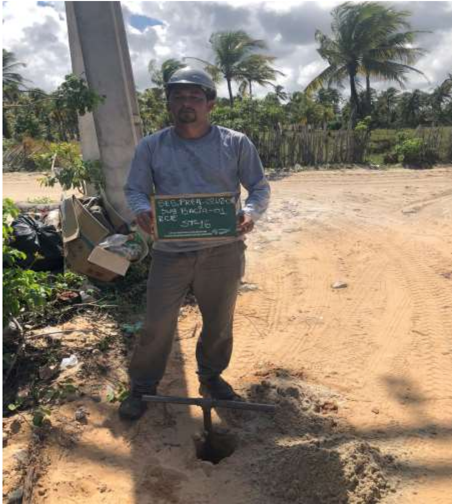
Instalação do furo ST-16
