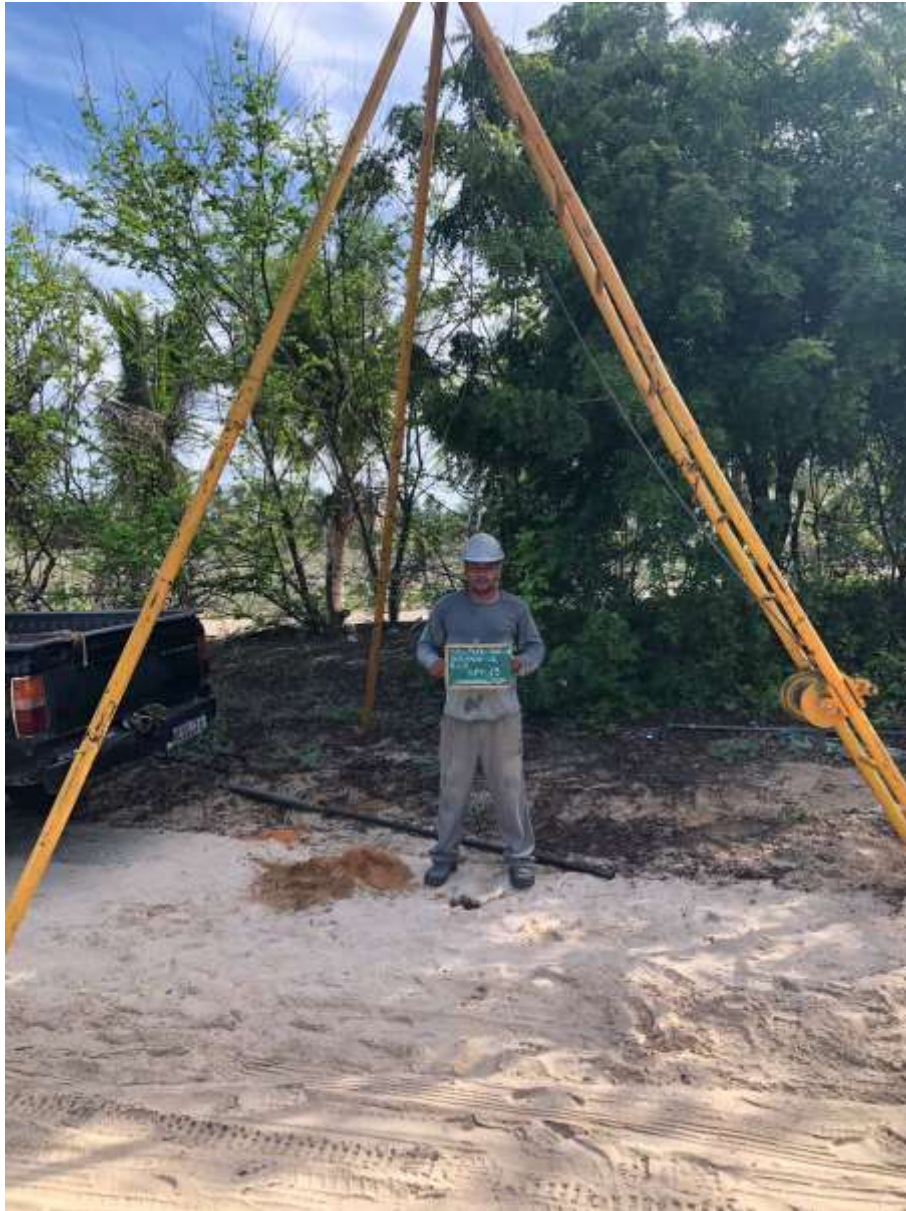
Instalação do furo SP-13
