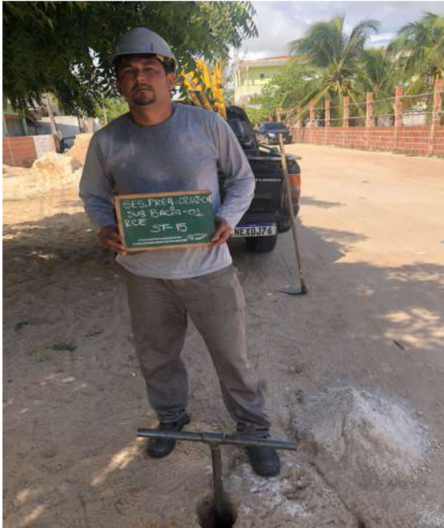
Instalação do furo ST-15
