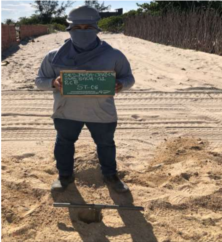
Instalação do furo ST-06
