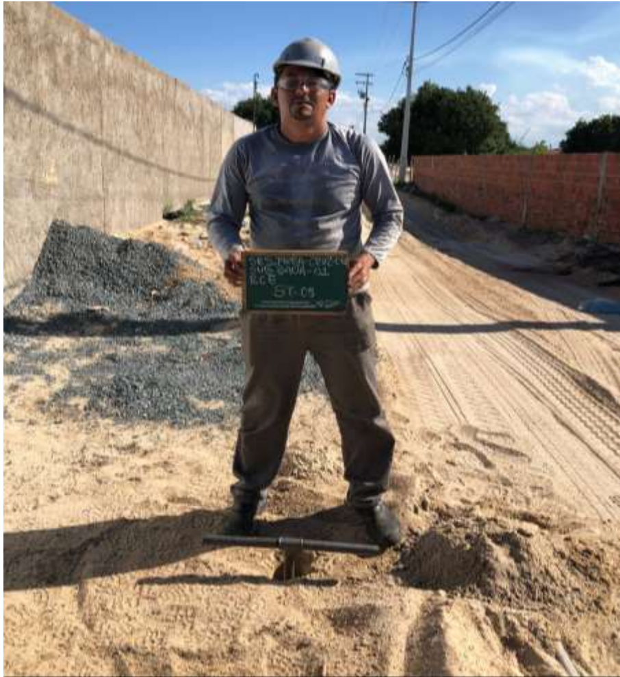
Instalação do furo ST-05
