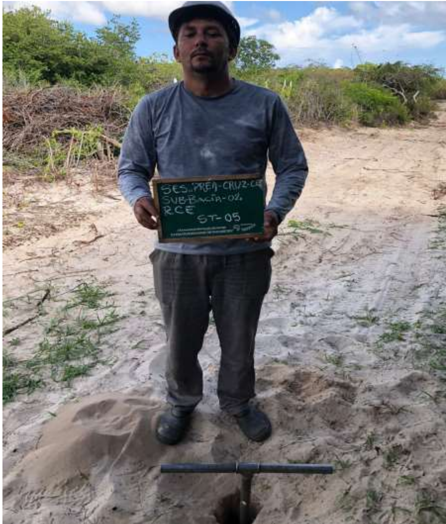
Instalação do furo ST-05
