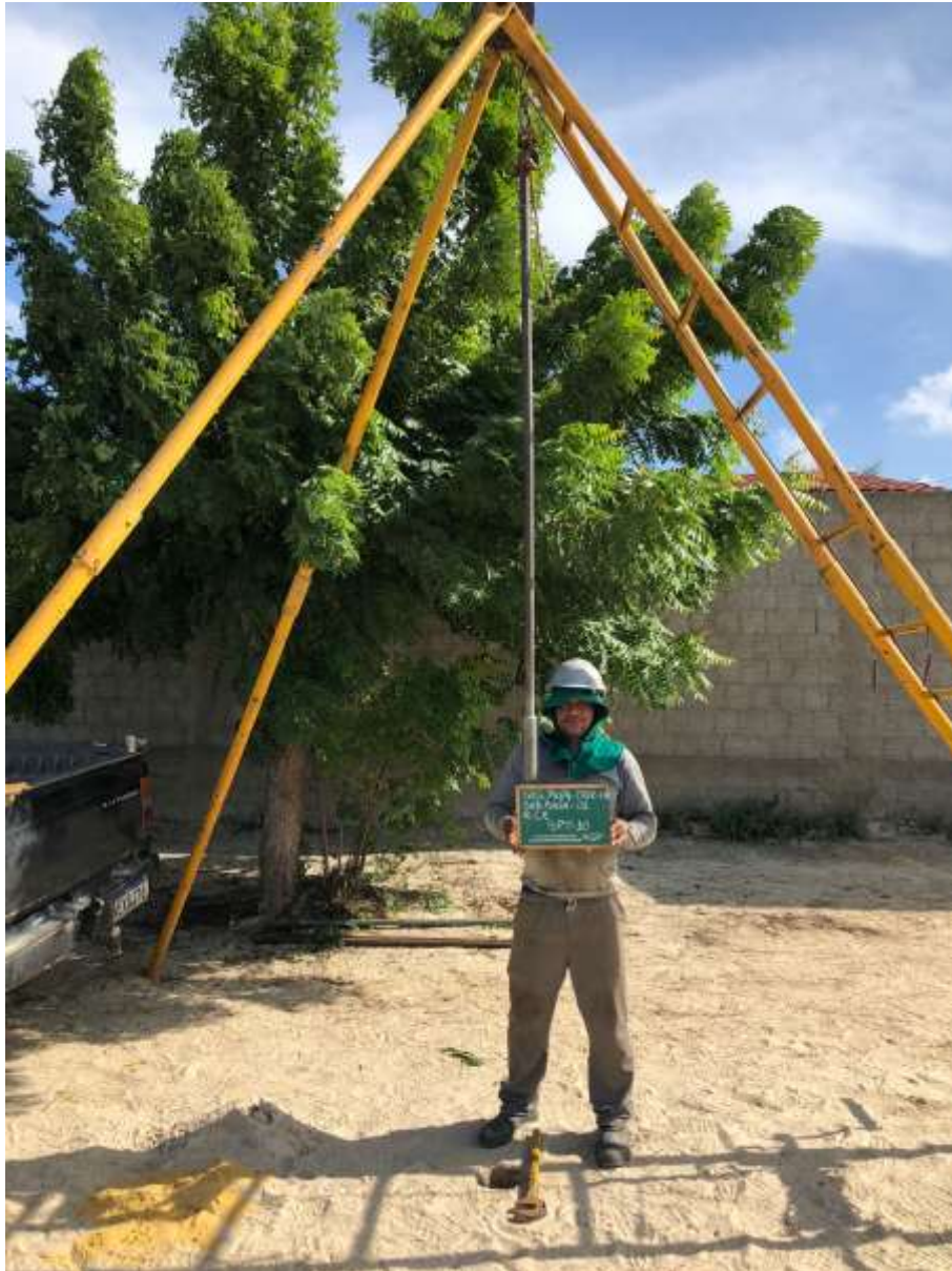
Instalação do furo SP-10
