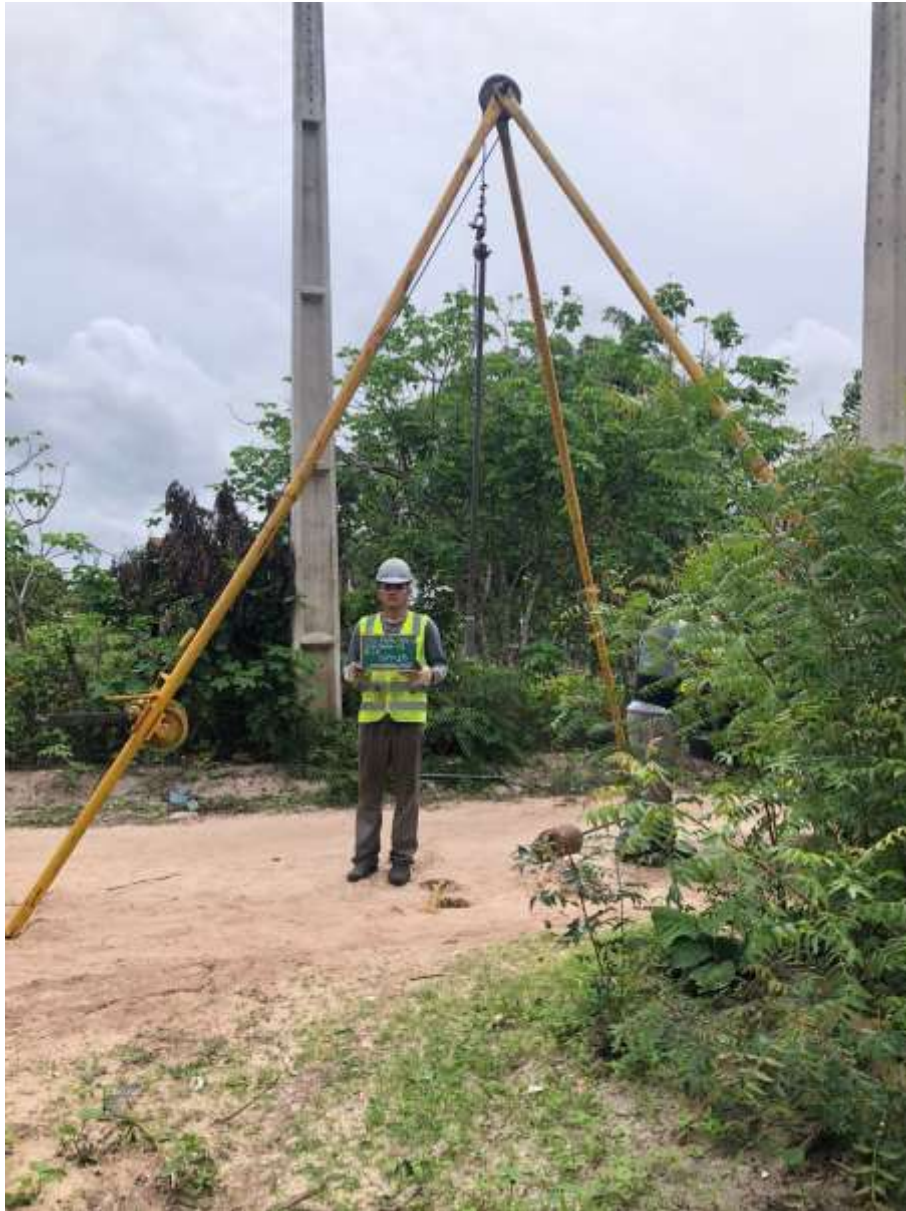
Instalação do furo SP-18
