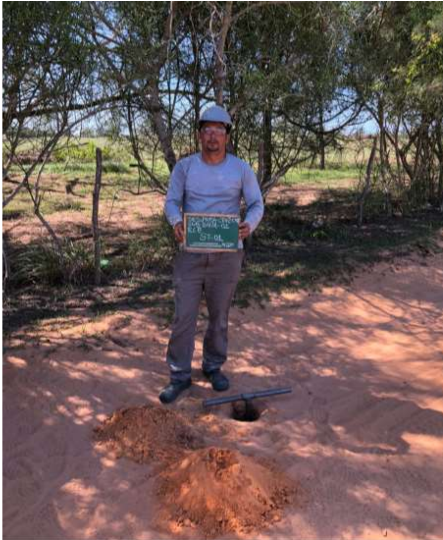
Instalação do furo ST-01
