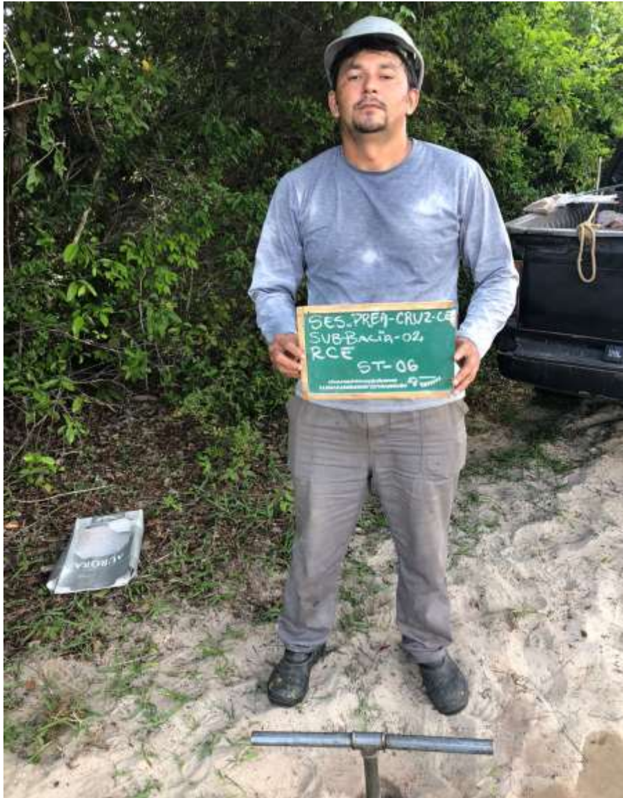
Instalação do furo ST-06
