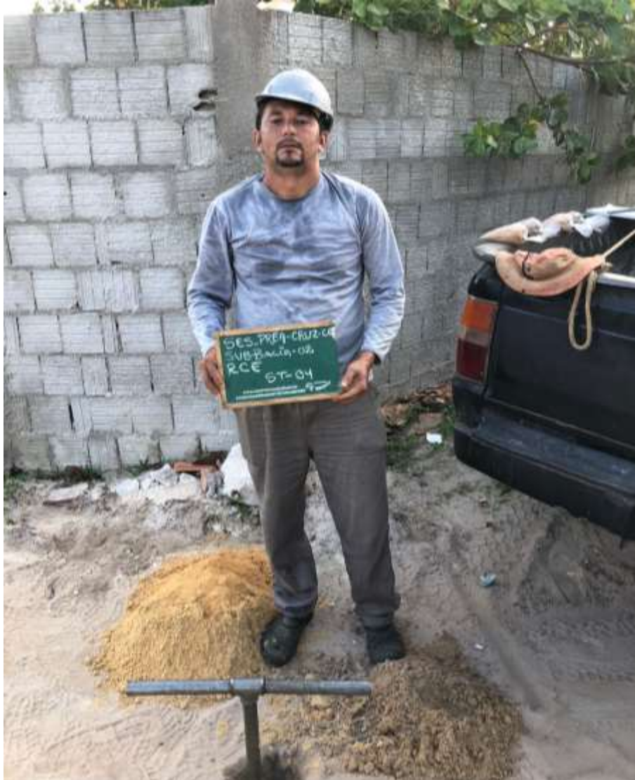
Instalação do furo ST-04
