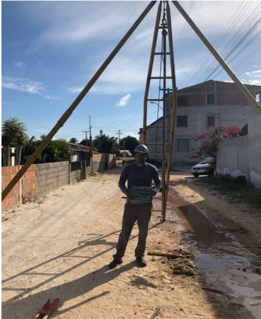
Instalação do furo SP-01
