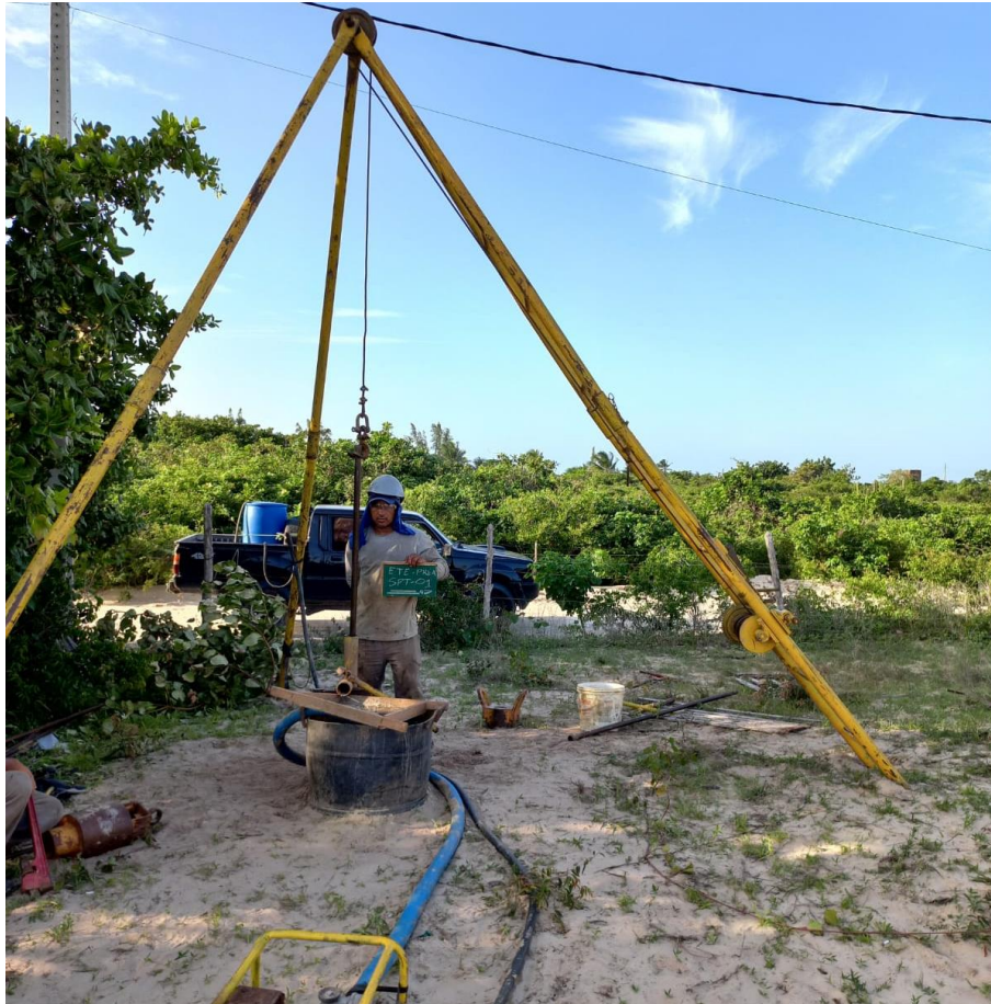
Instalação do furo SP-01
