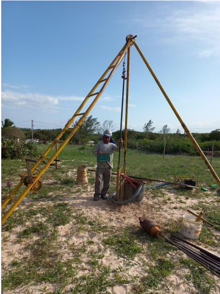
Instalação do furo SP-02
