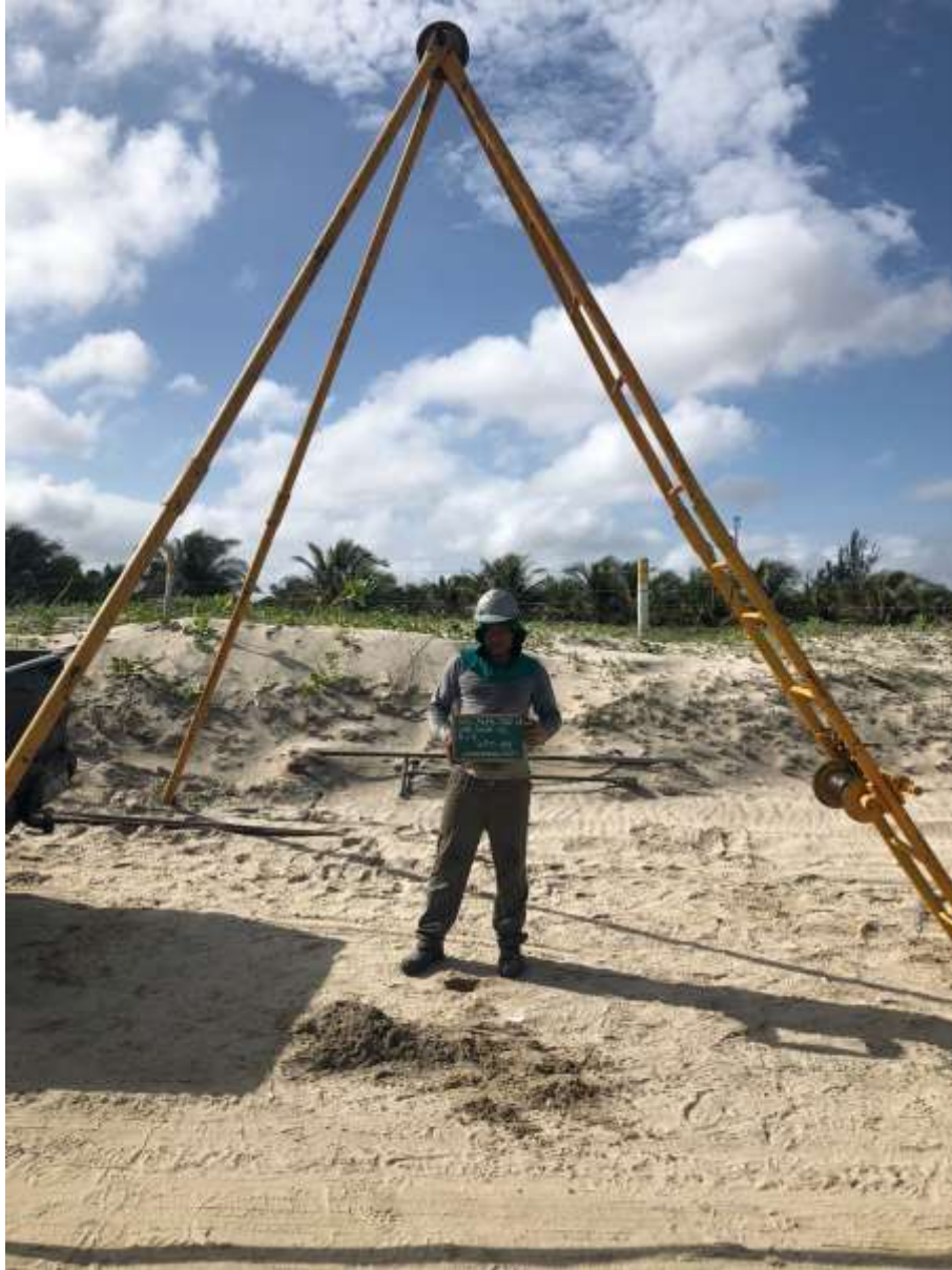
Instalação do furo SP-05
