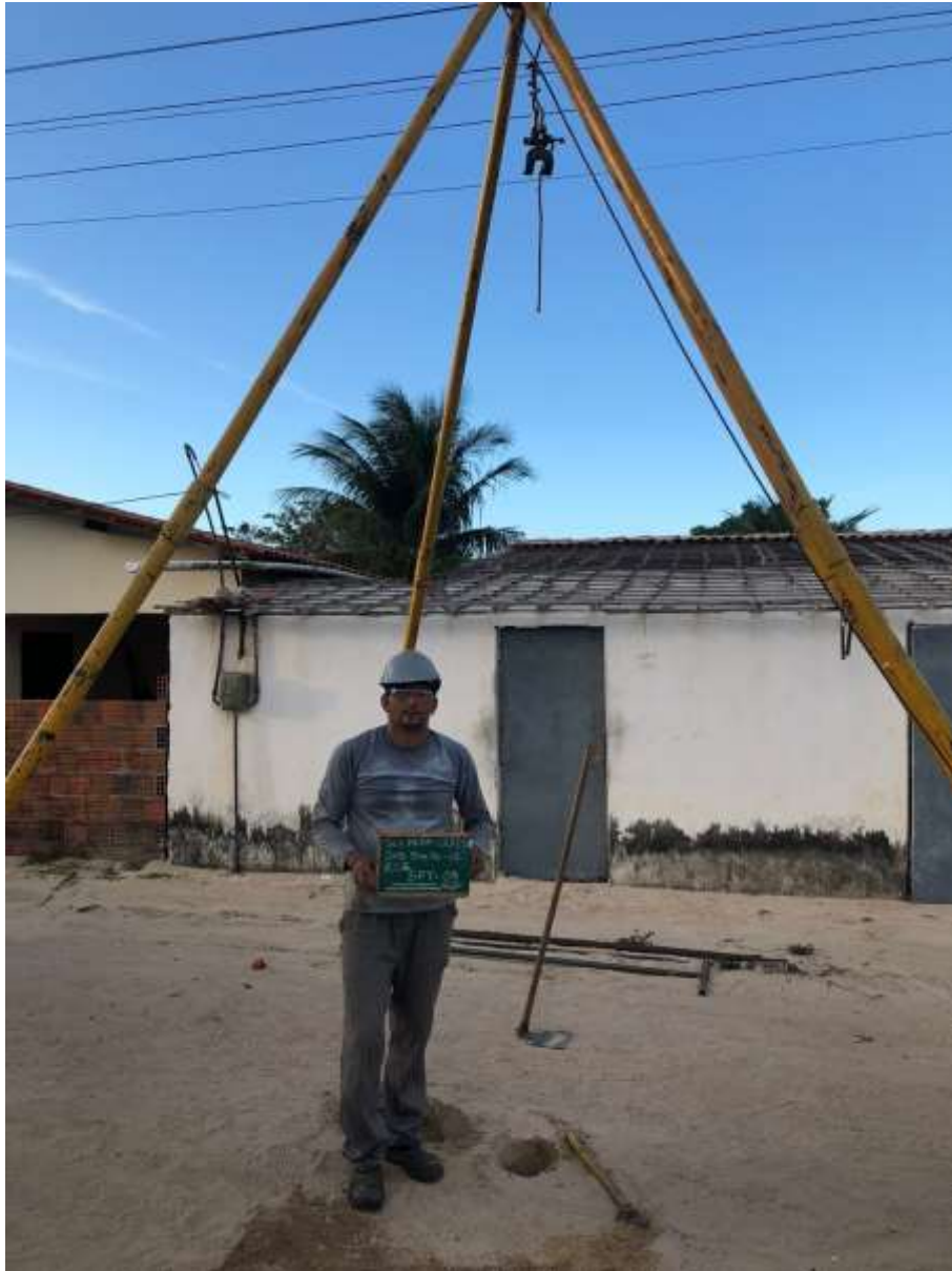
Instalação do furo SP-09
