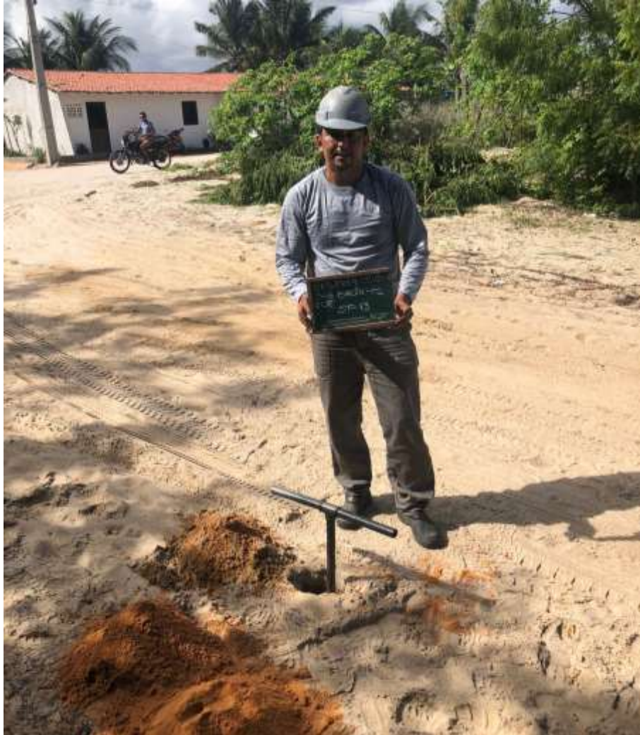
Instalação do furo ST-13
