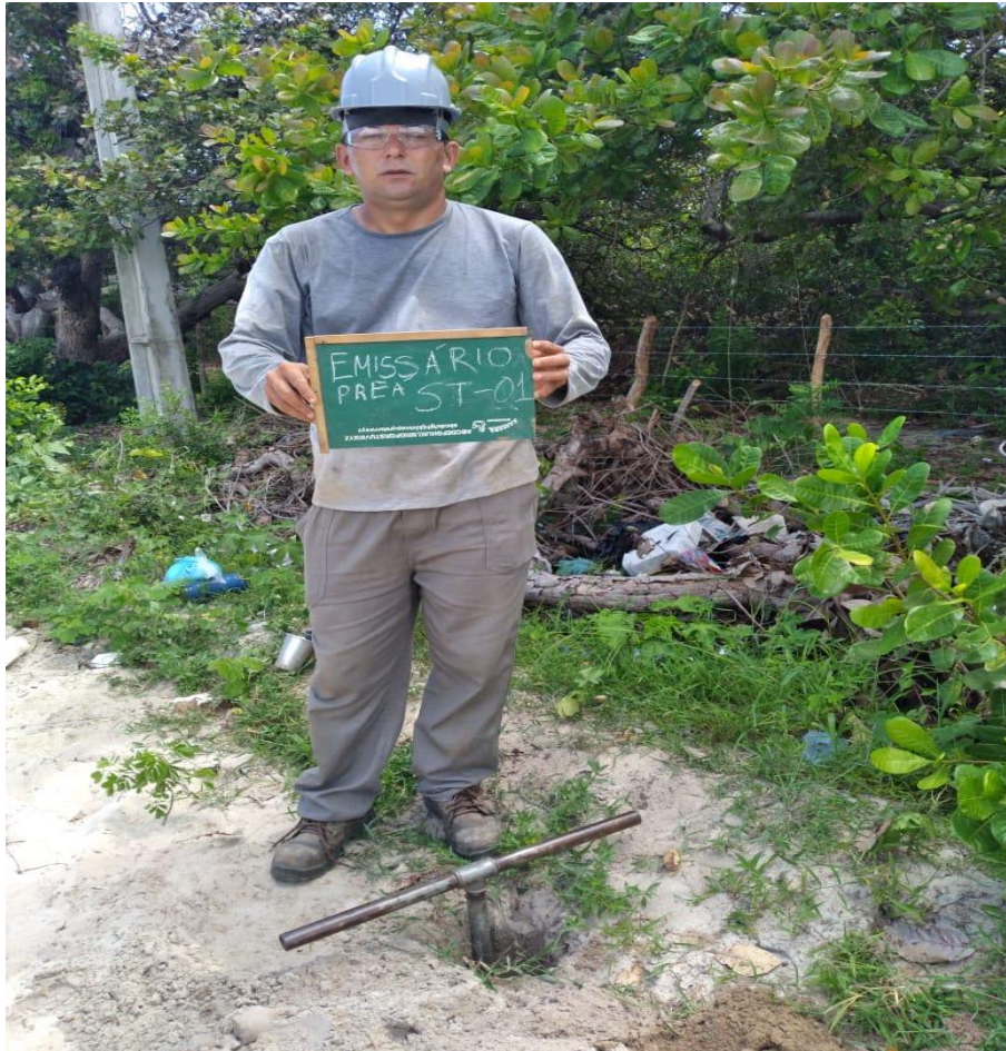
Instalação do furo ST-01
