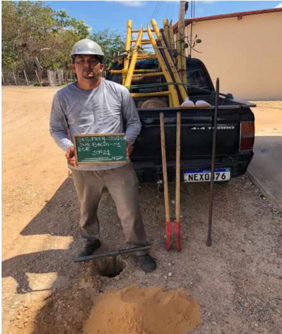
Instalação do furo ST-21
