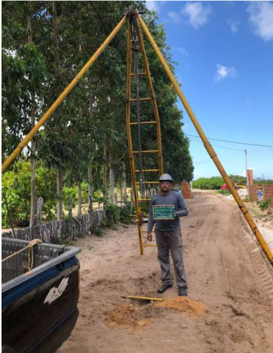
Instalação do furo SP-03
