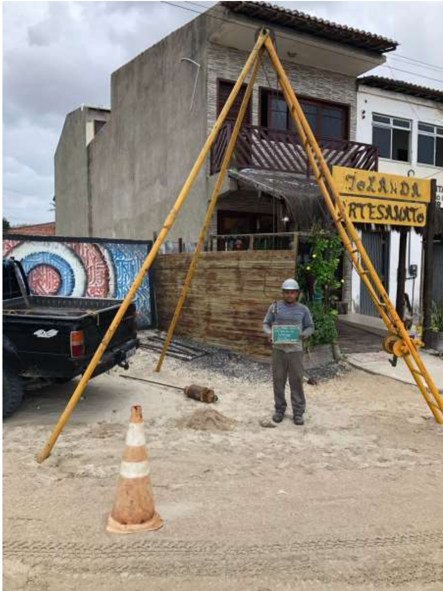
Instalação do furo SP-03
