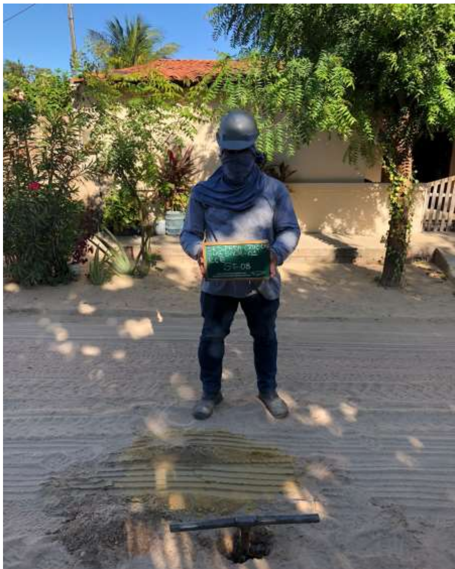
Instalação do furo ST-08
