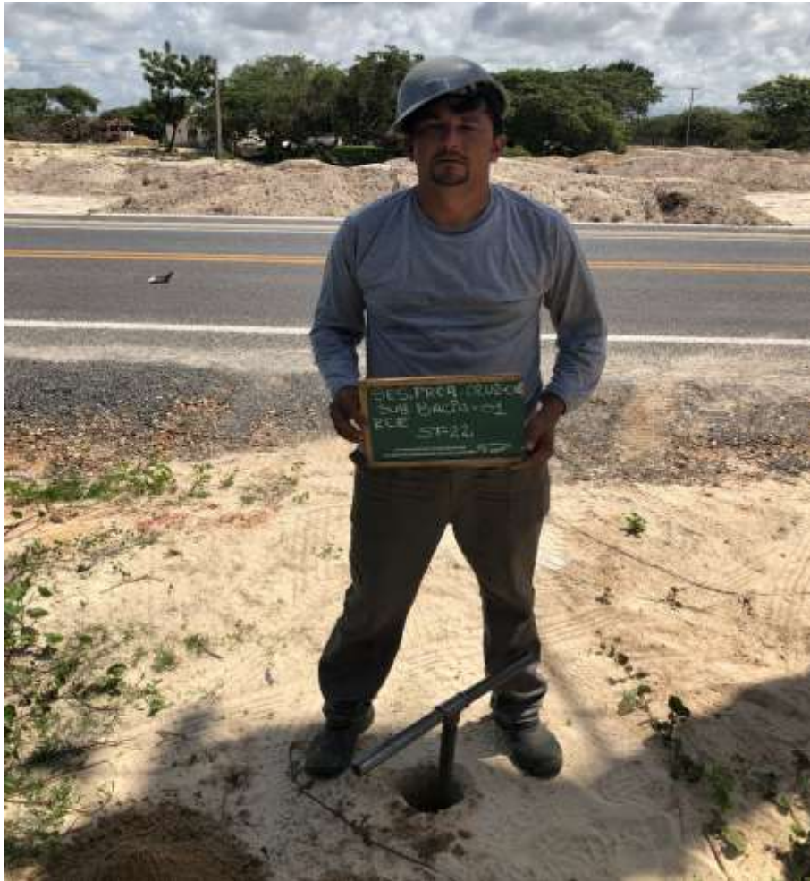
Instalação do furo ST-22
