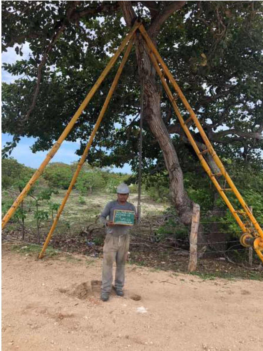
Instalação do furo SP-22
