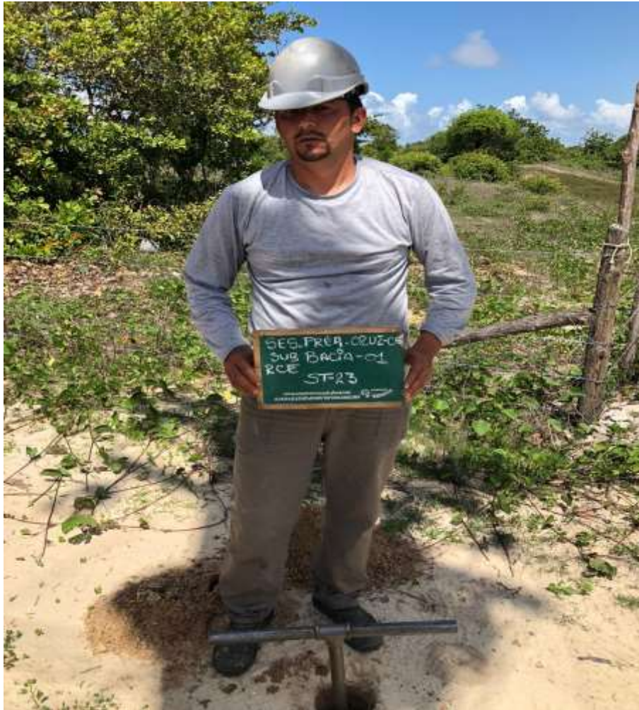
Instalação do furo ST-23
