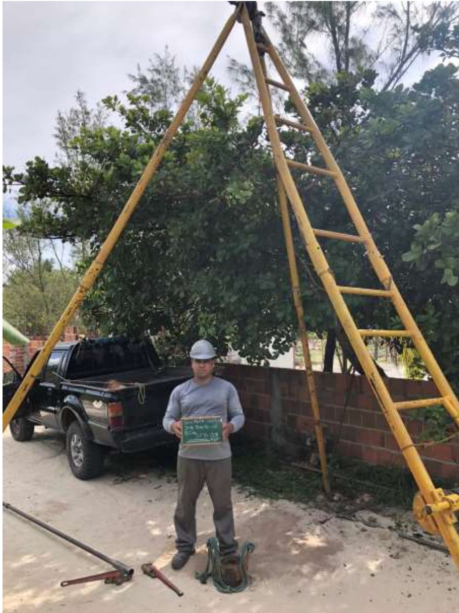
Instalação do furo SP-07
