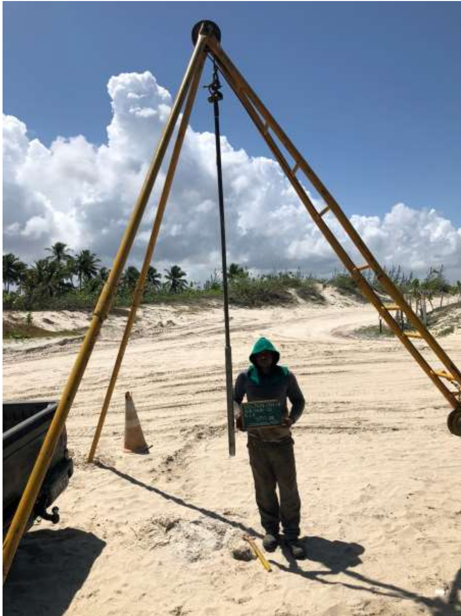
Instalação do furo SP-08
