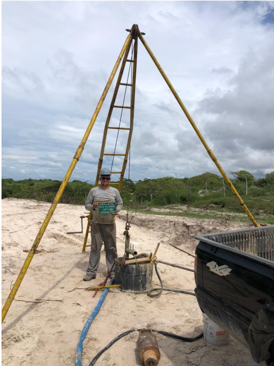
Instalação do furo SP-05
