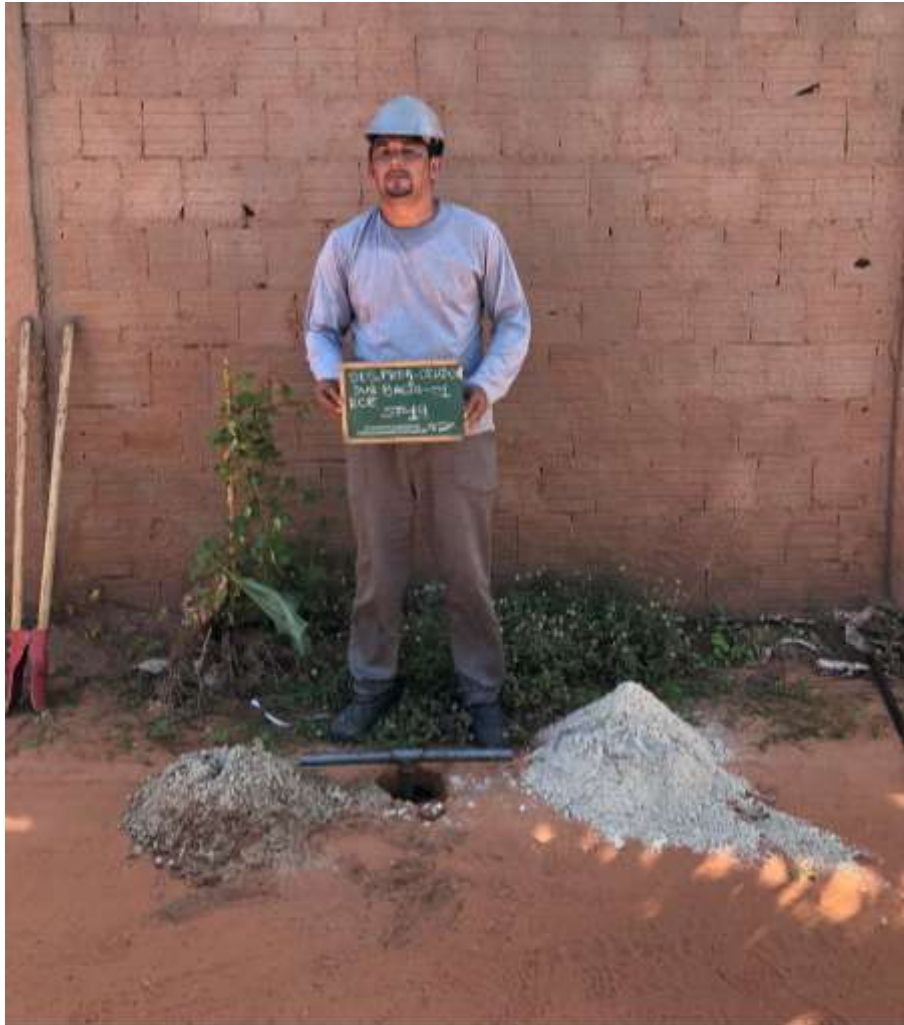
Instalação do furo ST-19
