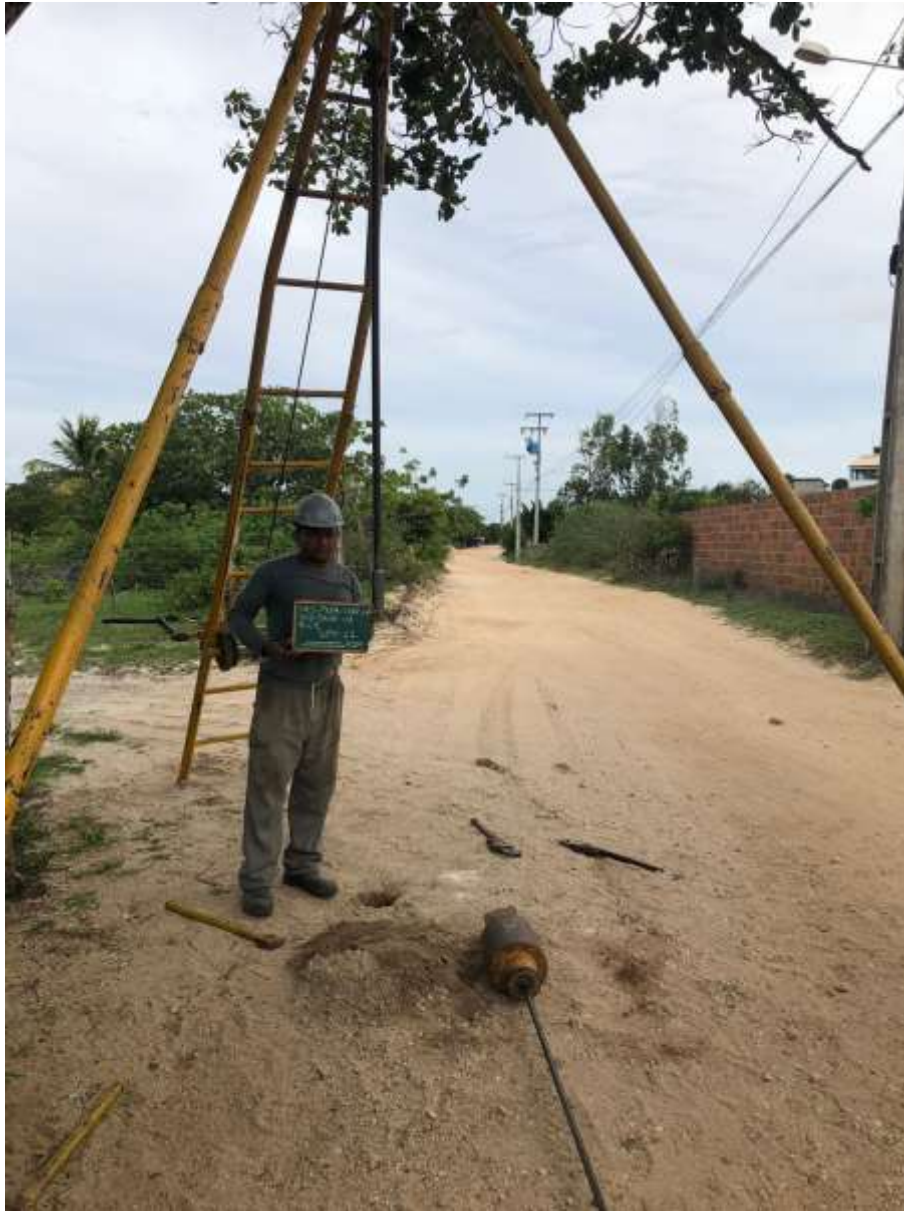
Instalação do furo SP-21
