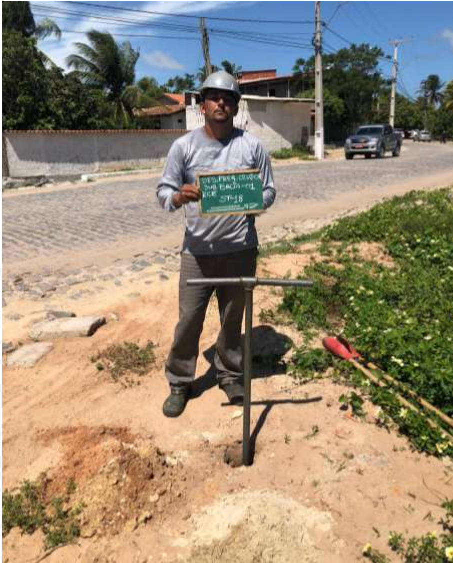
Instalação do furo ST-18
