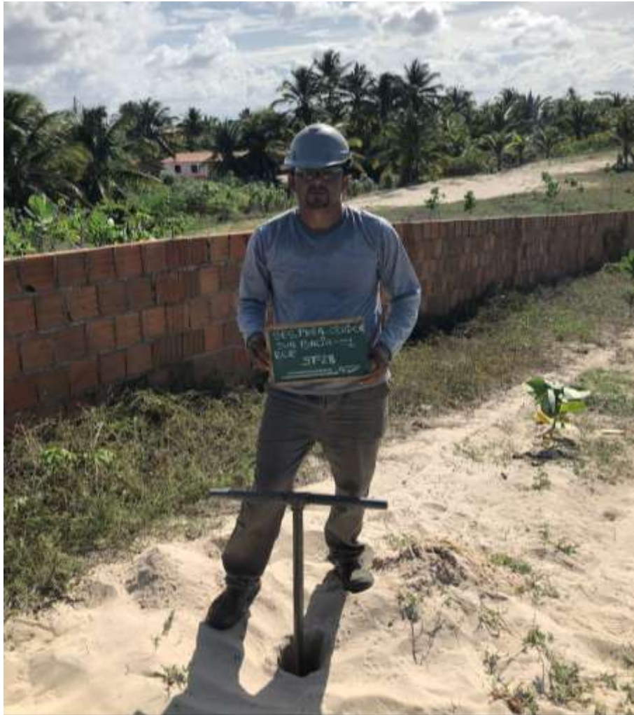
Instalação do furo ST-28
