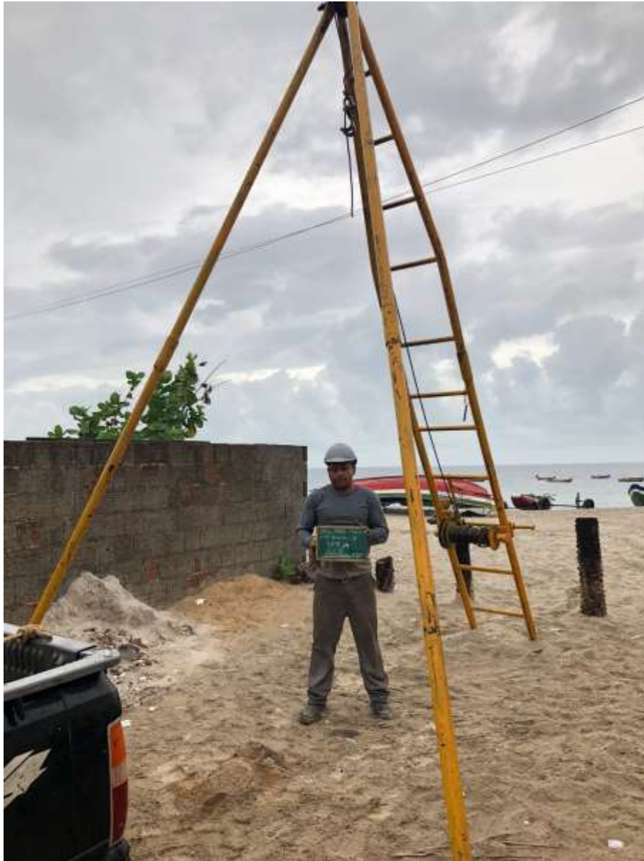
Instalação do furo SP-04
