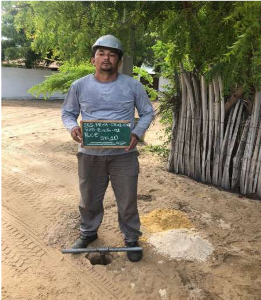
Instalação do furo ST-10
