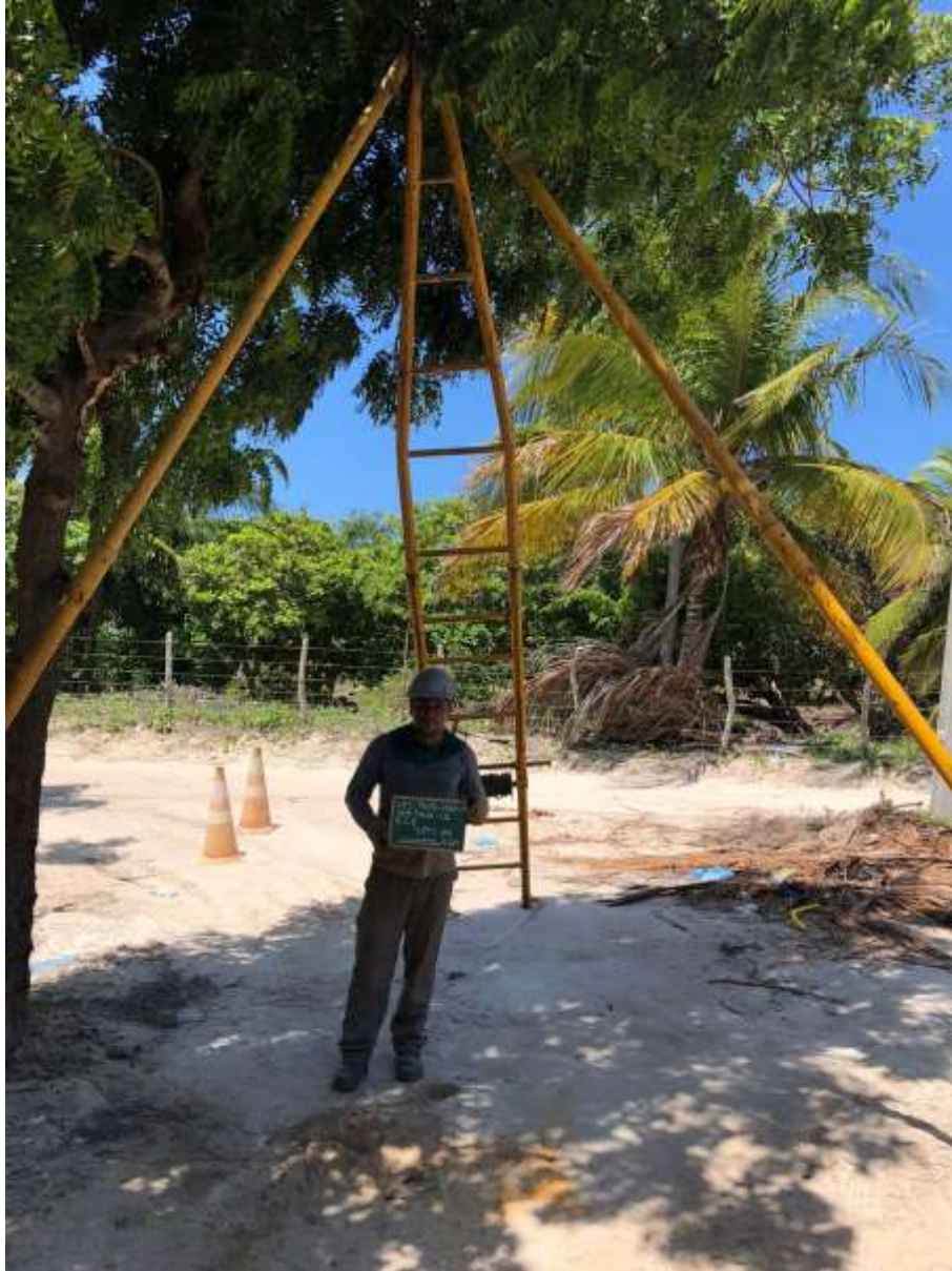
Instalação do furo SP-09
