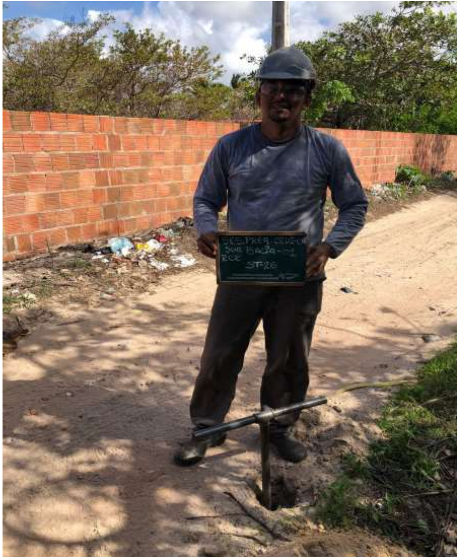
Instalação do furo ST-26
