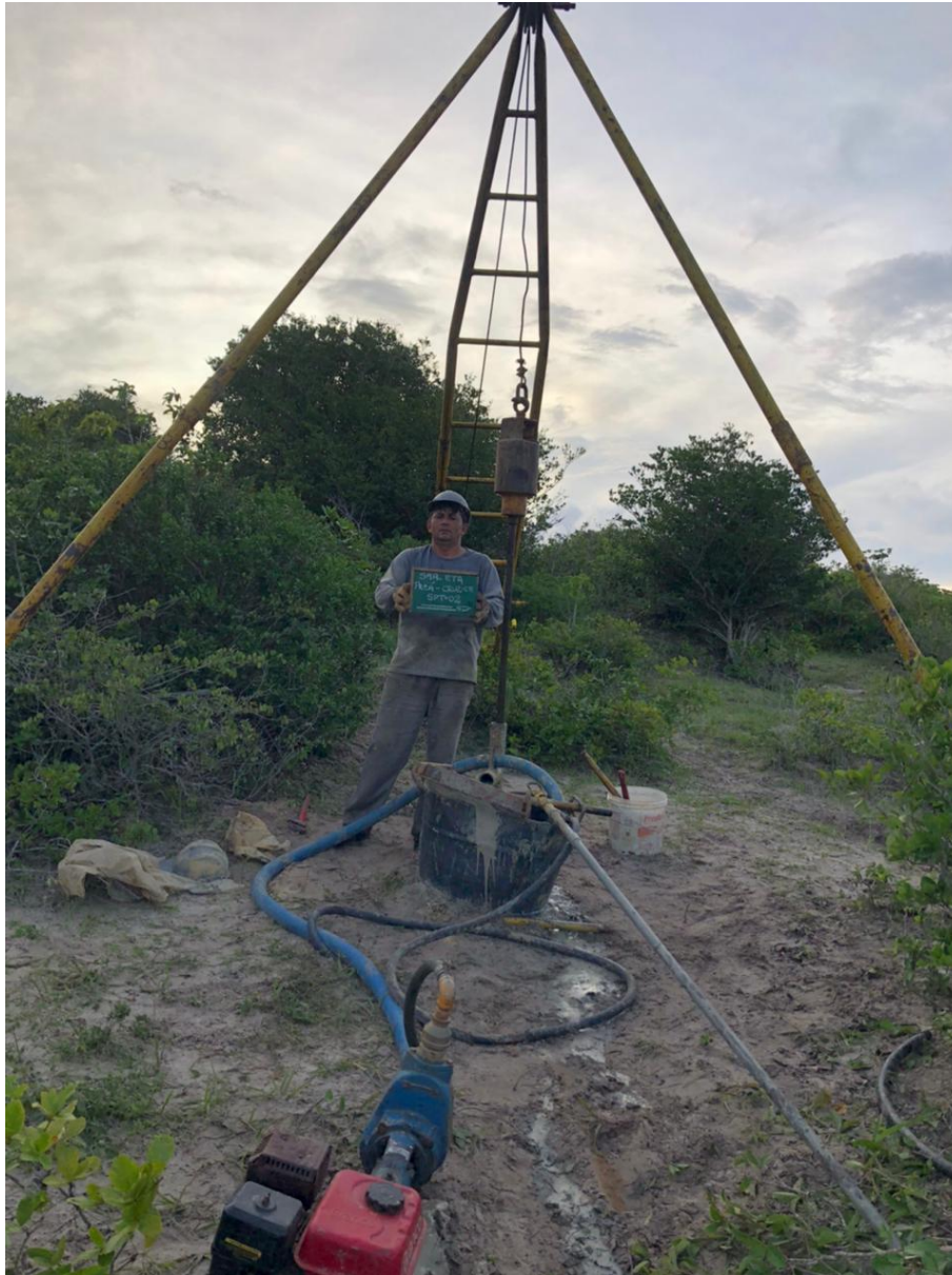
Instalação do furo SP-02
