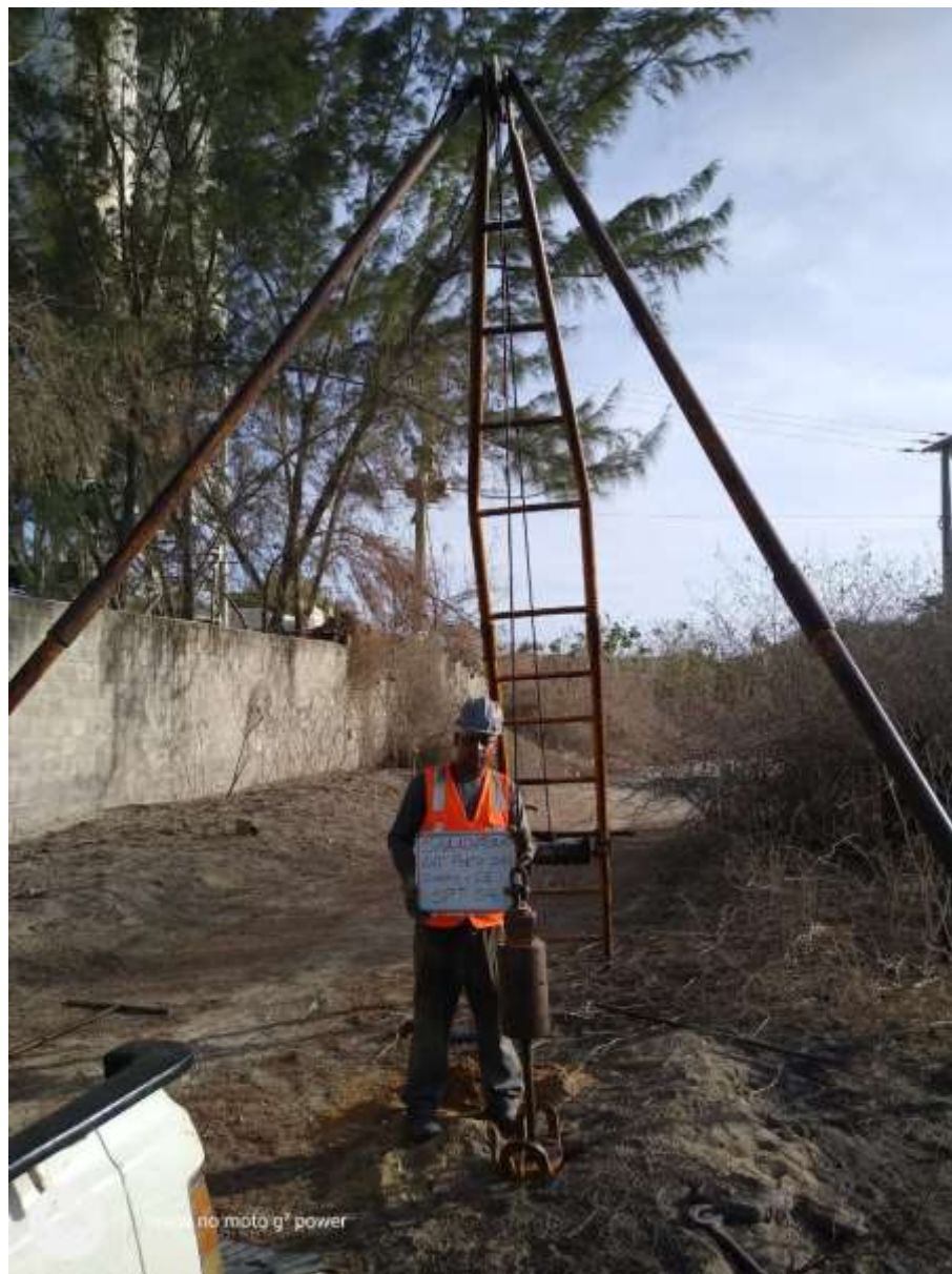
Instalação do furo SP-04
