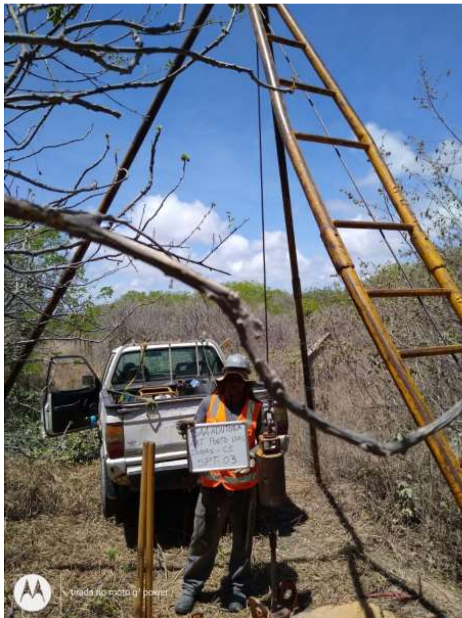
Instalação do furo SP-03
