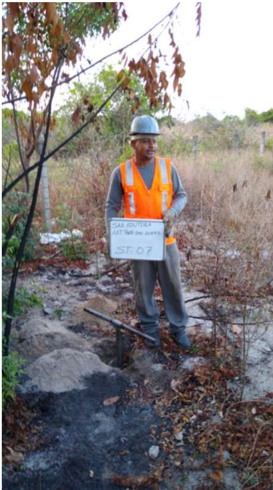
Instalação do furo ST-07
