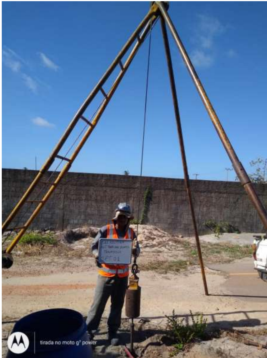
Instalação do furo SP-01
