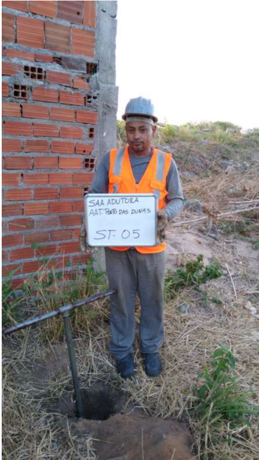
Instalação do furo ST-05
