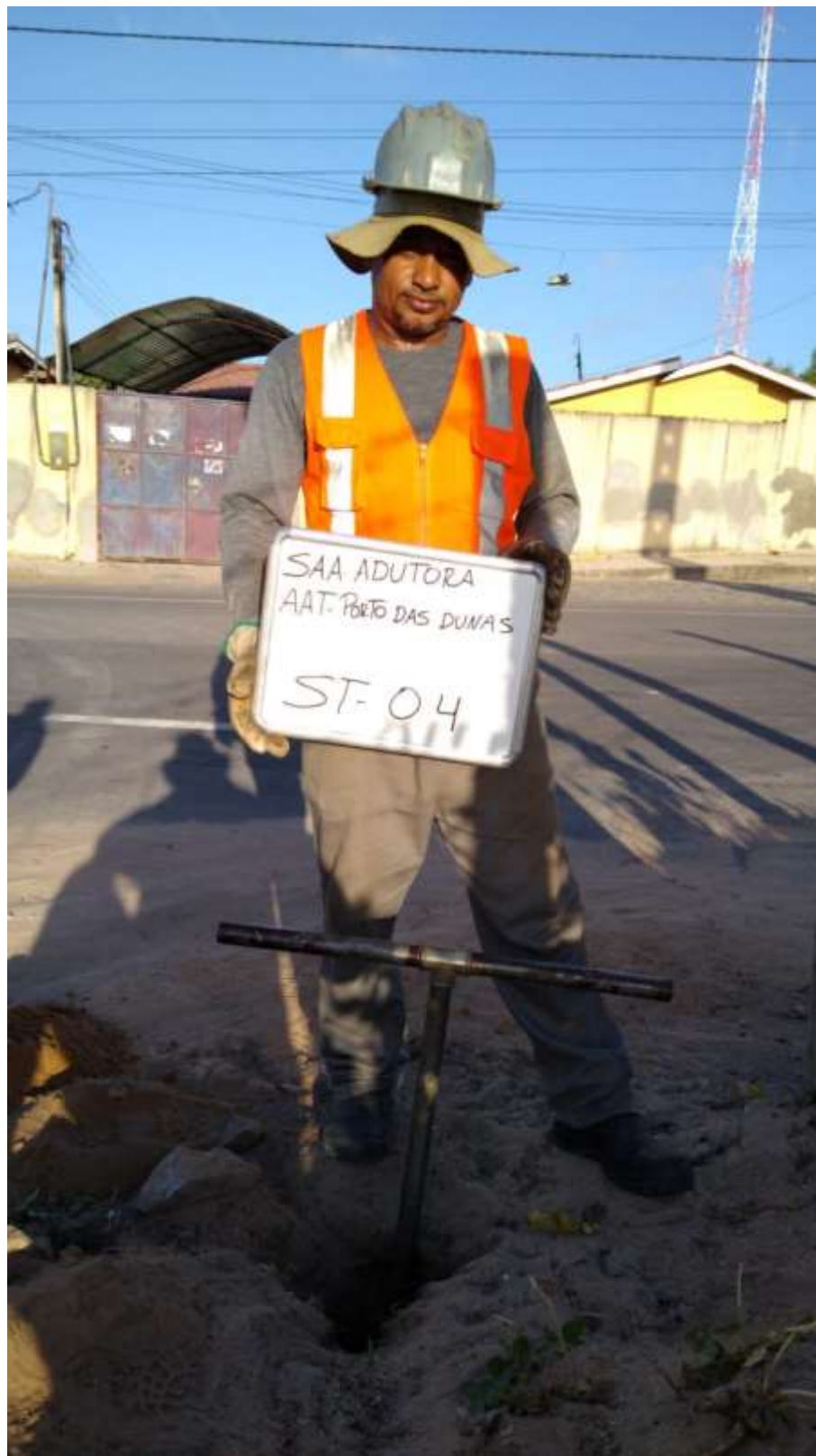
Instalação do furo ST-04
