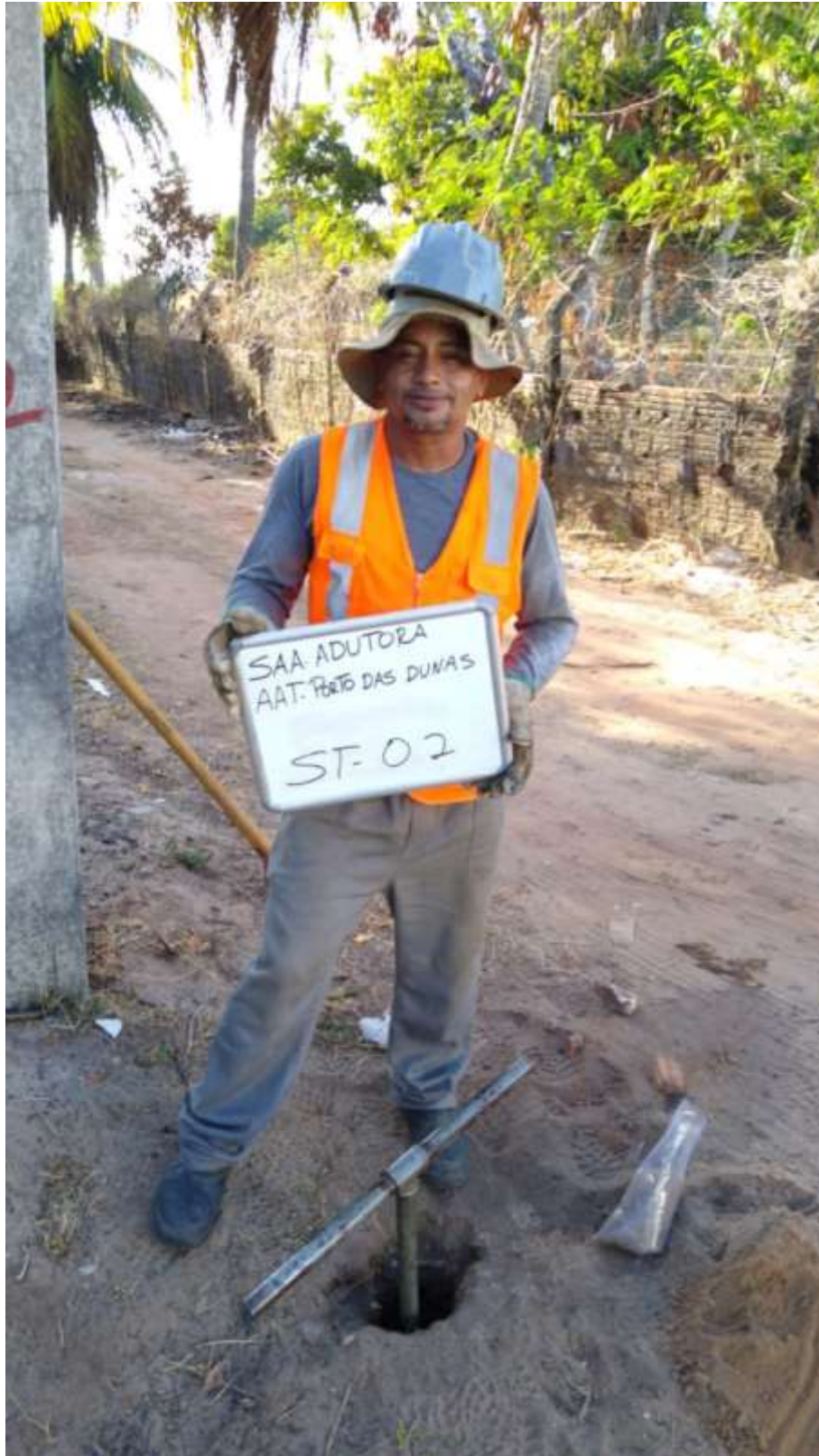
Instalação do furo ST-02
