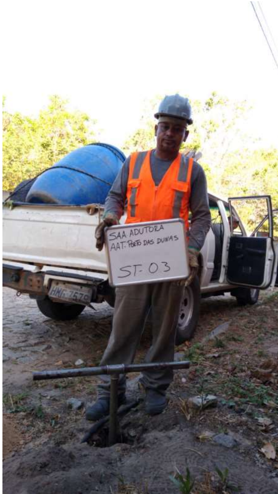
Instalação do furo ST-03
