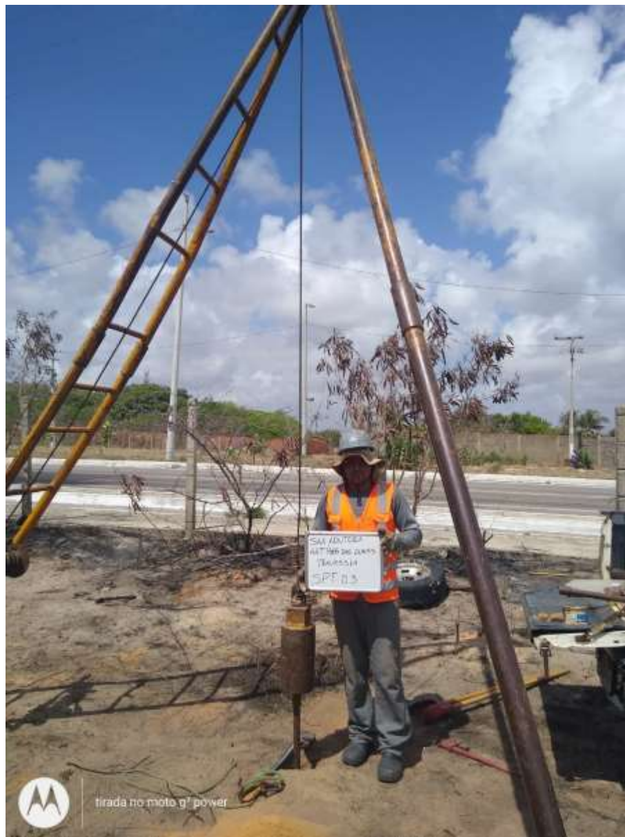
Instalação do furo SP-03
