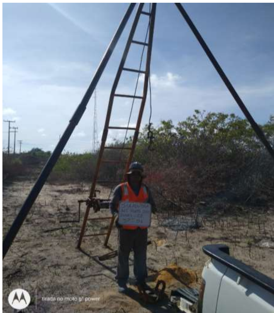
Instalação do furo SP-01
