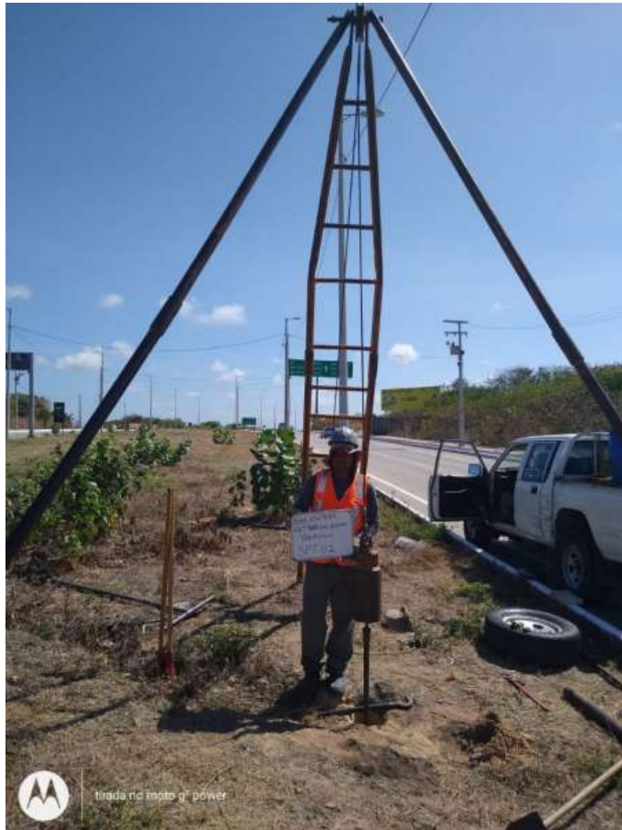
Instalação do furo SP-02
