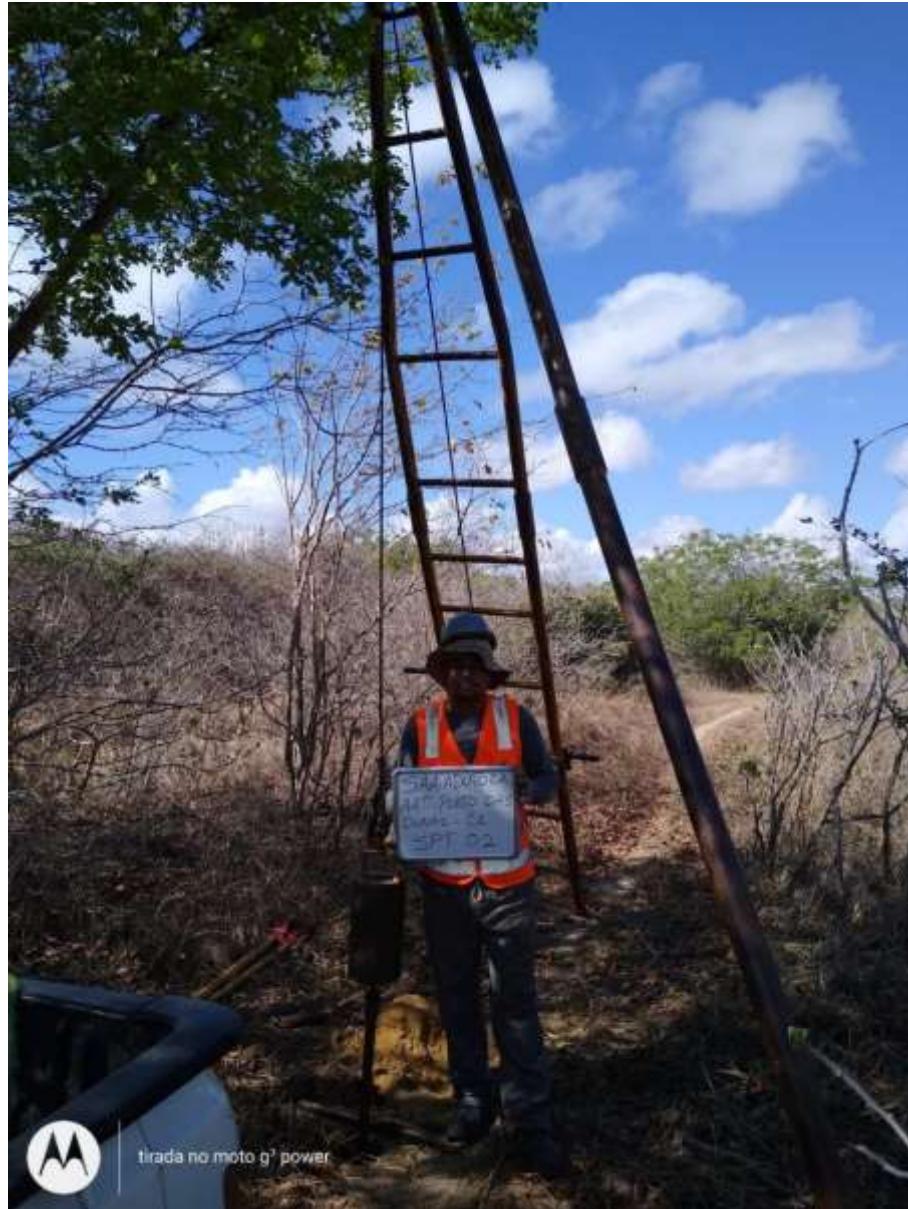
Instalação do furo SP-02
