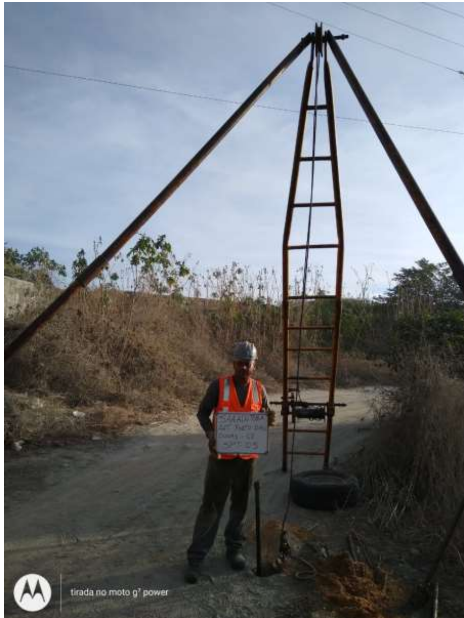
Instalação do furo SP-05
