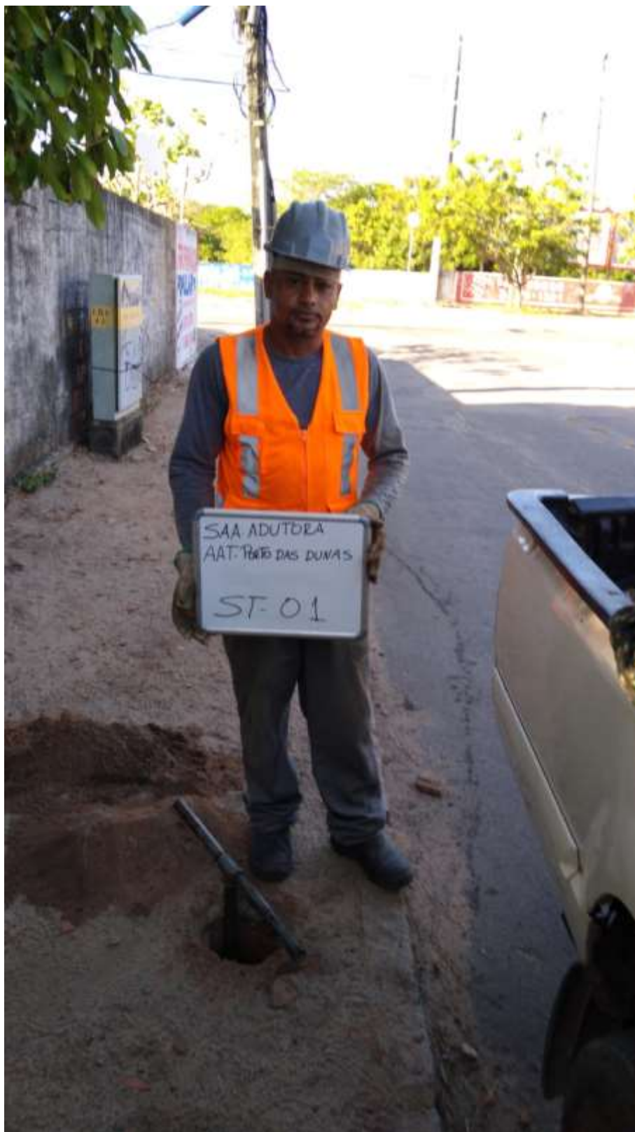
Instalação do furo ST-01
