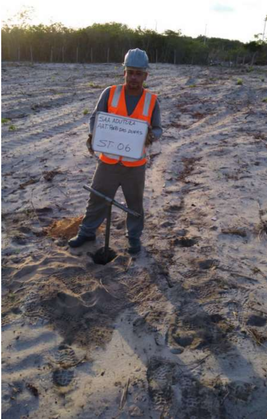
Instalação do furo ST-06
