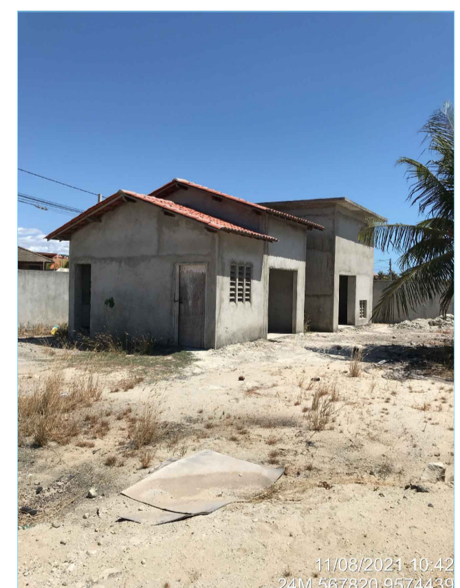
FOTO 1. CASA DO GERADOR E SUBESTAÇÃO
