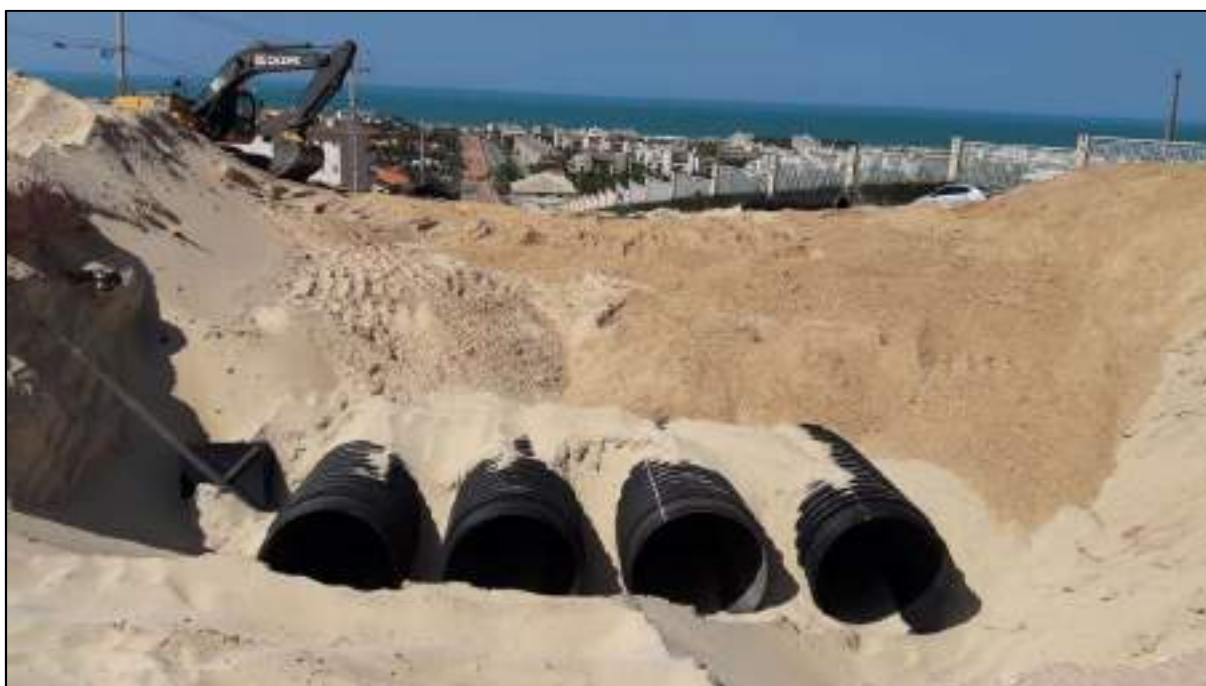
Foto 2. Tubos camisa das cinco travessias previstas sob a rotatória da CE-025. Mais à esquerda, observa-se o tamponamento do tubo DN600, ao lado das quatro tubulações DN1500.
