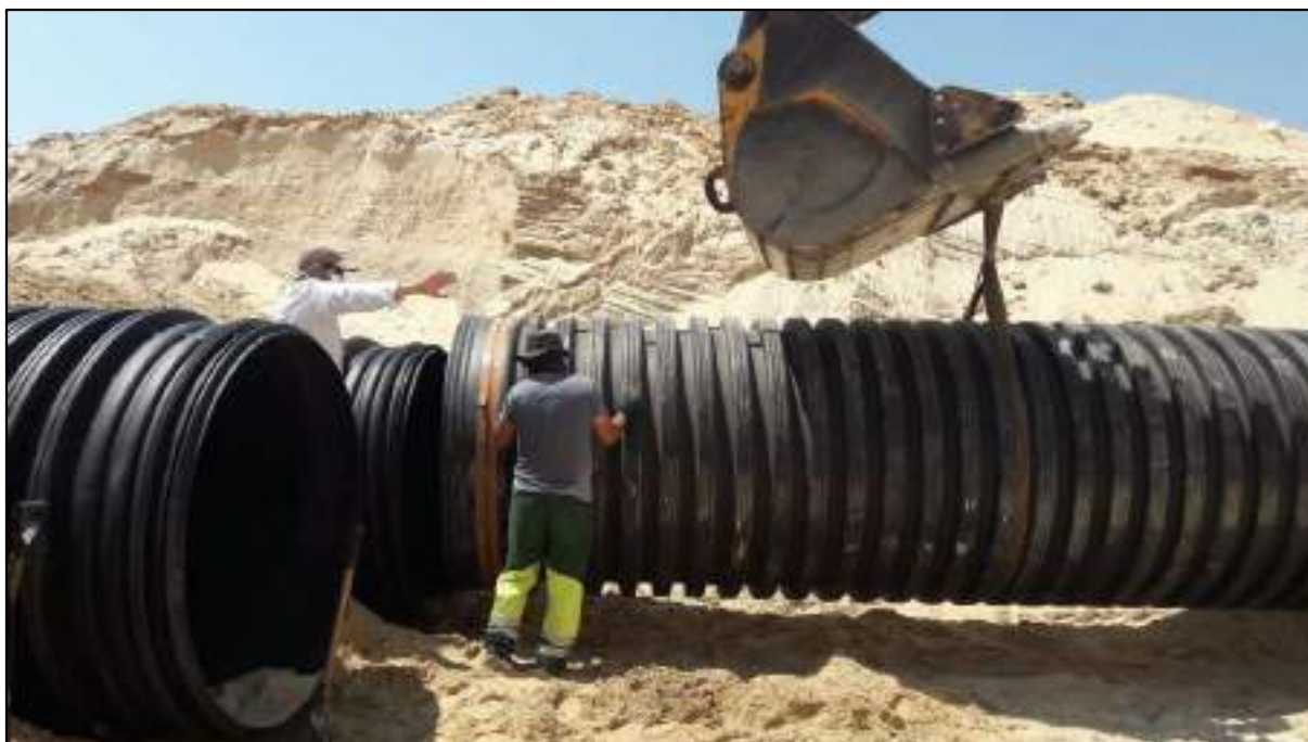
Foto 1. Assentamento tubo corrugado DN1500mm
