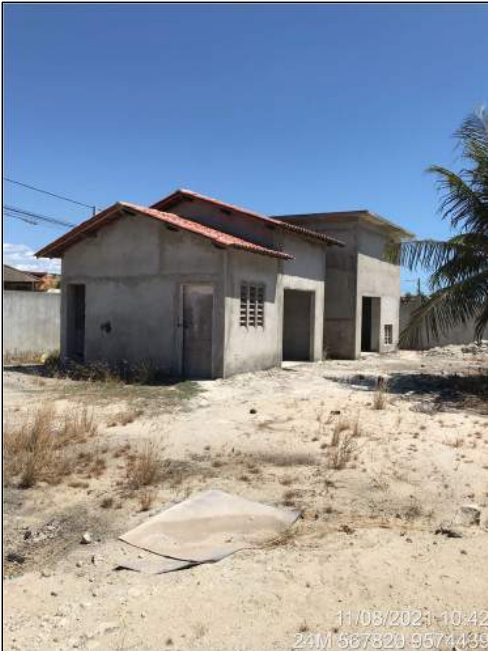
Foto 4.2. Casa da Subestação e Casa de Gerador, EEE - PDD
