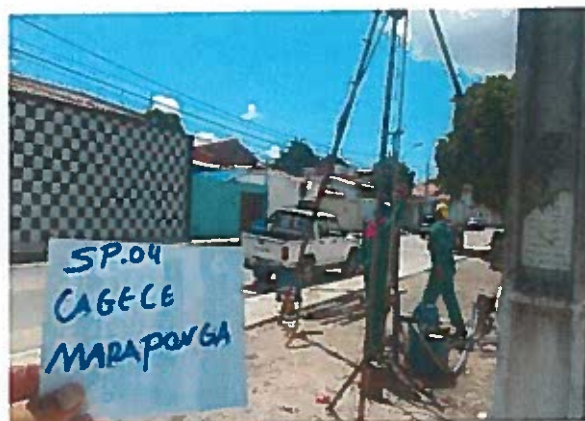
FOTO 05: Detalhe da equipe realizando o avanço a trado do furo SP-04..
