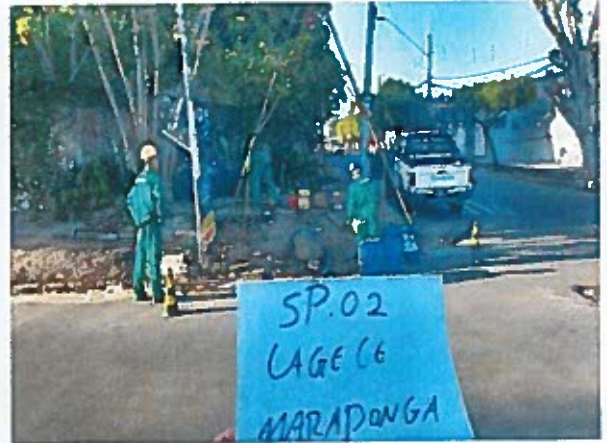
FOTO 02: Detalhe do local onde foi realizado o furo SP-02.
