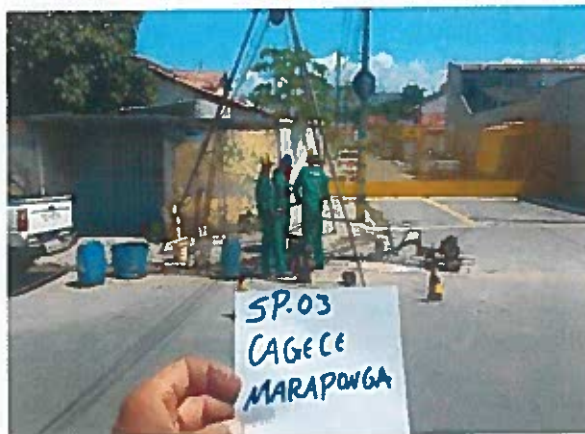
FOTO 03: Equipe iniciando a Sondagem do furo SP-03.
