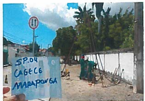
FOTO 06: Detalhe da equipe realizando o avanço a trado do furo SP-04.
