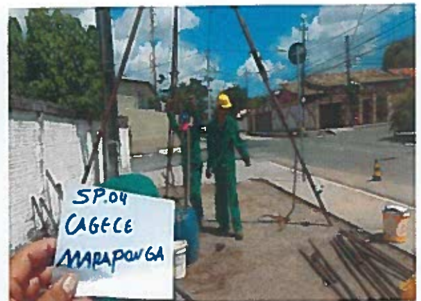
FOTO 04: Detalhe da equipe realizando o avanço a trado do furo SP-04.
