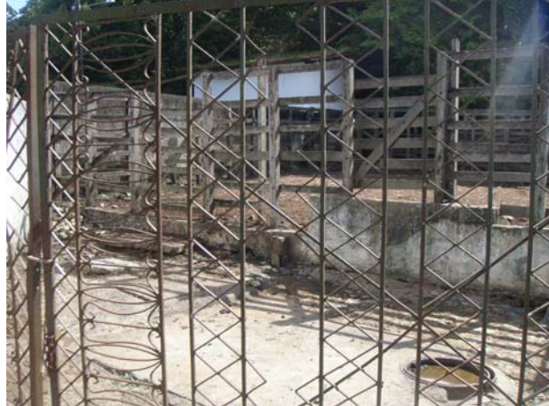
Figura 12 - Caixa de passagem aberta recebendo materiais sólidos
